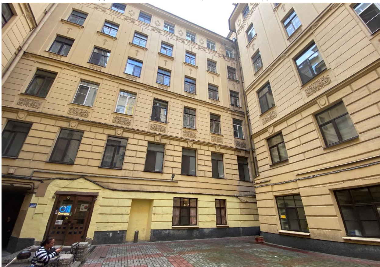
Фото 4. Угол юго-восточного и северо-восточного фасадов первого двора-колодца. Вид с юго-востока
