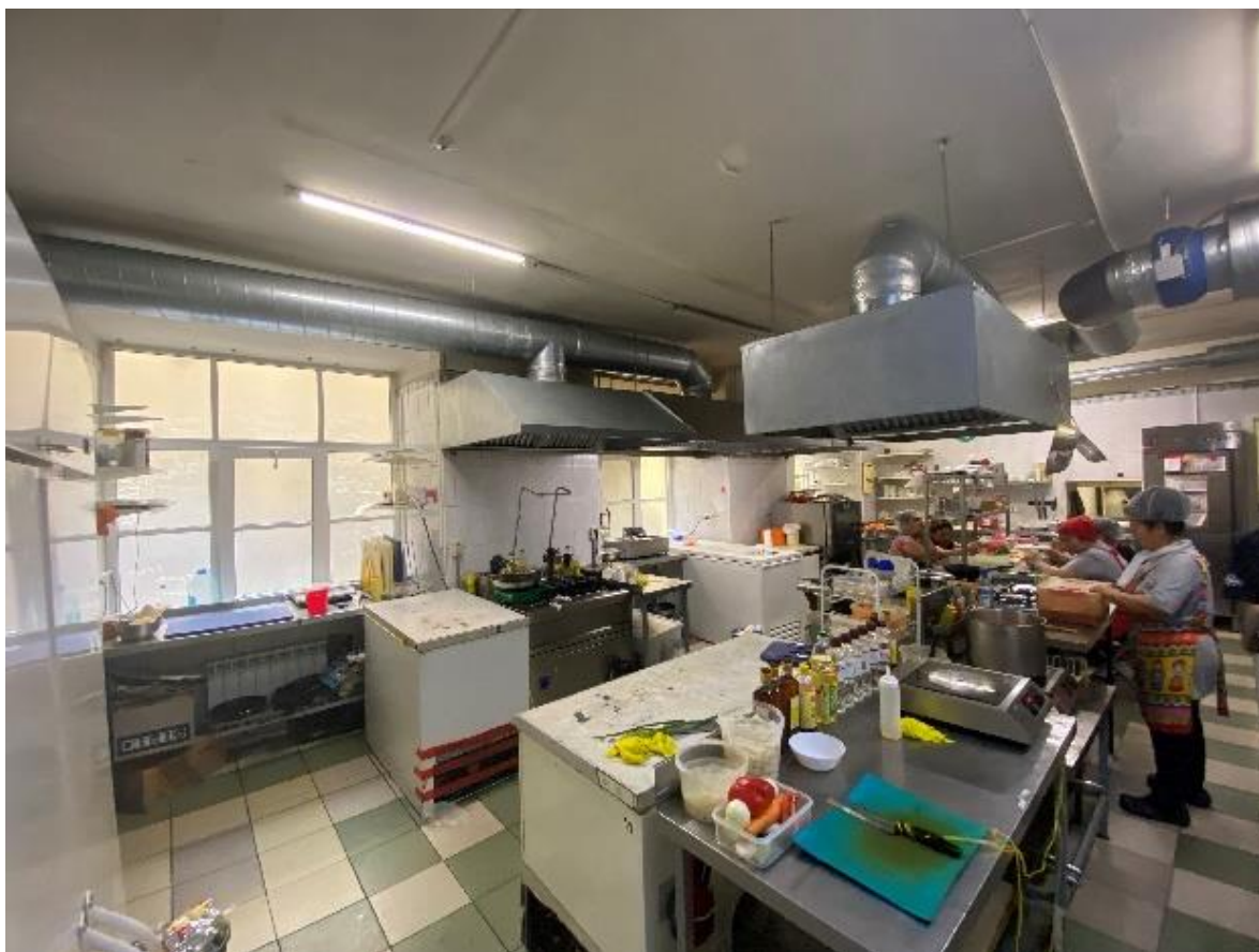
Фото 23. Помещение №12, №13 согласно плану ПИБ. Вид с северо-востока
