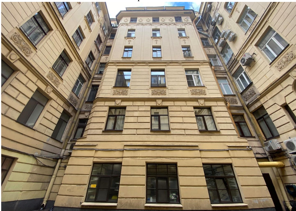
Фото 2. Юго-восточный фасад первого двора-колодца. Вид с юго-востока
