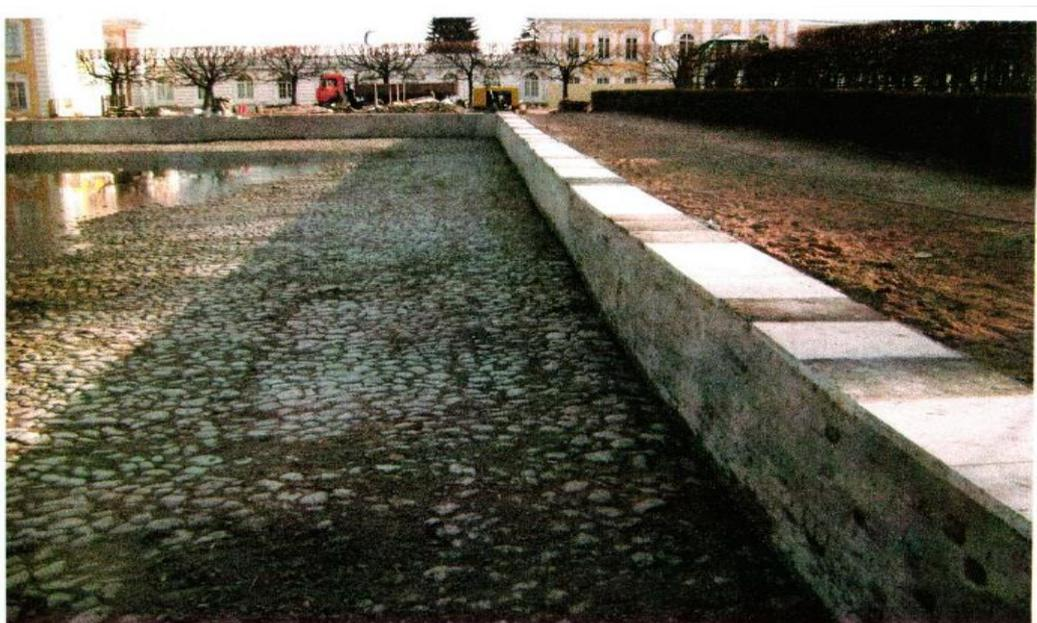
40. Петергоф. Верхний сад. Восточный Квадратный пруд. 2009 г. Состояние дна и восточной подпорной стенки пруда после завершения противоаварийных работ. (Научный отчёт о проделанной работе», ООО «Феррумленд» 2009 г.). Архив Службы реставрации, реконструкции и капитального ремонта ГМЗ «Петергоф».
