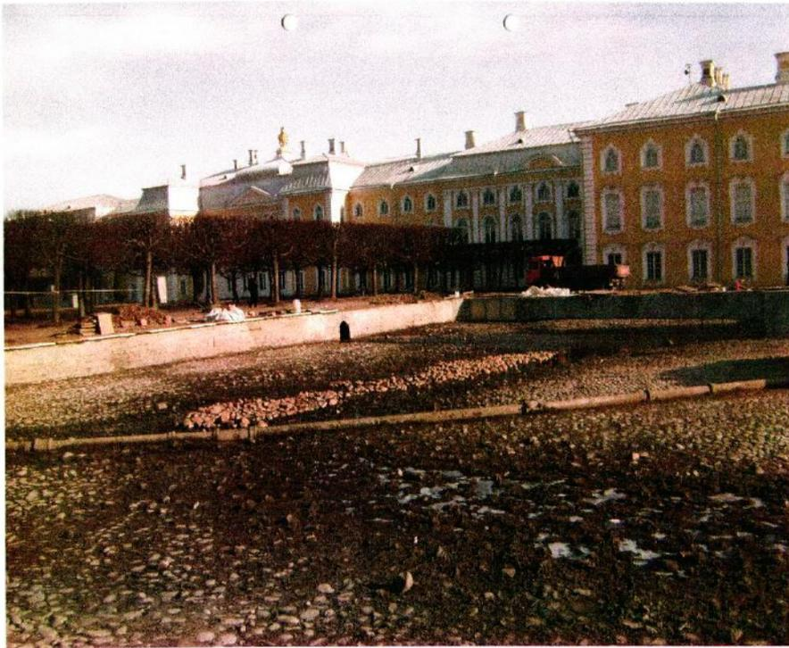
42. Петергоф. Верхний сад. Восточный Квадратный пруд. 2009 г. Состояние дна пруда, арок в подпорных стенках и фонтанного водовода после завершения противоаварийных работ. (Научный отчёт о проделанной работе), ООО «Феррумленд» 2009 г.). Архив Службы реставрации, реконструкции и капитального ремонта ГМЗ «Петергоф».
