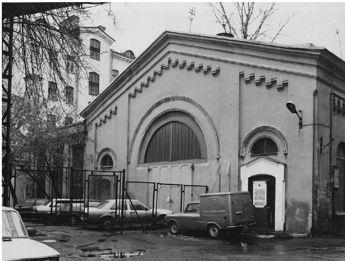
Илл. 75. Главный (юго-западный) фасад здания конторы. Фото 1999 г. КГИОП. Паспорт. Завод Чугуно-литейный и механический Ф.К. Сан-Галли. Контора. 294-З. Инв. № 880п. Составитель Луцко Е.И.
