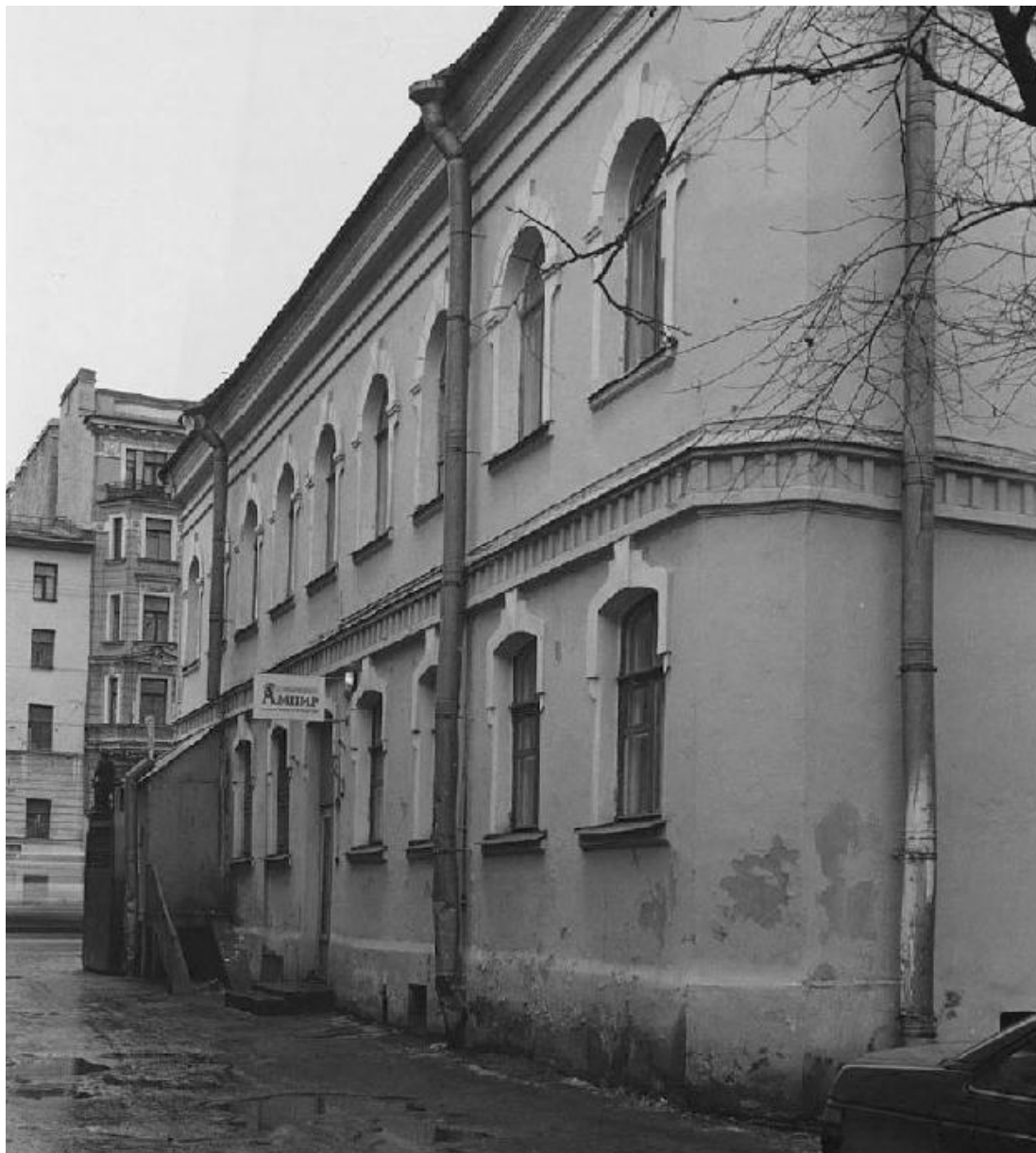
Илл. 73. Здание проходной. Общий вид с территории двора (юго-западный) фасад. Фото 1999 г. КГИОП. Паспорт. Завод Чугуно-литейный и механический Ф.К. Сан-Галли. Комплекс. 294-1. Инв. № 878п. Составитель Луцко Е.И.
