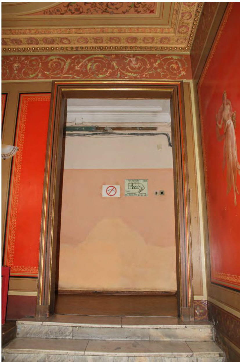
50. г. Санкт-Петербург, Кожевенная линия, д. 1-3. Выявленный объект культурного наследия «Кожевенный завод А.А. Парамонова». Особняк владельца (Кожевенная линия, д. 1-3, лит. Р). Главная лестница, помещение 1-Н №62 (14,0 кв.м). Оформление дверного проема в уровне 2-го этажа. Дата фотофиксации: 29.09.2021.
