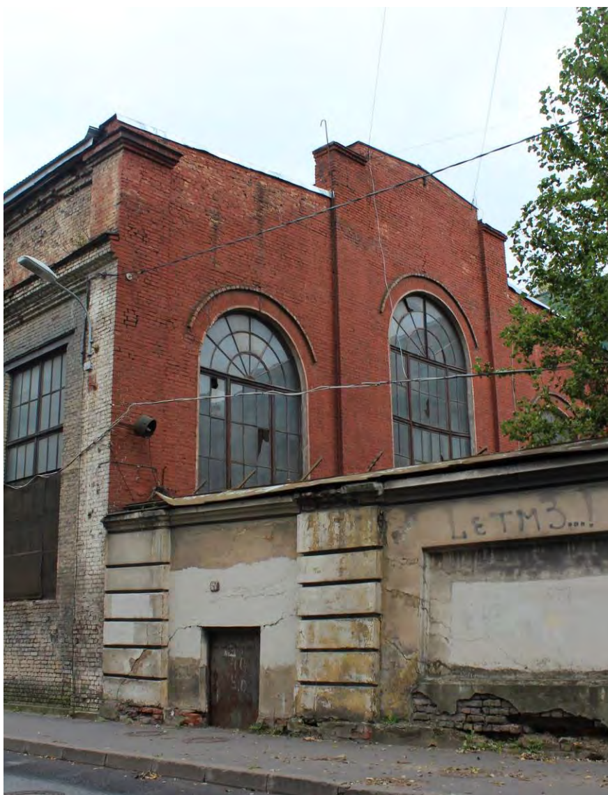
2. г. Санкт-Петербург, Кожевенная линия, д. 1-3. Выявленный объект культурного наследия «Кожевенный завод А.А. Парамонова». Котельная (Кожевенная линия, д. 1-3, лит. Д). Северо-западный фасад (фрагмент). Вид с Масляного канала. Дата фотофиксации: 13.09. 2021 г.
