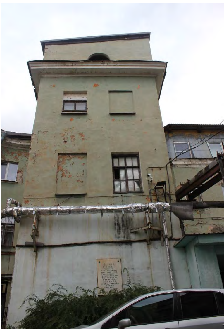
28. г. Санкт-Петербург, Кожевенная линия, д. 1-3. Выявленный объект культурного наследия «Кожевенный завод А.А. Парамонова». Особняк владельца (Кожевенная линия, д. 1-3, лит. Р). Фрагмент дворового фасада. Вид с территории завода в юго-восточном направлении. Дата фотофиксации: 29.09.2021 г.
