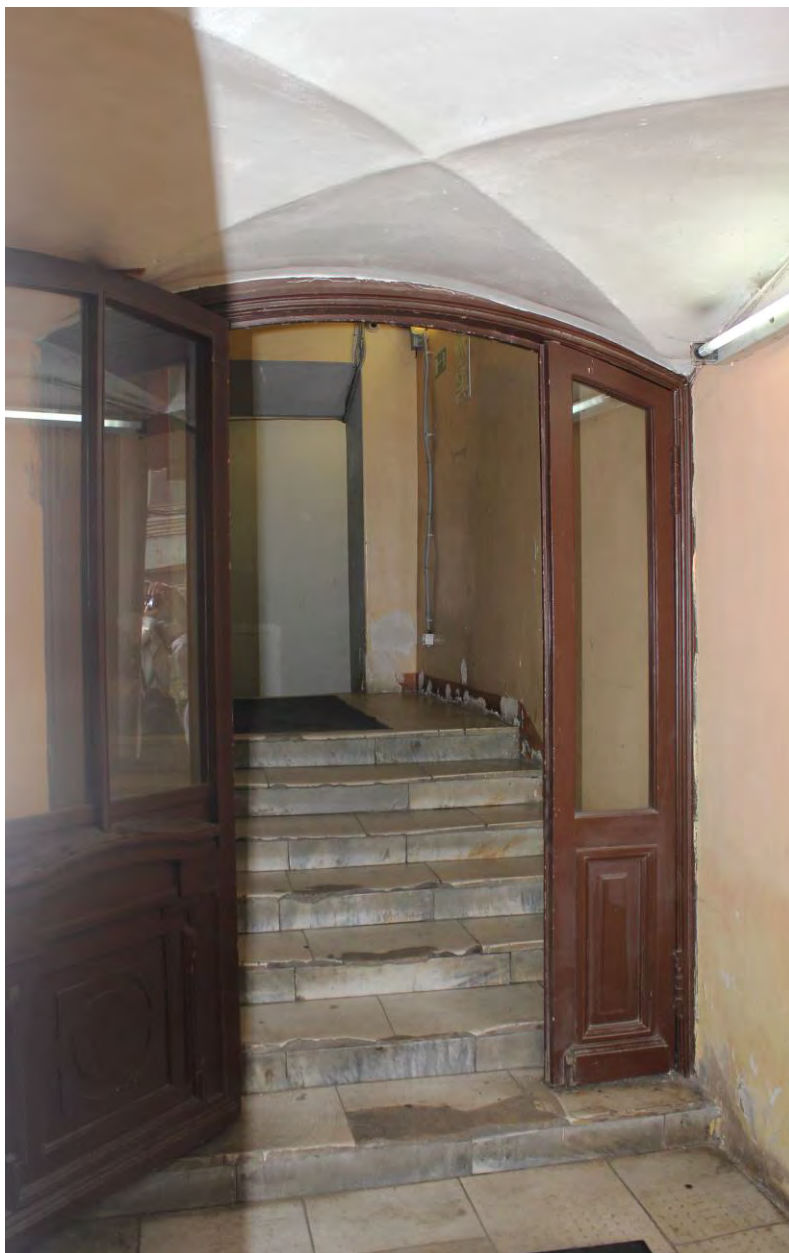
42. г. Санкт-Петербург, Кожевенная линия, д. 1-3. Выявленный объект культурного наследия «Кожевенный завод А.А. Парамонова». Особняк владельца (Кожевенная линия, д. 1-3, лит. Р). 1 этаж. Помещение 1-Н №5 (9,8 кв.м). Тамбур, общий вид помещения с показом крестового сводчатого перекрытия. Дата фотофиксации: 29.09.2021.
