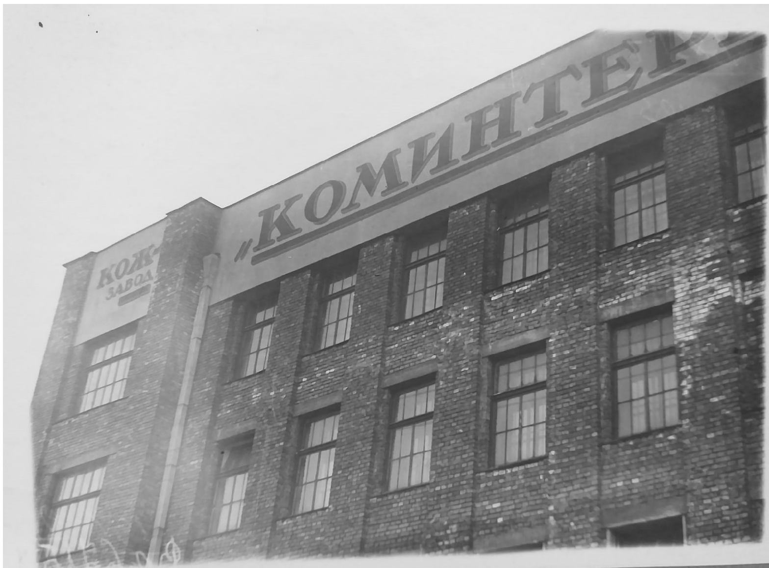
Ил. 58. Часть лицевого фасада заводского корпуса по Кожевенной линии, 1-3 лит. П. 1930 г. // ЦГА КФФД СПб. Шифр: Вр 6715.
