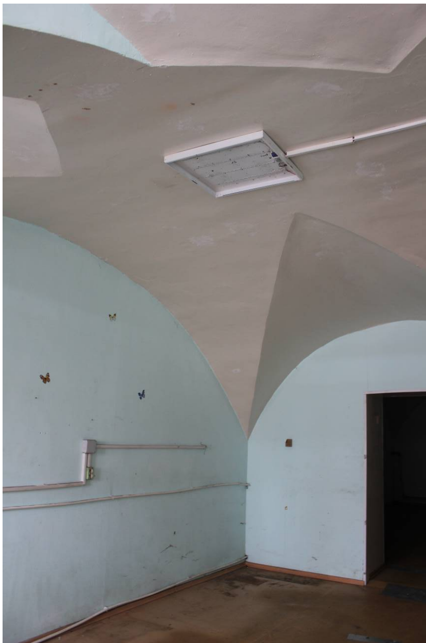
35. г. Санкт-Петербург, Кожевенная линия, д. 1-3. Выявленный объект культурного наследия «Кожевенный завод А.А. Парамонова». Особняк владельца (Кожевенная линия, д. 1-3, лит. Р). 1 этаж. Помещение 1-Н №25 (24,8 кв.м). Общий вид помещения, крестовый свод. Дата фотофиксации: 29.09.2021.
