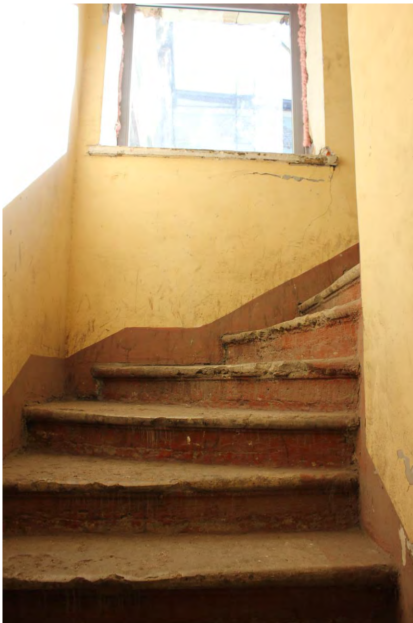
82. г. Санкт-Петербург, Кожевенная линия, д. 1-3. Выявленный объект культурного наследия «Кожевенный завод А.А. Парамонова». Особняк владельца (Кожевенная линия, д. 1-3, лит. Р). 2 этаж. Лестничная клетка, помещение 1-Н №44 (11,6 кв.м). Общий вид помещения, забежные ступени. Дата фотофиксации: 29.09.2021 г.
