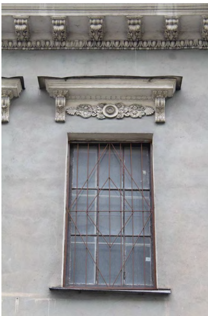
16. г. Санкт-Петербург, Кожевенная линия, д. 1-3. Выявленный объект культурного наследия «Кожевенный завод А.А. Парамонова». Особняк владельца (Кожевенная линия, д. 1-3, лит. Р). Фрагмент лицевого (северо-восточного) фасада с показом оформления и заполнения оконного проема второго этажа, венчающего карниза. Дата фотофиксации: 13.09.2021 г.
