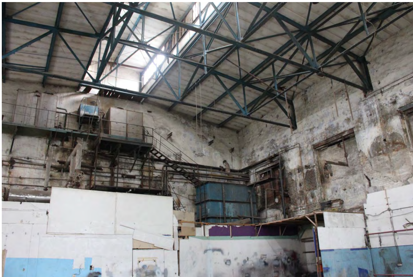
8. г. Санкт-Петербург, Кожевенная линия, д. 1-3. Выявленный объект культурного наследия «Кожевенный завод А.А. Парамонова». Котельная (по адресу: Кожевенная линия, д. 1-3, лит. Д). Общий вид интерьера с показом металлоконструкций крыши и светового фонаря. Дата фотофиксации: 13.09.2021 г.
