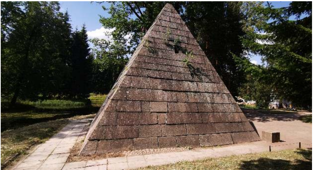
7. Юго- восточный фасад объекта культурного наследия федерального значения «Пирамида с четырьмя колоннами», расположенного по адресу: Санкт-Петербург, г. Пушкин, Екатерининский парк, литера БЗ, входящего в состав объекта культурного наследия федерального значения «Екатерининский дворец и парк. Парк Екатерининский». 24.08.2021.
