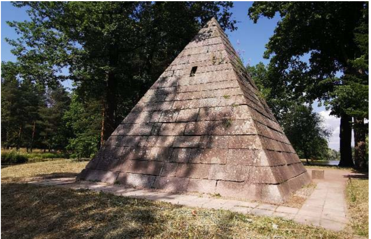
9. Юго- западный фасад объекта культурного наследия федерального значения «Пирамида с четырьмя колоннами», расположенного по адресу: Санкт-Петербург, г. Пушкин, Екатерининский парк, литера БЗ, входящего в состав объекта культурного наследия федерального значения «Екатерининский дворец и парк. Парк Екатерининский». 24.08.2021.
