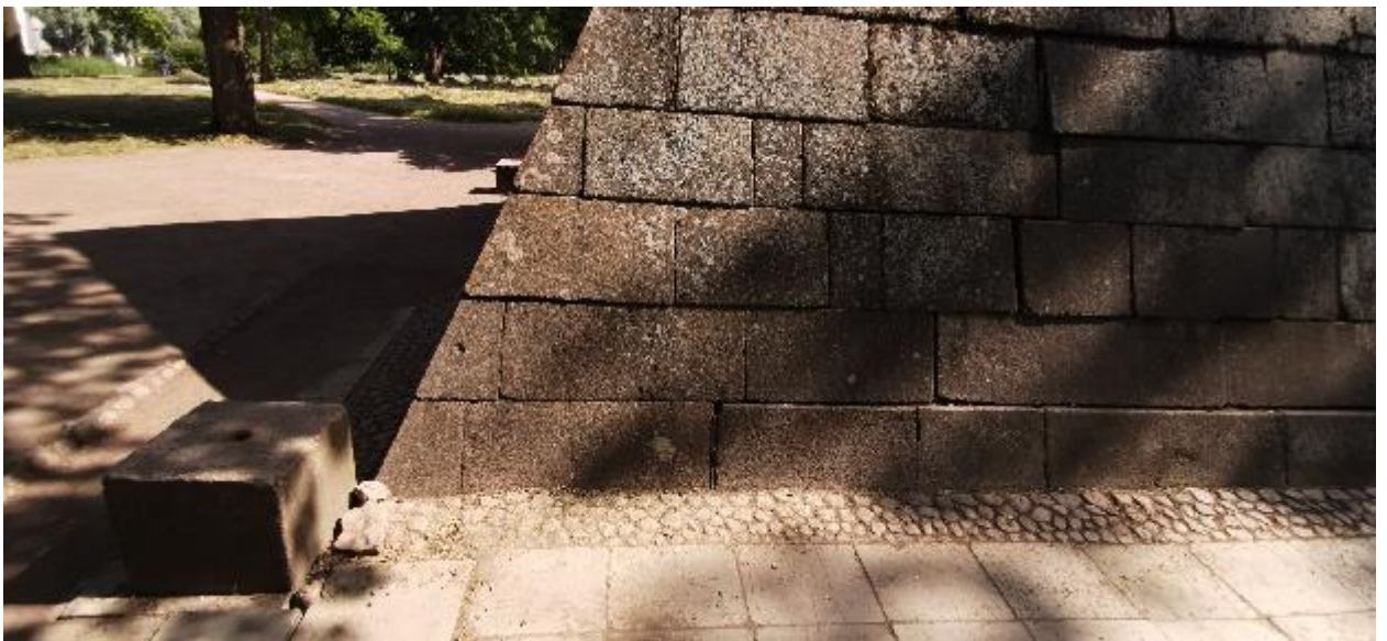
б. Северо- западный фасад и пьедестал под колонну объекта культурного наследия федерального значения «Пирамида с четырьмя колоннами», расположенного по адресу: Санкт-Петербург, г. Пушкин, Екатерининский парк, литера БЗ, входящего в состав объекта культурного наследия федерального значения «Екатерининский дворец и парк. Парк Екатерининский». 24.08.2021.
