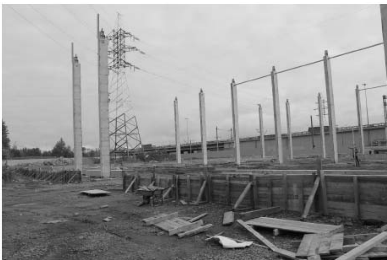
Рис. 27. Санкт Петербург, Фрунзенский район, Грузовой проезд, восточнее д. 23, литера П. Общий вид на участок работ с юго-запада. Точка съемки 5.
