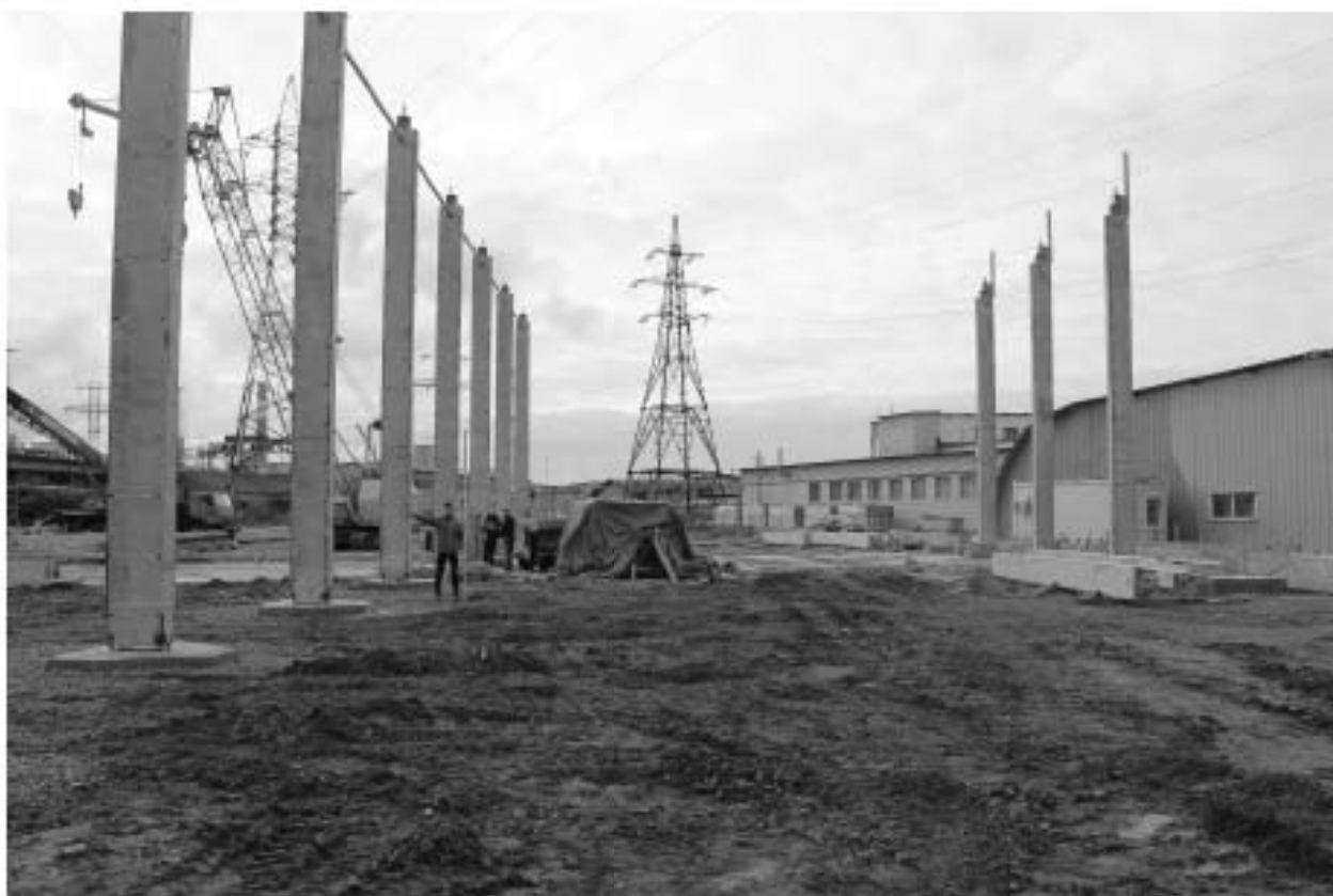
Рис. 26. Санкт Петербург, Фрунзенский район, Грузовой проезд, восточнее д. 23, литера П. Общий вид на участок работ с северо-запада. Точка съемки 4.
