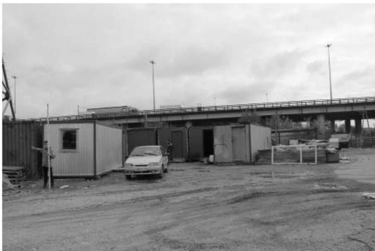
Рис. 34. Санкт Петербург, Фрунзенский район, Грузовой проезд, восточнее д. 23, литера П. Общий вид на участок работ с ЮЮЗ. Точка съемки 7.
