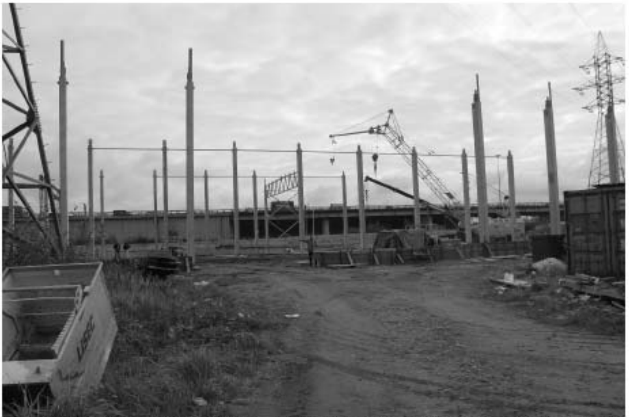
Рис. 24. Санкт Петербург, Фрунзенский район, Грузовой проезд, восточнее д. 23, литера П. Общий вид на центральную часть участка работ с запада. Точка съемки 3.
