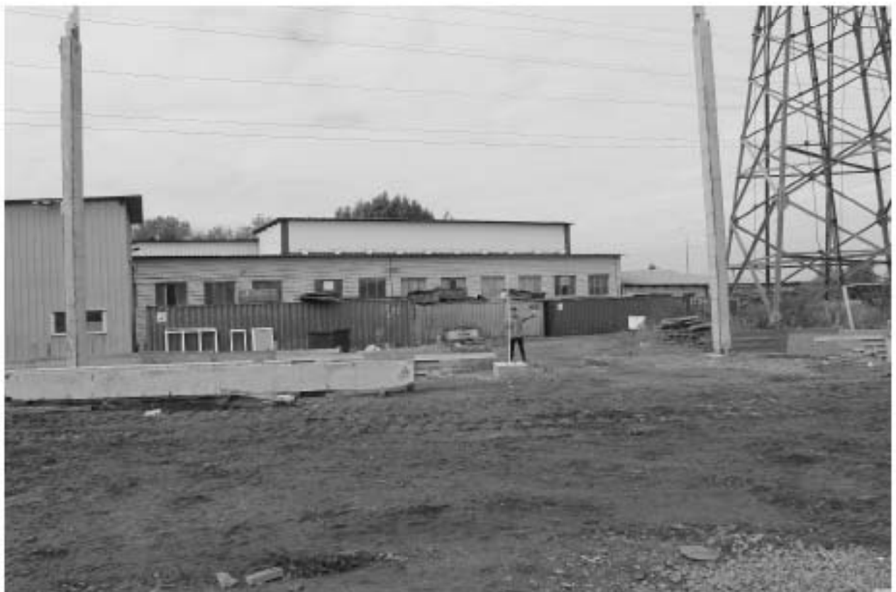
Рис. 25. Санкт Петербург, Фрунзенский район, Грузовой проезд, восточнее д. 23, литера П. Общий вид на участок работ с востока. Точка съемки 4.
