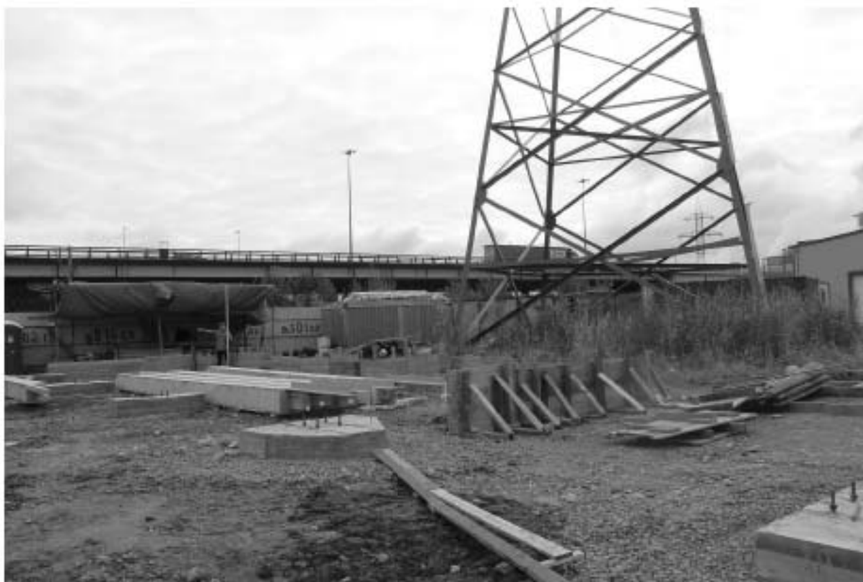
Рис. 28. Санкт Петербург, Фрунзенский район, Грузовой проезд, восточнее д. 23, литера П. Общий вид на участок работ с СЗ. Точка съемки б.
