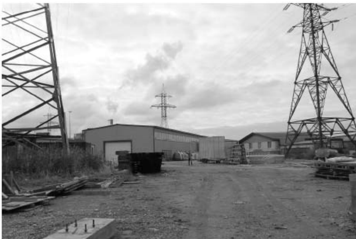
Рис. 29. Санкт Петербург, Фрунзенский район, Грузовой проезд, восточнее д. 23, литера П. Общий вид на участок работ с ССЗ. Точка съемки б.
