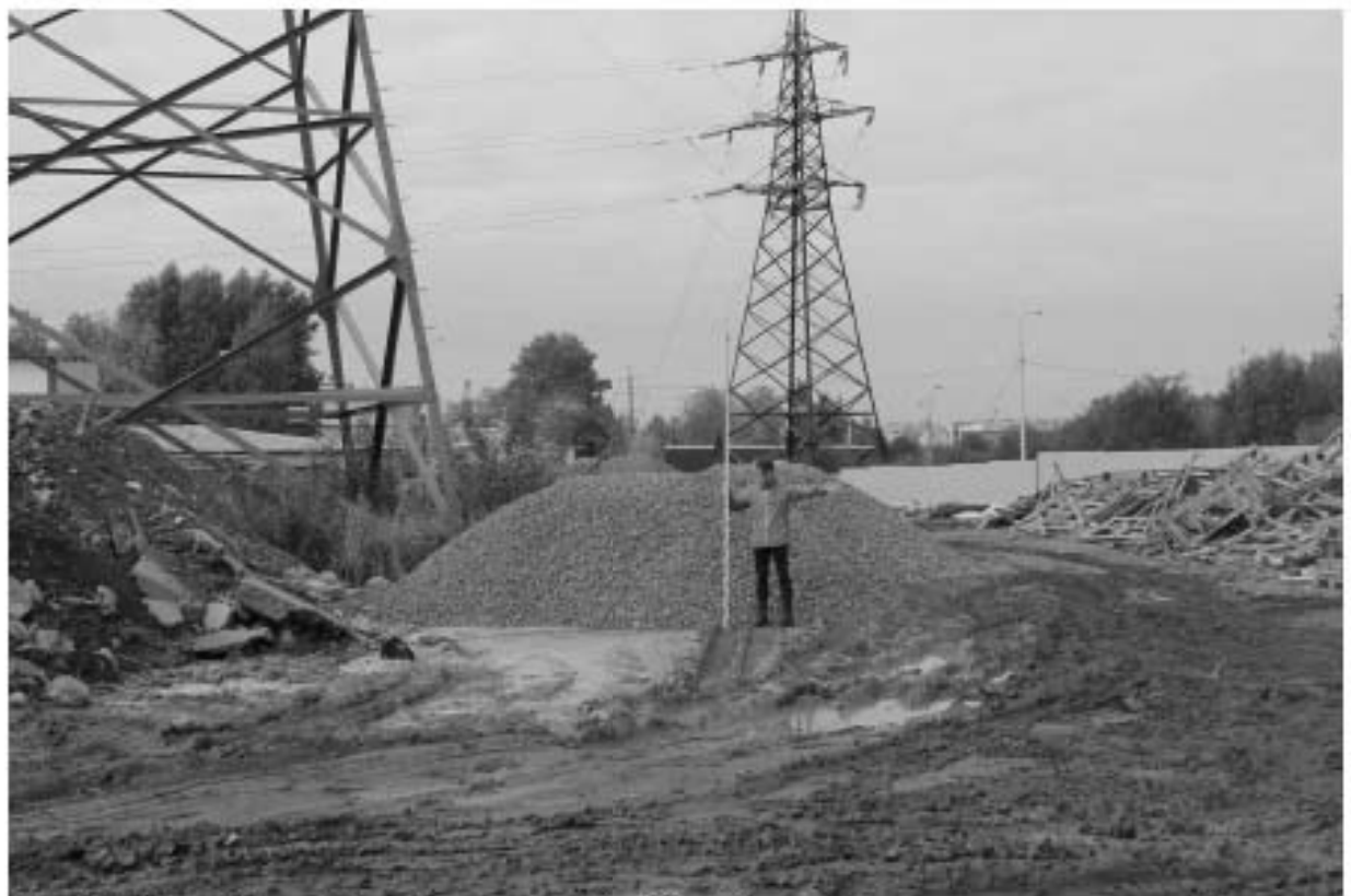
Рис. 19. Санкт Петербург, Фрунзенский район, Грузовой проезд, восточнее д. 23, литера П. Общий вид на участок работ с востока. Точка съемки 1.
