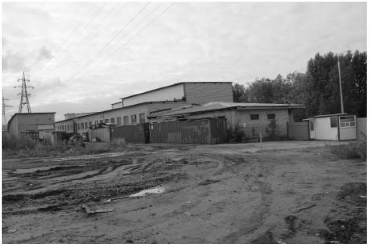
Рис. 22. Санкт Петербург, Фрунзенский район, Грузовой проезд, восточнее д. 23, литера П. Общий вид на участок работ с северо-востока. Точка съемки 2.
