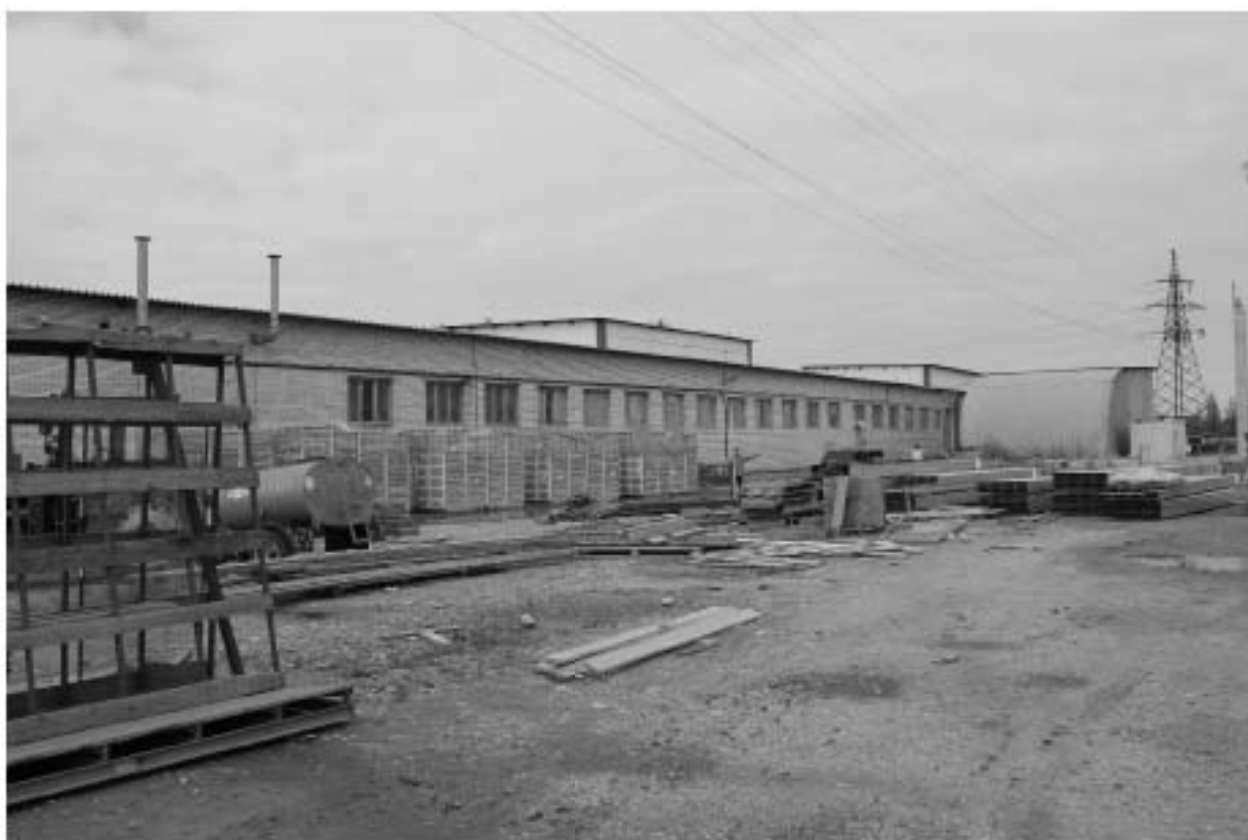
Рис. 31. Санкт Петербург, Фрунзенский район, Грузовой проезд, восточнее д. 23, литера П. Общий вид на участок работ с ЮВ. Точка съемки 7.
