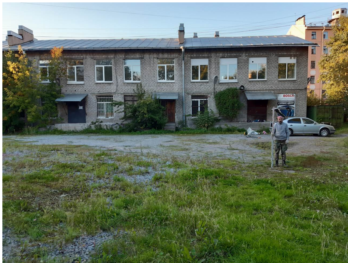
Рис. 11. Санкт-Петербург, Заставская ул., дом 30, литера А. Общий вид участка обследования. Точка съёмки 2. Вид на север
