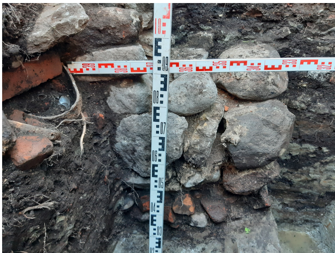
Рис. 25. Санкт-Петербург, Заставская ул., дом 30, литера А. Шурф 1. Фотофиксация южного фасада фундамента
