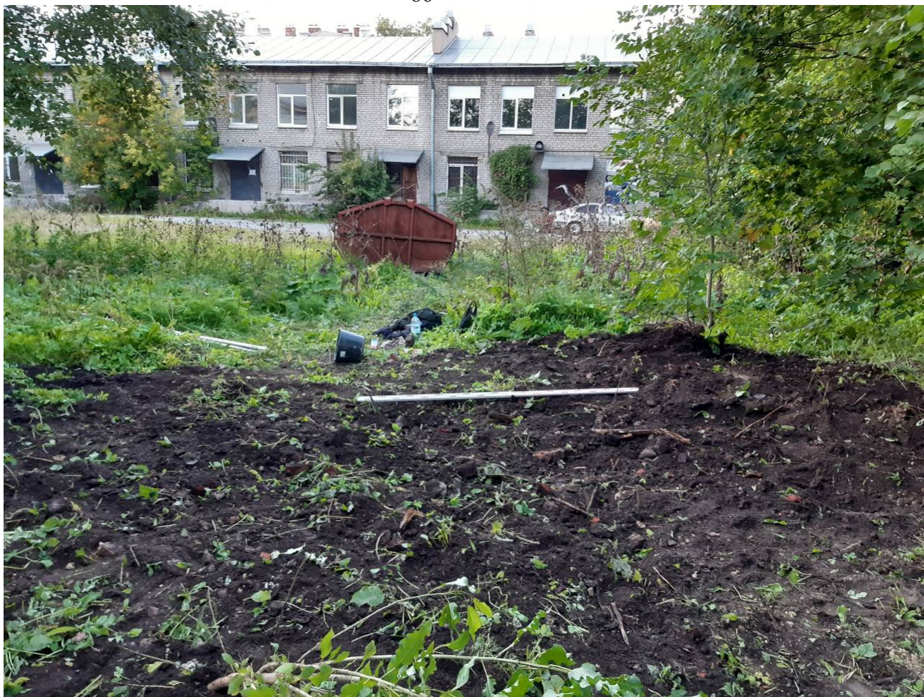
Рис. 33. Санкт-Петербург, Заставская ул., дом 30, литера А. Шурф 1. Фотофиксация после рекультивации. Вид на север
