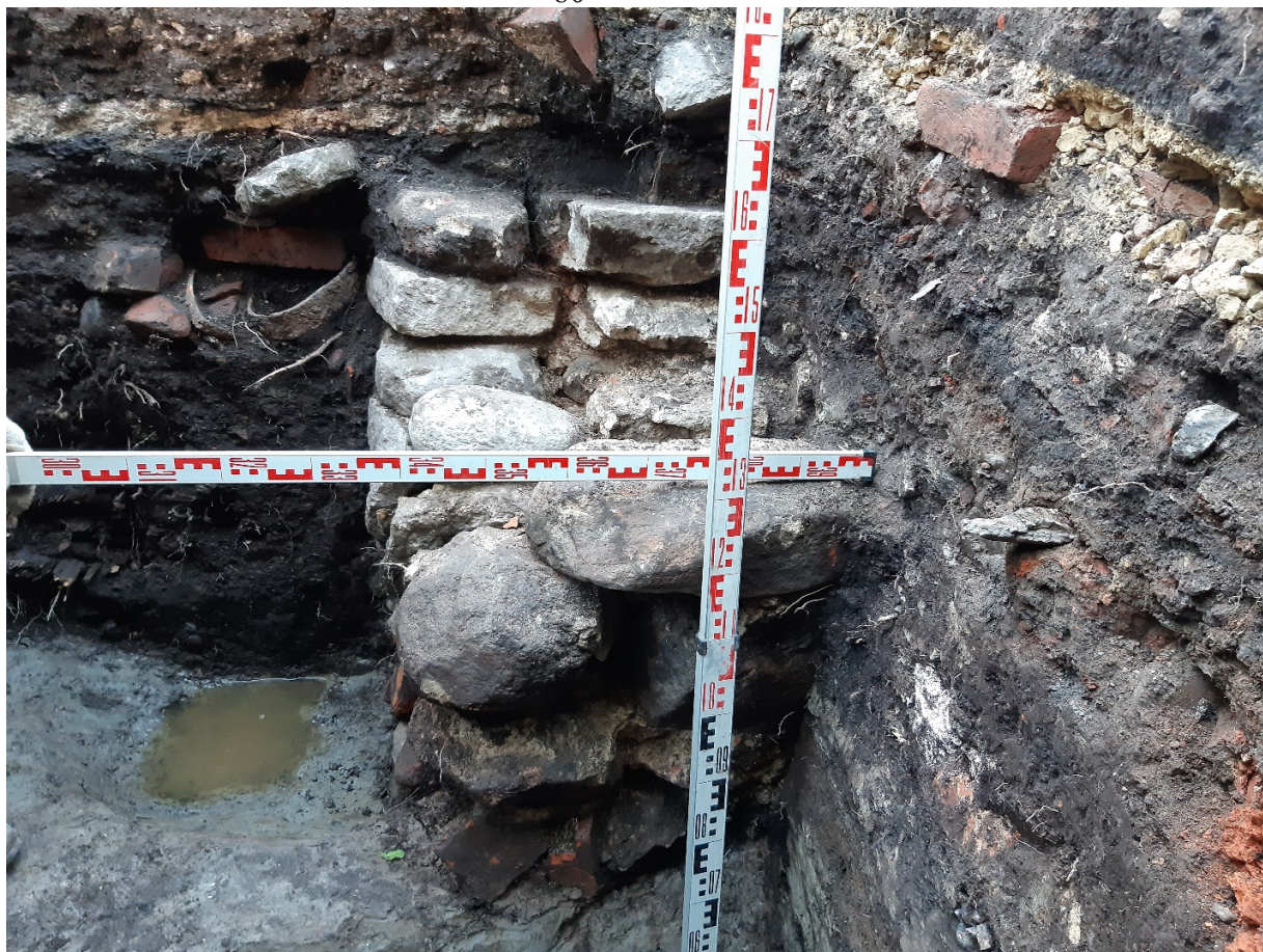
Рис. 26. Санкт-Петербург, Заставская ул., дом 30, литера А. Шурф 1. Фотофиксация восточного фаса фундамента
