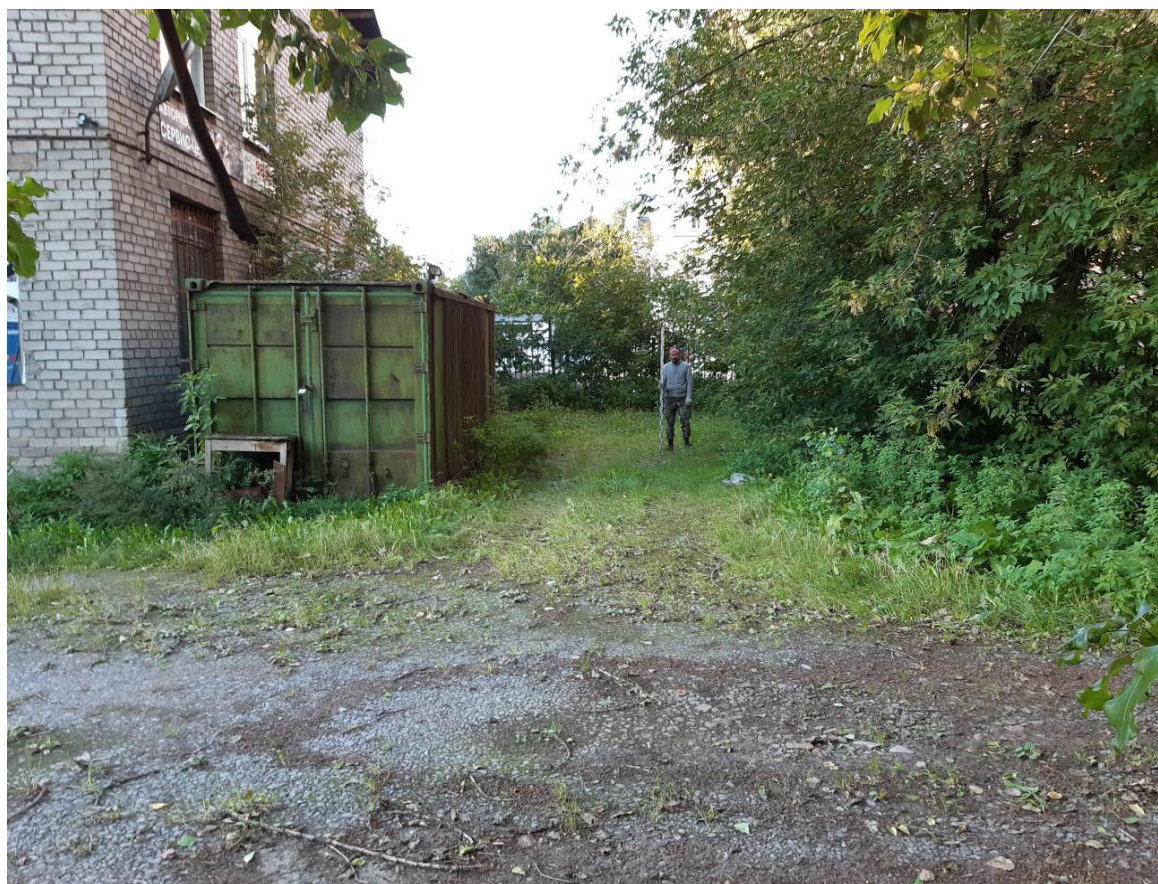
Рис. 15. Санкт-Петербург, Заставская ул., дом 30, литера А. Общий вид участка обследования. Точка съемки 5. Вид на север
