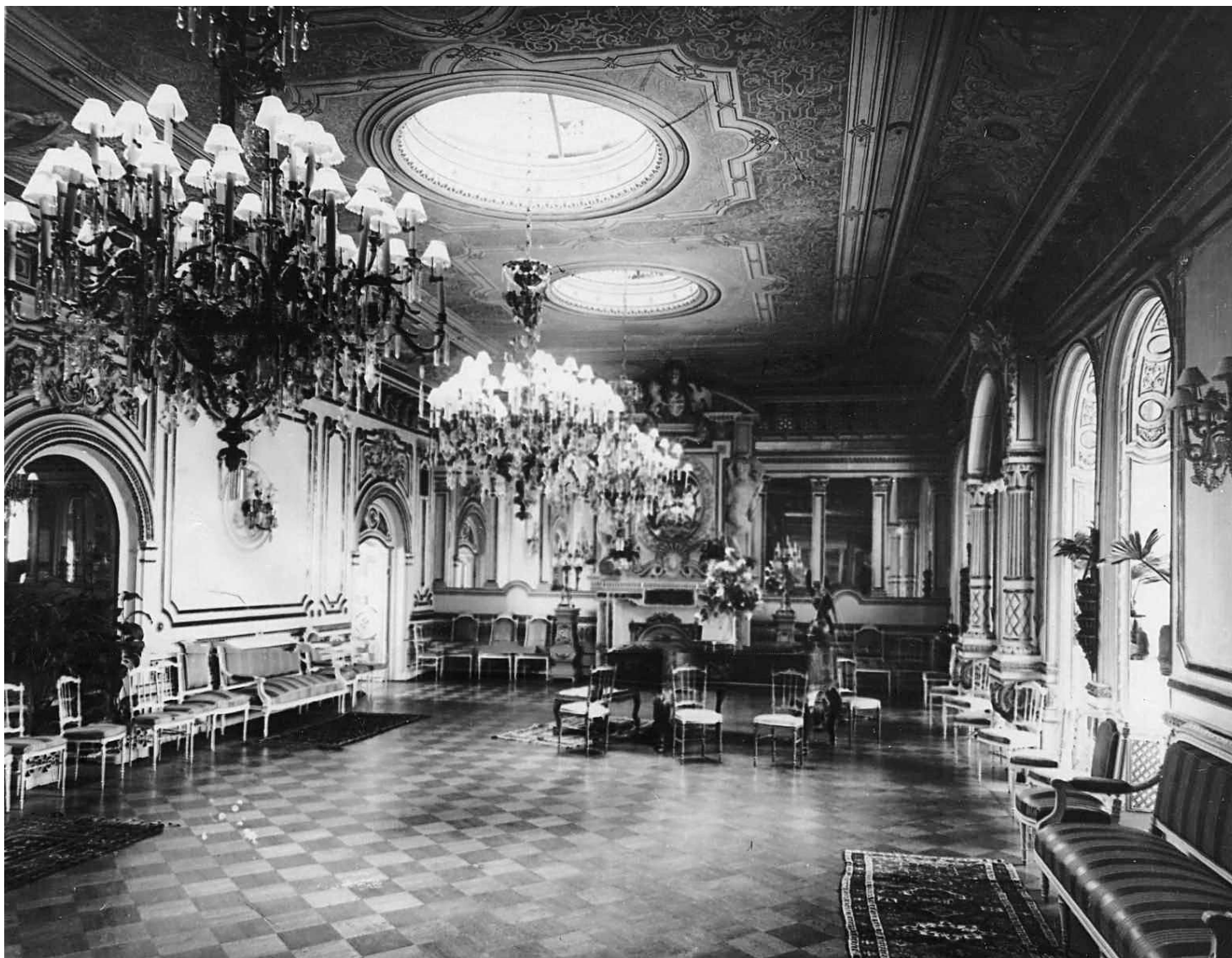
98. Посольство Королевства Италии в Санкт-Петербурге. Наб. реки Мойки, 86. 2 этаж. Большой зал. Вид от восточной стены. Фотография, 1909 - 1913 гг. ЦГАКФФД, Е-789.
