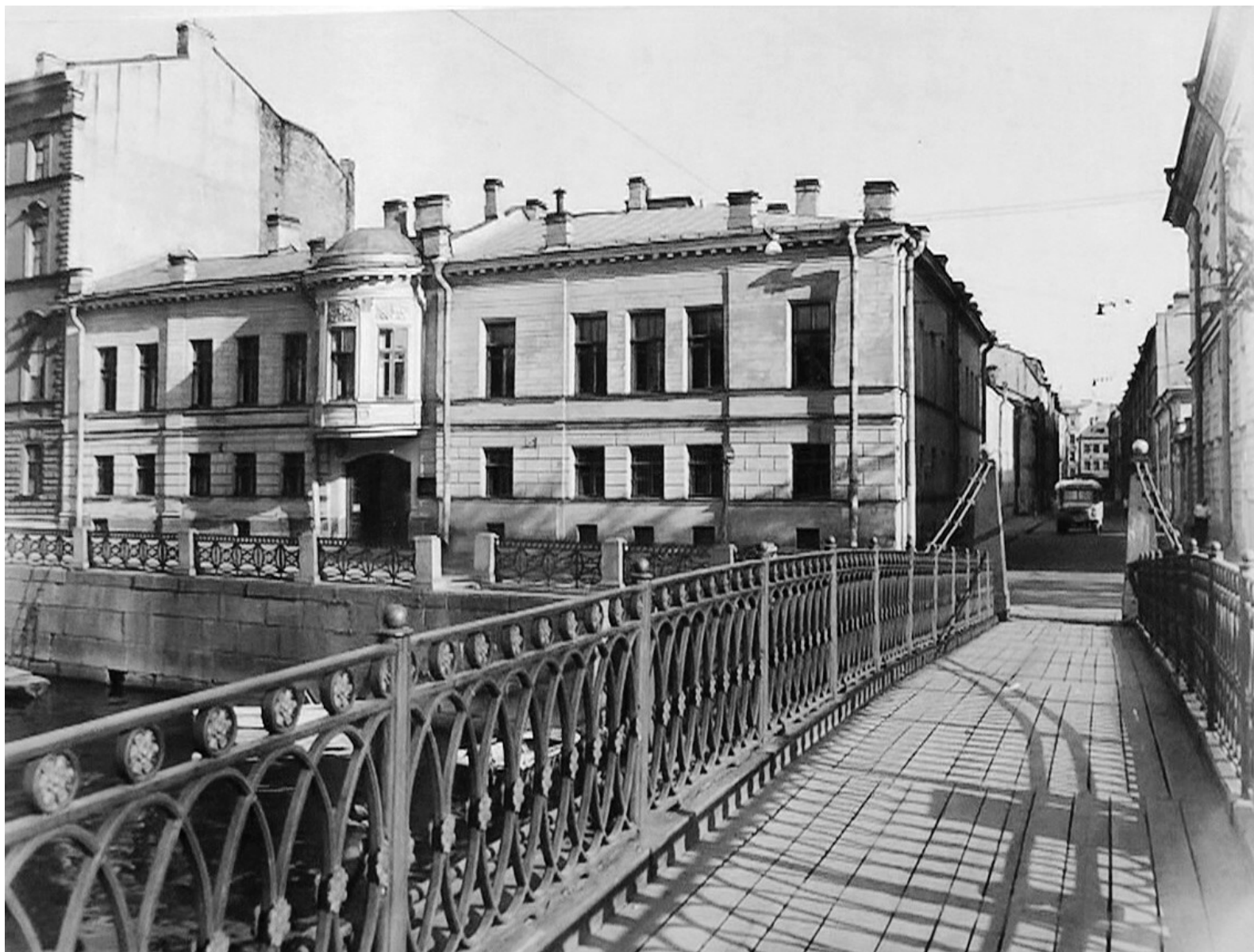
127. Набережная реки Мойки, 86-88. Фотография, 1980 г. КГИОП СПб, нег. 44515.
