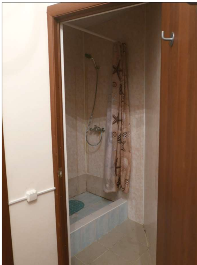
17. Хозяйственное помещение (пом. 9 согласно инвентарному плану 2012 г.). Общий вид на существующее помещение душевой, не зафиксированное инвентарным планом 2012 г.).
