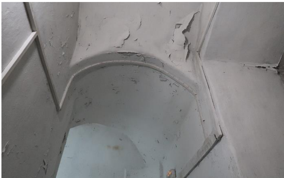
34. Объект культурного наследия федерального значения «Церковь», расположенный по адресу: г. Санкт-Петербург, 8-я линия В.О., дом 67, литера Б (г. Санкт-Петербург, 8-я линия Васильевского острова, д. 67, 7-я линия Васильевского острова, д. 68), входящий в состав объекта культурного наследия федерального значения «Церковь Благовещения Пресвятой Богородицы» по адресу: г. Санкт-Петербург, 8-я линия В.О., дом 67, литера Б, дом 71, литера А (г. Санкт-Петербург, 8-я линия В.О., д. 67, 71, 7-я линия В.О., д. 68, Малый проспект В.О., между домами 18 и 20). Лестница ведущая на колокольню. Общий вид. Стены и своды. Фрагмент интерьера.
