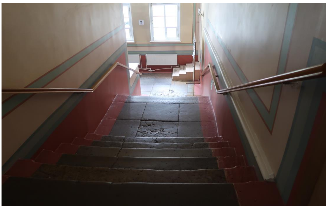
12. Объект культурного наследия федерального значения «Церковь», расположенный по адресу: г. Санкт-Петербург, 8-я линия В.О., дом 67, литера Б (г. Санкт-Петербург, 8-я линия Васильевского острова, д. 67, 7-я линия Васильевского острова, д. 68), входящий в состав объекта культурного наследия федерального значения «Церковь Благовещения Пресвятой Богородицы» по адресу: г. Санкт-Петербург, 8-я линия В.О., дом 67, литера Б, дом 71, литера А (г. Санкт-Петербург, 8-я линия В.О., д. 67, 71, 7-я линия В.О., д. 68, Малый проспект В.О., между домами 18 и 20). Главная лестница в верхний храм. Общий вид.
