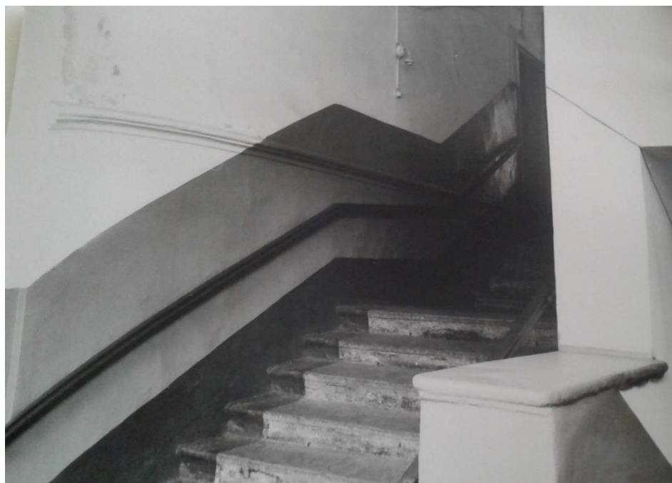
46. Церковь Благовещения Пресвятой Богородицы на Василевском острове. Южная главная лестница. Верхние марши. Фотография. 1985 г. Архив КГИОП. Нег. № 55165.
