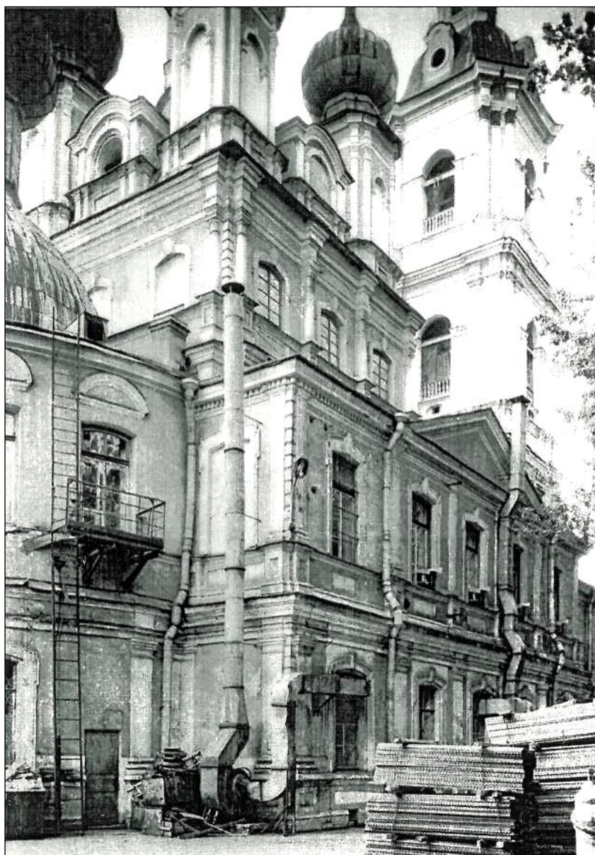
23. Церковь Благовещения Пресвятой Богородицы. Фрагмент северного фасада. Фотография. 1989 г. Архив КГИОП. Фототека. № 19, нег. № 54644.
