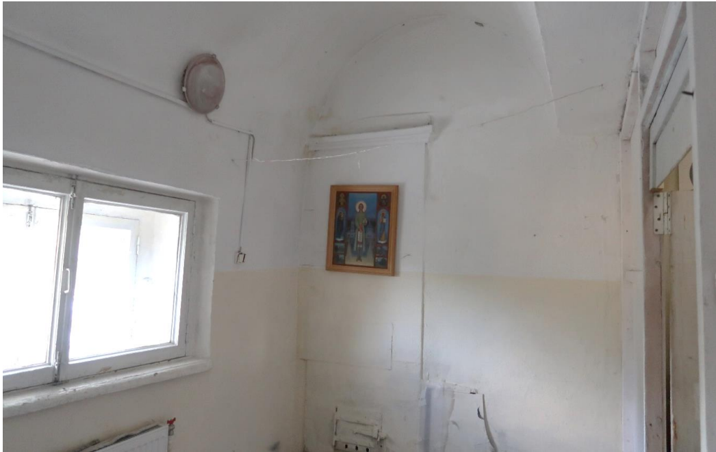
27. Объект культурного наследия федерального значения «Церковь», расположенный по адресу: г. Санкт-Петербург, 8-я линия В.О., дом 67, литера Б (г. Санкт-Петербург, 8-я линия Васильевского острова, д. 67, 7-я линия Васильевского острова, д. 68), входящий в состав объекта культурного наследия федерального значения «Церковь Благовещения Пресвятой Богородицы» по адресу: г. Санкт-Петербург, 8-я линия В.О., дом 67, литера Б, дом 71, литера А (г. Санкт-Петербург, 8-я линия В.О., д. 67, 71, 7-я линия В.О., д. 68, Малый проспект В.О., между домами 18 и 20). Придел во имя Зачатия Иоанна Предтечи. Помещение 61. Вид в восточном направлении.
