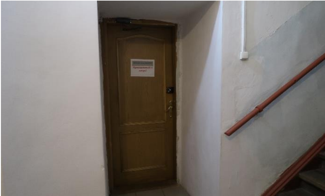
36. Объект культурного наследия федерального значения «Церковь», расположенный по адресу: г. Санкт-Петербург, 8-я линия В.О., дом 67, литера Б (г. Санкт-Петербург, 8-я линия Васильевского острова, д. 67, 7-я линия Васильевского острова, д. 68), входящий в состав объекта культурного наследия федерального значения «Церковь Благовещения Пресвятой Богородицы» по адресу: г. Санкт-Петербург, 8-я линия В.О., дом 67, литера Б, дом 71, литера А (г. Санкт-Петербург, 8-я линия В.О., д. 67, 71, 7-я линия В.О., д. 68, Малый проспект В.О., между домами 18 и 20). Лестница, ведущая на колокольню. Дверной проем.
