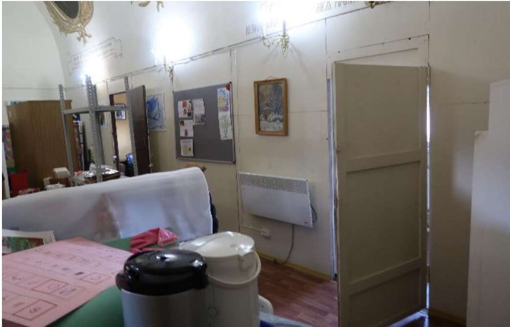
25. Объект культурного наследия федерального значения «Церковь», расположенный по адресу: г. Санкт-Петербург, 8-я линия В.О., дом 67, литера Б (г. Санкт-Петербург, 8-я линия Васильевского острова, д. 67, 7-я линия Васильевского острова, д. 68), входящий в состав объекта культурного наследия федерального значения «Церковь Благовещения Пресвятой Богородицы» по адресу: г. Санкт-Петербург, 8-я линия В.О., дом 67, литера Б, дом 71, литера А (г. Санкт-Петербург, 8-я линия В.О., д. 67, 71, 7-я линия В.О., д. 68, Малый проспект В.О., между домами 18 и 20). Придел во имя Зачатия Св. Иоанна Предтечи. Фрагмент интерьера.
