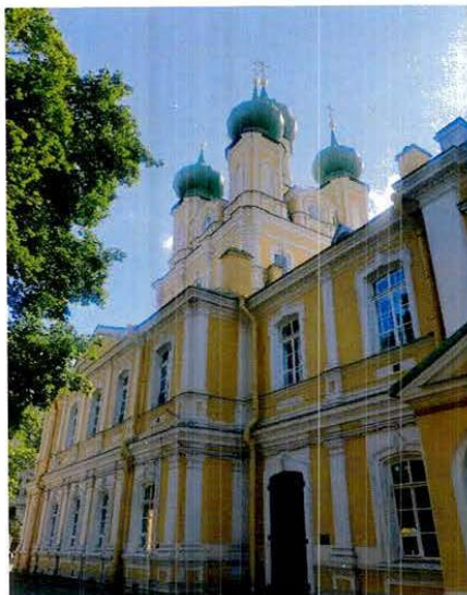
1. Вид на объект культурного наследия с северо-западной стороны
