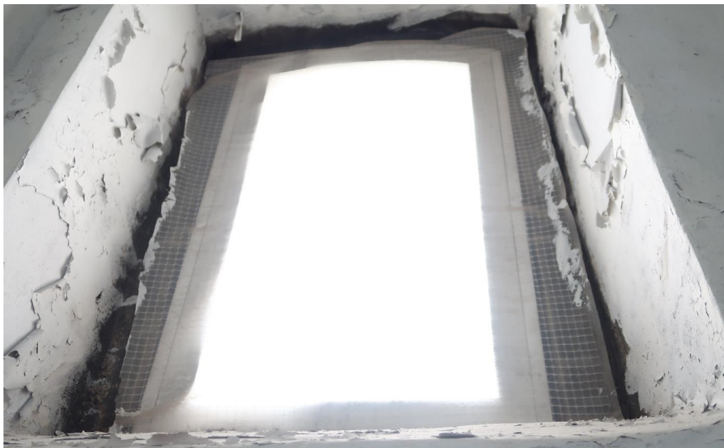
37. Объект культурного наследия федерального значения «Церковь», расположенный по адресу: г. Санкт-Петербург, 8-я линия В.О., дом 67, литера Б (г. Санкт-Петербург, 8-я линия Васильевского острова, д. 67, 7-я линия Васильевского острова, д. 68), входящий в состав объекта культурного наследия федерального значения «Церковь Благовещения Пресвятой Богородицы» по адресу: г. Санкт-Петербург, 8-я линия В.О., дом 67, литера Б, дом 71, литера А (г. Санкт-Петербург, 8-я линия В.О., д. 67, 71, 7-я линия В.О., д. 68, Малый проспект В.О., между домами 18 и 20). Лестница, ведущая на колокольню. Оконный проем.
