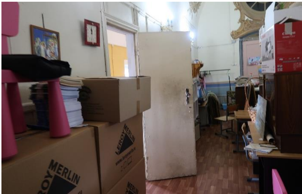
26. Объект культурного наследия федерального значения «Церковь», расположенный по адресу: г. Санкт-Петербург, 8-я линия В.О., дом 67, литера Б (г. Санкт-Петербург, 8-я линия Васильевского острова, д. 67, 7-я линия Васильевского острова, д. 68), входящий в состав объекта культурного наследия федерального значения «Церковь Благовещения Пресвятой Богородицы» по адресу: г. Санкт-Петербург, 8-я линия В.О., дом 67, литера Б, дом 71, литера А (г. Санкт-Петербург, 8-я линия В.О., д. 67, 71, 7-я линия В.О., д. 68, Малый проспект В.О., между домами 18 и 20). Придел во имя Зачатия Св. Иоанна Предтечи. Фрагмент интерьера.
