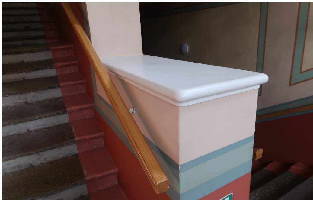
11. Объект культурного наследия федерального значения «Церковь», расположенный по адресу: г. Санкт-Петербург, 8-я линия В.О., дом 67, литера Б (г. Санкт-Петербург, 8-я линия Васильевского острова, д. 67, 7-я линия Васильевского острова, д. 68), входящий в состав объекта культурного наследия федерального значения «Церковь Благовещения Пресвятой Богородицы» по адресу: г. Санкт-Петербург, 8-я линия В.О., дом 67, литера Б, дом 71, литера А (г. Санкт-Петербург, 8-я линия В.О., д. 67, 71, 7-я линия В.О., д. 68, Малый проспект В.О., между домами 18 и 20). Главная лестница в верхний храм. Фрагмент.
