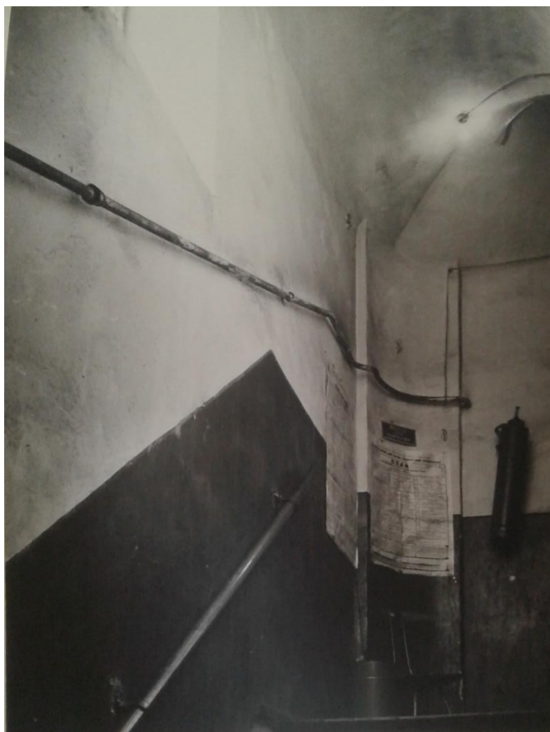
47. Церковь Благовещения Пресвятой Богородицы на Василевском острове. Лестница, ведущая на колокольню. Фотография. 1957 г. Архив КГИОП. Нег. № 28126.
