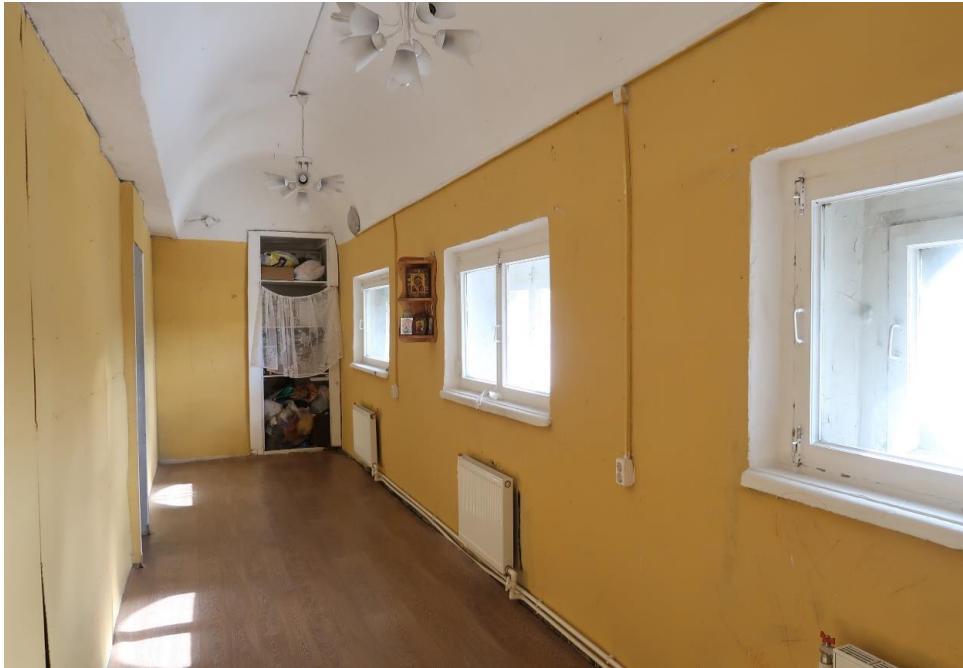
29. Объект культурного наследия федерального значения «Церковь», расположенный по адресу: г. Санкт-Петербург, 8-я линия В.О., дом 67, литера Б (г. Санкт-Петербург, 8-я линия Васильевского острова, д. 67, 7-я линия Васильевского острова, д. 68), входящий в состав объекта культурного наследия федерального значения «Церковь Благовещения Пресвятой Богородицы» по адресу: г. Санкт-Петербург, 8-я линия В.О., дом 67, литера Б, дом 71, литера А (г. Санкт-Петербург, 8-я линия В.О., д. 67, 71, 7-я линия В.О., д. 68, Малый проспект В.О., между домами 18 и 20). Придел во имя Зачатия Иоанна Предтечи. Помещение 62. Вид в восточном направлении.
