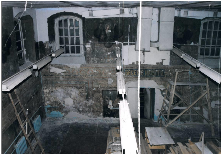
52. Церковь Благовещения Пресвятой Богородицы. Верхний храм. Второй свет четверика над перекрытием советского периода. Вид на западную часть. Фотография. 1998 г. Фотограф Л.А. Торопов.
