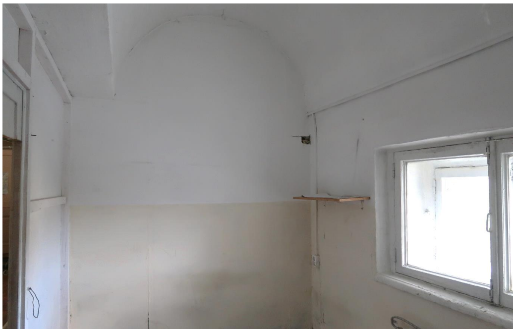
28. Объект культурного наследия федерального значения «Церковь», расположенный по адресу: г. Санкт-Петербург, 8-я линия В.О., дом 67, литера Б (г. Санкт-Петербург, 8-я линия Васильевского острова, д. 67, 7-я линия Васильевского острова, д. 68), входящий в состав объекта культурного наследия федерального значения «Церковь Благовещения Пресвятой Богородицы» по адресу: г. Санкт-Петербург, 8-я линия В.О., дом 67, литера Б, дом 71, литера А (г. Санкт-Петербург, 8-я линия В.О., д. 67, 71, 7-я линия В.О., д. 68, Малый проспект В.О., между домами 18 и 20). Придел во имя Зачатия Иоанна Предтечи. Помещение 61. Вид в западном направлении.
