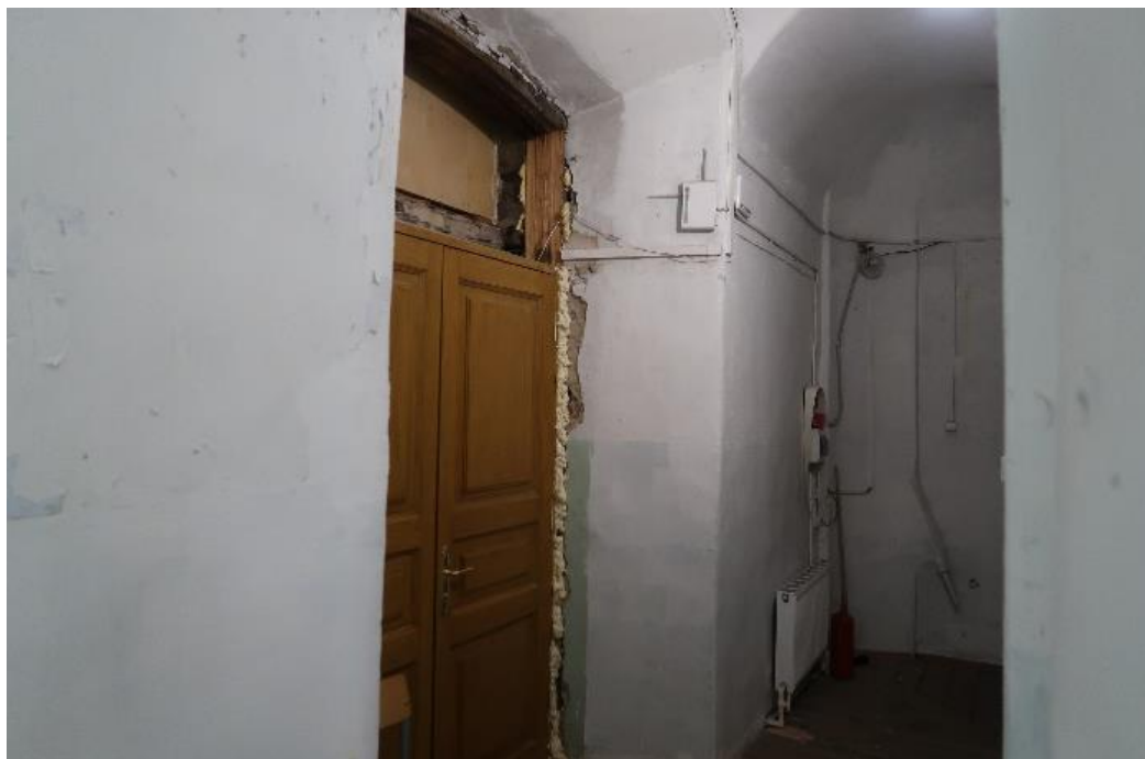
35. Объект культурного наследия федерального значения «Церковь», расположенный по адресу: г. Санкт-Петербург, 8-я линия В.О., дом 67, литера Б (г. Санкт-Петербург, 8-я линия Васильевского острова, д. 67, 7-я линия Васильевского острова, д. 68), входящий в состав объекта культурного наследия федерального значения «Церковь Благовещения Пресвятой Богородицы» по адресу: г. Санкт-Петербург, 8-я линия В.О., дом 67, литера Б, дом 71, литера А (г. Санкт-Петербург, 8-я линия В.О., д. 67, 71, 7-я линия В.О., д. 68, Малый проспект В.О., между домами 18 и 20). Объем лестницы, ведущей на колокольню. Фрагмент интерьера.
