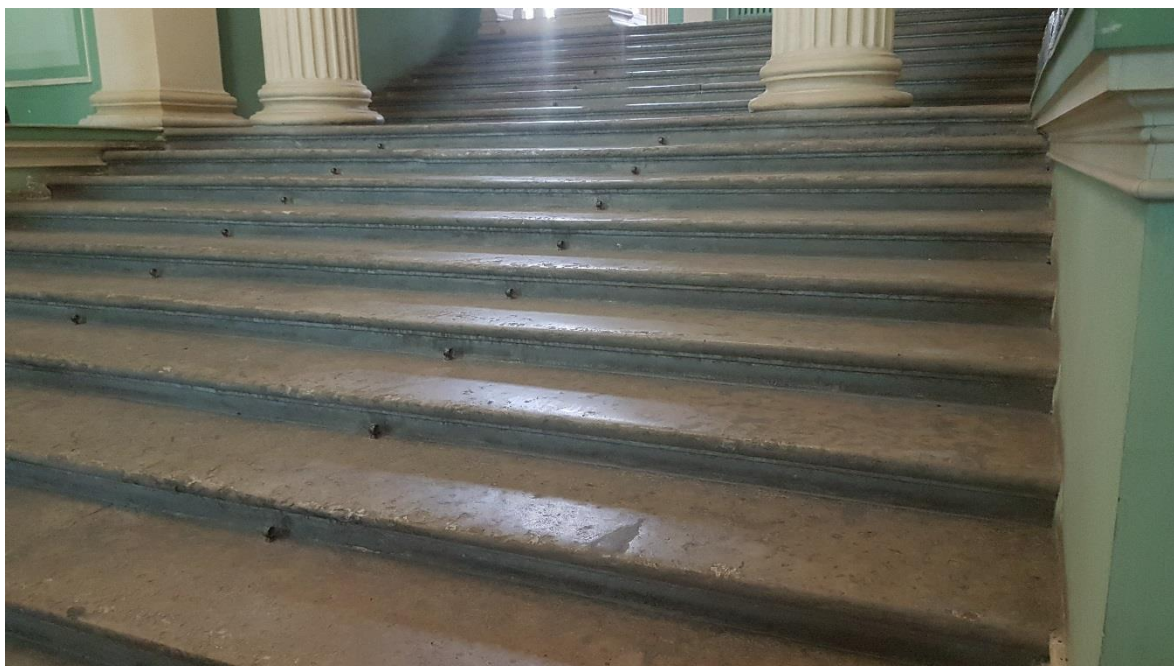
Фото 9. Вестибюль. Ступени лестницы.
