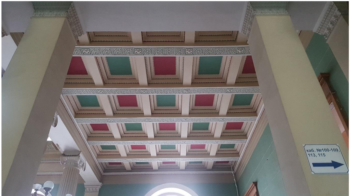
Фото 13. Парадная лестница. Потолок.
