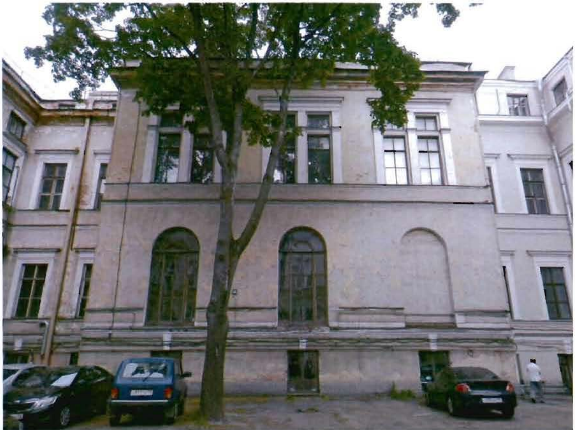
5. Восточный фасад внутреннего двора
