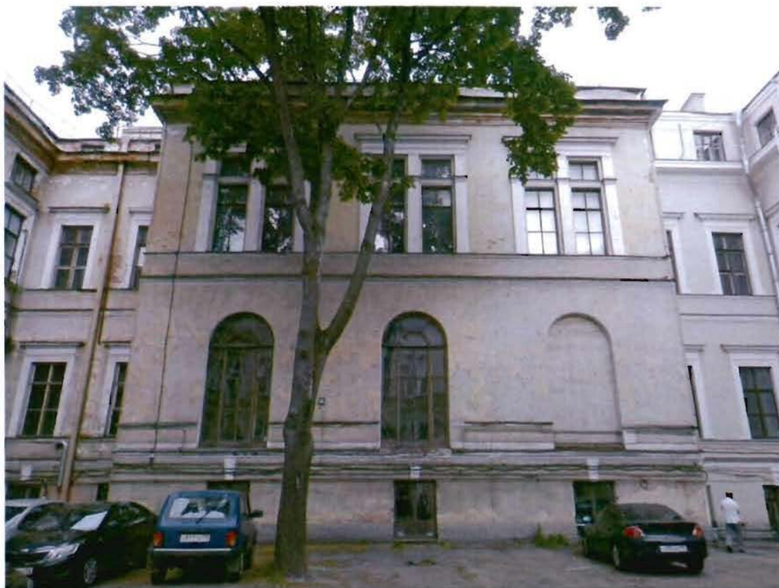
5. Восточный фасад внутреннего двора
