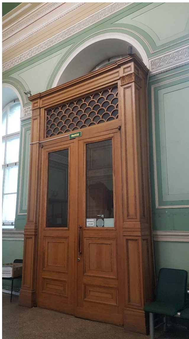
Фото 1. Вестибюль. Вид на тамбур.
