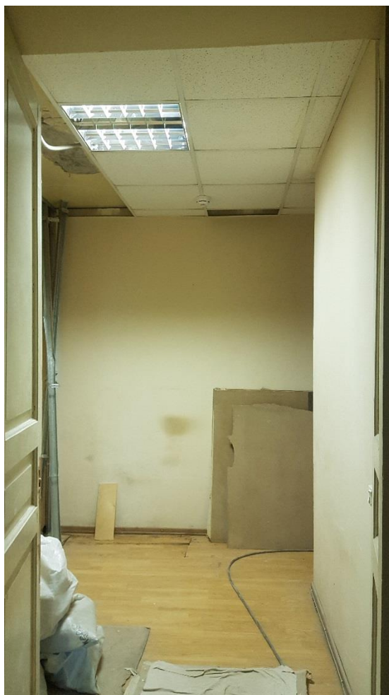
Фото 36. Пом. 171. Со стороны пом. 172.
