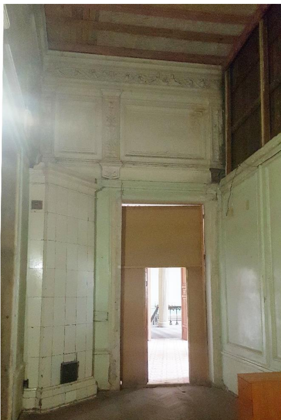
Фото 45. Пом. 122. Вид на дверь в пом.121.
