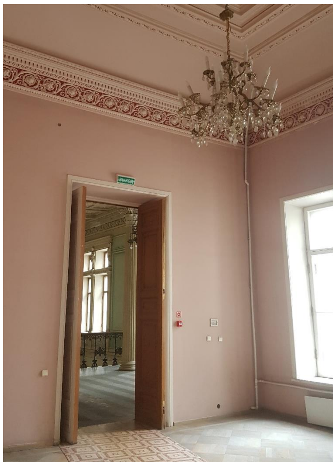
Фото 39. Пом. 121. Вид на окно и дверь в парадную лестницу.
