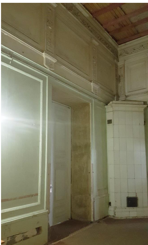
Фото 46. Пом. 122. Вид на камин и дверь в пом.164.
