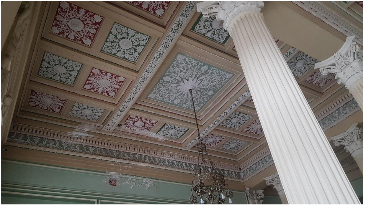
Фото 29. Парадная лестница. Вид на потолок 2-го этажа.
