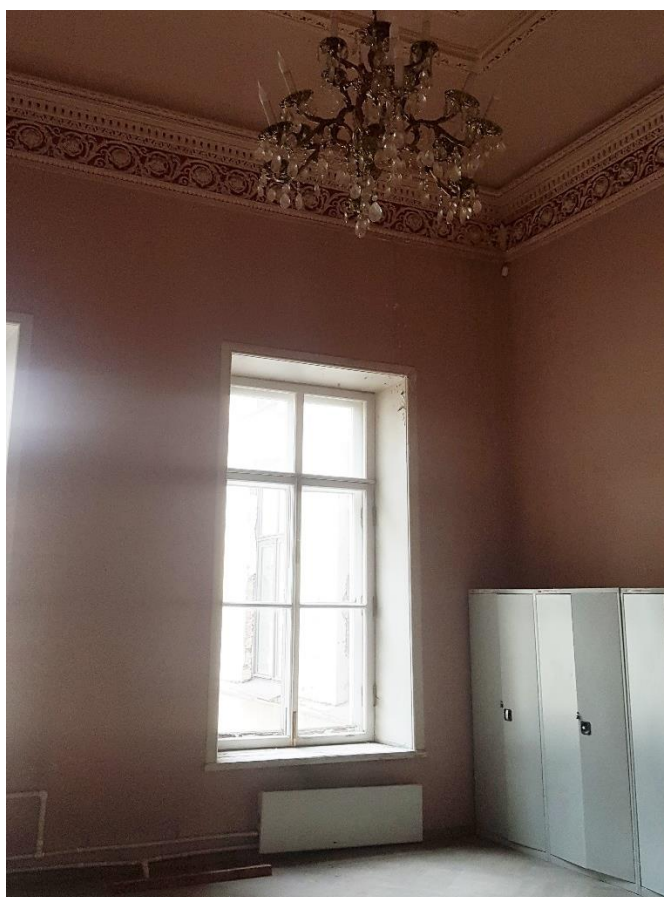
Фото 40. Пом. 121. Вид на окно.
