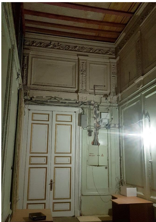
Фото 43. Пом. 122. Вид на дверь в пом.163.
