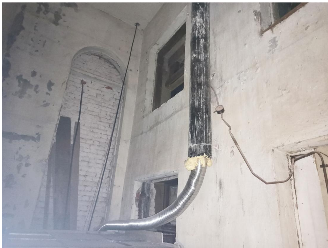
Фото 48. Пом. 141а. Вид на дверной проем.
