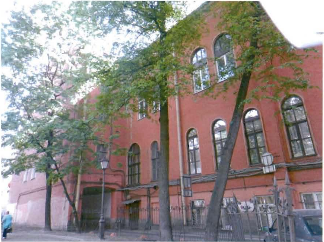
3. Фрагмент северного фасада.
