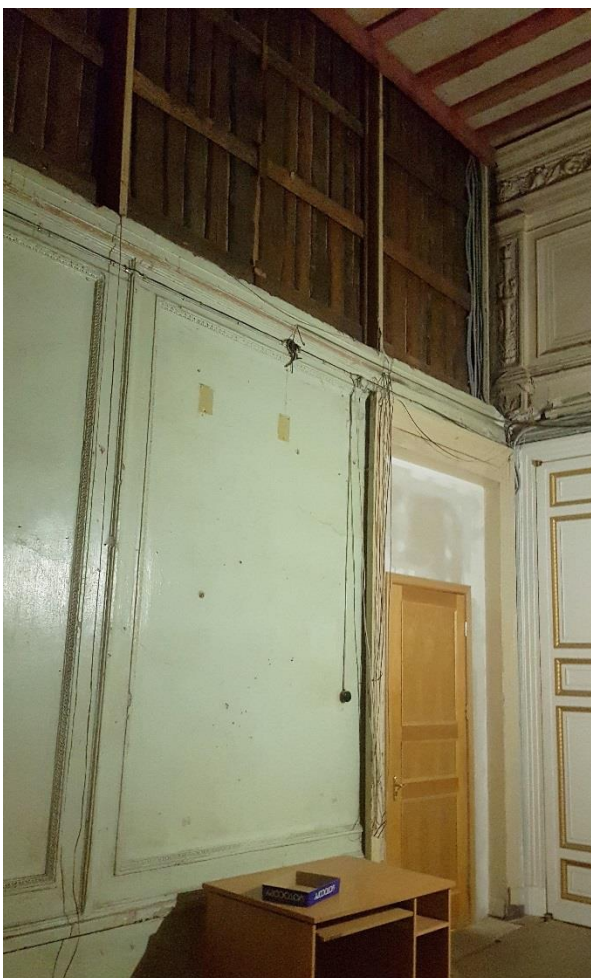
Фото 44. Пом. 122. Вид на дверь в пом.125.
