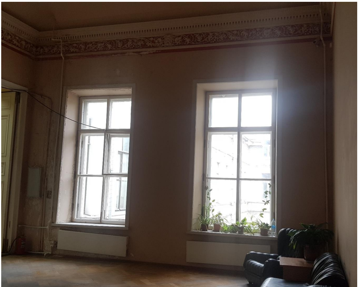
Фото 33. Пом.170. Вид на окна.
