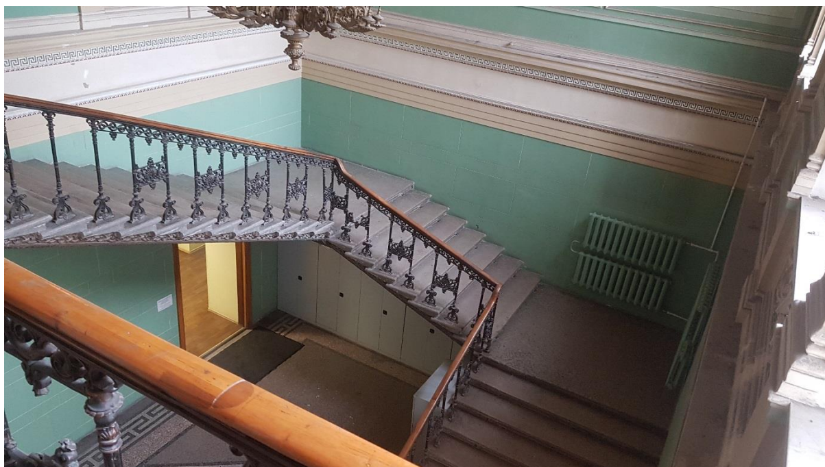
Фото 24. Парадная лестница. Вид сверху.
