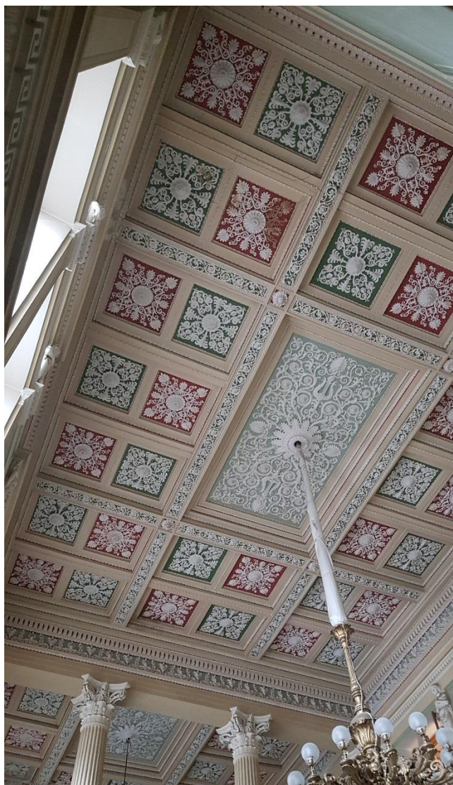
Фото 21. Л Парадная лестница. 2 эт. Потолок.
