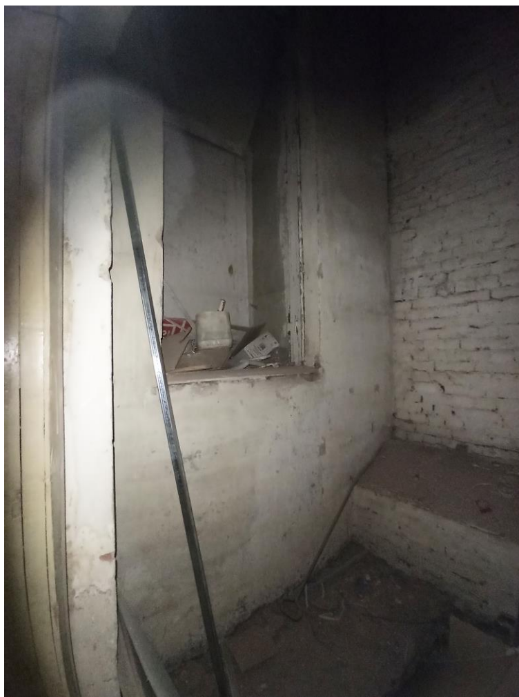
Фото 47. Пом. 141а. Вид на оконный проем.
