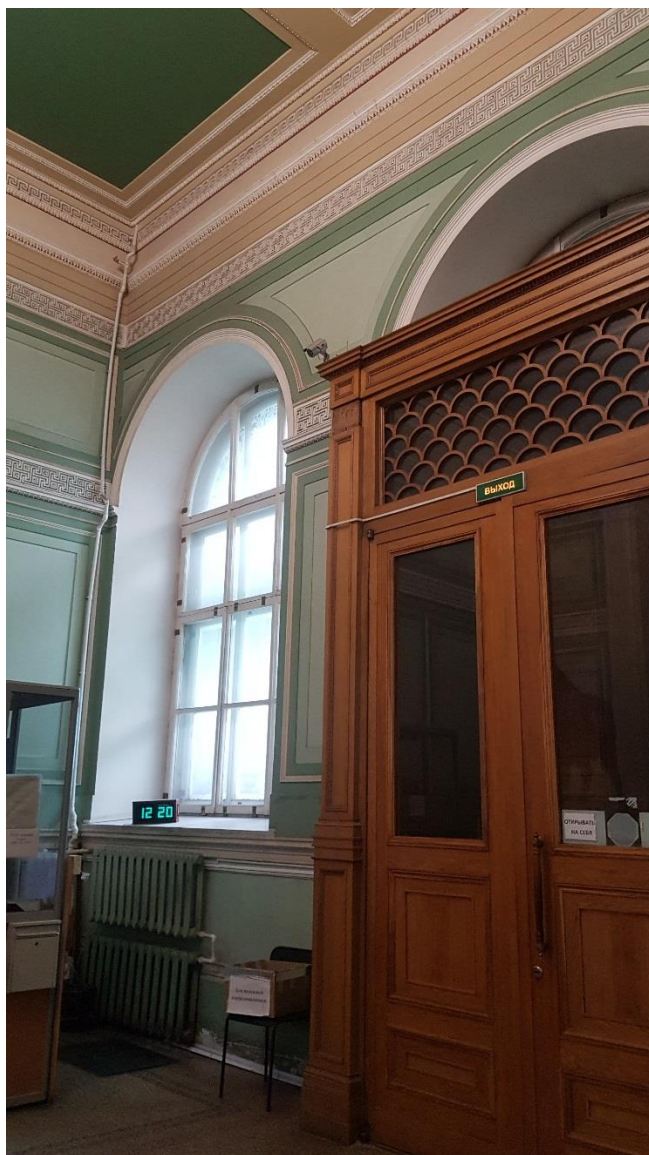
Фото 7. Вестибюль. Вид на окно, тамбур.
