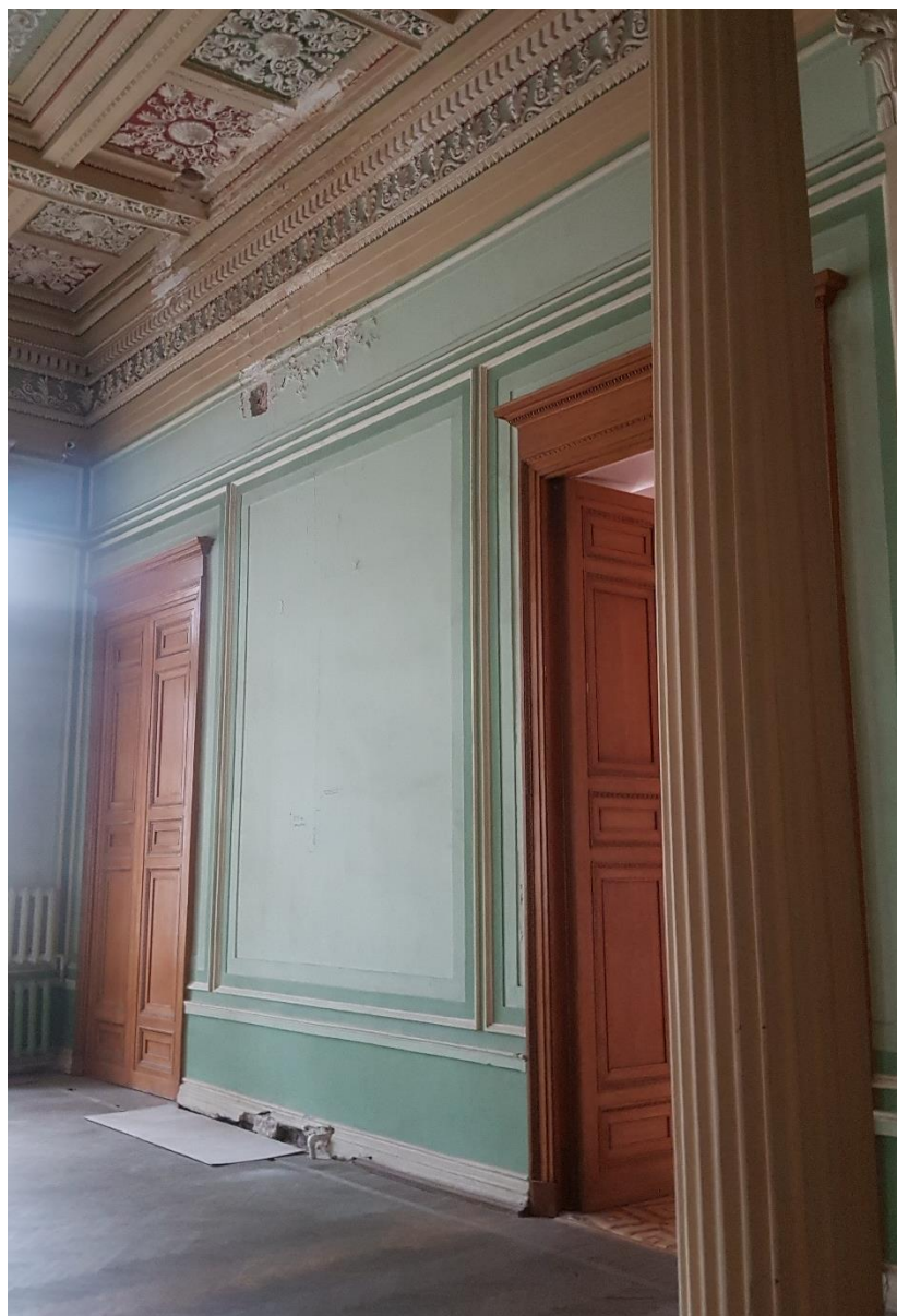
Фото 28. Пом. 120. Вид на дверь в пом. 121 и фальш дверь.
