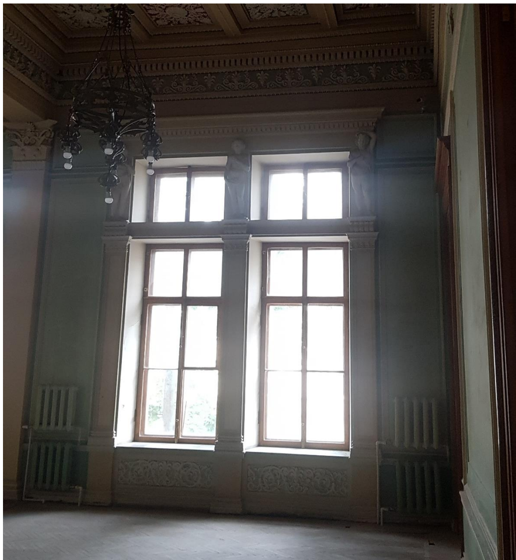
Фото 30. Пом. 120. Вид на окна
