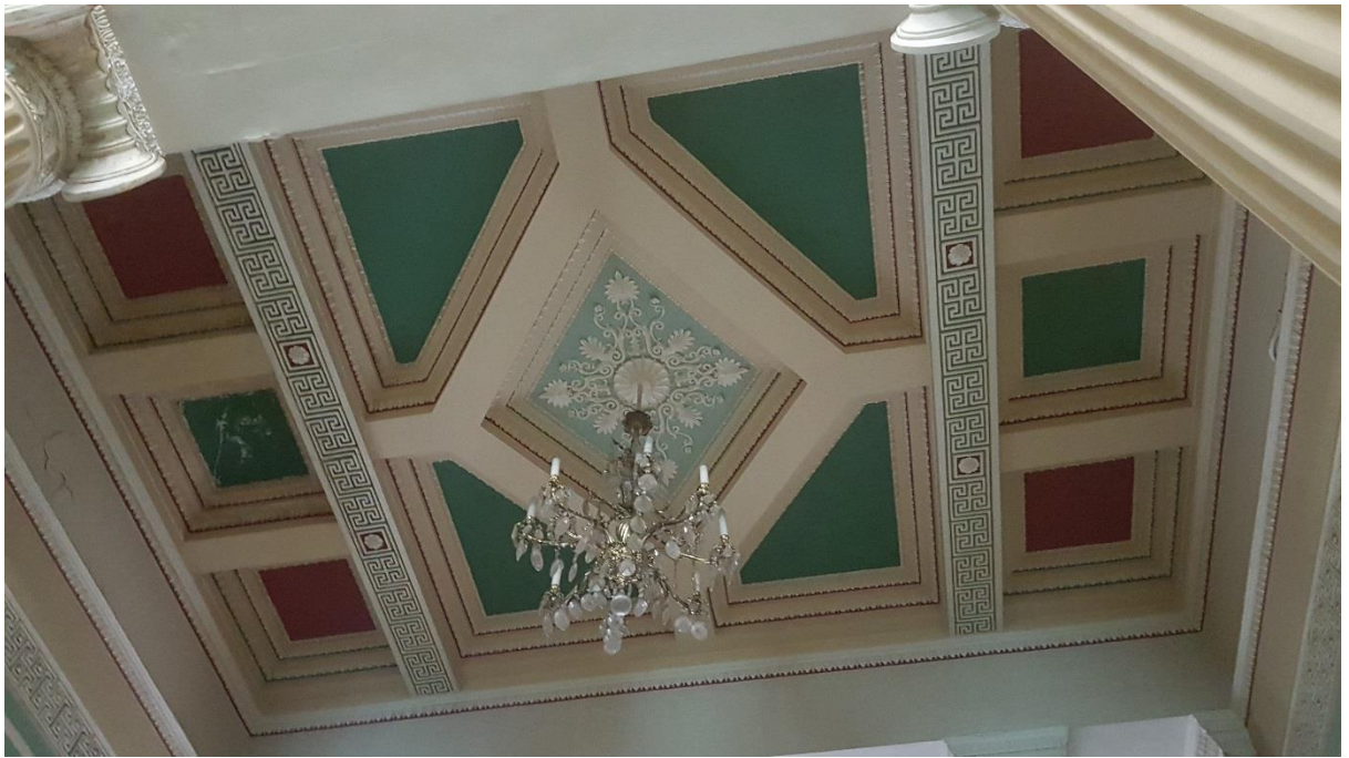
Фото 11. Потолок помещения между колоннами.
