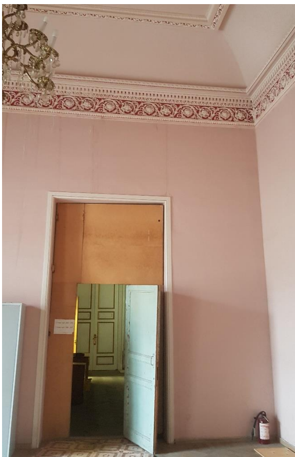
Фото 41. Пом. 121. Вид на дверь в пом. 122.
