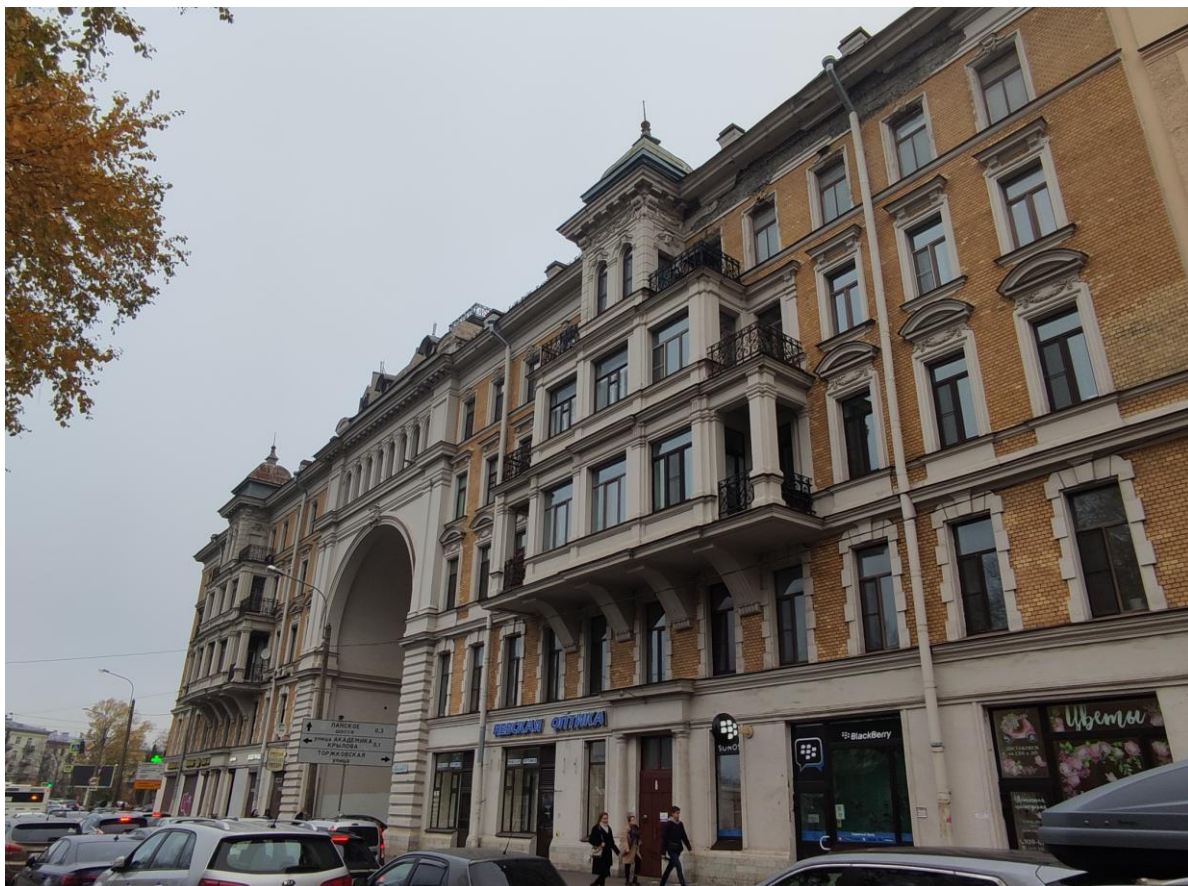
Фото 3. Фрагмент лицевого фасада объекта культурного наследия регионального значения «Дом Д.И. Поршнева»
