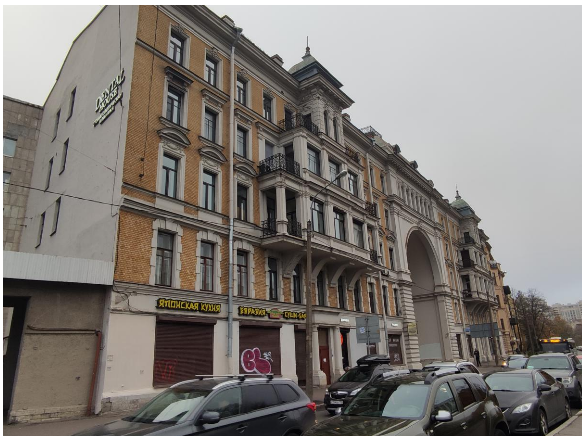
Фото 2. Фрагмент лицевого фасада объекта культурного наследия регионального значения «Дом Д.И. Поршнева»
