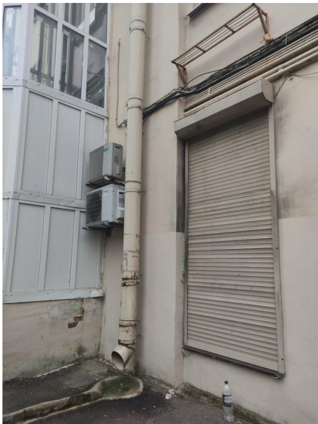
Фото 12. Фрагмент дворового фасада объекта культурного наследия регионального значения «Дом Д.И. Поршнева», оконные роллеты
