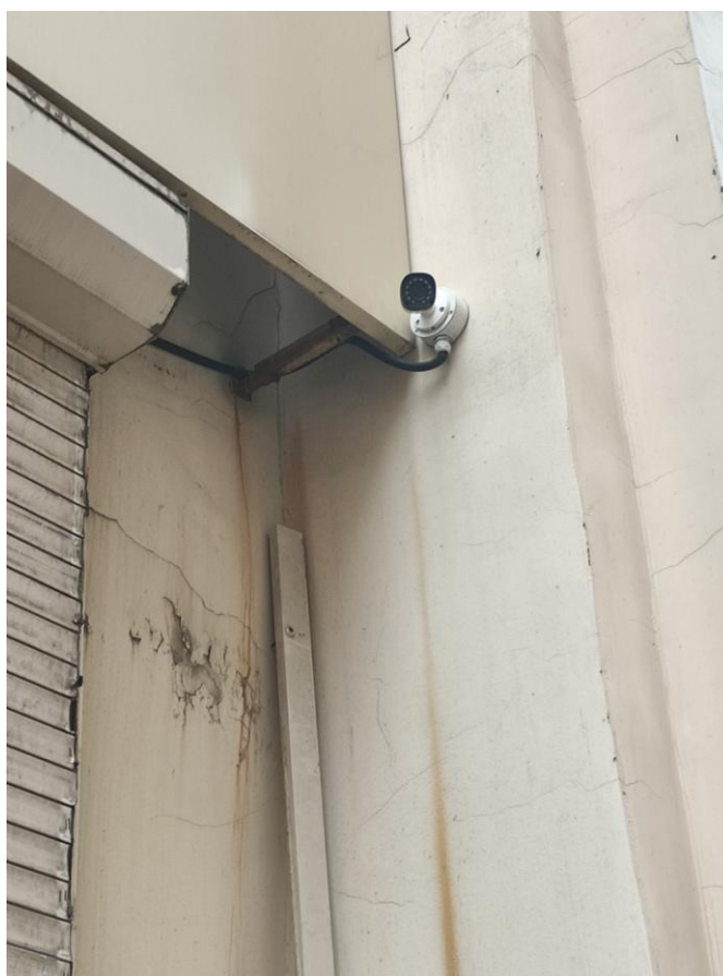
Фото 13. Фрагмент дворового фасада объекта культурного наследия регионального значения «Дом Д.И. Поршнева», элемент системы наружного видеонаблюдения
