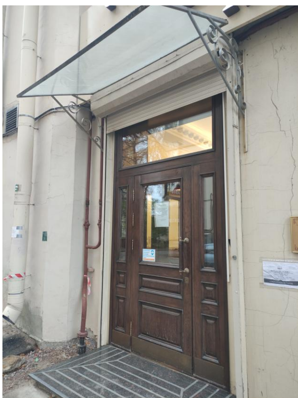
Фото 6. Фрагмент дворового фасада объекта культурного наследия регионального значения «Дом Д.И. Поршнева», входное дверное заполнение
