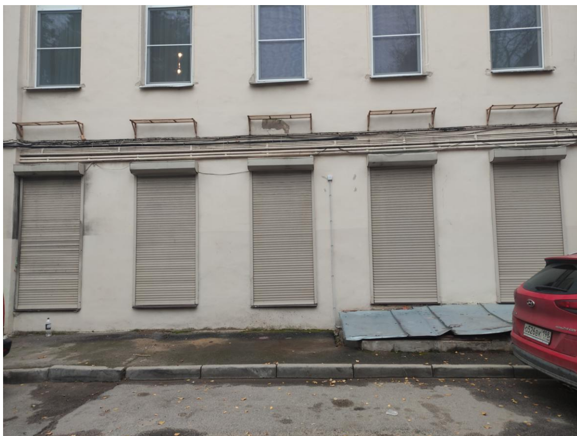
Фото 9. Фрагмент дворового фасада объекта культурного наследия регионального значения «Дом Д.И. Поршнева», оконные роллеты
