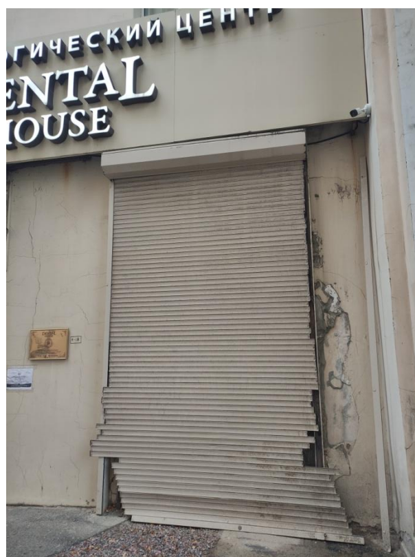
Фото 7. Фрагмент дворового фасада объекта культурного наследия регионального значения «Дом Д.И. Поршнева», роллеты
