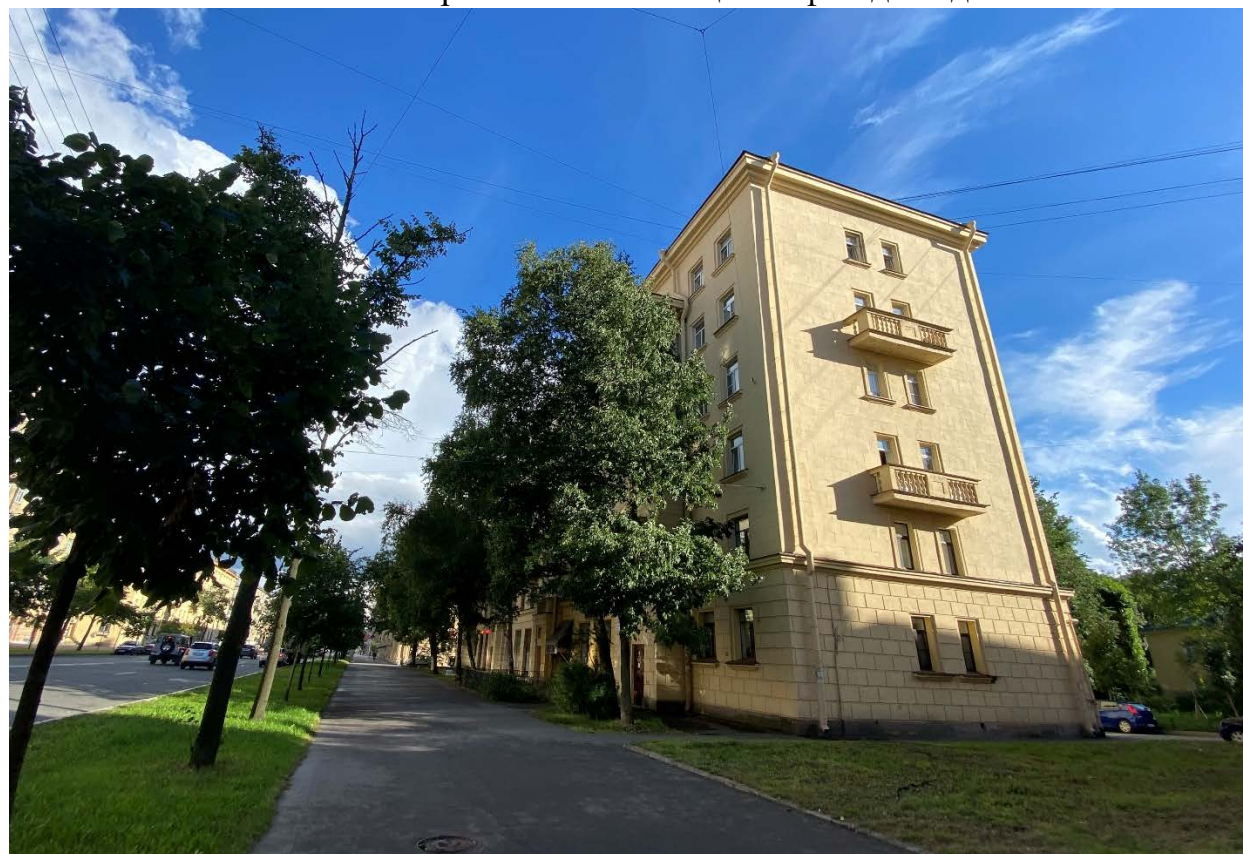
Фото 2. Общий вид с северо-запада.
