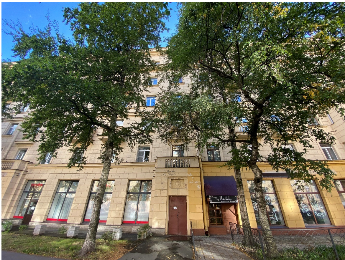
Фото 3. Восточная часть лицевого фасада. Вид с северо-востока.
