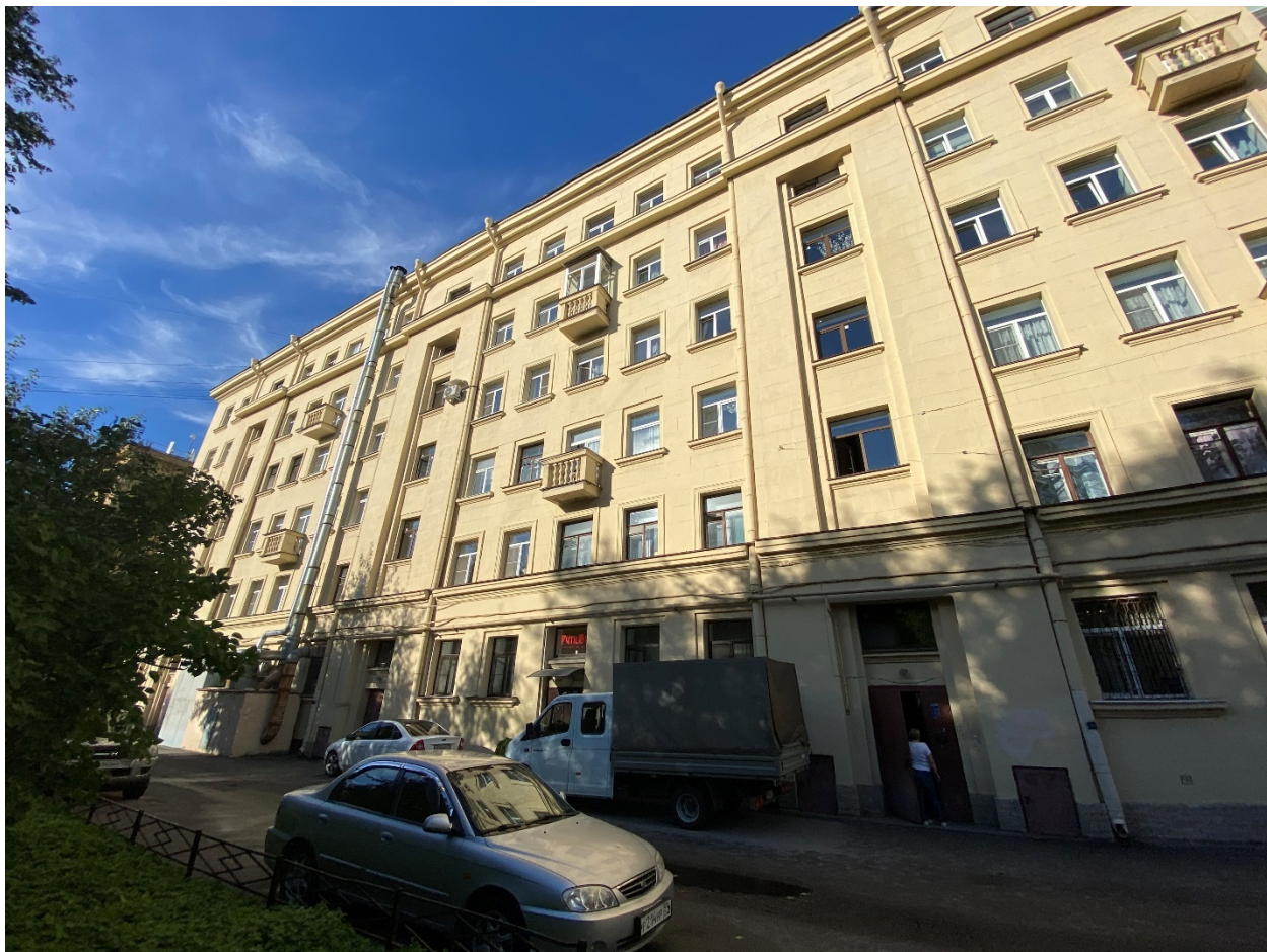
Фото 5. Восточная часть юго-западного дворового фасада. Вид с юга.
