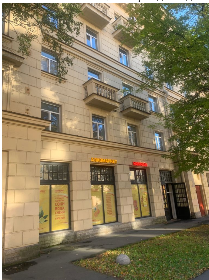
Фото 4. Восточная часть лицевого фасада. В уровне 3-го этажа расположены балконный и оконный проем кв. № 23. Вид с востока.
