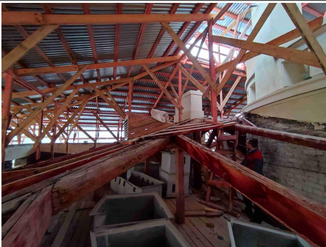
41. Вид на конструкции временной крыши установленной для ремонта исторической крыши объекта культурного наследия.
