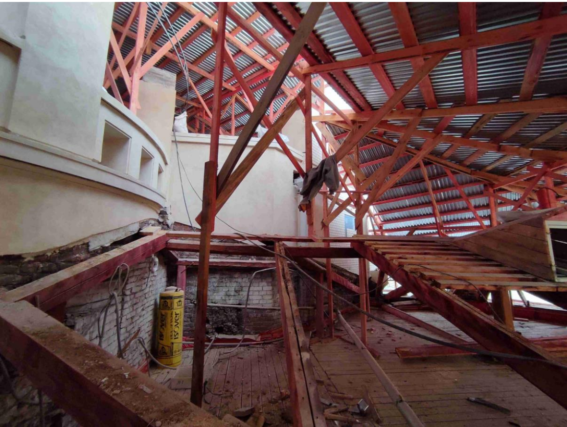
40. Фрагмент юго-западного торцевого фасада и ограждения светового фонаря.
