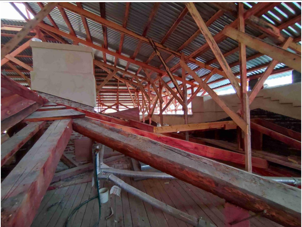
39. Вид на конструкции временной крыши установленной для ремонта исторической крыши объекта культурного наследия.
