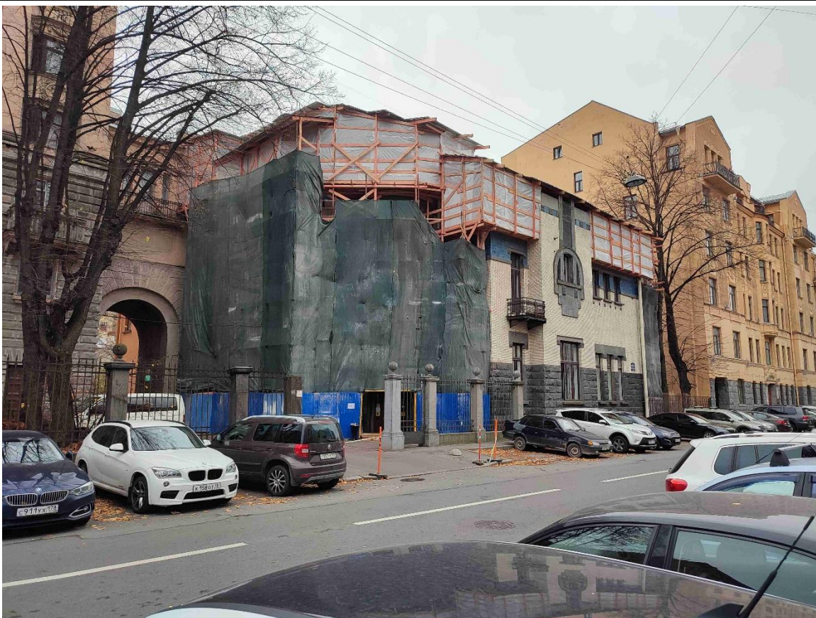
3. Общий вид северного лицевого фасада и восточного торцевого фасада объекта культурного наследия регионального значения «Особняк Чаева С.Н.».
