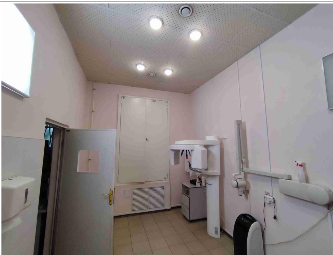
14. Общий вид пом. № 1-Н (37) в уровне 1-го этажа.
