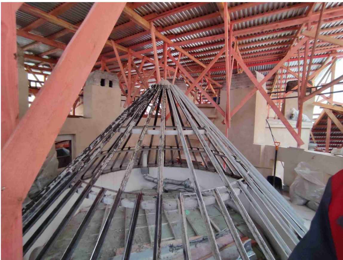
44. Вид на конструкции временной крыши установленной для ремонта исторической крыши объекта культурного наследия. Конструкция светового фонаря.
