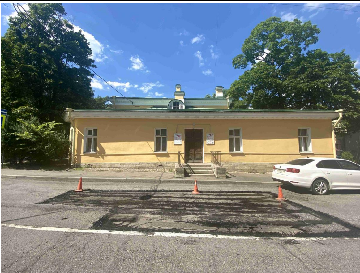
5. Общий вид юго-восточного лицевого фасада объекта культурного наследия по Церковной улице.
