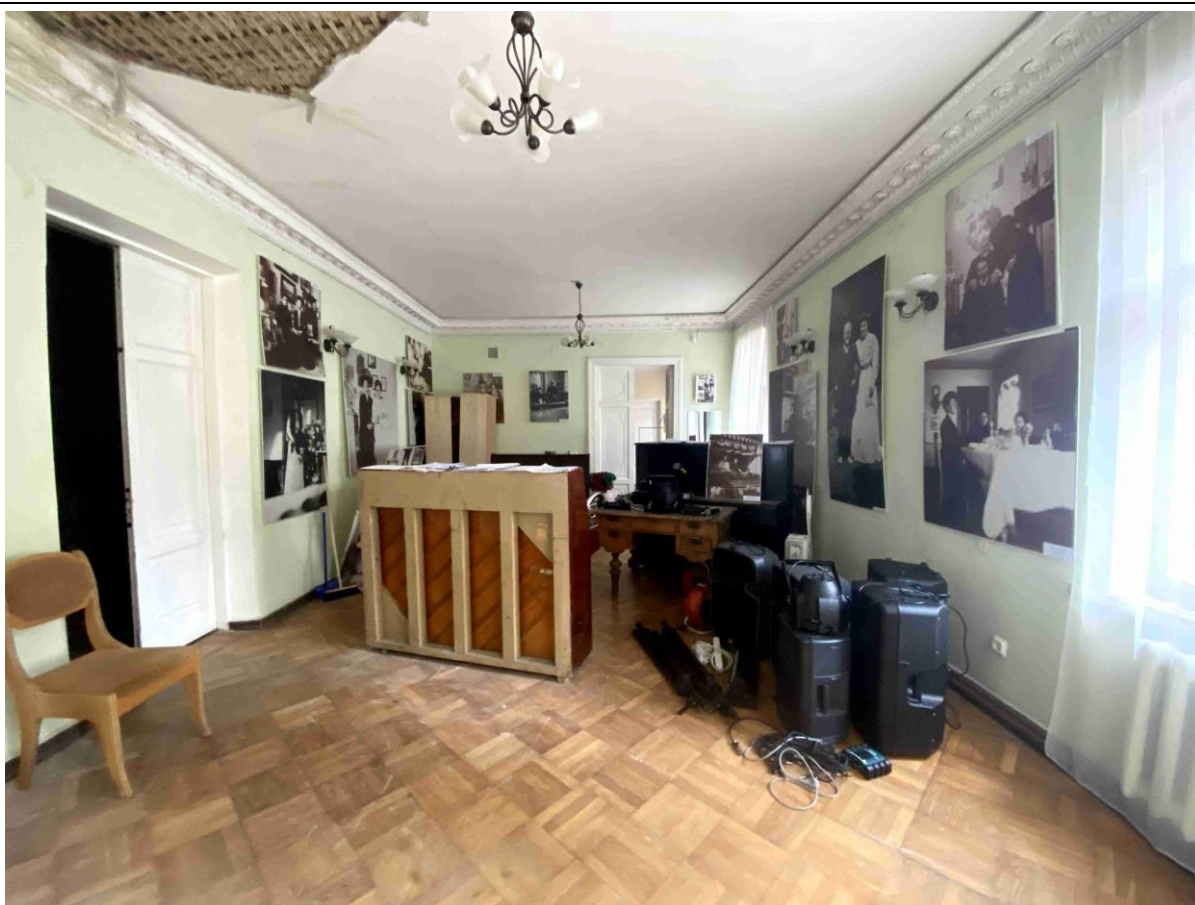
19. Общий вид пом. № 1-Н (6) в уровне 1-го этажа.
