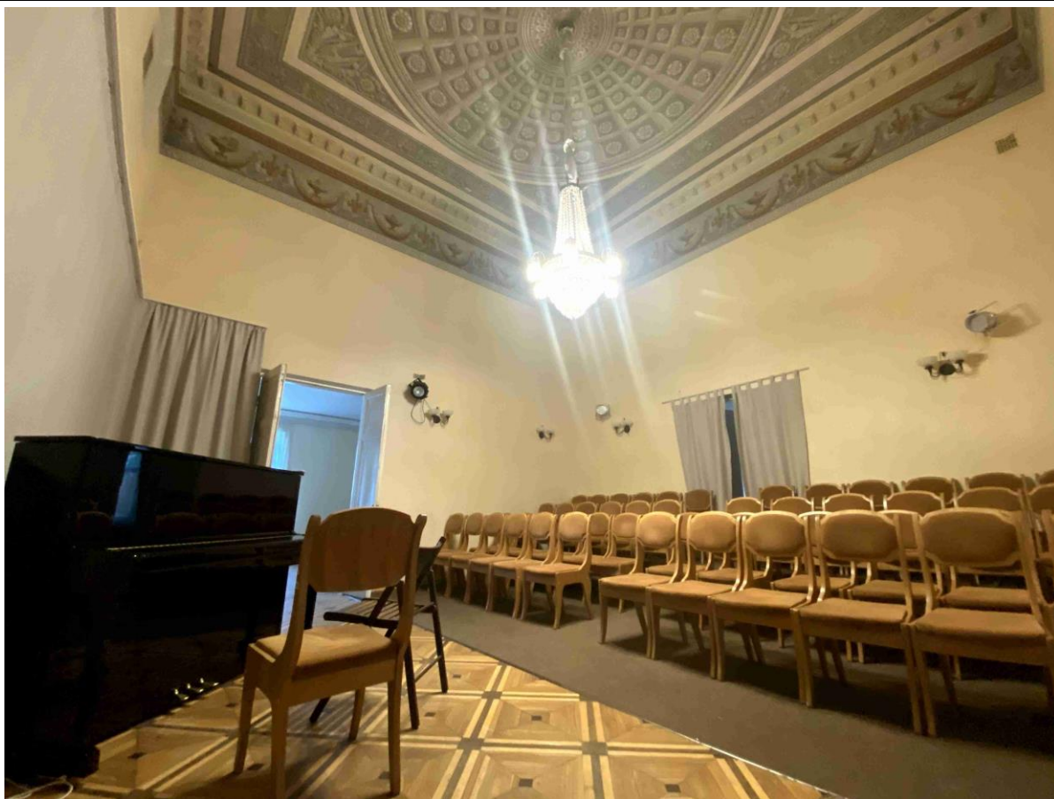
20. Общий вид пом. № 1-Н (7) в уровне 1-го этажа.
