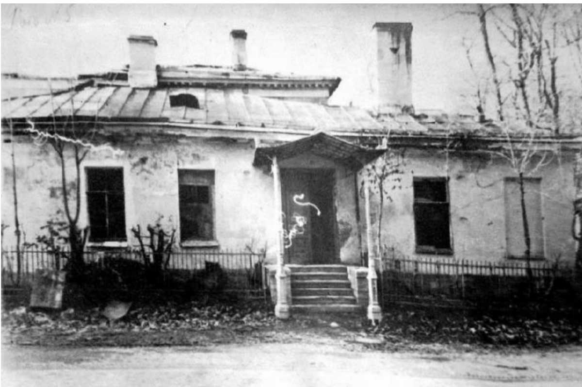
15. Фасад со стороны Церковной улицы. Фото 1947 г. КГИОП, сектор хранения документированной информации Управления организационного обеспечения и контроля.
