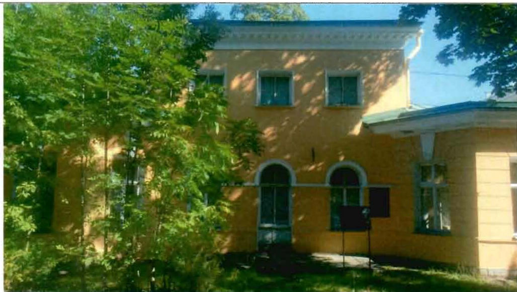
1. Фрагмент лицевого фасада
