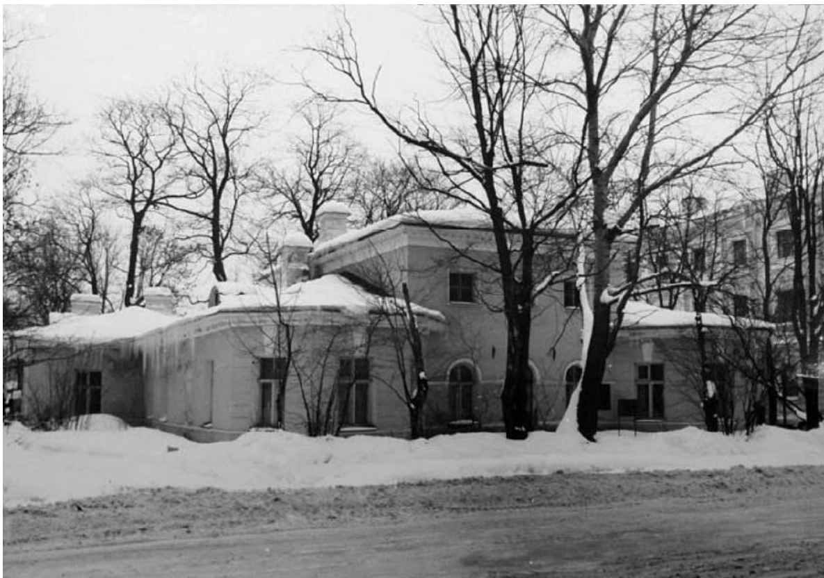
23. Дом Теппера де Фергюсона. Фасад по Средней улице. 1985 г. КГИОП, сектор хранения документированной информации Управления организационного обеспечения и контроля.
