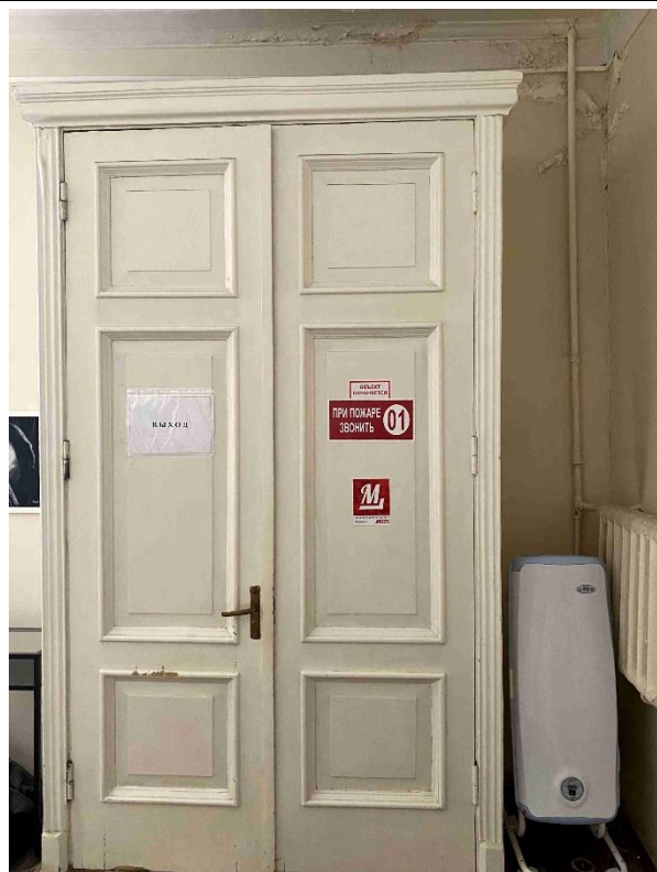
16. Общий вид тамбура в пом. 1-Н (2) в уровне 1-го этажа.
