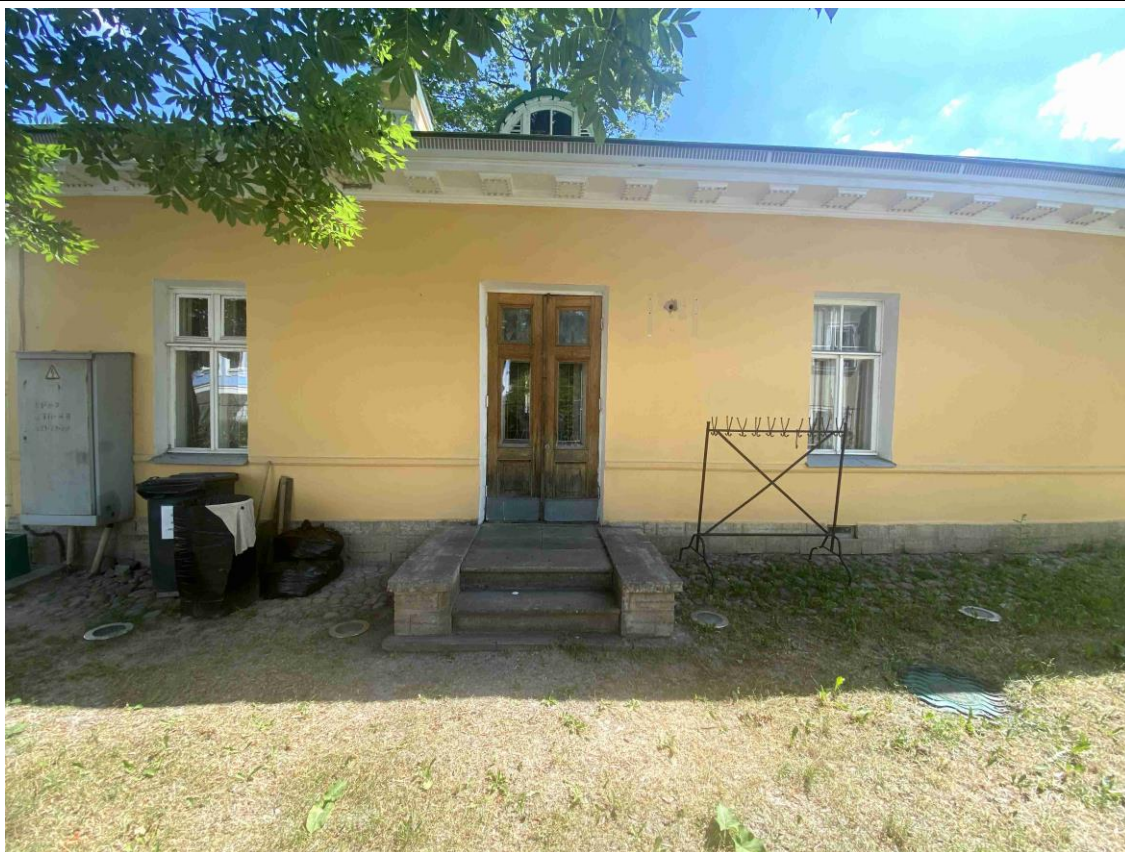
11. Фрагмент северо-западного фасада северной одноэтажной пристройки объекта культурного наследия.
