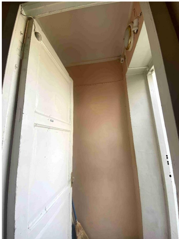
36. Фрагмент пом. № 1-Н (21) в уровне 1-го этажа.
