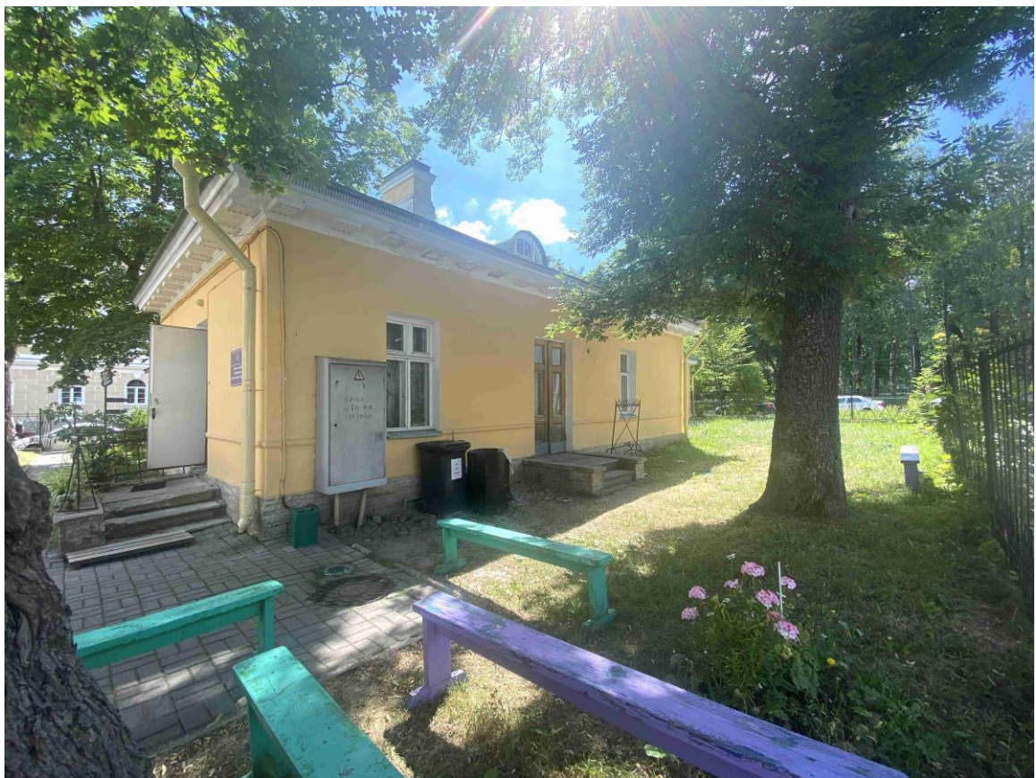
10. Общий вид северо-западного фасада северной одноэтажной пристройки объекта культурного наследия.
