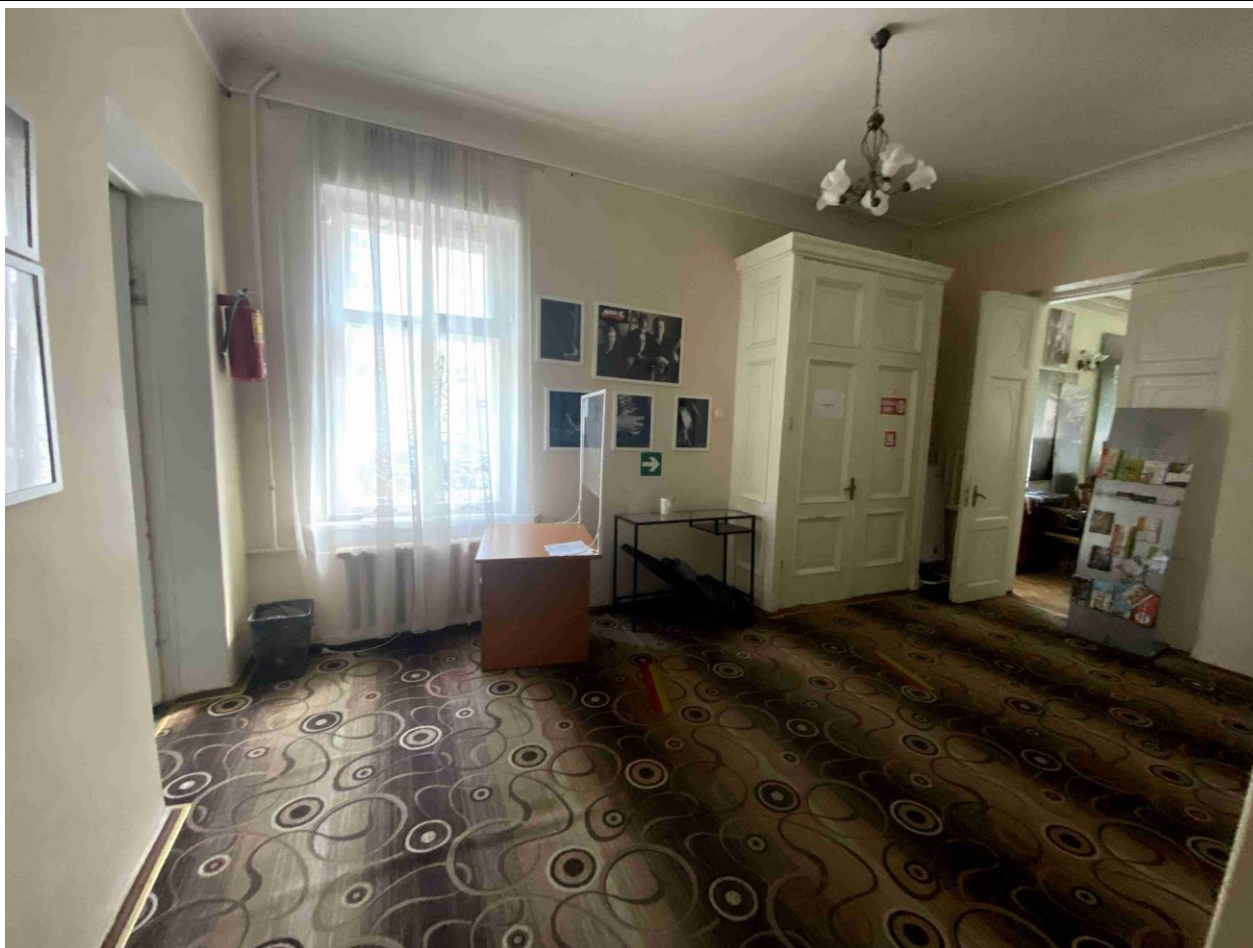
15. Общий вид пом. № 1-Н (2) в уровне 1-го этажа.
