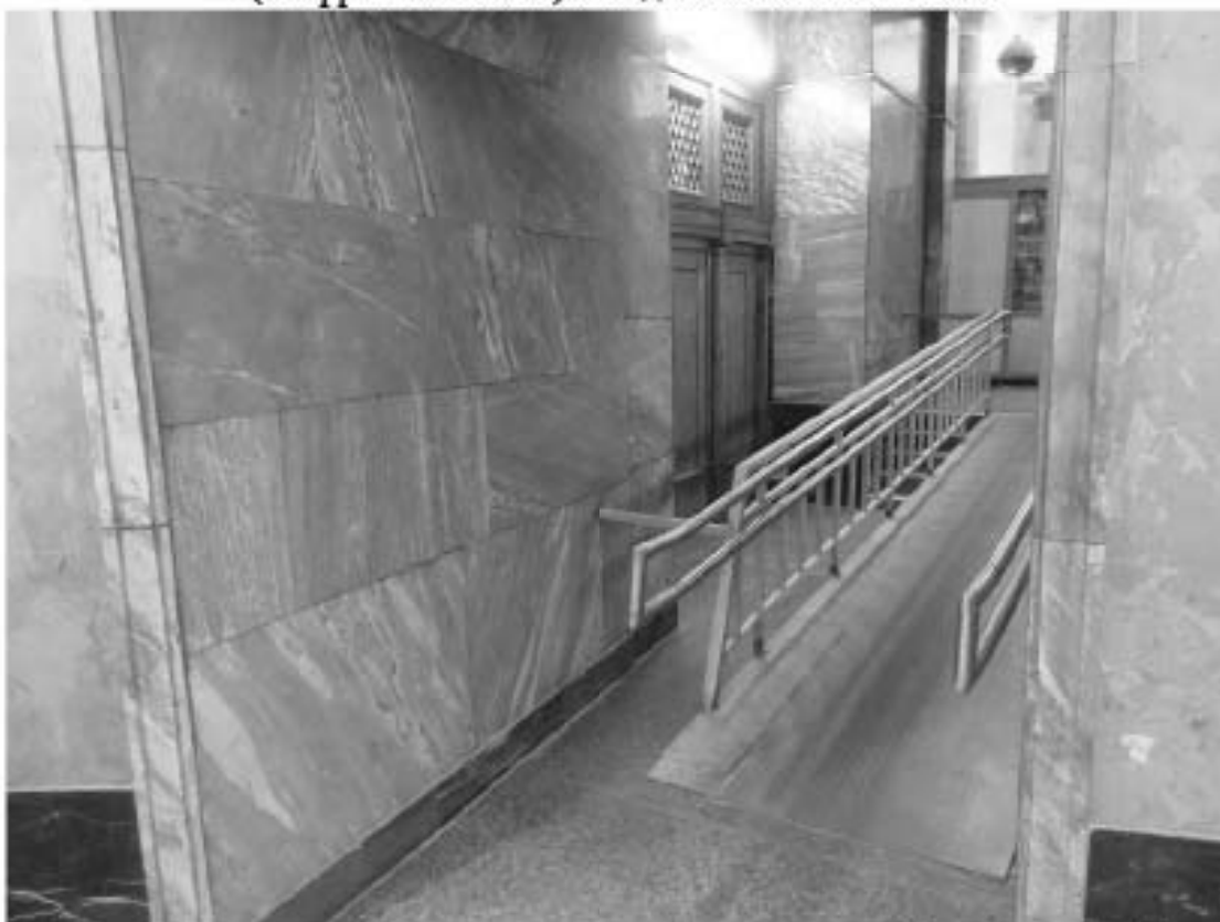
Фото 16. Объект культурного наследия регионального значения «Станция метро «Балтийская» (с перронным залом)». Вид части кассового зала.
