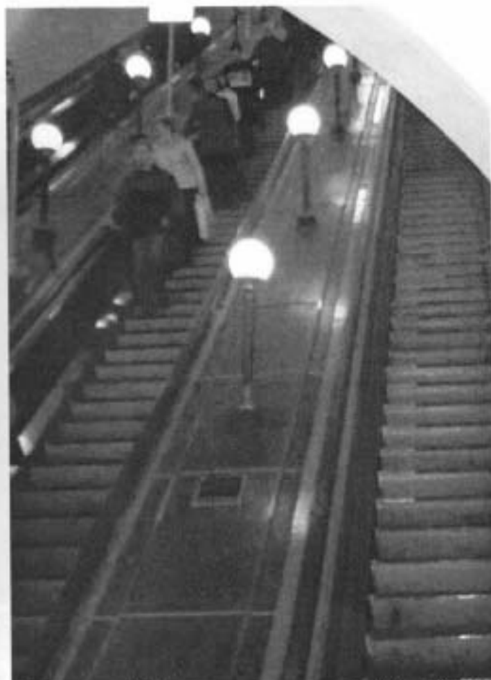
Светильник № 7, вентиляционная решетка № 8 по Описи (приложение 2 к охранному обязательству от 2 № 2 )
