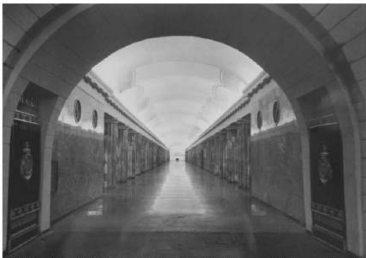
14. 1955 г. Бенуа М. К.; Кубасов А. И.; Олейник Ф. Ф.; Эшштейн С. М. Подземный вестибюль станции «Балтийская». Вид на вестибюль от центрального входа. Музей архитектуры им. А.В. Щусева.
