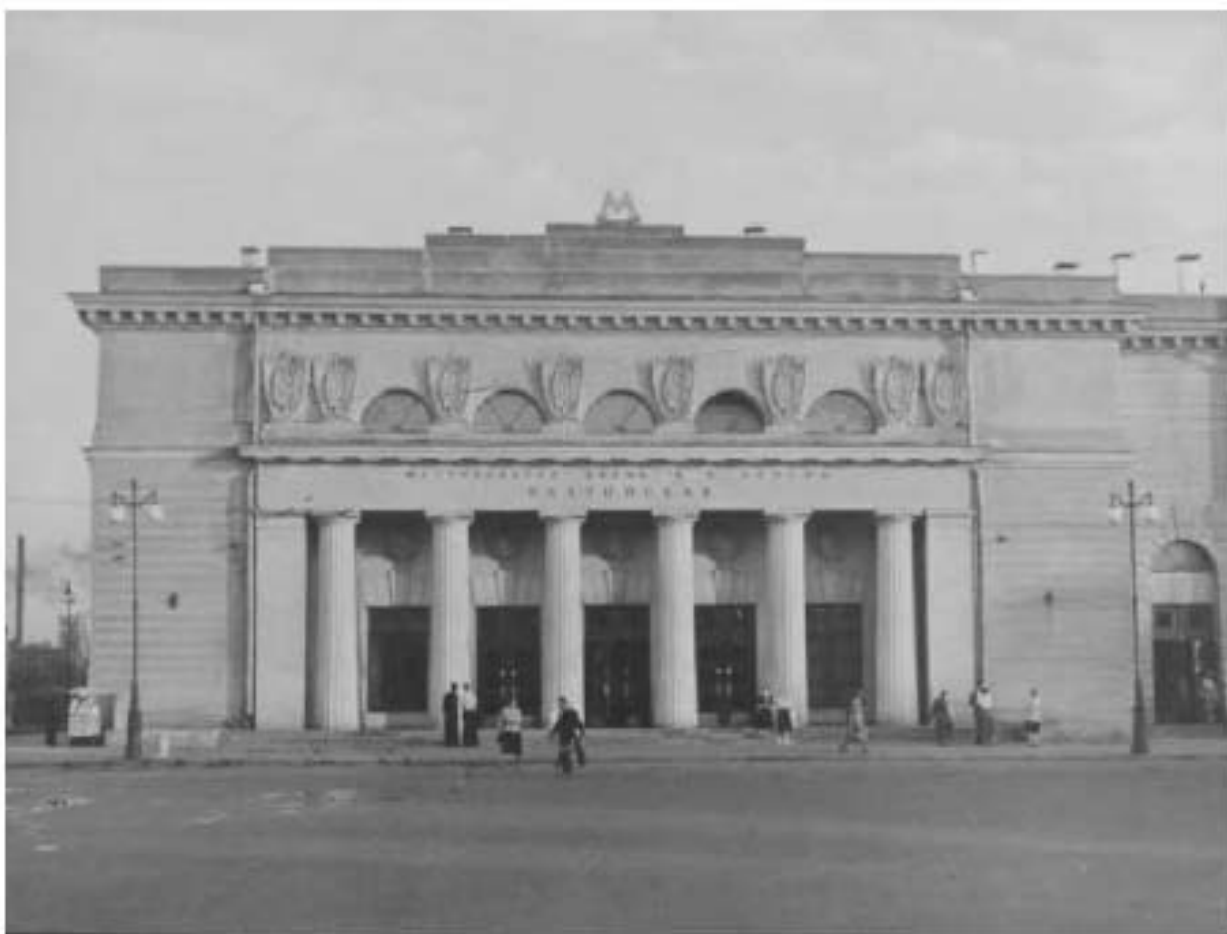
2. 1955 г. Бенуа М. К.; Кубасов А. И.; Олейник Ф. Ф.; Эпштейн С. М. Наземный вестибюль станции «Балтийская». Фасад на площадь у Балтийского вокзала. Музей архитектуры им. А.В. Щусева.
