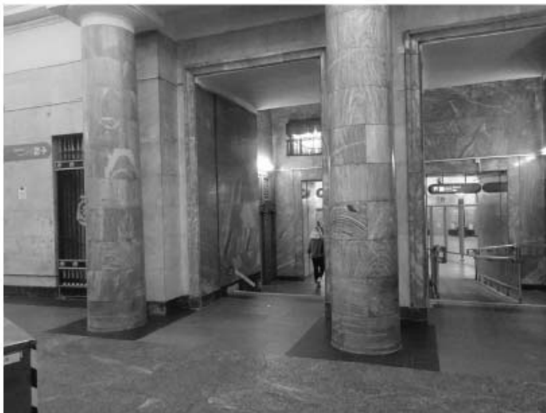
Фото 15. Объект культурного наследия регионального значения «Станция метро «Балтийская» (с перронным залом)». Вид части кассового зала.
