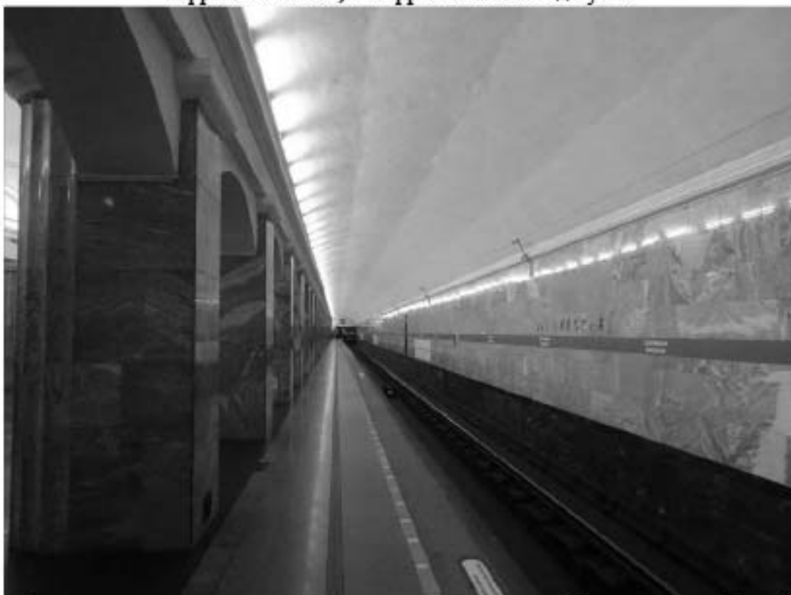
Фото 4. Объект культурного наследия регионального значения «Станция метро «Балтийская» (с перронным залом)». Перронный зал. Вид путей.
