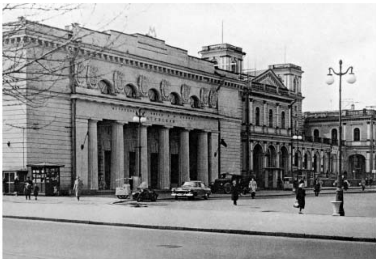
3. 1962 г. Вид здания наземного павильона станции метро «Балтийская», примыкающего к восточному флигелю Балтийского вокзала (Метрополитен Северной Столицы. – СПб, «Линки России», 1995)
