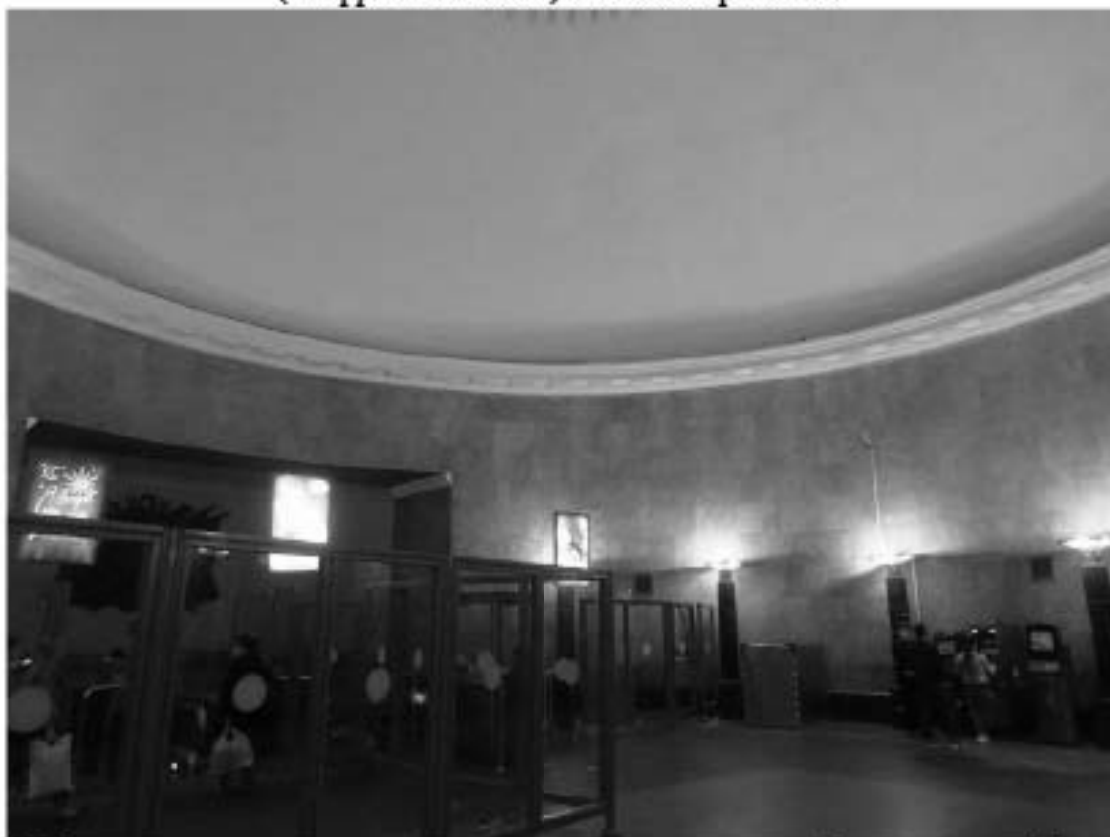
Фото 12. Объект культурного наследия регионального значения «Станция метро «Балтийская» (с перронным залом)». Эскалаторный зал.
