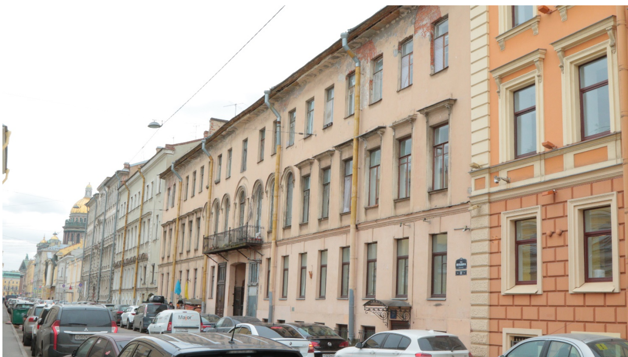
1.1. Лицевой фасад дома №. 22, лит. А. Вид с улицы Якубовича.
