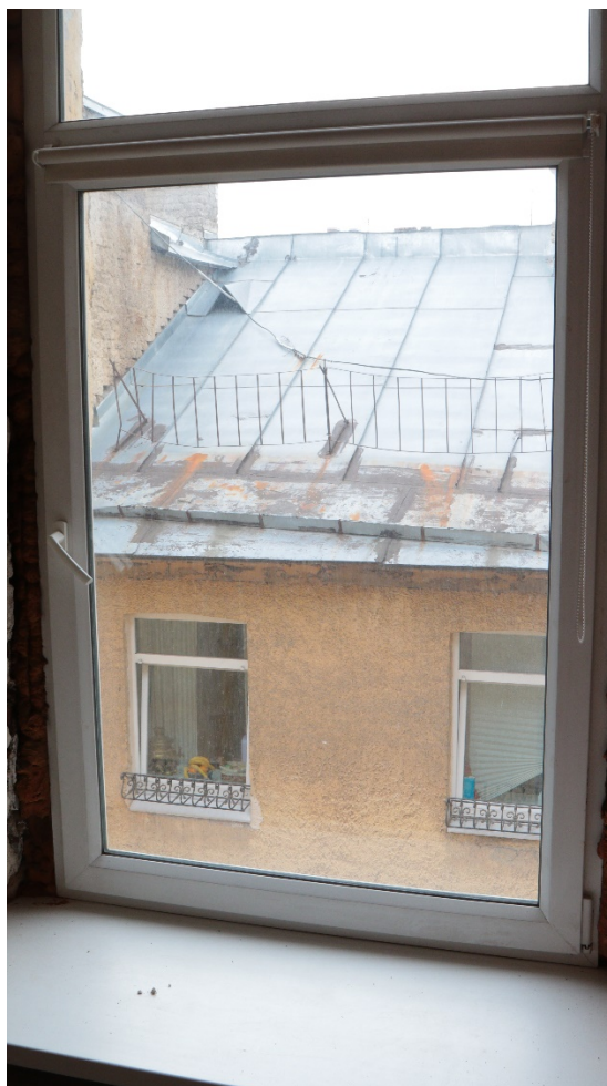
2.13. Помещение 9. Вид из окна.
