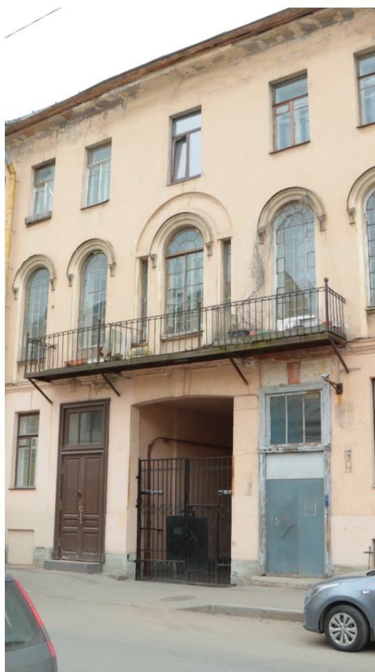
1.2. Лицевой фасад дома №. 22, лит. А. Вид с улицы Якубовича. Фрагмент.
