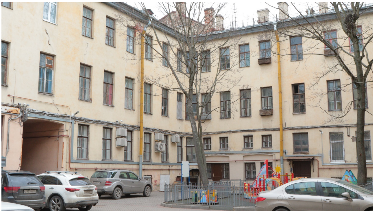
1.5. Западный и южный дворовые фасады дома №. 22, лит. А.
