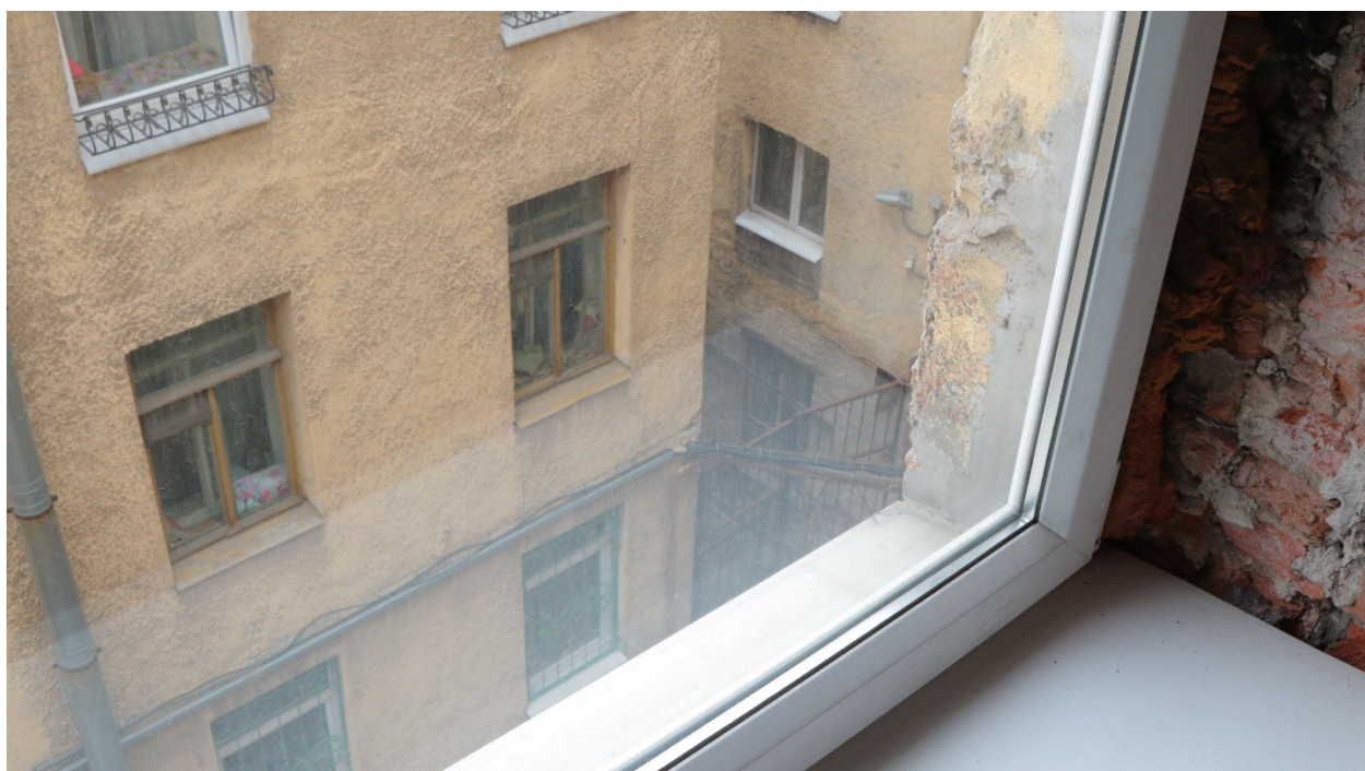
2.14. Помещение 9. Вид из окна.
