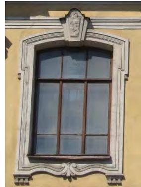
оформление оконных проемов 5-го этажа – профилированные раскрепованные штукатурные наличники, трехчастные замковые камни;
