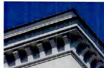
ступенчатый аттик с профилированным карнизом и надписью St PETRI в профилированной рамке, его историческое местоположение (центральная часть южного фасада), конфигурация, габариты;
