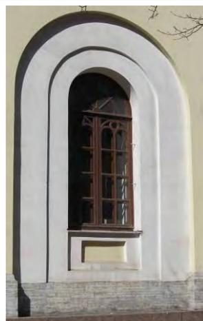
арочные ниши в профилированном обрамлении, разделенные на четыре части карнизами, оформленные в межоконных простенках оштукатуренными пилястрами, в уровне 1-4-го этажей центральной части западного и восточного фасадов;
