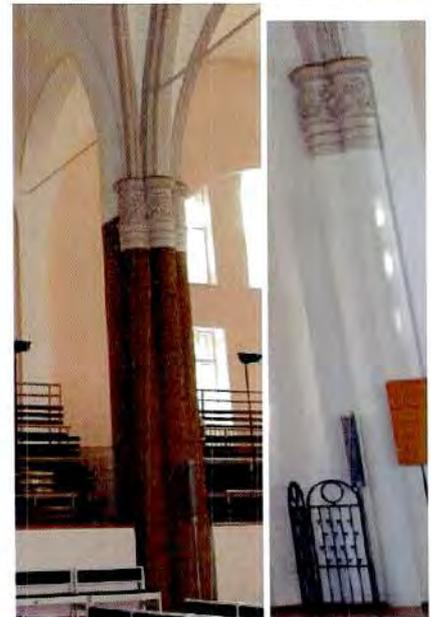
четыре гранитных пилона с гранитными приставными колонками с окрашенными стилизованными капителями, на постаментах (по три колонки у каждого пилона);
