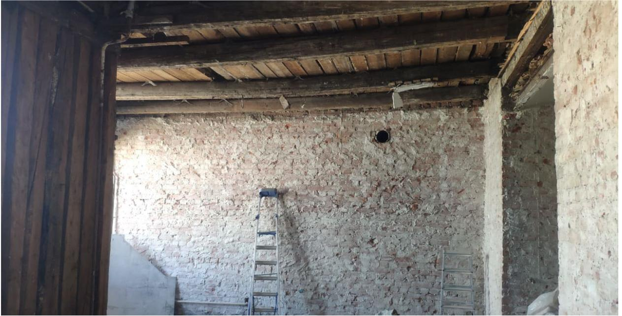
Фото № 9. Интерьер квартиры № 26. Помещение 4. Перегородки и ценные элементы архитектурно-художественной отделки отсутствуют. Проводятся противоаварийные работы.
