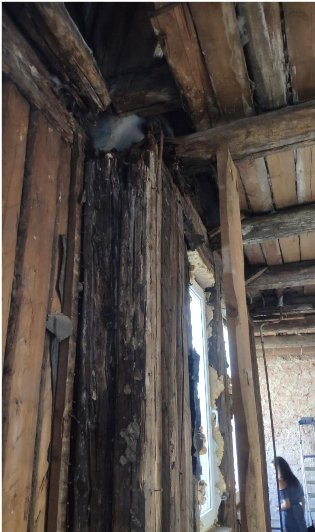
Фото № 4. Интерьер квартиры № 26. Присутствуют повреждения элементов стропильной конструкции. Элементы архитектурно-художественной отделки отсутствуют.
