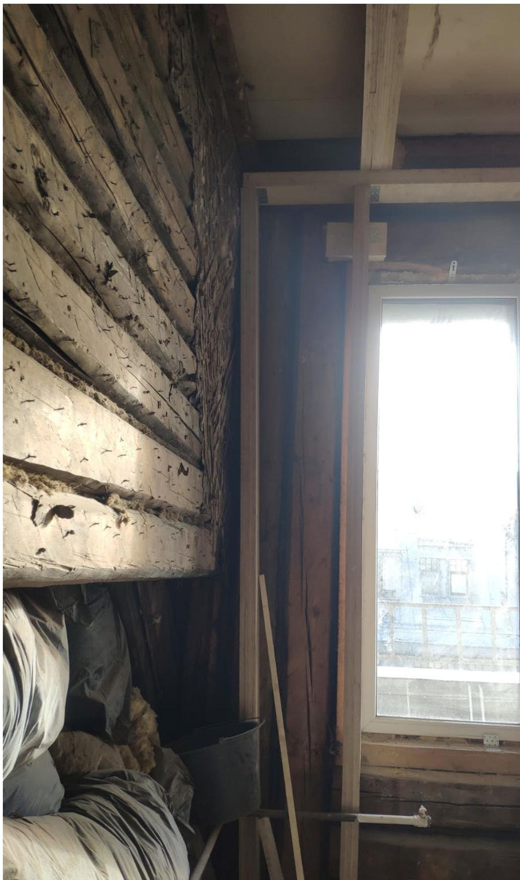
Фото № 13. Интерьер квартиры № 26. Помещение 4. Ценные элементы архитектурно-художественной отделки отсутствуют. Внутренняя обшивка стен разобрана. Проводятся противоаварийные работы.
