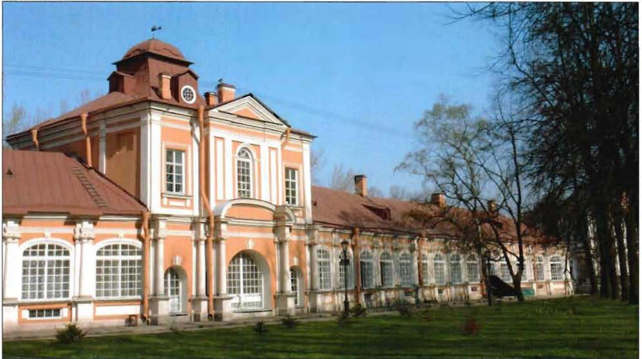
3. Южный фасад. Восточная часть.
