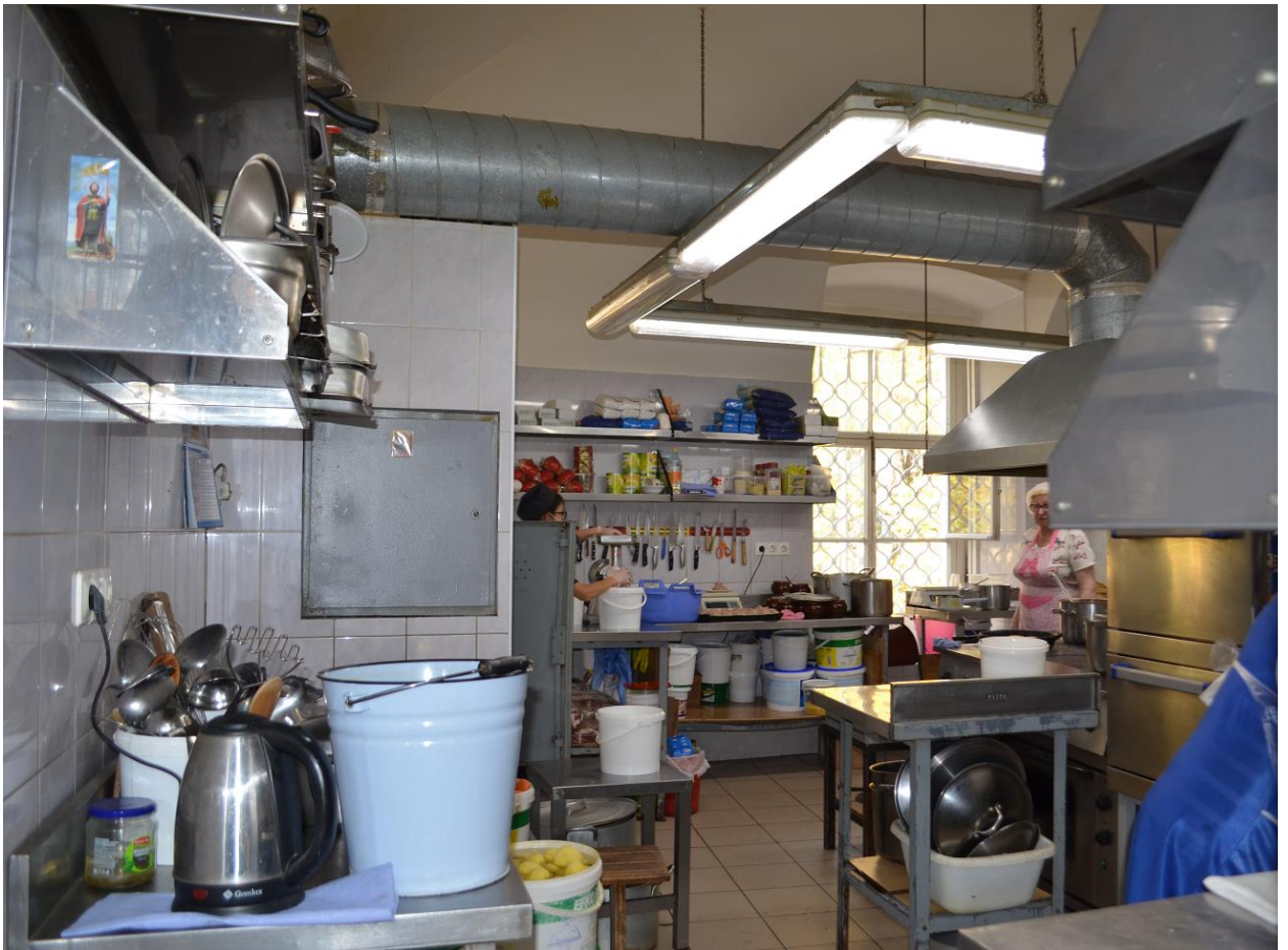
Фото 07. ОКН федерального значения «Корпус просфорный с северными воротами главного двора» (наб. реки Монастырки, дом 1, литера Г). Помещение в осях Б-Г/4-5. Съемка 27.09.2021 г.
