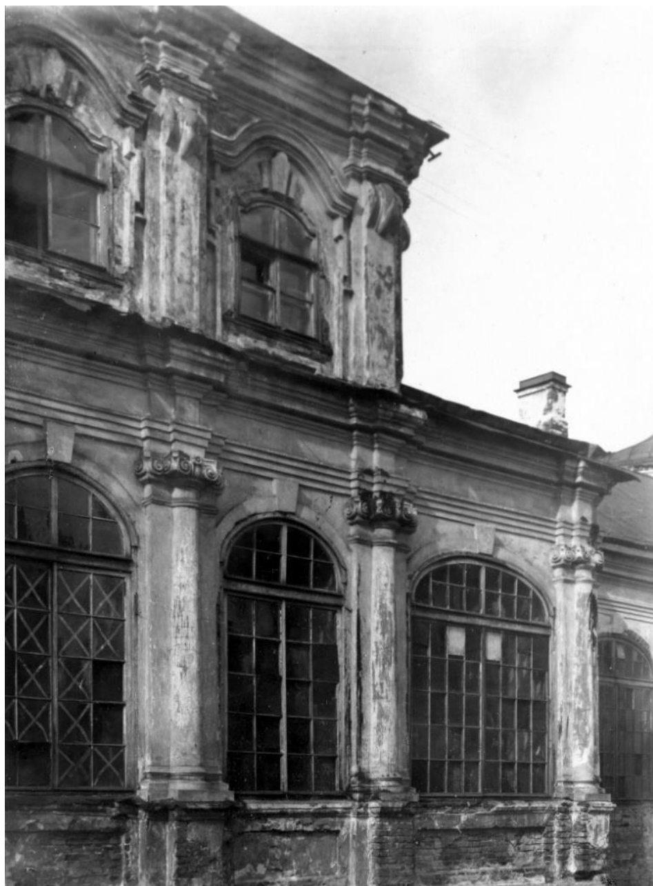
Илл. 13. Фрагмент двухэтажного флигеля Просфорного корпуса. 1940-е гг.
