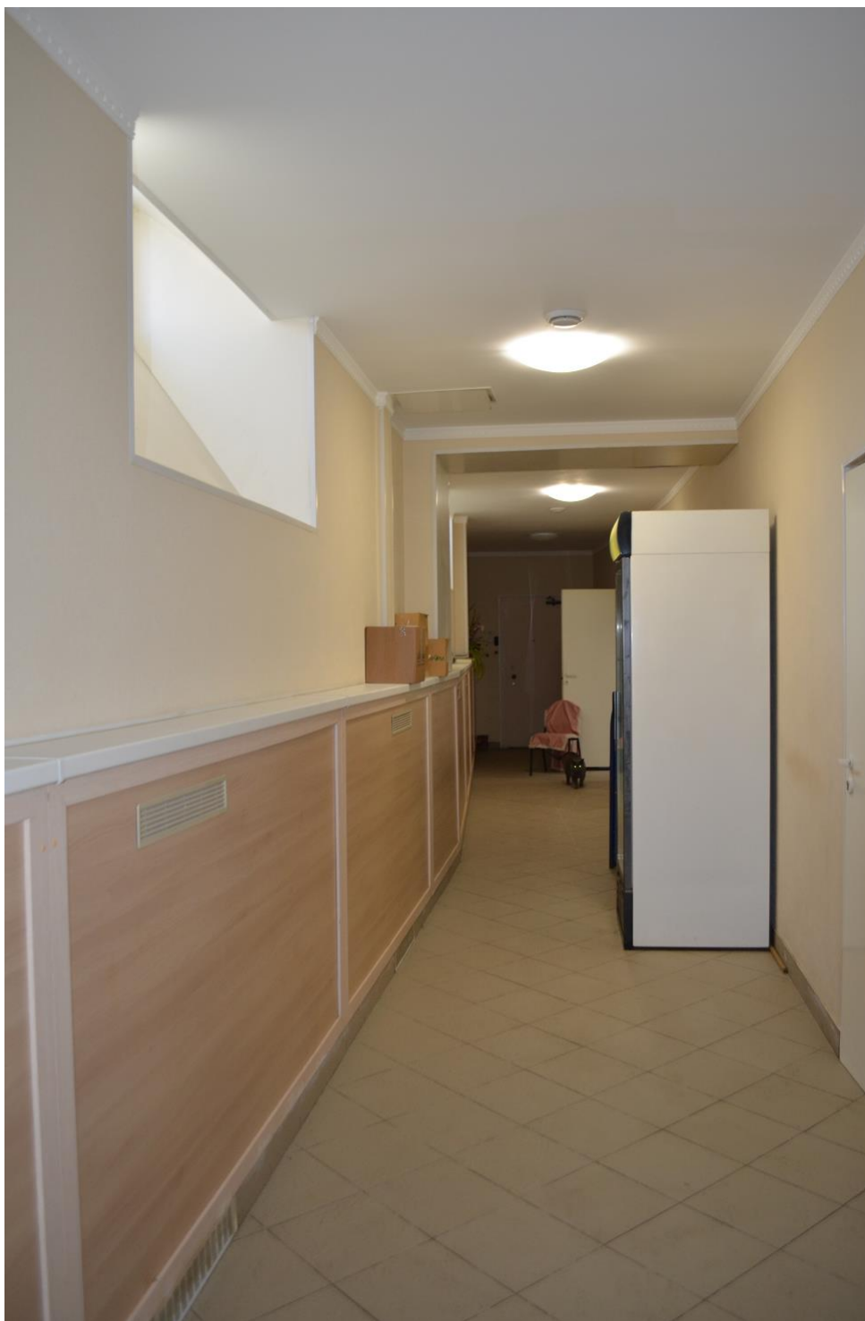
Фото 22. ОКН федерального значения «Корпус просфорный с северными воротами главного двора» (наб. реки Монастырки, дом 1, литера Г). Помещение в осях Б-Г/4-5. Съемка 27.09.2021 г.
