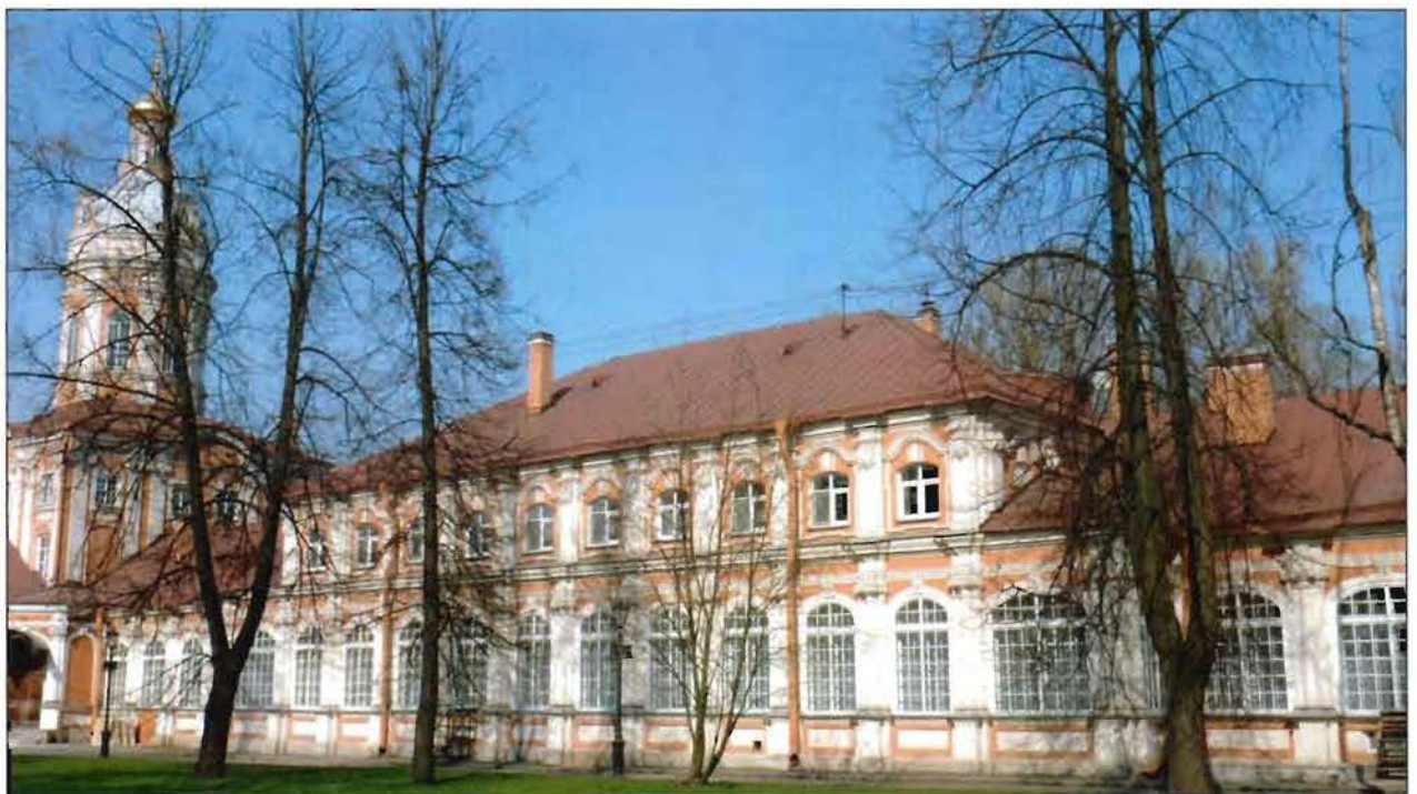
4. Южный фасад. Западная часть.
