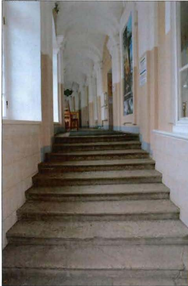
7. Галерея в уровне первого этажа.
