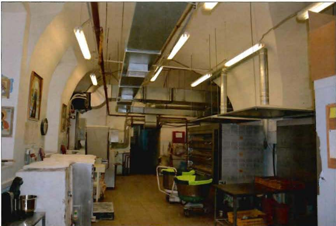
6. Сводчатые перекрытия в уровне цокольного этажа.
