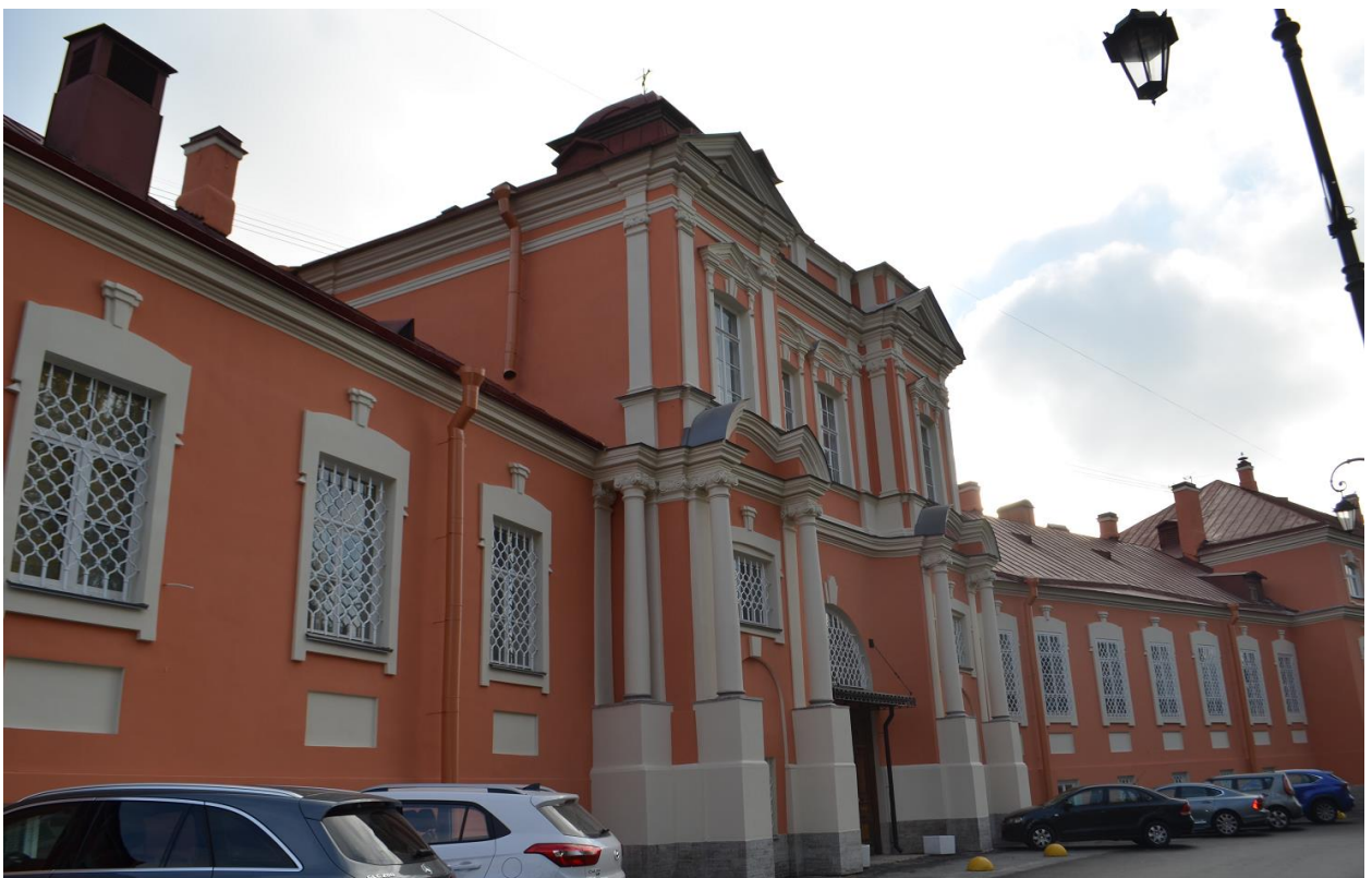
Фото 31. ОКН федерального значения «Корпус просфорный с северными воротами главного двора» (наб. реки Монастырки, дом 1, литера Г). Северный фасад. Фрагмент. Съёмка 27.09.2021 г.
