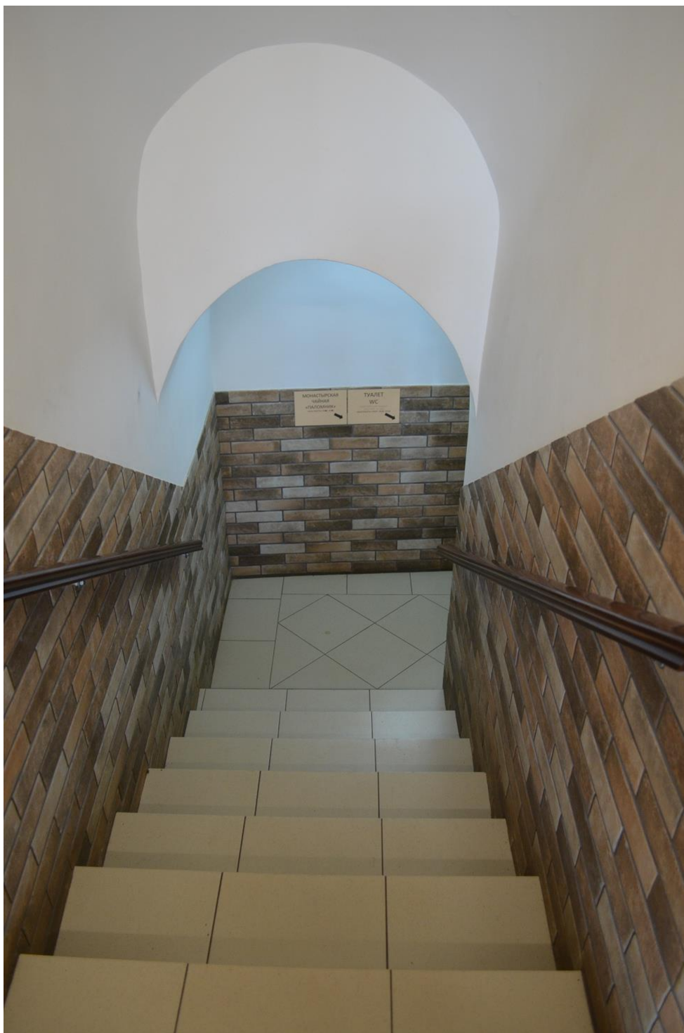
Фото 03. ОКН федерального значения «Корпус просфорный с северными воротами главного двора» (наб. реки Монастырки, дом 1, литера Г). Лестница в осях Б-Г/4-5. Съёмка 27.09.2021 г.
