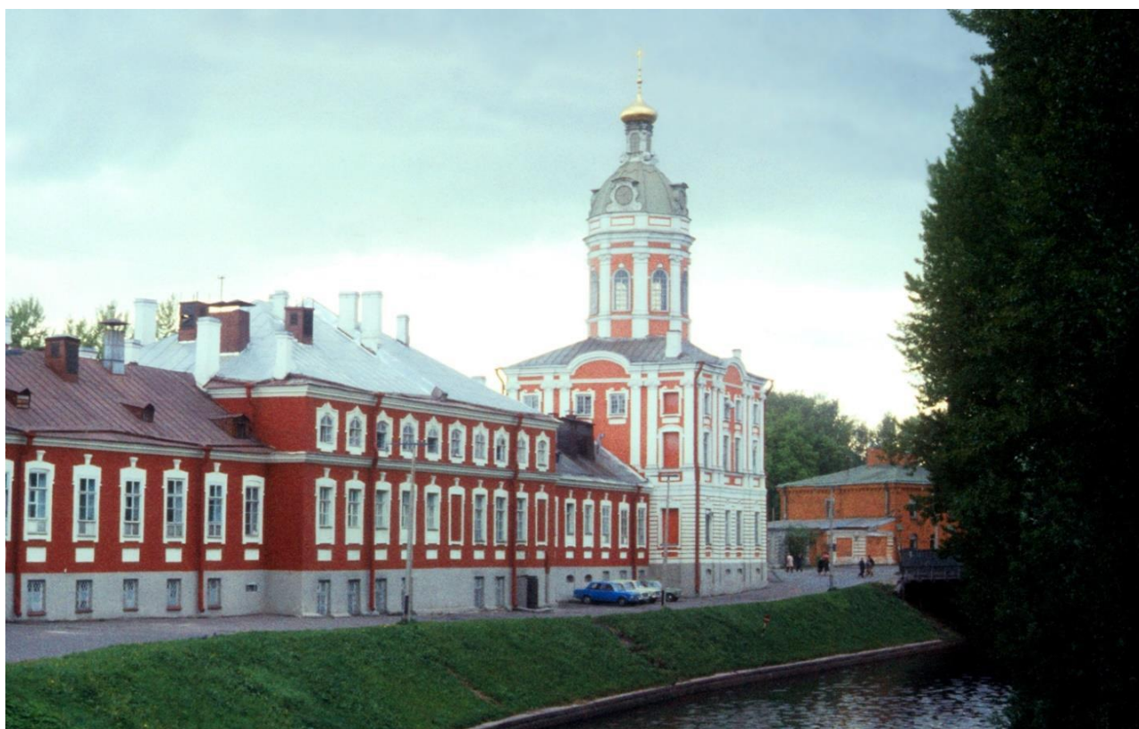
Илл.18. Просфорный корпус и Северо-Западная башня. 1977 г.
