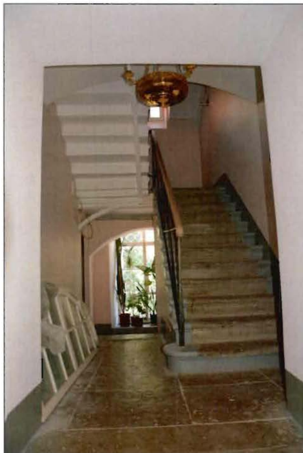
8. Лестница в северо-восточной части здания.
