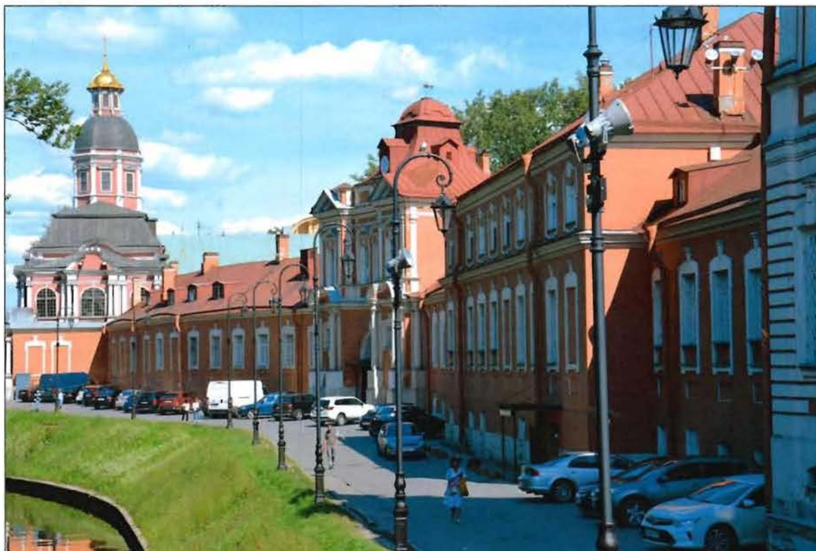
1.Общий вид с северо-запада.
