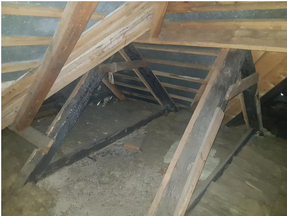
20. Объект культурного наследия регионального значения «Дача А.Н. Францена (О. Бертенсон)» по адресу: г. Санкт-Петербург, г. Зеленогорск, ул. Березовая, д. 19, лит. Д. Стропильная система. Фрагмент.
