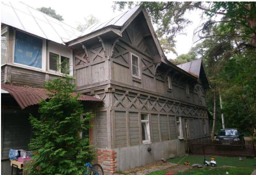
12. Объект культурного наследия регионального значения «Дача А.Н. Францена (О. Бертенсон)» по адресу: г. Санкт-Петербург, г. Зеленогорск, ул. Березовая, д. 19, лит. Д. Вид вдоль восточного фасада.
