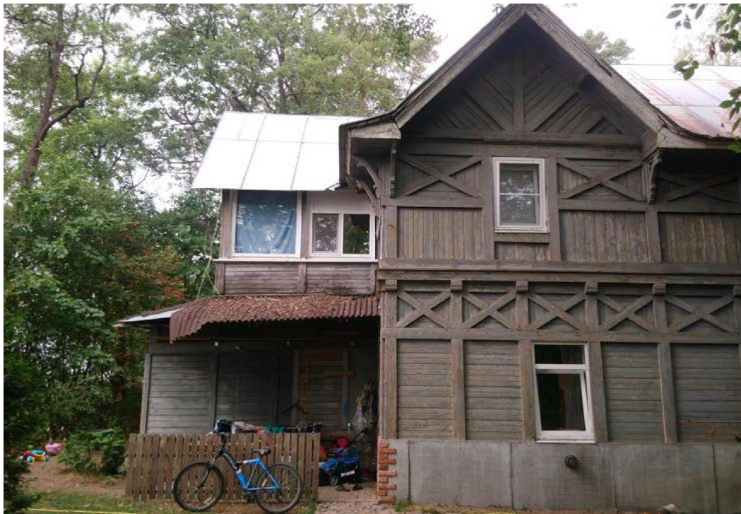
14. Объект культурного наследия регионального значения «Дача А.Н. Францена (О. Бертенсон)» по адресу: г. Санкт-Петербург, г. Зеленогорск, ул. Березовая, д. 19, лит. Д. Восточный фасад. Фрагмент. Вид на веранду первого этажа и второй этаж (мансарда).
