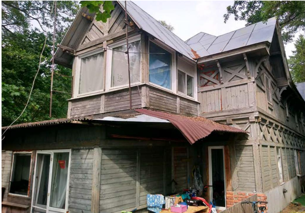
11. Объект культурного наследия регионального значения «Дача А.Н. Францена (О. Бертенсон)» по адресу: г. Санкт-Петербург, г. Зеленогорск, ул. Березовая, д. 19, лит. Д. Вид на южный фасад.
