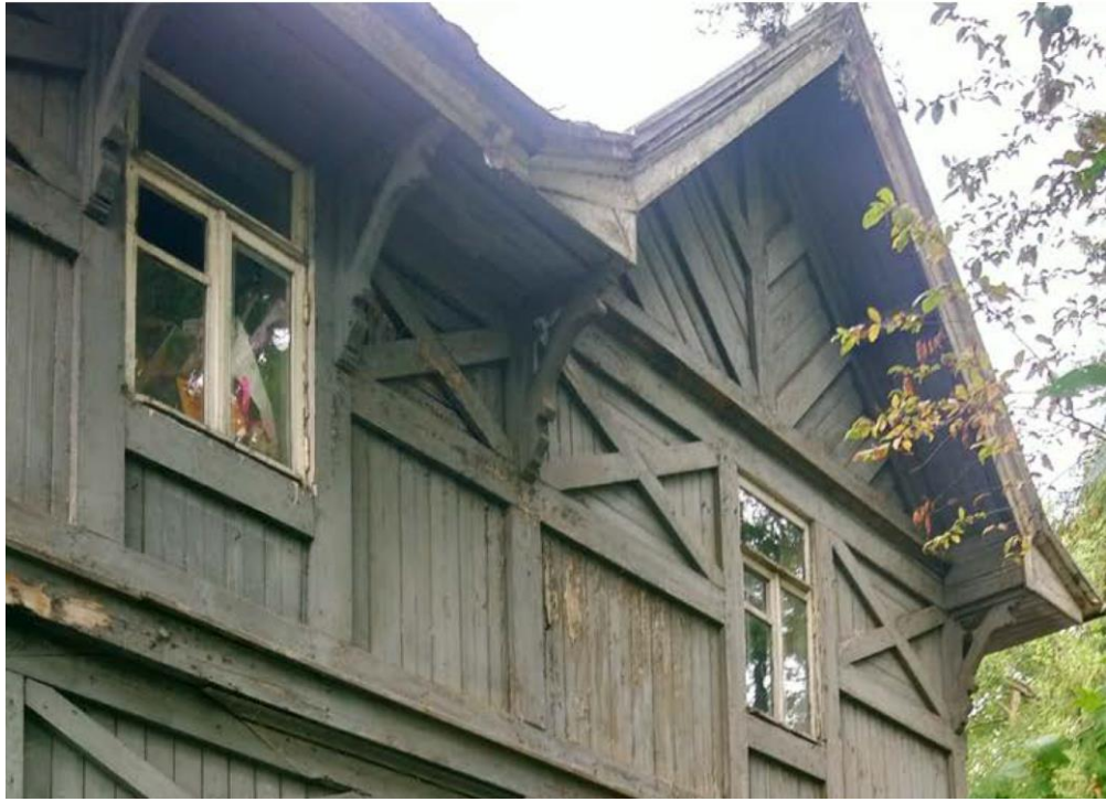
17. Объект культурного наследия регионального значения «Дача А.Н. Францена (О. Бертенсон)» по адресу: г. Санкт-Петербург, г. Зеленогорск, ул. Березовая, д. 19, лит. Д. Восточный фасад. Фрагмент. Второй этаж (мансарда).
