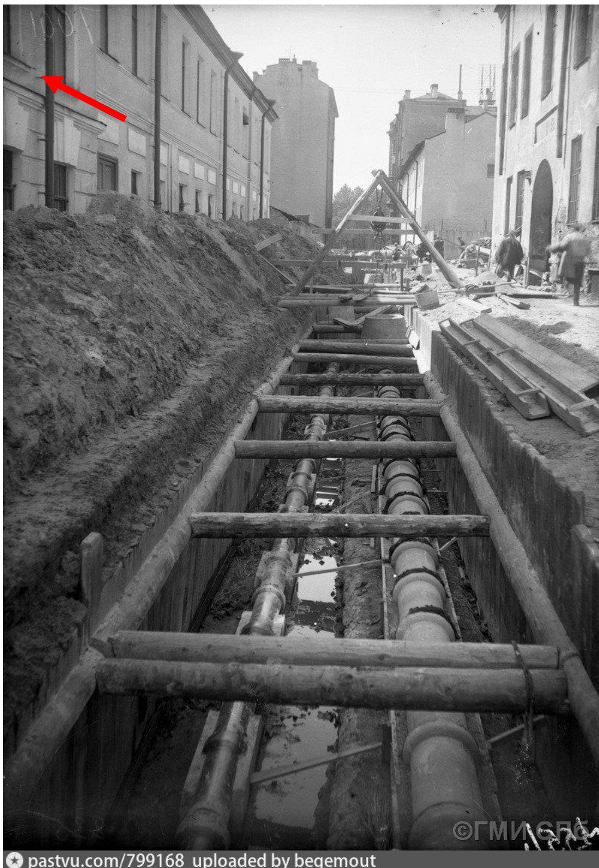
Илл. 18. Укладка инженерных сетей в Иностранном переулке. 1928 г. Интернет-ресурс https://pastvu.com/p/139020 .
