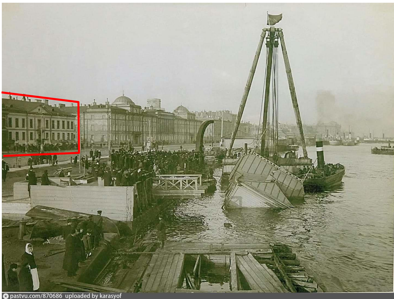
Илл. 17. Аварийно-спасательные работы на Николаевской набережной. К. XIX – нач. XX вв.
