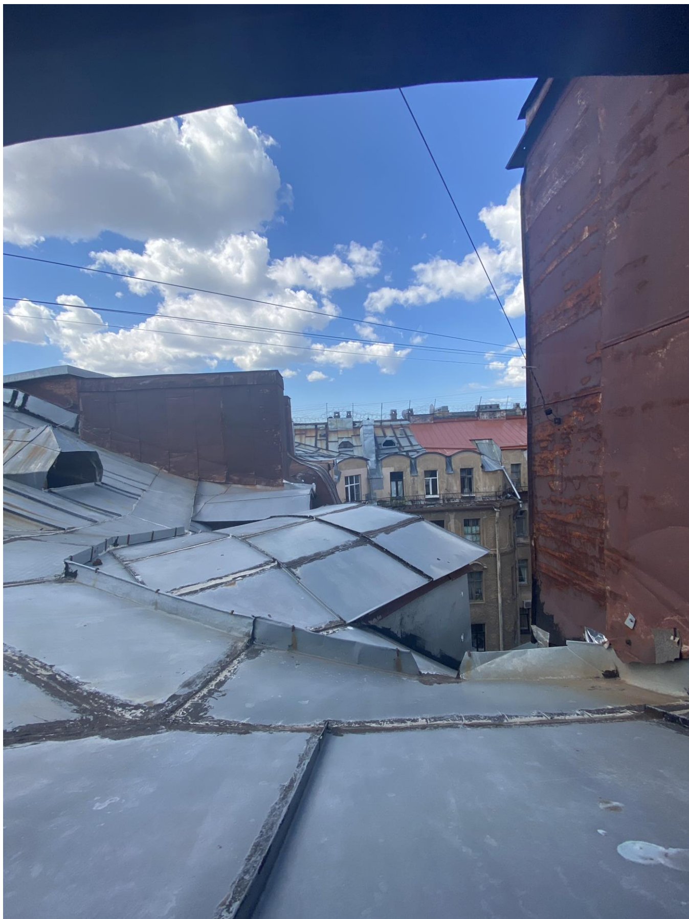
24. Мансарда и открытие кровли. Фрагмент.
