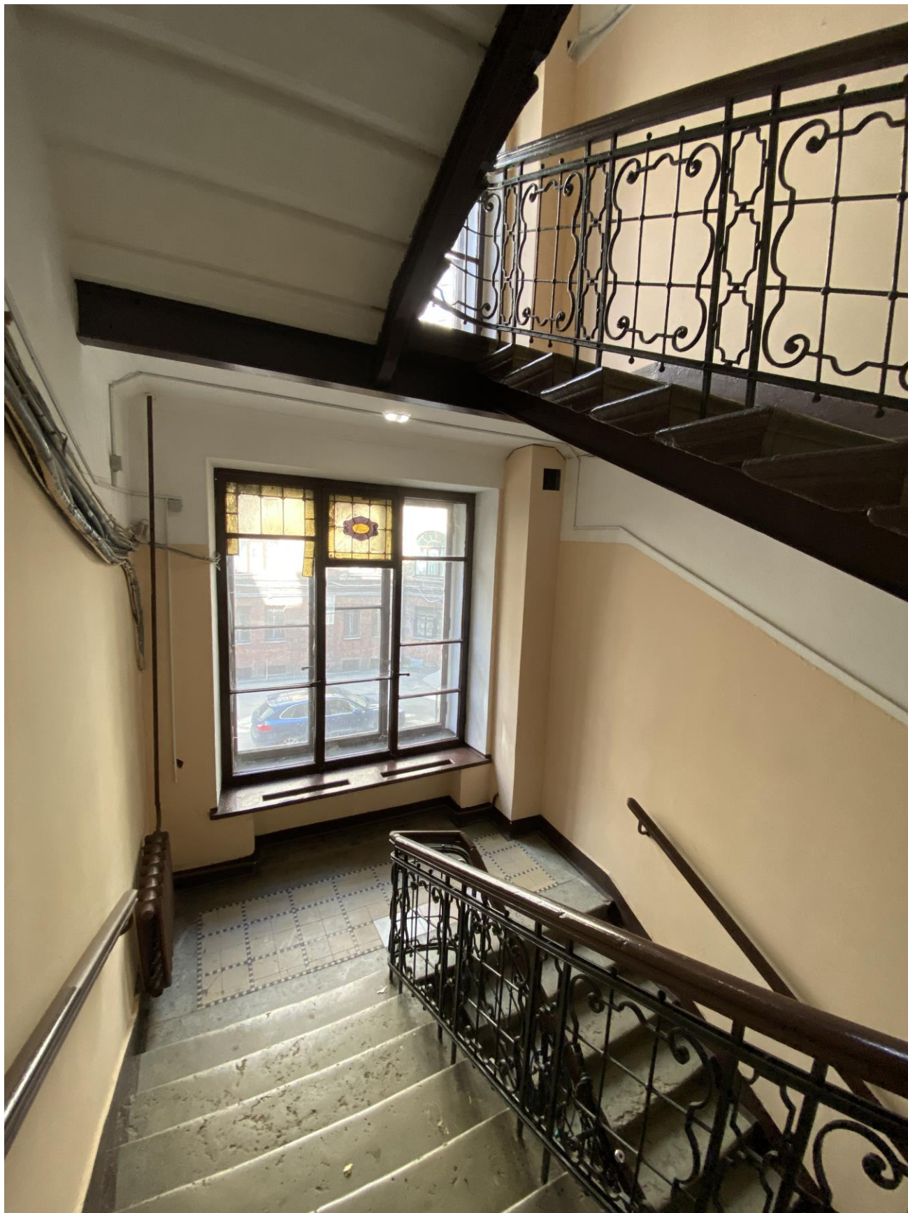
36. Интерьер лестницы Л-1 в уровне межэтажной площадки 2-3 этажей.
