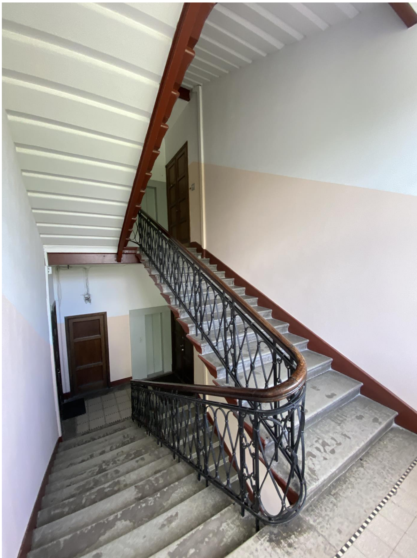
47. Лестница Л-2 в уровне 5-4 этажей.
