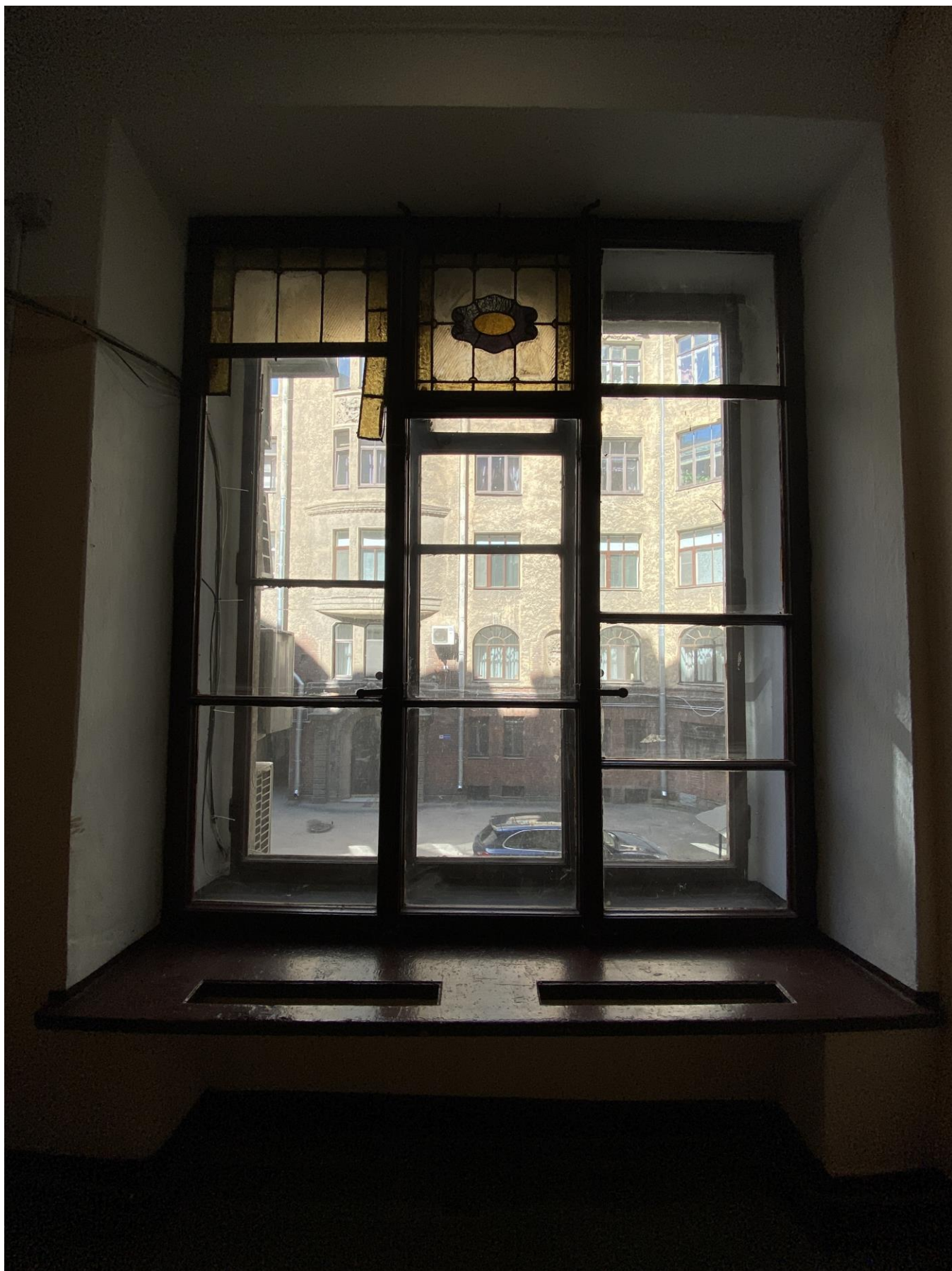
34.Оконный проем с витражным заполнением на площадке 1-2 этажа лестницы Л-1
