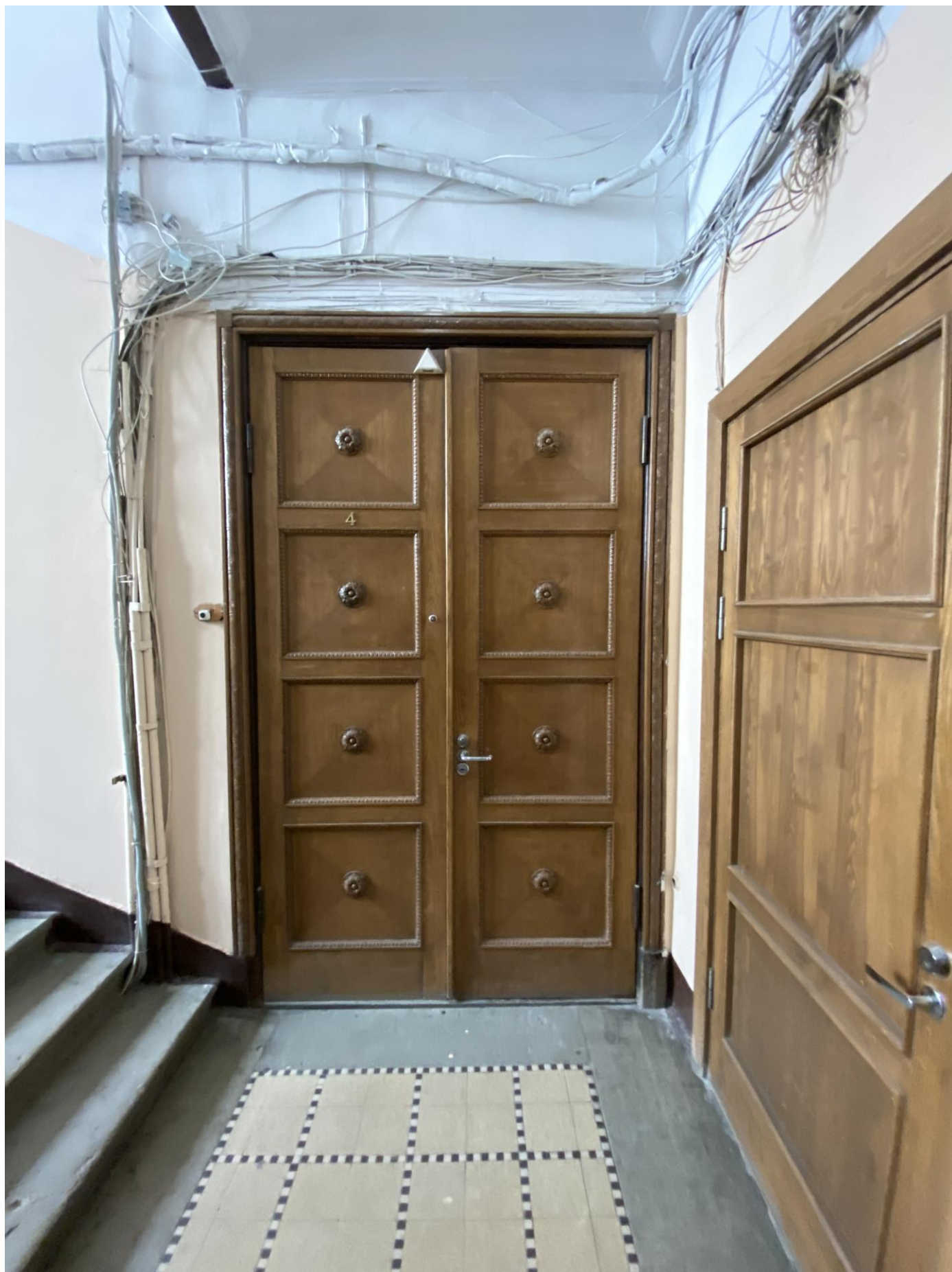
39. Историческое дверное заполнение на лестничной площадке 3 этажа.
