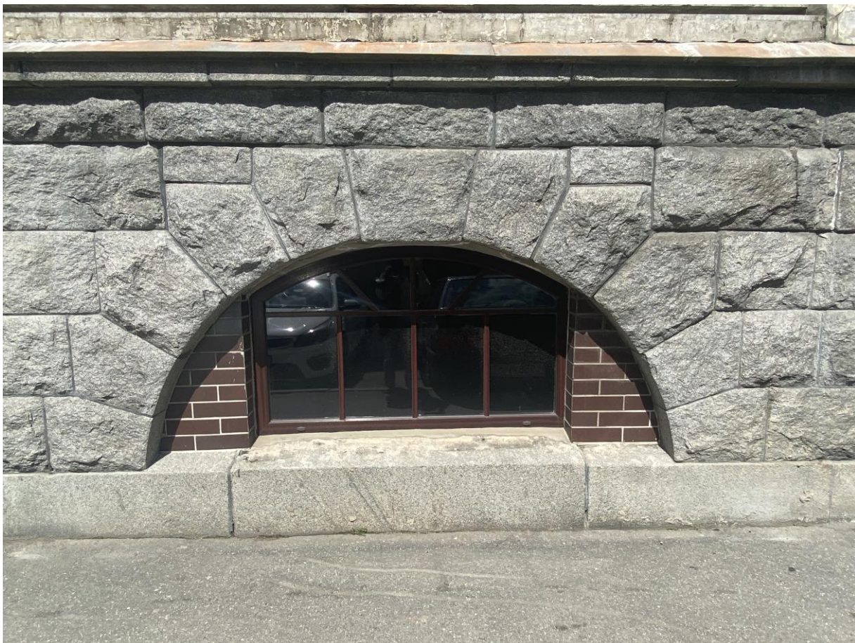
7. Окно цокольного этажа
