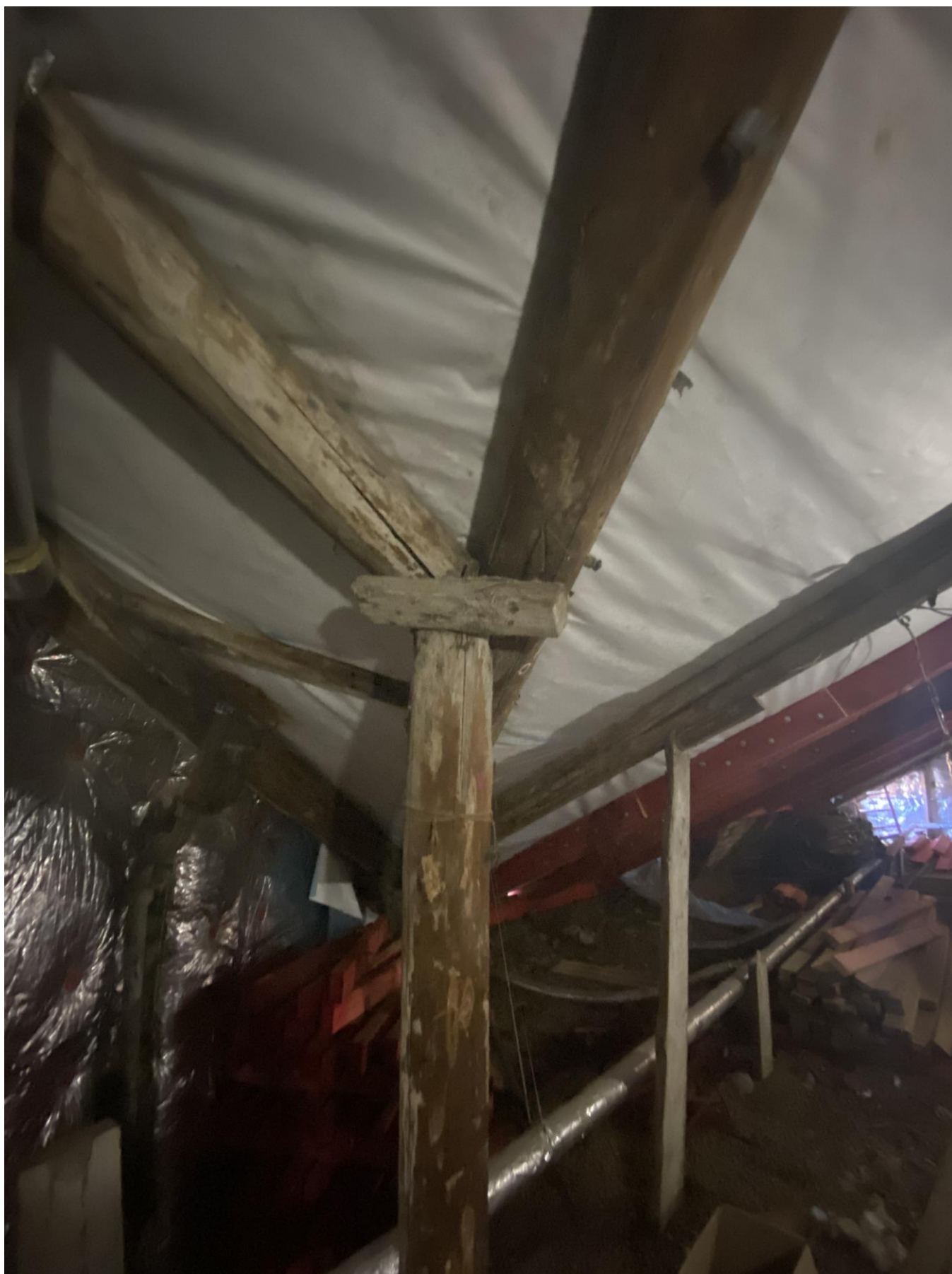
55. Стропильная система здания. Фрагмент.
