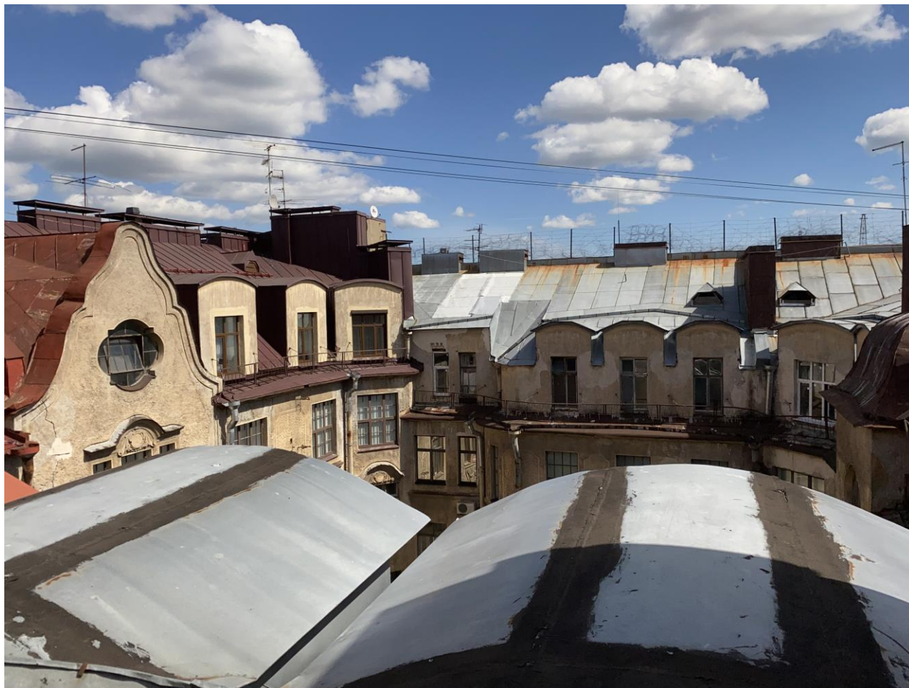
21. Мансарда и открытие кровли. Фрагмент.
