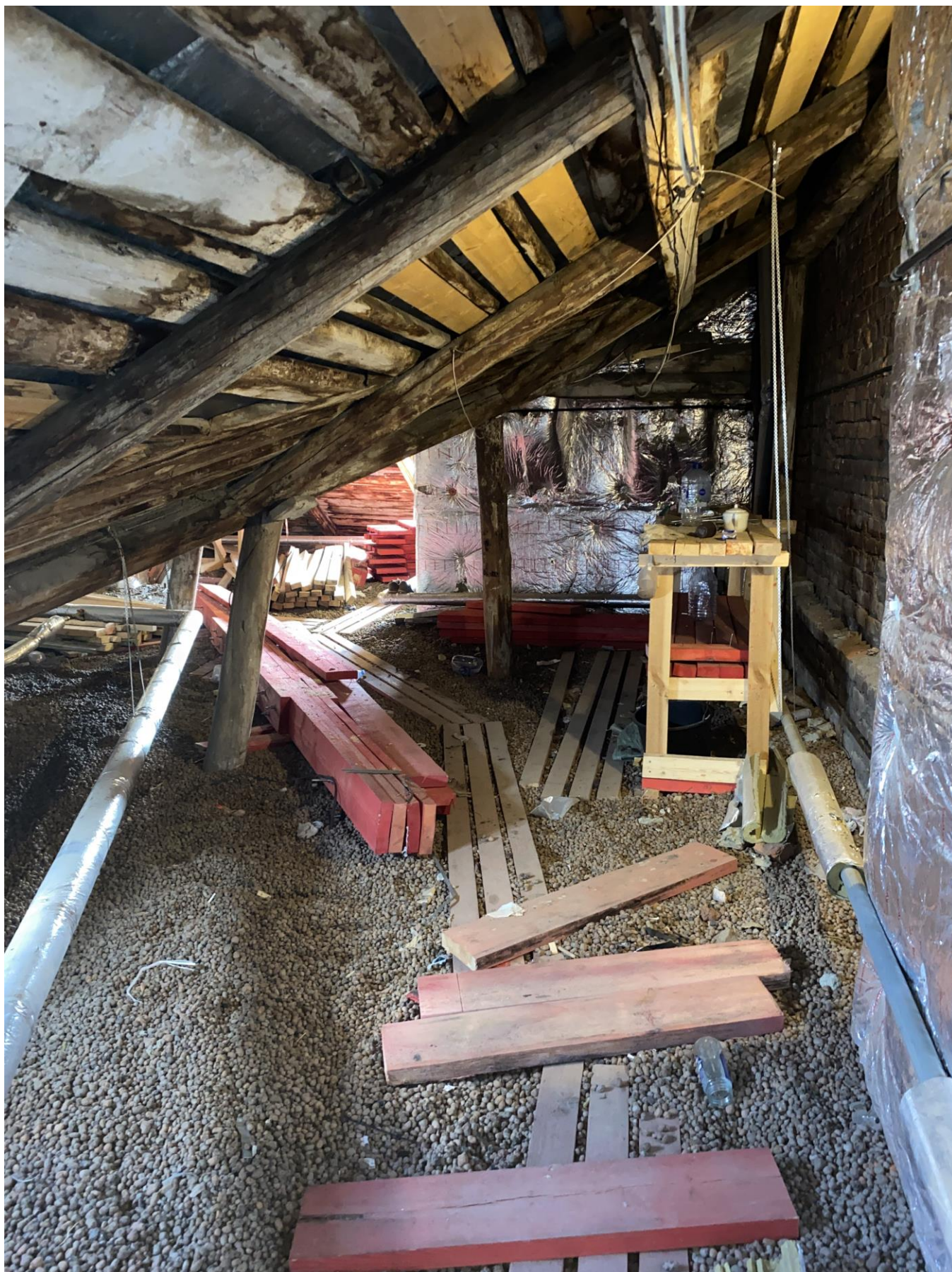
57. Стропильная система. Фрагмент.
