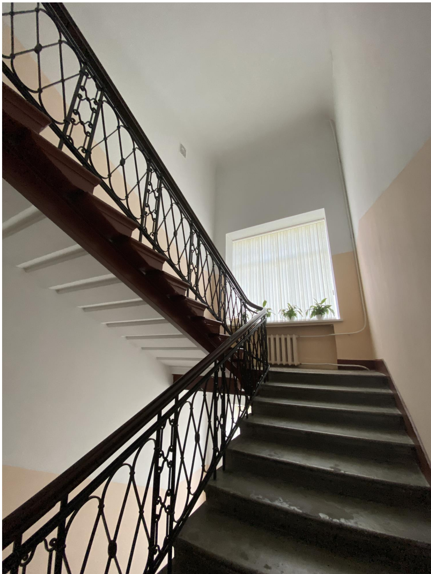
46. Лестница Л-2 в уровне 6-5 этажей
