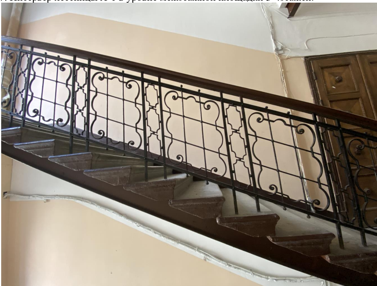
38. Лестница Л-1. Фрагмент.
