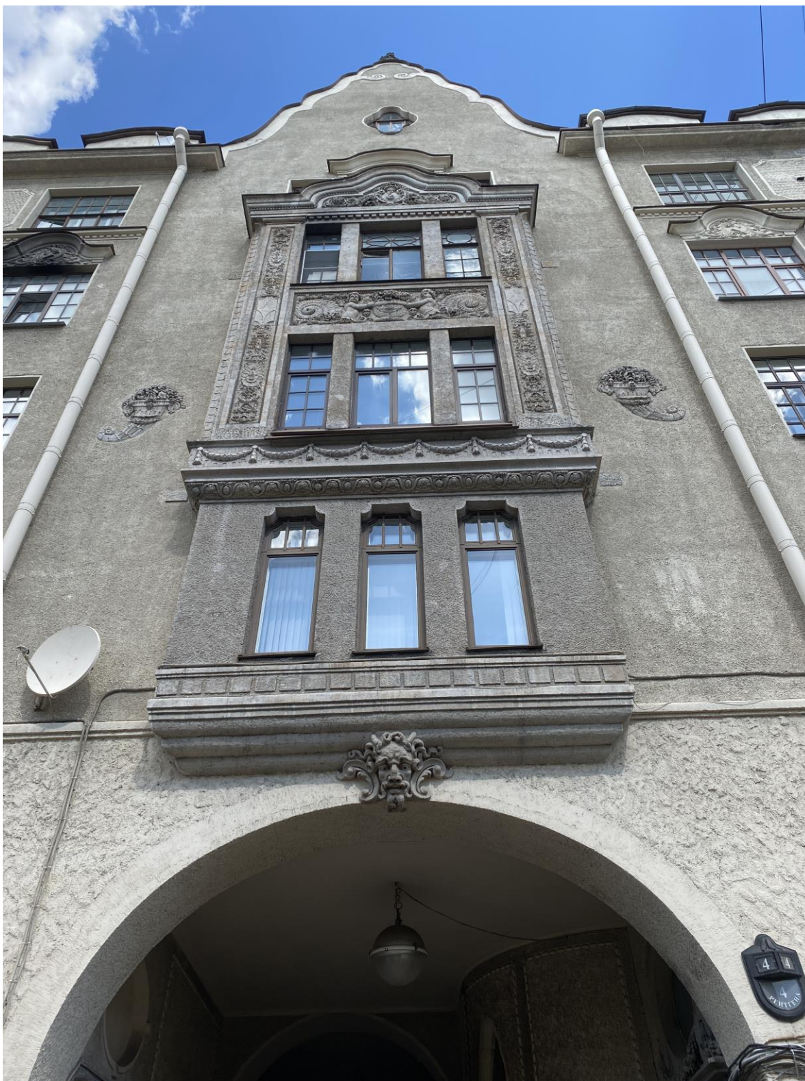
5. Лицевой фасад. Фрагмент.
