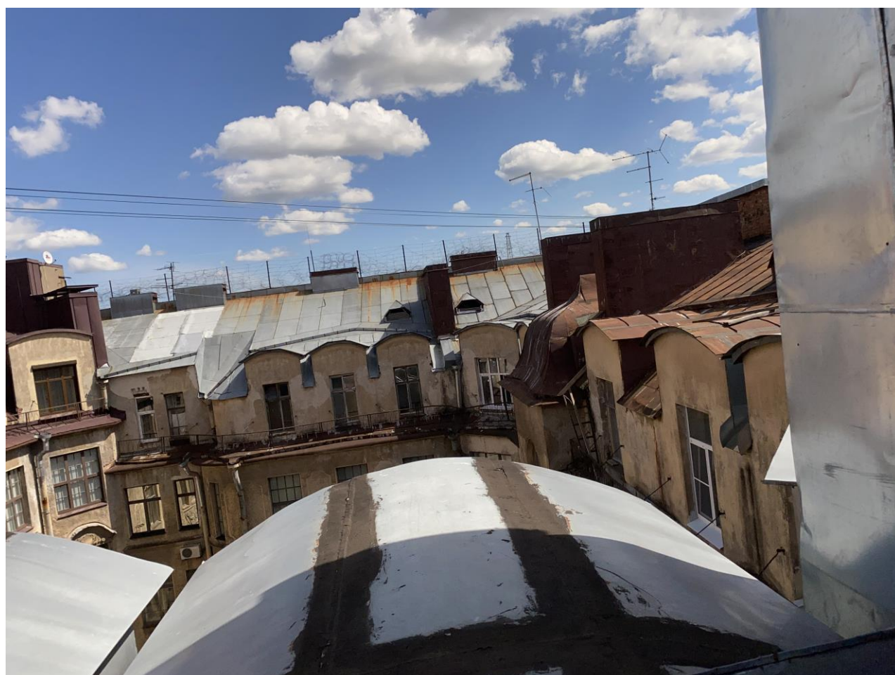
22. Мансарда и открытие кровли. Фрагмент.
