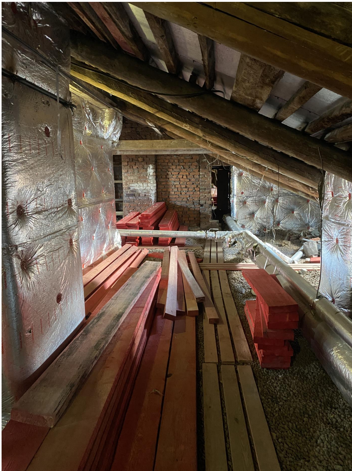
59. Стропильная система. Фрагмент.
