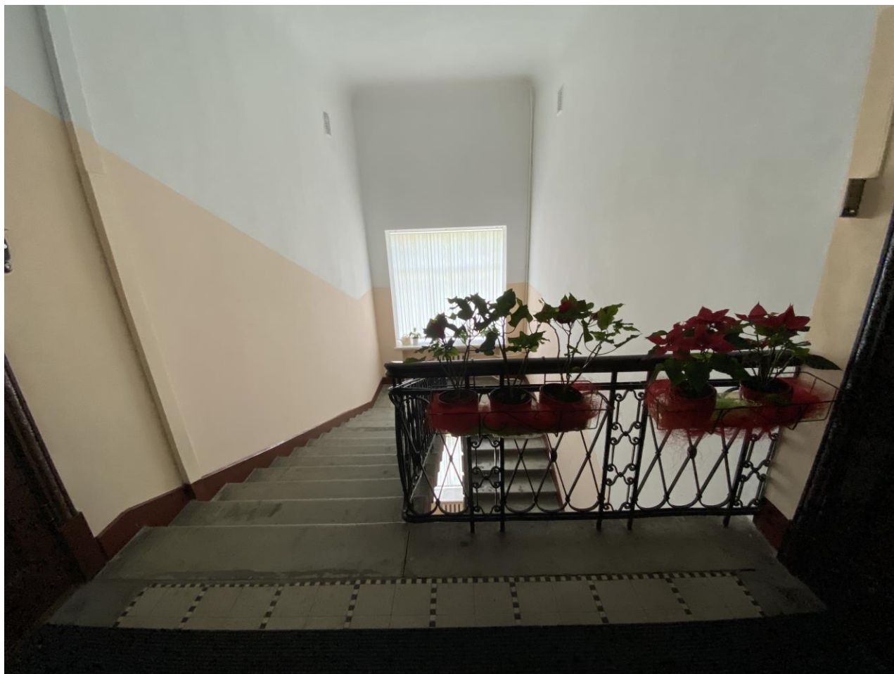
44. Лестничная площадка мансардного этажа лестницы Л-2
