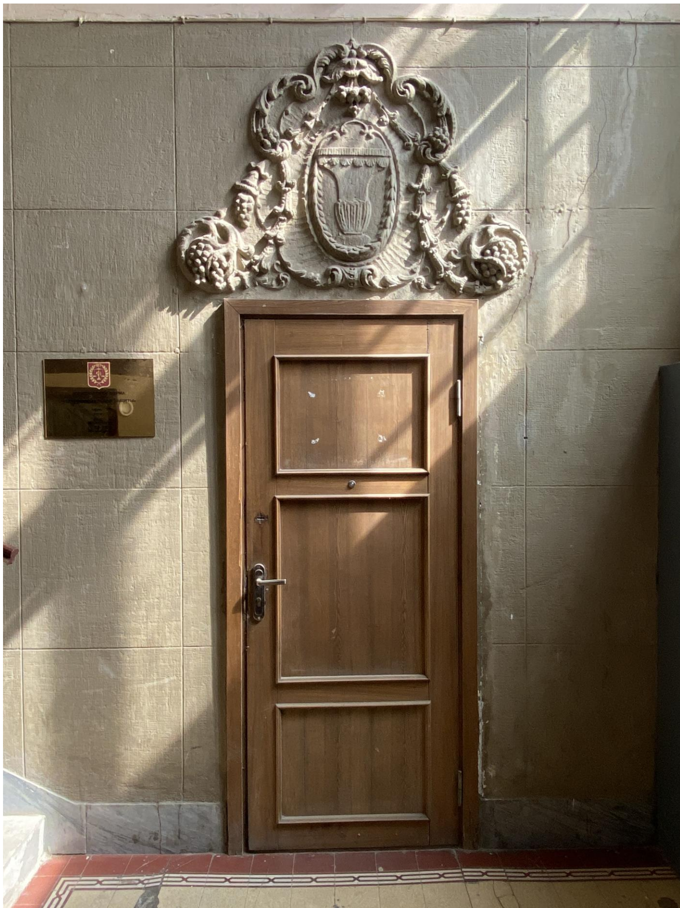
32. Оформление входа на площадке первого этажа парадной лестницы Л-1.
