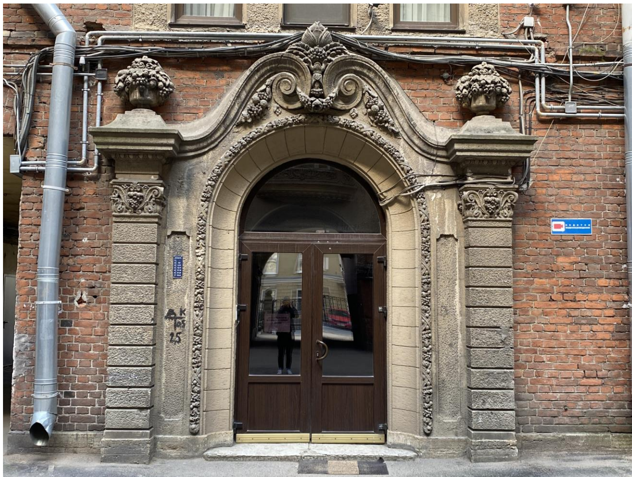
18. Портал и входная дверь (дворовый фасад).
