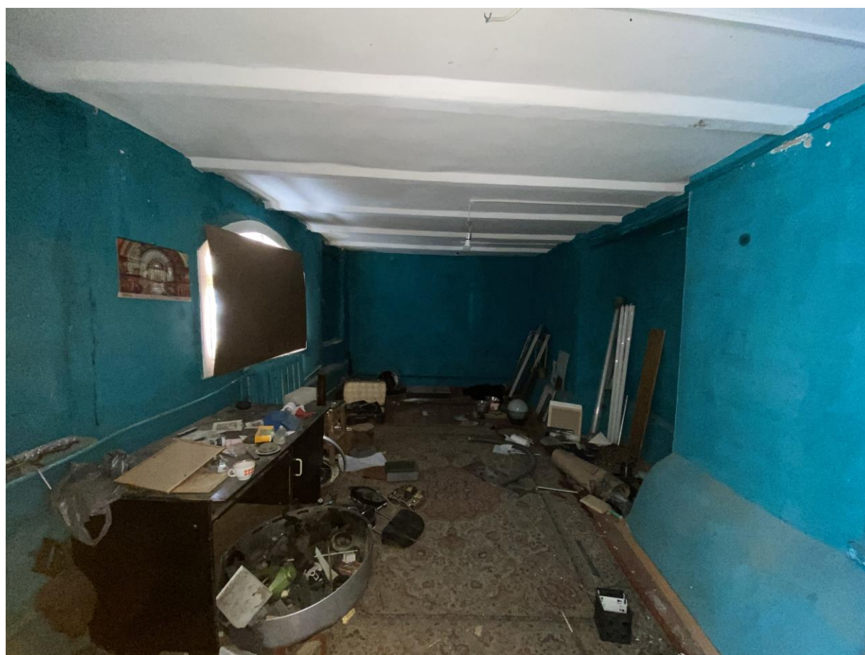
53. Интерьер помещений цокольного этажа.
