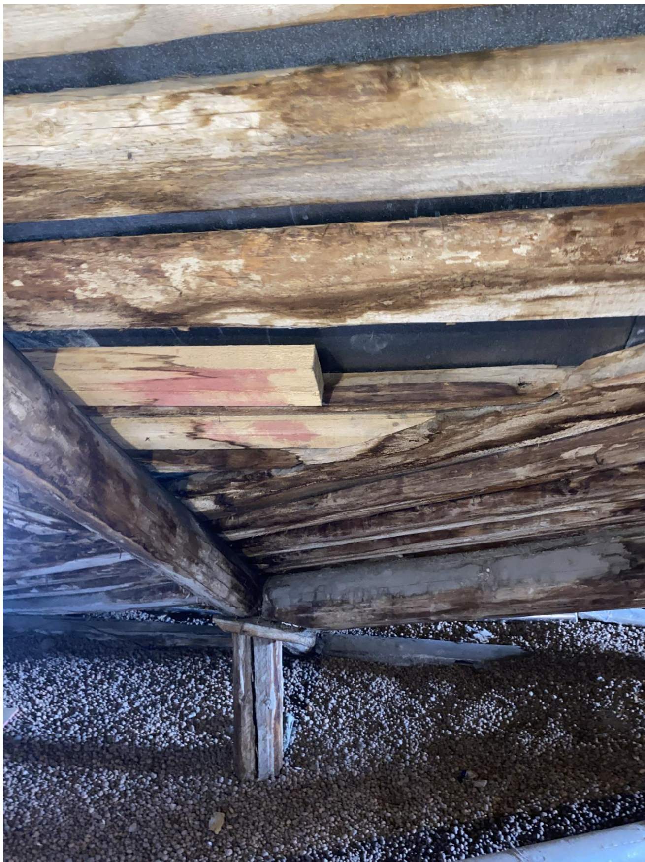
58. Стропильная система. Фрагмент.
