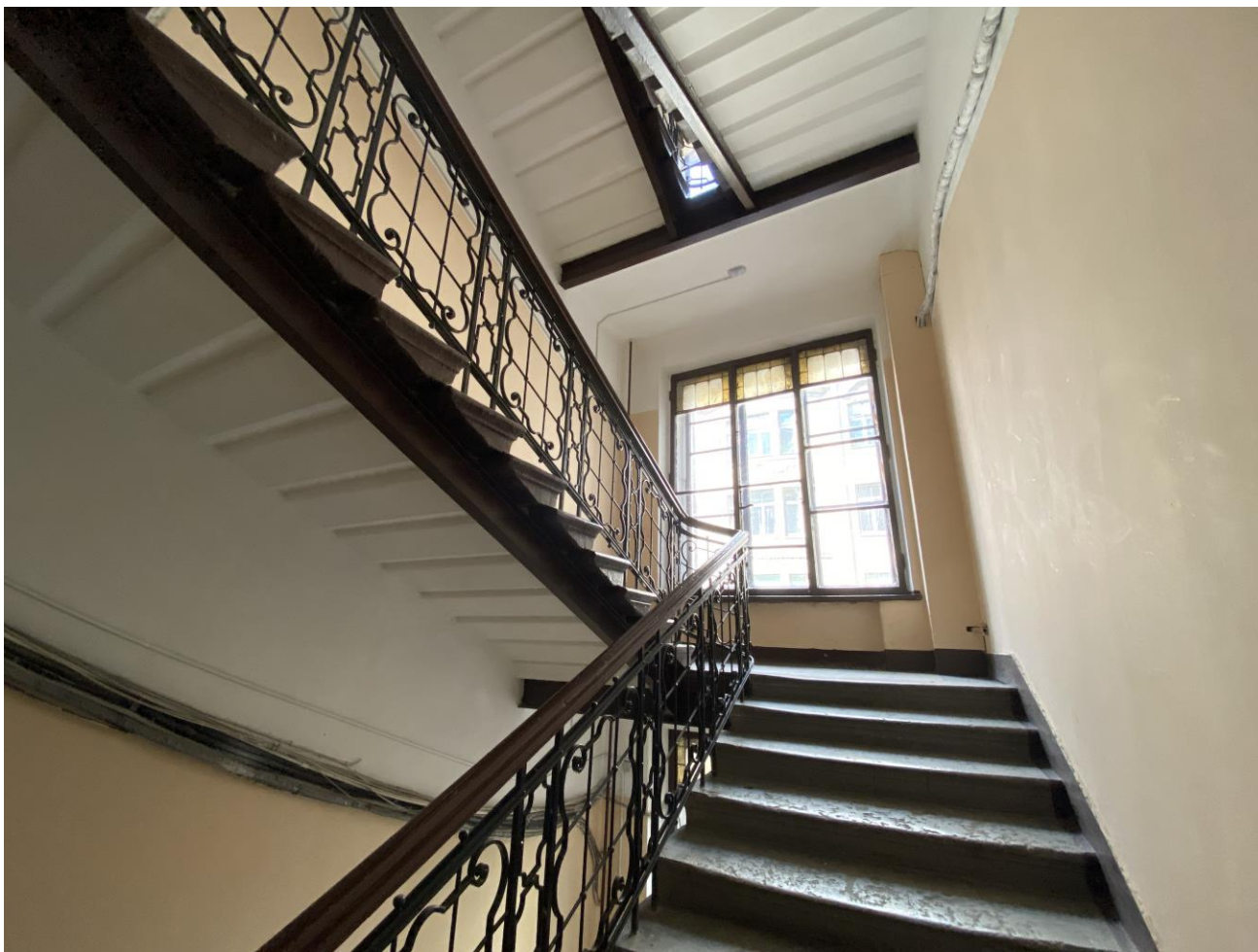
37. Интерьер лестницы Л-1 в уровне межэтажной площадки 3-4этажей.
