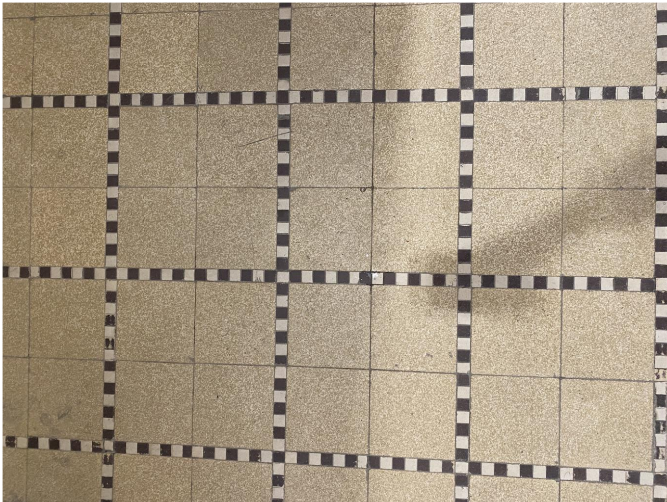
40. Облицовка пола лестничных площадок. Фрагмент.
