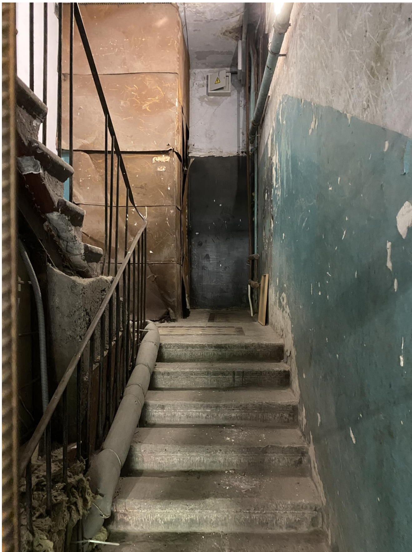
50. Лестница в северной части здания. Площадка 1 этажа.
