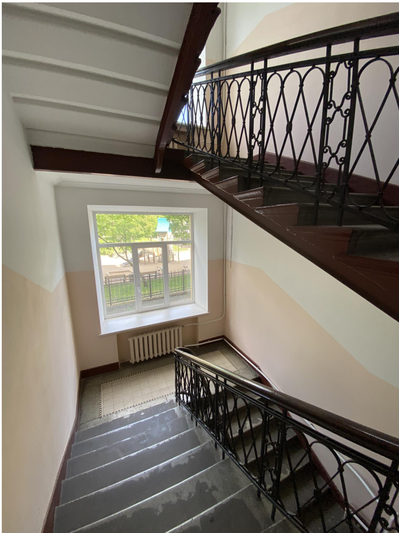
48. Лестница Л-2 в уровне 4-3 этажей.
