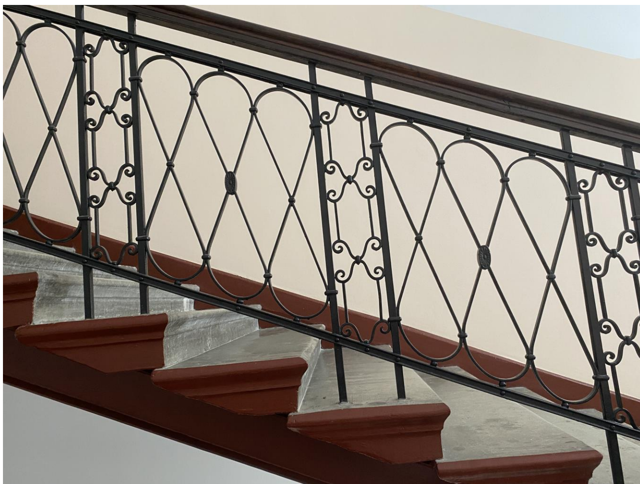
45. Металлическое лестничное ограждение лестницы Л-2. Фрагмент.
