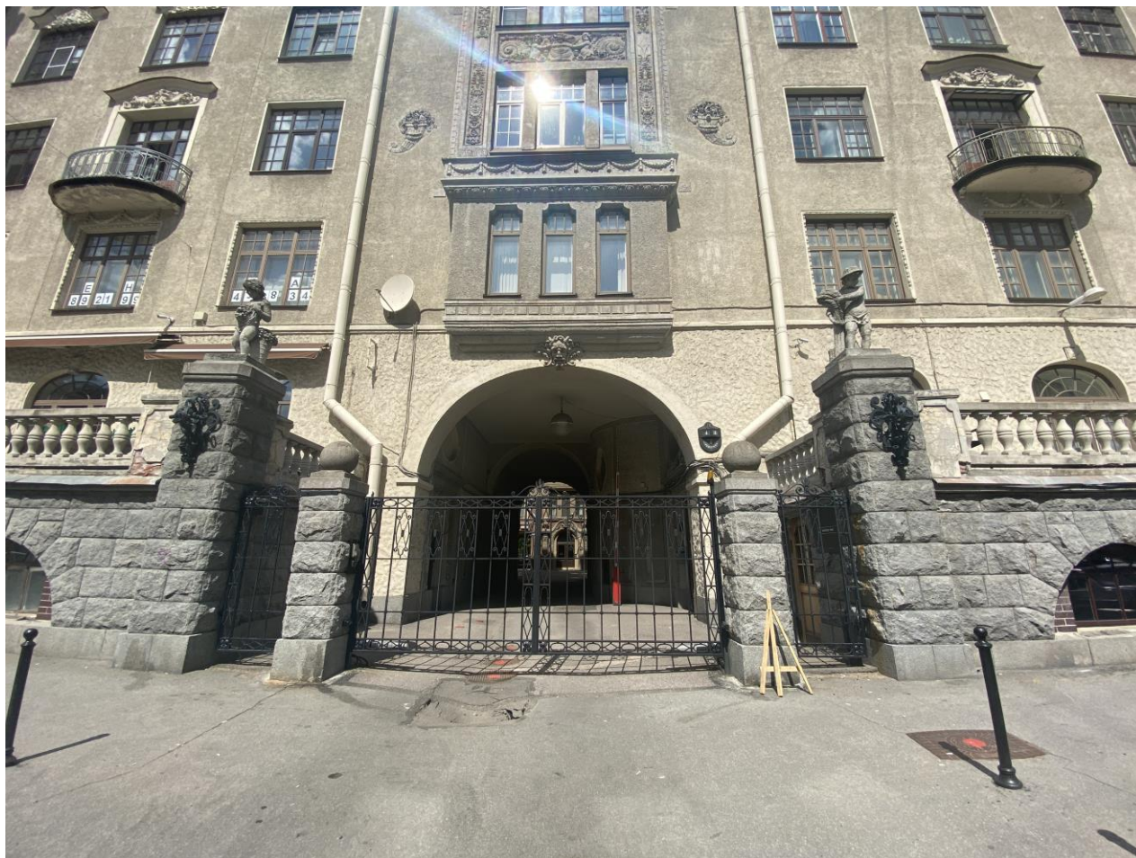
3. Лицевой фасад. Общий вид входной группы.
