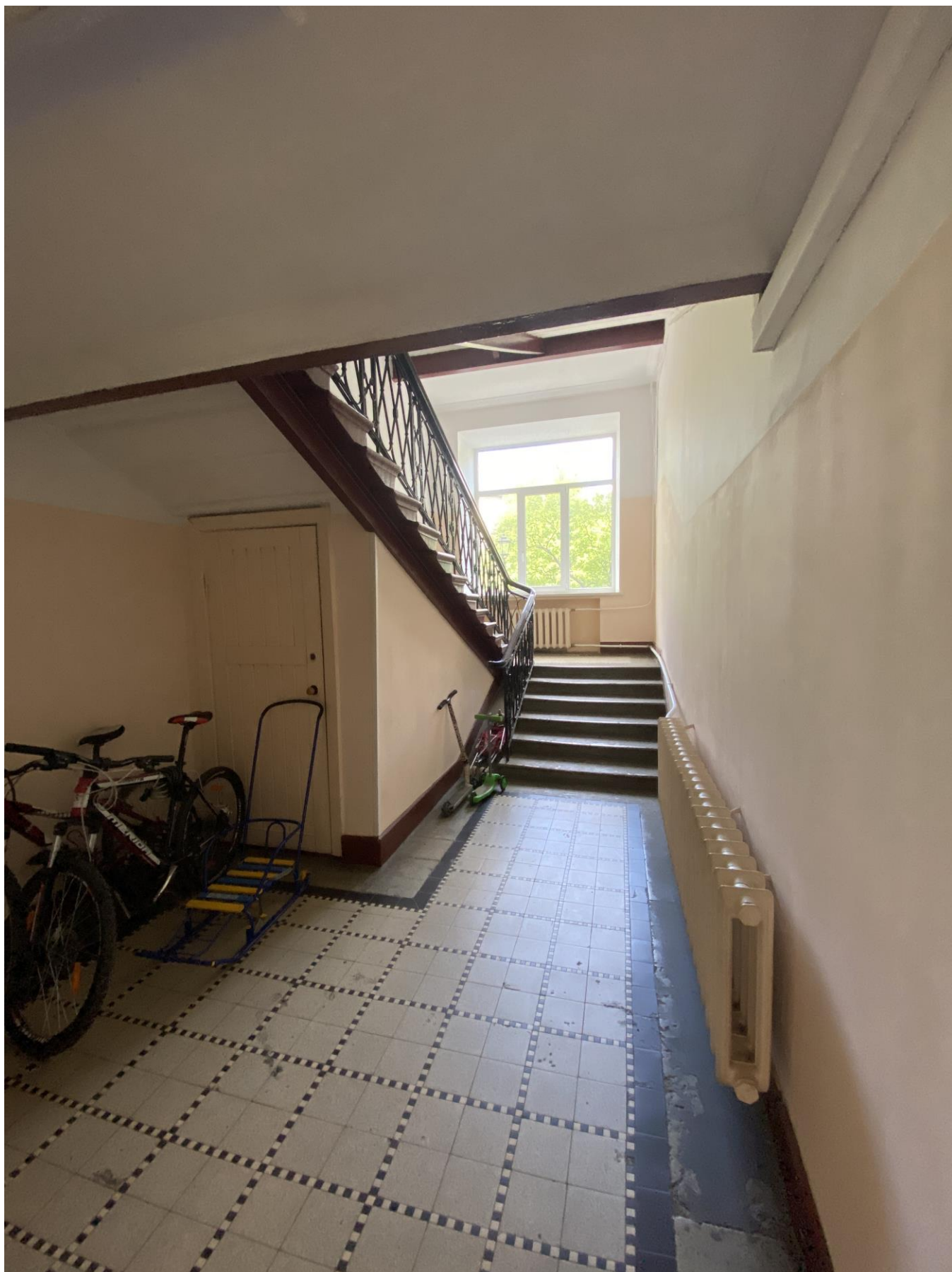
49. Лестничная площадка 1 этажа лестницы Л-2.
