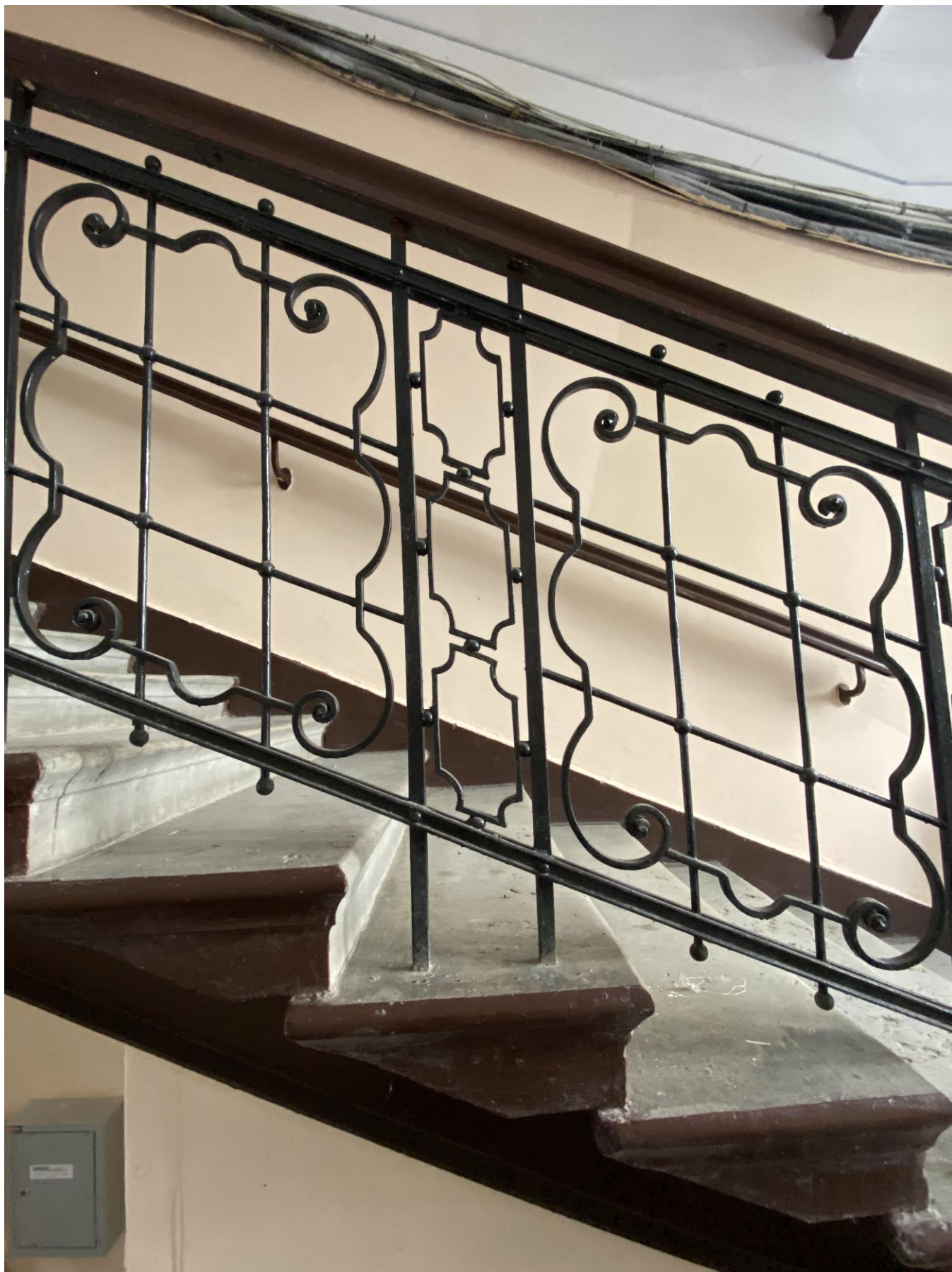
35. Металлическое ограждение лестницы Л-1. Фрагмент
