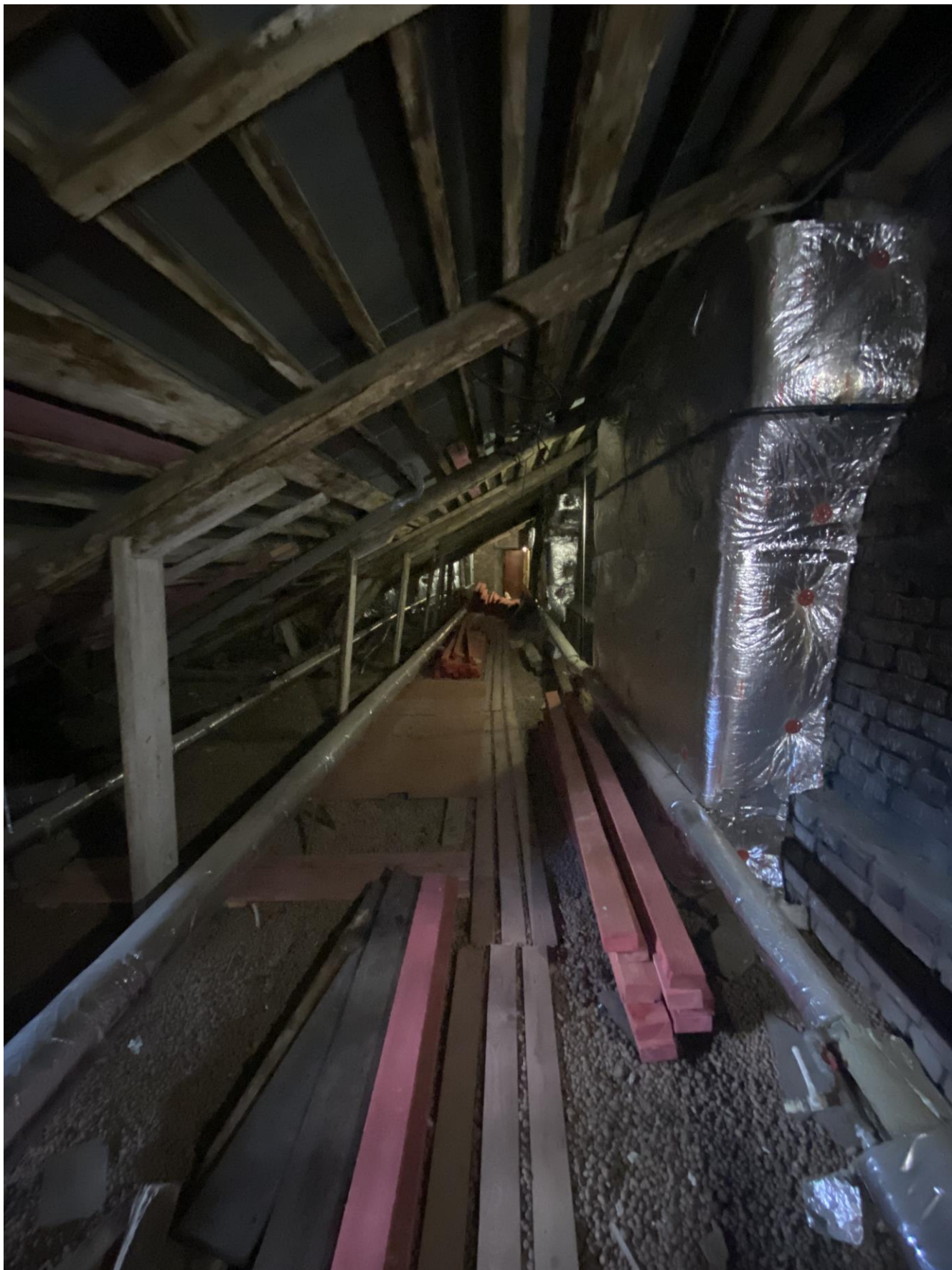
60. Стропильная система. Фрагмент.
