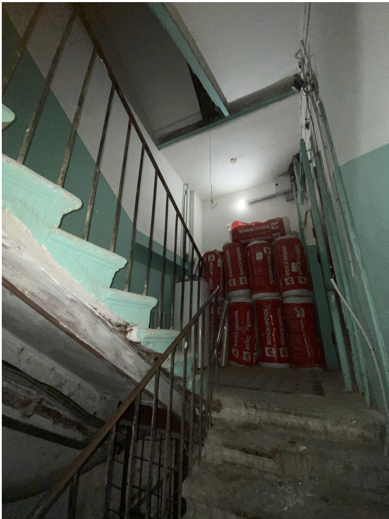
51. Лестница в северной части здания. Площадка 2-3 этажей.
