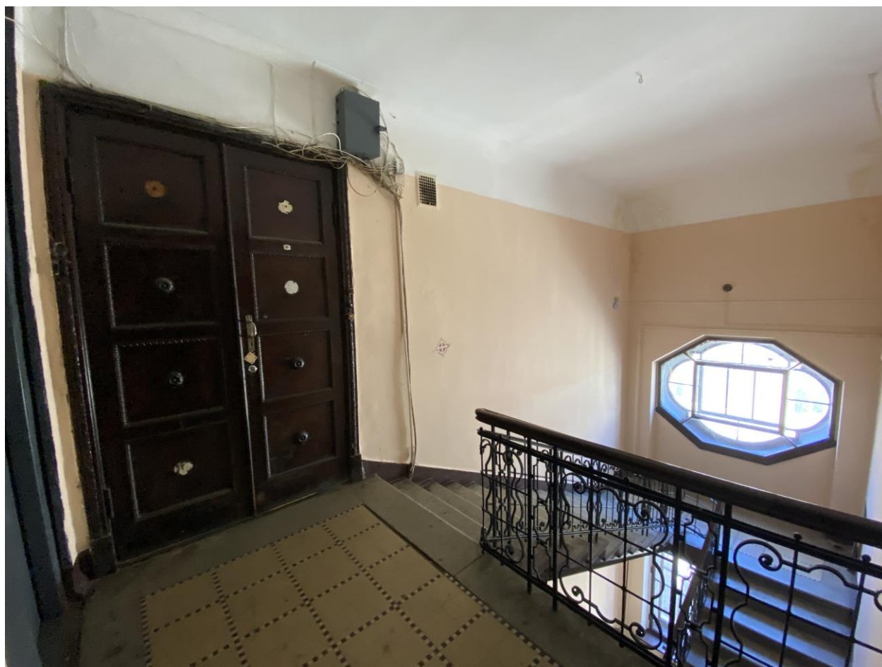
43. Лестничная площадка мансарды лестницы Л-1.
