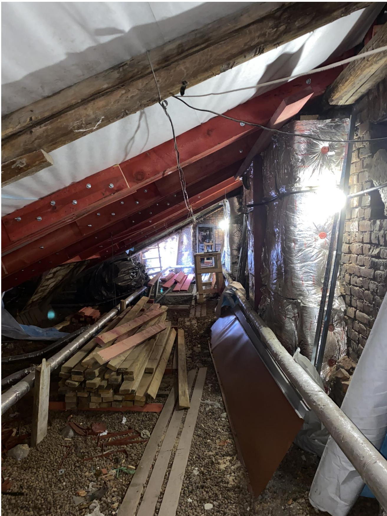
54. Стропильная система здания. Фрагмент.
