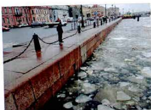
3. Стенка набережной. Вид от 9-й линии В.О.
