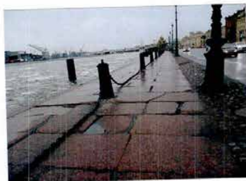
2. Вид от Благовещенского моста
