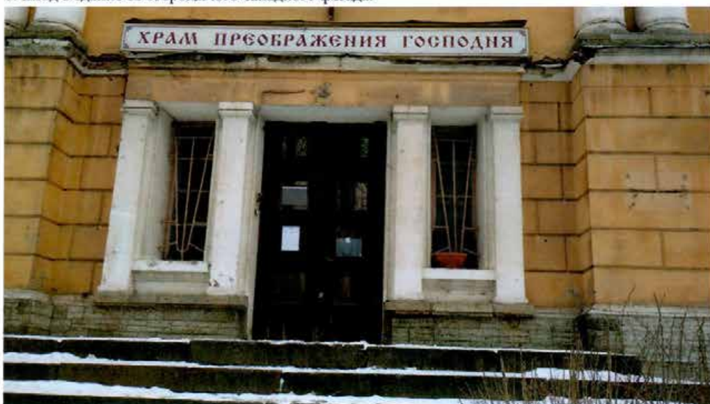
8. Вход в здание со стороны юго-западного фасада.
