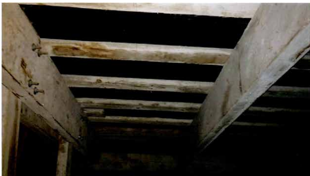
5. Стропильная система.
