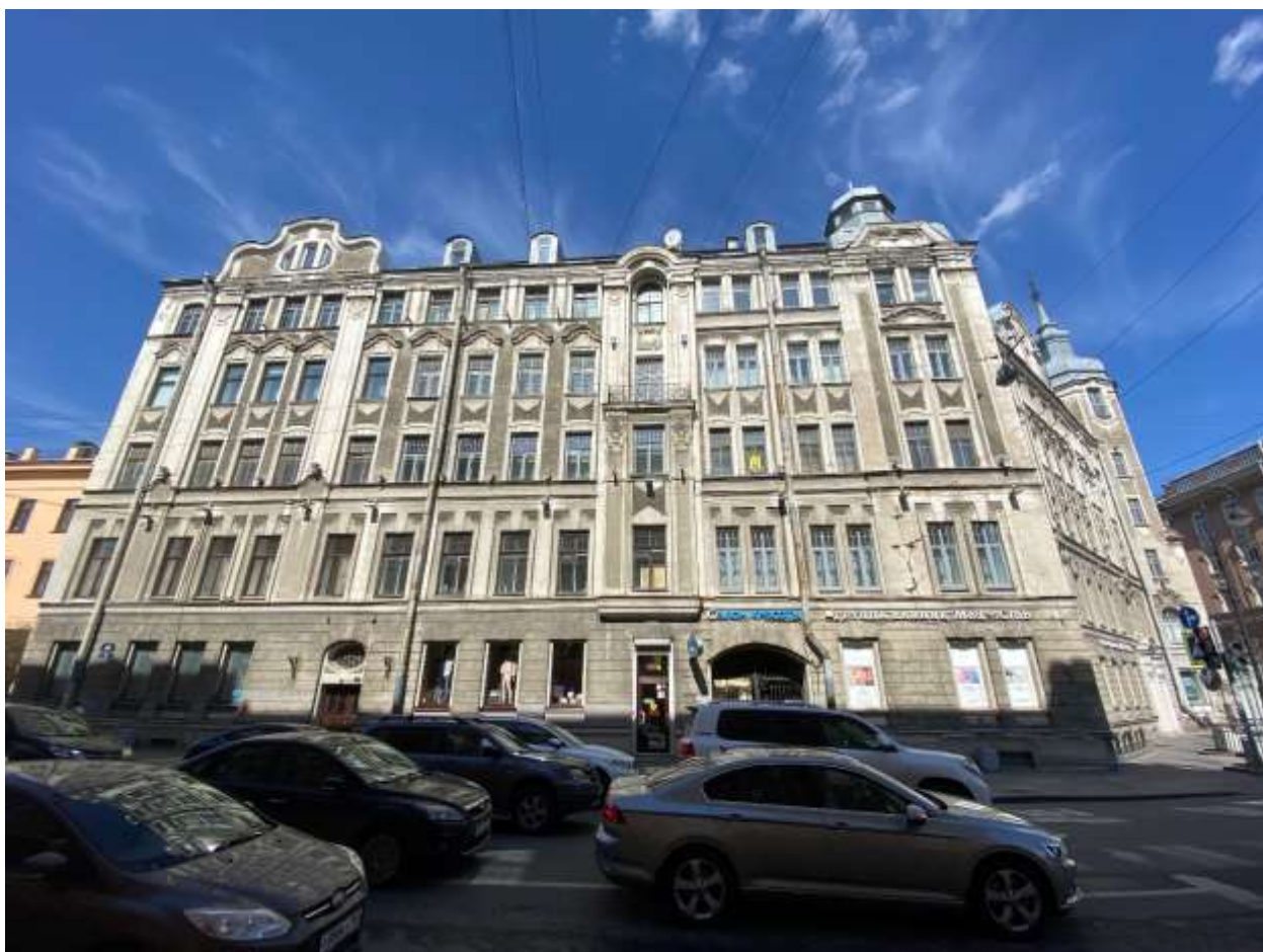
Фото 2. Общий вид южного лицевого фасада по улице Мира. Вид с юго-востока.
