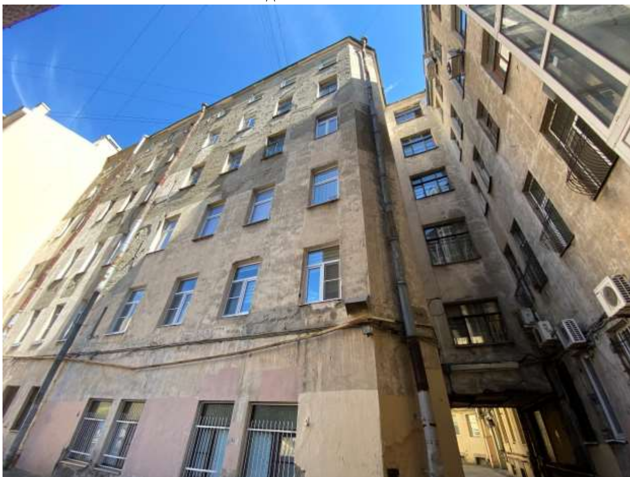
Фото 4. Общий вид юго-западного фасада дворового шестиэтажного флигеля. Вид с юго-запада.
