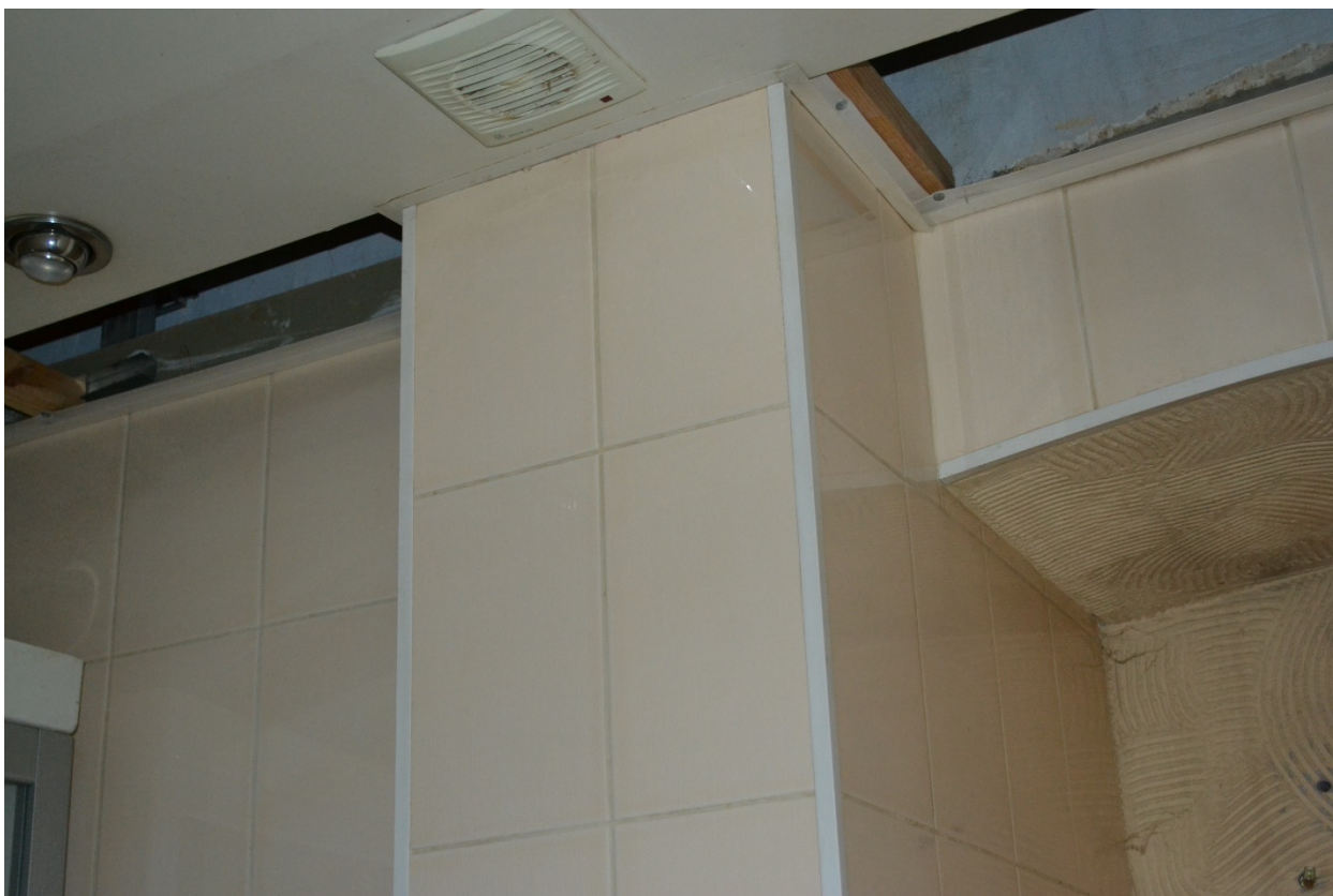
Фото 11. Часть помещения №4 (совмещенный санузел) согласно техническому паспорту. Общий вид.
