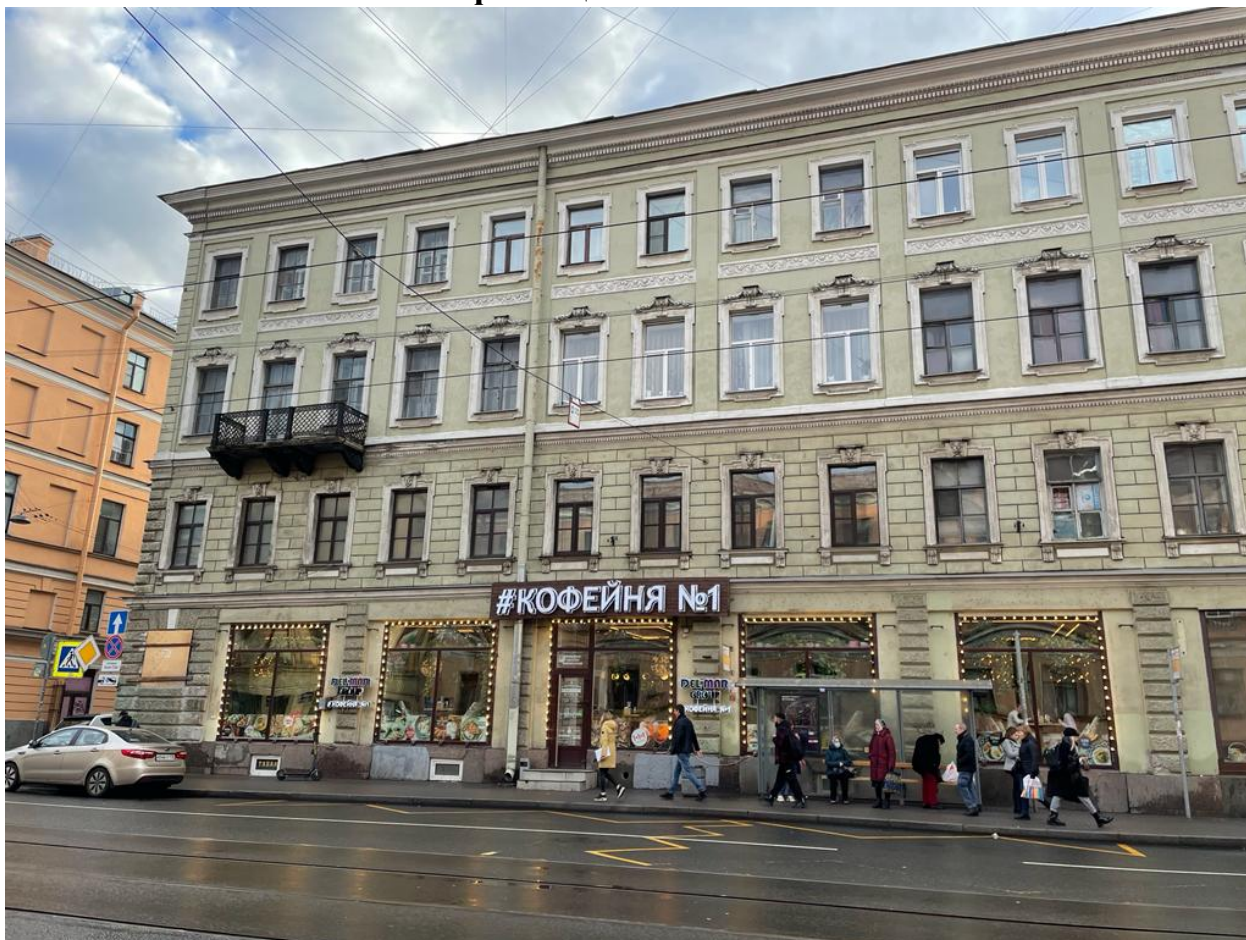
Фото 1. Северо-восточный фасад. Вид с северо-востока.
