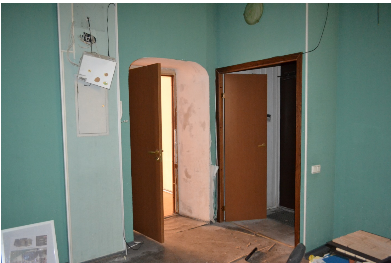
Фото 4. Помещение №2 (коридор). Вид на дверной проем на лестничную клетку 4Л и в помещение №8 (комната) согласно техническому паспорту.
