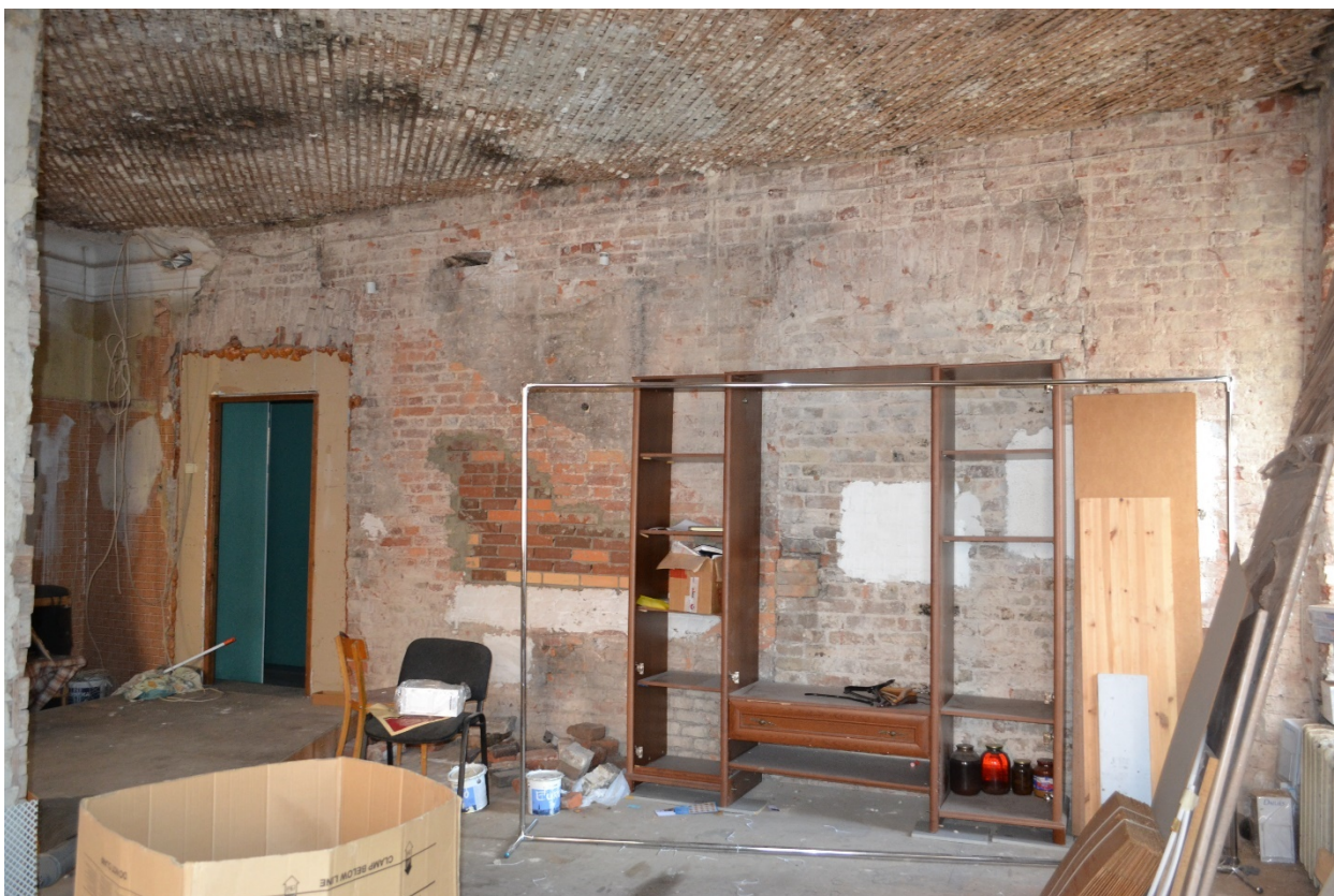
Фото 14. Помещение №7 (комната) согласно техническому паспорту. Общий вид.
