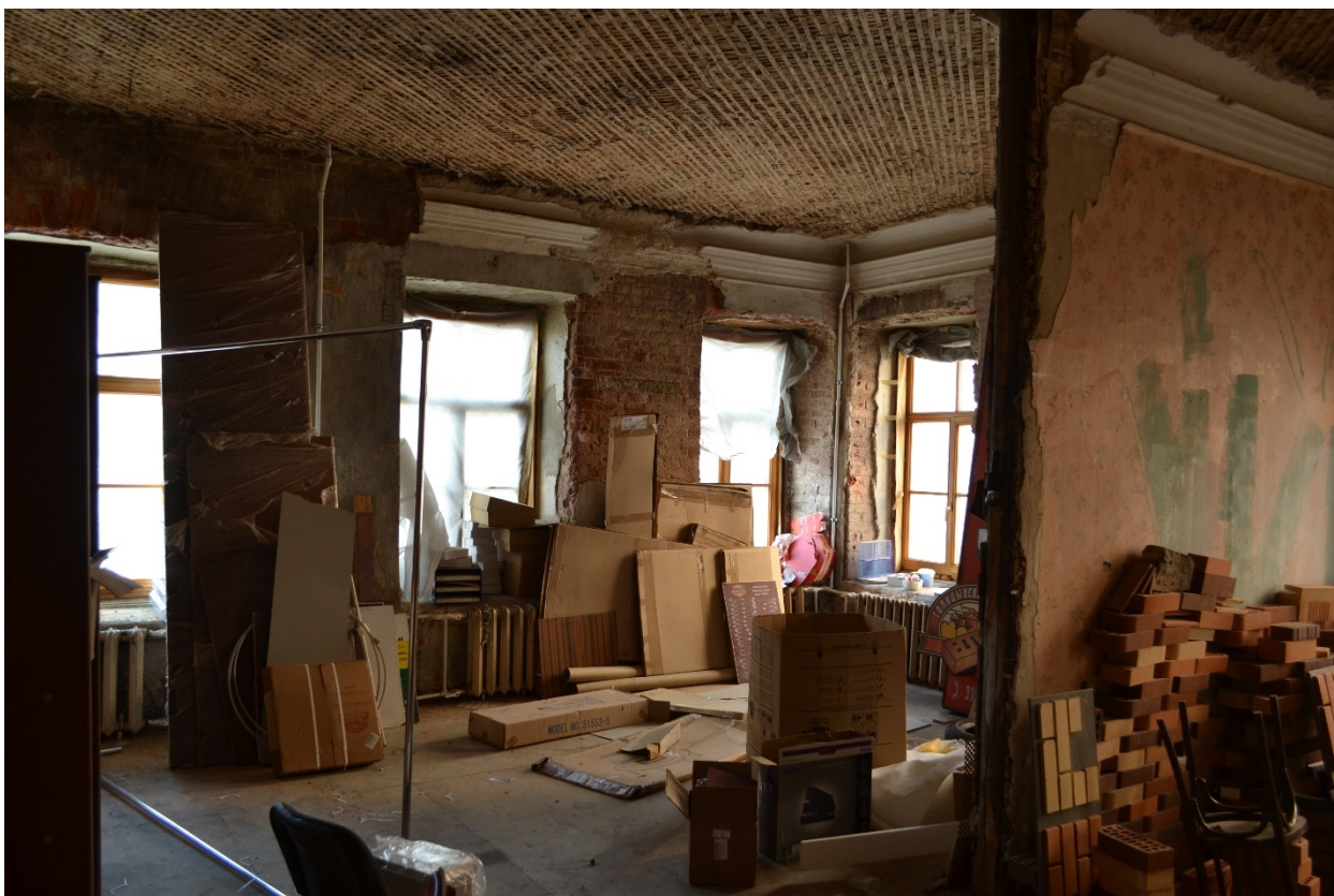
Фото 12. Помещение №7 (комната) согласно техническому паспорту. Общий вид.
