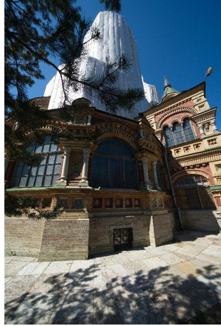
13. «Б. Собор Петра и Павла со зданием б. Церковно-приходской школы», г. Петергоф, Санкт-Петербургский проспект, дом 32, литера А; дом 43 б, литера А (Красный пр., 32, Красный пр., 43). Восточный фасад. Фрагмент. Фото 18.09.2021г.
