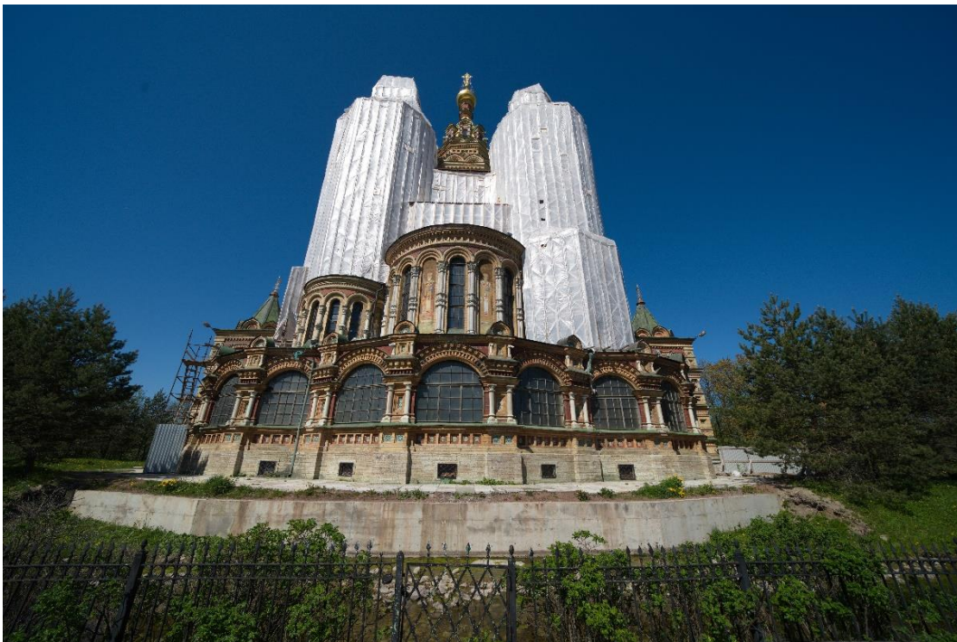
2. «Б. Собор Петра и Павла со зданием б. Церковно-приходской школы», г. Петергоф, Санкт-Петербургский проспект, дом 32, литера А; дом 43 б, литера А (Красный пр., 32, Красный пр., 43). Восточный фасад. Общий вид. Фото 18.09.2021г.
