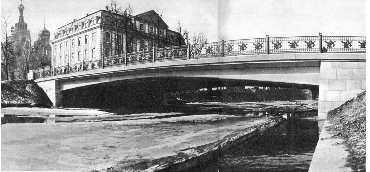
Илл. 17. Вид 2-го Садового моста. 1968-1969 г.
