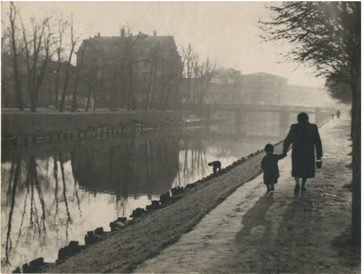
Илл. 11. Мойка в районе Садовых мостов. 1955-1960-е гг.
