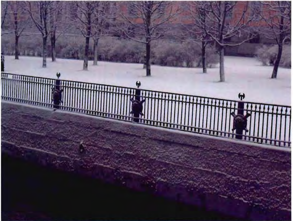
3. Ограждение набережной со стороны Михайловского (Инженерного) замка
