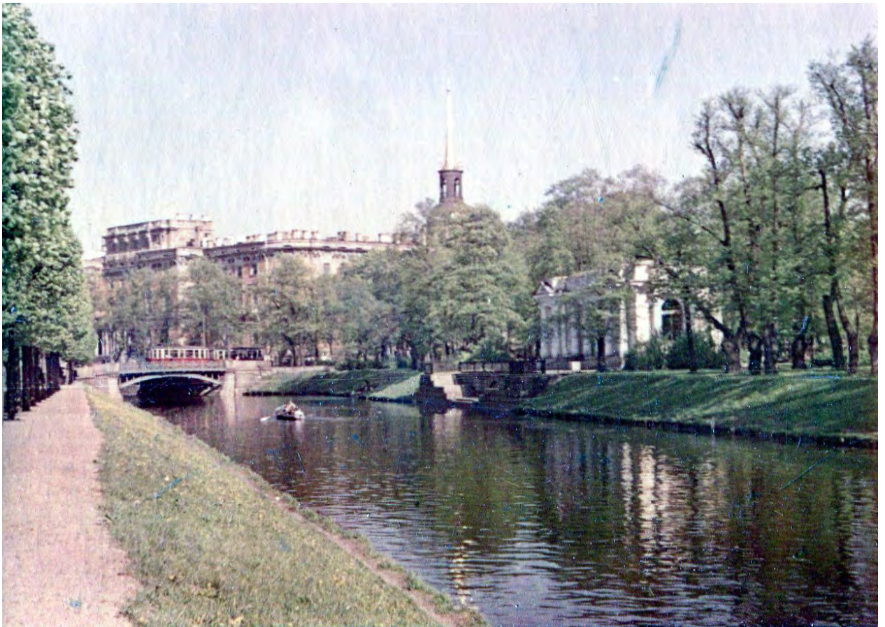
Илл. 10. Мойка в районе Садовых мостов. 1950-е гг.
