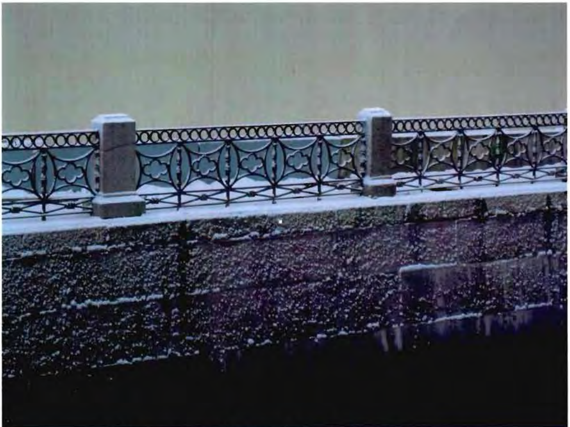
6. Ограждение набережной. Левобережная стенка
