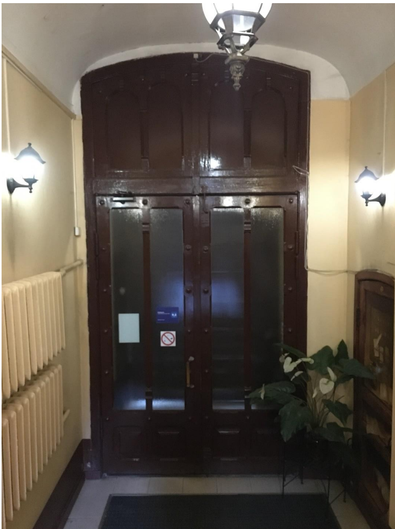
Фото 25. Вид на двери вестибюля 1ЛК.
