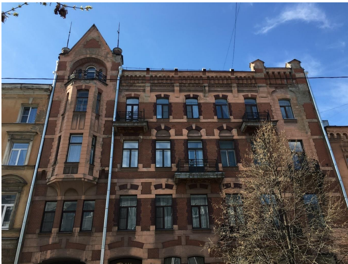
Фото 2. Вид на верхнюю часть северо-восточного фасада лицевого корпуса.
