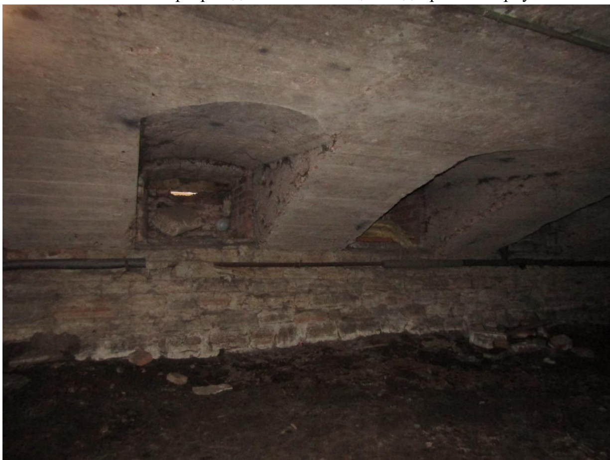
Фото 23. Интерьер подвальных помещений дворового корпуса.
