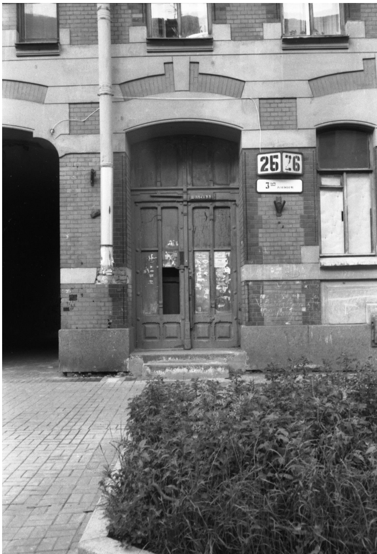
Илл. 29. Доходный дом П.Я. Прохорова. Лицевой фасад. Парадный вход. Общий вид. 2000 г. (источник: https://pastvu.com/p/1407445 ).
