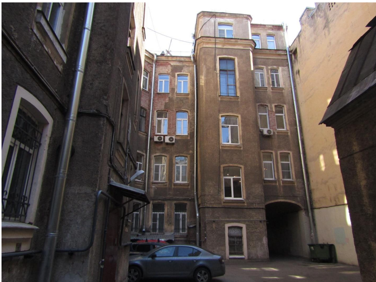
Фото 6. Вид на юго-западный фасад лицевого корпуса.
