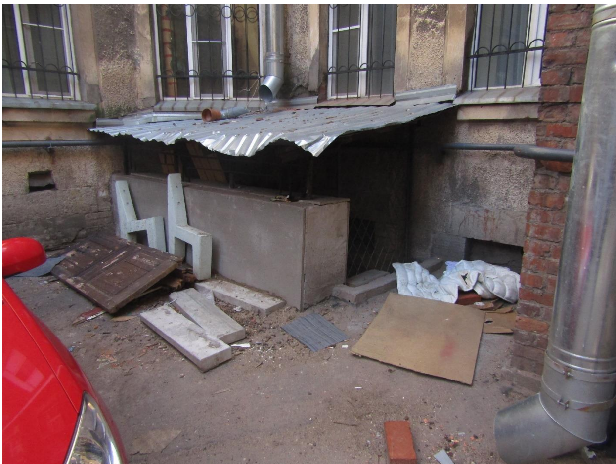
Фото 14. Вид на вход в подвал лицевого корпуса со стороны двора.
