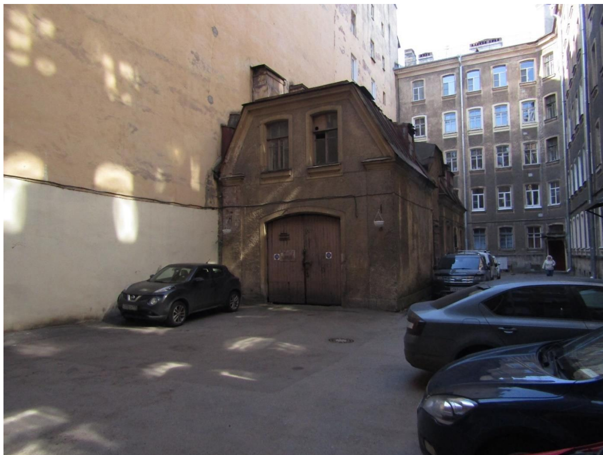
Фото 12. Вид на северо-восточный фасад здания служб.
