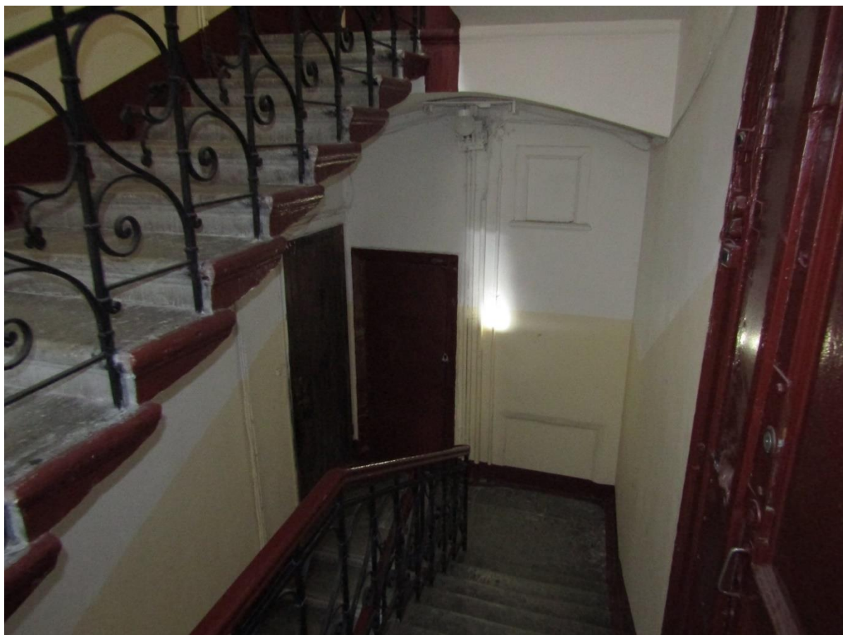
Фото 42. Вид на лестничную площадку 2ЛК в уровне 3-го этажа.
