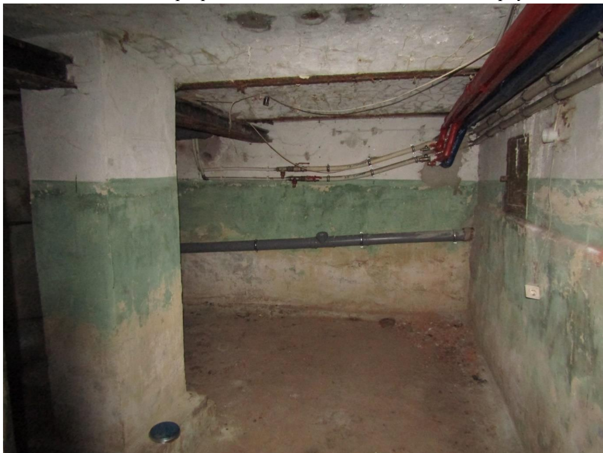
Фото 17. Интерьер подвальных помещений лицевого корпуса.
