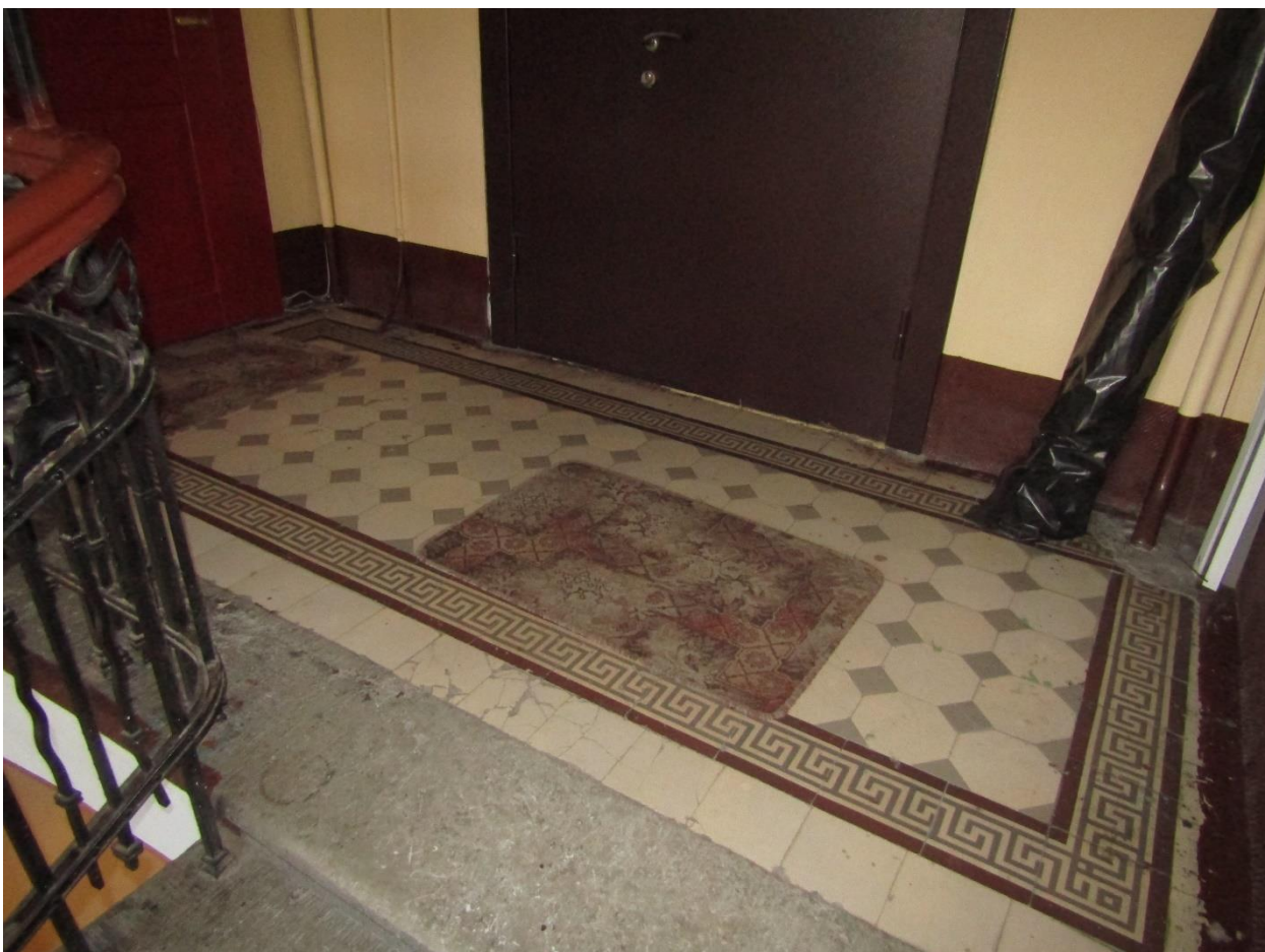
Фото 36. Вид на лестничную клетку 1ЛК в уровне 4-го этажа.
