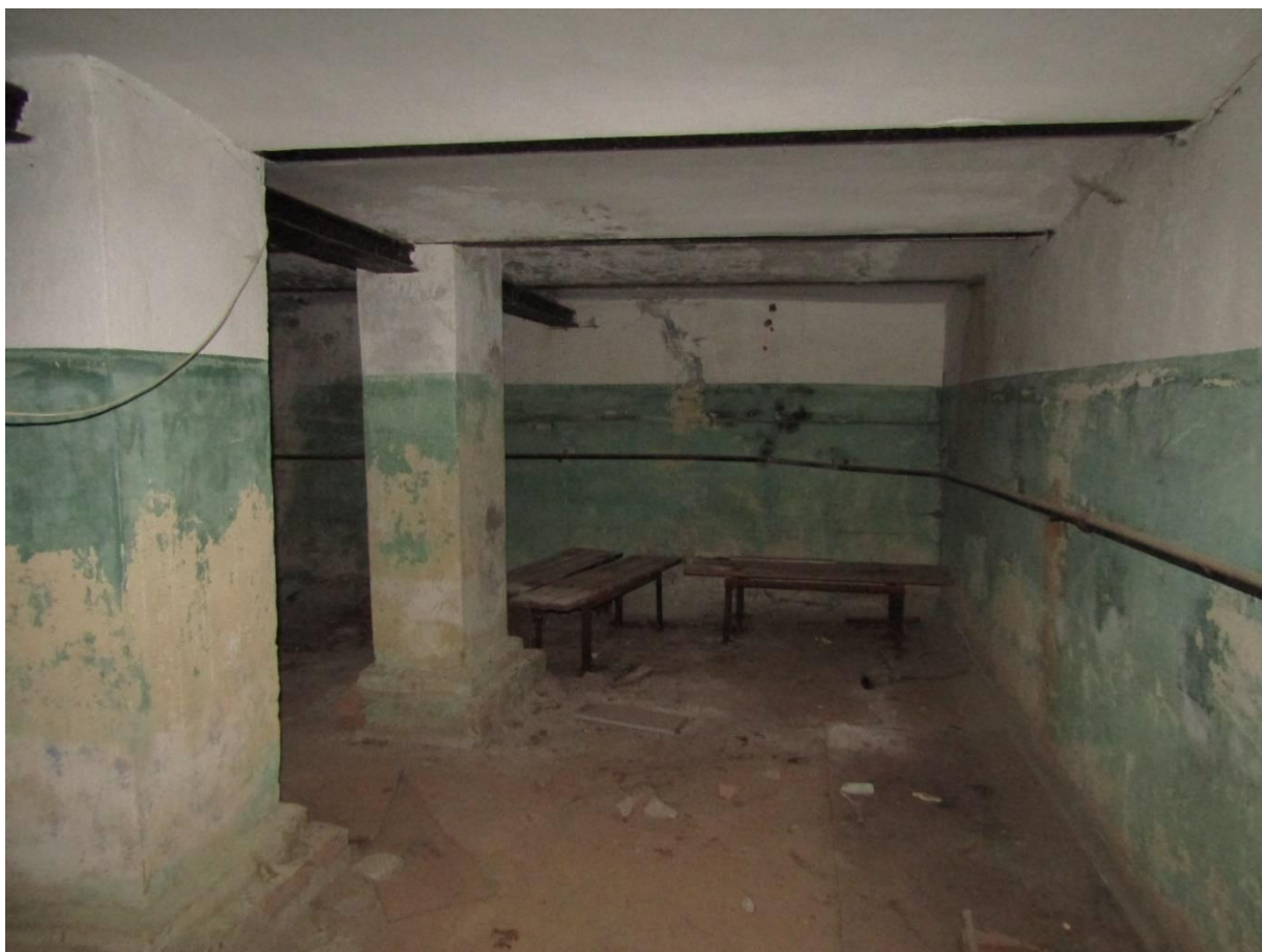
Фото 20. Интерьер подвальных помещений лицевого корпуса.
