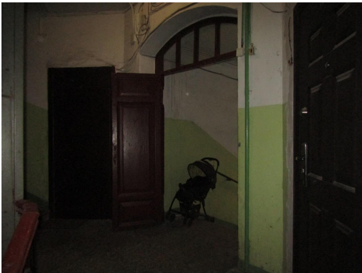
Фото 48. Вид на лестничную клетку ЗЛК в уровне 1-го этажа.
