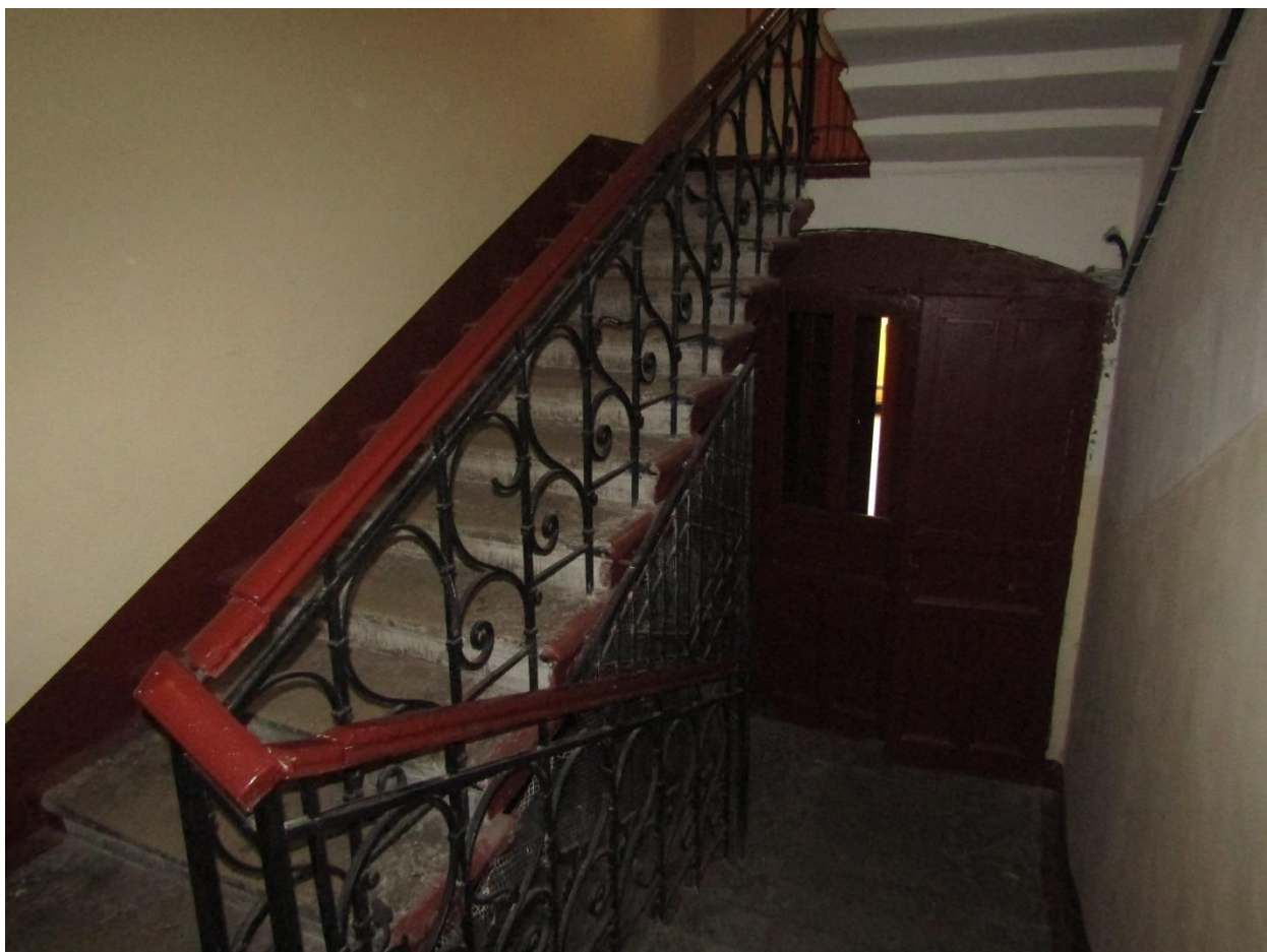
Фото 40. Вид на лестничную клетку 2ЛК в уровне 1-го этажа.
