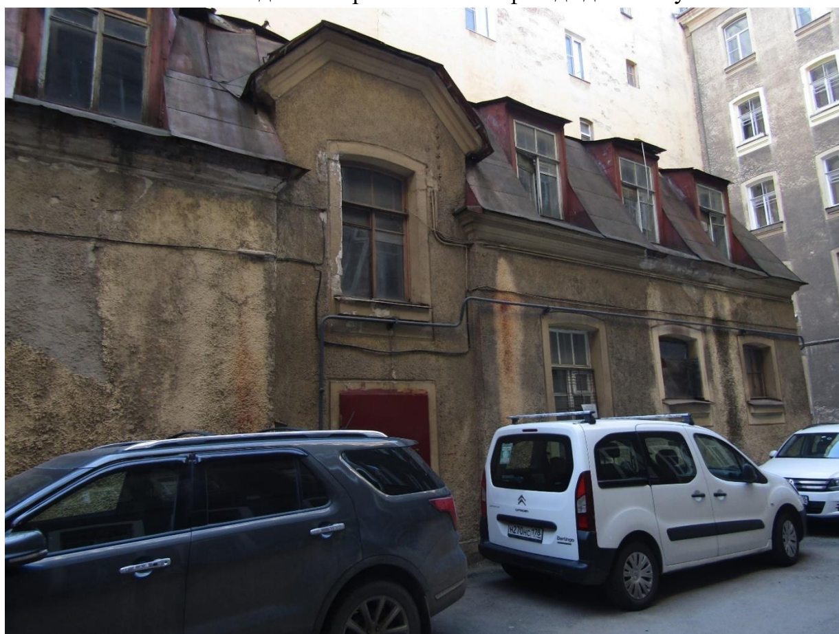
Фото 13. Вид на северо-западный фасад здания служб.
