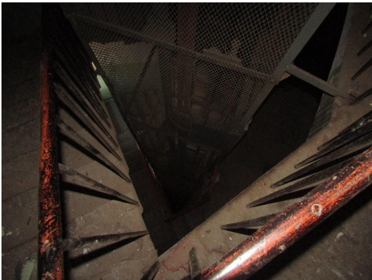
Фото 54. Вид на лестницу ЗЛК с 5-го этажа.
