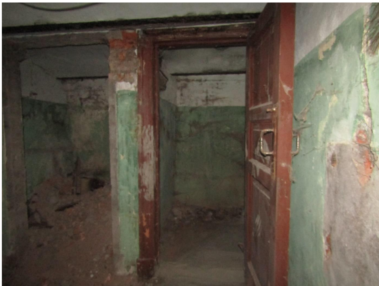
Фото 18. Интерьер подвальных помещений лицевого корпуса.
