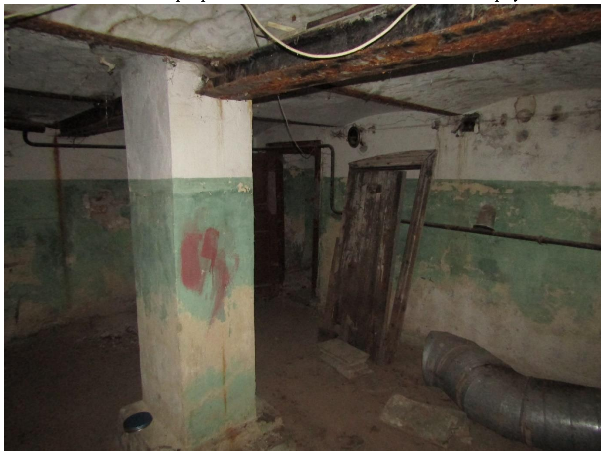
Фото 19. Интерьер подвальных помещений лицевого корпуса.
