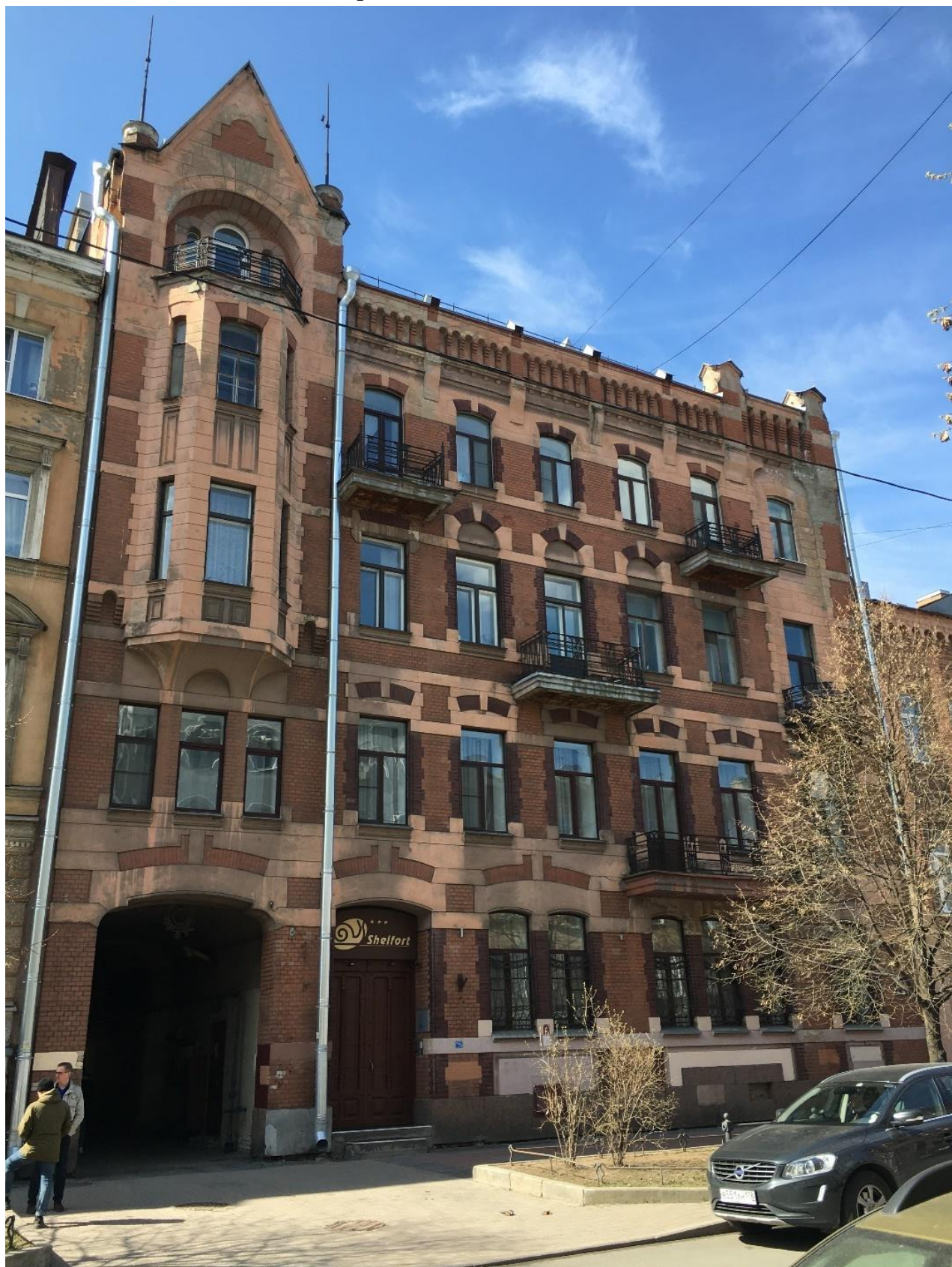
Фото 1. Общий вид северо-восточного фасада лицевого корпуса.
