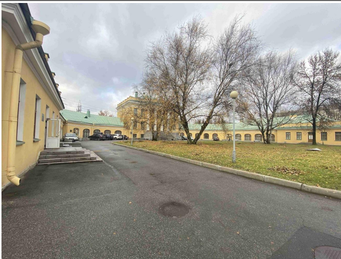
5. «Дача Дашковой «Кирияново». Санкт-Петербург, пр. Стачек, д. 45, лит. А. Общий вид на юго-восточный лицевой фасад.
