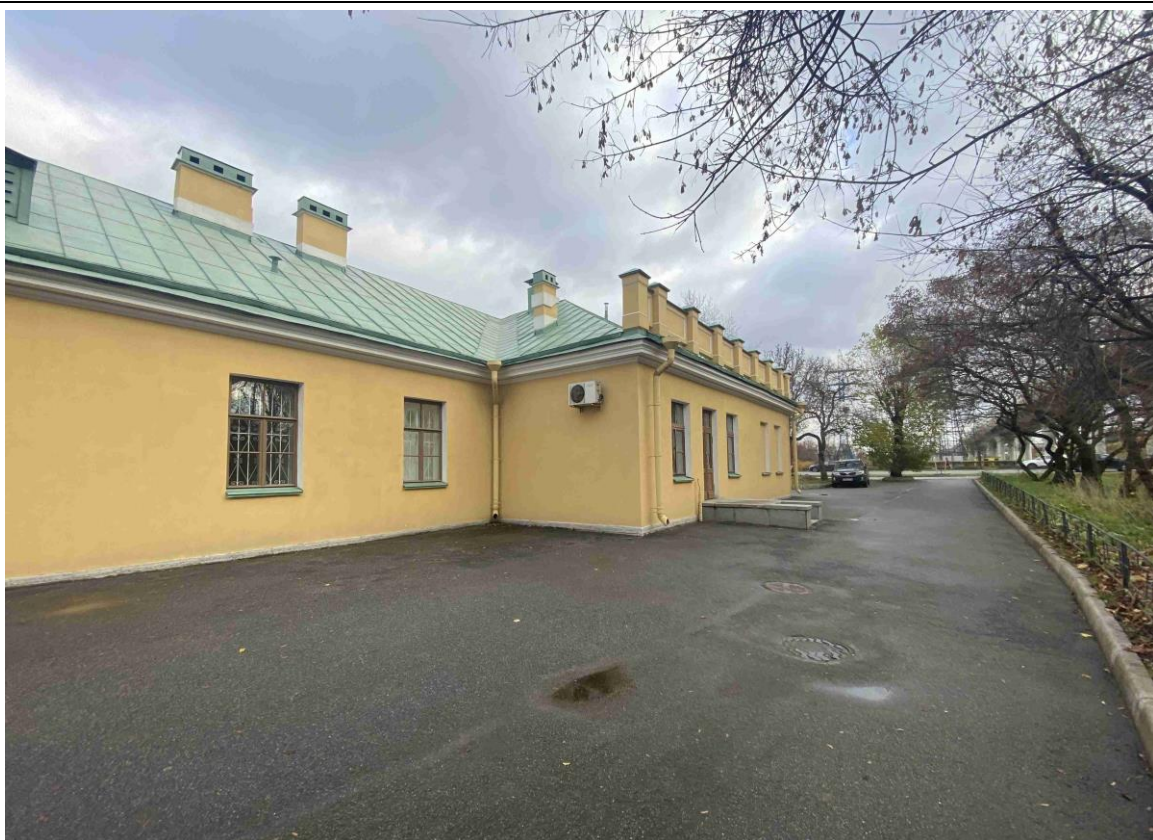
4. «Дача Дашковой «Кирияново». Санкт-Петербург, пр. Стачек, д. 45, лит. А. Общий вид на юго-западный флигель.
