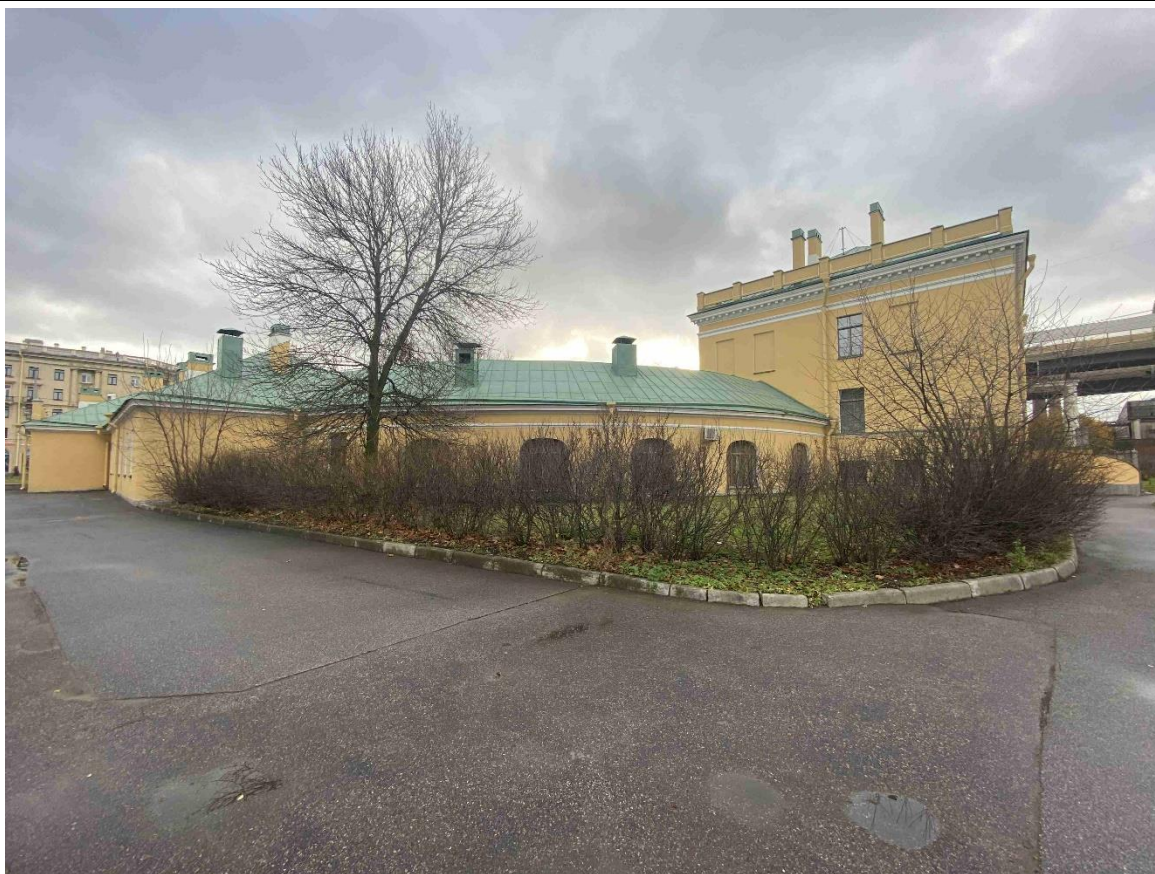
13. «Дача Дашковой «Кирияново». Санкт-Петербург, пр. Стачек, д. 45, лит. А. Общий вид на северный фасад северо-восточного крыла, соединяющего центральную часть с флигелем.
