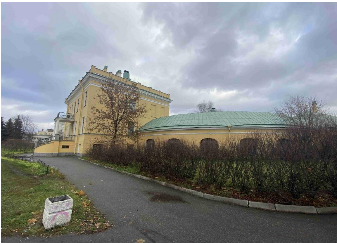
3. «Дача Дашковой «Кирияново». Санкт-Петербург, пр. Стачек, д. 45, лит. А. Общий вид на центральную часть с северо-западного лицевого фасада и юго-западное крыло, соединяющее центральную часть с флигелем.
