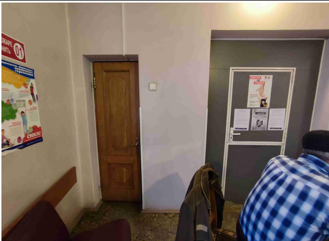
21. «Дача Дашковой «Кирьяново». Санкт-Петербург, пр. Стачек, д. 45, лит. А. Фрагмент пом. № 1-Н (63).
