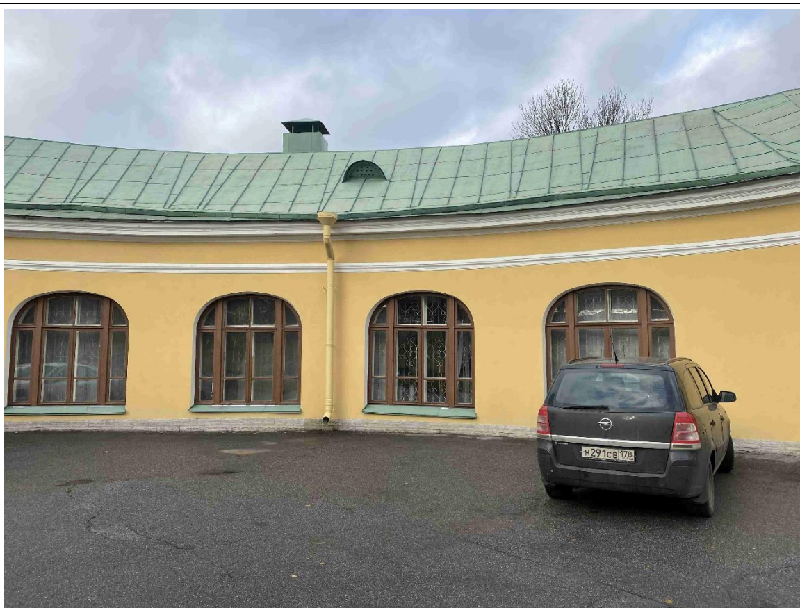
9. «Дача Дашковой «Кирияново». Санкт-Петербург, пр. Стачек, д. 45, лит. А. Фрагмент южного фасада северо-восточного крыла, соединяющего центральную часть с флигелем.
