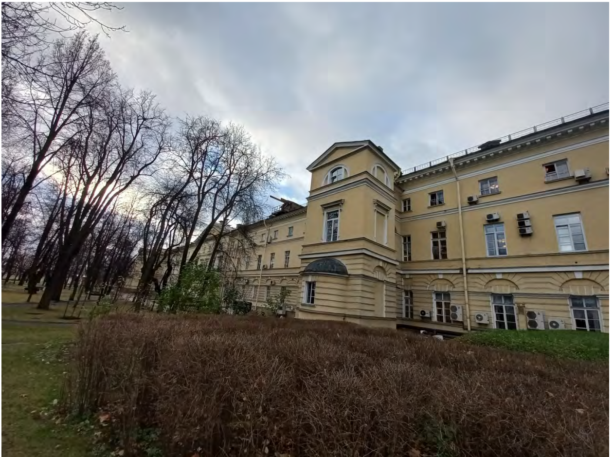
Фото 4. Северный объем лестницы. Направление съемки – юг.
