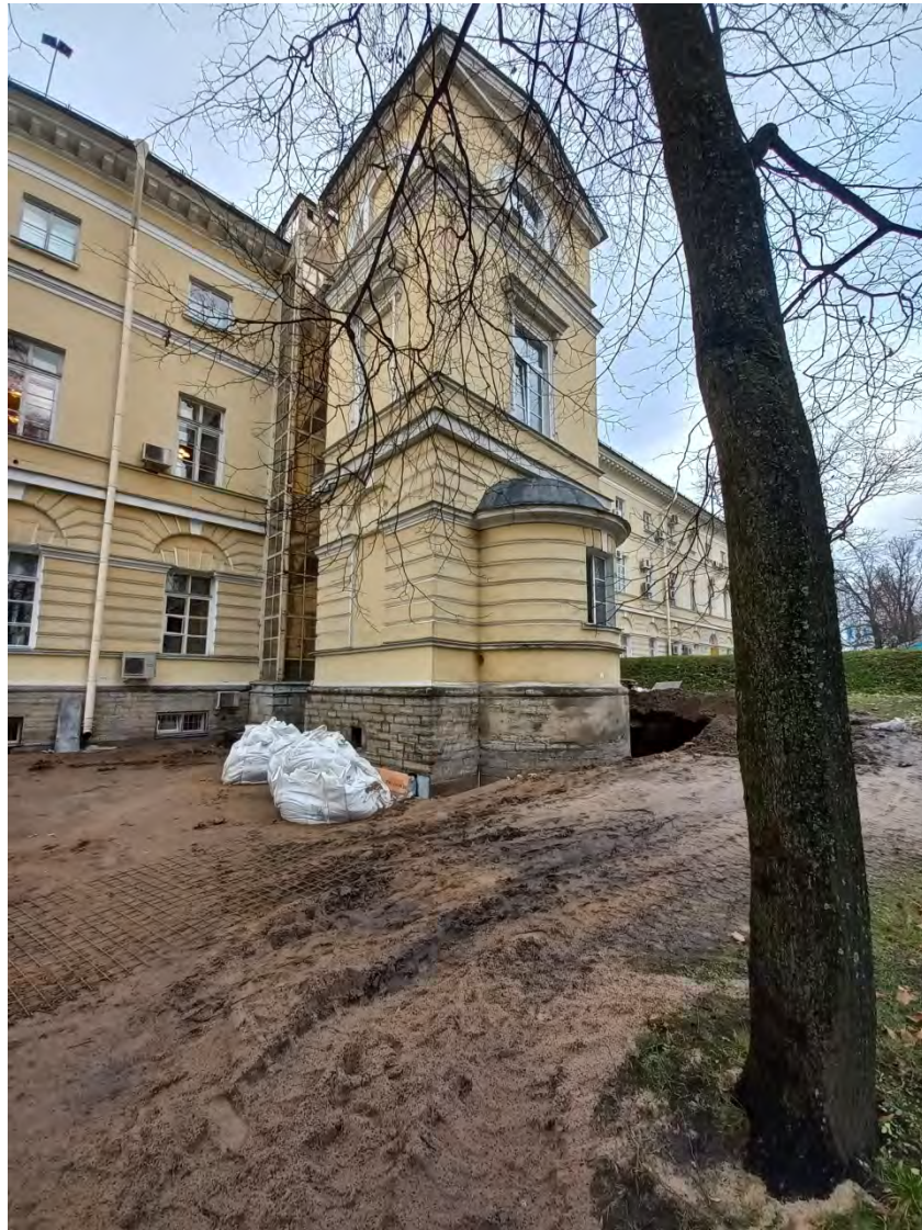
Фото 9. Северный объем лестницы. Направление съемки – северо-запад.
