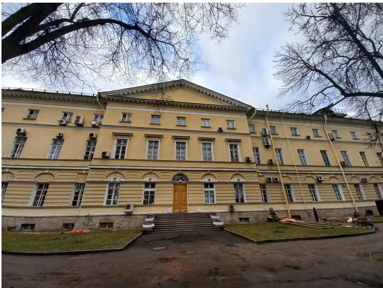
Фото 3. Общий вид фасада. Центральный вход. Направление съемки – запад.
