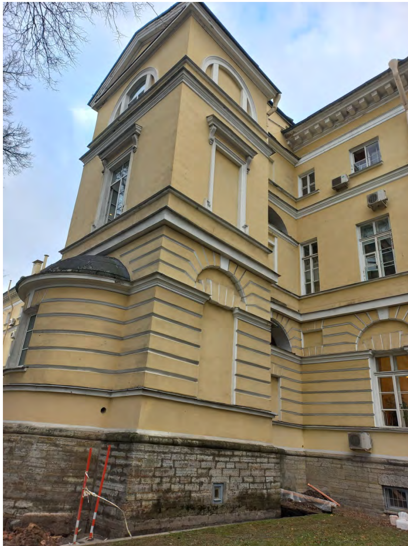
Фото 6. Южный объем лестницы. Направление съемки – юг.
