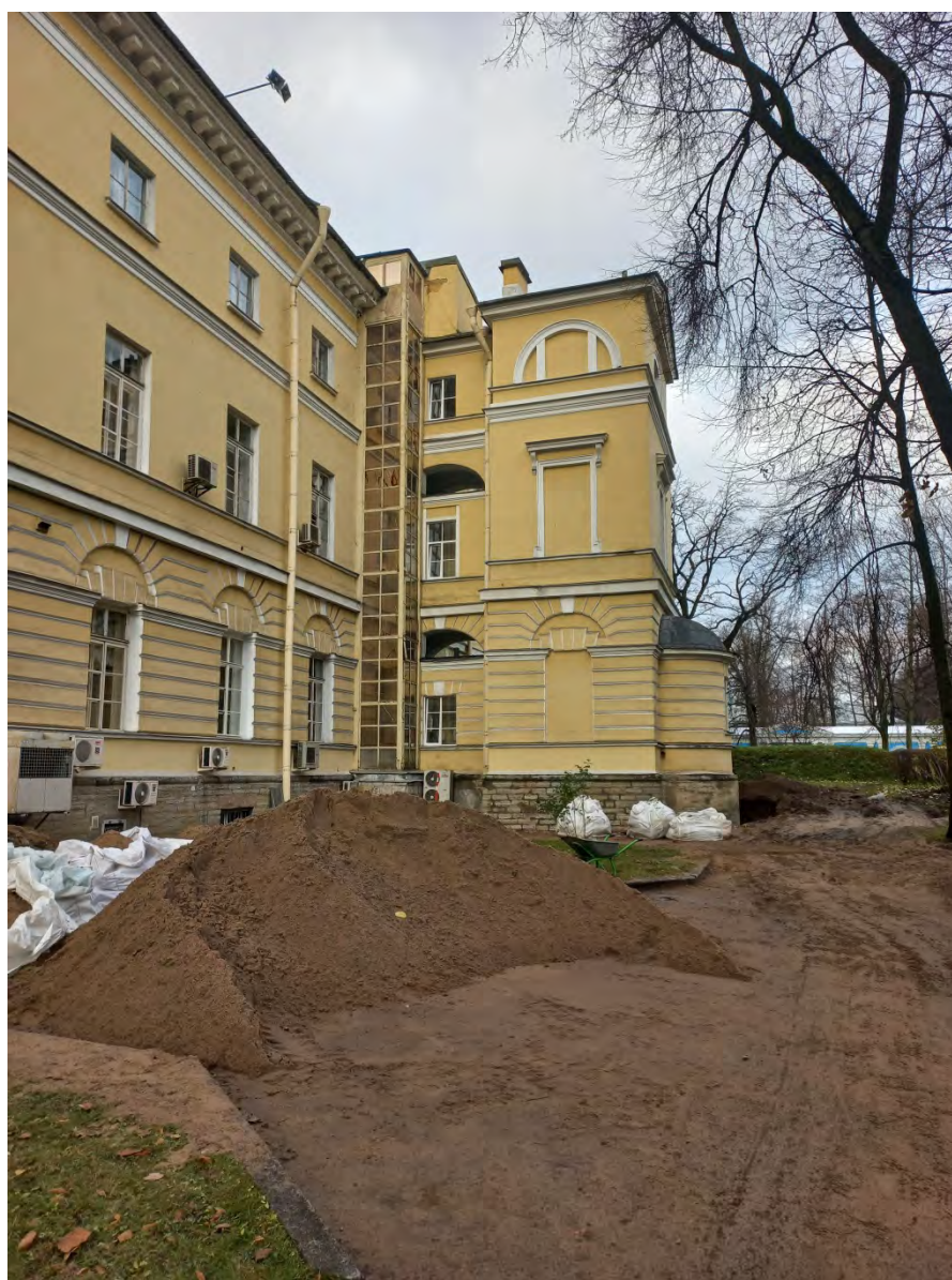
Фото 8. Северный объем лестницы. Шахта лифта. Направление съемки – север.
