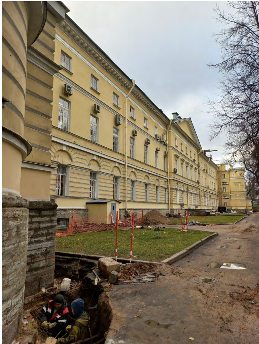
Фото 2. Общий вид фасада. Направление съемки – север.
