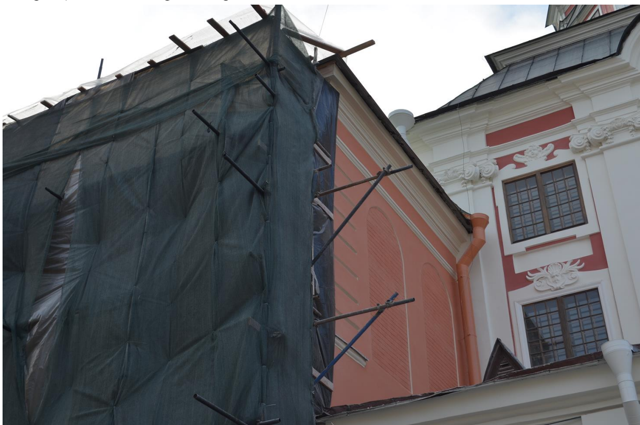
Фото 12. ОКН федерального значения «Корпус Духовской» (наб. реки Монастырки, дом 1, литера Д). Восточный фасад. Фрагмент. Съёмка 11.10.2021 г.
