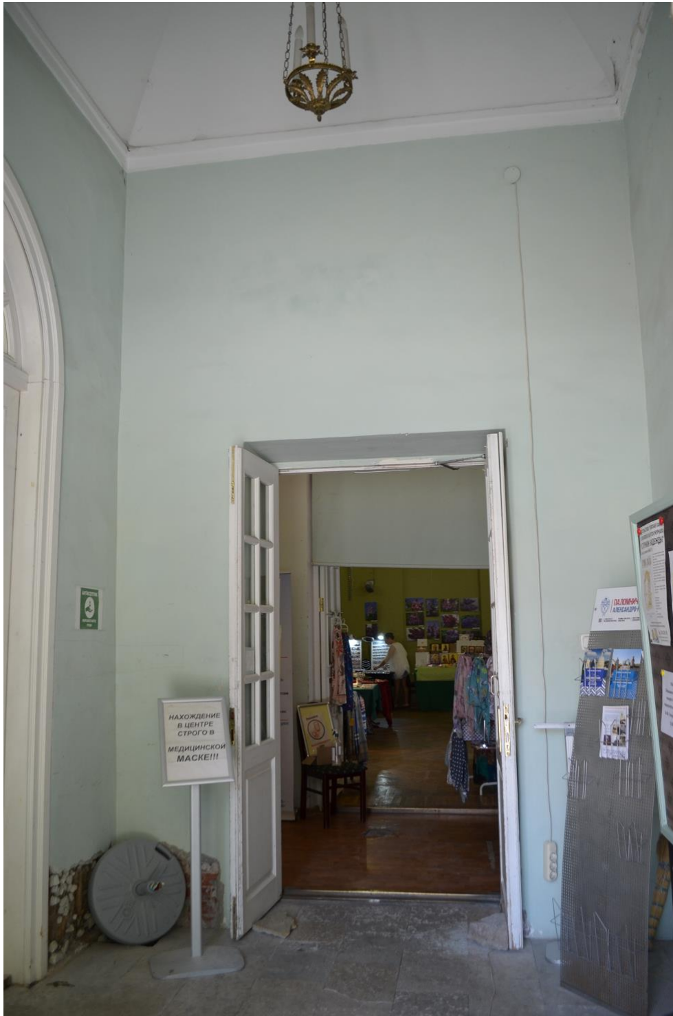
Фото 31. ОКН федерального значения «Корпус Духовской» (наб. реки Монастырки, дом 1, литера Д). Первый этаж. Помещение 6-Н (17). Съёмка 11.10.2021 г.
