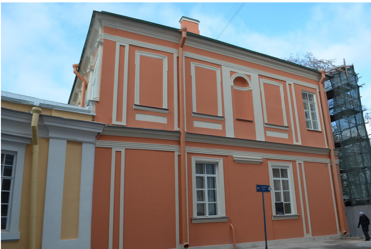
Фото 05. ОКН федерального значения «Корпус Духовской» (наб. реки Монастырки, дом 1, литера Д). Южный фасад. Общий вид. Съёмка 11.10.2021 г.
