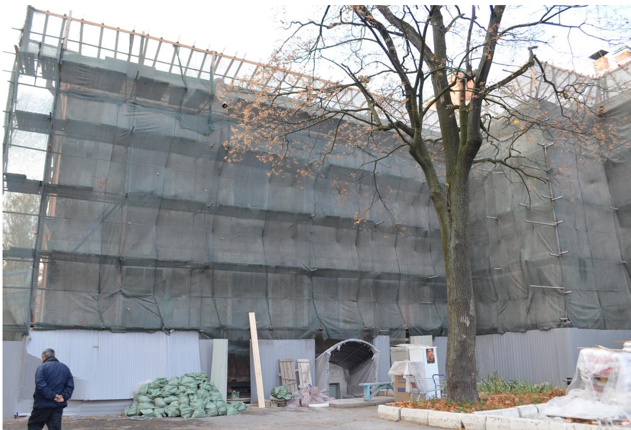
Фото 06. ОКН федерального значения «Корпус Духовской» (наб. реки Монастырки, дом 1, литера Д). Восточный фасад. Фрагмент. Съёмка 11.10.2021 г.
