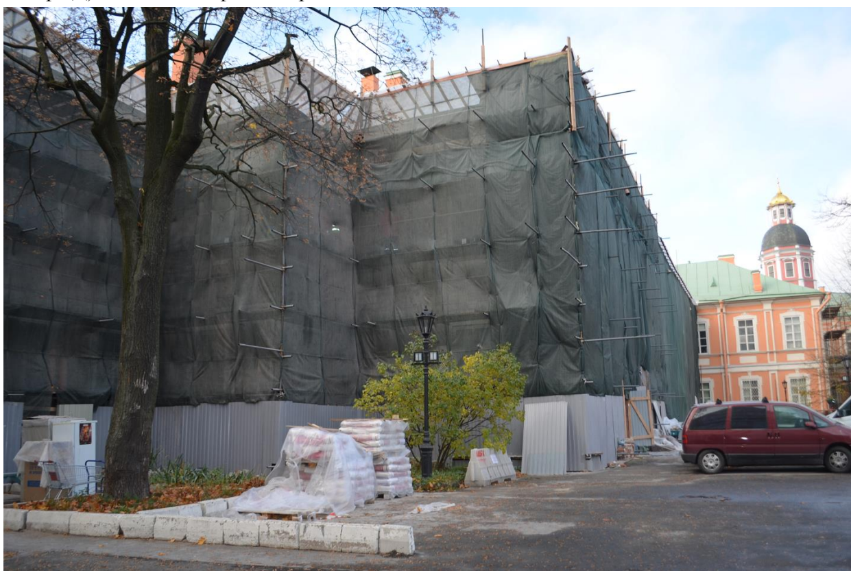
Фото 07. ОКН федерального значения «Корпус Духовской» (наб. реки Монастырки, дом 1, литера Д). Восточный фасад. Фрагмент. Съёмка 11.10.2021 г.
