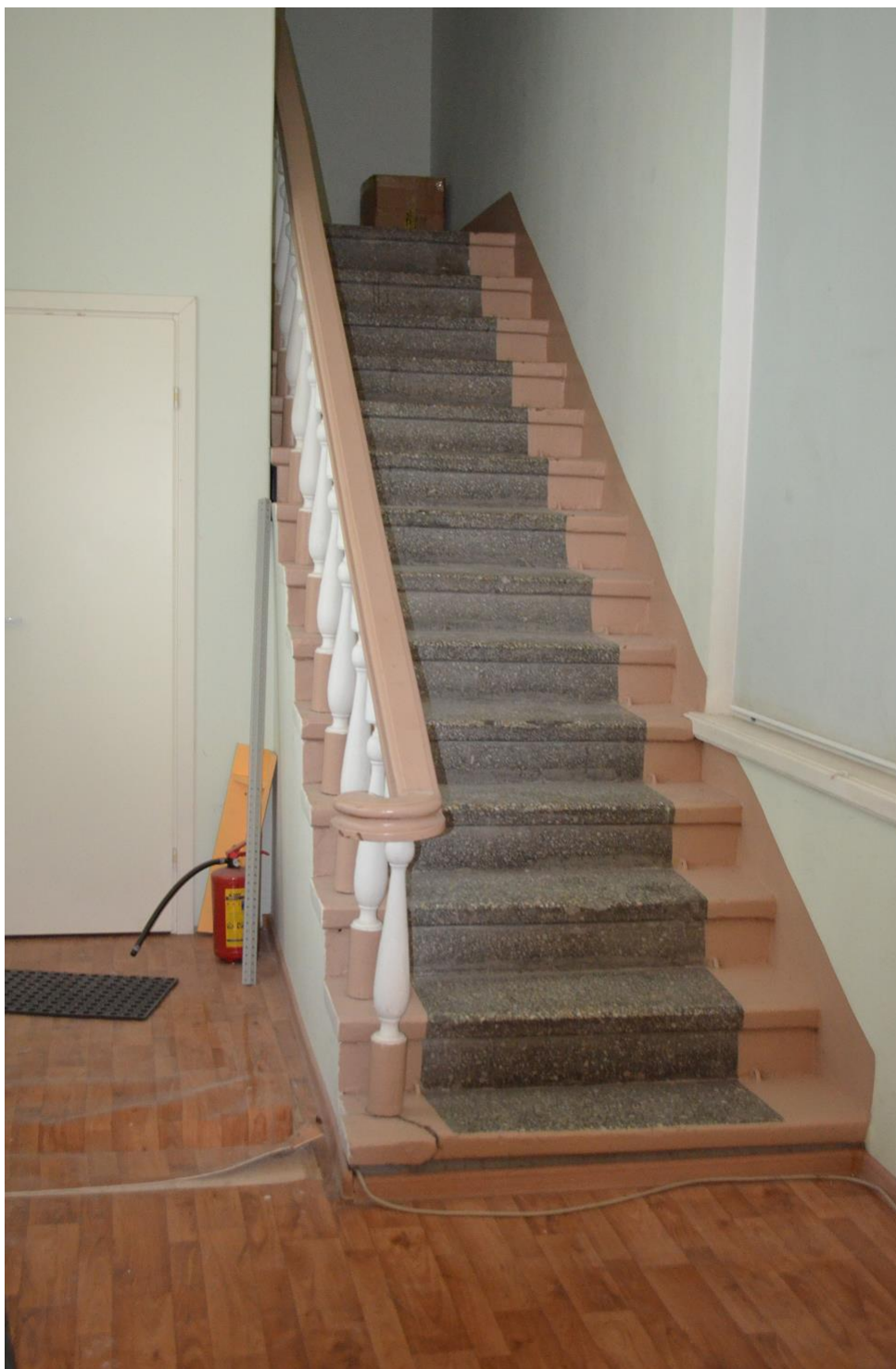
Фото 32. ОКН федерального значения «Корпус Духовской» (наб. реки Монастырки, дом 1, литера Д). Первый этаж. Помещение 6-Н (16). Съёмка 11.10.2021 г.
