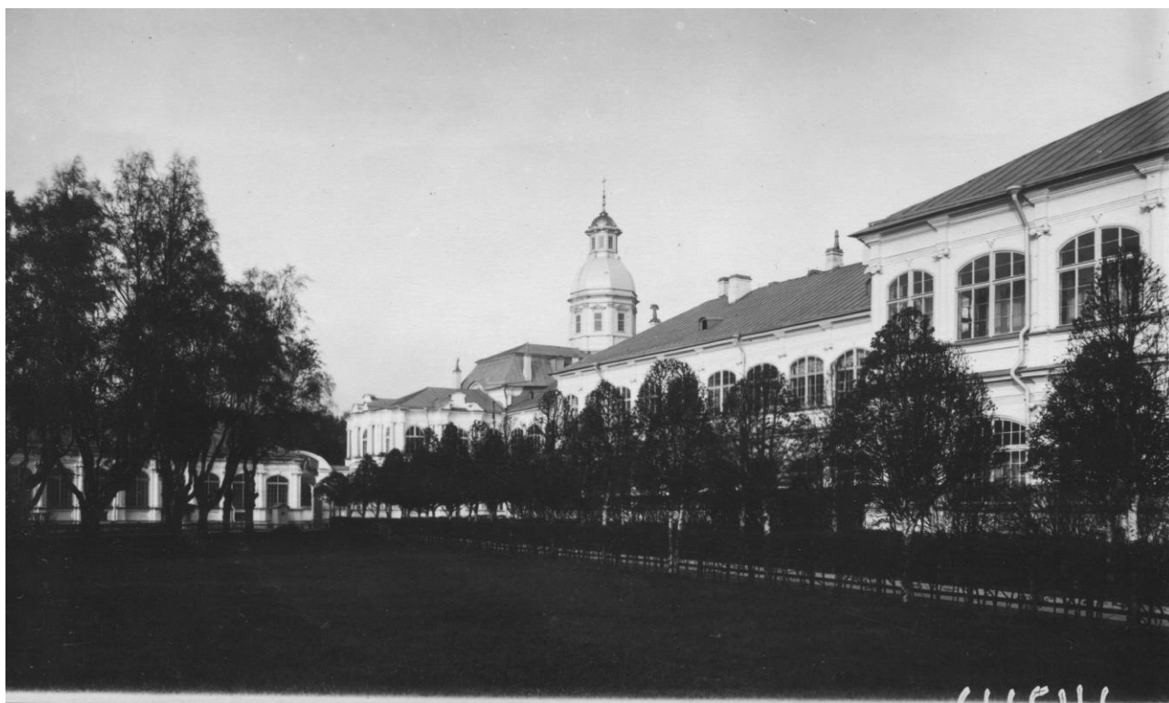
Илл.6. Западные фасады второго и третьего флигелей Духовского корпуса. 1912–1914 гг.
