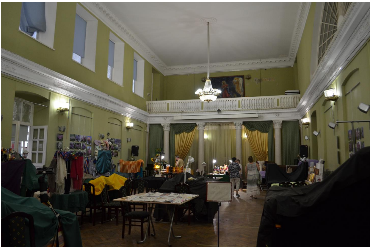
Фото 33. ОКН федерального значения «Корпус Духовской» (наб. реки Монастырки, дом 1, литера Д). Первый этаж. Помещение 6-Н (18). Съёмка 11.10.2021 г.
