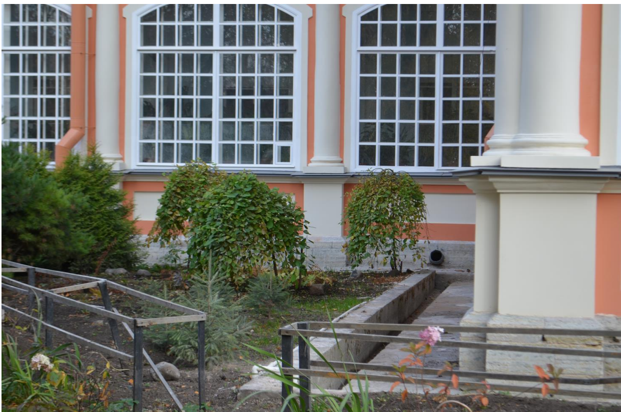
Фото 04. ОКН федерального значения «Корпус Духовской» (наб. реки Монастырки, дом 1, литера Д). Западный фасад. Фрагмент. Съёмка 11.10.2021 г.
