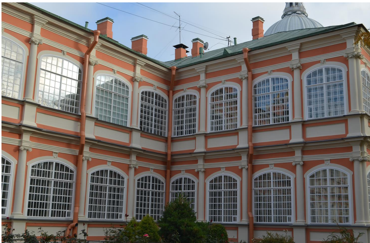
Фото 02. ОКН федерального значения «Корпус Духовской» (наб. реки Монастырки, дом 1, литера Д). Западный фасад. Фрагмент. Съёмка 11.10.2021 г.
