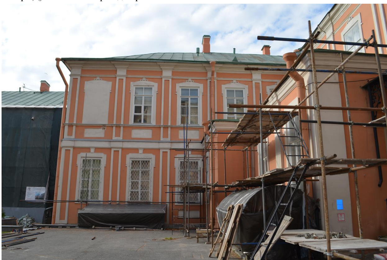
Фото 09. ОКН федерального значения «Корпус Духовской» (наб. реки Монастырки, дом 1, литера Д). Восточный фасад. Фрагмент. Съёмка 11.10.2021 г.
