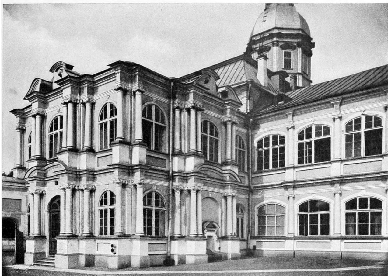
Илл. 3. Лестничная пристройка Благовещенской церкви и часть первого флигеля Духовского корпуса. 1900 (?) г.
