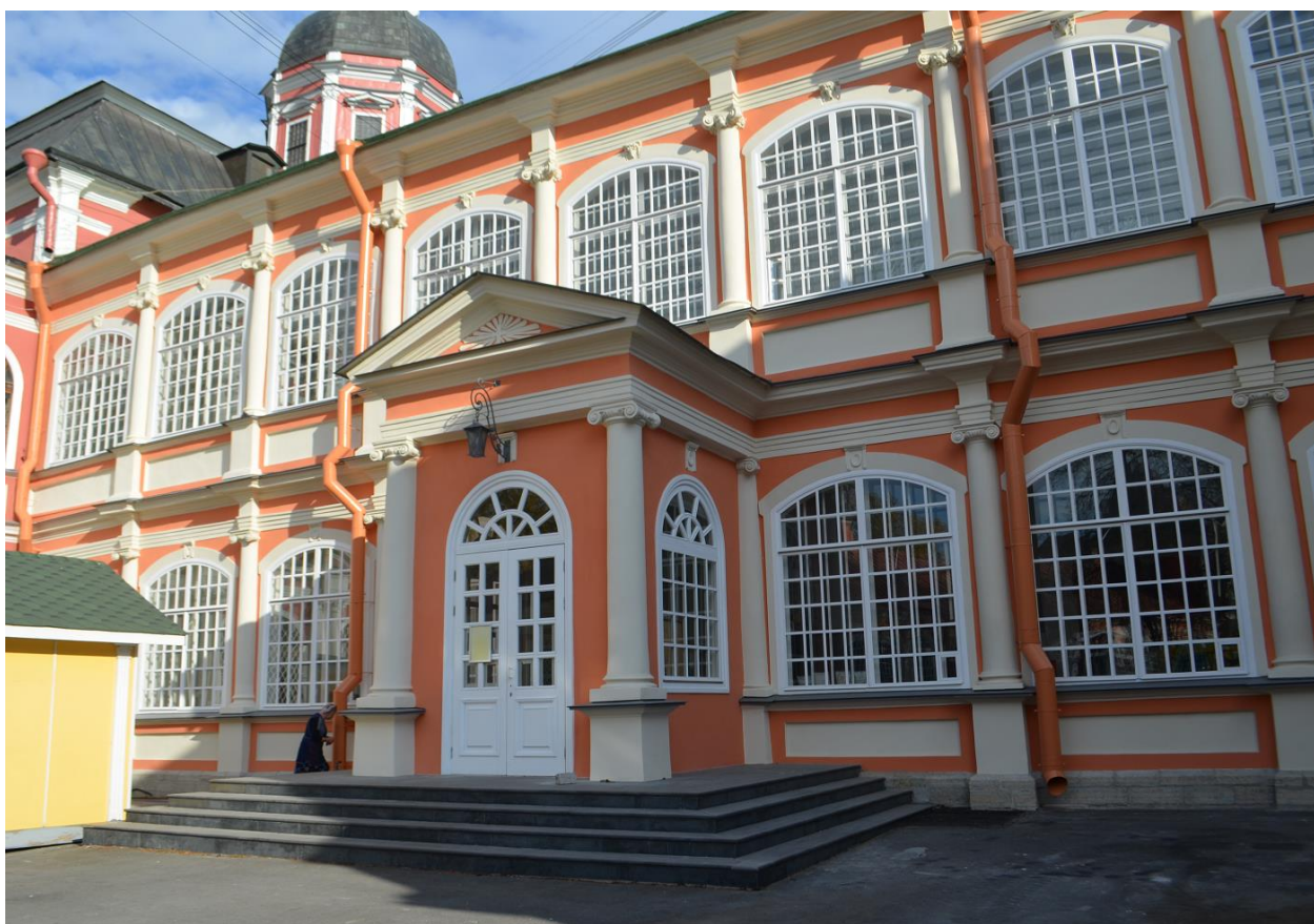
Фото 01. ОКН федерального значения «Корпус Духовской» (наб. реки Монастырки, дом 1, литера Д). Западный фасад. Фрагмент. Съёмка 11.10.2021 г.
