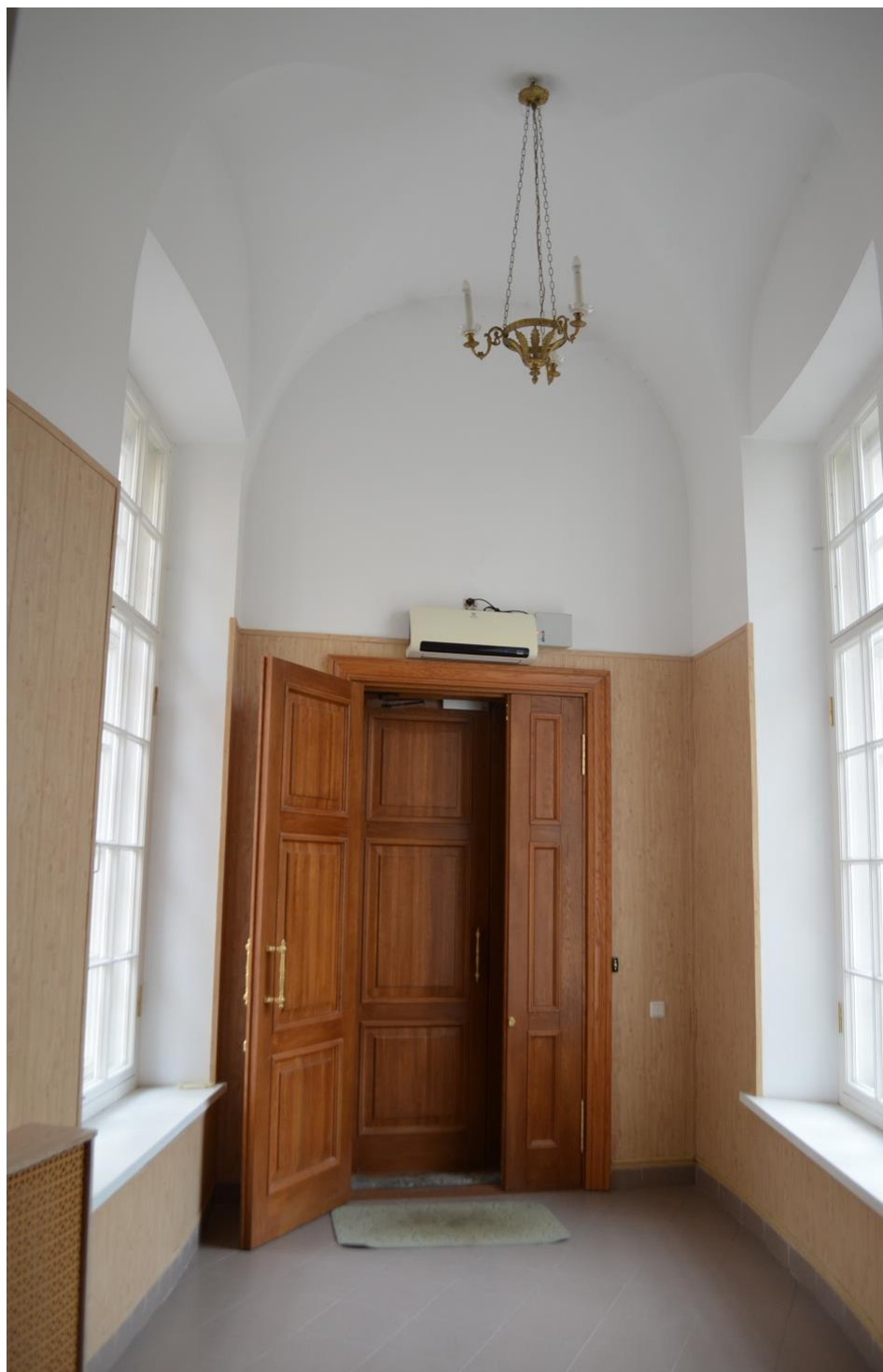
Фото 18. ОКН федерального значения «Корпус Духовской» (наб. реки Монастырки, дом 1, литера Д). Первый этаж. Помещение 7-Н (1). Съёмка 11.10.2021 г.
