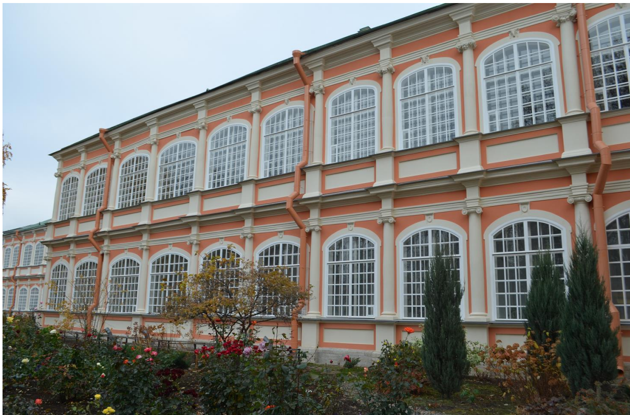
Фото 03. ОКН федерального значения «Корпус Духовской» (наб. реки Монастырки, дом 1, литера Д). Западный фасад. Фрагмент. Съёмка 11.10.2021 г.
