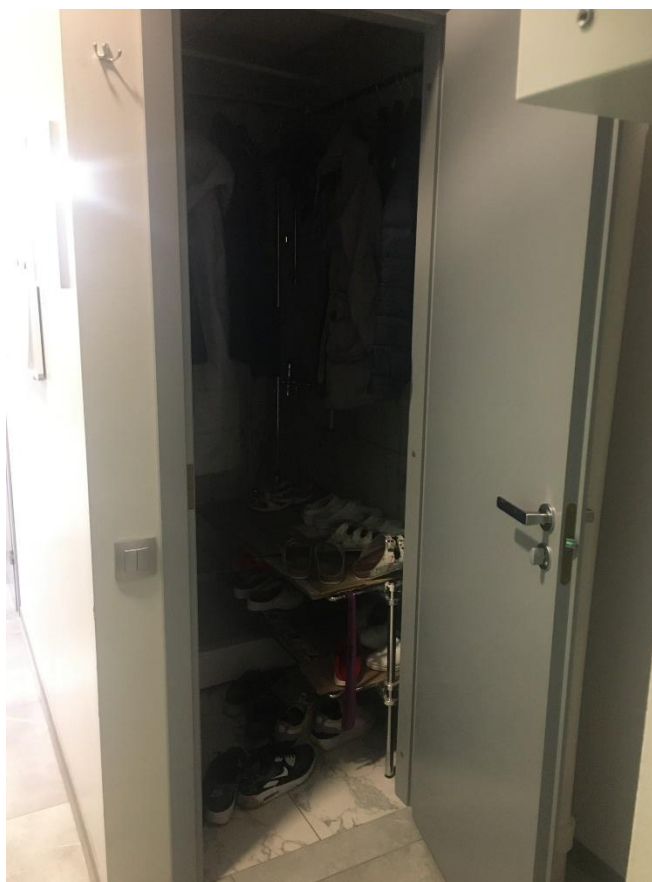
20. Фотофиксация 2-го этажа здания Невский пр., д.82, литера А. Квартира № 44. Техническое помещение.
