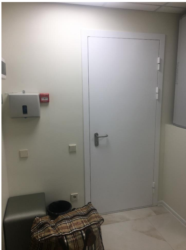
25. Фотофиксация 5-го этажа здания Невский пр., д.82, литера А. Квартира № 50. Коридор.
