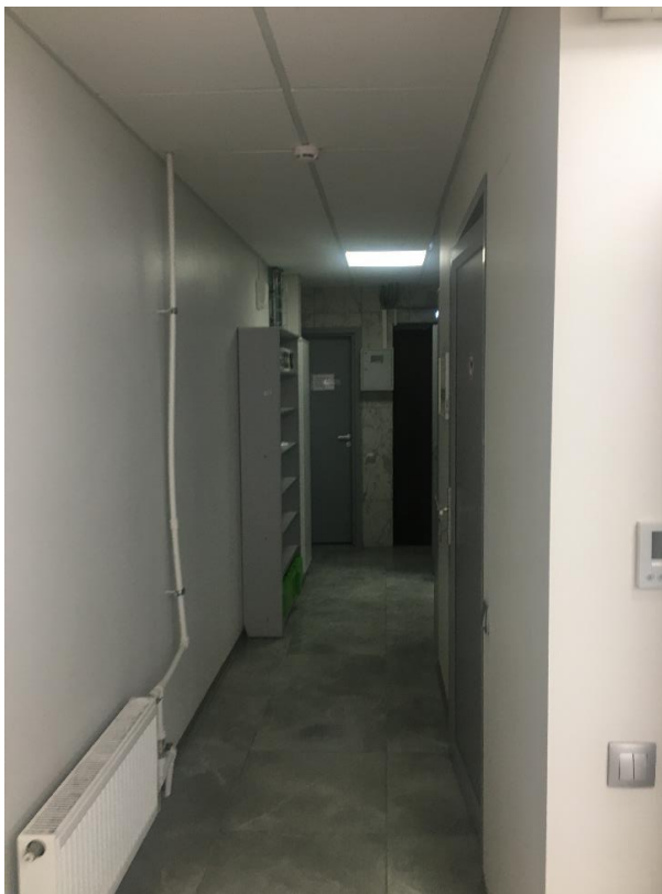
13. Фотофиксация 3-го этажа здания Невский пр., д.82, литера А. Квартира 46. Коридор.
