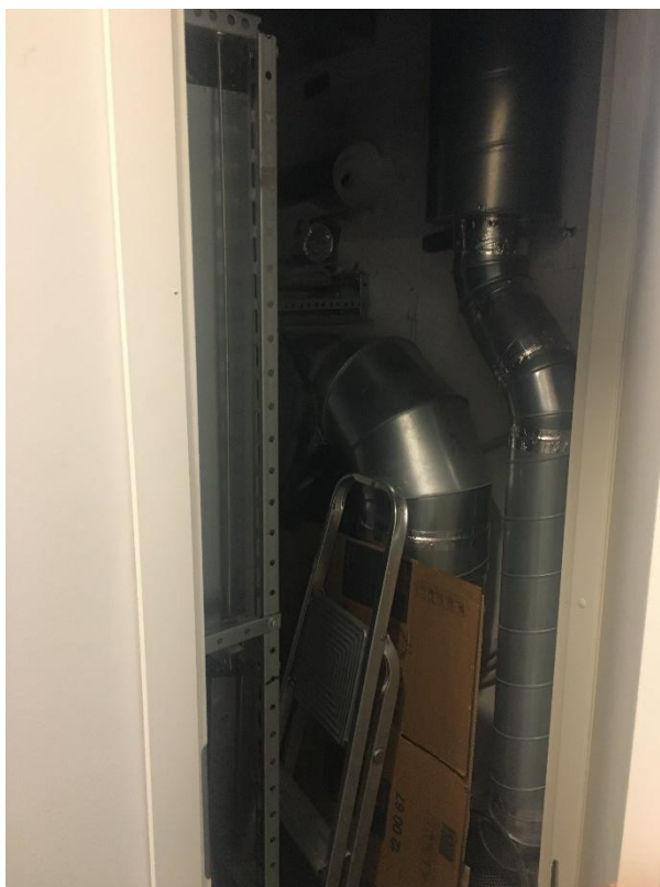
21. Фотофиксация 2-го этажа здания Невский пр., д.82, литера А. Квартира № 44. Техническое помещение.
