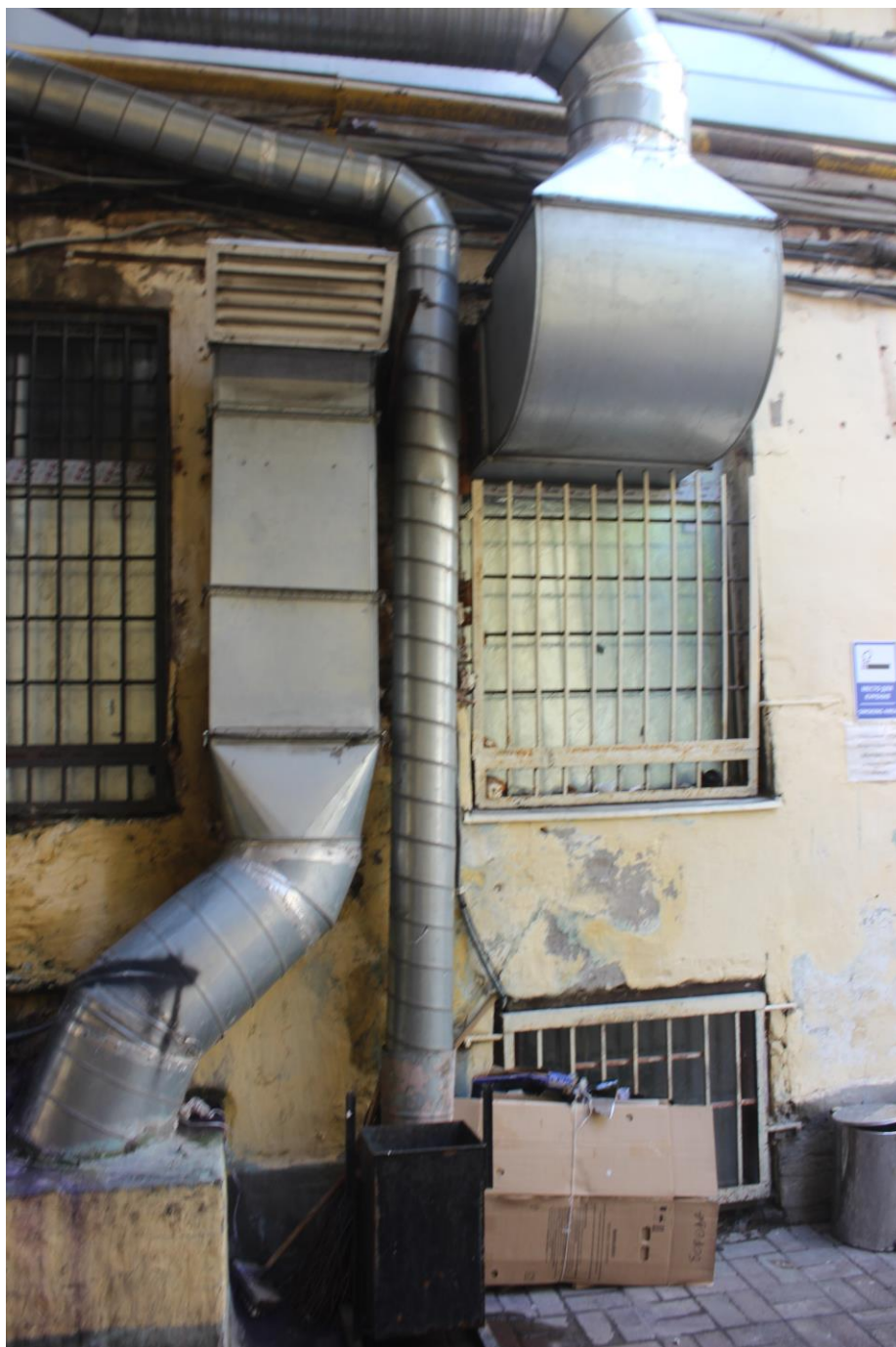
8. Здание по адресу: Санкт-Петербург, Казанская улица, д. 8-10, Лит. А. Дворовый фасад северного лицевого корпуса. Справа оконные проемы помещения 23-Н. На фасадах инженерное оборудование помещения 23-Н.
