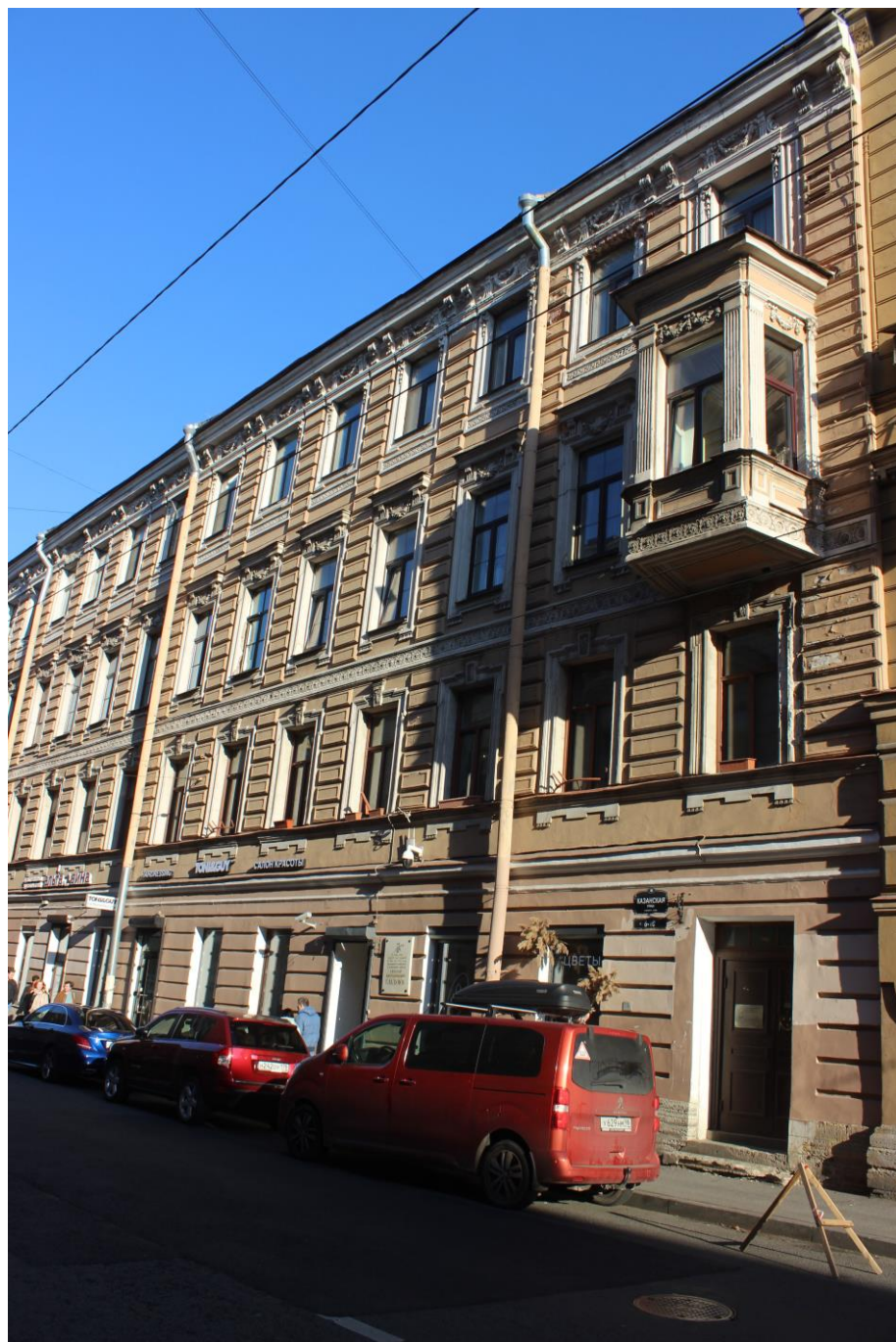
4. Здание по адресу: Санкт-Петербург, Казанская улица, д. 8-10, Лит. А Фрагмент лицевого фасада южного лицевого корпуса.
