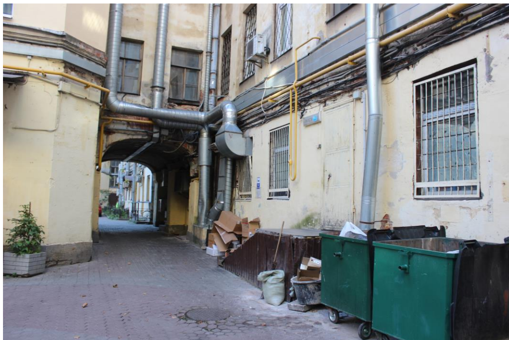
7. Здание по адресу: Санкт-Петербург, Казанская улица, д. 8-10, Лит. А. Дворовый фасад северного лицевого корпуса. Справа оконные проемы помещения 23-Н. На фасадах инженерное оборудование помещения 23-Н.
