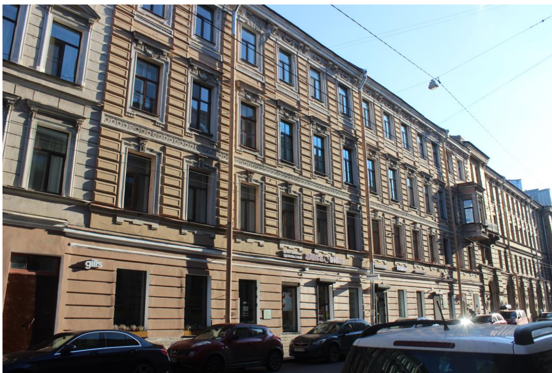
2. Здание по адресу: Санкт-Петербург, Казанская улица, д. 8-10, Лит. А. Фрагмент лицевого фасада южного лицевого корпуса.
