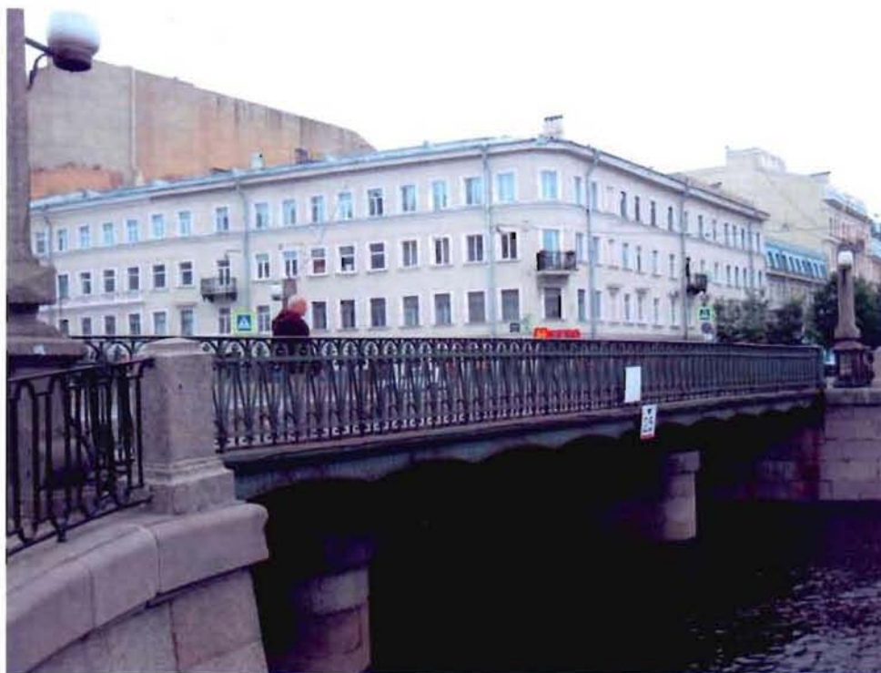
3. Вид моста со стороны низового фасада
