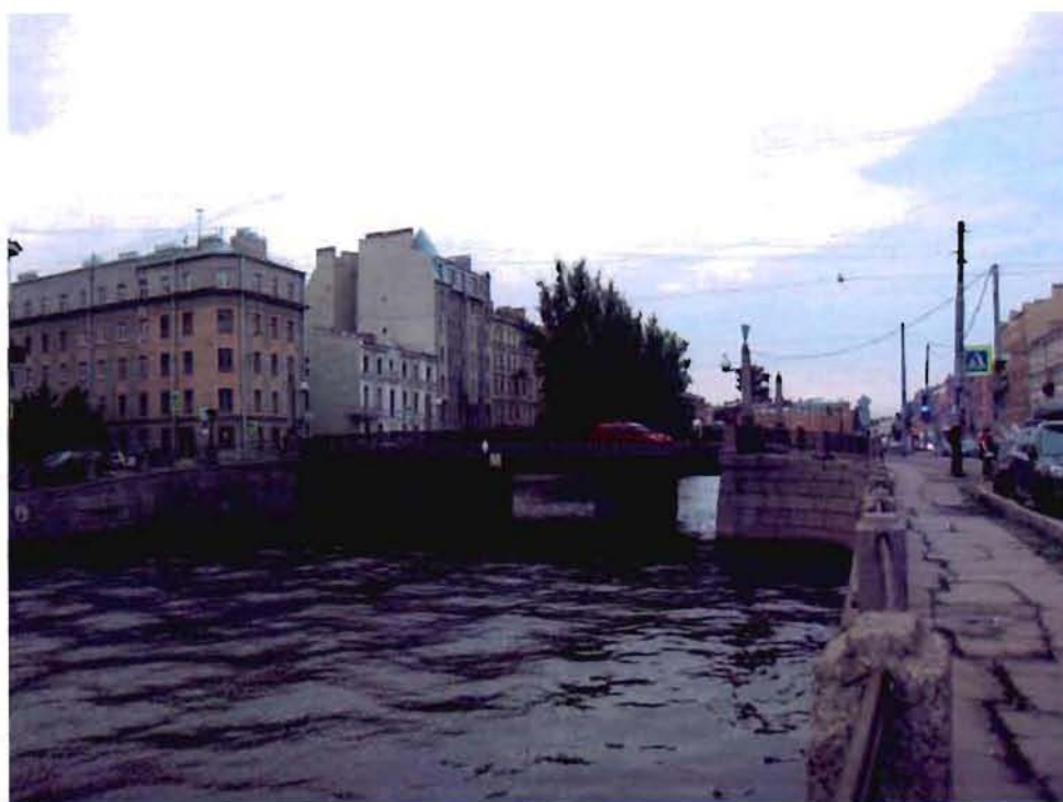
2. Вид моста со стороны верхового фасада
