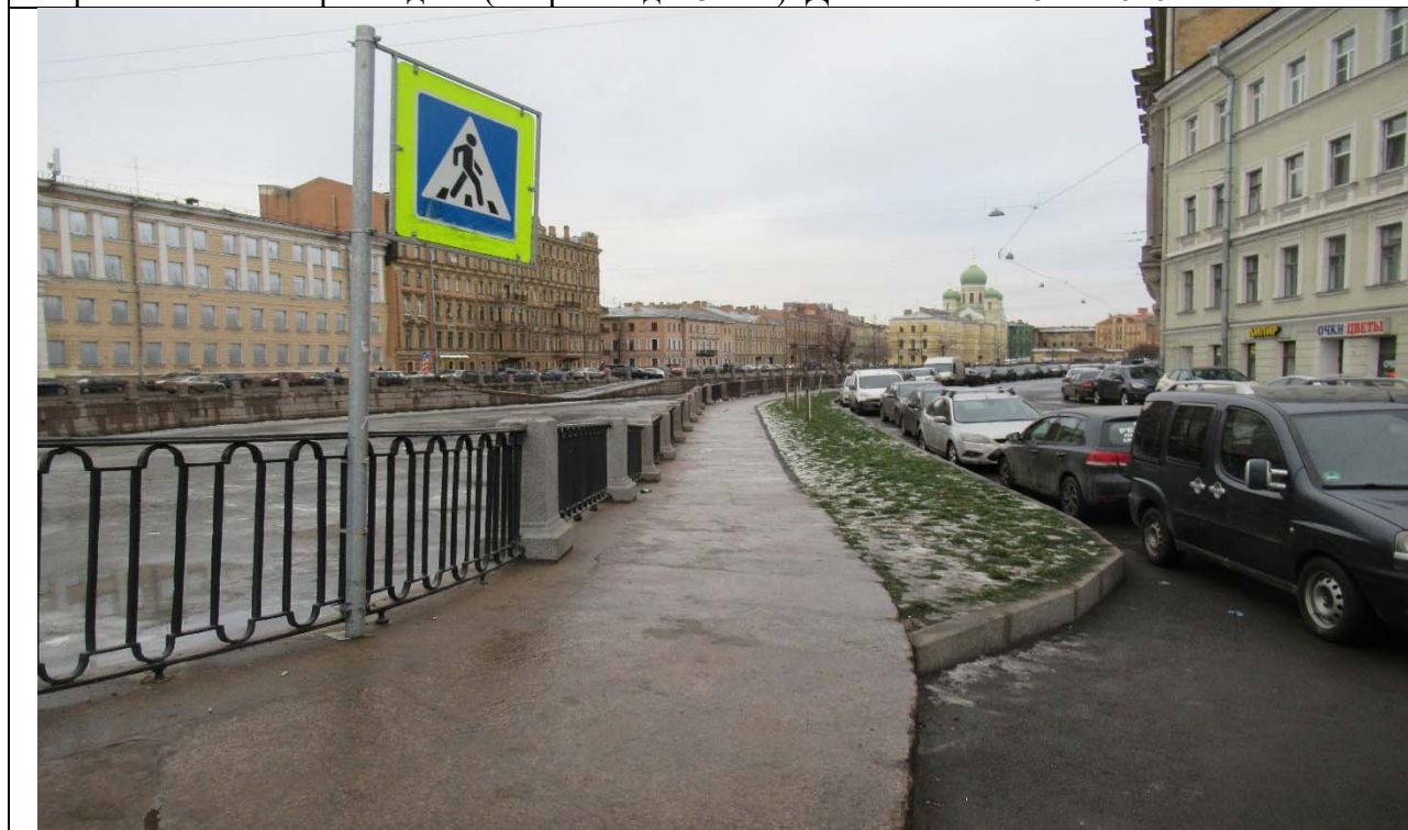
16. ОКН ФЗ «Мост Аларчин», входящий в состав комплекса «Набережные и мосты Екатерининского канала (ныне канала Грибоедова)» по адресу: г. Санкт-Петербург, через канал Грибоедова по Английскому пр. Вид от моста вдоль наб. кан. Грибоедова напротив д. 152. Дата съемки: 16.11.2020 г.
