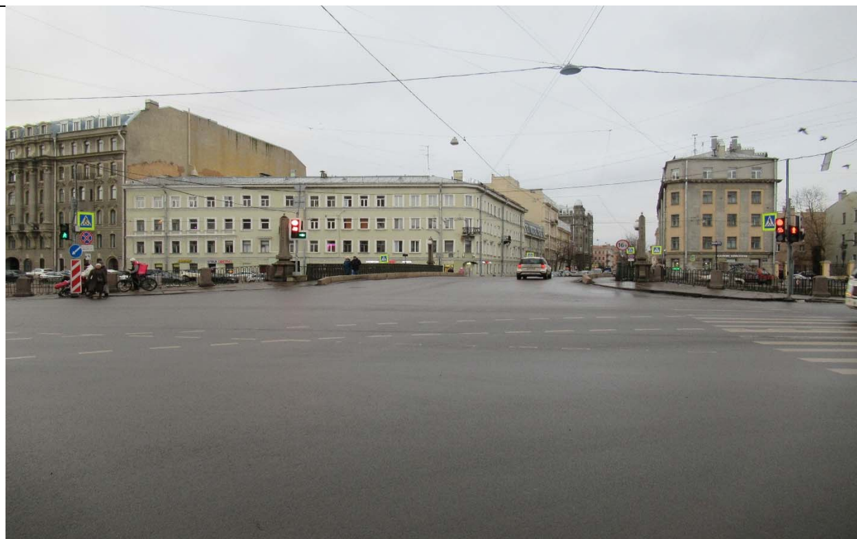
23. ОКН ФЗ «Мост Аларчин», входящий в состав комплекса «Набережные и мосты Екатерининского канала (ныне канала Грибоедова)» по адресу: г. Санкт-Петербург, через канал Грибоедова по Английскому пр. Вид на проезжую часть моста со стороны просп. Римского-Корсакова. Дата съемки: 16.11.2020 г.
