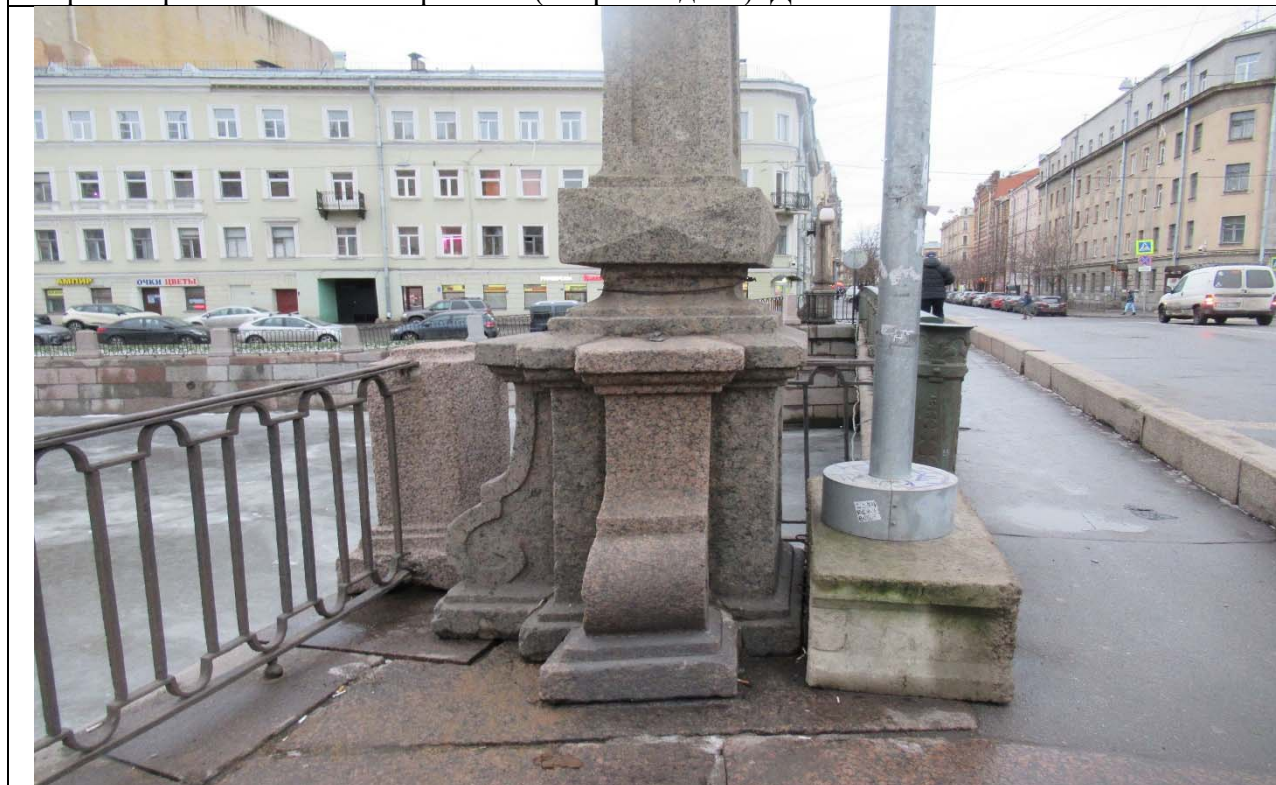
14. ОКН ФЗ «Мост Аларчин», входящий в состав комплекса «Набережные и мосты Екатерининского канала (ныне канала Грибоедова)» по адресу: г. Санкт-Петербург, через канал Грибоедова по Английскому пр. Постаменты, парапетная профилированная тумба со стороны просп. Римского-Корсакова (напротив д. 71). Дата съемки: 16.11.2020 г.
