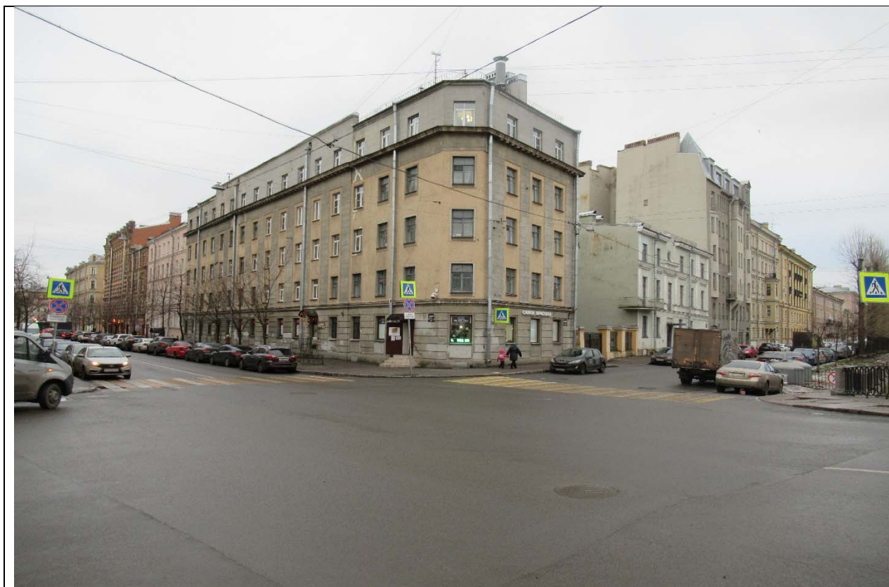
21. ОКН ФЗ «Мост Аларчин», входящий в состав комплекса «Набережные и мосты Екатерининского канала (ныне канала Грибоедова)» по адресу: г. Санкт-Петербург, через канал Грибоедова по Английскому пр. Вид от моста на здание по наб. кан. Грибоедова, 154. Дата съемки: 16.11.2020 г.
