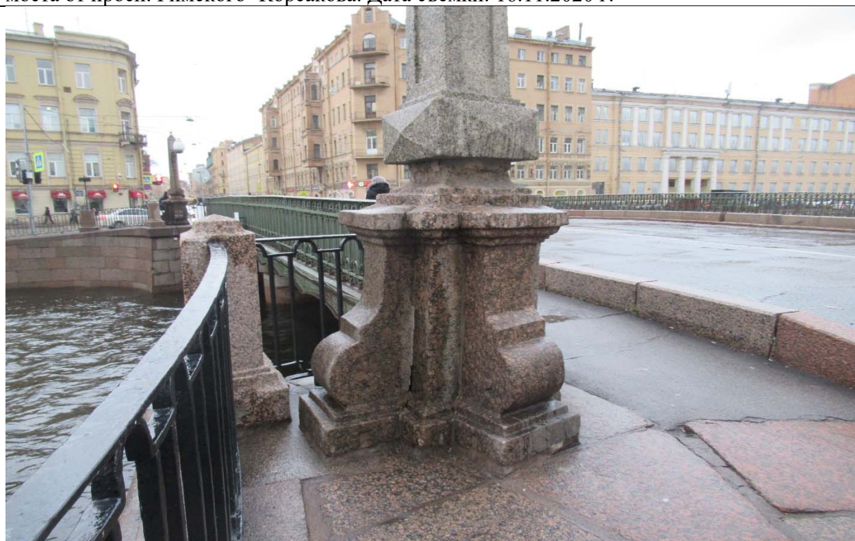
10. ОКН ФЗ «Мост Аларчин», входящий в состав комплекса «Набережные и мосты Екатерининского канала (ныне канала Грибоедова)» по адресу: г. Санкт-Петербург, через канал Грибоедова по Английскому пр. Постаменты, парапетная профилированная тумба со стороны наб. кан. Грибоедова (напротив д. 154). Дата съемки: 16.11.2020 г.
