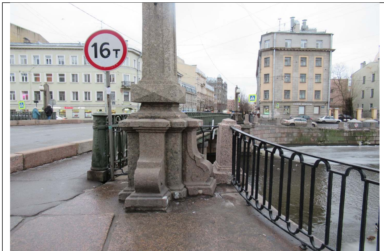
13. ОКН ФЗ «Мост Аларчин», входящий в состав комплекса «Набережные и мосты Екатерининского канала (ныне канала Грибоедова)» по адресу: г. Санкт-Петербург, через канал Грибоедова по Английскому пр. Постаменты, парапетная профилированная тумба со стороны просп. Римского-Корсакова (напротив д. 73). Дата съемки: 16.11.2020 г.
