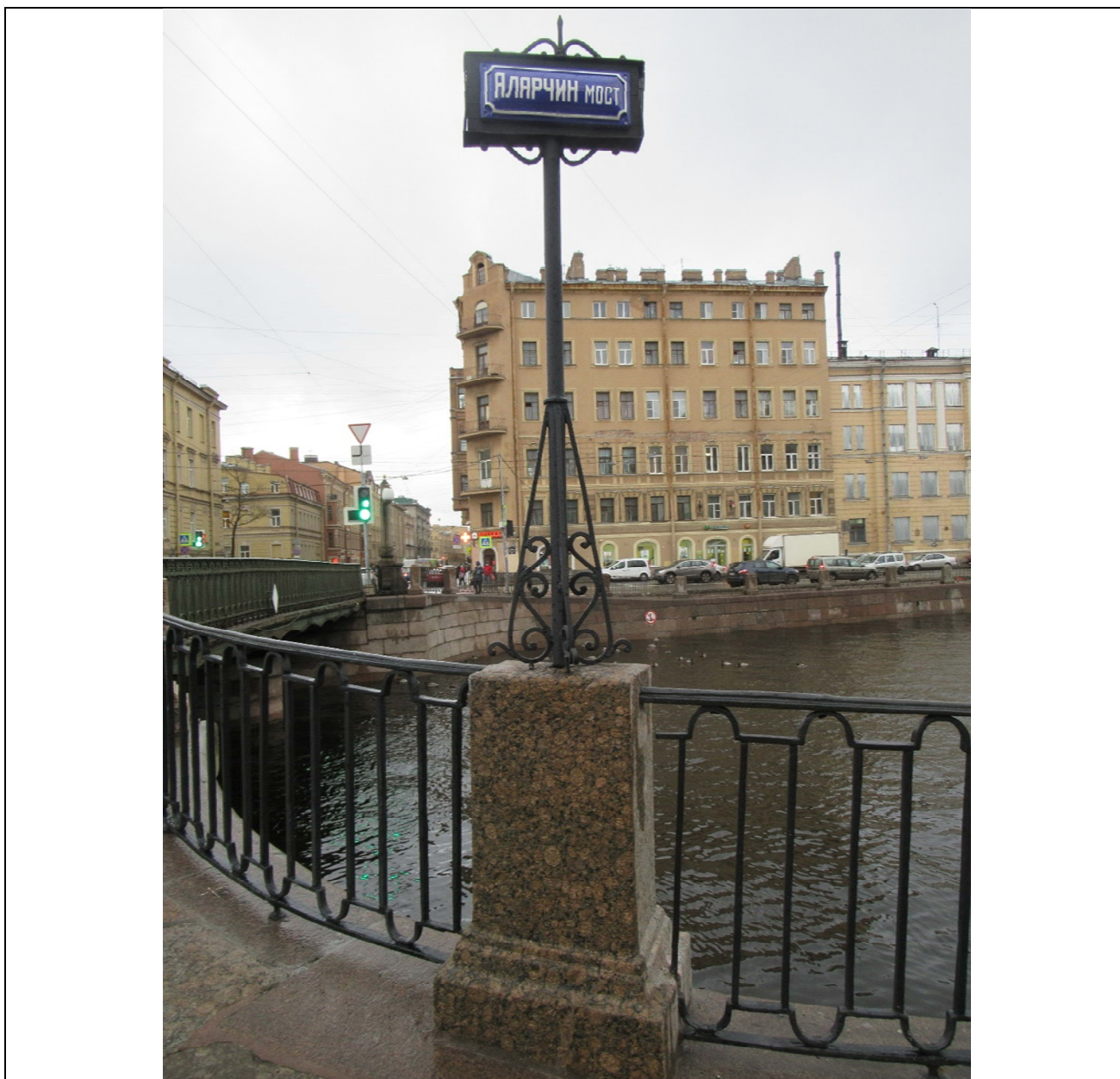
6. ОКН ФЗ «Мост Аларчин», входящий в состав комплекса «Набережные и мосты Екатерининского канала (ныне канала Грибоедова)» по адресу: г. Санкт-Петербург, через канал Грибоедова по Английскому пр. Декоративная стойка для таблички и табличка с названием моста (со стороны наб.кан. Грибоедова) и вид на набережную со стороны проспекта Римского-Корсакова. Дата съемки: 16.11.2020 г.
