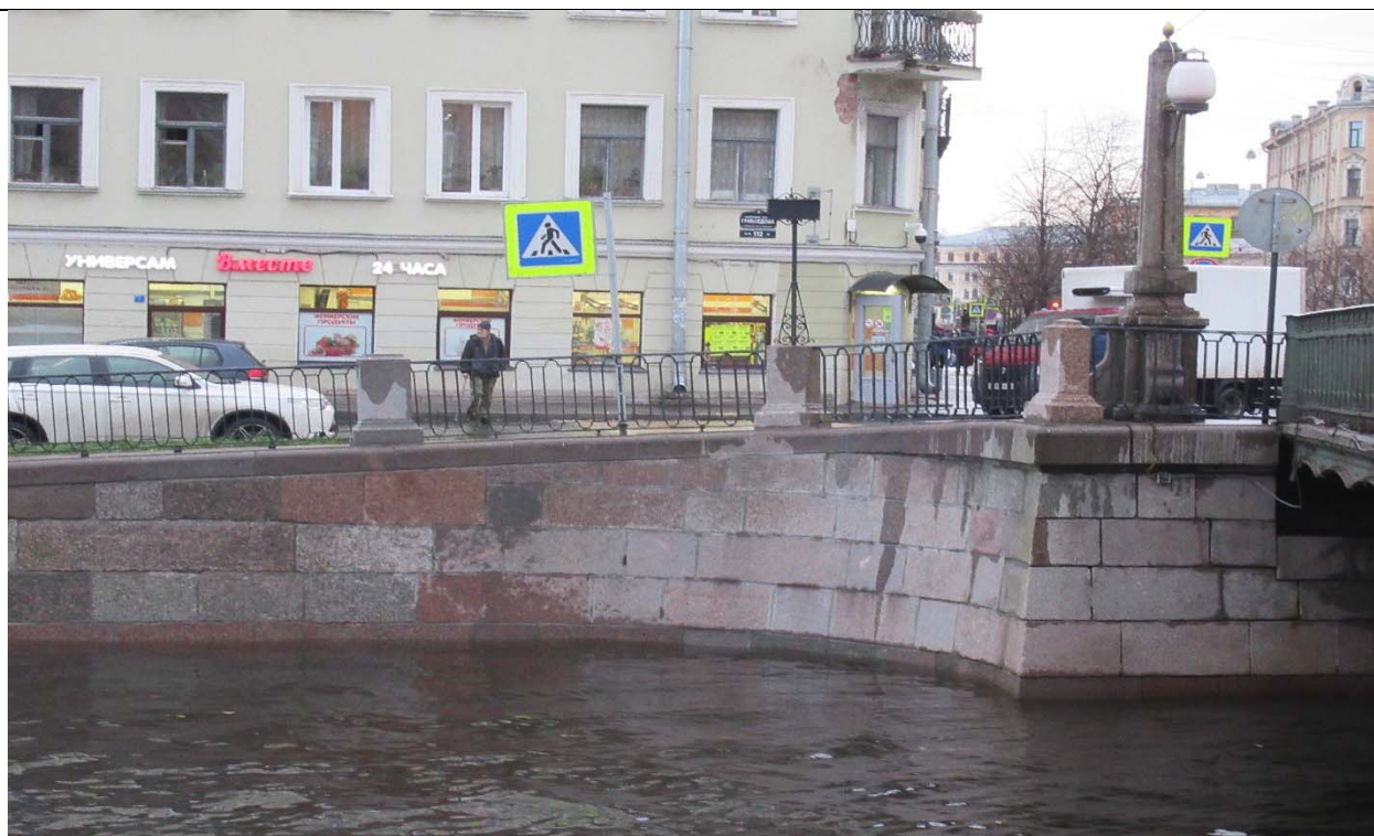
3. ОКН ФЗ «Мост Аларчин», входящий в состав комплекса «Набережные и мосты Екатерининского канала (ныне канала Грибоедова)» по адресу: г. Санкт-Петербург, через канал Грибоедова по Английскому пр. Вид на береговые устои моста, расположенные со стороны наб. кан. Грибоедова. Дата съемки: 16.11.2020 г.
