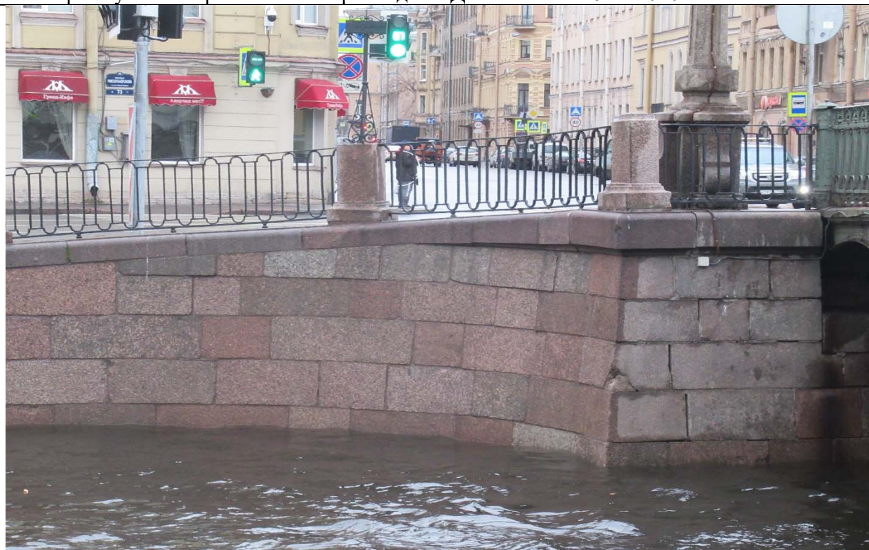
8. ОКН ФЗ «Мост Аларчин», входящий в состав комплекса «Набережные и мосты Екатерининского канала (ныне канала Грибоедова)» по адресу: г. Санкт-Петербург, через канал Грибоедова по Английскому пр. Вид на береговые устои моста, гранитную стеллу и набережную со стороны просп. Римского-Корсакова. Дата съемки: 16.11.2020 г.
