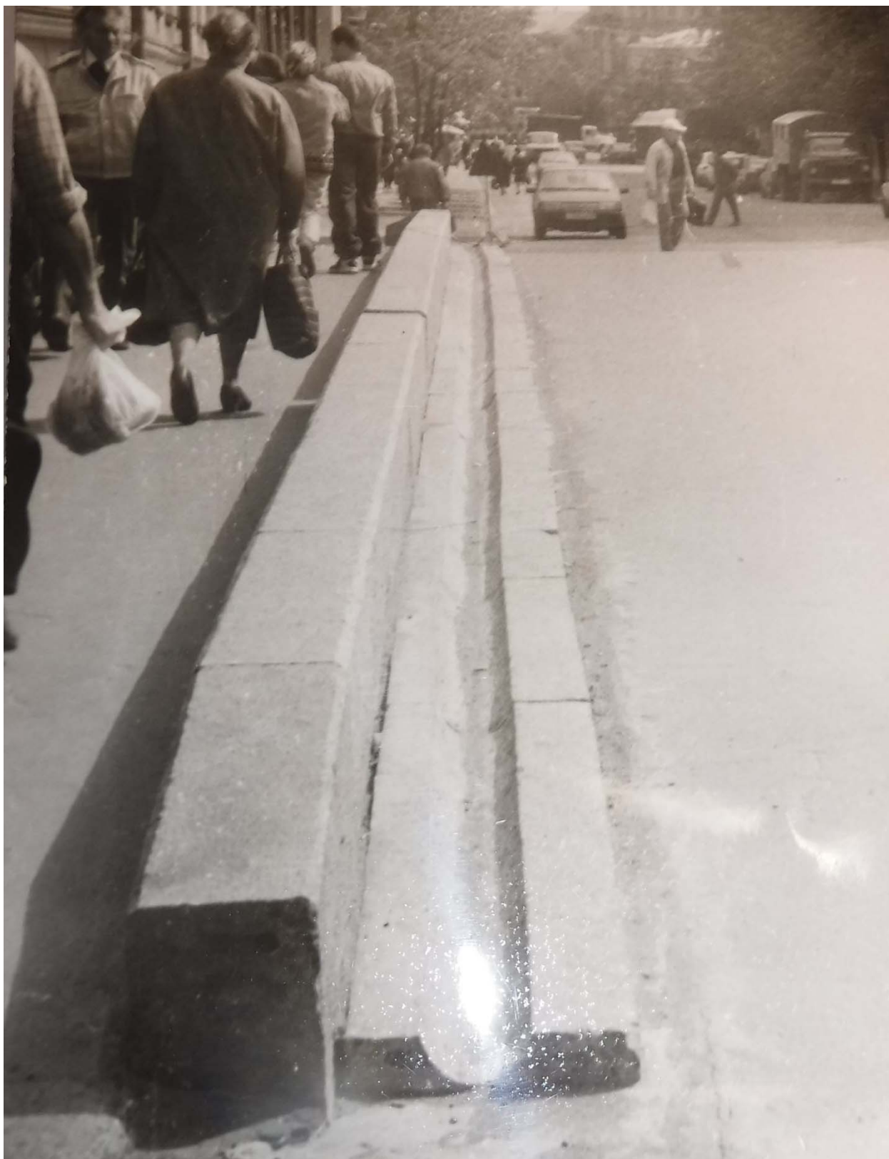
Ил. 52. Аларчин мост. Гранитный водоотводный лоток. Фотография. 1995.
