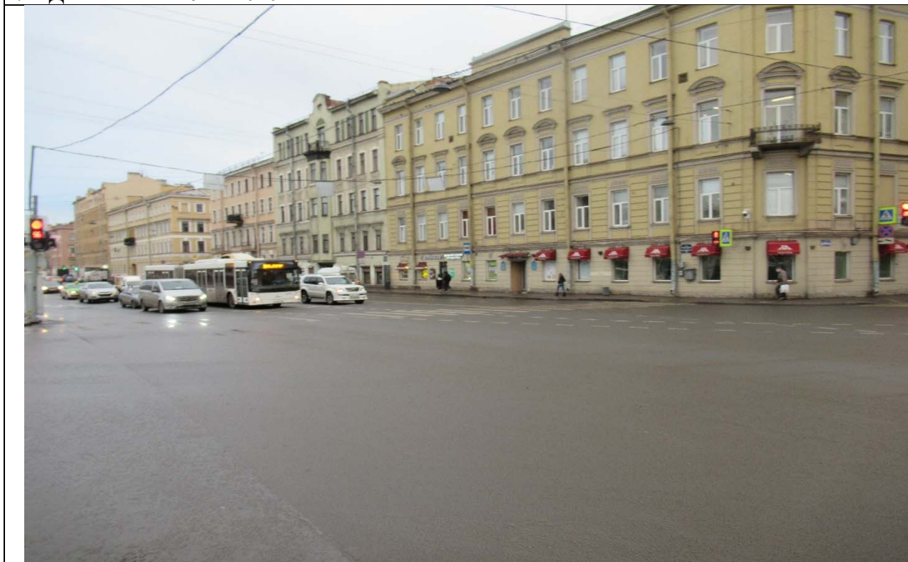
20. ОКН ФЗ «Мост Аларчин», входящий в состав комплекса «Набережные и мосты Екатерининского канала (ныне канала Грибоедова)» по адресу: г. Санкт-Петербург, через канал Грибоедова по Английскому пр. Вид от моста на здание по посп. Римского-Корсакова, 73. Дата съемки: 16.11.2020 г.
