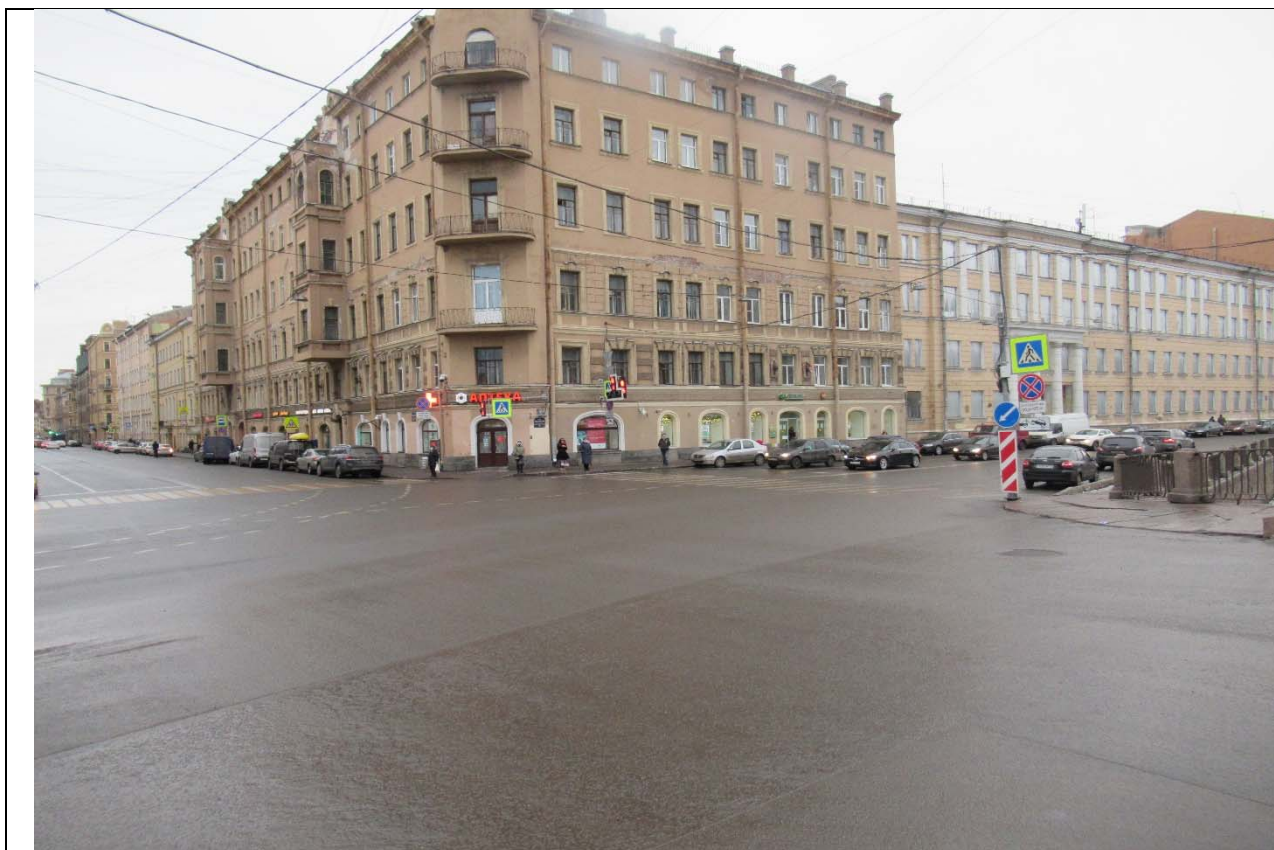
19. ОКН ФЗ «Мост Аларчин», входящий в состав комплекса «Набережные и мосты Екатерининского канала (ныне канала Грибоедова)» по адресу: г. Санкт-Петербург, через канал Грибоедова по Английскому пр. Вид от моста на здание по посп. Римского-Корсакова, 71. Дата съемки: 16.11.2020 г.
