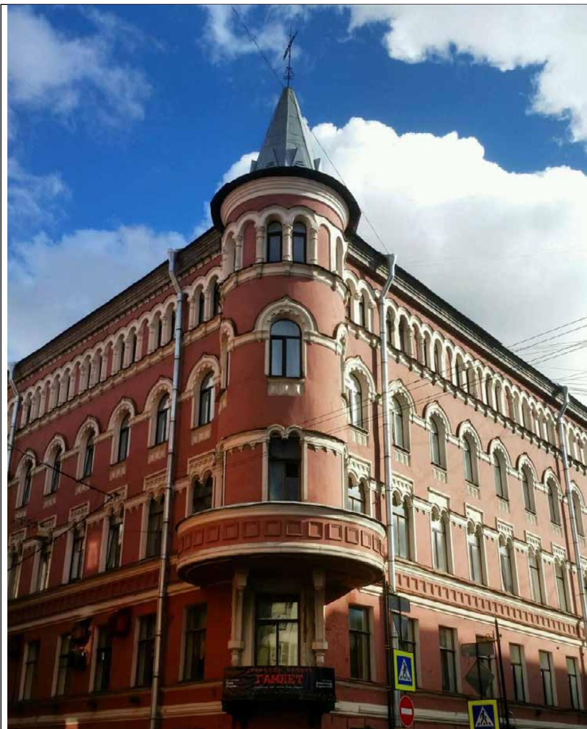
5. «Дом М.А. Жевержевой» (ул. Рубинштейна, дом 18/5, литера А). 2016 г.
