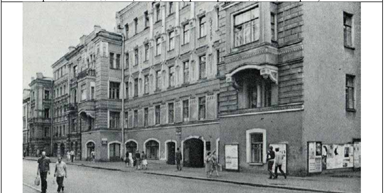
10. «Дом А.П. Рот» (ул. Рубинштейна, дом 25, литера А). 1980-е гг.
