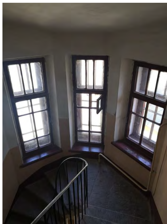
103. Лестница ЗЛК в уровне 6-7-го этажей
