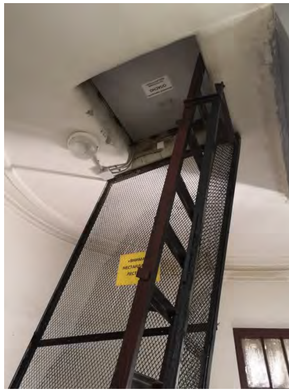
52. Парадная лестница 1ЛК в уровне 7-го этажа. Выход на крышу
