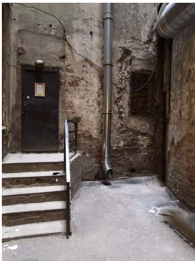
28. Фрагмент дворовых фасадов
