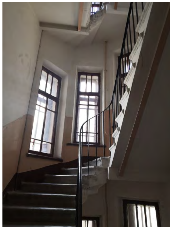
95. Лестница ЗЛК в уровне 3-4-го этажей
