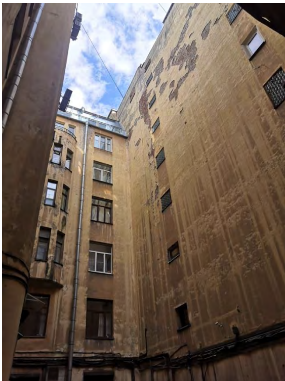
22. Фрагмент дворовых фасадов
