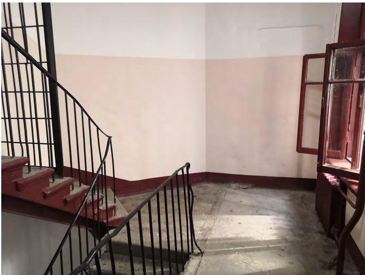
117. Лестница 4ЛК в уровне 4-го этажа
