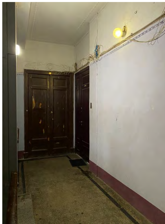
78. Парадная лестница 2ЛК в уровне 5-го этажа
