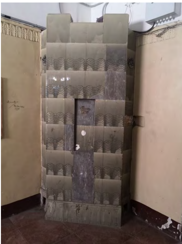
36. Вестибюль парадной лестницы 1ЛК. Печь угловая
