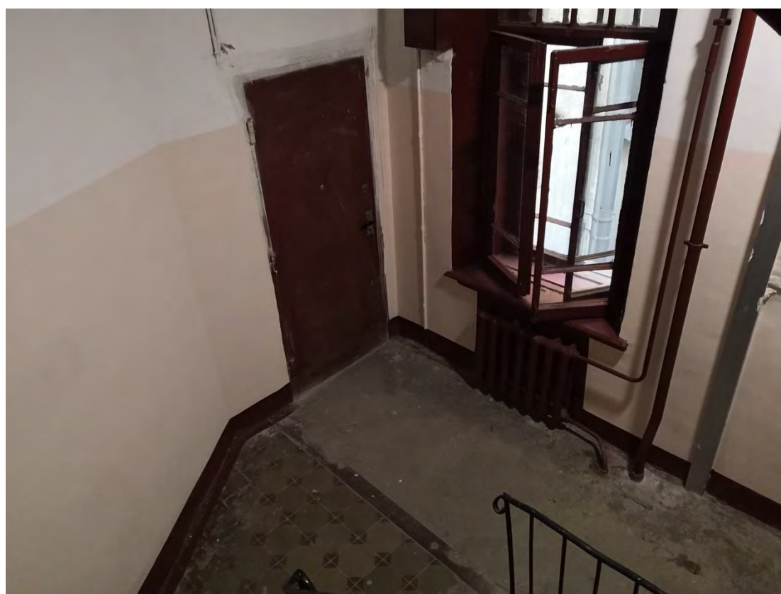
111. Лестница 4ЛК в уровне 2-го этажа
