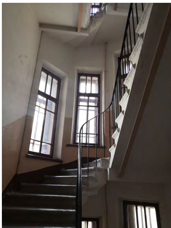
102. Лестница ЗЛК в уровне 6-7-го этажей
