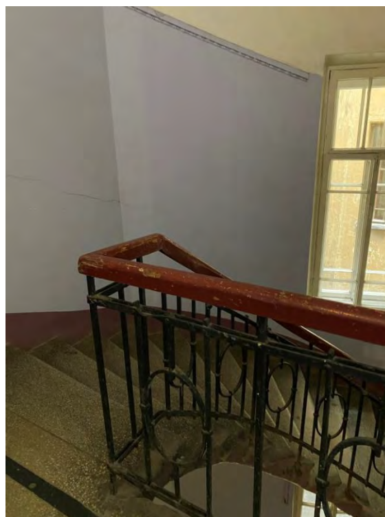
70. Парадная лестница 2ЛК в уровне 3-го этажа
