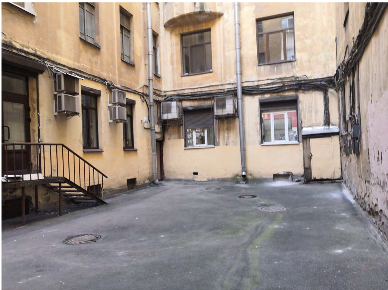
26. Фрагмент дворовых фасадов
