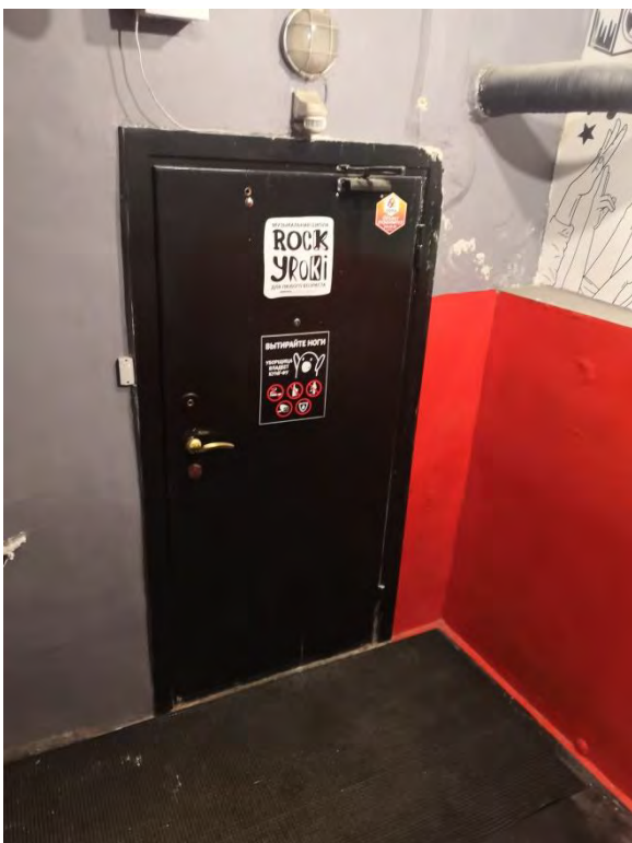
89. Лестница ЗЛК в уровне подвала
