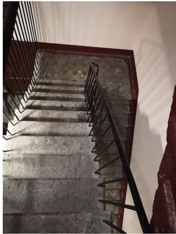
109. Лестница 4ЛК в уровне 1-2-го этажей
