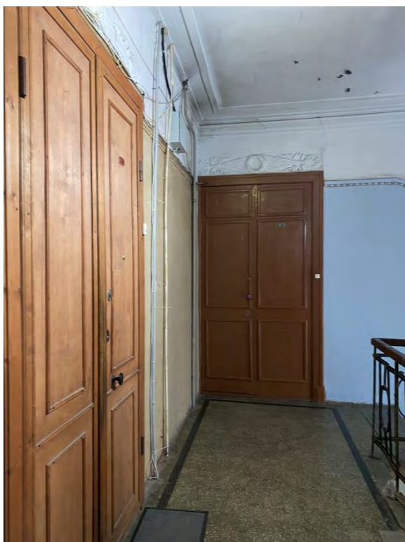
85. Парадная лестница 2ЛК в уровне 7-го этажа
