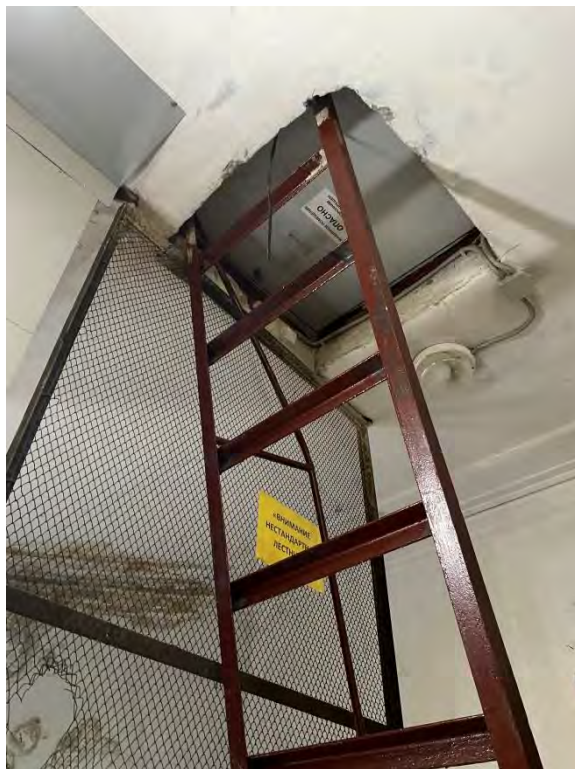
84. Парадная лестница 2ЛК в уровне 7-го этажа. Выход на чердак
