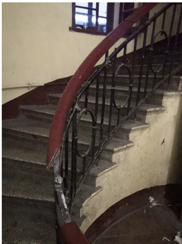
40. Парадная лестница 1ЛК в уровне 1-го этажа
