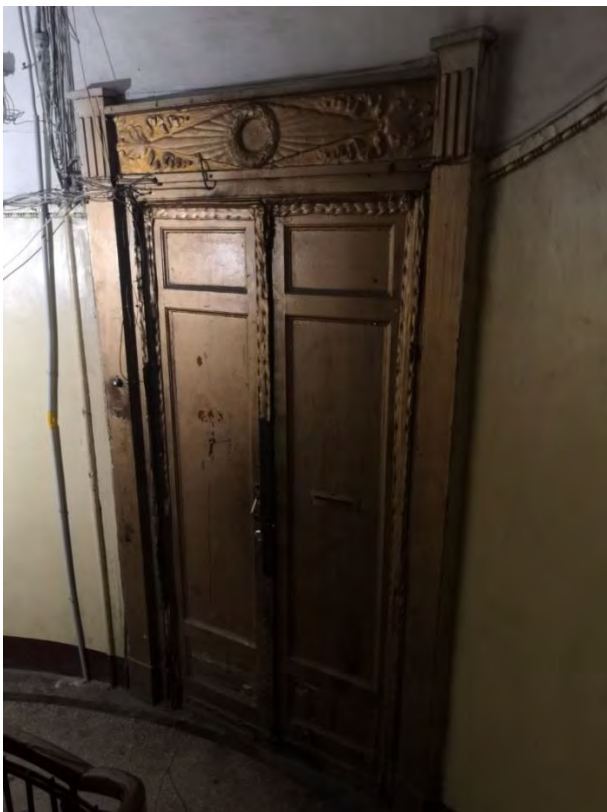
41. Парадная лестница 1ЛК в уровне 2-го этажа. Деревянные двустворчатые двери
