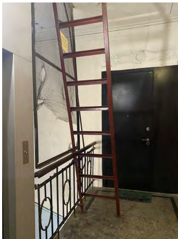
86. Парадная лестница 2ЛК в уровне 7-го этажа
