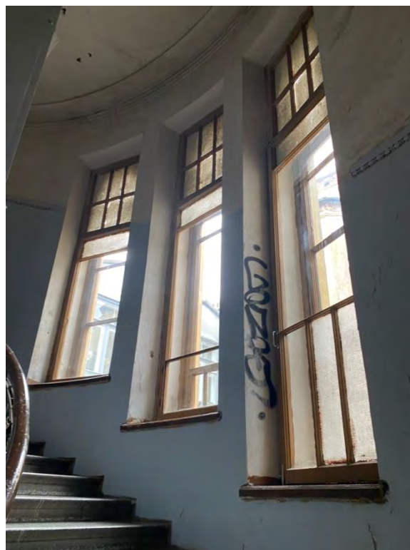
82. Оконные проемы парадной лестницы 2ЛК в уровне 6-7-го этажей
