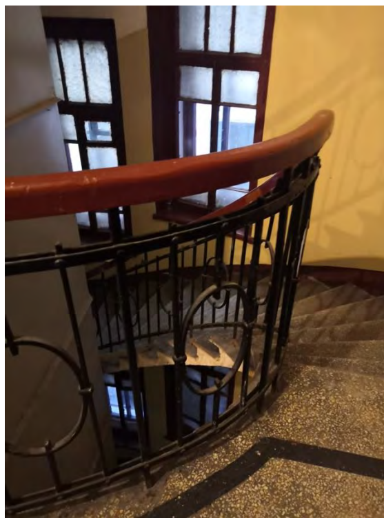
44. Парадная лестница 1ЛК в уровне 5-го этажа
