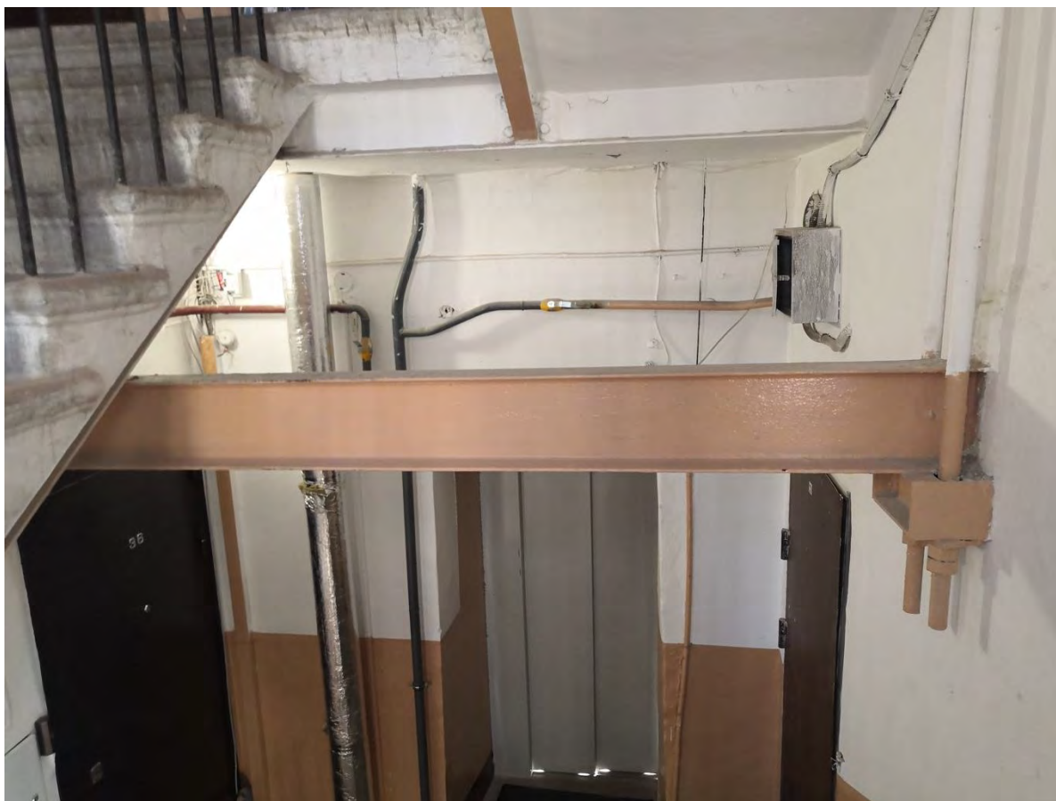
101. Лестница ЗЛК в уровне 6-го этажа
