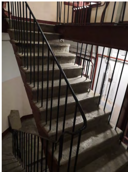
115 Лестница 4ЛК в уровне 3-4-го этажей
