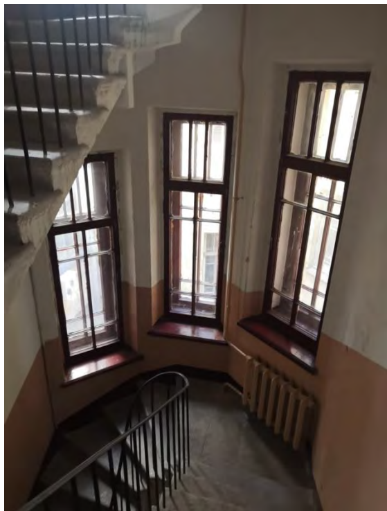
94. Лестница ЗЛК в уровне 2-3-го этажей
