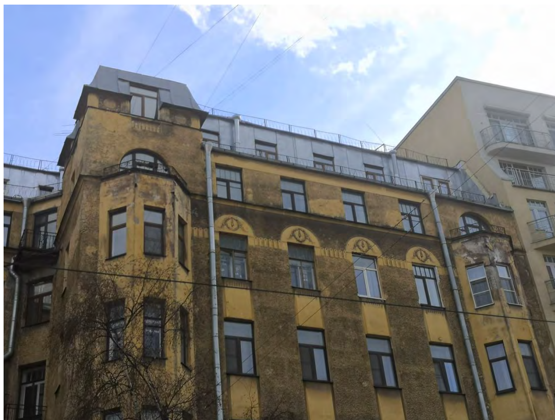
12. Завершение правого крыла лицевого фасада по наб. реки Карповки в форме шатра с переломом.
