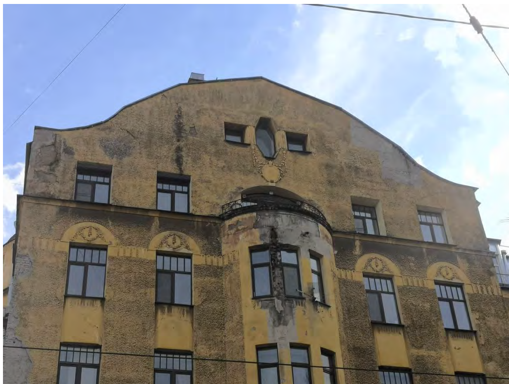
7. Завершение левого крыла лицевого фасада по наб. реки Карповки в форме фигурного щипца.
