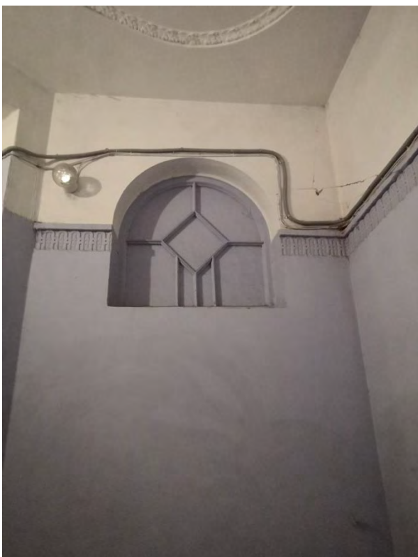
56. Вестибюль парадной лестницы 2ЛК. Ниша
