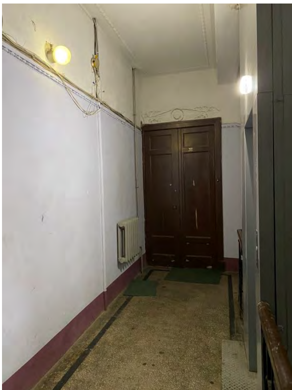
77. Парадная лестница 2ЛК в уровне 5-го этажа
