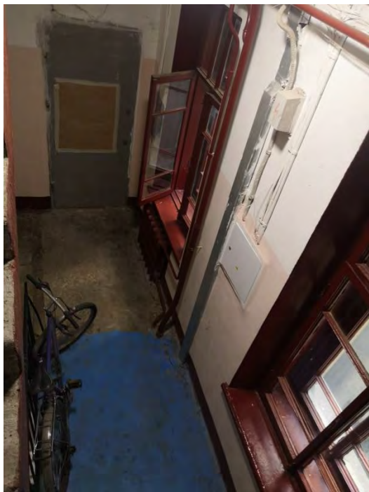
114. Лестница 4ЛК в уровне 3-го этажа
