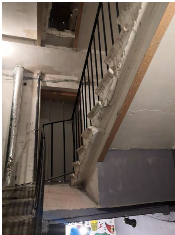
90. Лестница ЗЛК в уровне 1-го этажа
