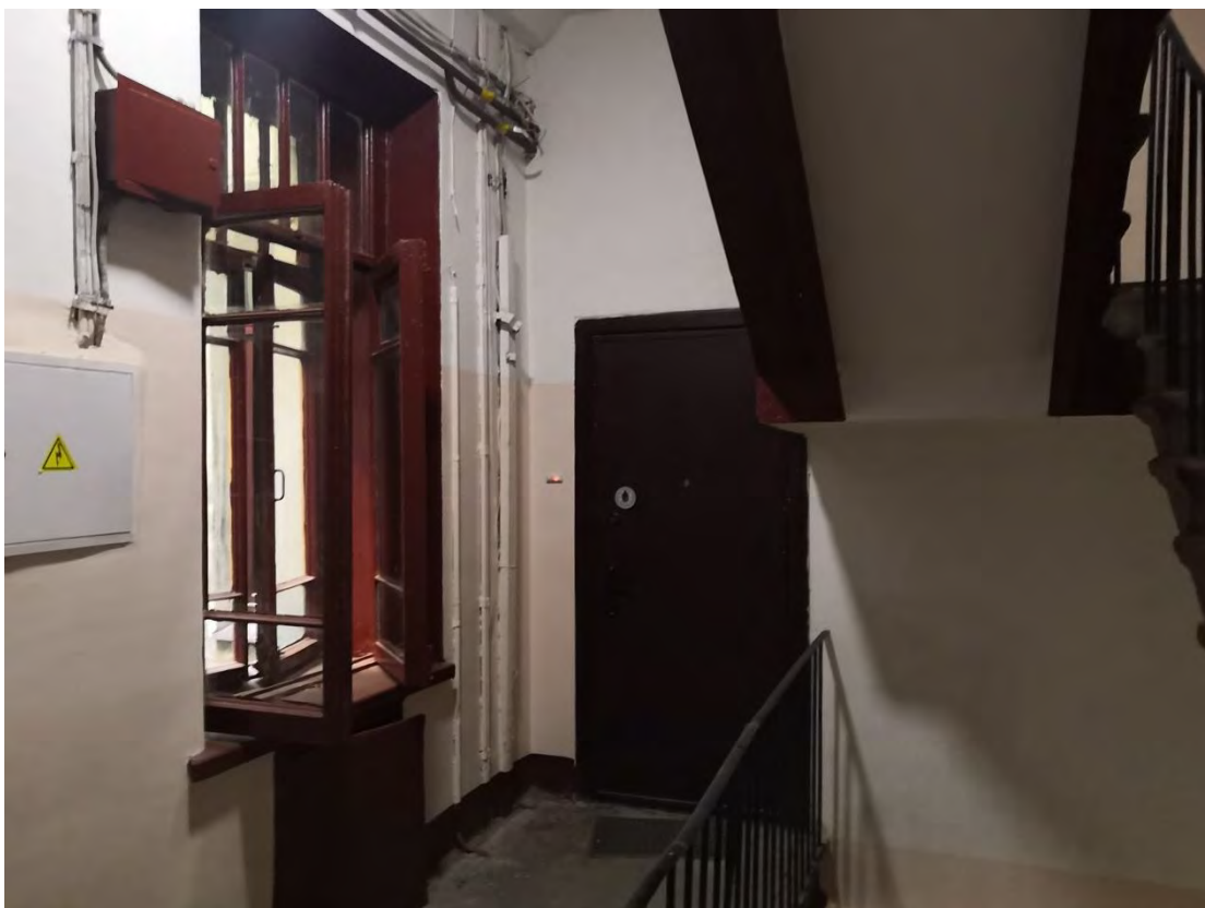
110. Лестница 4ЛК в уровне 2-го этажа
