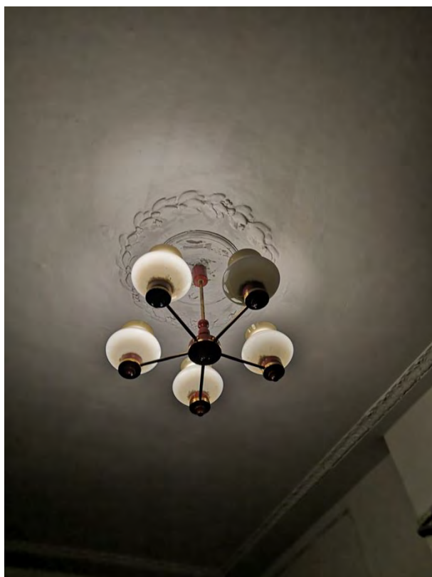
59. Вестибюль парадной лестницы 2ЛК. Розетка.
