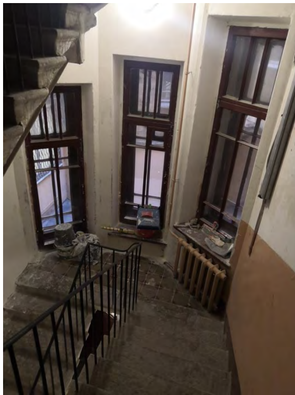
92. Лестница ЗЛК в уровне 1-2-го этажей
