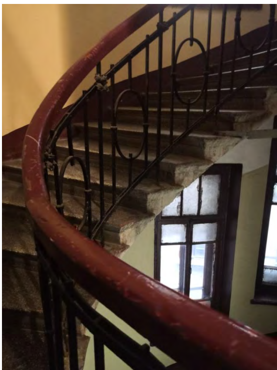
43. Парадная лестница 1ЛК в уровне 4-го этажа
