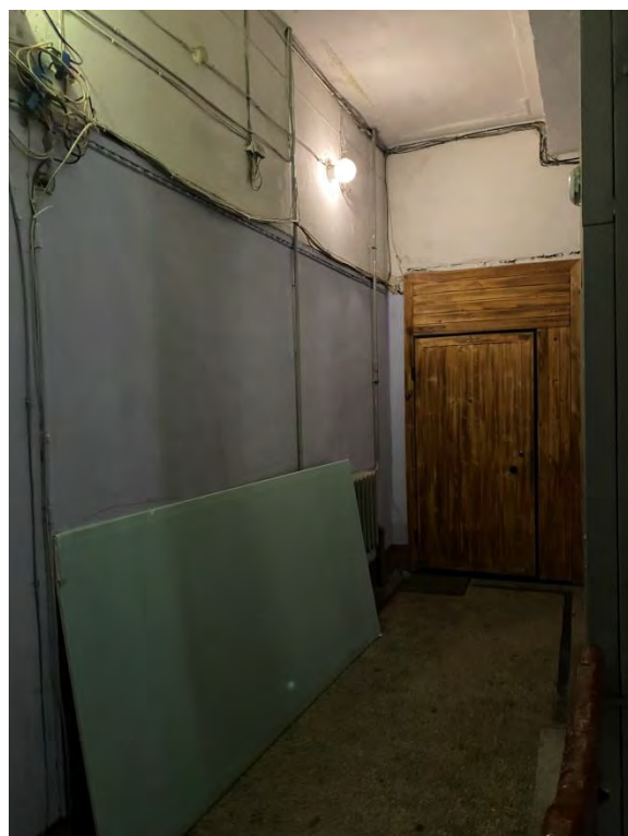
67. Парадная лестница 2ЛК в уровне 2-го этажа
