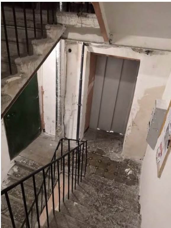
91. Лестница ЗЛК в уровне 1-го этажа
