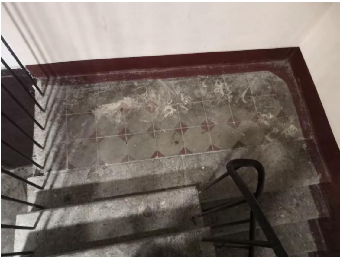
112. Лестница 4ЛК в уровне 2-3-го этажей
