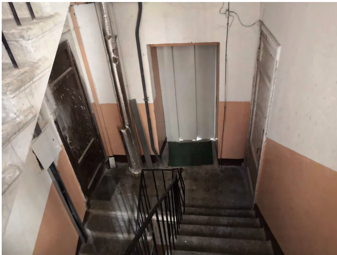
96. Лестница ЗЛК в уровне 4-го этажа
