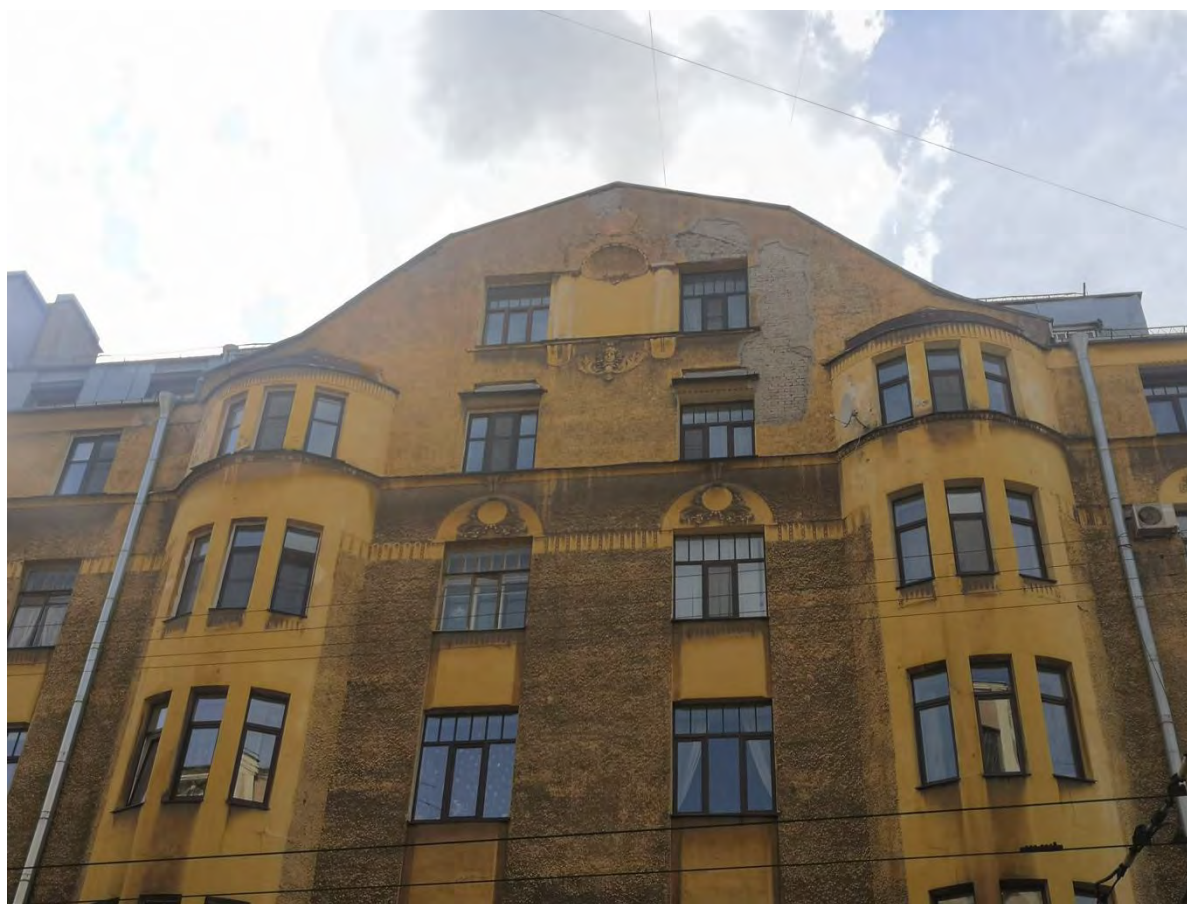
2. Завершение центральной части лицевого фасада по Большому проспекту П.С.
