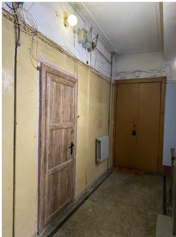
80. Парадная лестница 2ЛК в уровне 6-го этажа
