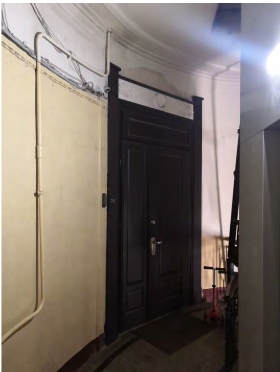
51. Парадная лестница 1ЛК в уровне 7-го этажа
