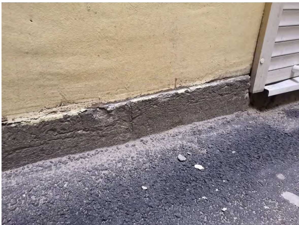
21. Фрагмент дворового фасада. Известняковый цоколь
