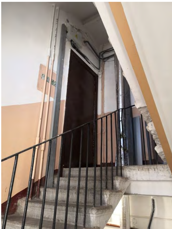
97. Лестница ЗЛК в уровне 5-го этажа
