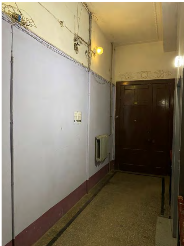
71. Парадная лестница 2ЛК в уровне 3-го этажа
