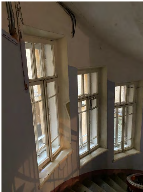
65. Оконные проемы парадной лестницы 2ЛК в уровне 1-2-го этажей
