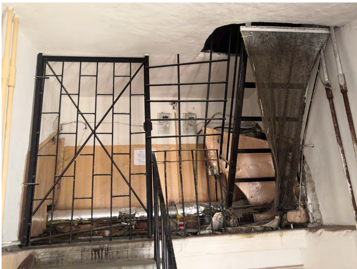
104. Лестница 3ЛК. Выход на чердак
