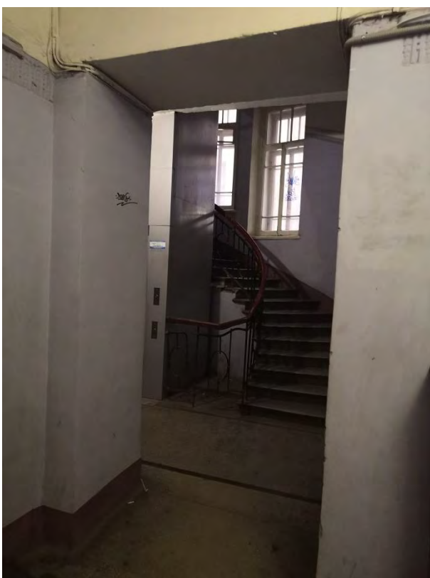
62. Парадная лестница 2ЛК в уровне 1-го этажа
