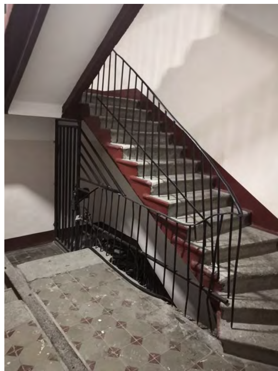
107. Лестница 4ЛК в уровне 1-го этажа
