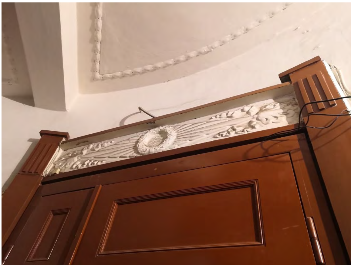
45. Парадная лестница 1ЛК. Лепной орнаментальный фриз в виде венка над дверью в квартиру
