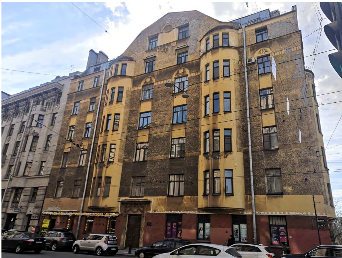
1. Лицевой фасад по Большому проспекту П.С.
