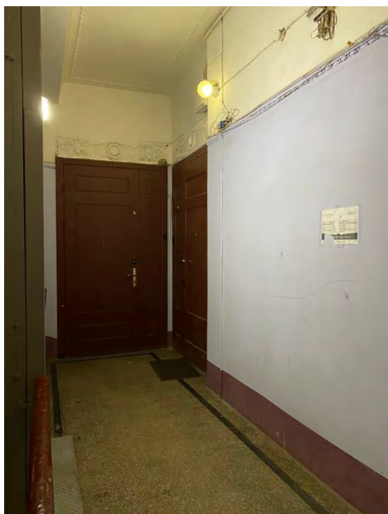
69. Парадная лестница 2ЛК в уровне 3-го этажа
