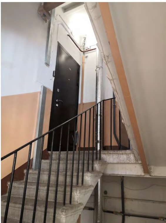
99. Лестница ЗЛК в уровне 6-го этажа
