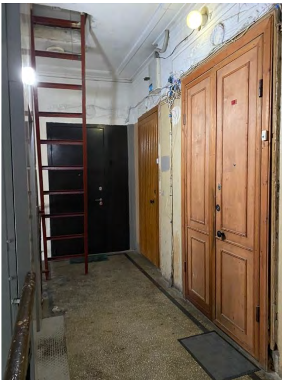
83. Парадная лестница 2ЛК в уровне 7-го этажа
