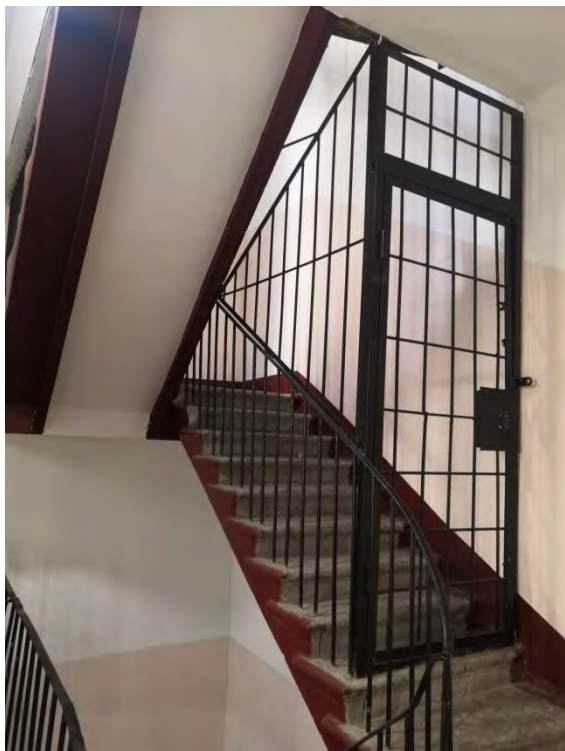
118. Лестница 4ЛК в уровне 4-го этажа
