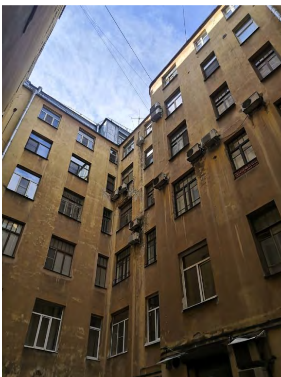
24. Фрагмент дворовых фасадов
