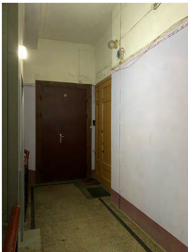
73. Парадная лестница 2ЛК в уровне 4-го этажа
