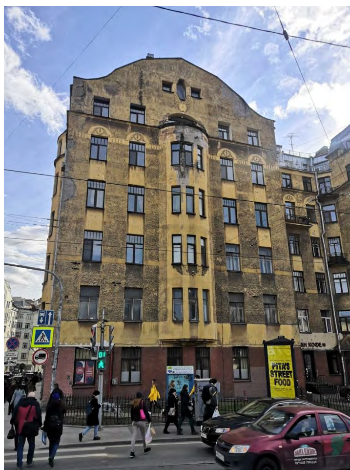
6. Фрагмент лицевого фасада по наб. реки Карповки. Левое крыло.
