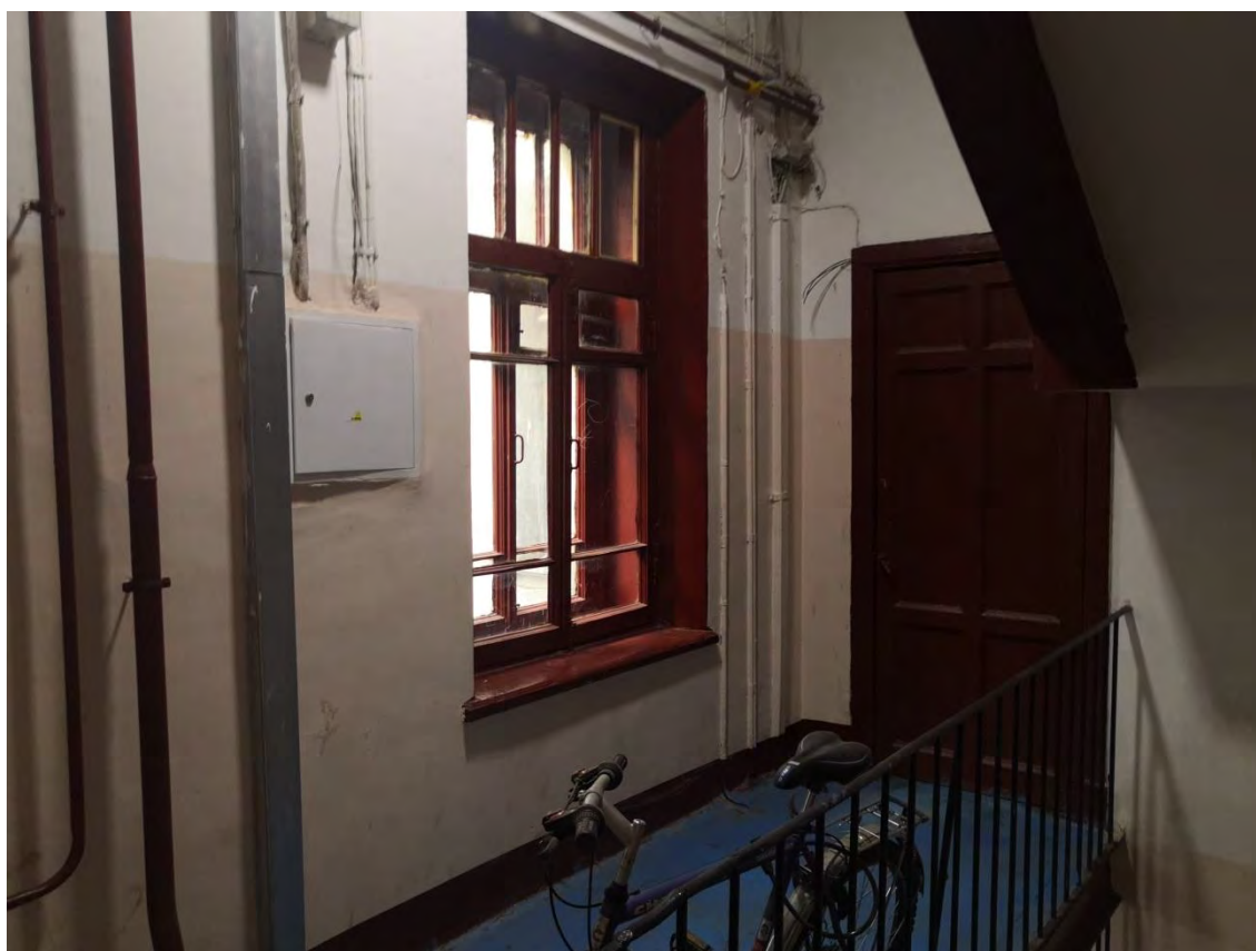
113. Лестница 4ЛК в уровне 3-го этажа
