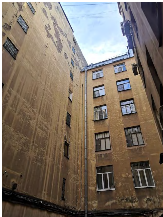
23. Фрагмент дворовых фасадов
