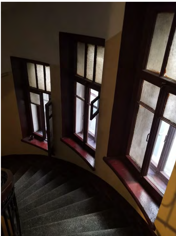
47. Оконные проемы парадной лестницы 1ЛК в уровне 5-6-го этажей
