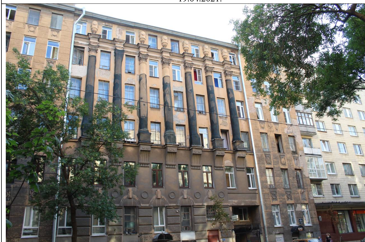
10. Дом В. И. Яковлева и В. Г. Васильева. 15-я линия В.О., дом 34. Фрагмент лицевого фасада. Вид с юго-востока. Фото: эксперт А. А. Кононов, 01.06.2021.
