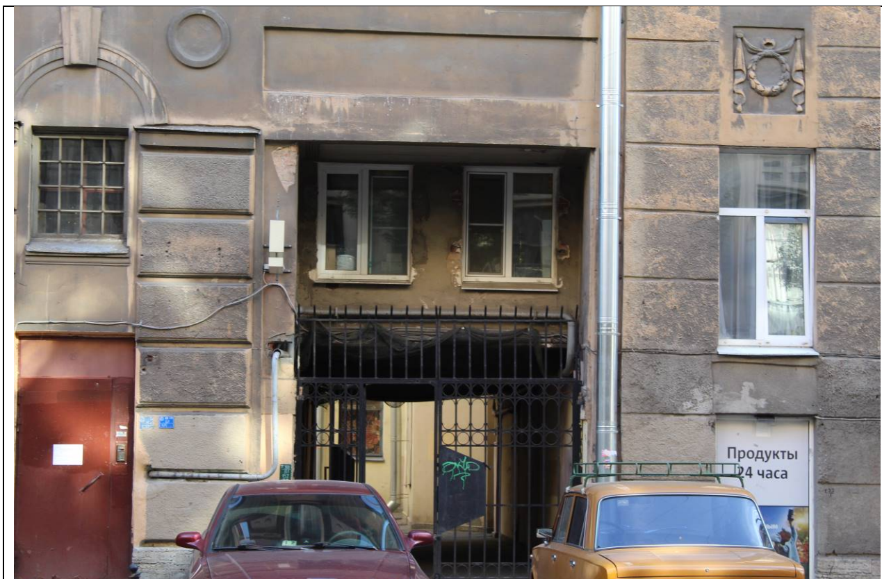
9. Дом В. И. Яковлева и В. Г. Васильева. 15-я линия В.О., дом 34. Фрагмент лицевого фасада. Арочный проезд. Вид с северо-востока. Фото: эксперт А. А. Кононов, 19.04.2021.
