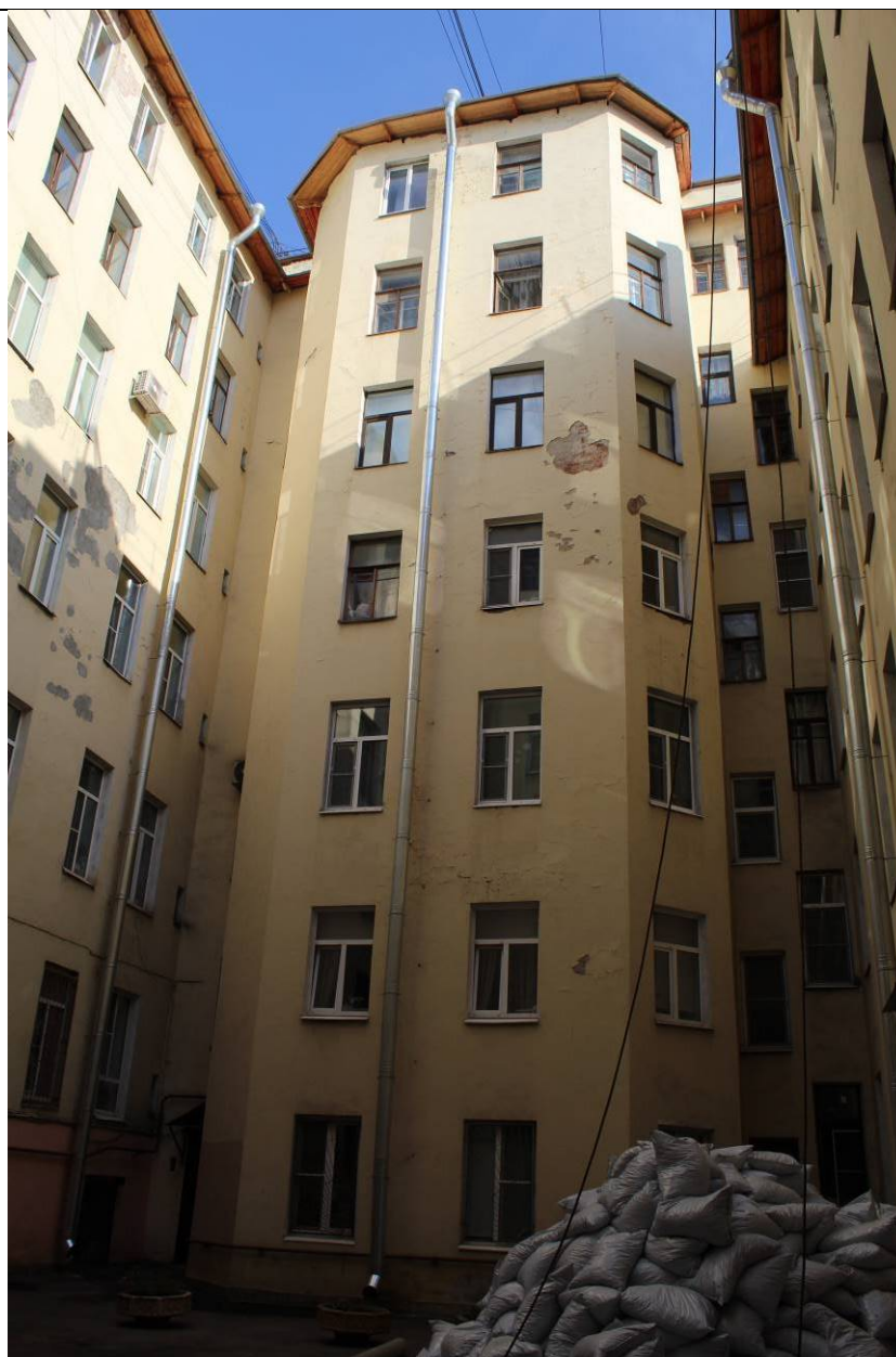
19. Дом В. И. Яковлева и В. Г. Васильева. 15-я линия В.О., дом 34. Северный дворовый корпус. Фрагмент. Вид с севера. Фото: эксперт А. А. Кононов, 19.04.2021.
