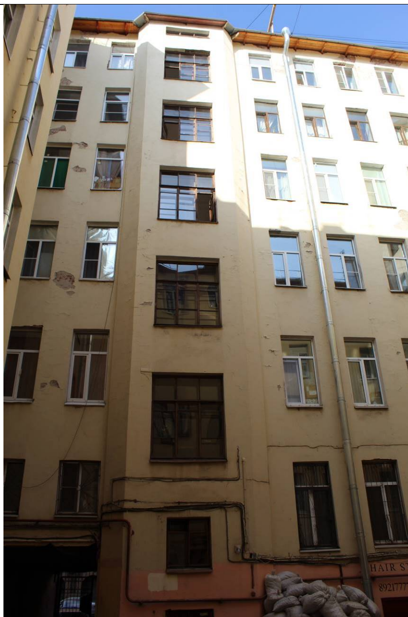
24. Дом В. И. Яковлева и В. Г. Васильева. 15-я линия В.О., дом 34. Дворовый фасад уличного корпуса. Фрагмент. Вид с запада. Фото: эксперт А. А. Кононов, 19.04.2021.
