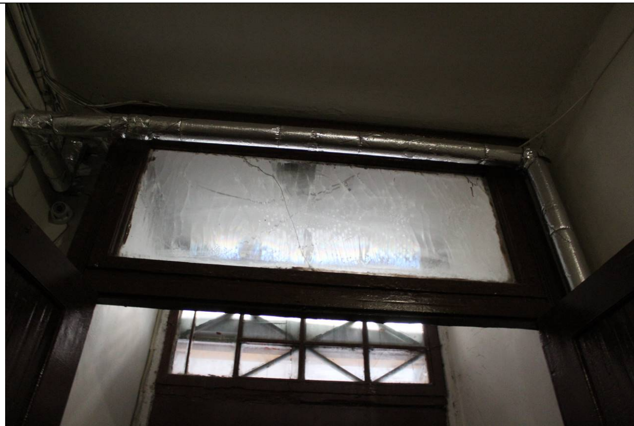
2. Дом В. И. Яковлева и В. Г. Васильева. 15-я линия В.О., дом 34. ЛК-2. Входная группа. Фрагмент. Заполнение дверной фрамуги. Фото: эксперт А. А. Кононов, 19.04.2021.
