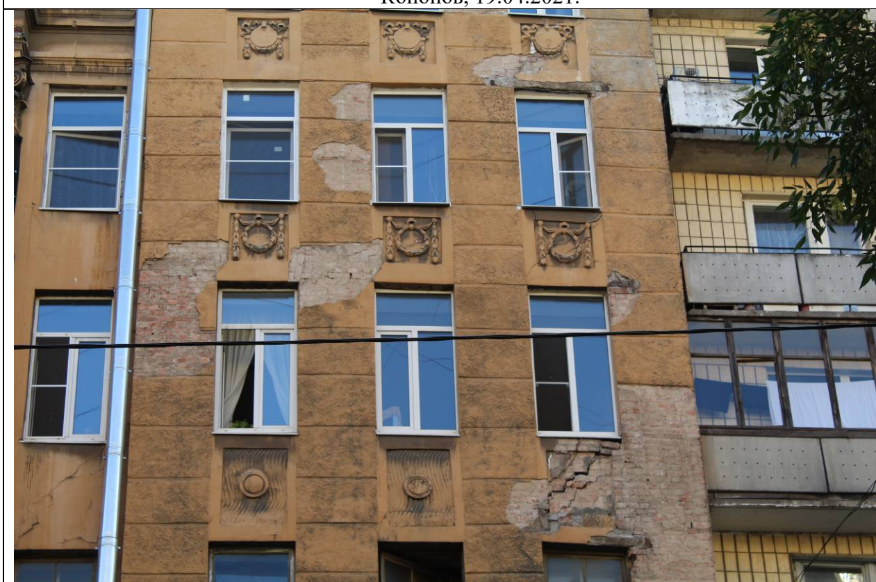
6. Дом В. И. Яковлева и В. Г. Васильева. 15-я линия В.О., дом 34. Фрагмент лицевого фасада. Архитектурный декор ризалита. Вид с северо-востока. Фото: эксперт А. А. Кононов, 01.06.2021.
