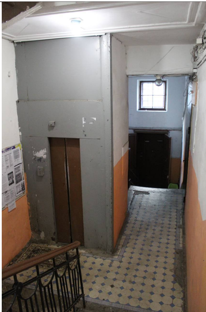
39. Дом В. И. Яковлева и В. Г. Васильева. 15-я линия В.О., дом 34. ЛК-1. Площадка 2 этажа. Фото: эксперт А. А. Кононов, 19.04.2021.
