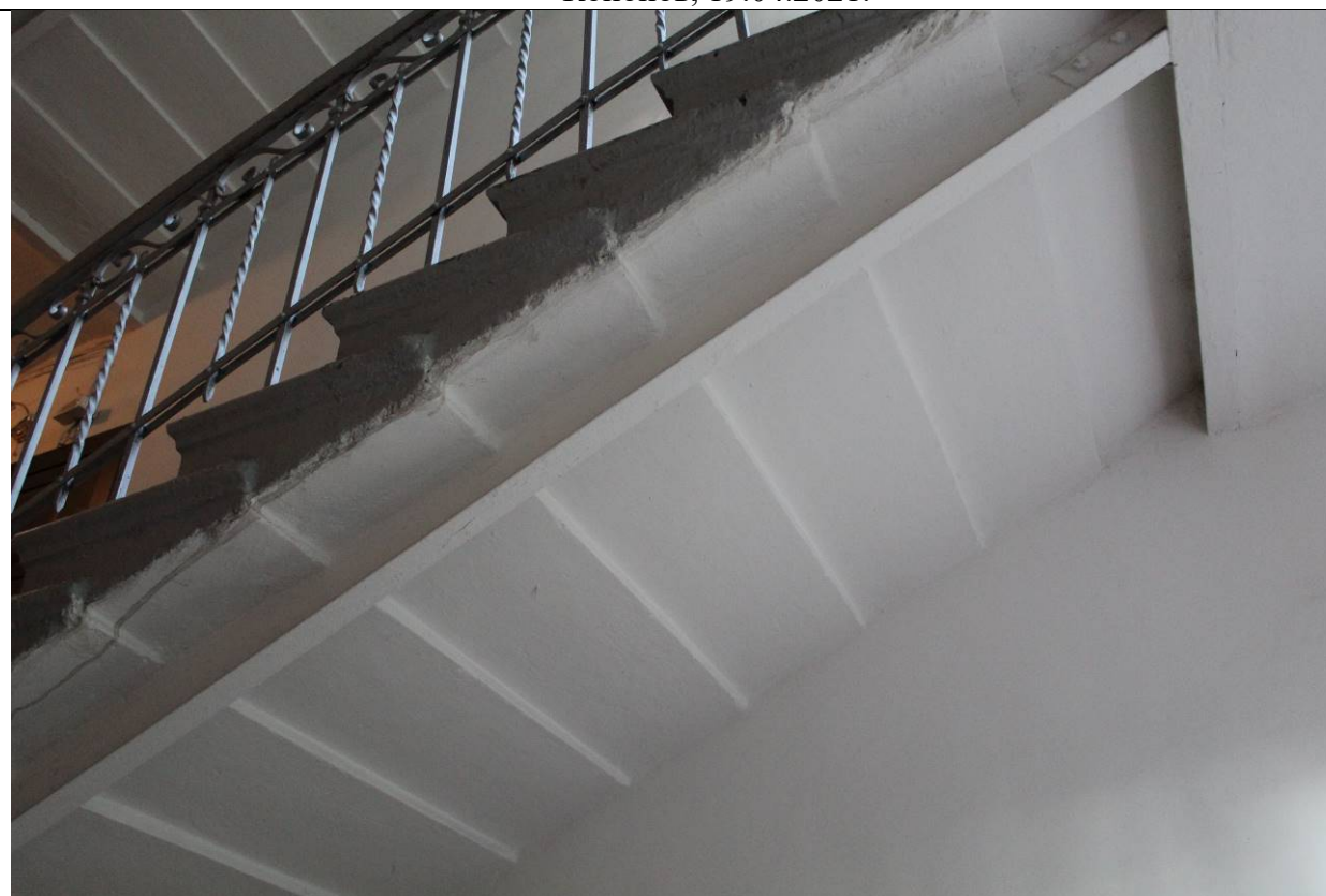
16. Дом В. И. Яковлева и В. Г. Васильева. 15-я линия В.О., дом 34. ЛК-2. Лестница на косоуре между 3 и 4 этажами. Фото: эксперт А. А. Кононов, 19.04.2021.
