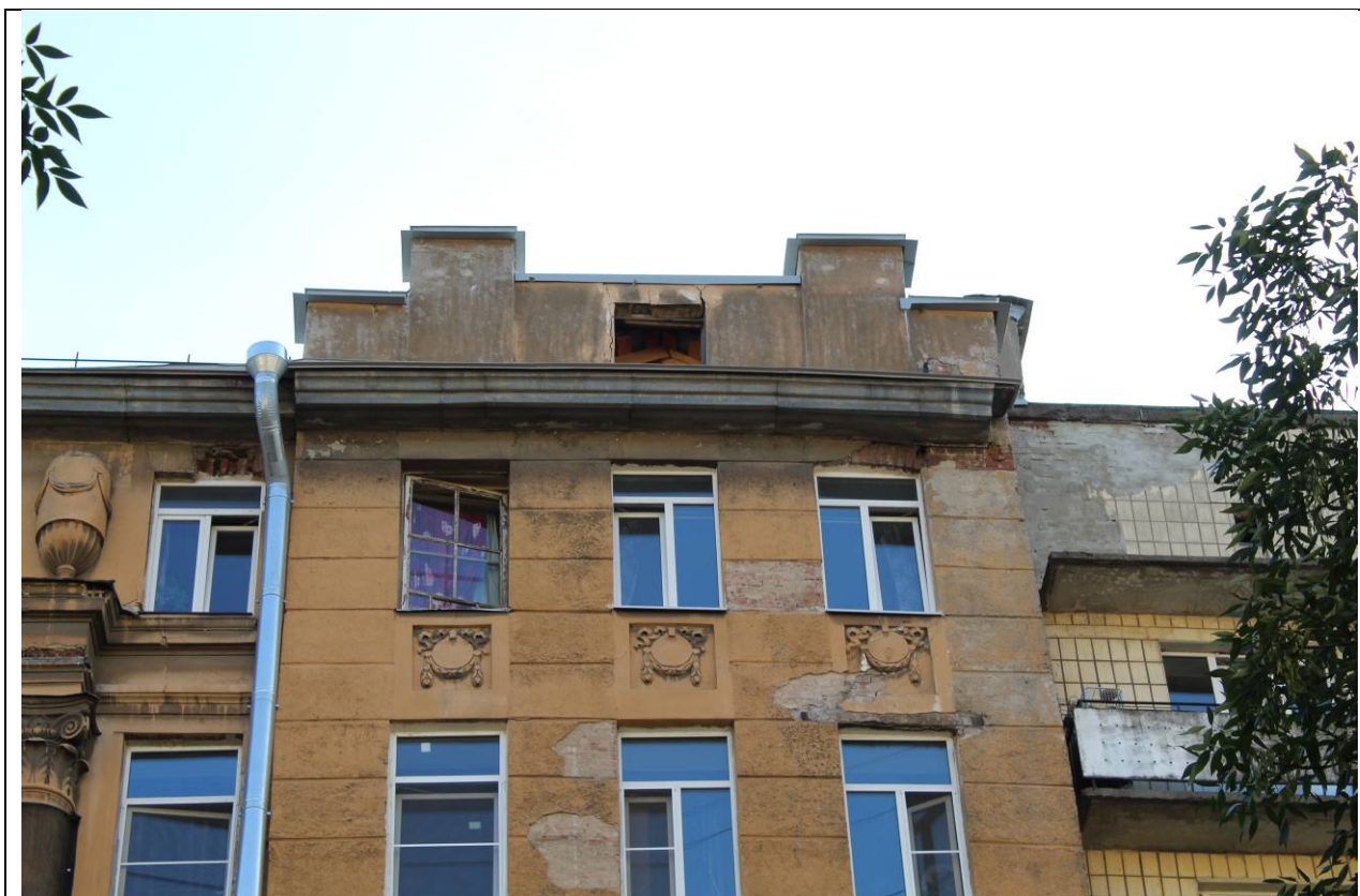
7. Дом В. И. Яковлева и В. Г. Васильева. 15-я линия В.О., дом 34. Фрагмент лицевого фасада. Архитектурный декор ризалита. Атик. Вид с северо-востока. Фото: эксперт А. А. Кононов, 01.06.2021
