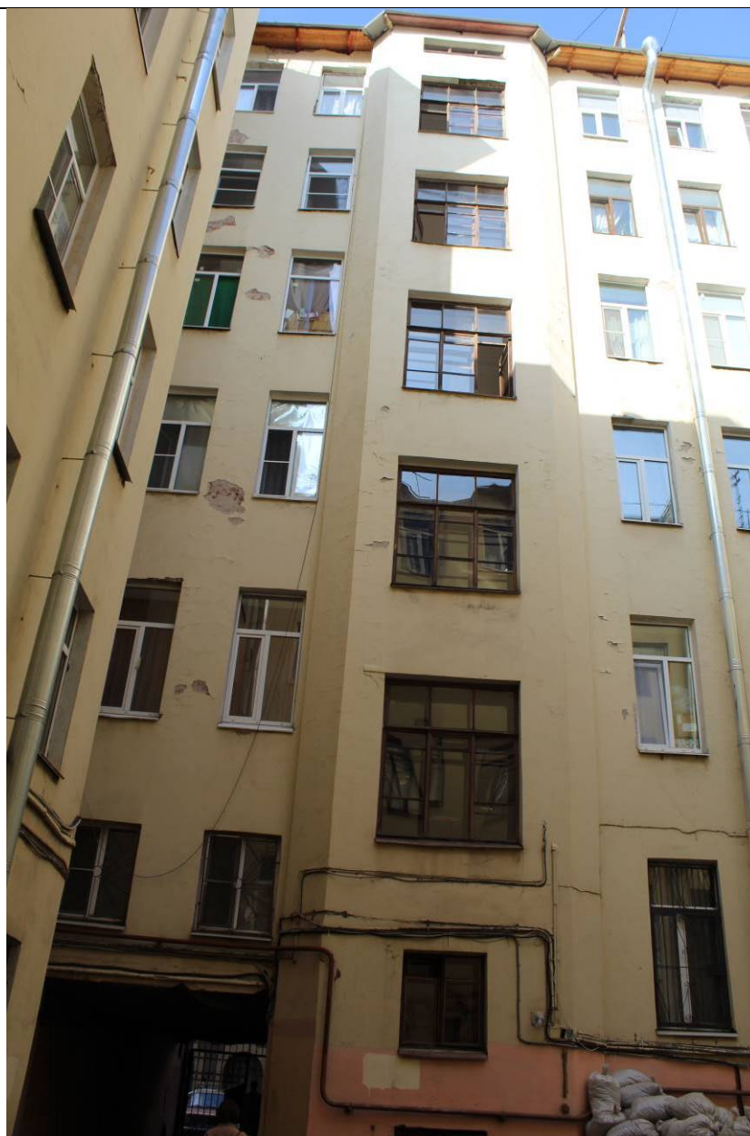
18. Дом В. И. Яковлева и В. Г. Васильева. 15-я линия В.О., дом 34. Дворовый фасад уличного корпуса. Фрагмент. Вид с запада. Фото: эксперт А. А. Кононов, 19.04.2021.
