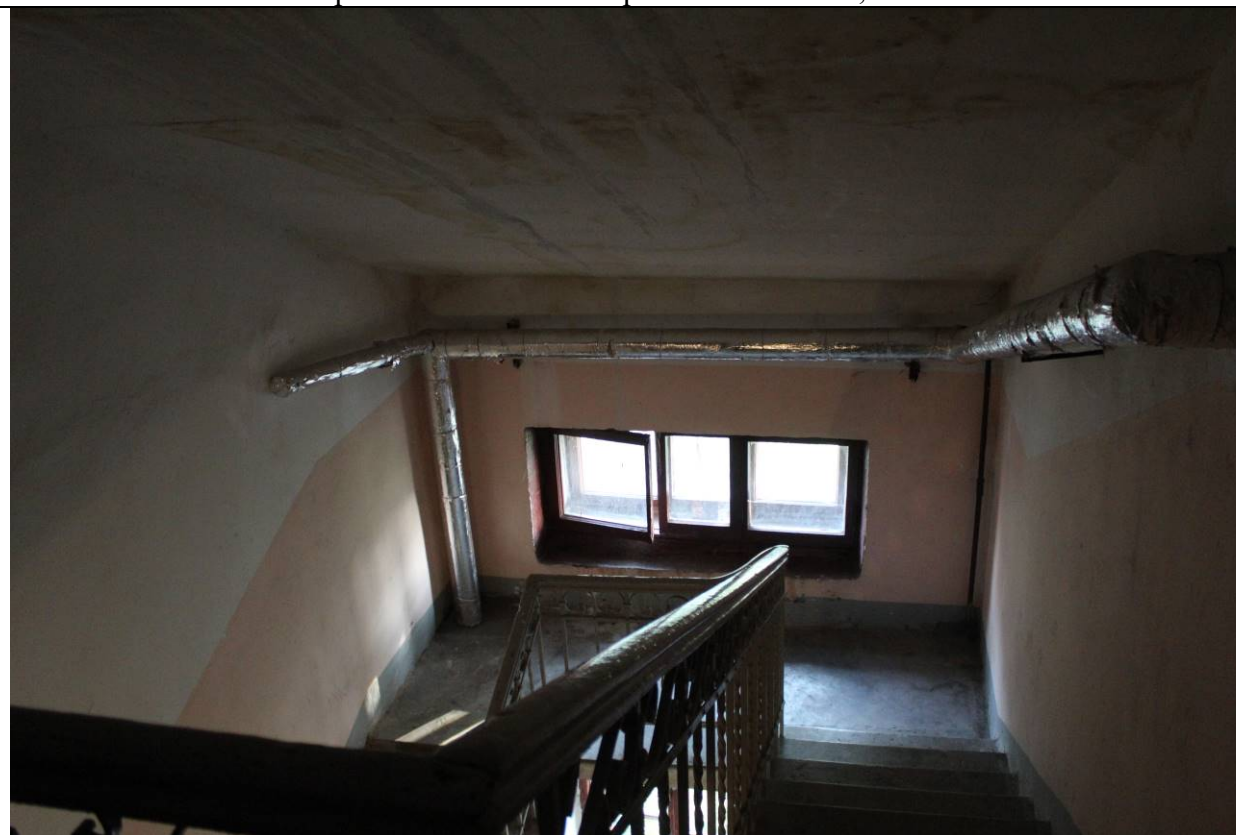
30. Дом В. И. Яковлева и В. Г. Васильева. 15-я линия В.О., дом 34. ЛК-2. Вид на площадку между 5 этажом и чердаком. Фото: эксперт А. А. Кононов, 19.04.2021.
