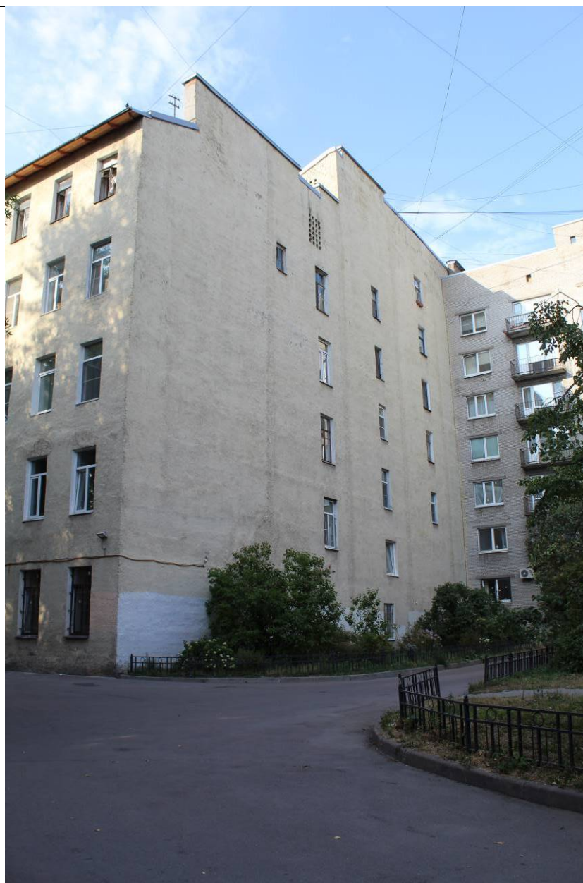
28. Дом В. И. Яковлева и В. Г. Васильева. 15-я линия В.О., дом 34. Вид на южный дворовый корпус с юго-запада. Фото: эксперт А. А. Кононов, 01.06.2021.
