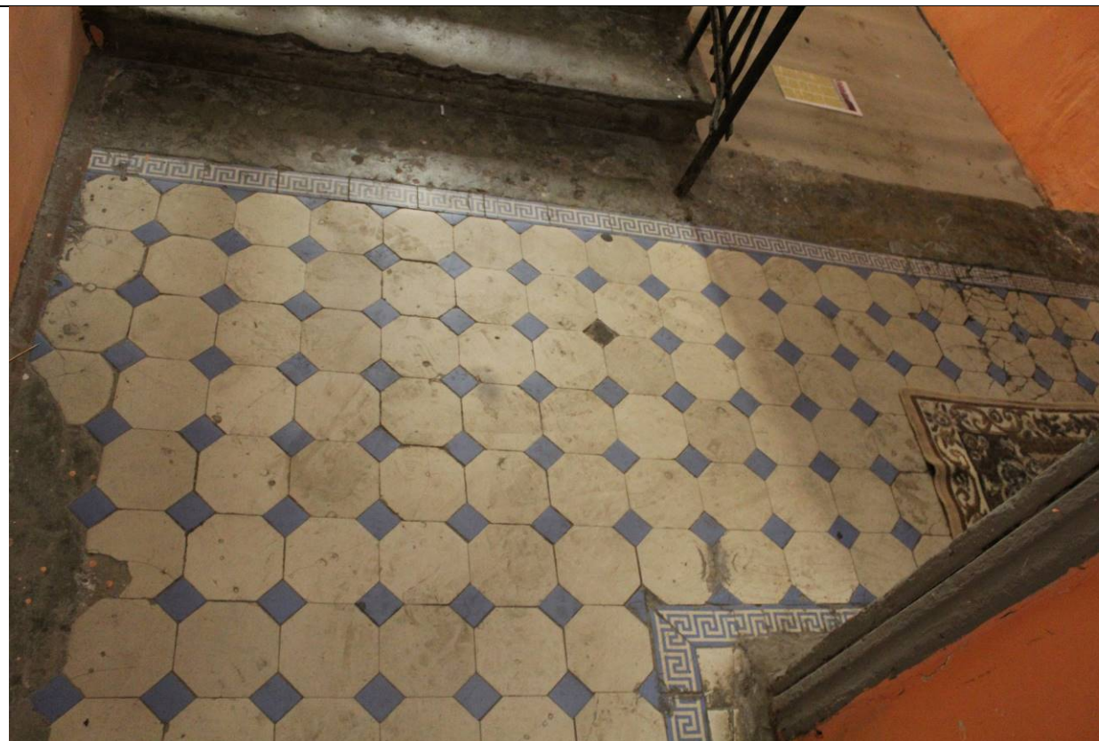
13. Дом В. И. Яковлева и В. Г. Васильева. 15-я линия В.О., дом 34. ЛК-1. Площадка 2 этажа. Фрагмент. Напольное покрытие. Фото: эксперт А. А. Кононов, 19.04.2021.
