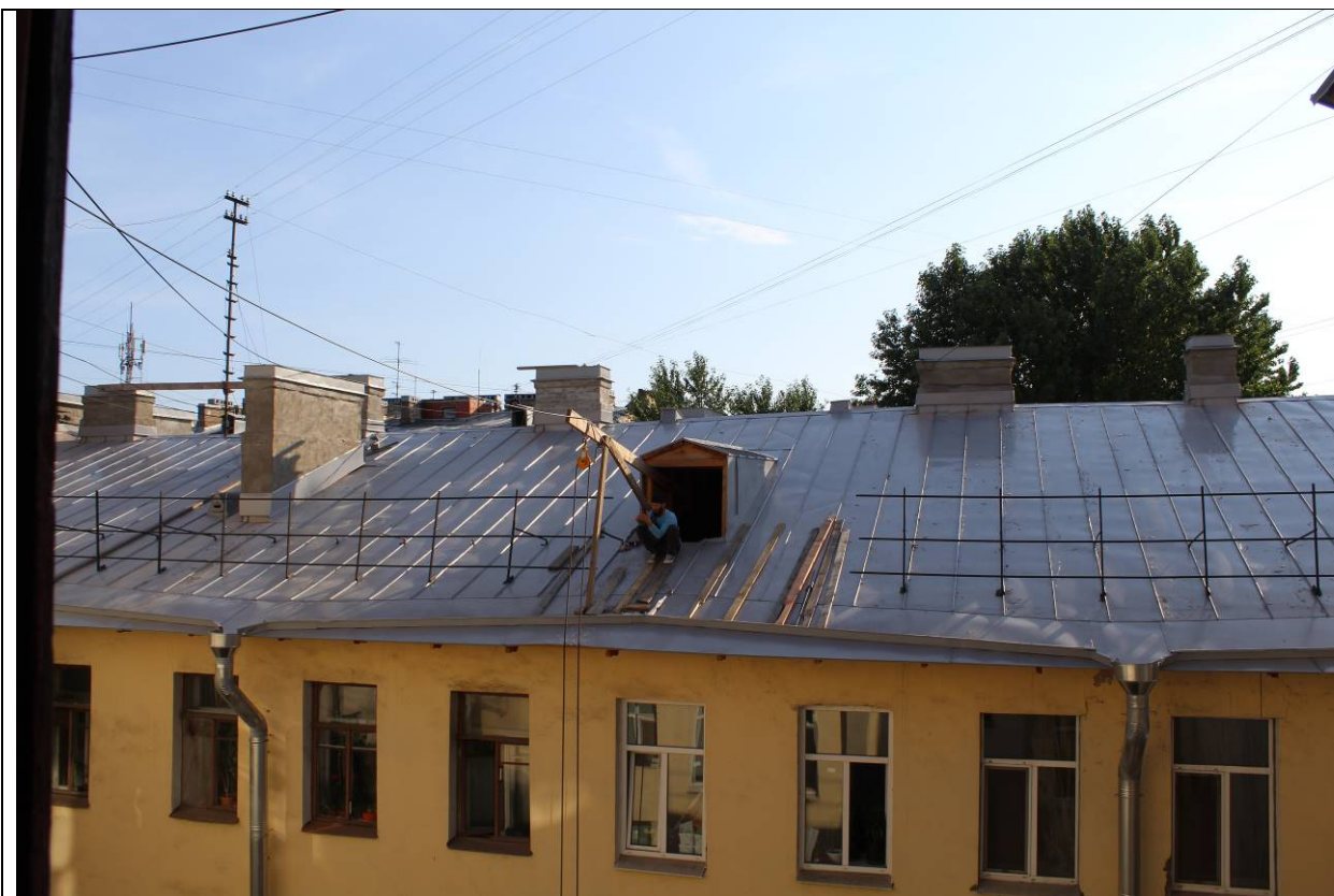
33. Дом В. И. Яковлева и В. Г. Васильева. 15-я линия В.О., дом 34. ЛК-1. Вид из окна на крышу дворового корпуса. Фрагмент. Фото: эксперт А. А. Кононов, 19.04.2021.
