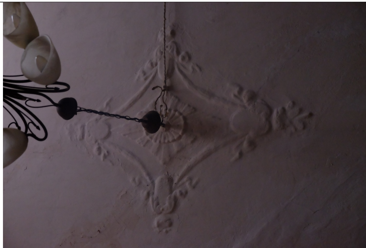
44. Дом В. И. Яковлева и В. Г. Васильева. 15-я линия В.О., дом 34. ЛК-1. Квартира №7, помещение площадью 15 кв. м. Лепной декор потолка. Розетка. Фото: эксперт А. А. Кононов, 19.04.2021.
