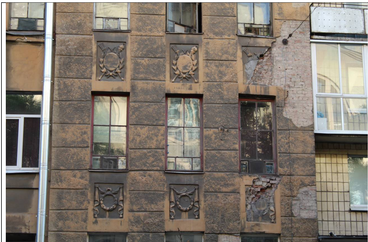
5. Дом В. И. Яковлева и В. Г. Васильева. 15-я линия В.О., дом 34. Фрагмент лицевого фасада. Архитектурный декор ризалита. Вид с северо-востока. Фото: эксперт А. А. Кононов, 19.04.2021.
