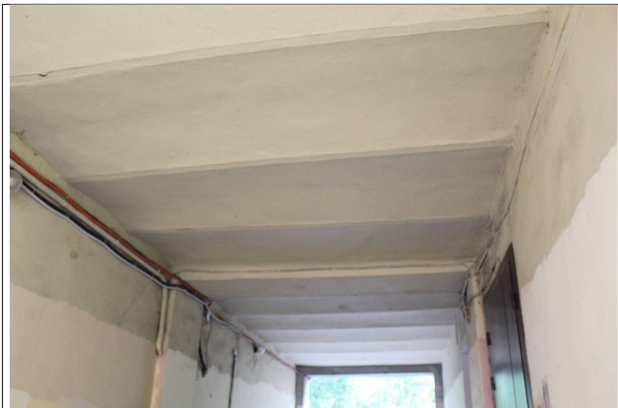
25. Дом В. И. Яковлева и В. Г. Васильева. 15-я линия В.О., дом 34. Западный дворовый корпус. Арочный проезд. Фрагмент. Вид с востока. Фото: эксперт А. А. Кононов, 19.04.2021.
