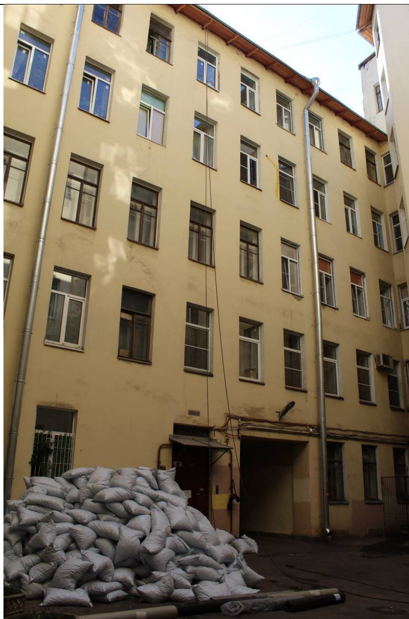
21. Дом В. И. Яковлева и В. Г. Васильева. 15-я линия В.О., дом 34. Западный дворовый корпус. Фрагмент. Вид с юго-востока. Фото: эксперт А. А. Кононов, 19.04.2021.
