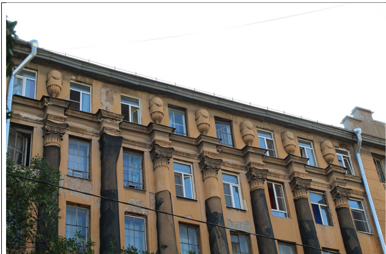
13. Дом В. И. Яковлева и В. Г. Васильева. 15-я линия В.О., дом 34. Фрагмент лицевого фасада. Архитектурный декор верхних этажей. Вид с юго-востока. Фото: эксперт А. А. Кононов, 01.06.2021.
