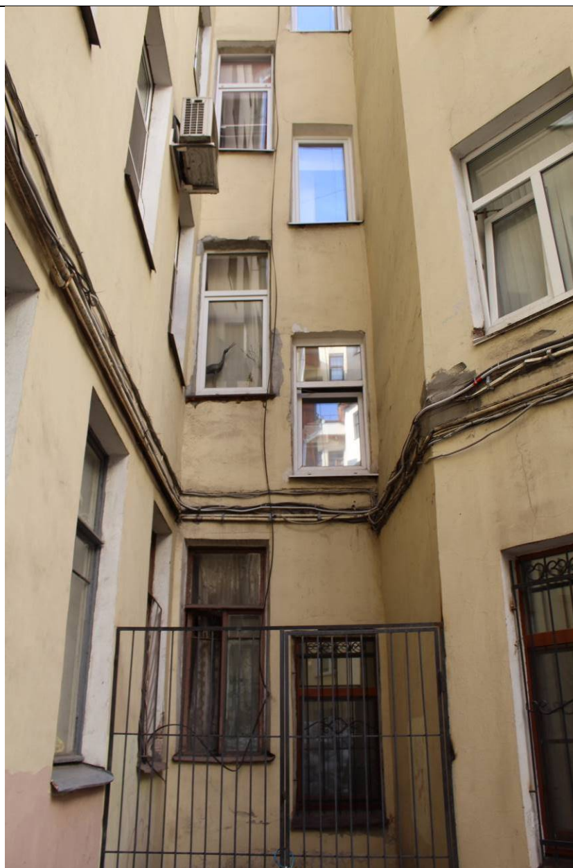
23. Дом В. И. Яковлева и В. Г. Васильева. 15-я линия В.О., дом 34. Северный дворовый корпус. Фрагмент. Вид с юга. Фото: эксперт А. А. Кононов, 19.04.2021.
