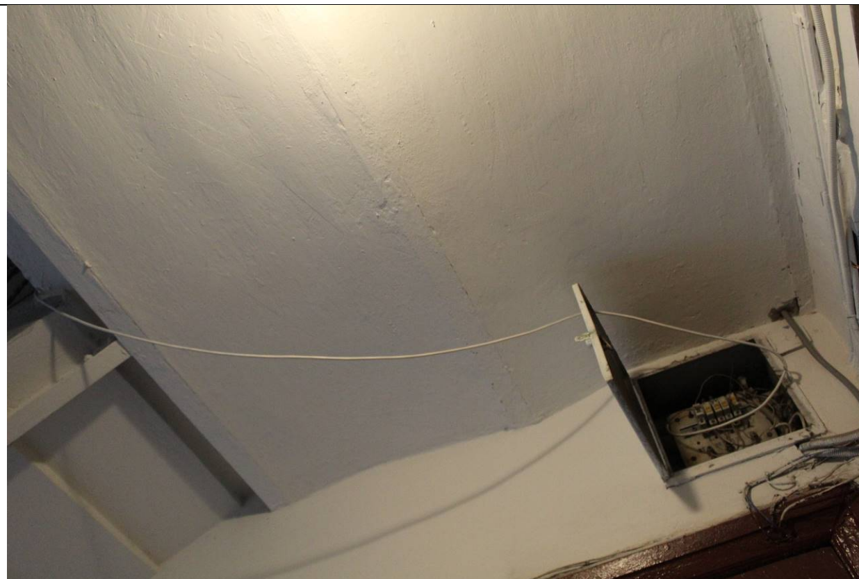
25. Дом В. И. Яковлева и В. Г. Васильева. 15-я линия В.О., дом 34. ЛК-2. Своды площадки 5 этажа. Фрагмент. Фото: эксперт А. А. Кононов, 19.04.2021.
