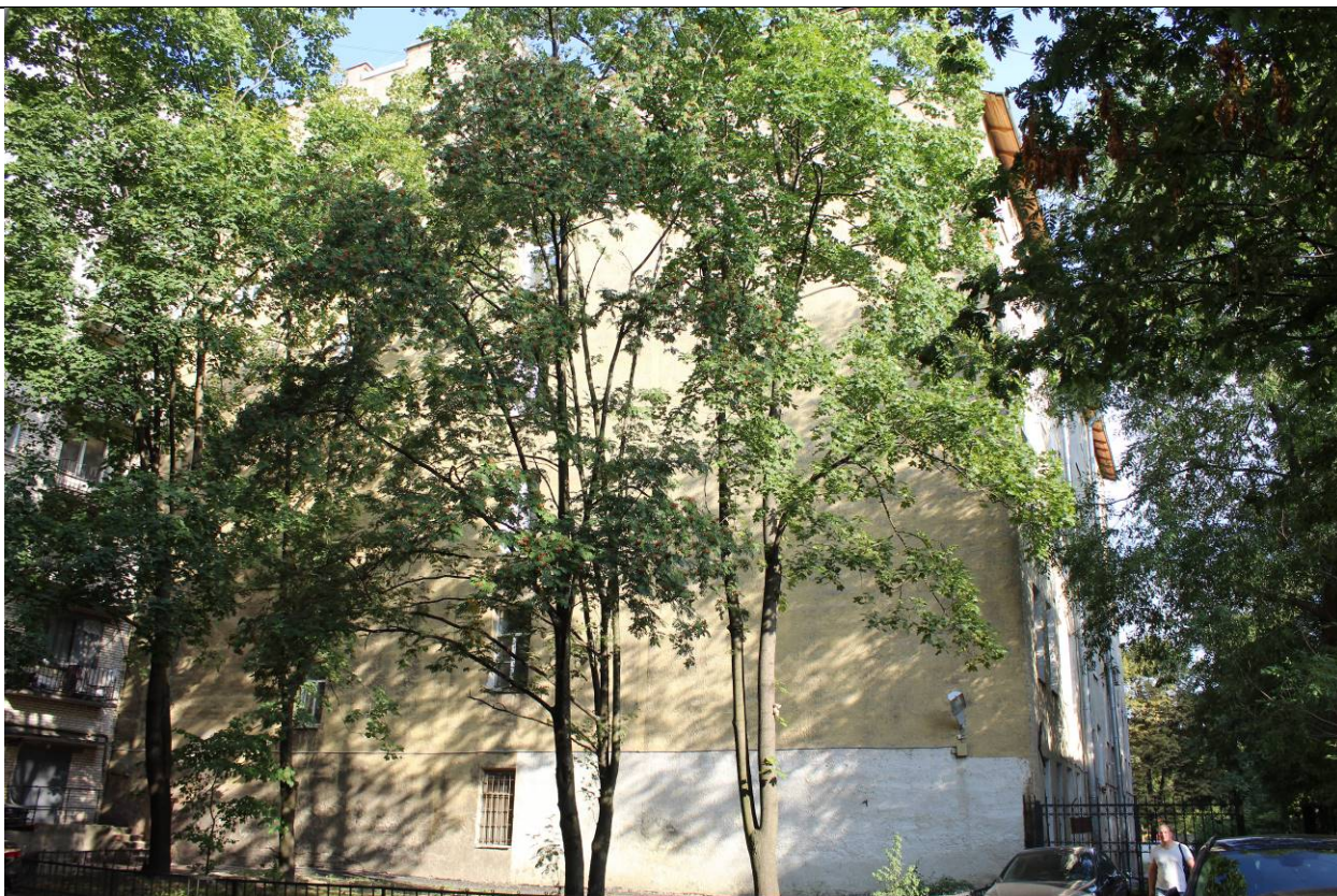
30. Дом В. И. Яковлева и В. Г. Васильева. 15-я линия В.О., дом 34. Вид на северный дворовый корпус с северо-запада. Фото: эксперт А. А. Кононов, 01.06.2021.
