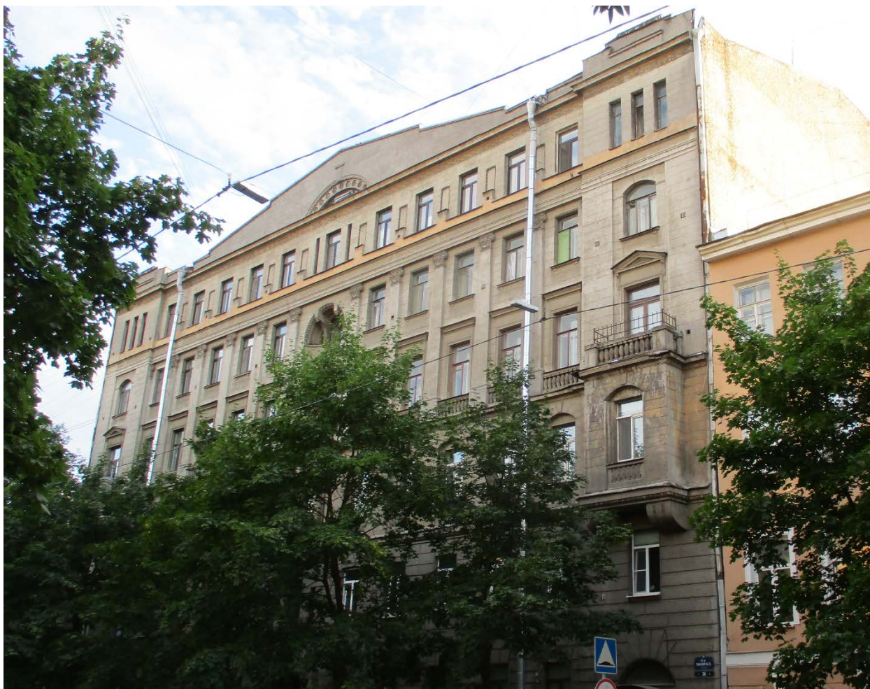
1. Санкт-Петербург, Василеостровский район, 11 линия В.О., дом 20, литера А. Лицевой фасад. 01.06.21
