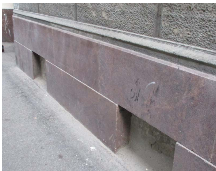
9. Санкт-Петербург, Василеостровский район, 11 линия В.О., дом 20, литера А. Фрагмент лицевого фасада. Цоколь. 01.06.21
