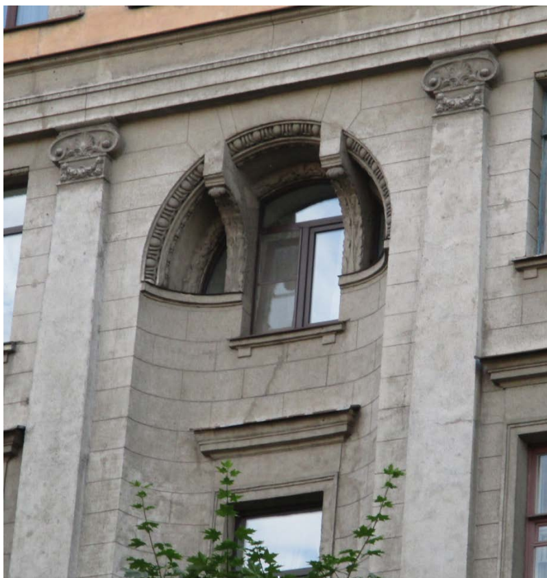
5. Санкт-Петербург, Василеостровский район, 11 линия В.О., дом 20, литера А. Фрагмент лицевого фасада. 01.06.21
