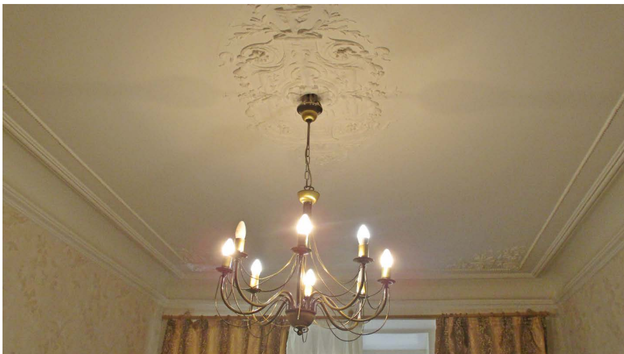
22. Санкт-Петербург, Василеостровский район, 11 линия В.О., дом 20, литера А. Лицевой корпус. Интерьер. Квартира № 34 (2 этаж), пом.8. Декоративное оформление плафона.
