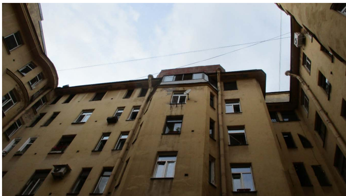
19. Санкт-Петербург, Василеостровский район, 11 линия В.О., дом 20, литера А. Северный флигель. Вид эркера, карниз. 19.04.21
