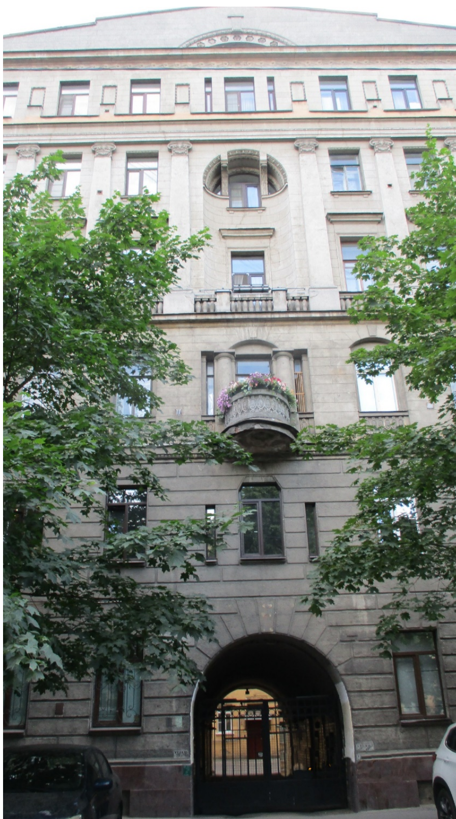
2. Санкт-Петербург, Василеостровский район, 11 линия В.О., дом 20, литера А. Фрагмент лицевого фасада. 01.06.21
