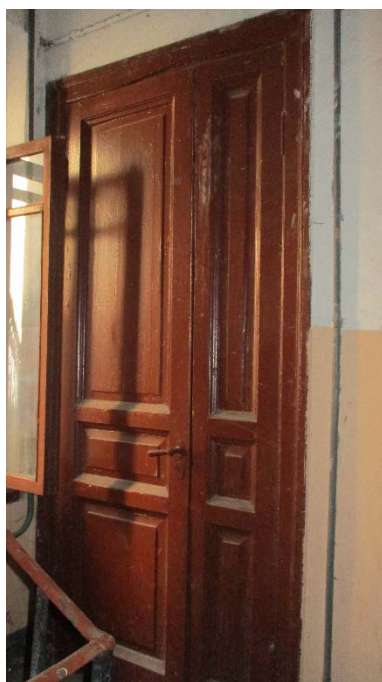
48. Санкт-Петербург, Василеостровский район, 11 линия В.О., дом 20, литера А. Западный флигель. Интерьер. Лестница Л-5, служебная (южная). Дверь кв. 35 (2 этаж)
