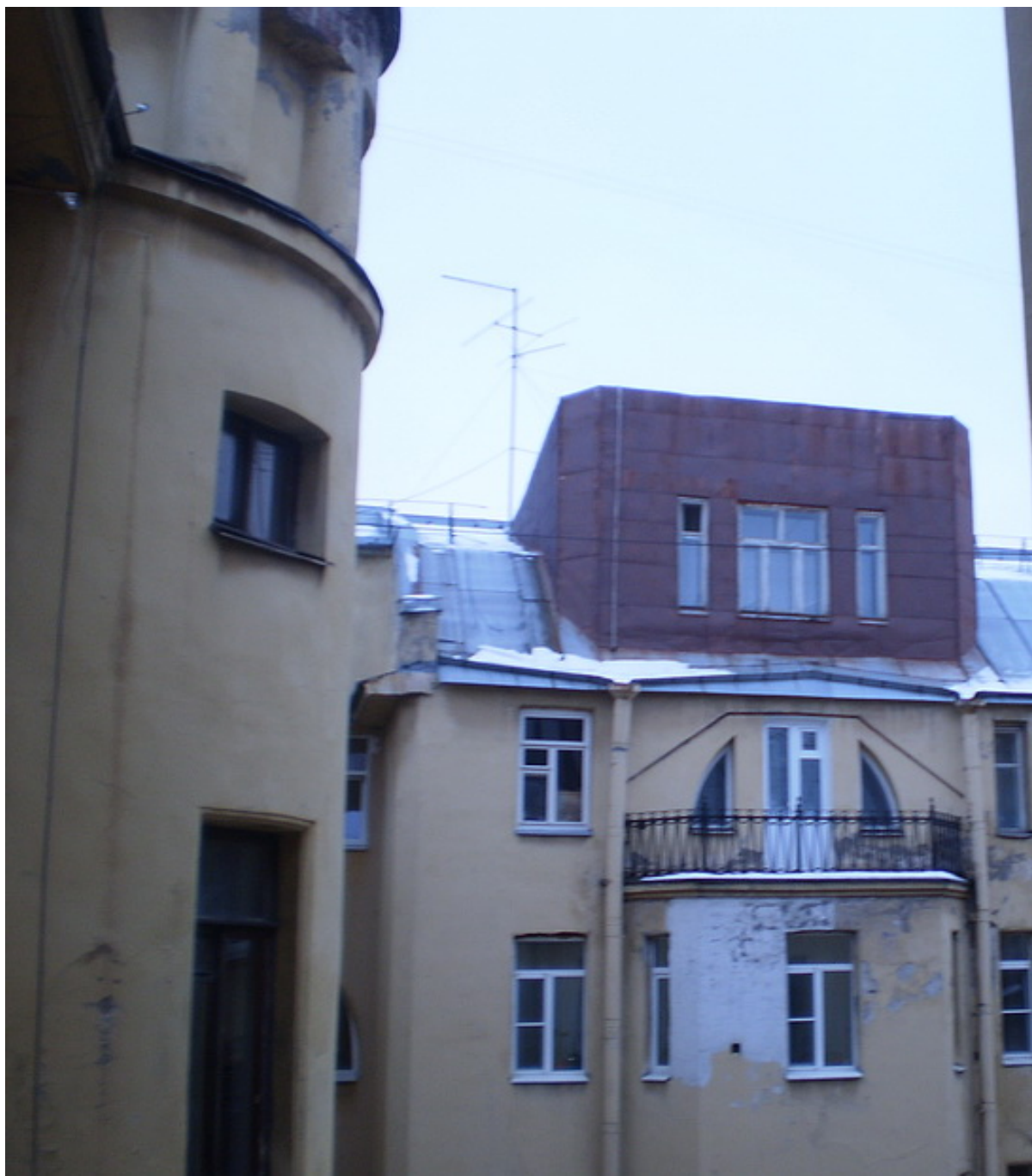
46. Дворовый фасад южного бокового флигеля с мансардой, возведенной по проекту, утвержденному 13 июля 1915 г. https://www.citywalls.ru/
