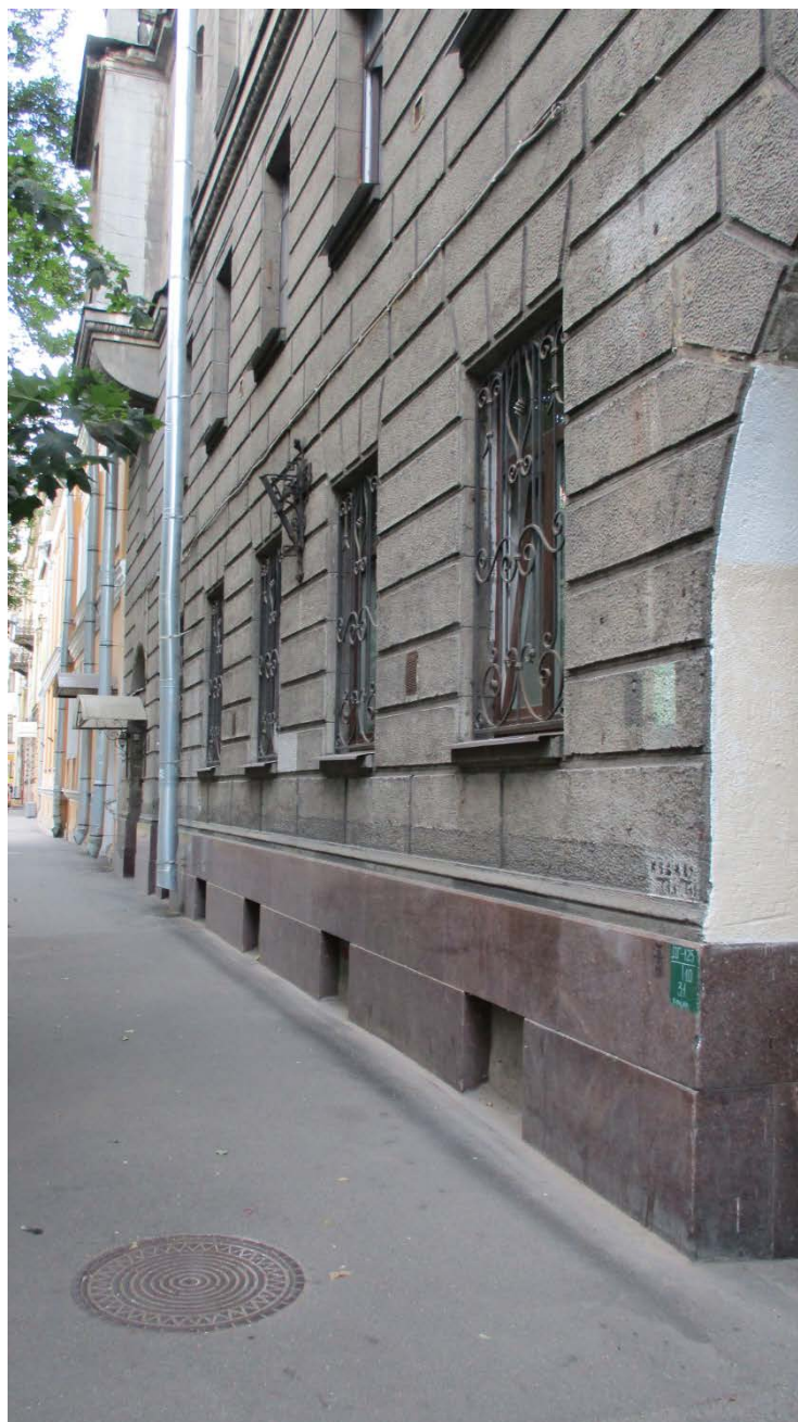
3. Санкт-Петербург, Василеостровский район, 11 линия В.О., дом 20, литера А. Фрагмент лицевого фасада. 01.06.21
