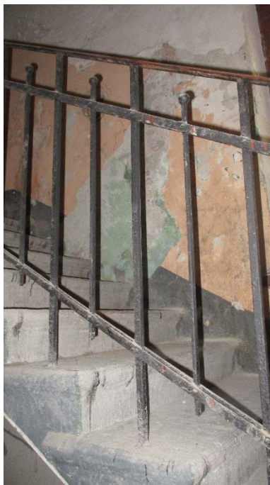
47. Санкт-Петербург, Василеостровский район, 11 линия В.О., дом 20, литера А. Западный флигель. Интерьер. Лестница Л-5, служебная (южная). Ограждение маршей.
