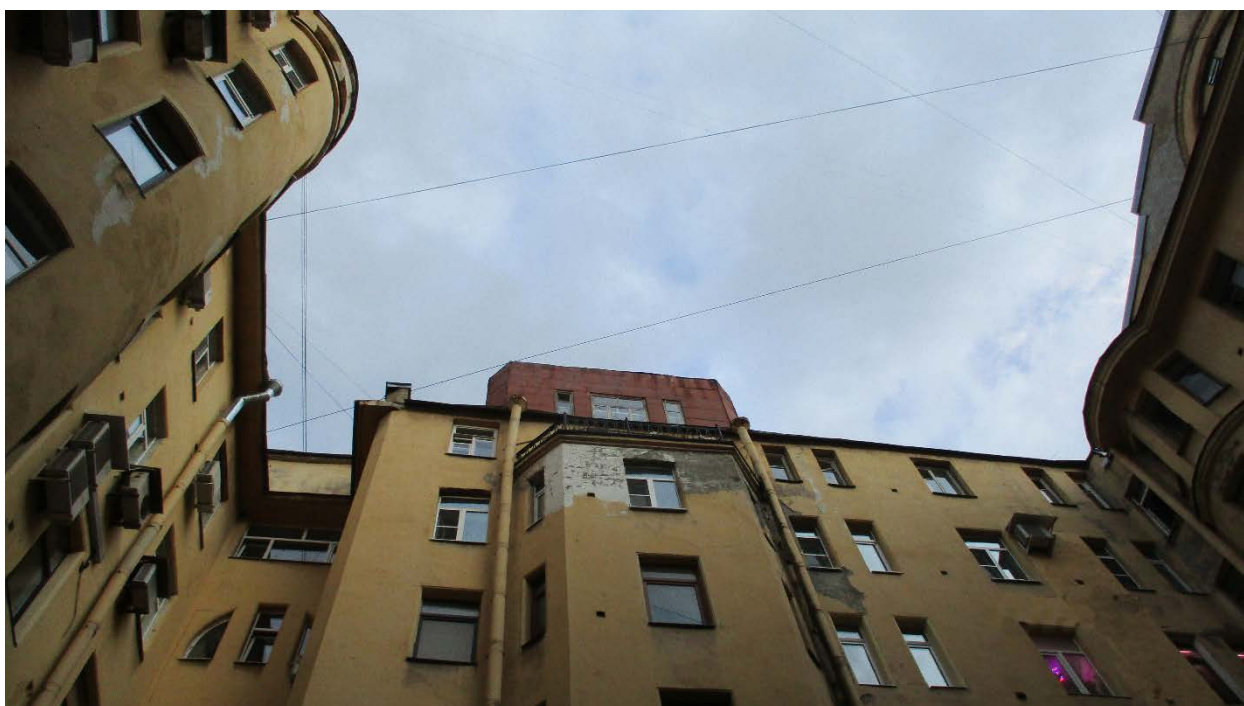
16. Санкт-Петербург, Василеостровский район, 11 линия В.О., дом 20, литера А. Южный флигель. Фрагмент фасада.01.06.21
