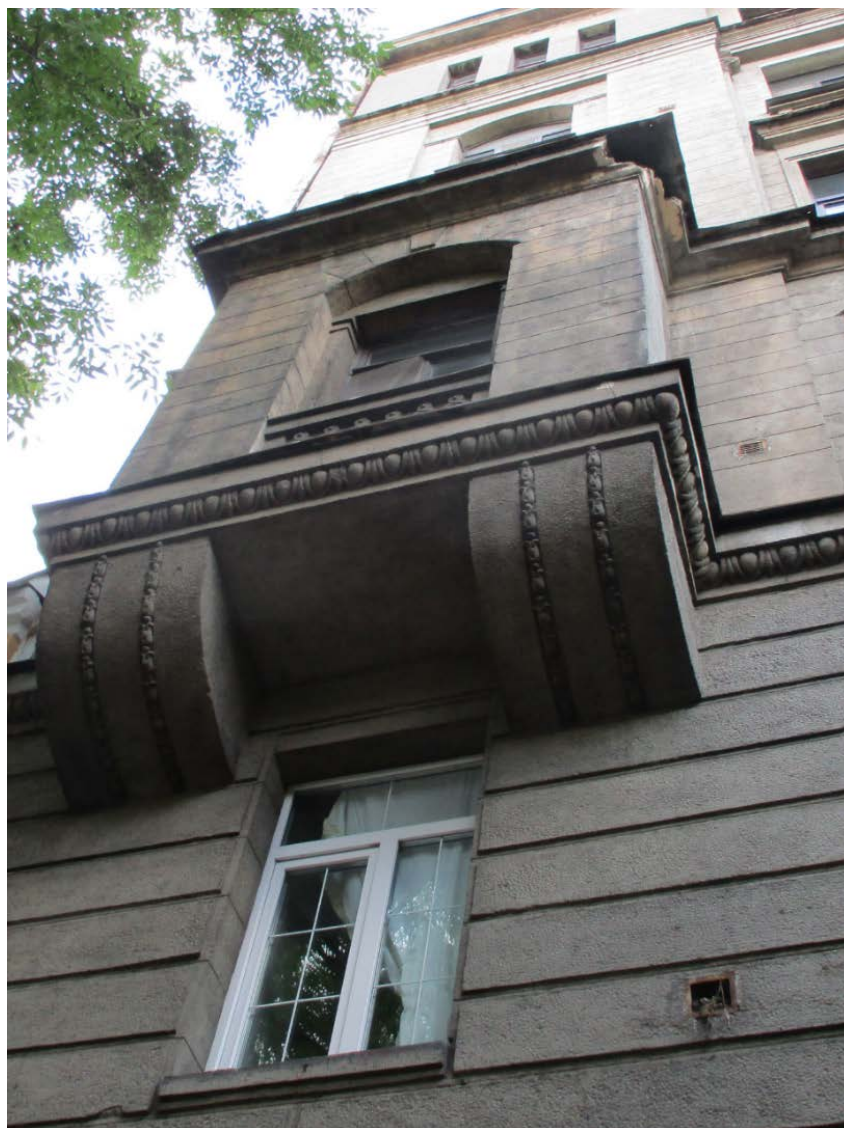
4. Санкт-Петербург, Василеостровский район, 11 линия В.О., дом 20, литера А. Фрагмент лицевого фасада. 01.06.21
