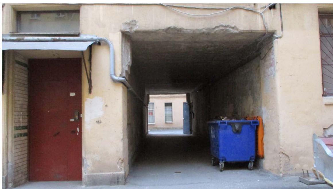
21. Санкт-Петербург, Василеостровский район, 11 линия В.О., дом 20, литера А. Западный флигель. Фрагмент восточного фасада. 19.04.21
