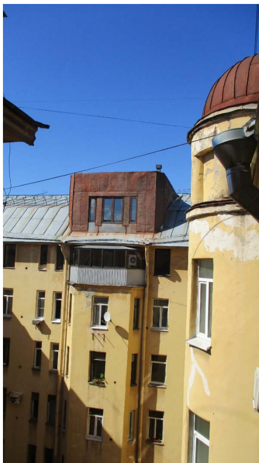
18. Санкт-Петербург, Василеостровский район, 11 линия В.О., дом 20, литера А. Северный флигель. Вид эркера и мансарды. 19.04.21
