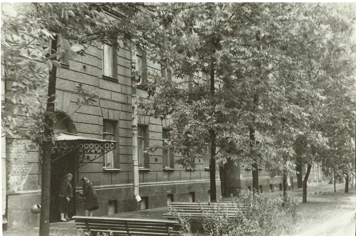
42. Фрагмент лицевого фасада в уровне 1-2 этажей. Фото 1975 г. https://pastvu.com/p/196449
