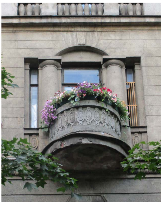
6. Санкт-Петербург, Василеостровский район, 11 линия В.О., дом 20, литера А. Фрагмент лицевого фасада. 01.06.21
