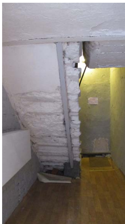
4. Санкт-Петербург, Василеостровский район, 11 линия В.О., дом 20, литера Б. Интерьер. Лестничная клетка в уровне 1 этажа. Фото: 01.06.21
