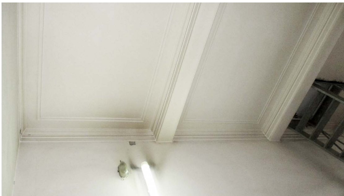
32. г.Санкт-Петербург, Кондратьевский проспект, дом 44, литера А. Интерьер. Перекрытие лестничной клетки, декоративное оформление плафона площадки лестницы.
