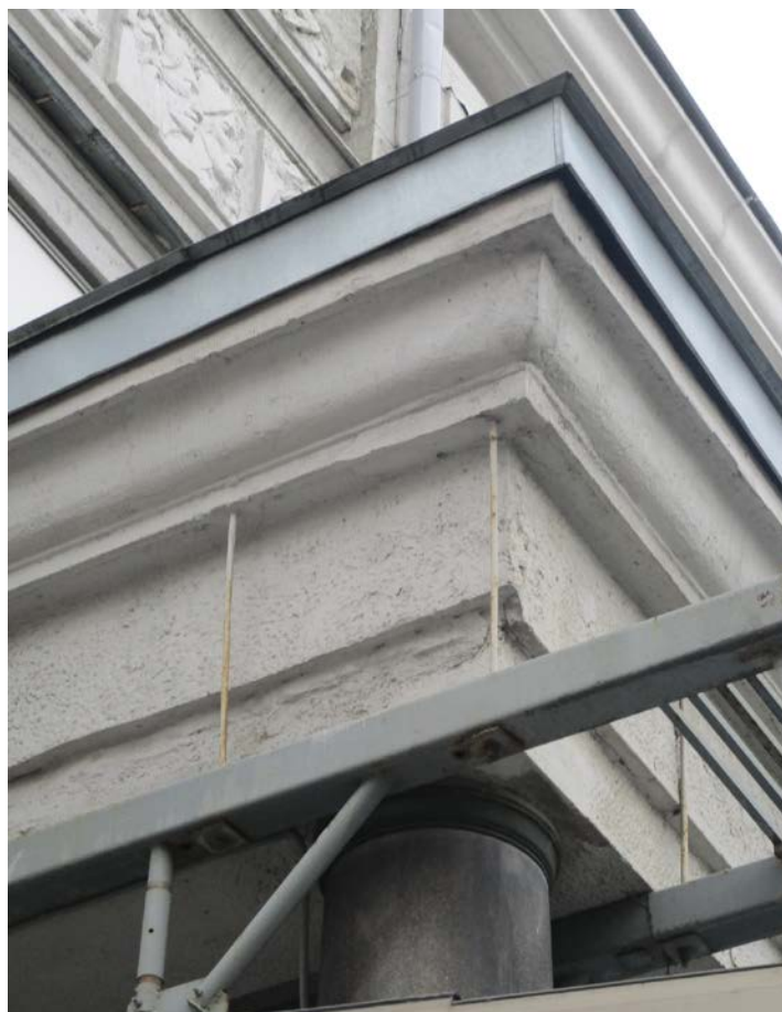
24. г.Санкт-Петербург, Кондратьевский проспект, дом 44, литера А. Венчающий карниз портика южного фасада.
