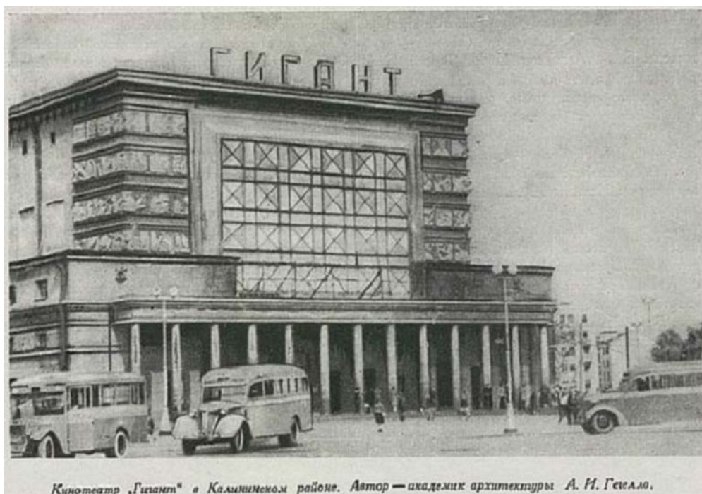
36. Кинотеатр «Гигант». 1947 г. (Баранов Н.В. «Архитектура и строительство Ленинграда», Л., 1948)
