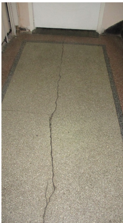
12. г.Санкт-Петербург, Кондратьевский проспект, дом 44, литера А. Интерьер. Лестница восточного объема (северная). Покрытие междуэтажной площадки- террацо.
