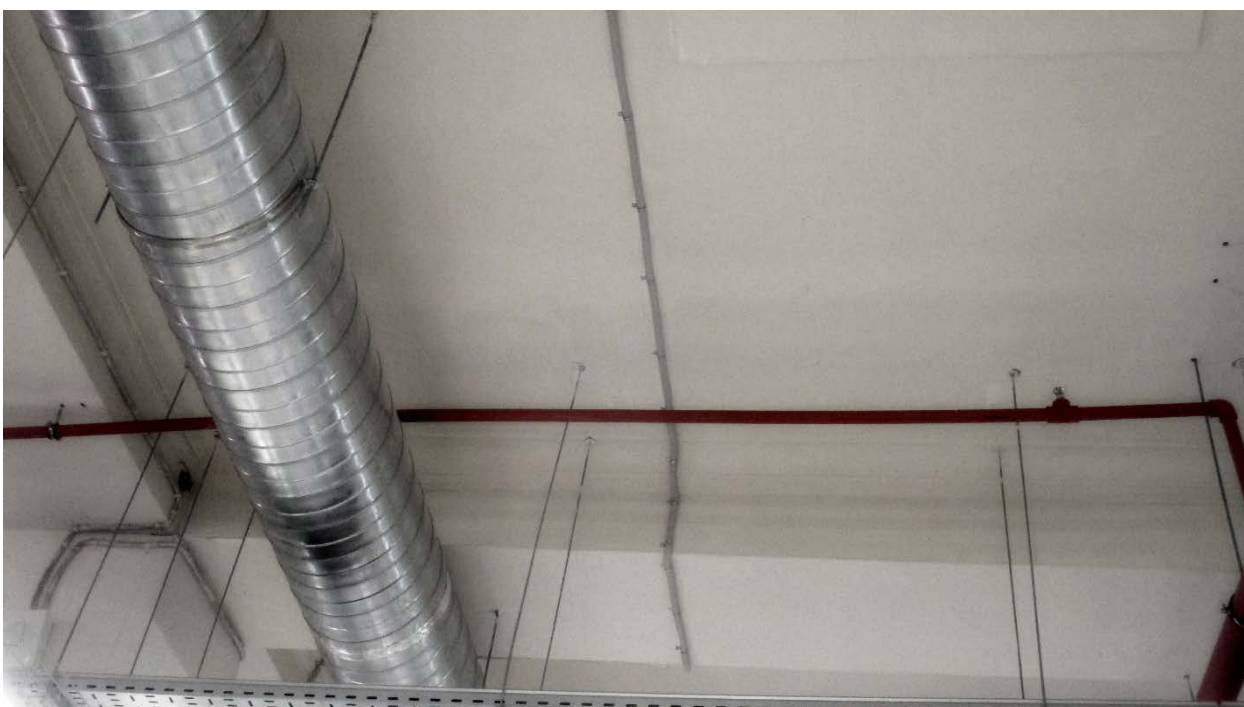
39. г.Санкт-Петербург, Кондратьевский проспект, дом 44, литера А. Интерьер. Помещение на 1 этаже.
