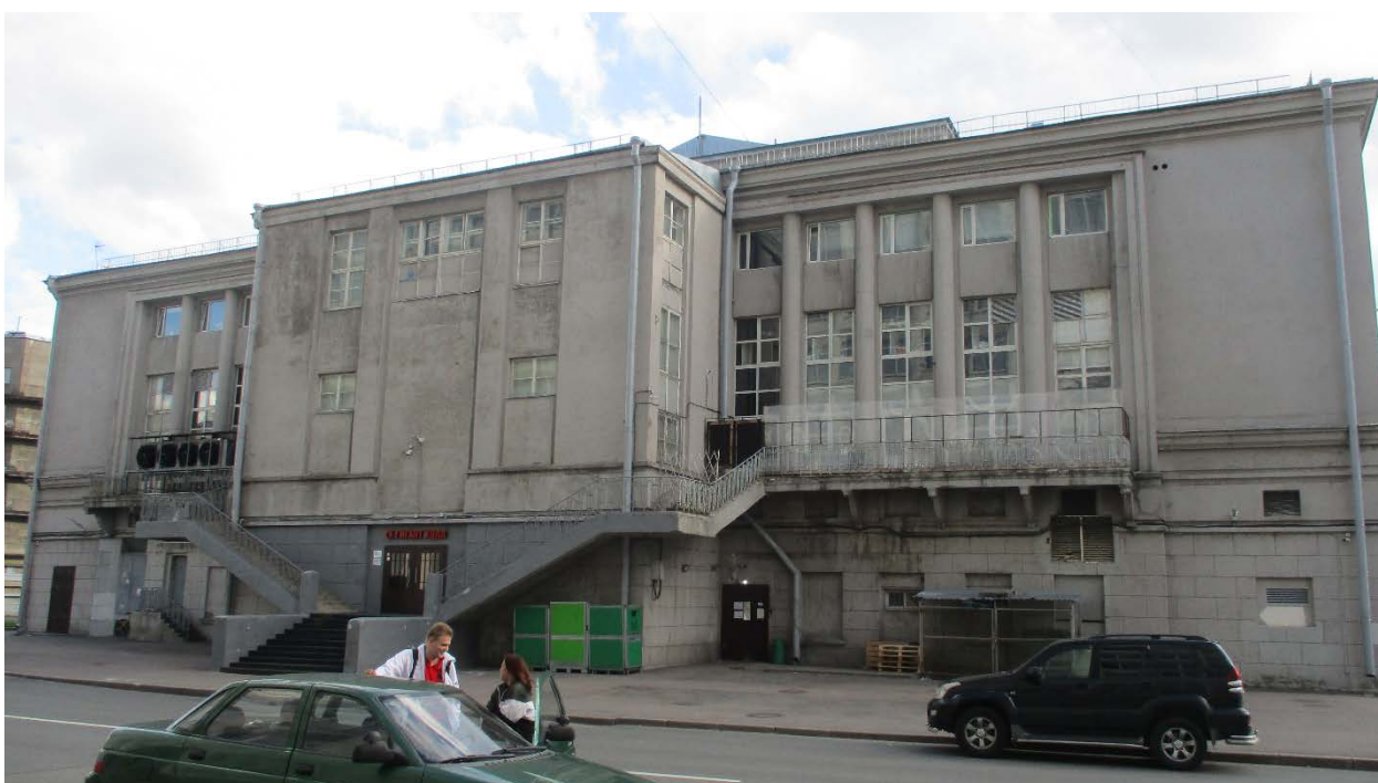
6. г.Санкт-Петербург, Кондратьевский проспект, дом 44, литера А. Северный фасад.
