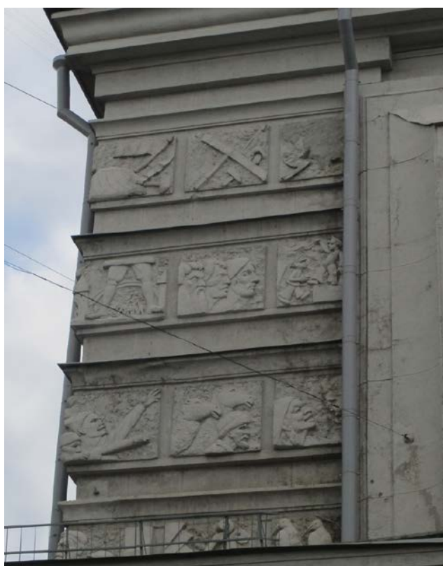
14. г. Санкт-Петербург, Кондратьевский проспект, дом 44, литера А. Фрагмент южного фасада. Западная барельефная композиция.
