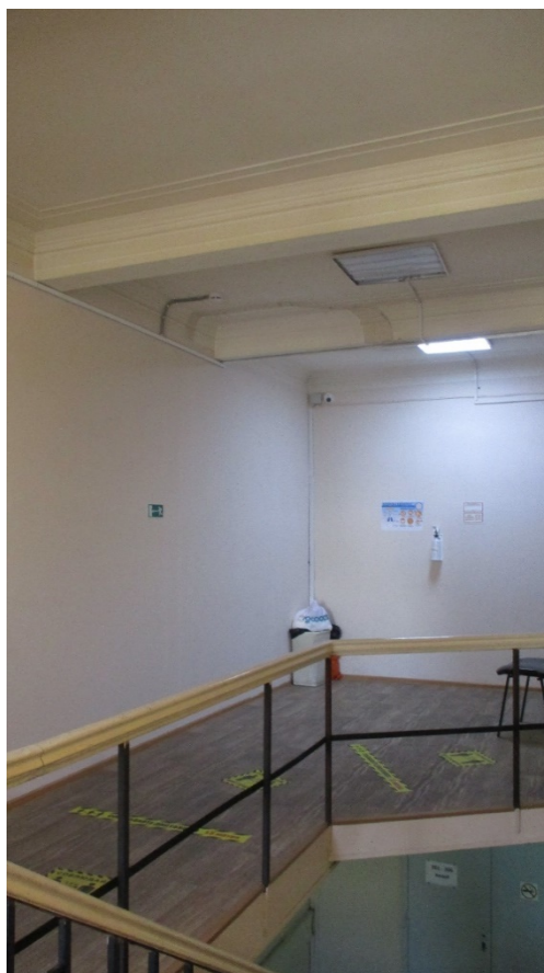
13. г.Санкт-Петербург, Кондратьевский проспект, дом 44, литера А. Интерьер. Лестница восточного объема (северная). Площадка в уровне 3 этажа.
