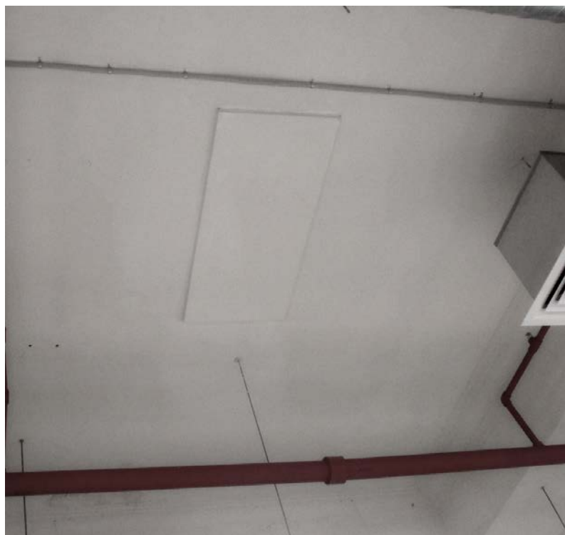
40. г.Санкт-Петербург, Кондратьевский проспект, дом 44, литера А. Интерьер. Помещение на 1 этаже. Декоративное оформление плафона.
