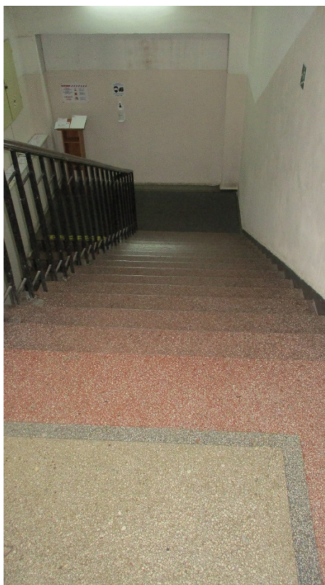
7. г.Санкт-Петербург, Кондратьевский проспект, дом 44, литера А. Интерьер. Лестница восточного объема (центральная).
