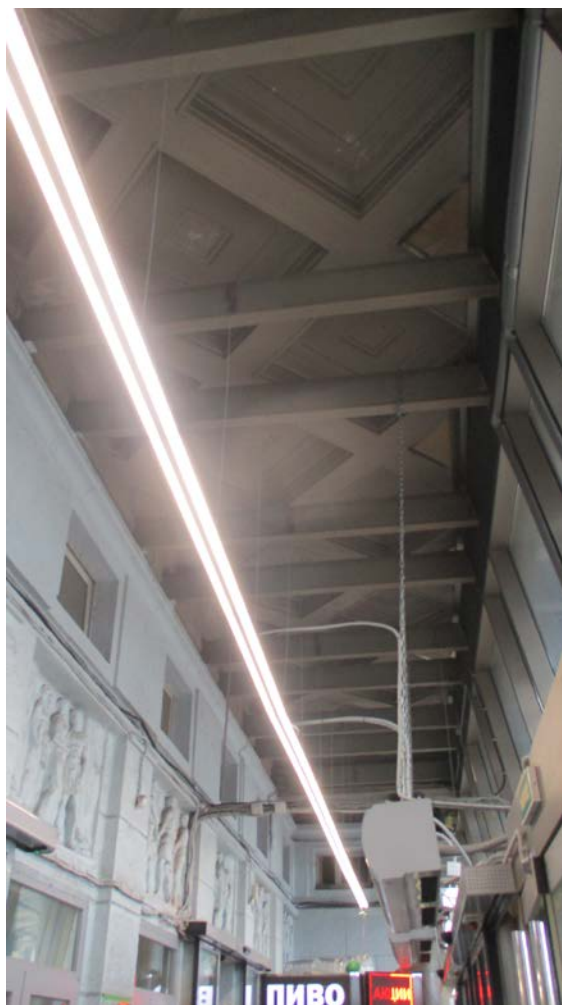
18. г.Санкт-Петербург, Кондратьевский проспект, дом 44, литера А. Кессонированное перекрытие портика.
