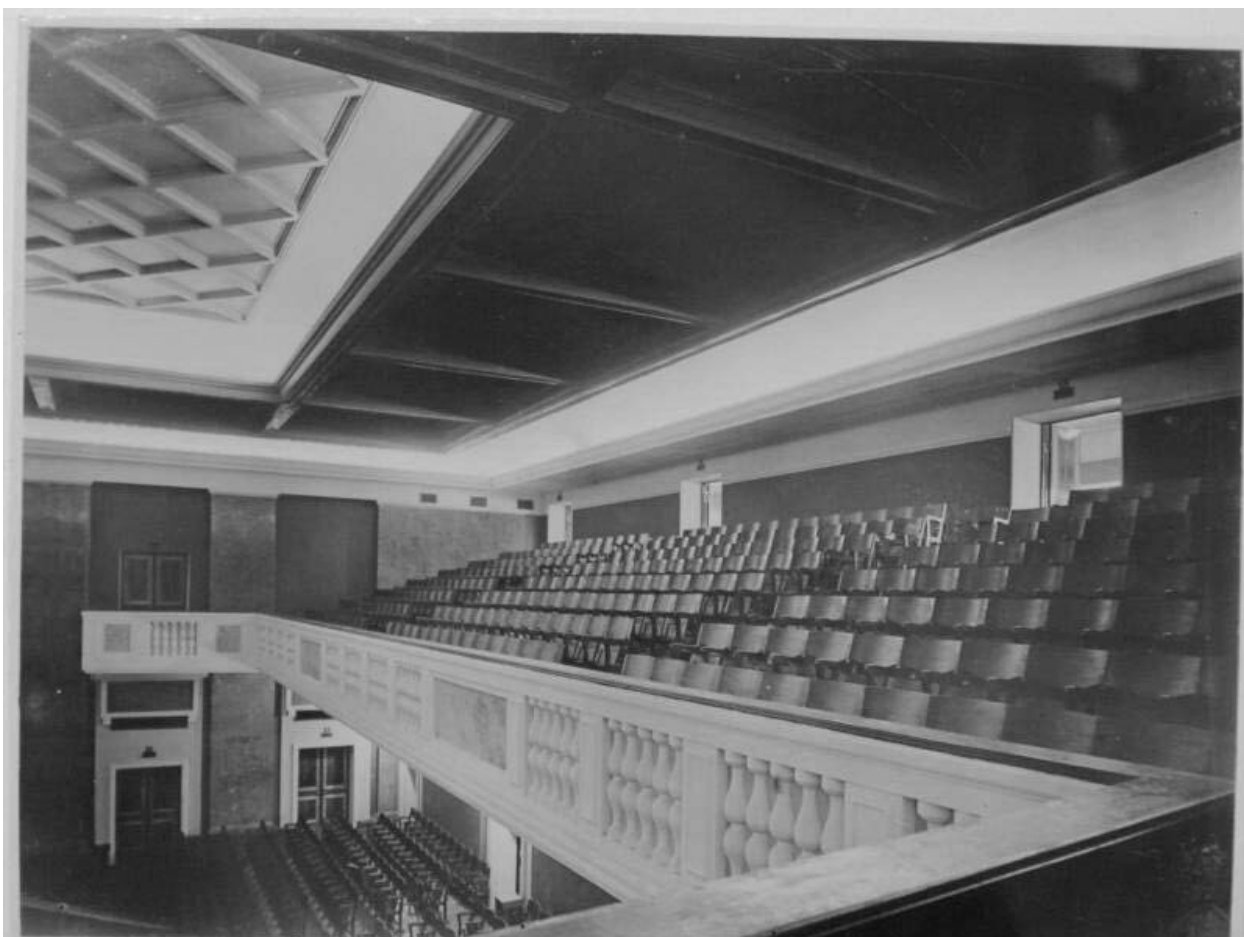
23. Кинотеатр "Гигант". Интерьер зала. Общий вид балкона. 1936 г. Фото Андреевского Л. Г. ( http://goskatalog.ru )
