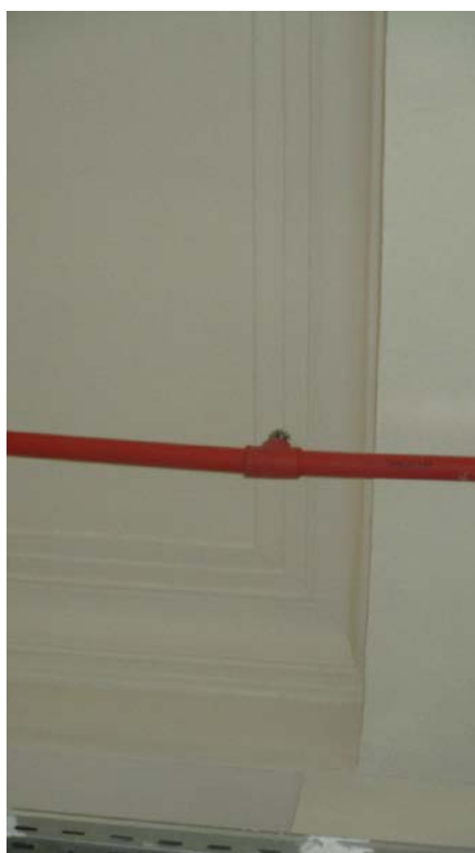
41. г.Санкт-Петербург, Кондратьевский проспект, дом 44, литера А. Интерьер. Помещение на 1 этаже. Декоративное оформление плафона.
