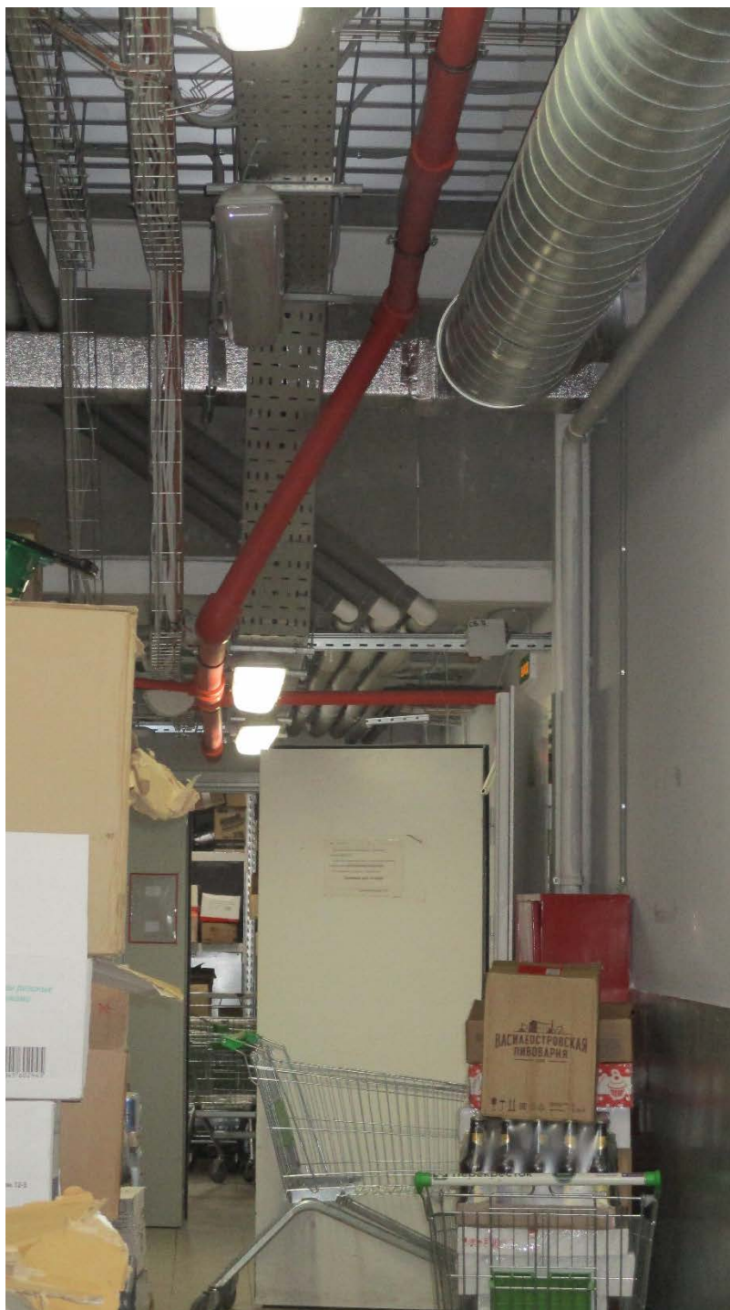
37. г.Санкт-Петербург, Кондратьевский проспект, дом 44, литера А. Интерьер. Помещение на1 этаже.
