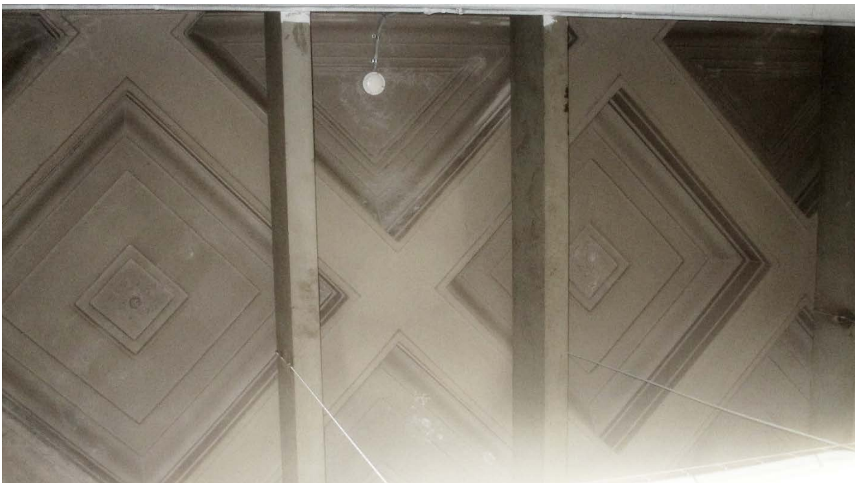
42. г.Санкт-Петербург, Кондратьевский проспект, дом 44, литера А. Помещение тамбура на 1 этаже (в объеме портика). Оформление кессонированного ререкрытия.
