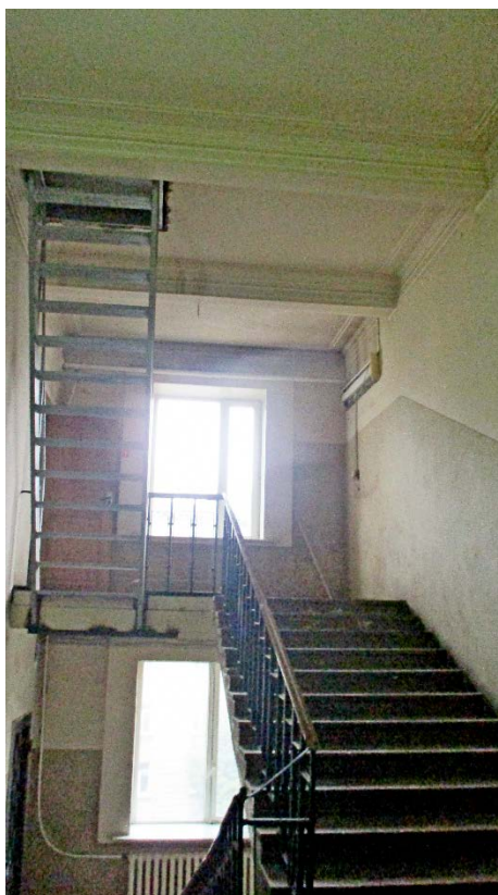
31. г.Санкт-Петербург, Кондратьевский проспект, дом 44, литера А. Интерьер. Перекрытие лестничной клетки.
