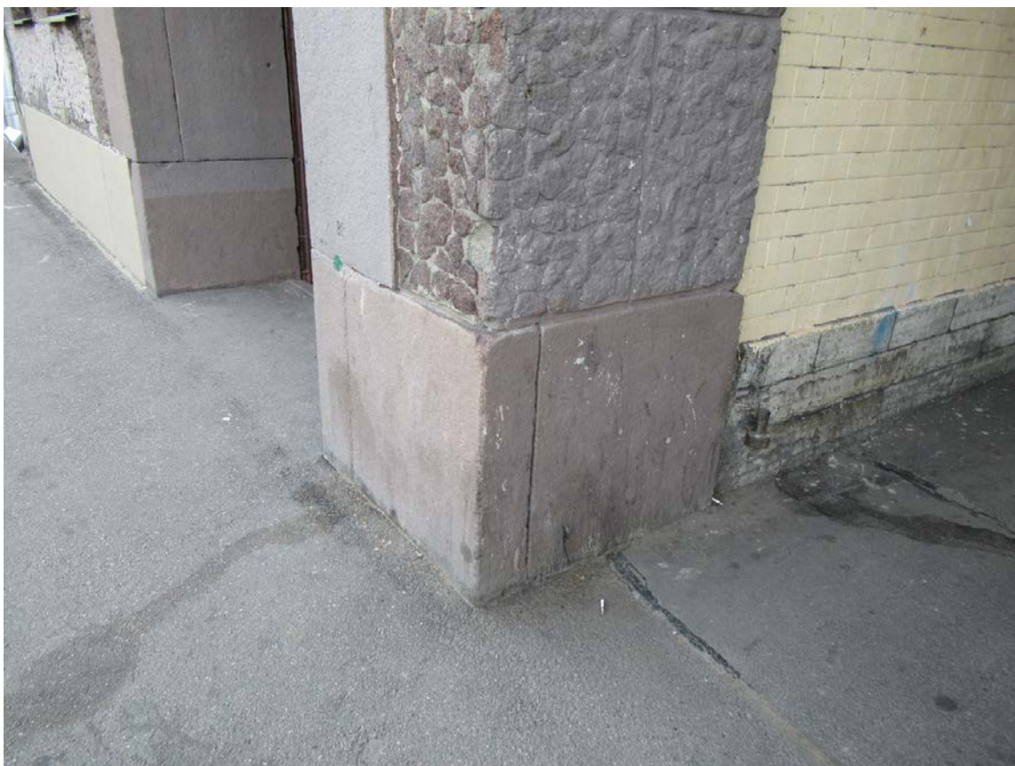
18. 15-я линия В.О., 70. Дом М.М. Кудрявцева. Фрагмент облицовки цоколя лицевого фасада.
