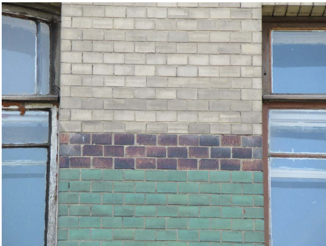
16. 15-я линия В.О., 70. Дом М.М. Кудрявцева. Фрагмент отделки лицевого фасада облицовочной плиткой в уровне 2 этажа.
