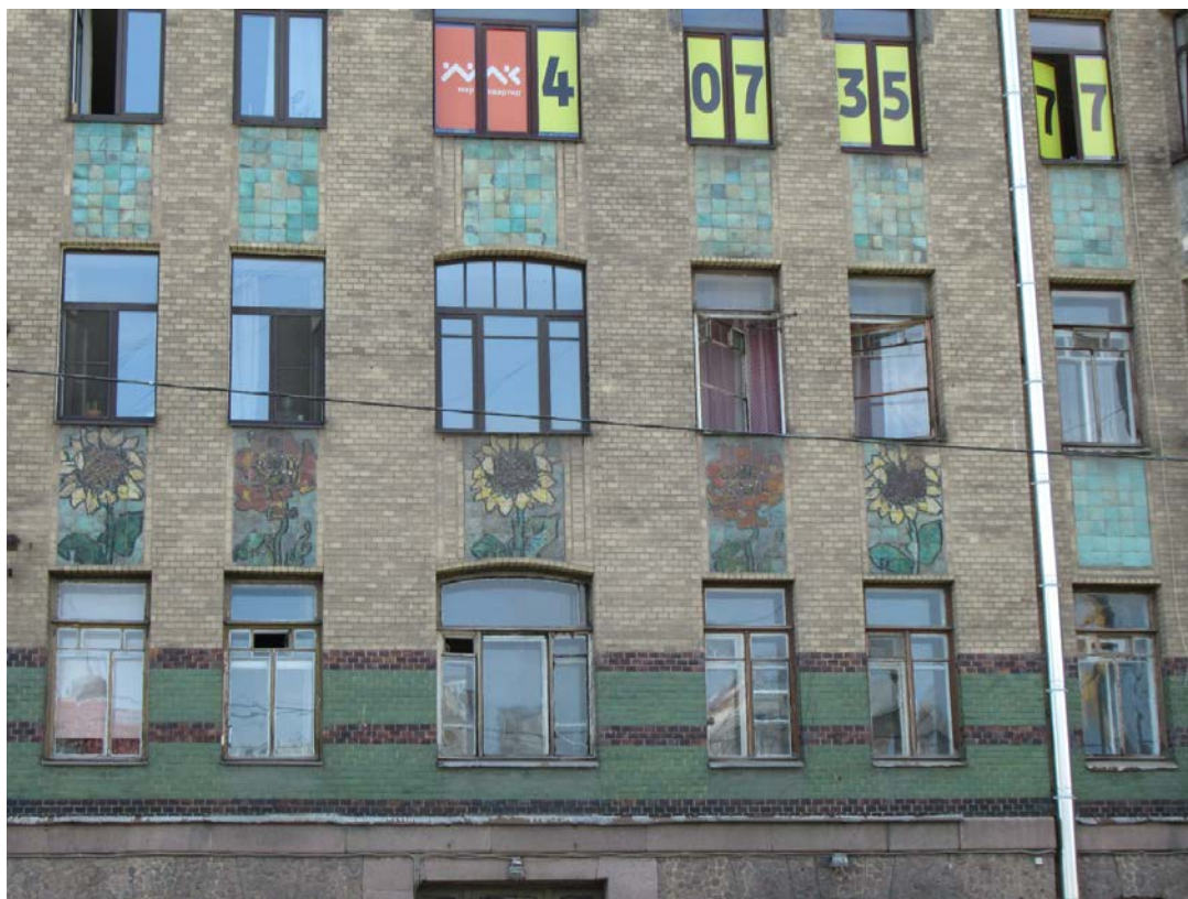
7. 15-я линия В.О., 70. Дом М.М. Кудрявцева. Центральная часть лицевого фасада в уровне 2-4 этажей.
