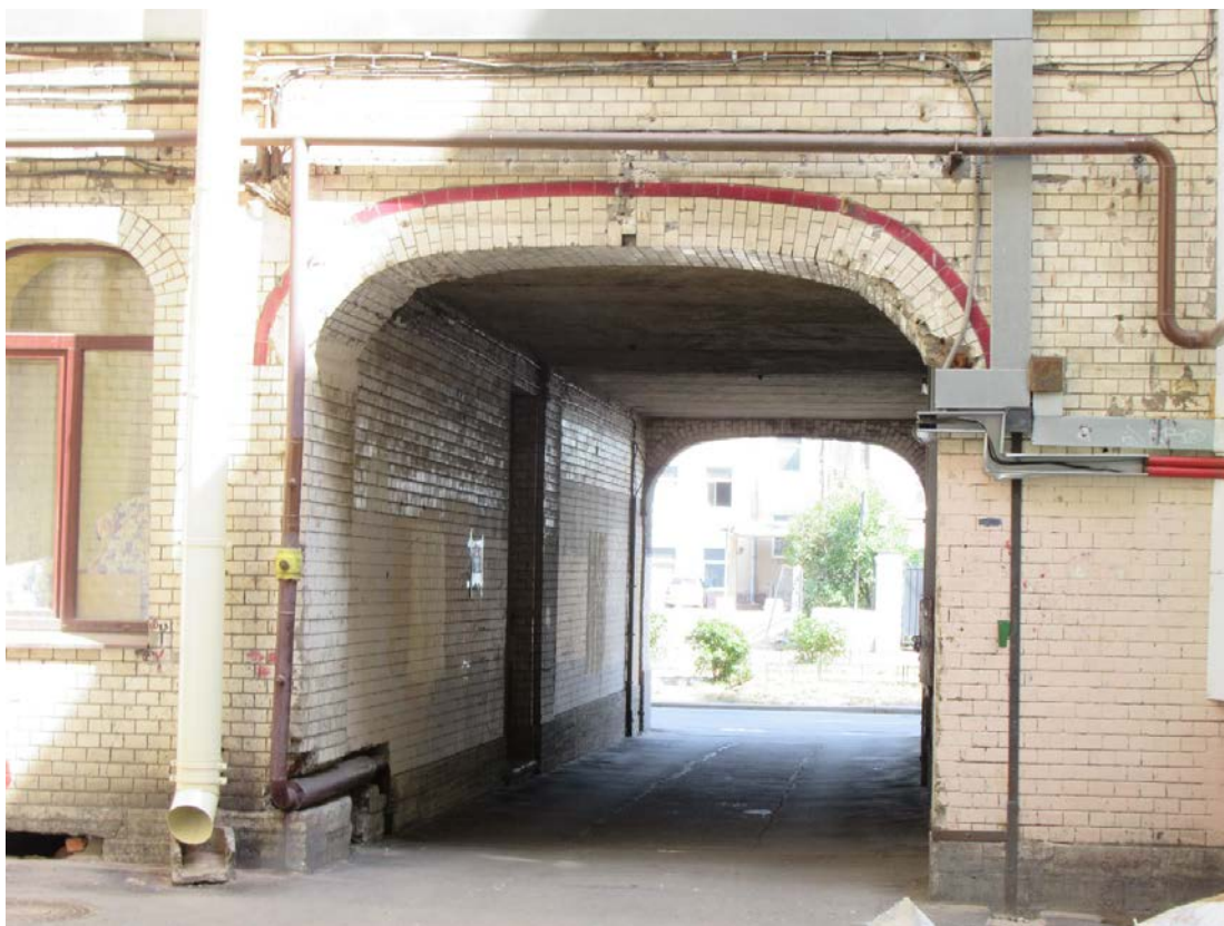
40. 15-я линия В.О., 70. Дом М.М. Кудрявцева. Вид на проезд лицевого корпуса со стороны двора.
