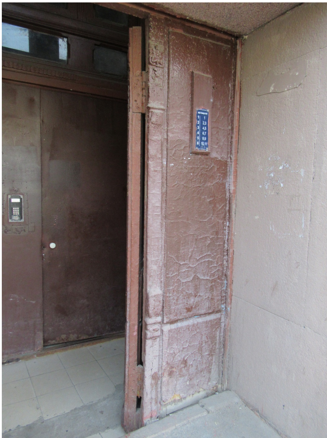
14. 15-я линия В.О., 70. Дом М.М. Кудрявцева. Деревянное заполнение дверного проема лицевого фасада.
