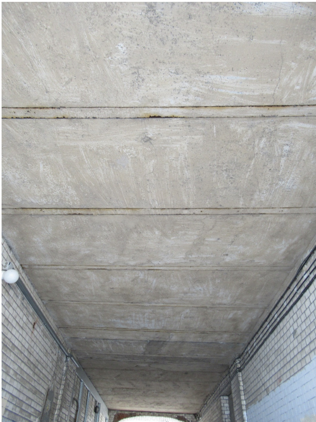
28. 15-я линия В.О., 70. Дом М.М. Кудрявцева. Потолок проезда лицевого корпуса с прусскими сводами.
