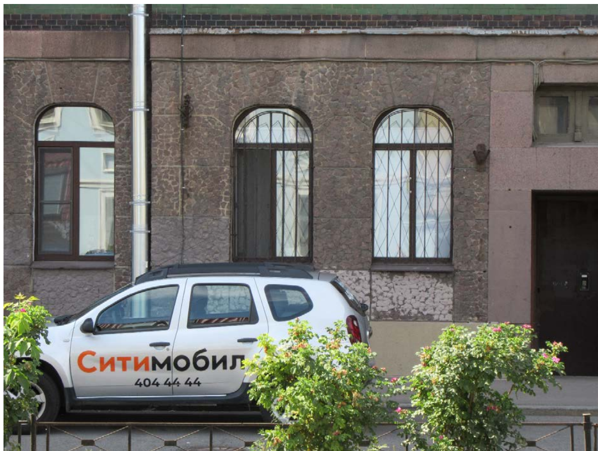
9. 15-я линия В.О., 70. Дом М.М. Кудрявцева. Фрагмент лицевого фасада в уровне 1 этажа.
