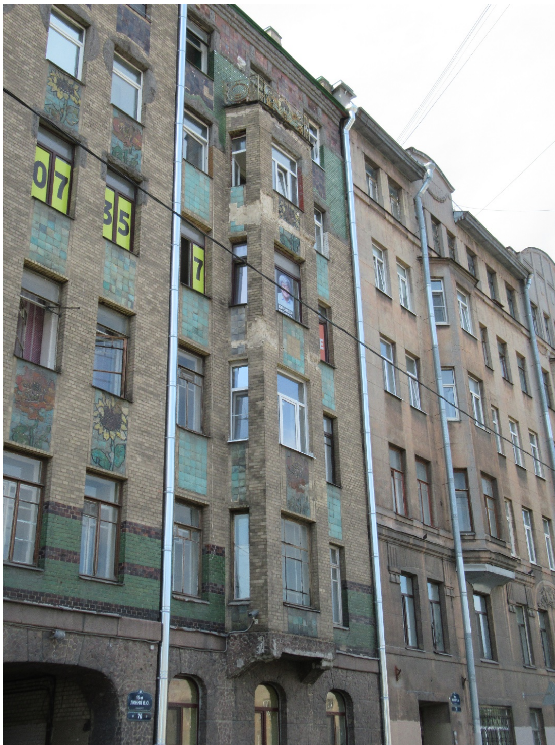
20. 15-я линия В.О., 70. Дом М.М. Кудрявцева. Вид на северный эркер лицевого фасада.
