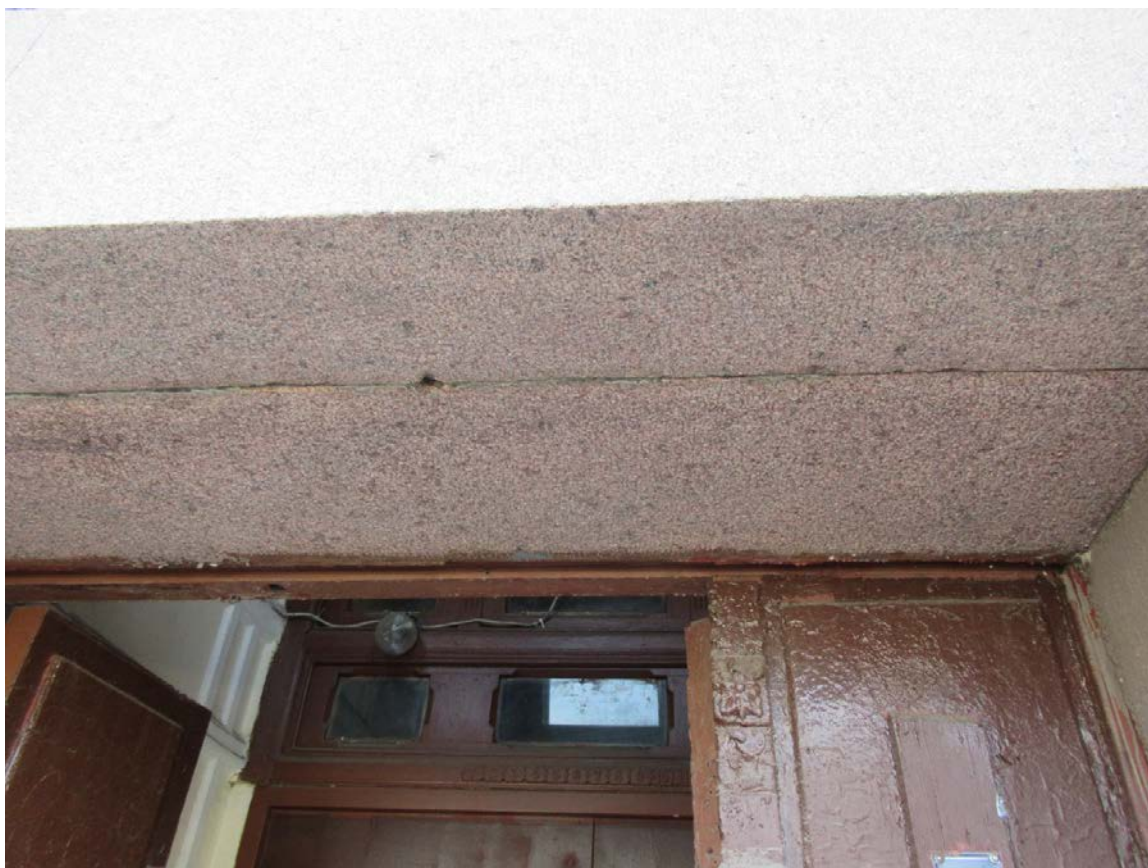
11. 15-я линия В.О., 70. Дом М.М. Кудрявцева. Облицовка откосов входного проема лицевого фасада.
