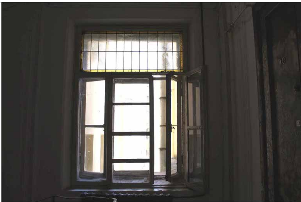
24. Дом В. И. Упатчева. 12 линия, д. 13. Лицевой корпус. Интерьеры. ЛК-1. Оконные проемы с витражом в уровне 3 этажа. Фото эксперта А. А. Кононова. 19.04.2021.
