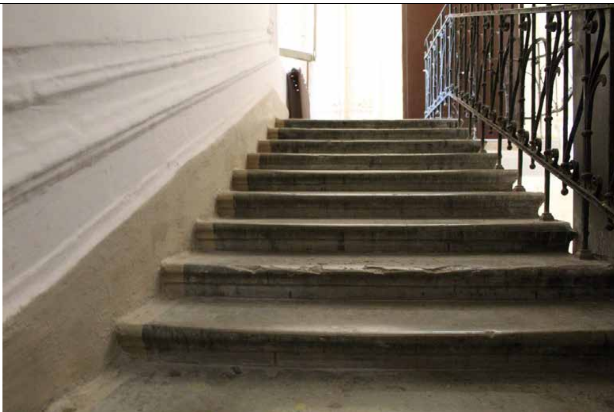
28. Дом В. И. Упатчева. 12 линия, д. 13. Лицевой корпус. Интерьеры. ЛК-1. Ступени с валиком. Фото эксперта А. А. Кононова. 19.04.2021.
