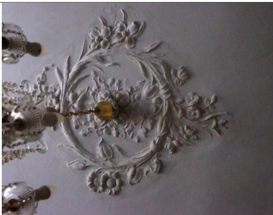
15. Дом В. И. Упатчева. 12 линия, д. 13. Интерьер квартиры № 22 комнаты № 6. Потолочная лепнина. Центральная розетка. Фото эксперта А. А. Кононова. 01.06.2021
