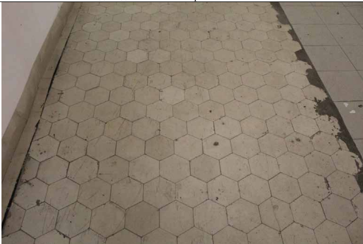
4. Дом В. И. Упатчева. 12 линия, д. 13. Лицевой корпус. Интерьеры. ЛК-1. Вестибюль. Фрагмент напольного покрытия. Фото эксперта А. А. Кононова. 19.04.2021.
