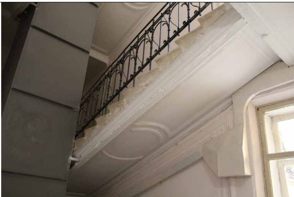
11. Дом В. И. Упатчева. 12 линия, д. 13. Лицевой корпус. Интерьеры. ЛК-1. Фрагмент лестничного марша между 1 и 2 этажами. Фото эксперта А. А. Кононова. 19.04.2021.
