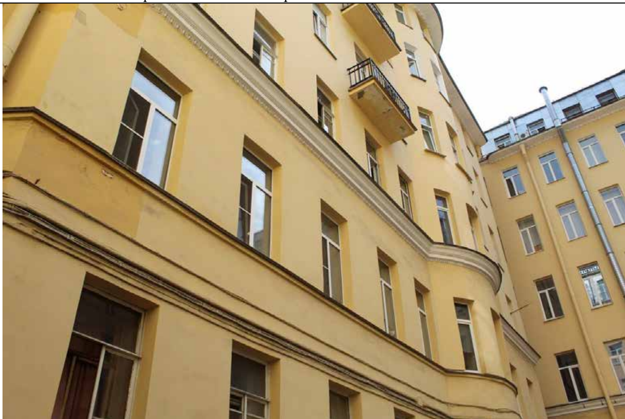
28. Дом В. И. Упатчева. 12 линия, д. 13. Фасад юго-восточного дворового корпуса. Фрагмент. Фото эксперта А. А. Кононова. 19.04.2021.
