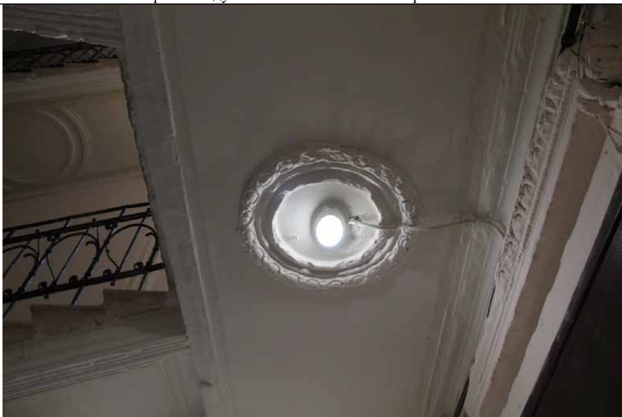
12. Дом В. И. Упатчева. 12 линия, д. 13. Лицевой корпус. Интерьеры. ЛК-1. Фрагмент оформления площадки 2 этажа. Фото эксперта А. А. Кононова. 19.04.2021.
