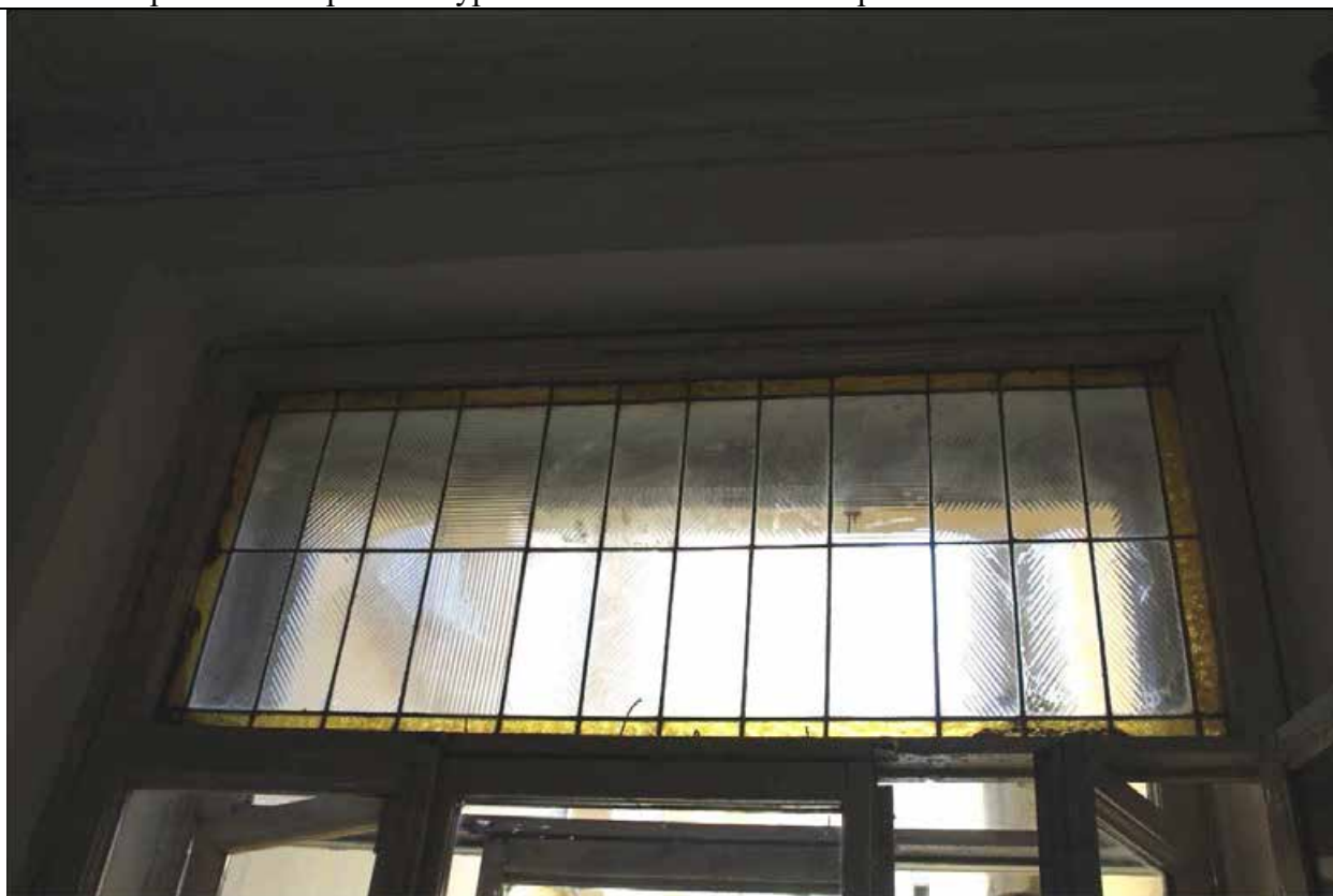
25. Дом В. И. Упатчева. 12 линия, д. 13. Лицевой корпус. Интерьеры. ЛК-1. Оконные проемы с витражом в уровне 3 этажа. Фото эксперта А. А. Кононова. 19.04.2021.
