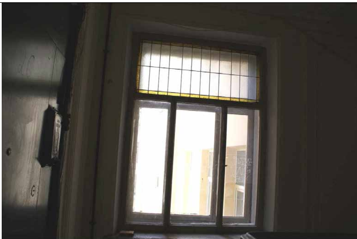
23. Дом В. И. Упатчева. 12 линия, д. 13. Лицевой корпус. Интерьеры. ЛК-2. Оконное заполнение площадки между 4 и 5 этажами. Фото эксперта А. А. Кононова. 19.04.2021.
