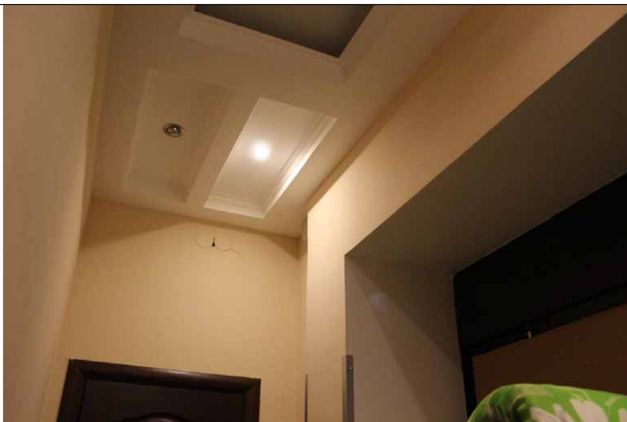
3. Дом В. И. Упатчева. 12 линия, д. 13. Интерьер помещения 1 этажа. Фрагмент. Дворовый северо-западный корпус. Фото эксперта А. А. Кононова. 19.04.2021.
