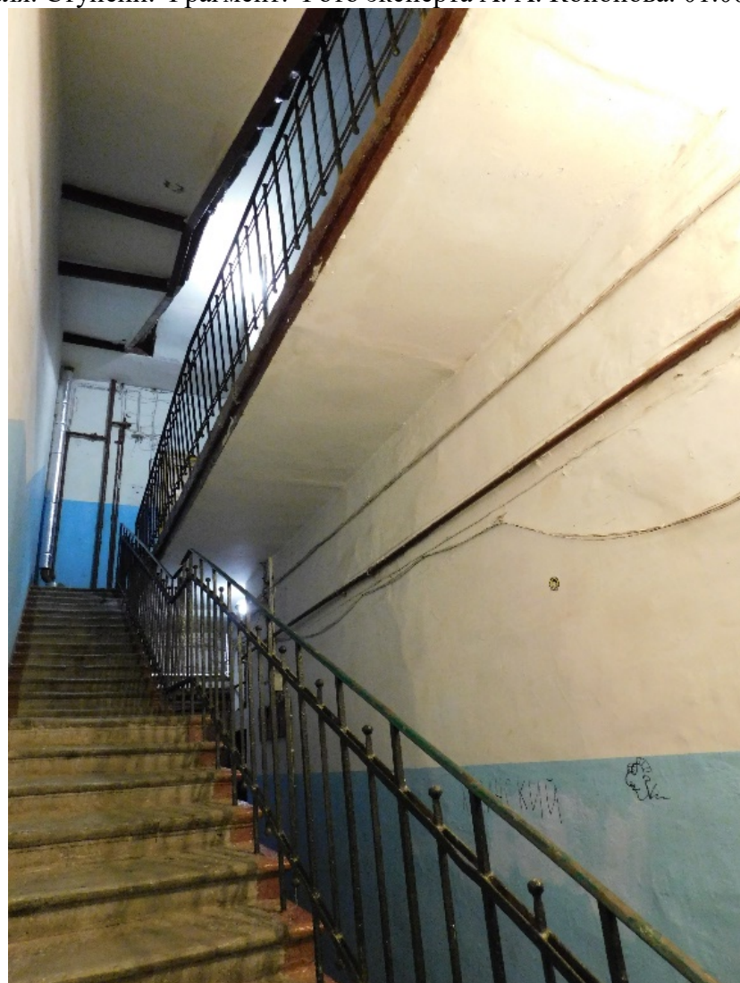
6. Дом В. И. Упатчева. 12 линия, д. 13. Южная межэтажная служебная лестница дворового флигеля. Вид на площадку 2-го этажа. Фото эксперта А. А. Кононова. 01.06.2021.
