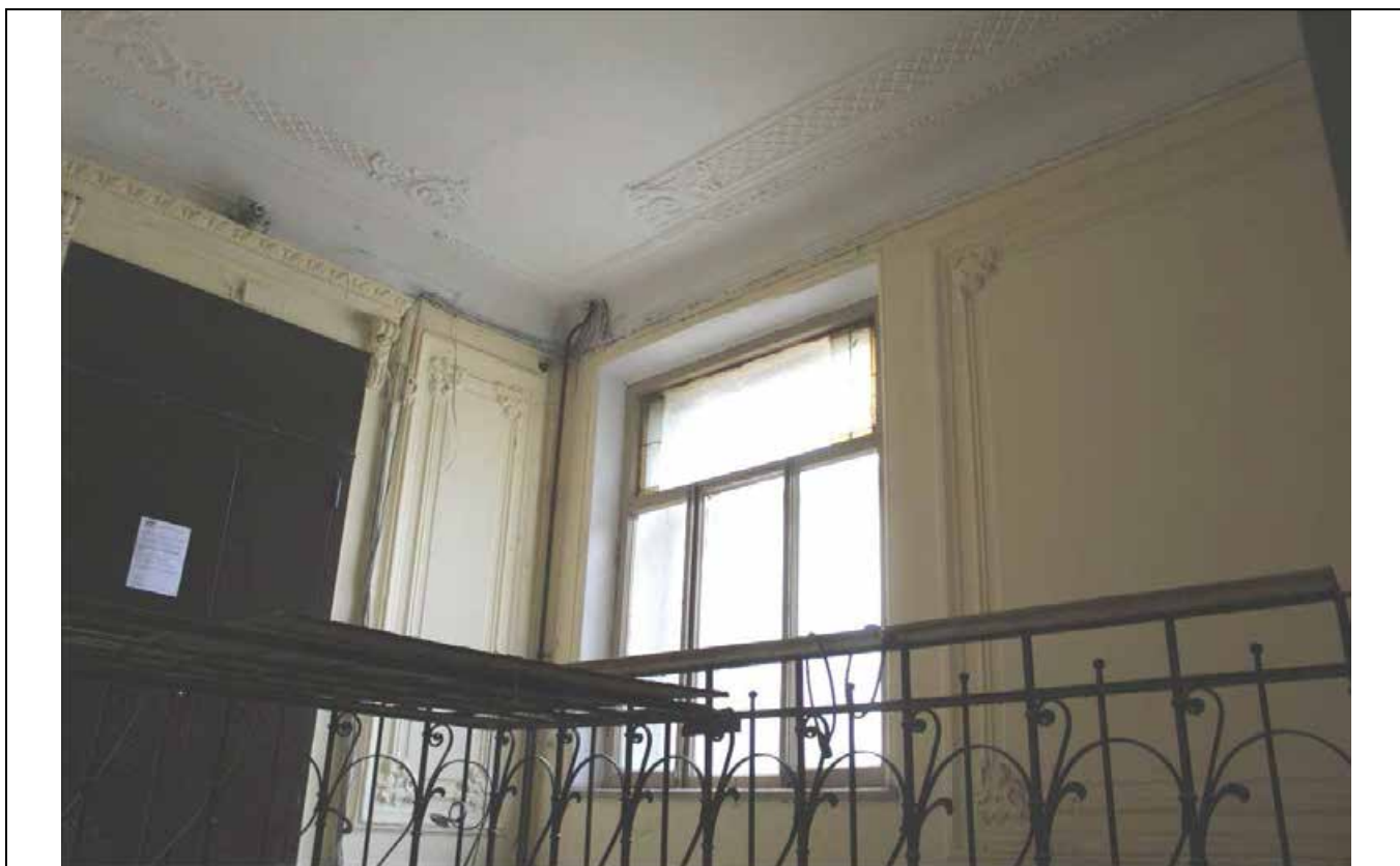
35. Дом В. И. Упатчева. 12 линия, д. 13. Лицевой корпус. Интерьеры. ЛК-2. Фрагмент мансардного этажа. Фото эксперта А. А. Кононова. 19.04.2021.
