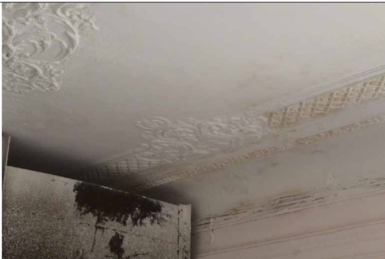
42. Дом В. И. Упатчева. 12 линия, д. 13. Лицевой корпус. Интерьеры. ЛК-1. Плафон мансардного этажа. Фото эксперта А. А. Кононова. 19.04.2021.
