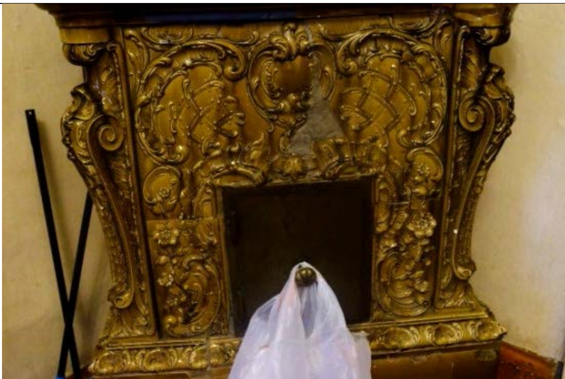
5. Дом В. И. Упатчева. 12 линия, д. 13. Интерьер квартиры № 22 комнаты № 3. Печь. Фрагмент. Фото эксперта А. А. Кононова. 01.06.2021
