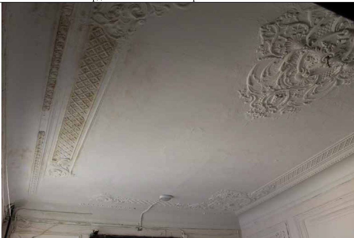
39. Дом В. И. Упатчева. 12 линия, д. 13. Лицевой корпус. Интерьеры. ЛК-1. Плафон мансардного этажа. Фото эксперта А. А. Кононова. 19.04.2021.
