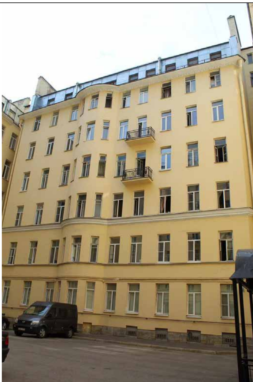
32. Дом В. И. Упатчева. 12 линия, д. 13. Фасад северо-западного дворового корпуса. Фрагмент. Фото эксперта А. А. Кононова. 19.04.2021.
