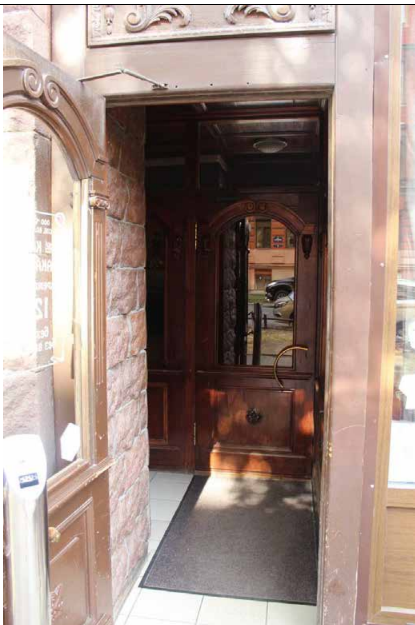
16. Дом В. И. Упатчева. 12 линия, д. 13. Лицевой фасад. Дверное заполнение (южная часть здания) в уровне 1 этажа. Фото эксперта А. А. Кононова. 19.04.2021.
