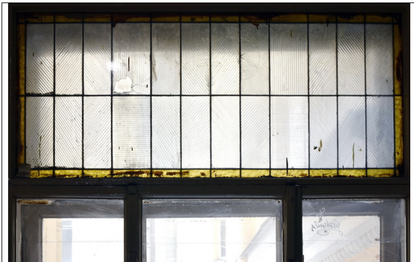
138. Дом В.И. Упатчева. Левая парадная. Фрамуга окна с витражом на площадке 2-3 этажа.
