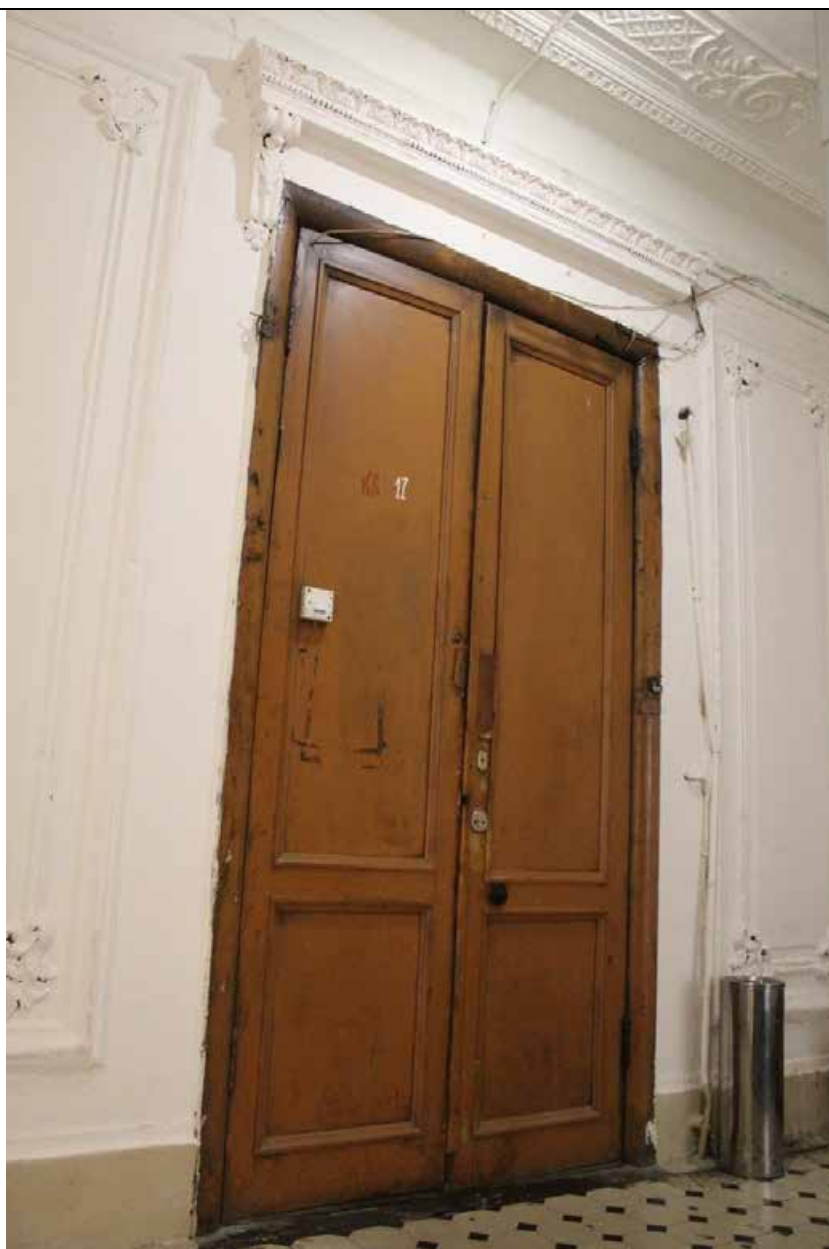
37. Дом В. И. Упатчева. 12 линия, д. 13. Лицевой корпус. Интерьеры. ЛК-1. Дверное заполнение квартиры в мансардном этаже. Фото эксперта А. А. Кононова. 19.04.2021.
