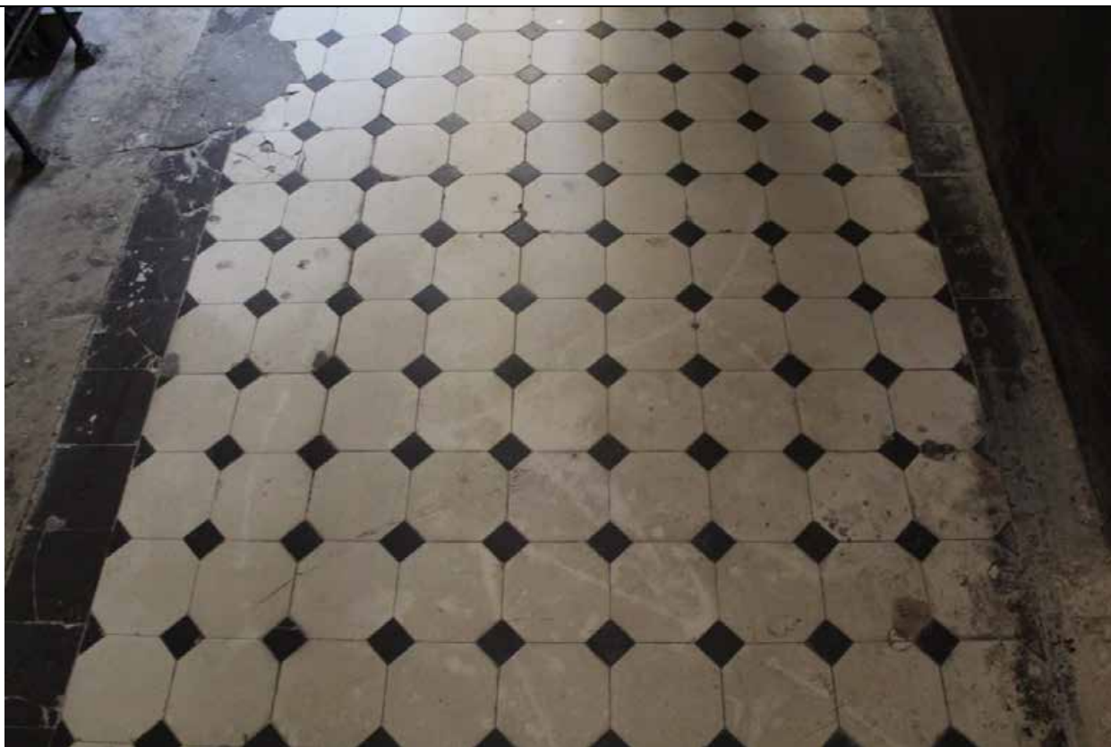
13. Дом В. И. Упатчева. 12 линия, д. 13. Лицевой корпус. Интерьеры. ЛК-1. Фрагмент напольного покрытия площадки между 1 и 2 этажами. Фото эксперта А. А. Кононова. 19.04.2021.
