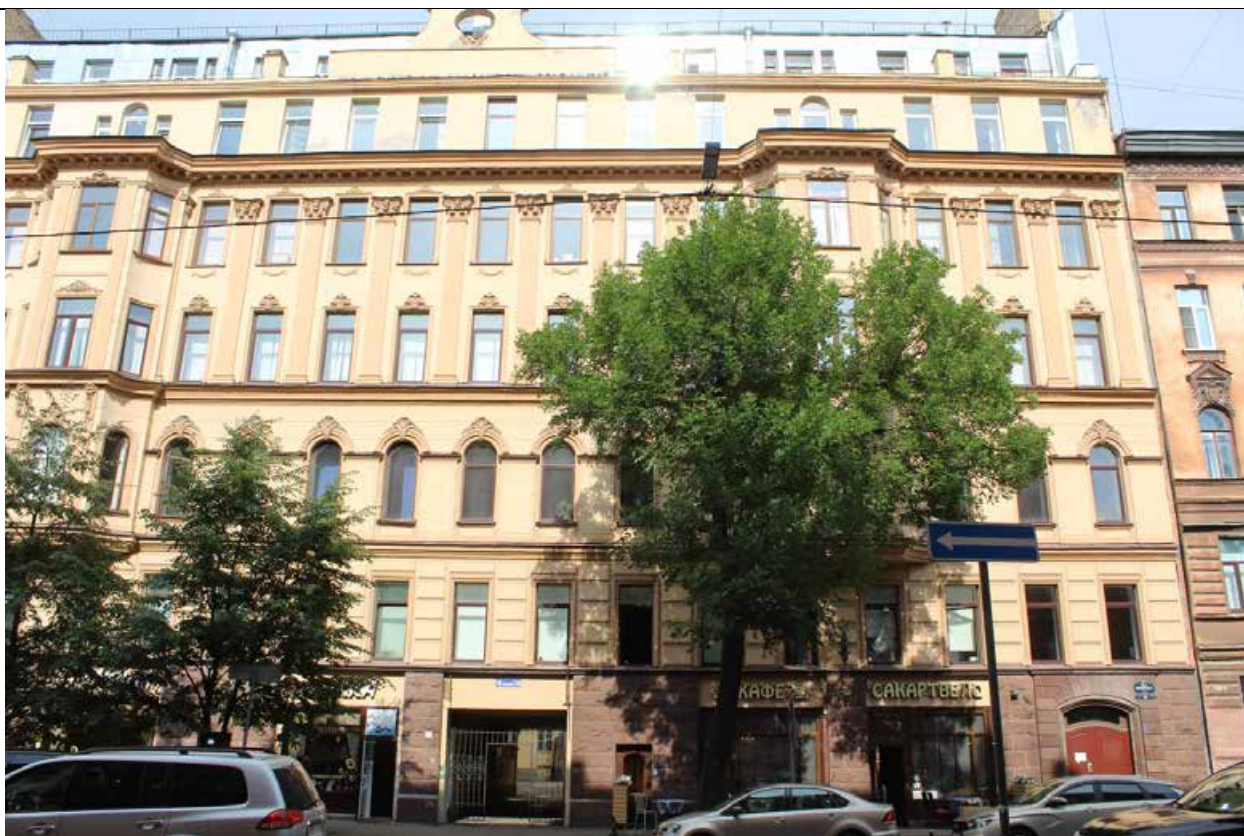
9. Дом В. И. Упатчева. 12 линия, д. 13. Лицевой фасад. Фрагмент, вид с юга. Фото эксперта А. А. Кононова. 01.06.2021.
