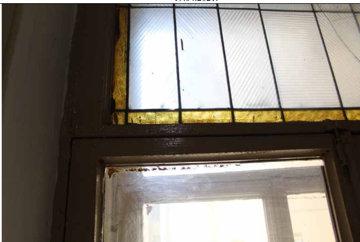
28. Дом В. И. Упатчева. 12 линия, д. 13. Лицевой корпус. Интерьеры. ЛК-2. Оконное заполнение площадки между 5 и 6 этажами. Витраж. Фрагмент. Фото эксперта А. А. Кононова. 19.04.2021.
