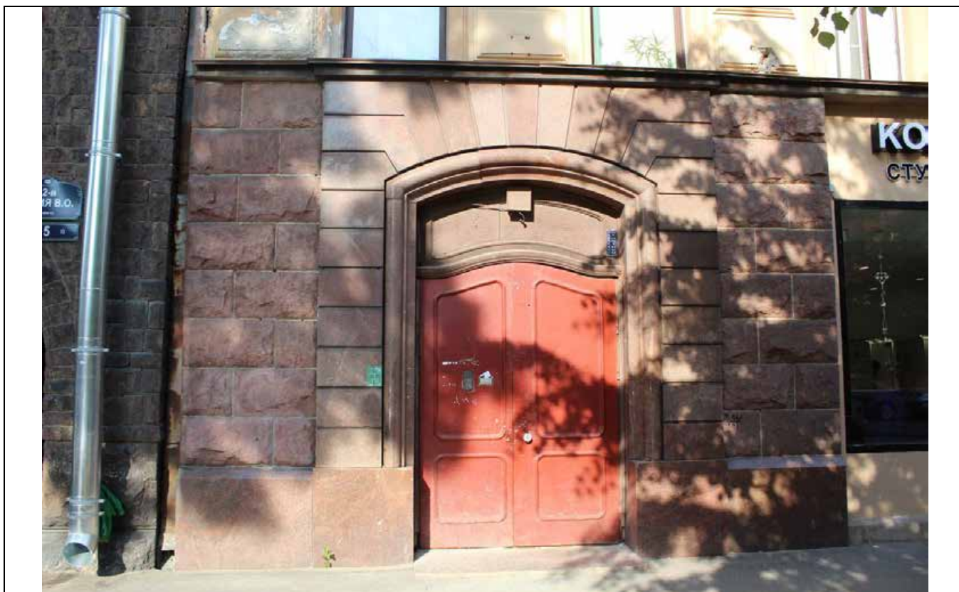
57. Дом В. И. Упатчева. 12 линия, д. 13. Лицевой фасад. Дверной проем в северной части здания. Вид с запада. Фото эксперта А. А. Кононова. 19.04.2021.
