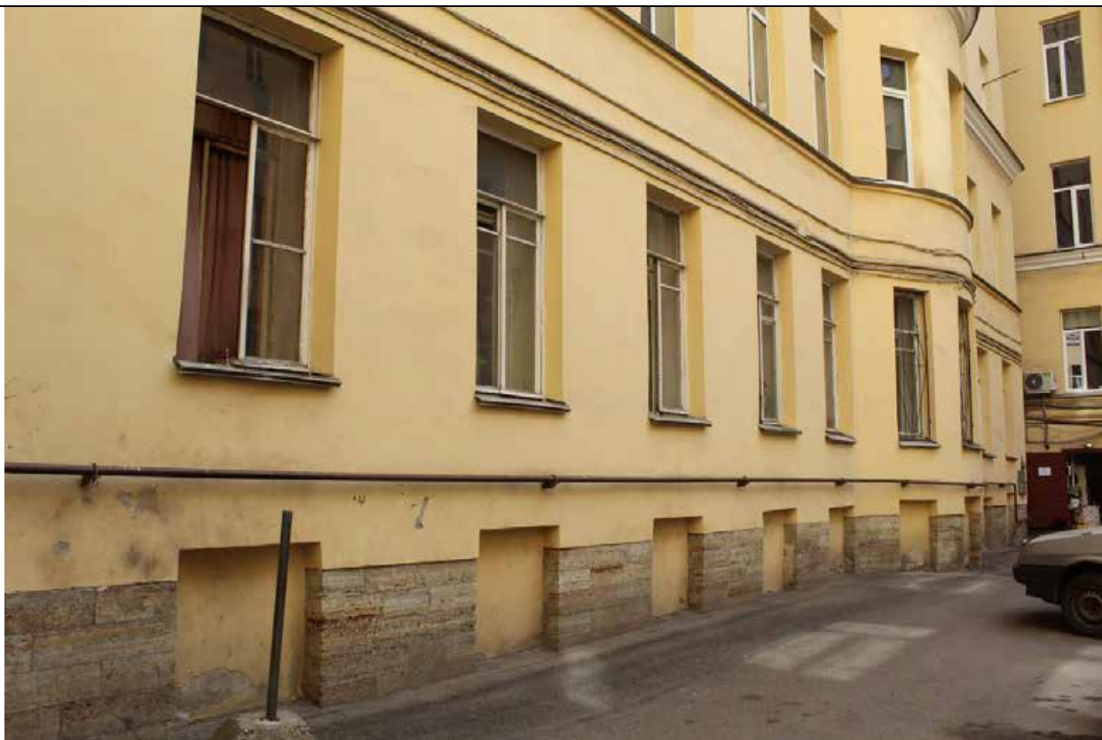
27. Дом В. И. Упатчева. 12 линия, д. 13. Фасад юго-восточного дворового корпуса. Фрагмент. Фото эксперта А. А. Кононова. 19.04.2021.
