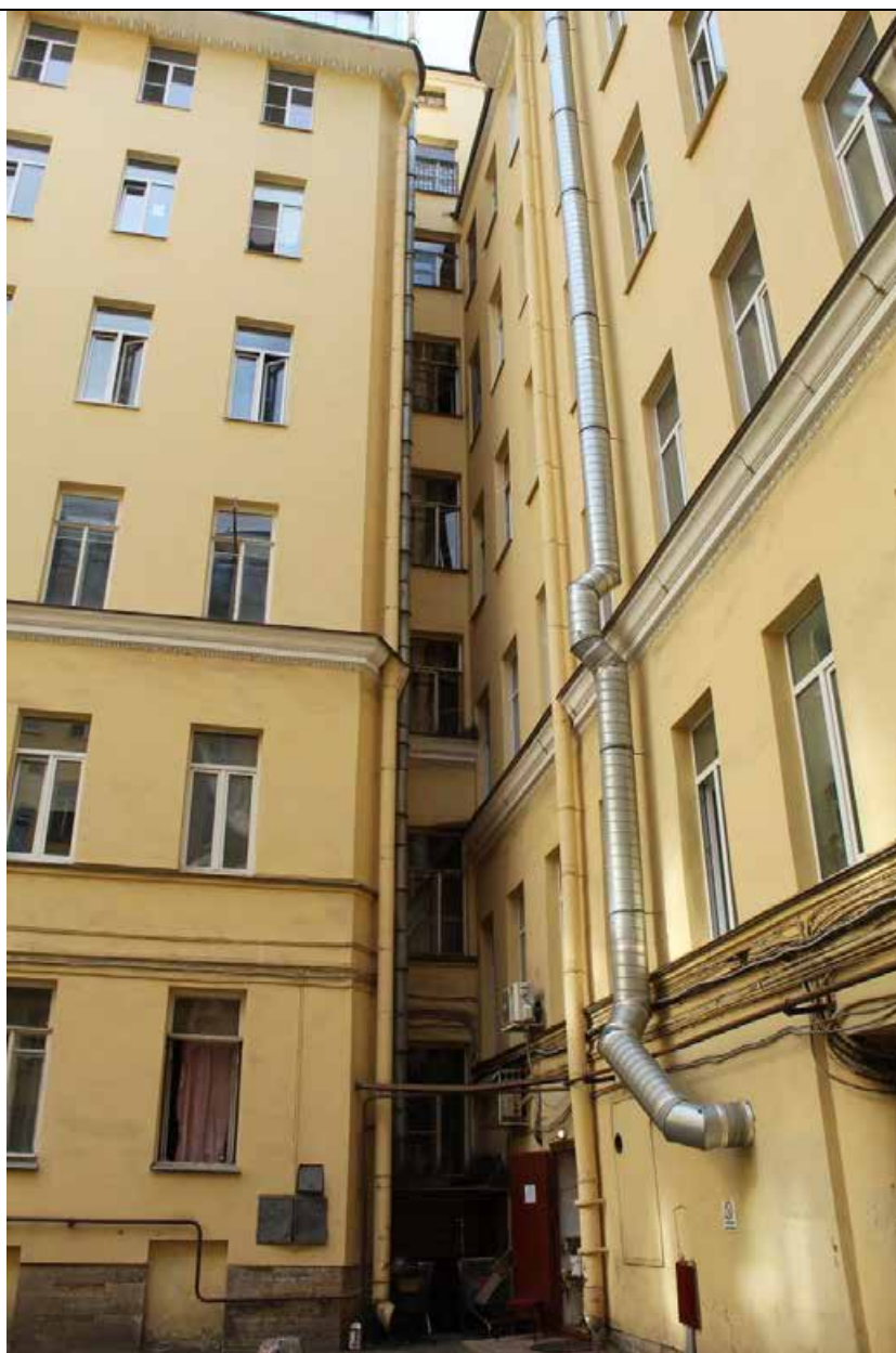
43. Дом В. И. Упатчева. 12 линия, д. 13. Фасад юго-восточного дворового корпуса. Фрагмент. Фото эксперта А. А. Кононова. 19.04.2021.
