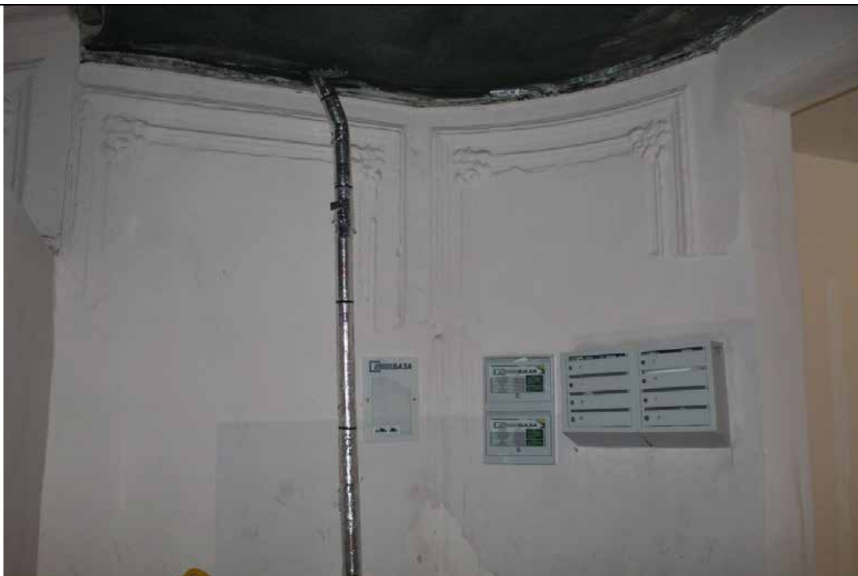
5. Дом В. И. Упатчева. 12 линия, д. 13. Лицевой корпус. Интерьеры. ЛК-1. Вестибюль. Фрагмент оформления стен. Фото эксперта А. А. Кононова. 19.04.2021.
