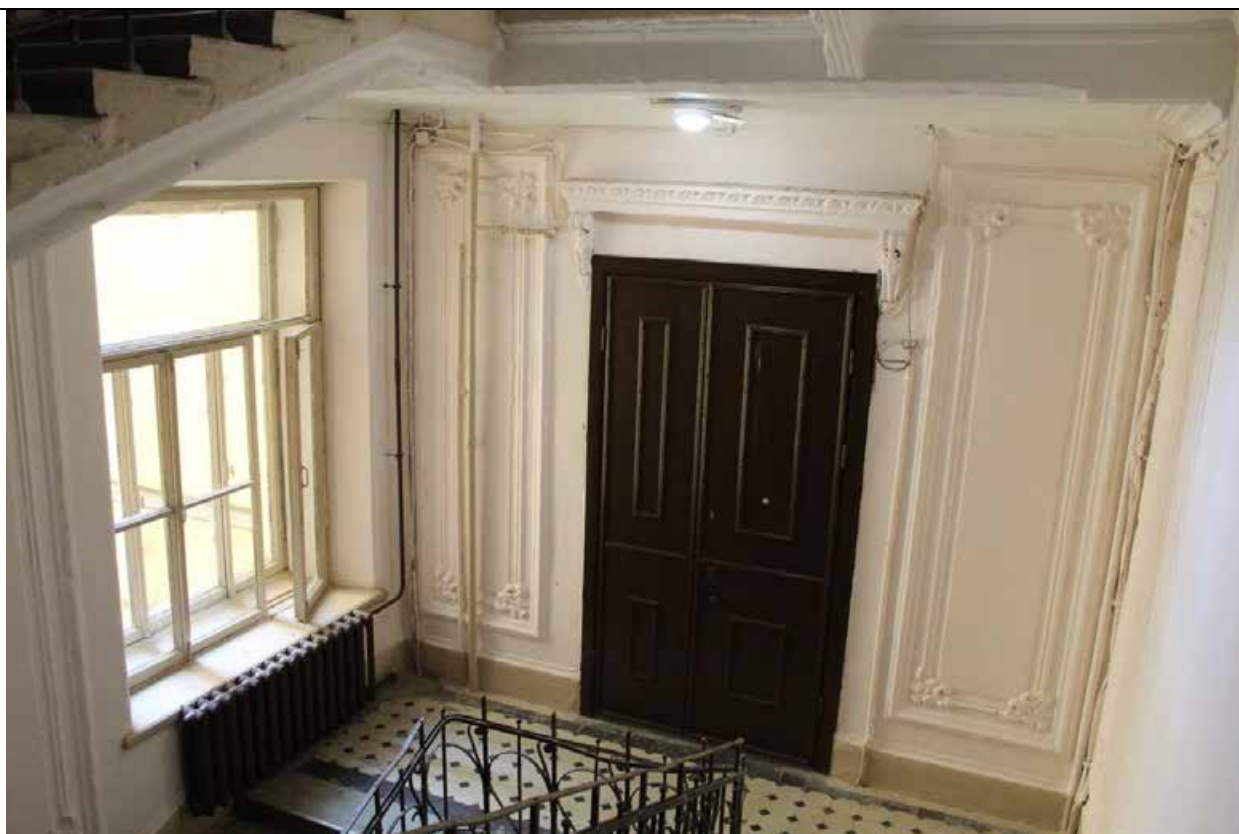
20. Дом В. И. Упатчева. 12 линия, д. 13. Лицевой корпус. Интерьеры. ЛК-1. Вид на площадку 2 этажа. Фото эксперта А. А. Кононова. 19.04.2021.
