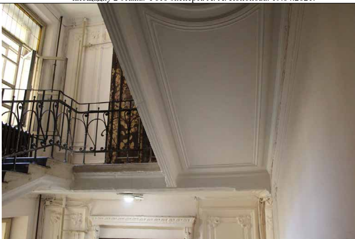
21. Дом В. И. Упатчева. 12 линия, д. 13. Лицевой корпус. Интерьеры. ЛК-1. Вид на площадку 3 этажа. Фото эксперта А. А. Кононова. 19.04.2021.
