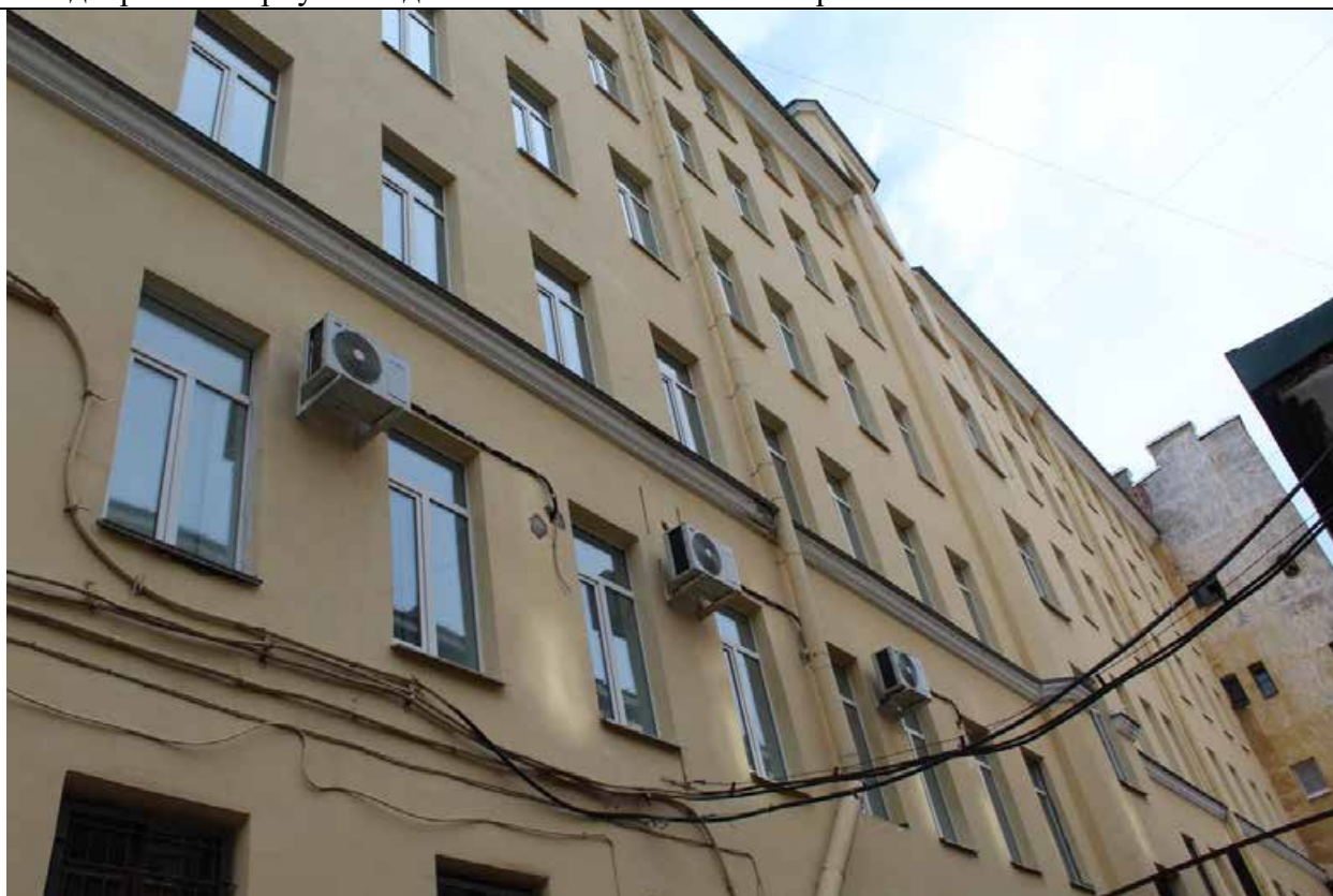
54. Дом В. И. Упатчева. 12 линия, д. 13. Фасад северо-восточного дворового корпуса. Вид с юго-востока. Фрагмент. Фото эксперта А. А. Кононова. 19.04.2021.
