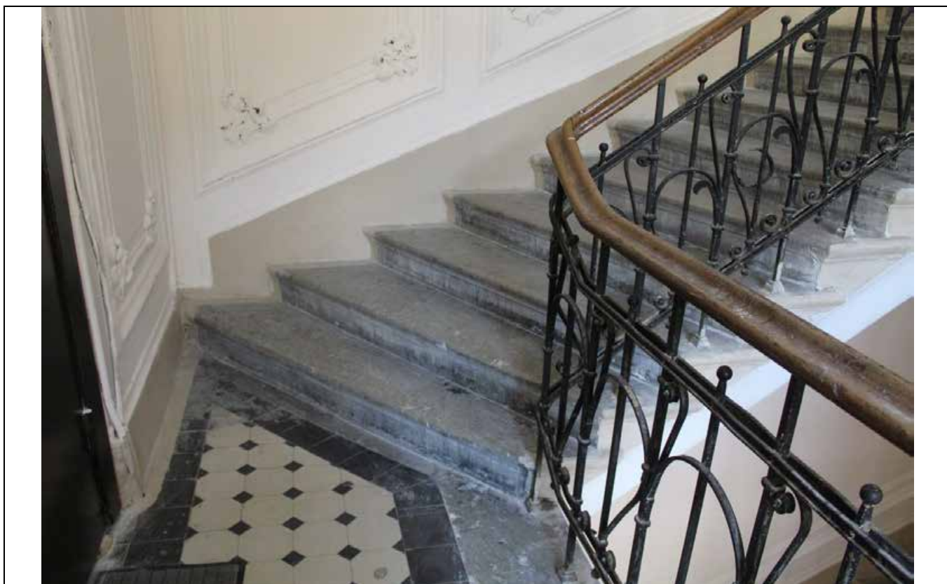
36. Дом В. И. Упатчева. 12 линия, д. 13. Лицевой корпус. Интерьеры. ЛК-1. Лестничный марш с 6 этажа на мансардный этаж. Фото эксперта А. А. Кононова. 19.04.2021.
