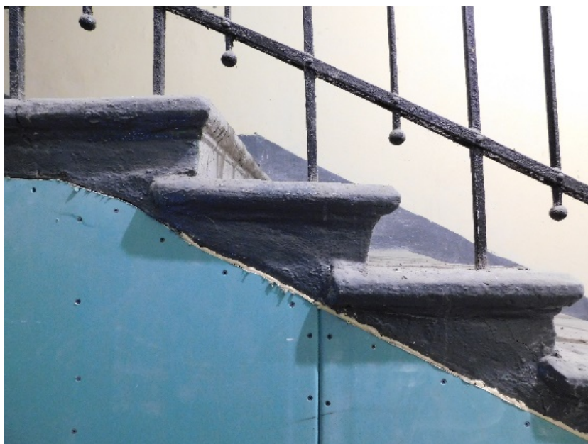
5. Дом В. И. Упатчева. 12 линия, д. 13. Северная межэтажная служебная лестница дворового флигеля. Ступени. Фрагмент. Фото эксперта А. А. Кононова. 01.06.2021.
