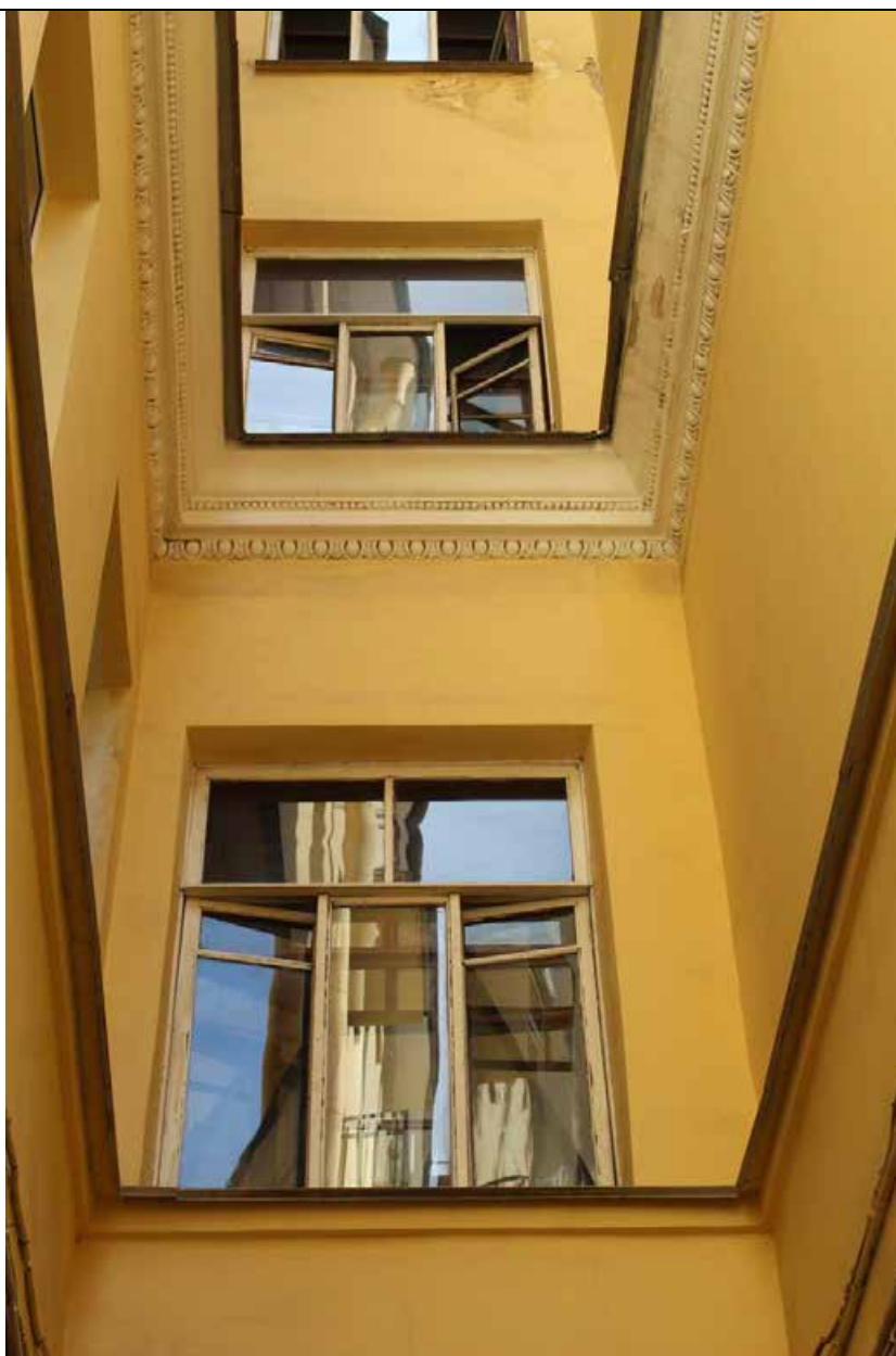
35. Дом В. И. Упатчева. 12 линия, д. 13. Фасад юго-восточного дворового корпуса. Фрагмент. Фото эксперта А. А. Кононова. 19.04.2021.
