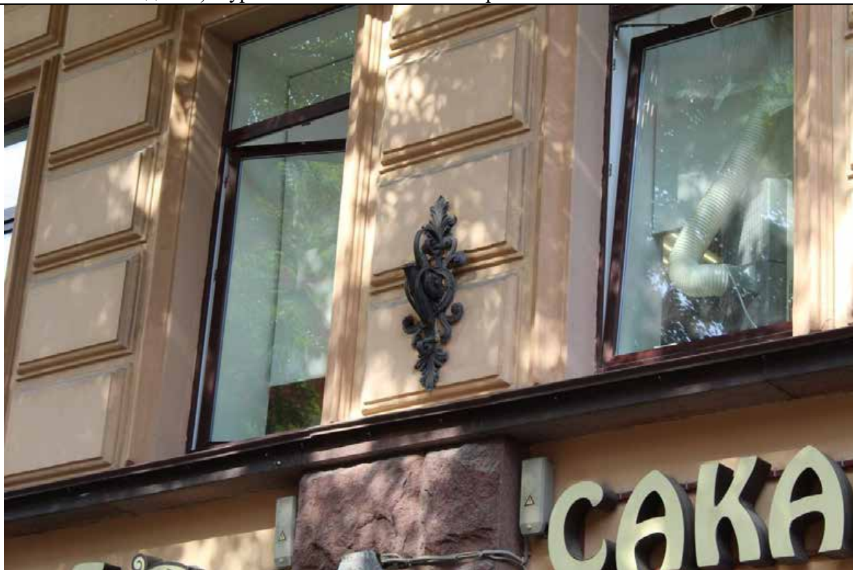
18. Дом В. И. Упатчева. 12 линия, д. 13. Лицевой фасад. Флагодержатель в южной части здания. Фото эксперта А. А. Кононова. 19.04.2021.
