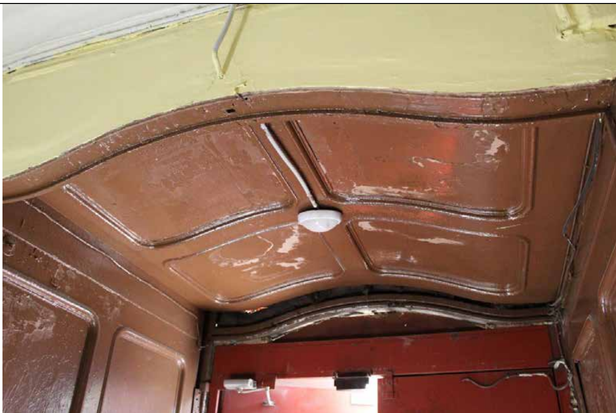
2. Дом В. И. Упатчева. 12 линия, д. 13. Лицевой корпус. Интерьеры. ЛК-2. Входная группа. Плафон. Фото эксперта А. А. Кононова. 19.04.2021.
