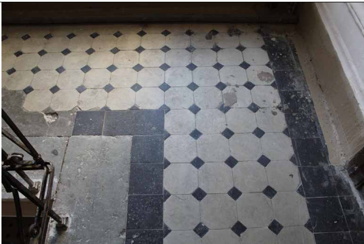
48. Дом В. И. Упатчева. 12 линия, д. 13. Лицевой корпус. Интерьеры. ЛК-1. Напольное покрытие лестничной площадки мансардного этажа. Фото эксперта А. А. Кононова. 19.04.2021.
