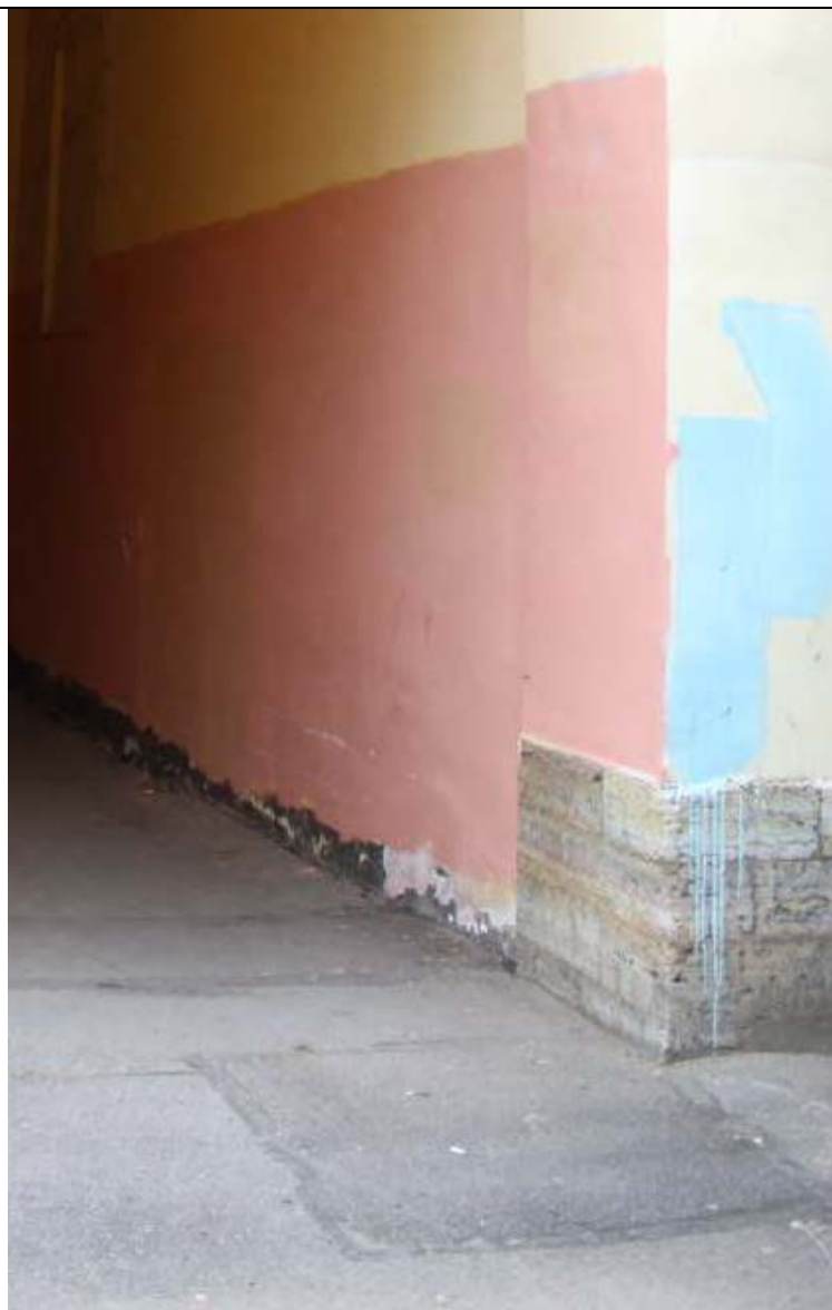
47. Дом В. И. Упатчева. 12 линия, д. 13. Фасад северо-восточного дворового корпуса. Арочный проезд, вид с северо-востока. Цоколь. Фото эксперта А. А. Кононова. 19.04.2021.
