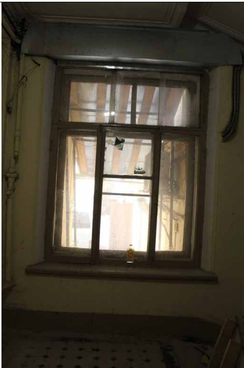
12. Дом В. И. Упатчева. 12 линия, д. 13. Лицевой корпус. Интерьеры. ЛК-2. Площадка между 1 и 2 этажами. Оконный проем. Фото эксперта А. А. Кононова. 19.04.2021.
