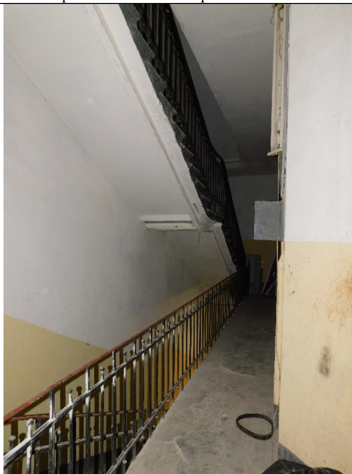
4. Дом В. И. Упатчева. 12 линия, д. 13. Северная межэтажная служебная лестница дворового флигеля. Площадка 2 этажа. Фото эксперта А. А. Кононова. 01.06.2021.
