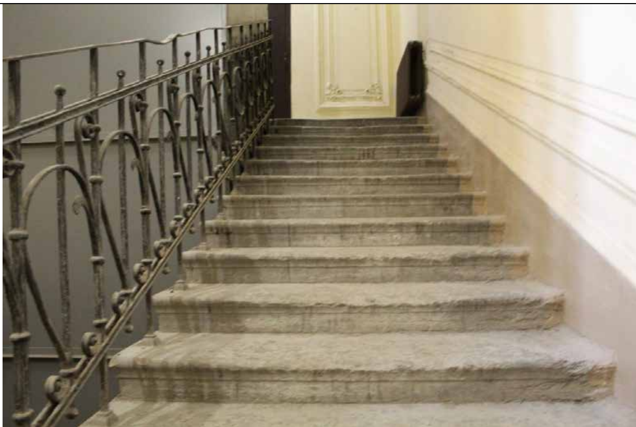
15. Дом В. И. Упатчева. 12 линия, д. 13. Лицевой корпус. Интерьеры. ЛК-2. Ступени из лещадной плиты. Фото эксперта А. А. Кононова. 19.04.2021.
