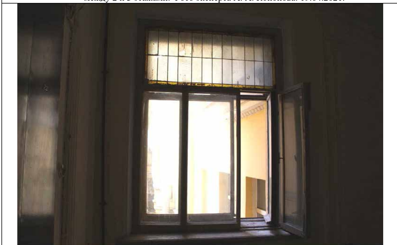
18. Дом В. И. Упатчева. 12 линия, д. 13. Лицевой корпус. Интерьеры. ЛК-2. Площадка между 2 и 3 этажами. Оконное заполнение. Фото эксперта А. А. Кононова. 19.04.2021.
