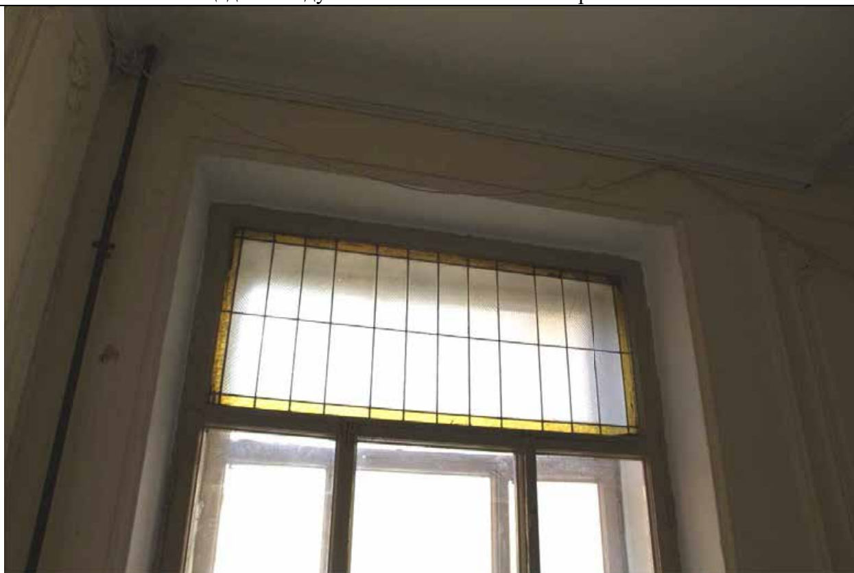
24. Дом В. И. Упатчева. 12 линия, д. 13. Лицевой корпус. Интерьеры. ЛК-2. Оконное заполнение площадки между 4 и 5 этажами. Витраж. Фото эксперта А. А. Кононова. 19.04.2021.
