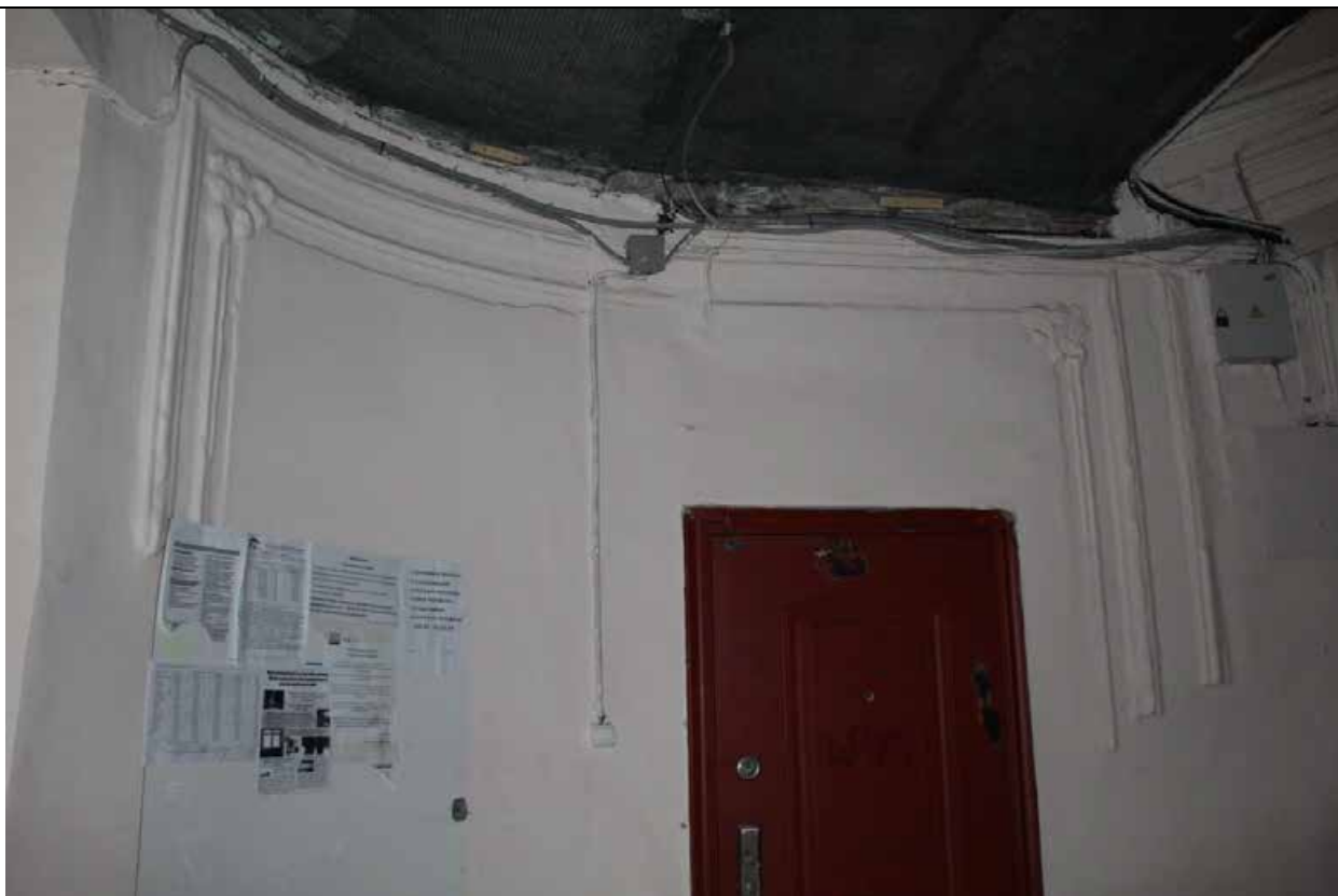
7. Дом В. И. Упатчева. 12 линия, д. 13. Лицевой корпус. Интерьеры. ЛК-1. Вестибюль. Фрагмент оформления стен. Фото эксперта А. А. Кононова. 19.04.2021.
