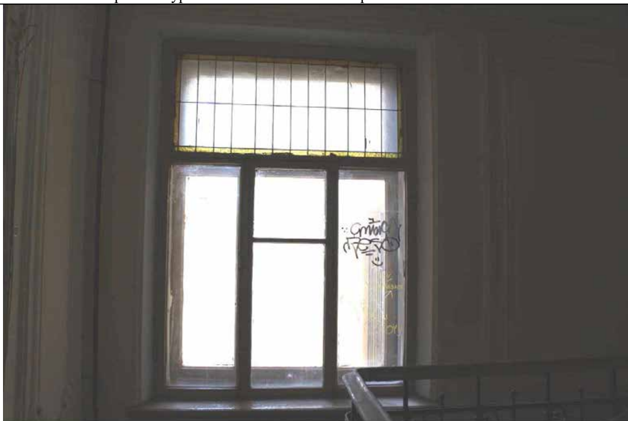
26. Дом В. И. Упатчева. 12 линия, д. 13. Лицевой корпус. Интерьеры. ЛК-2. Оконное заполнение площадки между 5 и 6 этажами. Фото эксперта А. А. Кононова. 19.04.2021.
