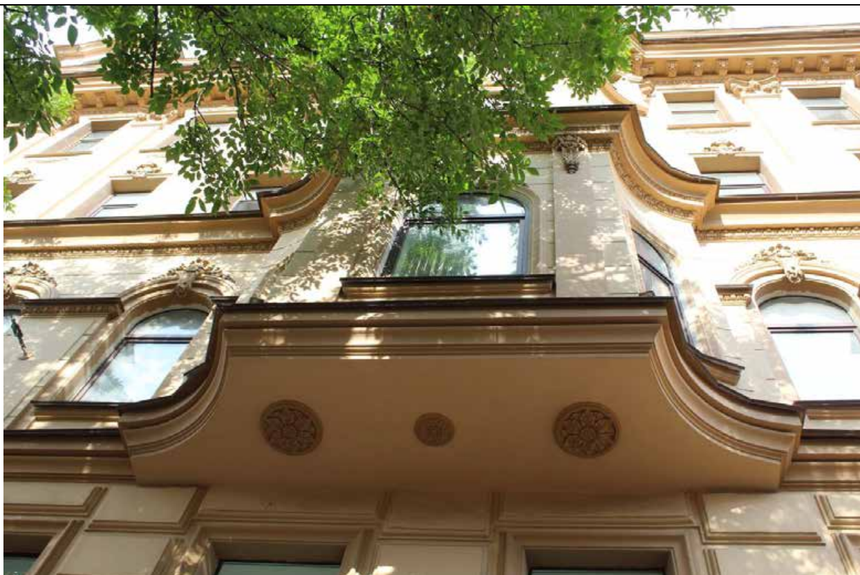
19. Дом В. И. Упатчева. 12 линия, д. 13. Лицевой фасад. Эркер в южной части здания. Вид снизу. Фото эксперта А. А. Кононова. 01.06.2021.
