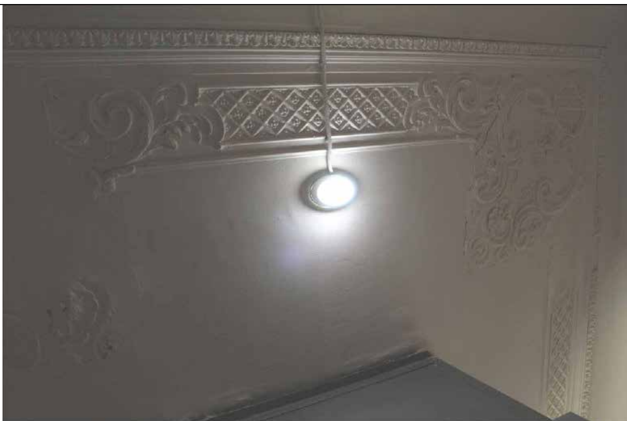
38. Дом В. И. Упатчева. 12 линия, д. 13. Лицевой корпус. Интерьеры. ЛК-1. Плафон мансардного этажа. Фото эксперта А. А. Кононова. 19.04.2021.
