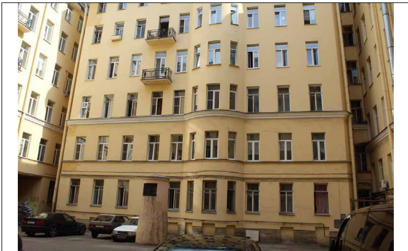
46. Дом В. И. Упатчева. 12 линия, д. 13. Фасад юго-восточного дворового корпуса. Фрагмент. Фото эксперта А. А. Кононова. 19.04.2021.
