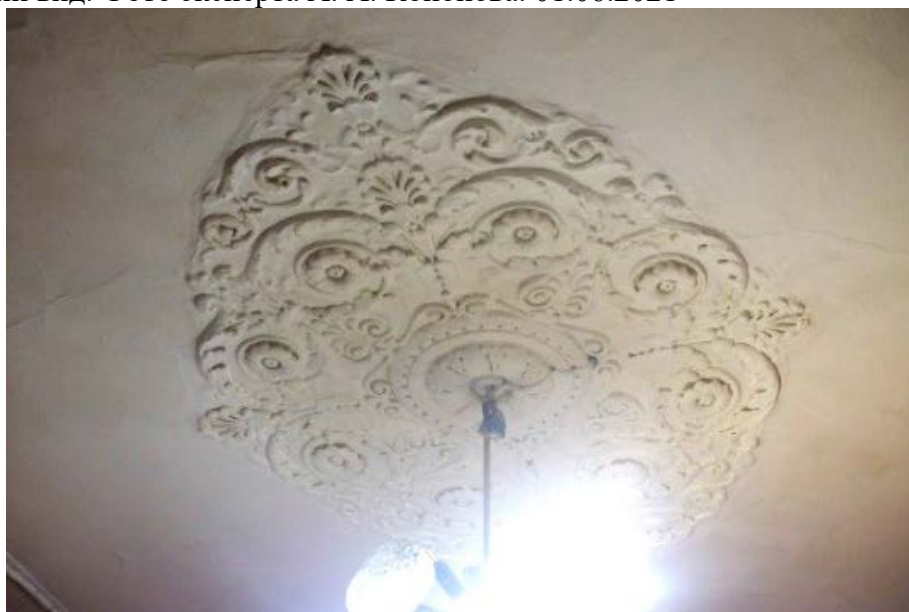
18. Дом В. И. Упатчева. 12 линия, д. 13. Интерьер квартиры № 22 комнаты № 8. Потолочная лепнина. Центральная розетка. Фото эксперта А. А. Кононова. 01.06.2021
