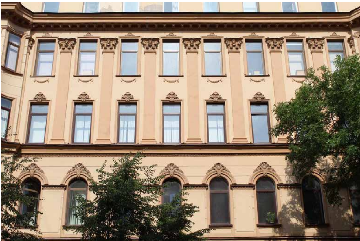
5. Дом В. И. Упатчева. 12 линия, д. 13. Лицевой фасад. Фрагмент плоскости фасада между эркерами. Фото эксперта А. А. Кононова. 01.06.2021.
