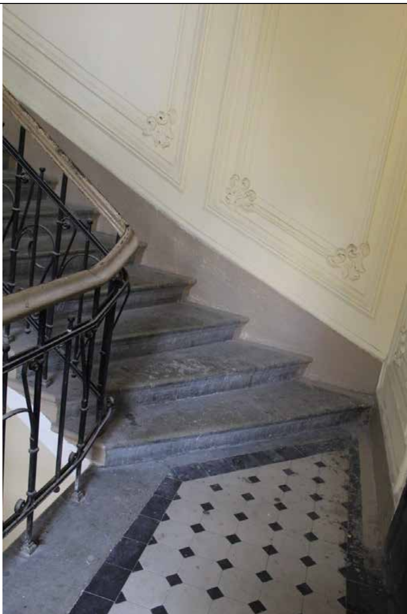
30. Дом В. И. Упатчева. 12 линия, д. 13. Лицевой корпус. Интерьеры. ЛК-2. Площадка 6 этажа и марш на мансардный этаж. Фото эксперта А. А. Кононова. 19.04.2021.
