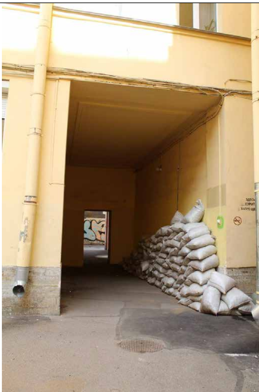
36. Дом В. И. Упатчева. 12 линия, д. 13. Фасад северо-восточного дворового корпуса. Фрагмент. Арочный проезд. Фото эксперта А. А. Кононова. 19.04.2021.
