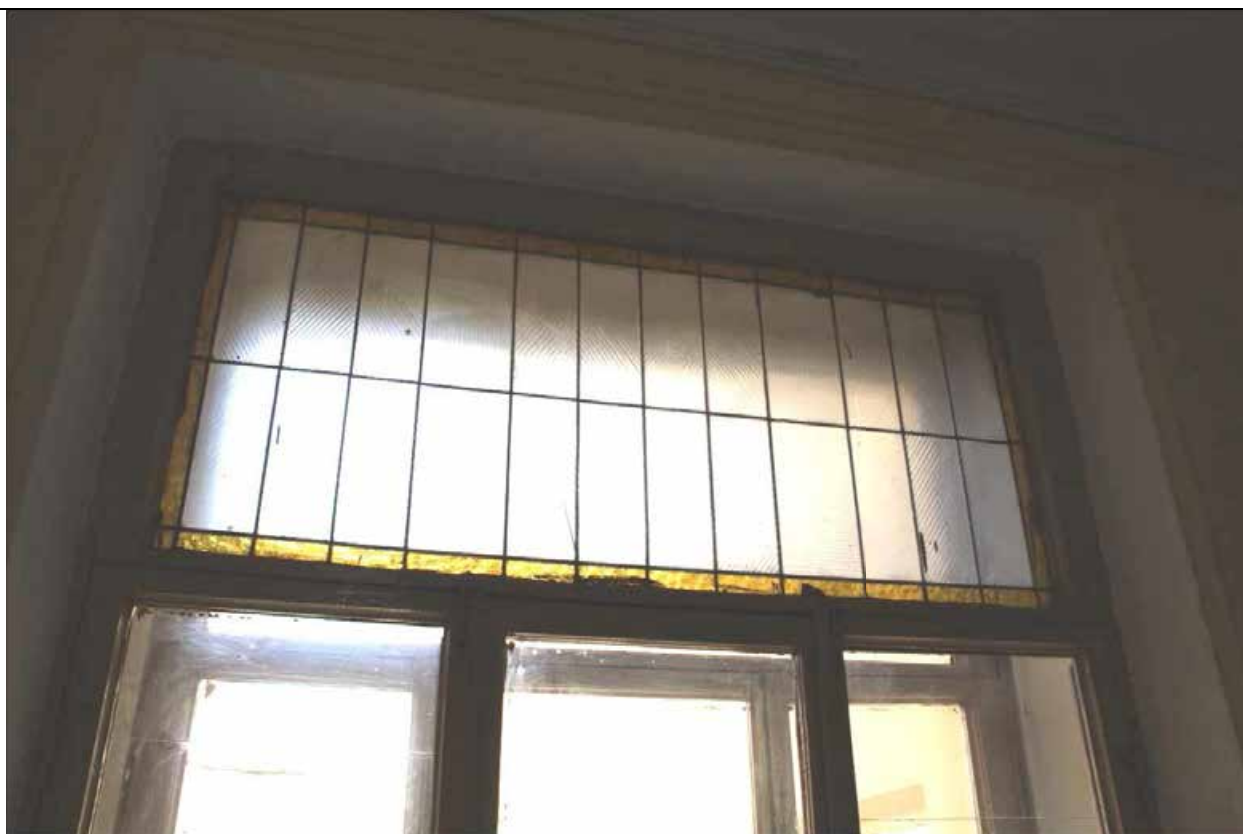
27. Дом В. И. Упатчева. 12 линия, д. 13. Лицевой корпус. Интерьеры. ЛК-2. Оконное заполнение площадки между 5 и 6 этажами. Витраж. Фото эксперта А. А. Кононова. 19.04.2021.
