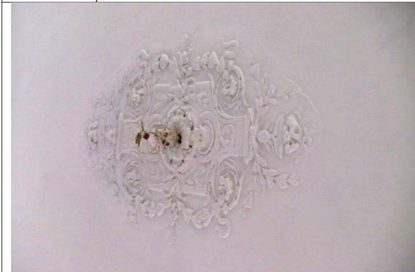
2. Дом В. И. Упатчева. 12 линия, д. 13. Интерьер квартиры № 22 комнаты № 2. Потолочная лепнина. Центральная розетка. Фото эксперта А. А. Кононова. 01.06.2021
