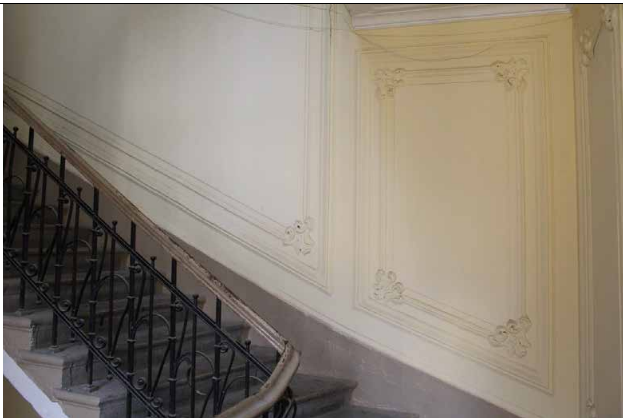
31. Дом В. И. Упатчева. 12 линия, д. 13. Лицевой корпус. Интерьеры. ЛК-2. Декор стены лестницы между 6 и мансардным этажом. Фото эксперта А. А. Кононова. 19.04.2021.
