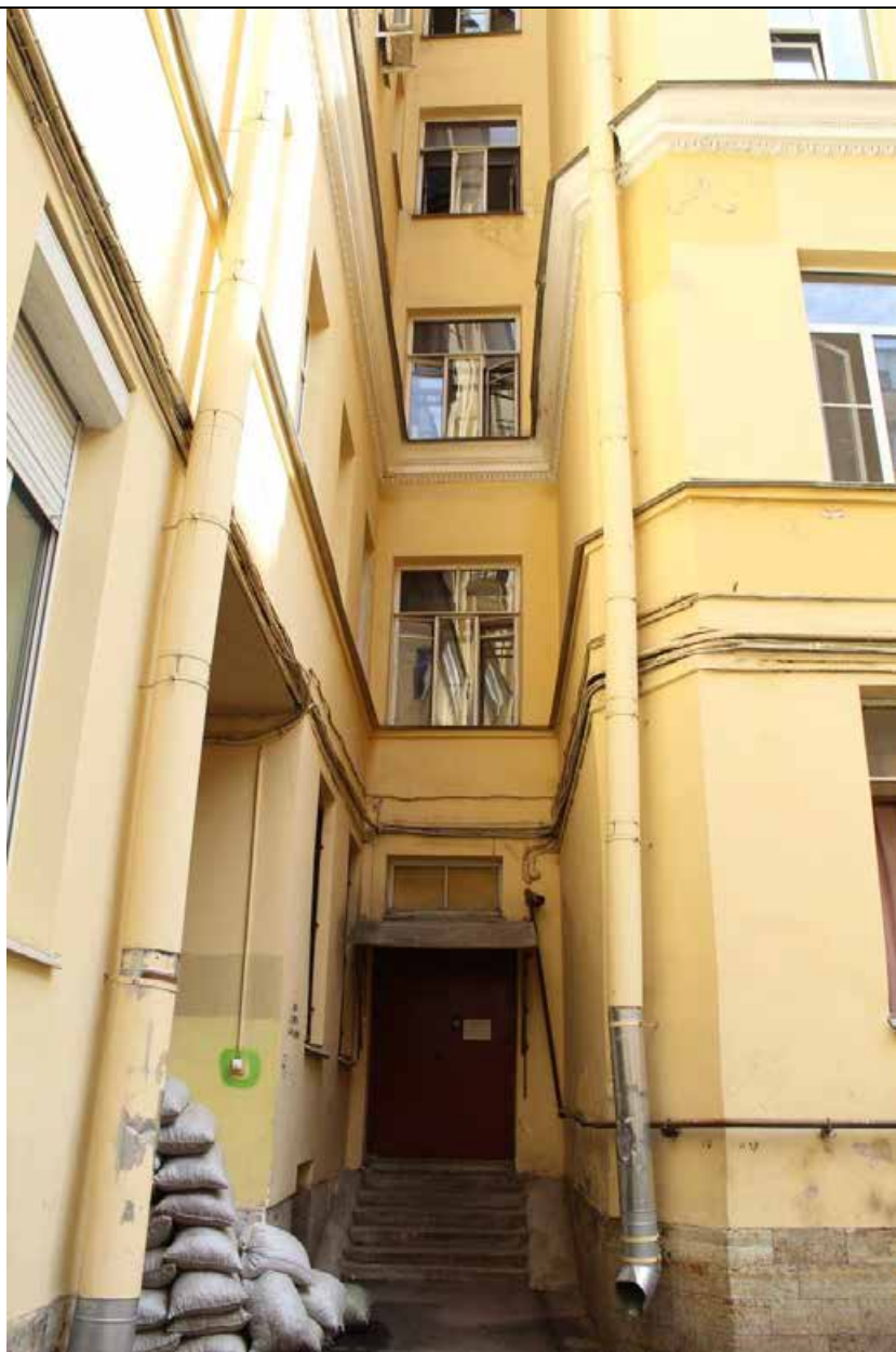
29. Дом В. И. Упатчева. 12 линия, д. 13. Фасад юго-восточного дворового корпуса. Фрагмент. Фото эксперта А. А. Кононова. 19.04.2021.
