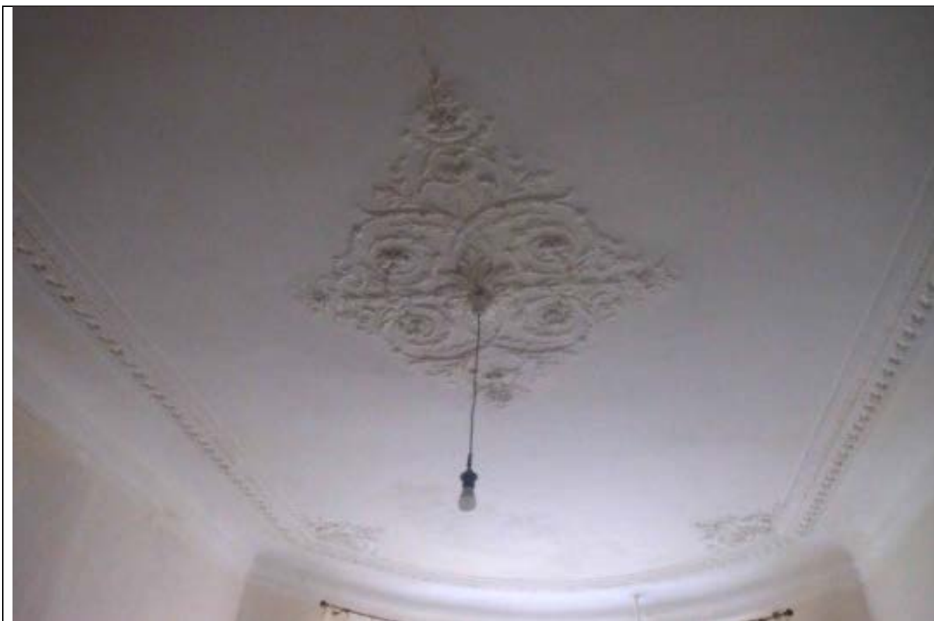
13. Дом В. И. Упатчева. 12 линия, д. 13. Интерьер квартиры № 22 комнаты № 5. Потолочная лепнина. Центральная розетка. Фото эксперта А. А. Кононова. 01.06.2021
