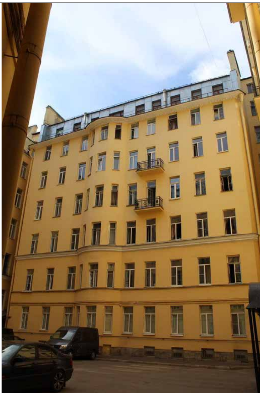
40. Дом В. И. Упатчева. 12 линия, д. 13. Фасад северо-западного дворового корпуса. Фото эксперта А. А. Кононова. 19.04.2021.
