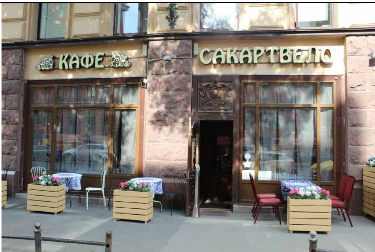
12. Дом В. И. Упатчева. 12 линия, д. 13. Лицевой фасад. Фрагмент (южная часть здания) в уровне 1 этажа. Фото эксперта А. А. Кононова. 19.04.2021.
