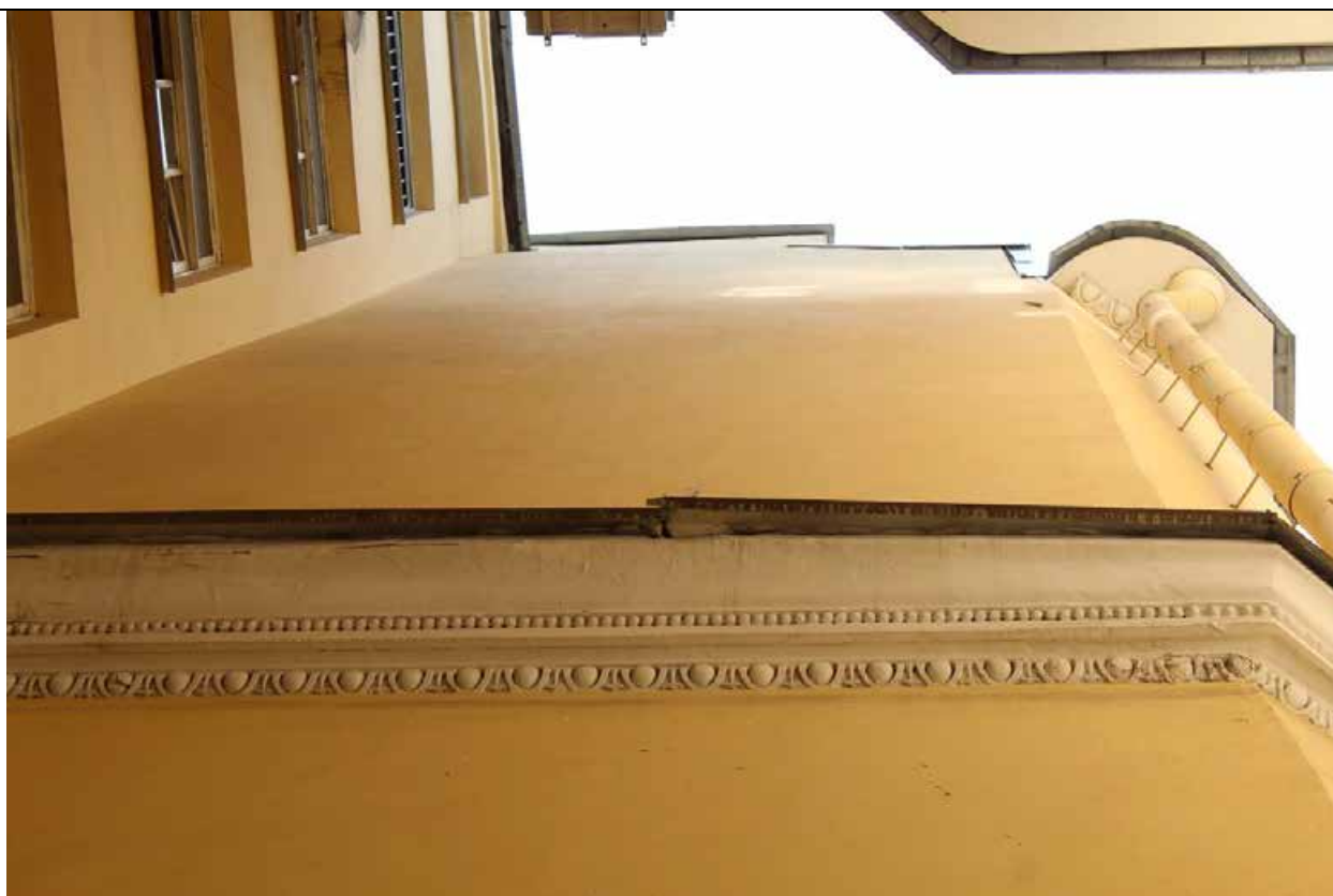
41. Дом В. И. Упатчева. 12 линия, д. 13. Фасад юго-восточного дворового корпуса. Фрагмент. Фото эксперта А. А. Кононова. 19.04.2021.
