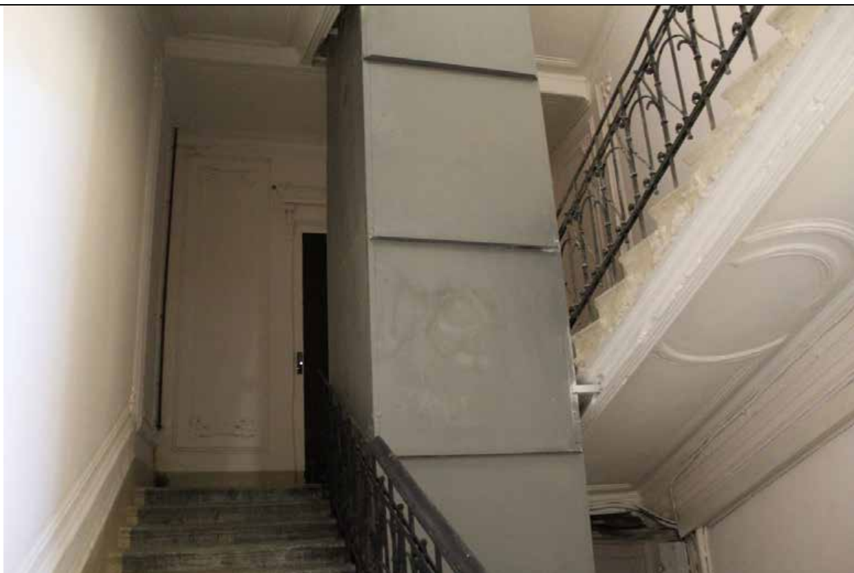
14. Дом В. И. Упатчева. 12 линия, д. 13. Лицевой корпус. Интерьеры. ЛК-1. Фрагмент лестничного марша между 1 и 2 этажами. Фото эксперта А. А. Кононова. 19.04.2021.
