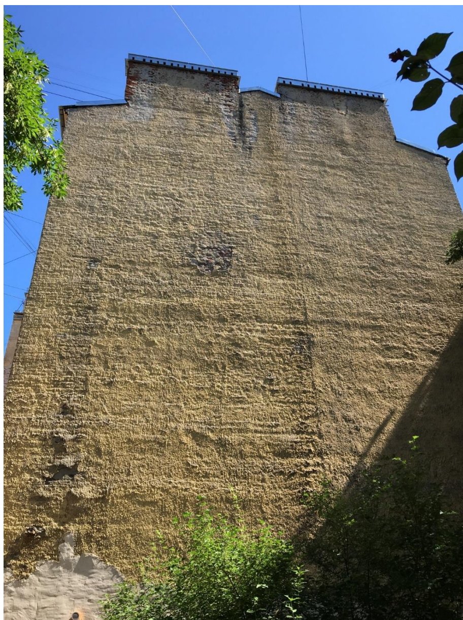
33. Фасады флигеля. Общий вид.
