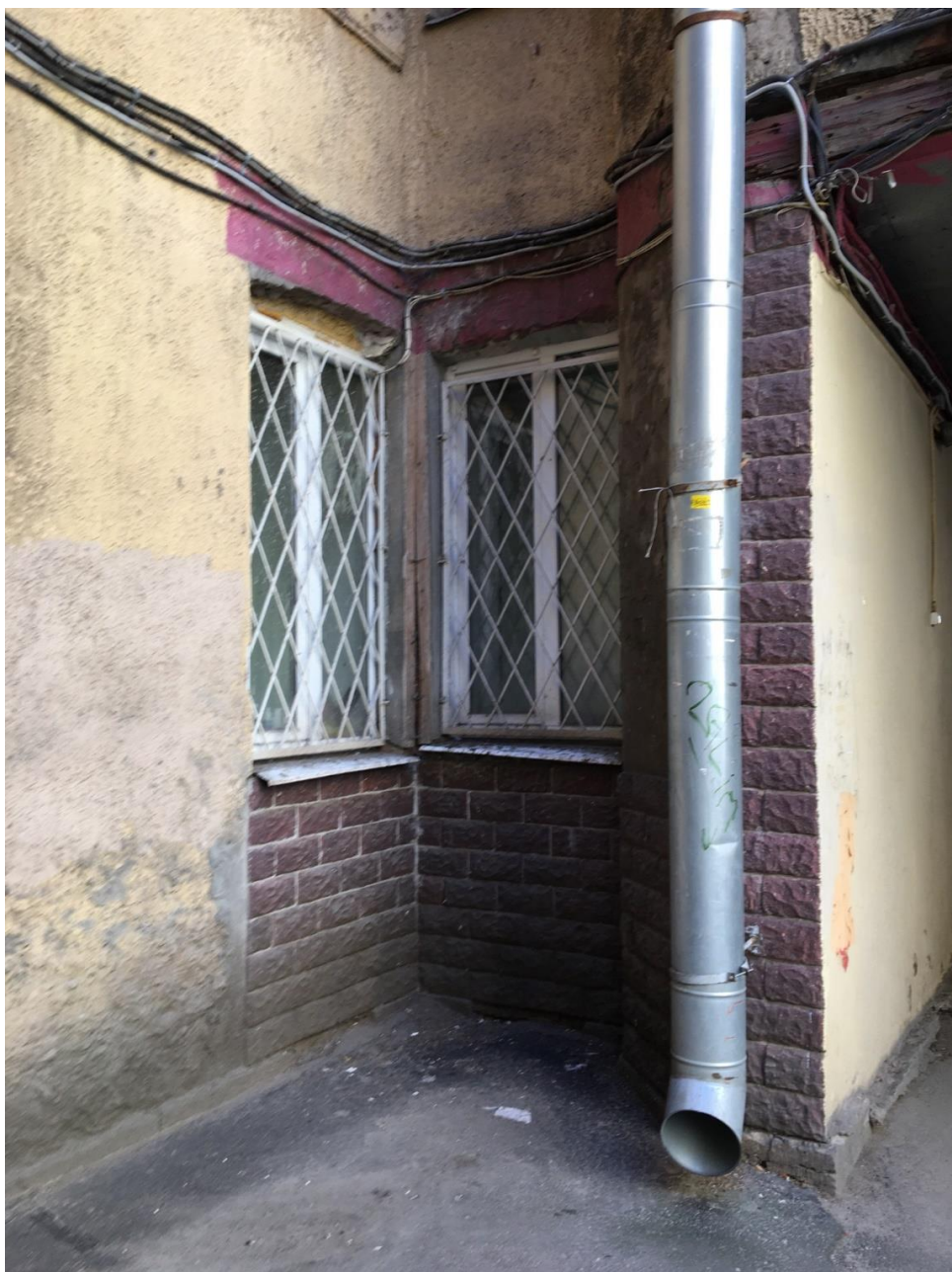
29. Проездная арка в южной части здания (между двором-колодцем и общим двором). 129
