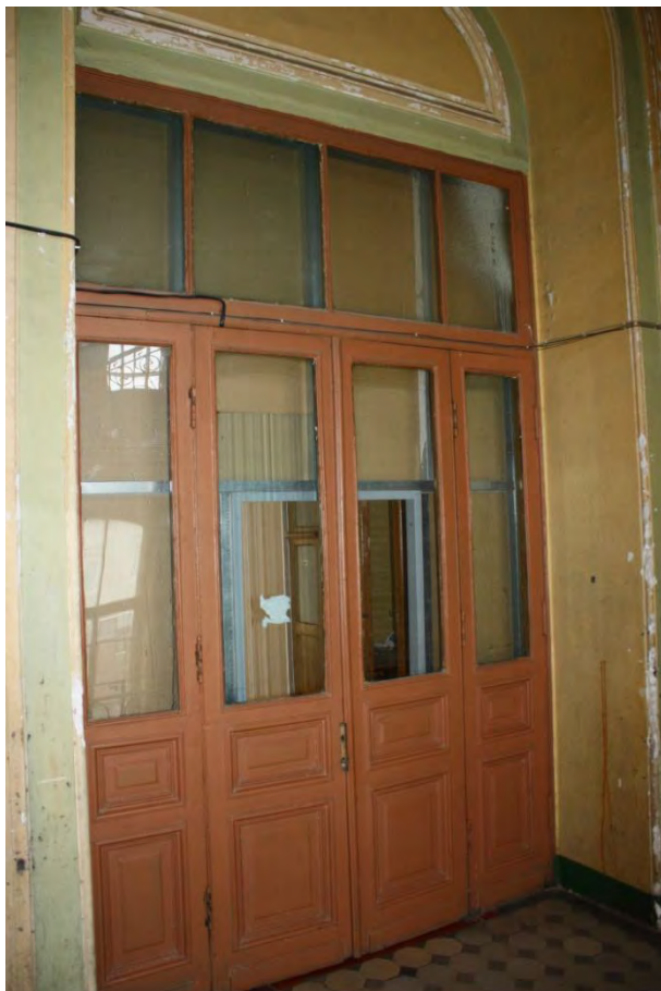
Фото 120. Дверное заполнение во 2 этаже.
