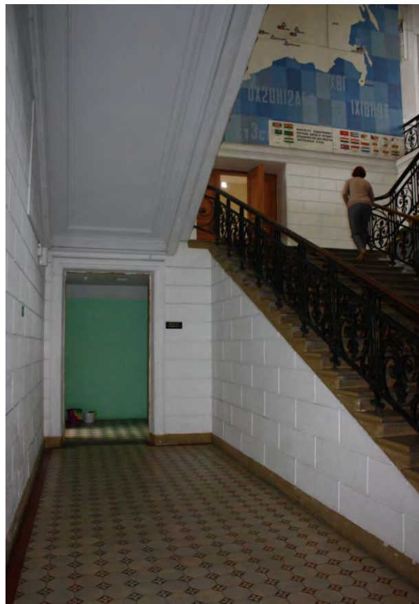
Фото 28. Западная часть первого этажа.
