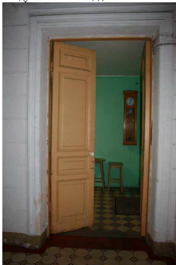
Фото 33. Дверное заполнение в западной части.
