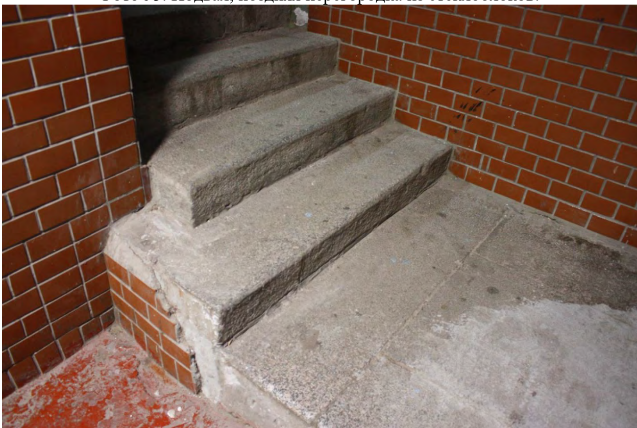
Фото 96. Начало лестницы, вид из подвала.
