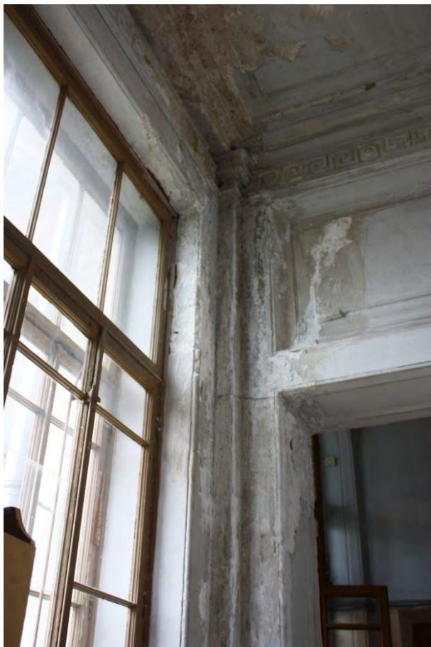
Фото 53. Примыкание лестничного объема к корпусу, фрагмент перекрытия.
