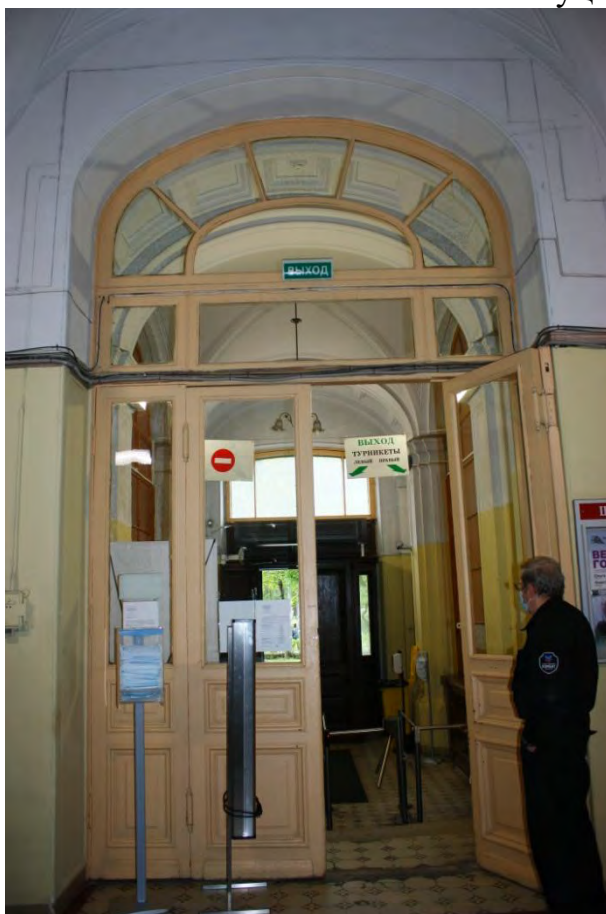
Фото 22. Дверное заполнение в вестибюль.
