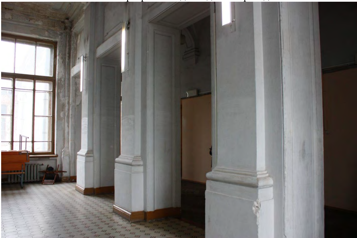
Фото 48. Проемы в коридор второго этажа.
