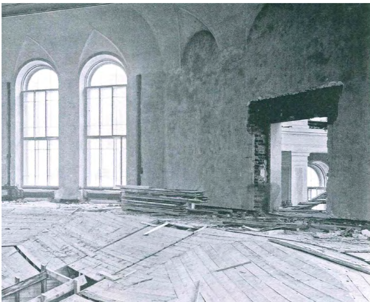
Илл. 12. Строительство амфитеатра большой аудитории. Фрагмент. Фото Н.А.Меншуткина. 8 августа 1902 г.
