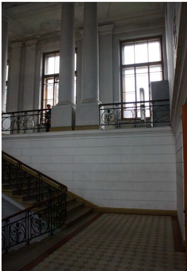
Фото 39. Западная часть междуэтажной площадки.
