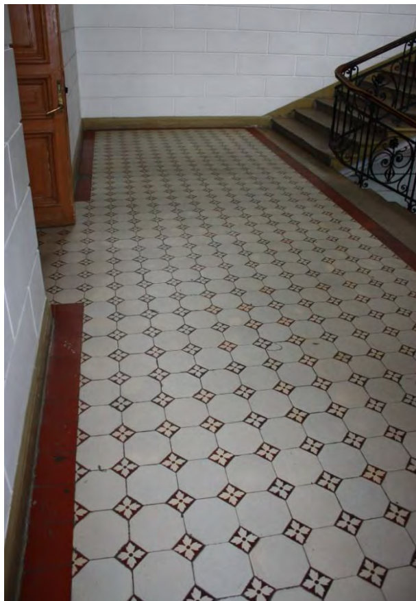
Фото 40. Покрытие полы междуэтажной площадки.
