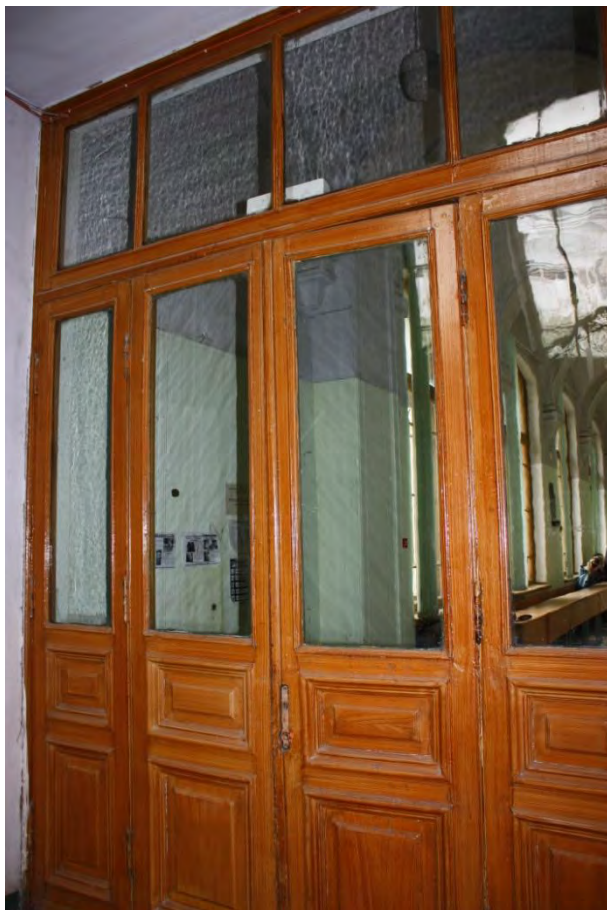
Фото 84. Дверное заполнение в коридор первого этажа.
