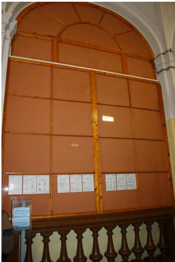
Фото 18. Оконное заполнение в вестибюле.
