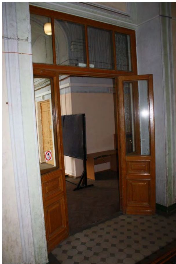
Фото 70. Дверное заполнение в коридор 2 этажа.
