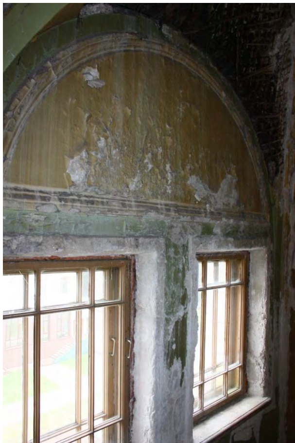
Фото 124. Оконные проемы в предчердачной части.
