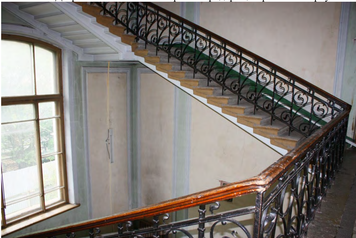
Фото 73. Вид лестниц в уровне 2 этажа.
