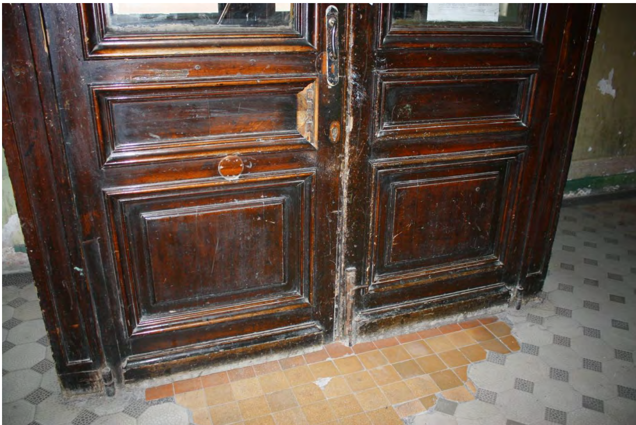
Фото 100. Цокольная зона дверных полотен.
