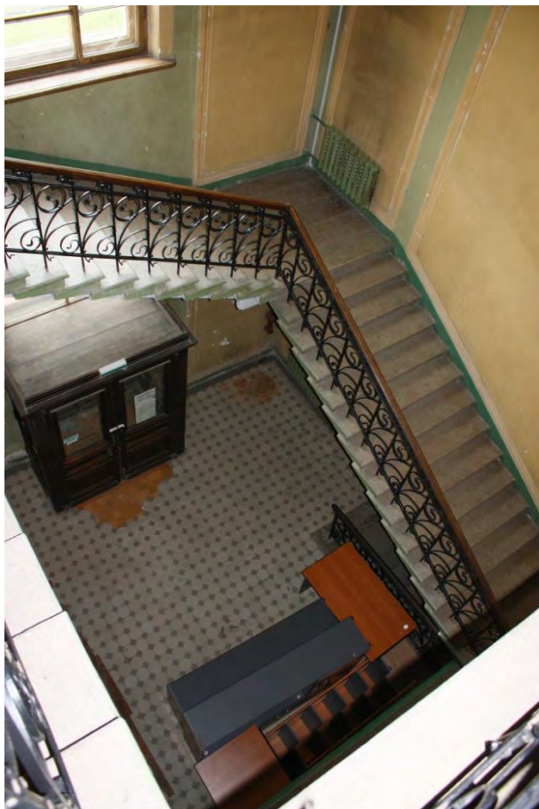
Фото 117. Общий вид на лестницу.
