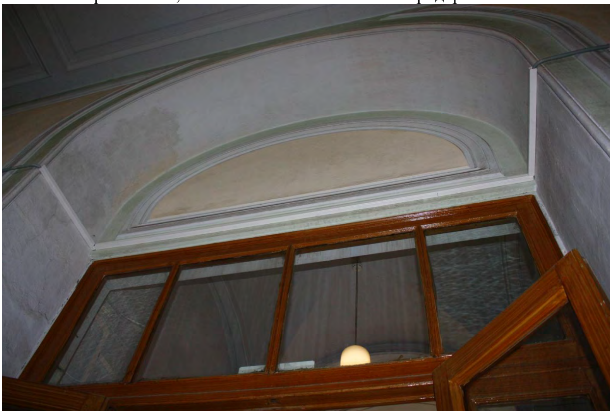
Фото 71. Верхняя фрамуга дверного заполнения.
