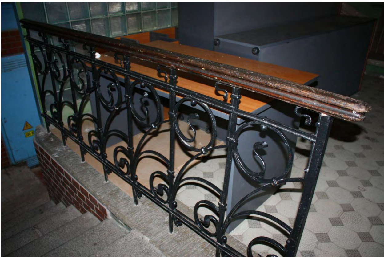
Фото 97. Ограждение лестницы в подвал.
