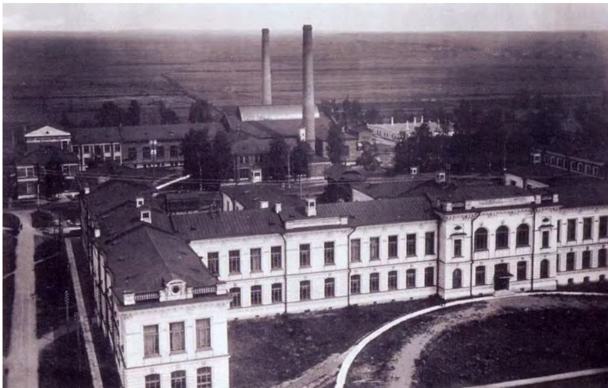
Илл. 21. Химический корпус Политехнического института. 1905-1914 гг. Санкт-Петербургский Политехнический институт в почтовых открытках. СПбГТУ, 2007 г. Электронный портал Pastvu.
