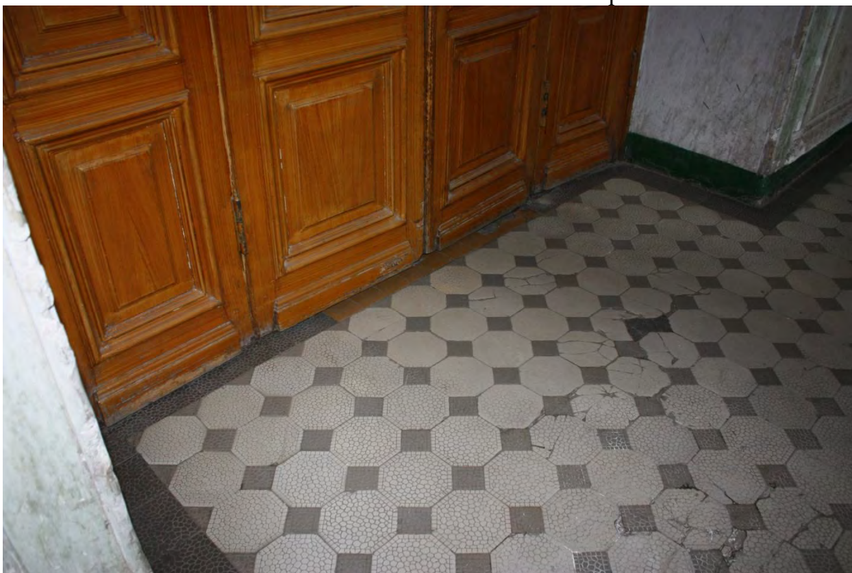
Фото 83. Покрытие пола в уровне первого этажа.
