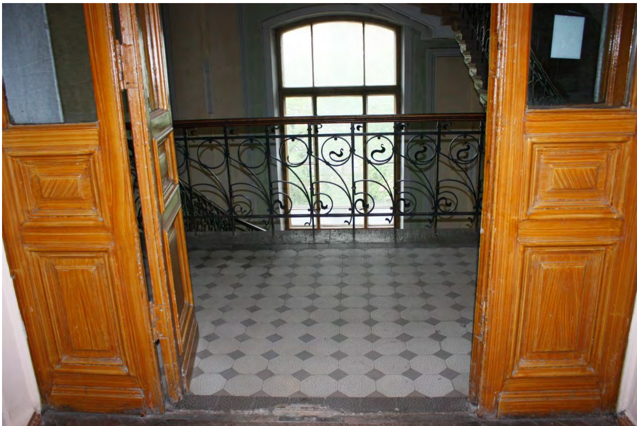
Фото 72. Дверное заполнение со стороны коридора центрального корпуса.
