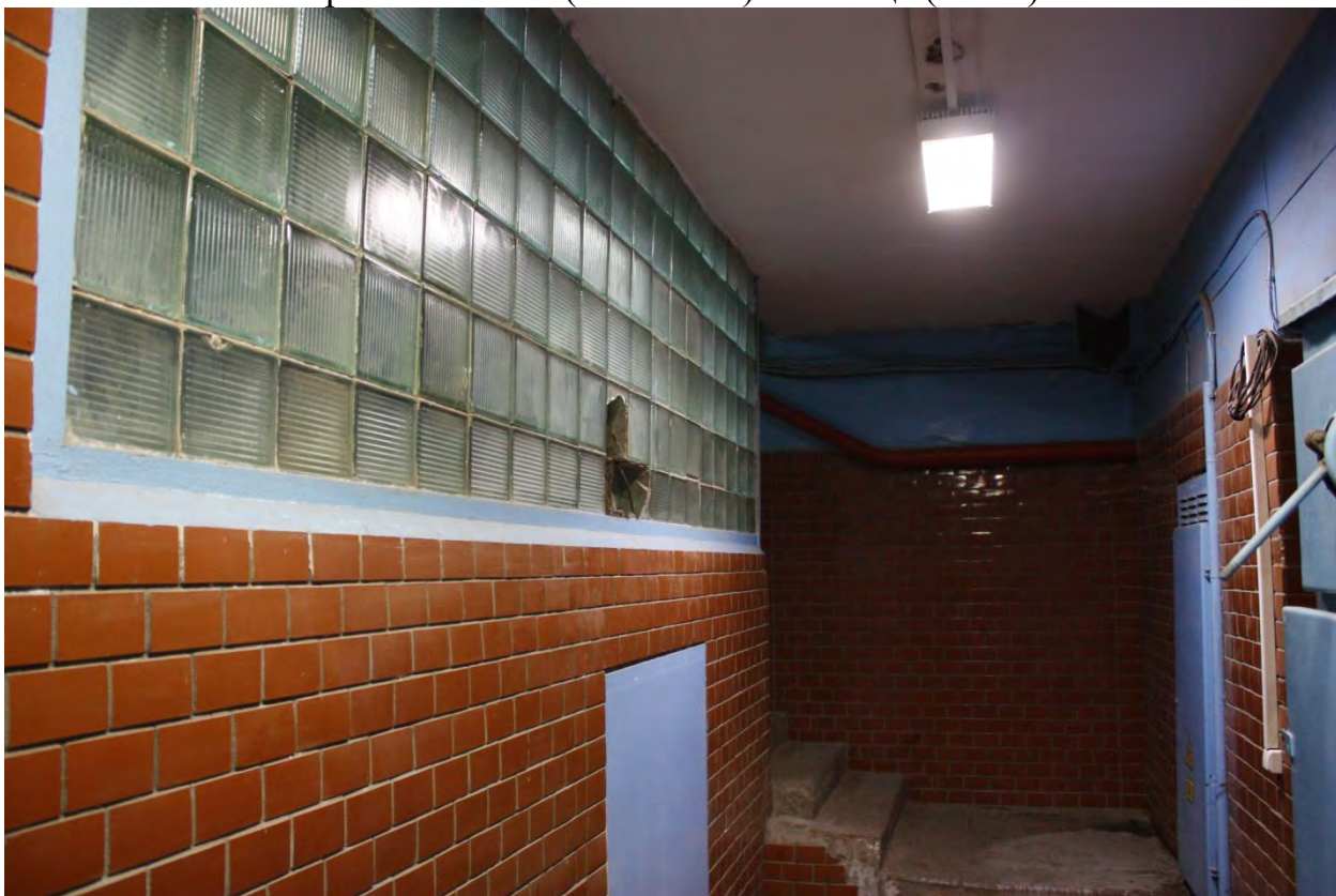
Фото 95. Подвал, поздняя перегородка из стеклоблоков.
