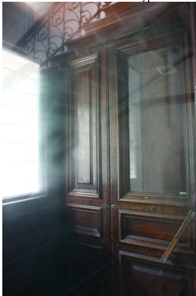
Фото 91. Северная часть тамбура.
