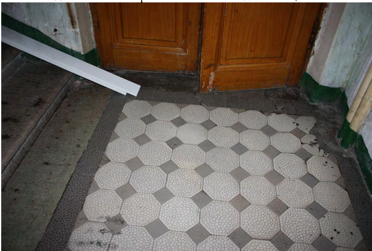
Фото 68. Покрытие пола 2 этажа.
