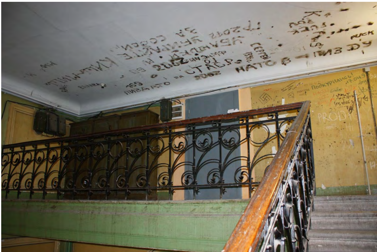
Фото 126. Общий вид на чердачный уровень.
