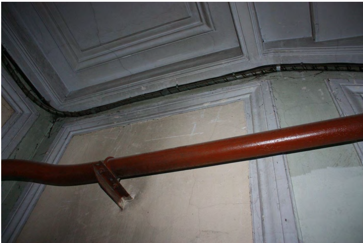
Фото 92. Фрагмент северной стены первого (цокольного) этажа.
