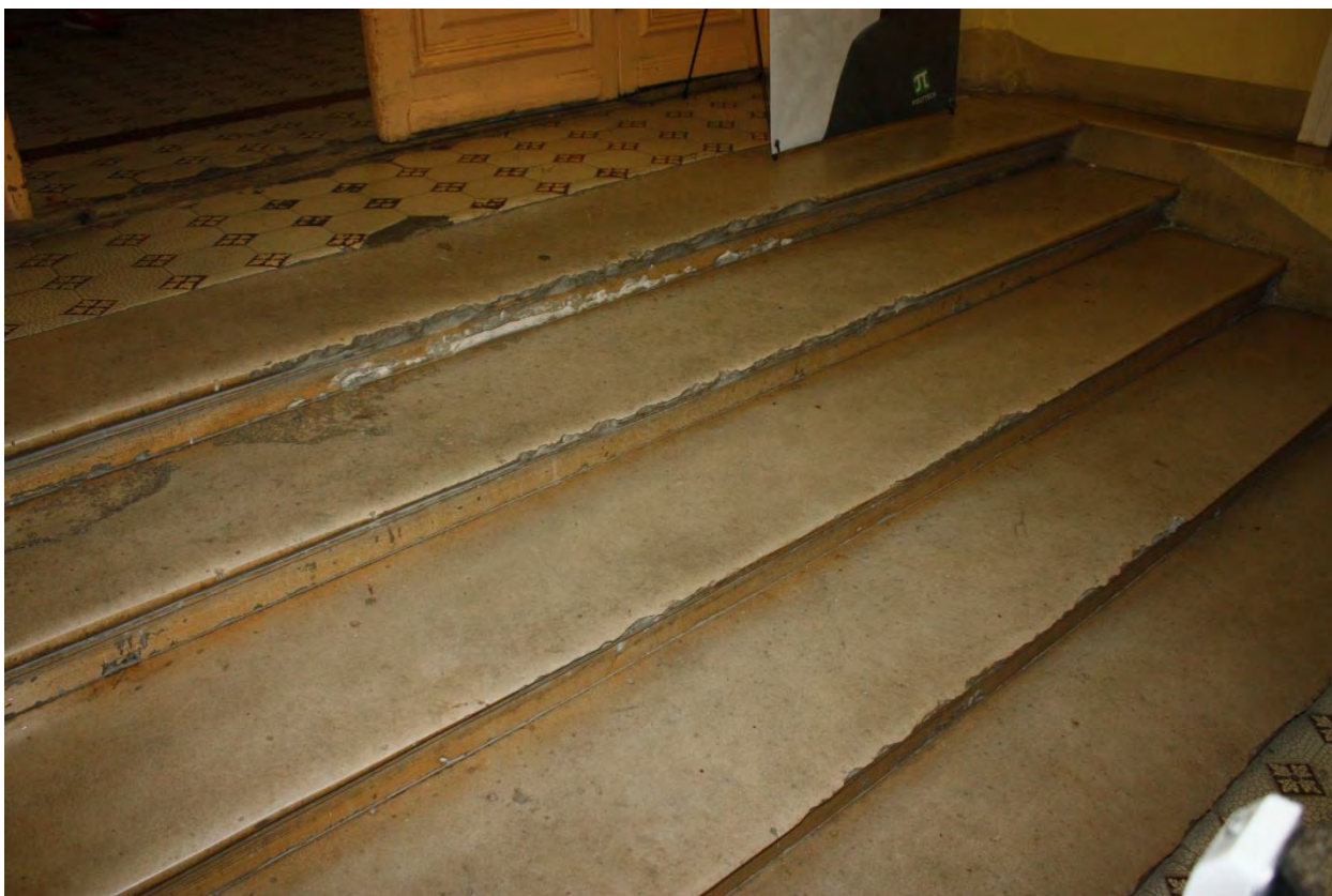
Фото 20. Лестница в вестибюле.
