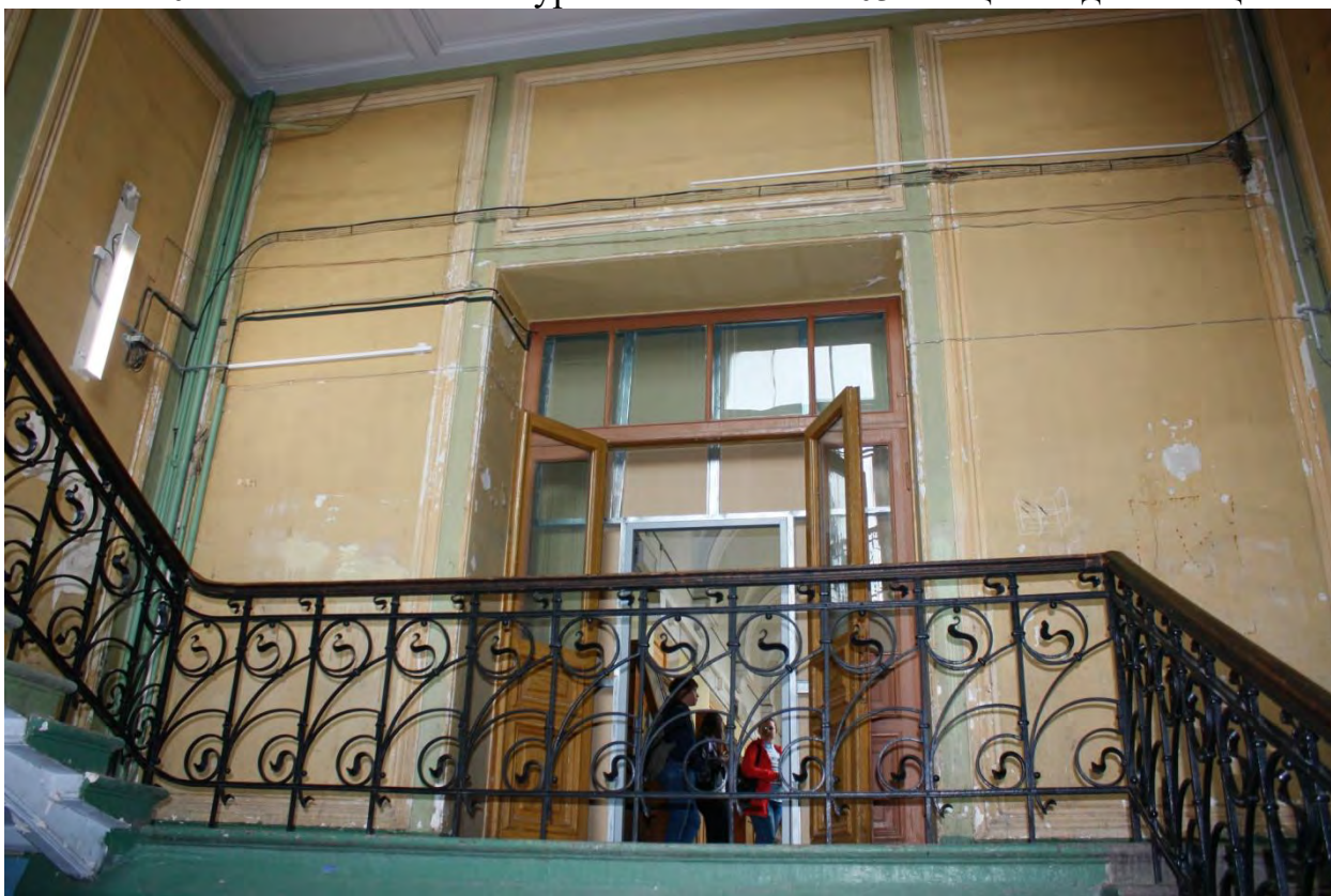
Фото 104. Ограждение в уровне первого этажа.
