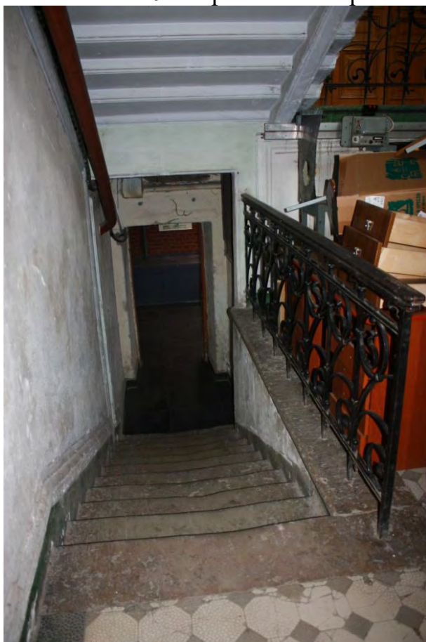
Фото 93. Лестница в подвал.
