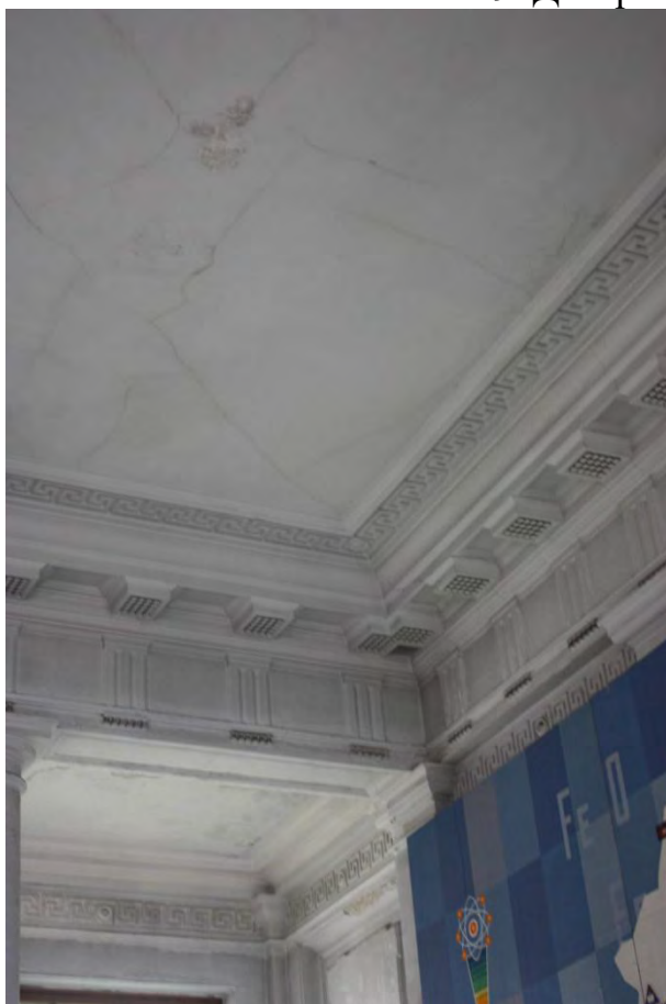
Фото 50. Фрагмент перекрытия центральной части лестницы.
