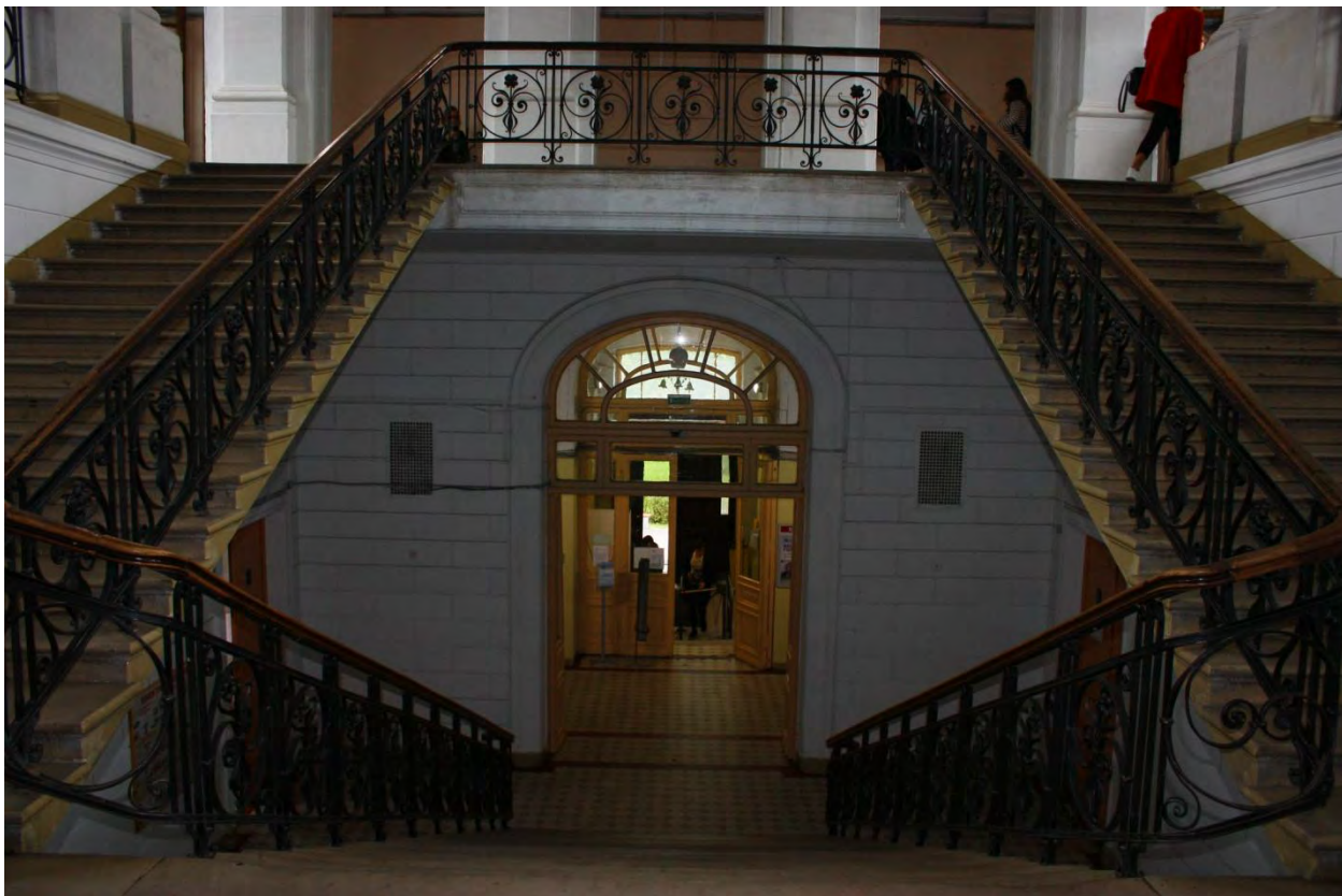
Фото 37. Общий вид лестницы.
