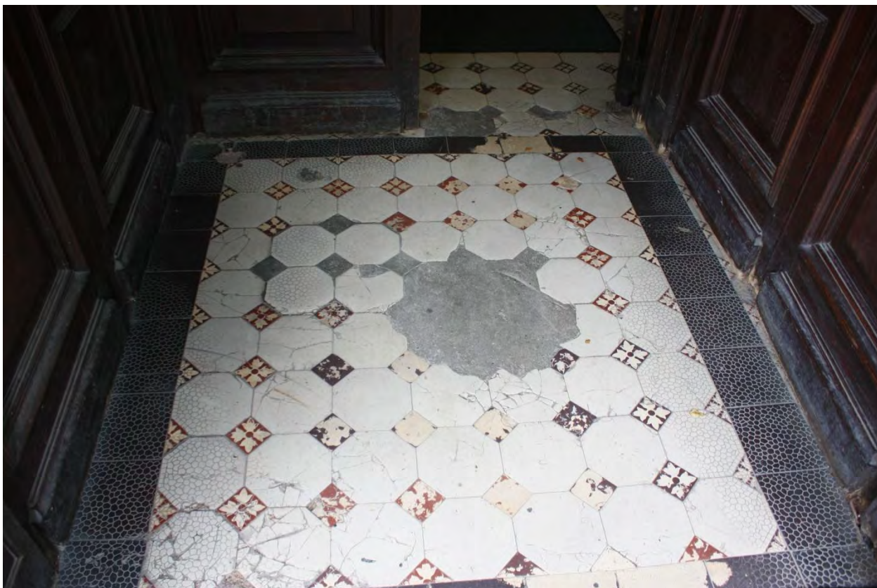
Фото 7. Покрытие пола тамбура.
