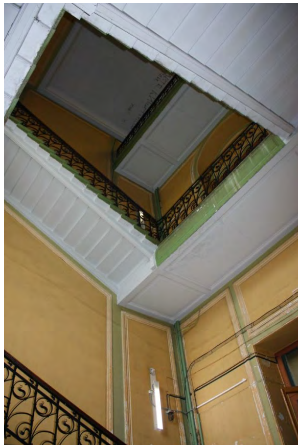
Фото 103. Общий вид лестницы.
