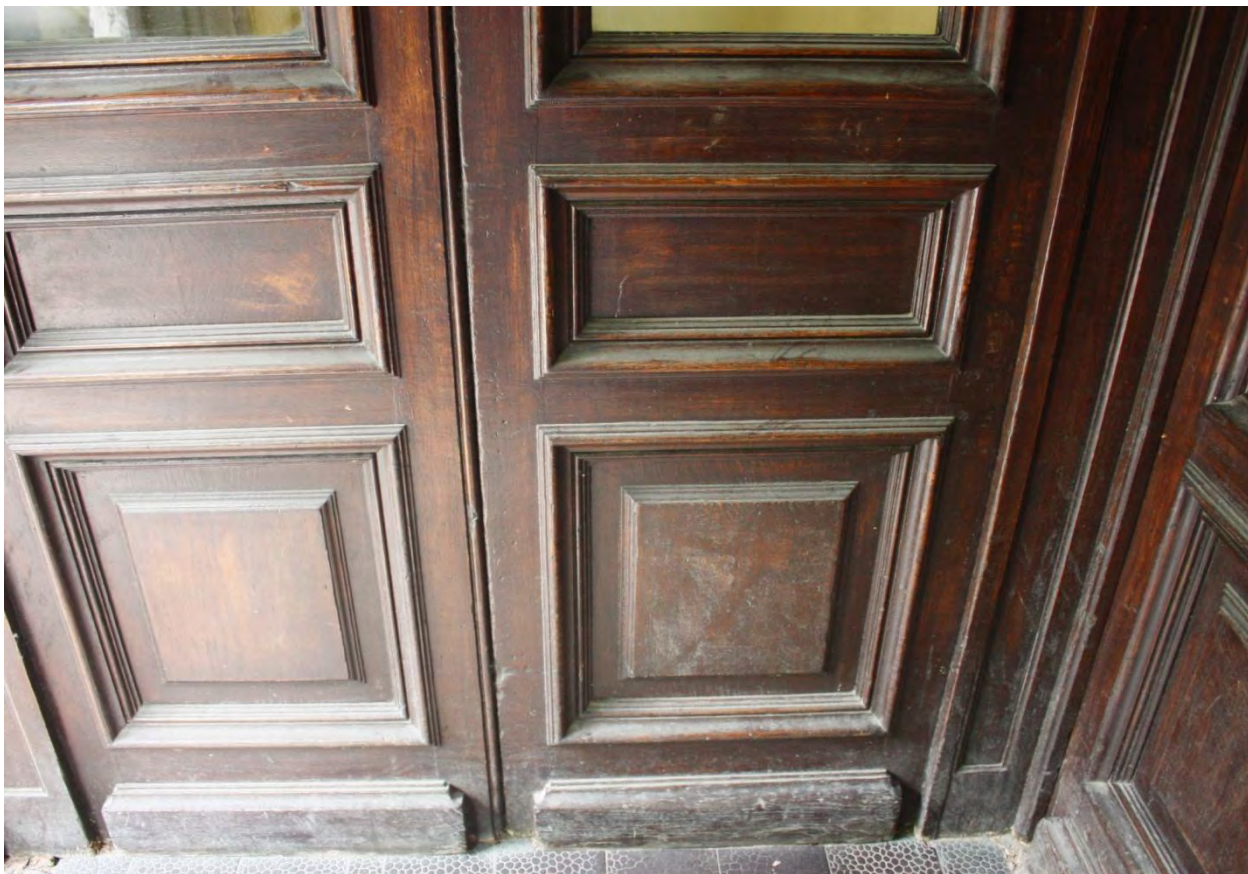
Фото 9. Западная часть тамбура.
