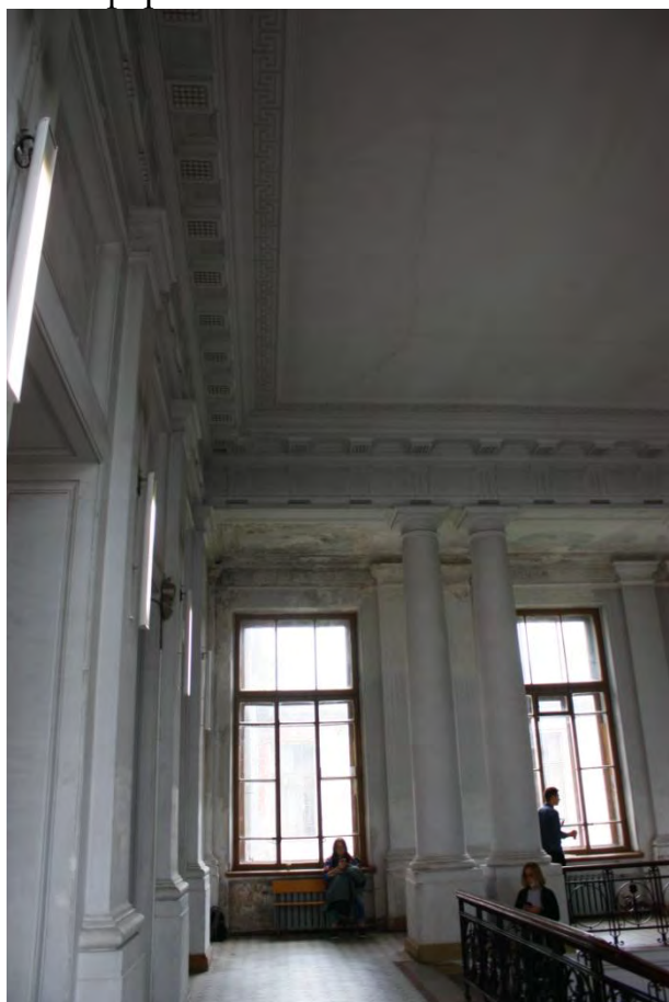
Фото 51. Вид на западную часть лестницы.
