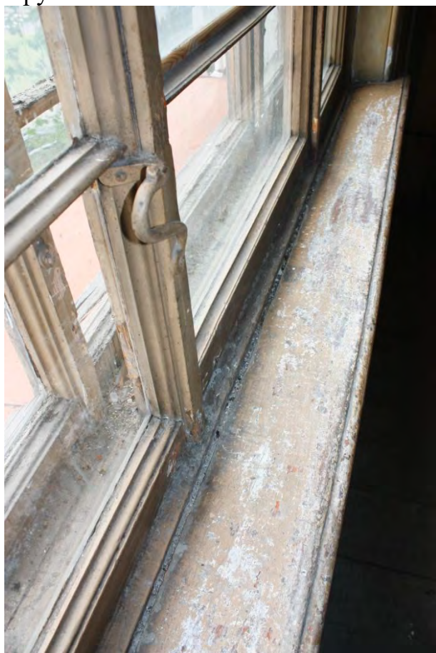
Фото 113. Оконное заполнение между первым и вторым этажами.
