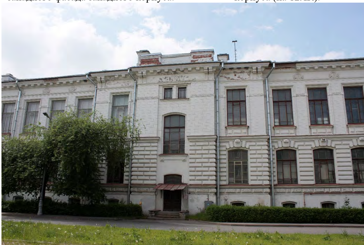
Фото 6. Центральная часть восточного фасада.
