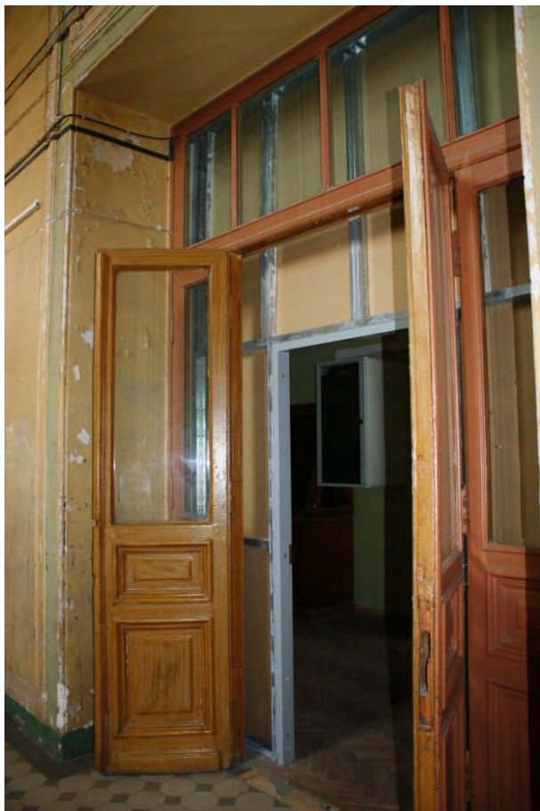
Фото 106. Дверное заполнение в уровне первого этажа.
