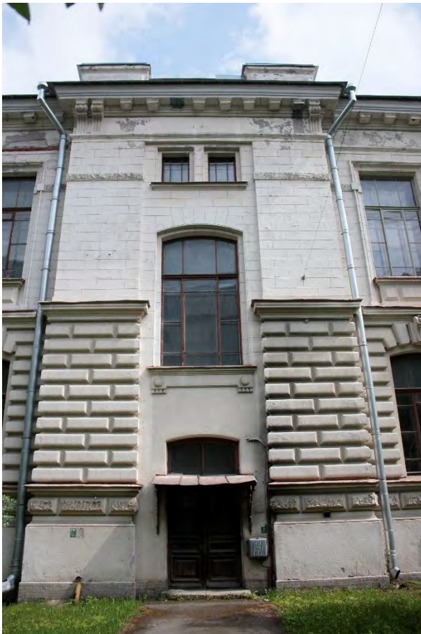
Фото 4. Центральный ризалит западного фасада западного корпуса.
