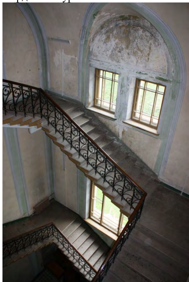
Фото 62. Общий вид лестницы.
