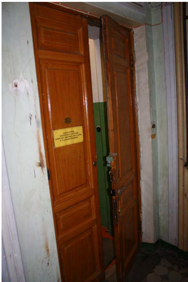
Фото 69. Дверное заполнение в северной стене, 2 этаж.
