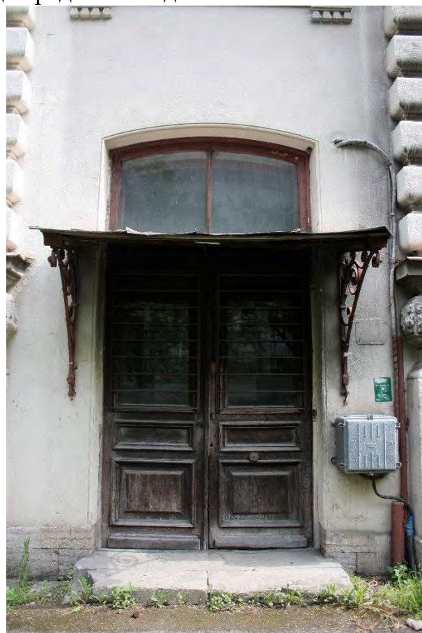
Фото 3. Главный вход западного корпуса (на 11ЛК).
