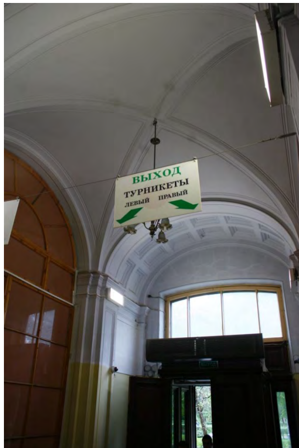
Фото 19. Перекрытия в вестибюле.
