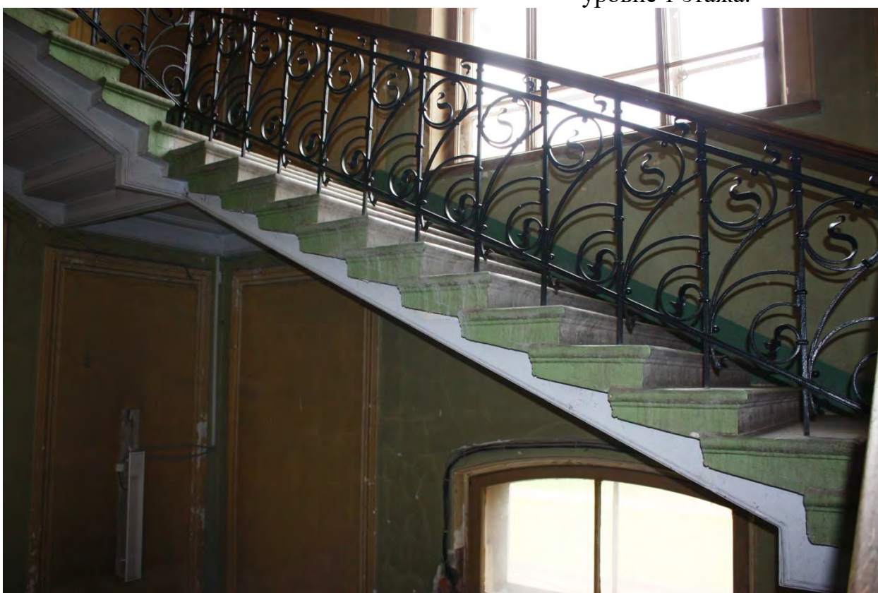
Фото 110. Лестничный марш вдоль восточной стены.
