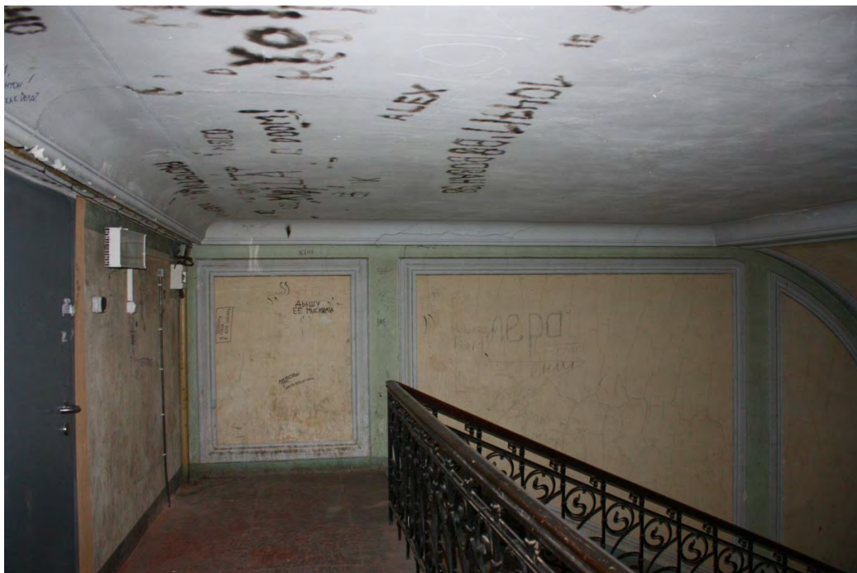
Фото 60. Южная стена чердачного уровня.
