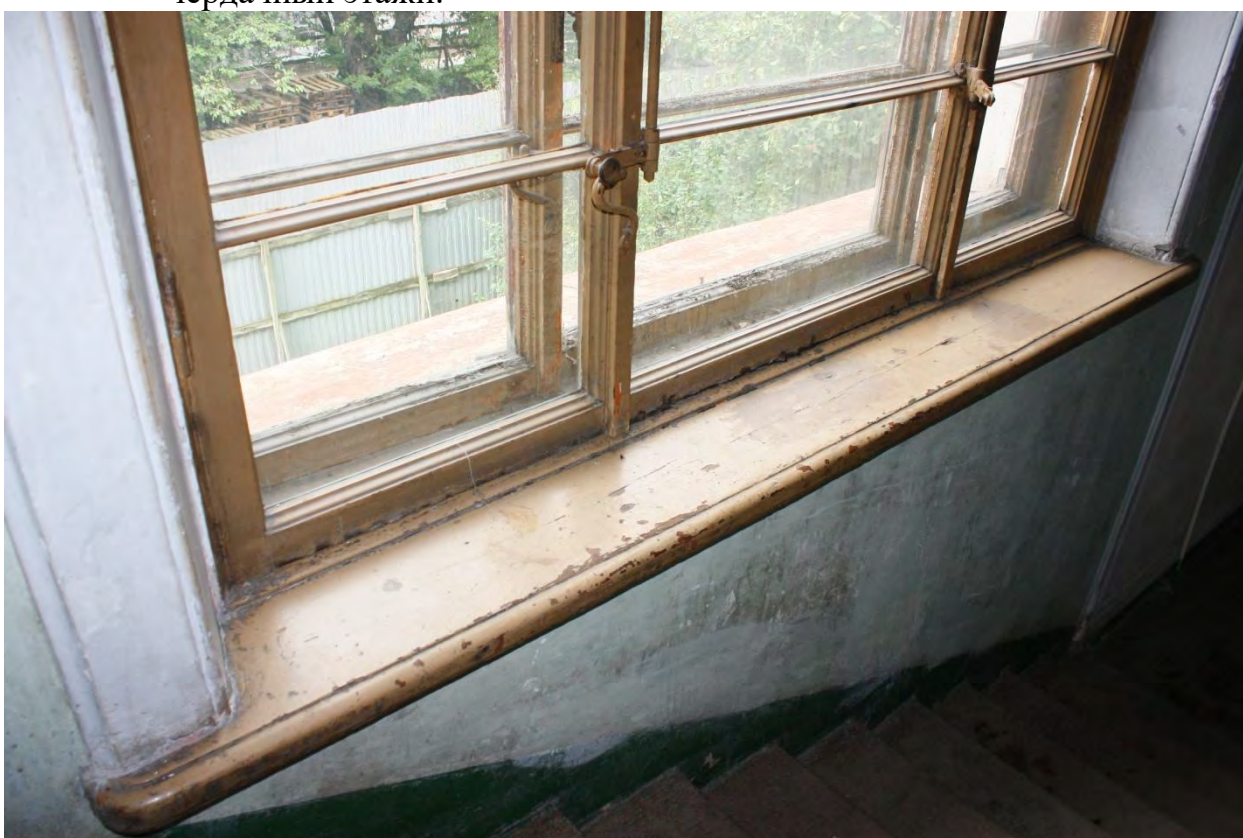
Фото 78. Оконное заполнение в уровне между вторым и первым этажами.
