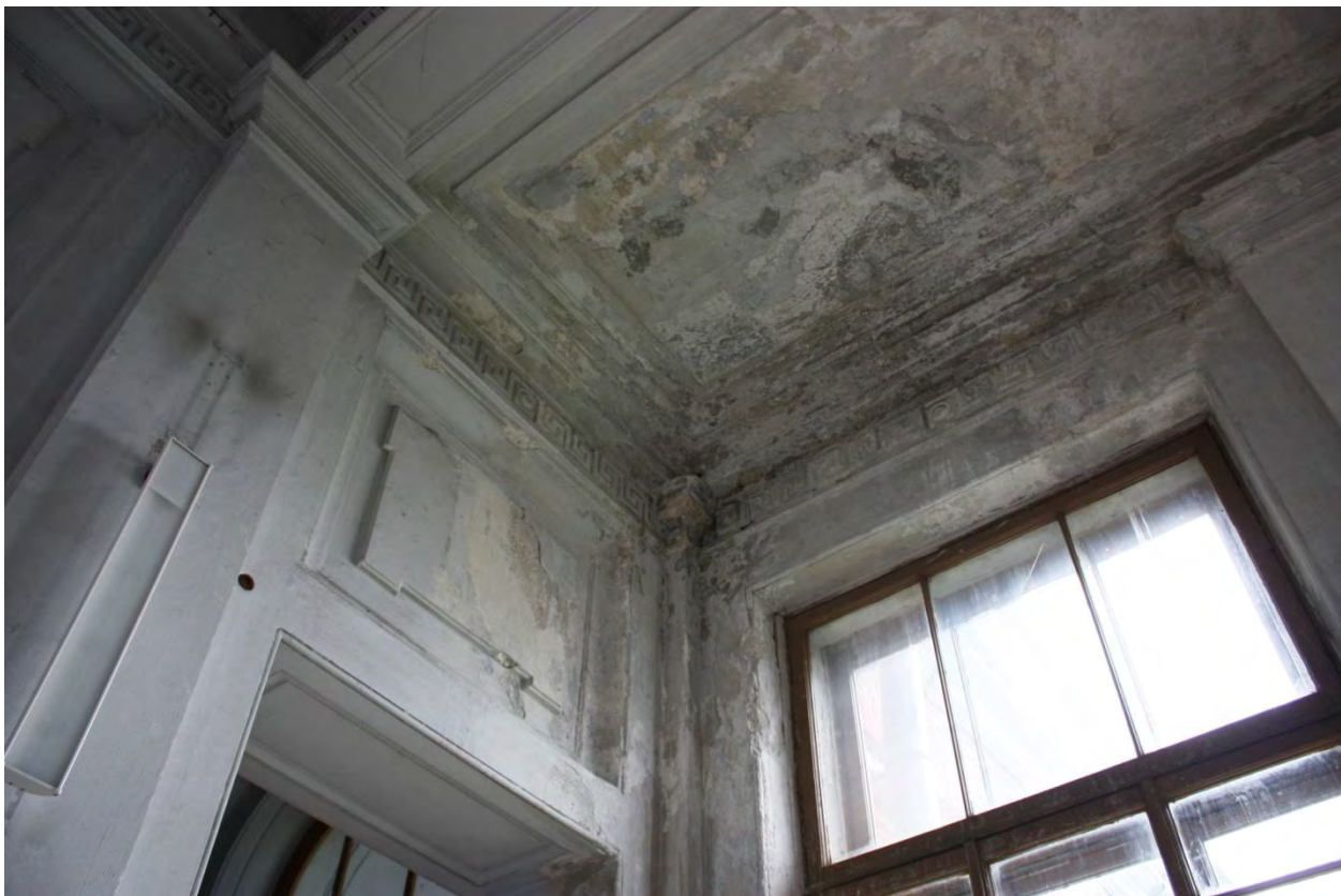
Фото 47. Перекрытие над западным переходом.
