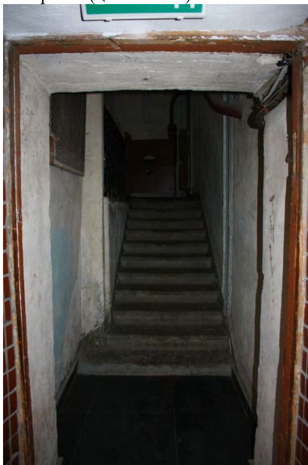
Фото 94. Лестница, вид из подвала.
