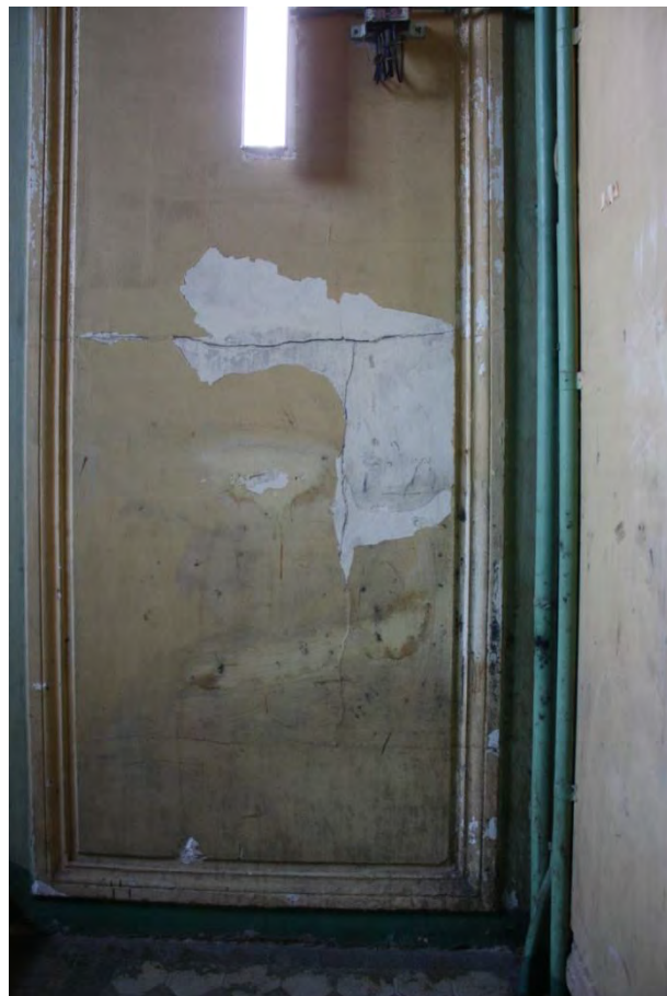
Фото 109. Фрагмент южной стены в уровне 1 этажа.
