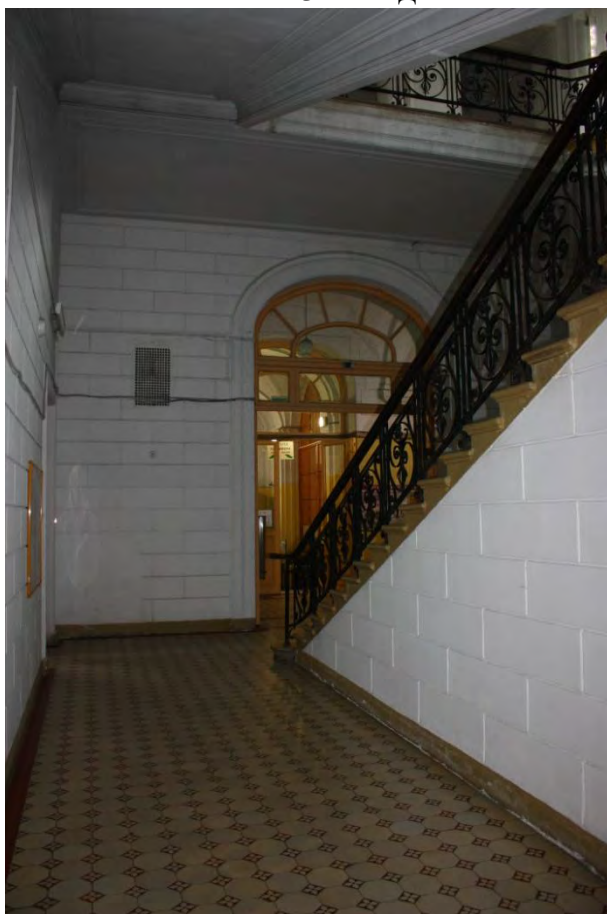
Фото 32. Западная часть первого этажа.
