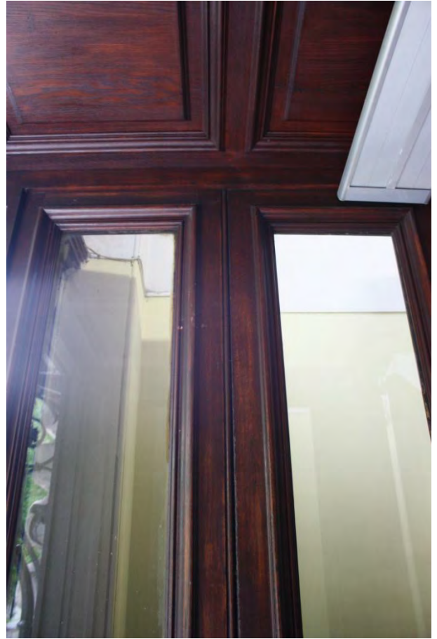
Фото 12. Остекление тамбура (западная часть).
