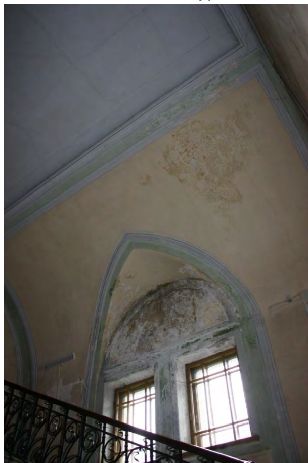
Фото 61. Перекрытие и оконный проем в чердачной зоне.
