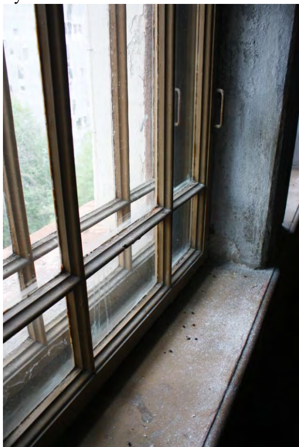
Фото 65. Оконное заполнение предчердачный уровень.
