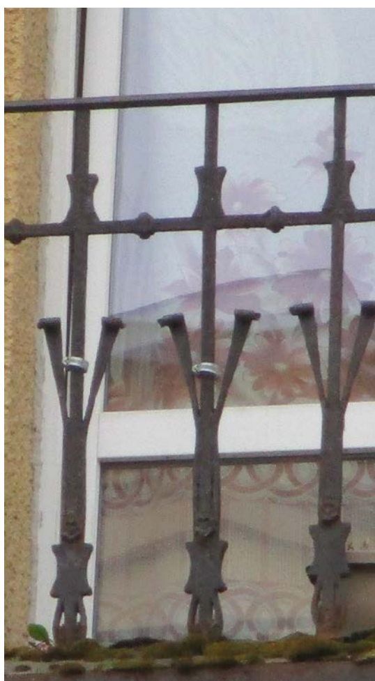
10. Санкт-Петербург. 11 линия, д.48. Ограждение балкона 3 этажа.
