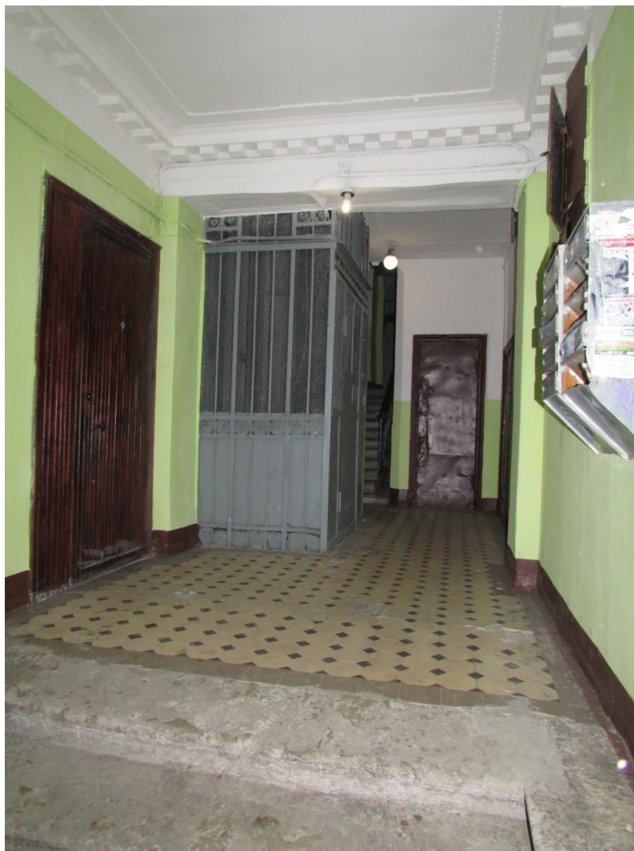
3. г. Санкт-Петербург, 11-я линия, В.О.д.48 Вестибюль лестницы 1 Лк
