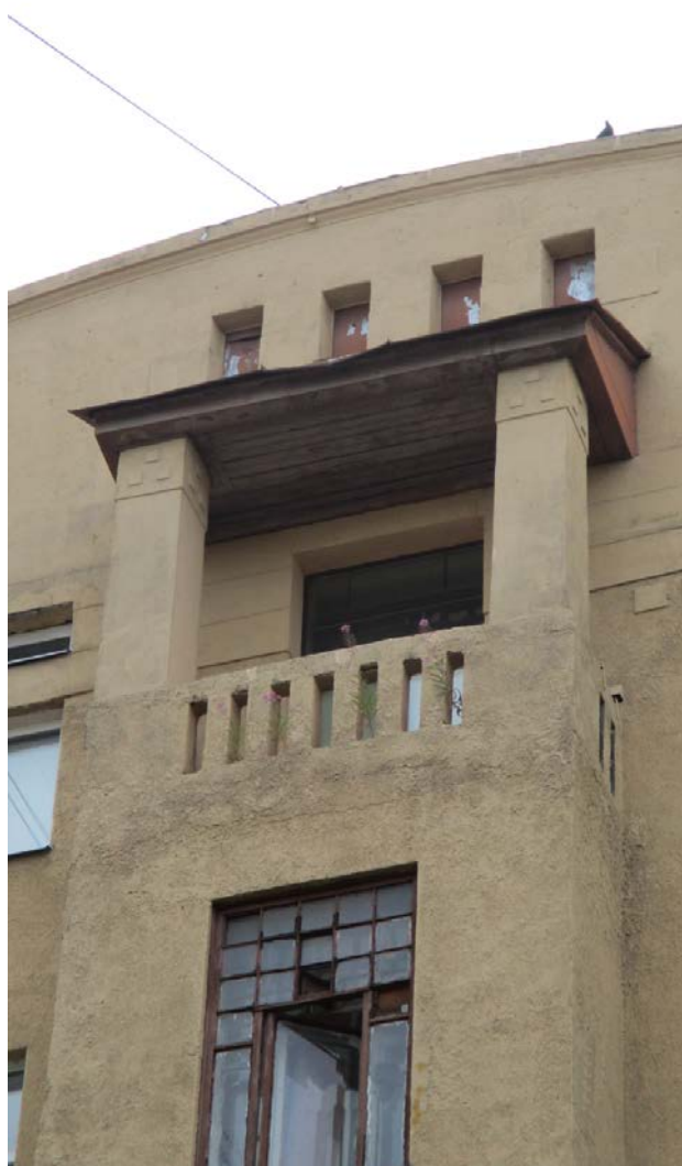
6. Санкт-Петербург. 11 линия, д.48. Фрагмент лицевого фасада.
