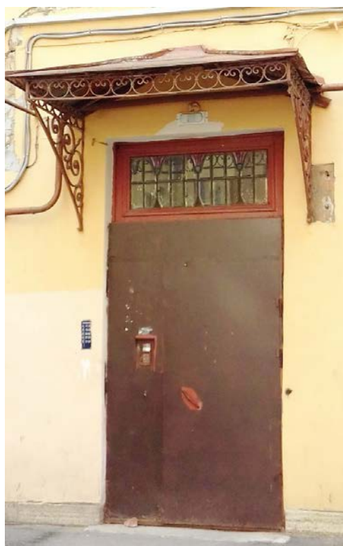
20. Санкт-Петербург. 11 линия, д.48. Фрагмент фасада лит. Б. Дверной проем лестничной клетки.
