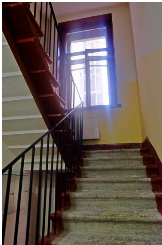
12. г. Санкт-Петербург, 11-я линия, В.О.д.48, Лестница 5 Лк
