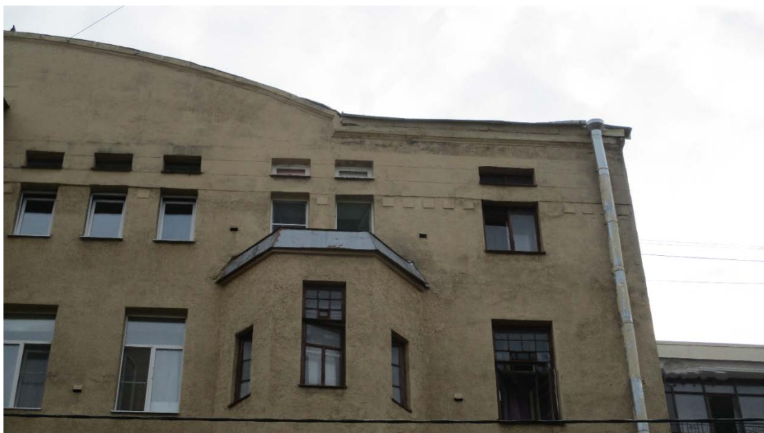
5. Санкт-Петербург. 11 линия, д.48. Фрагмент лицевого фасада.
