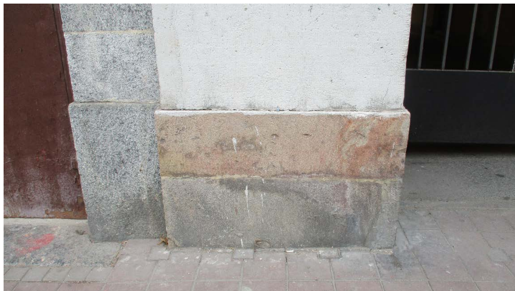
12. Санкт-Петербург. 11 линия, д.48. Фрагмент лицевого фасада. Гранитный цоколь.
