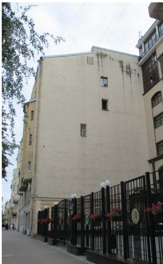
3. Санкт-Петербург. 11 линия, д.48. Общий вид с севера
