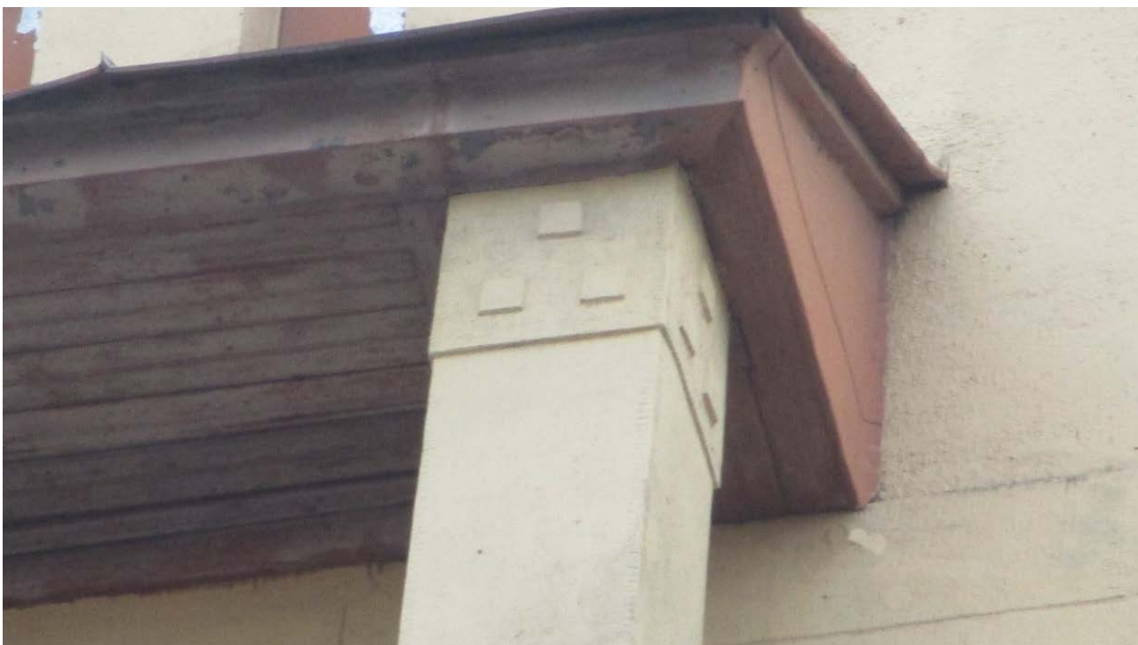
7. Санкт-Петербург. 11 линия, д.48. Фрагмент лицевого фасада.
