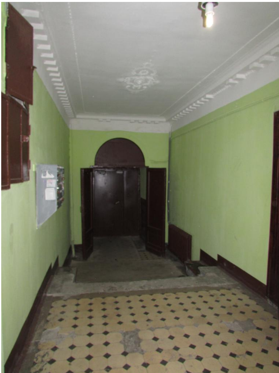
1. г. Санкт-Петербург, 11-я линия, В.О.д.48. Вестибюль лестницы 1 Лк
