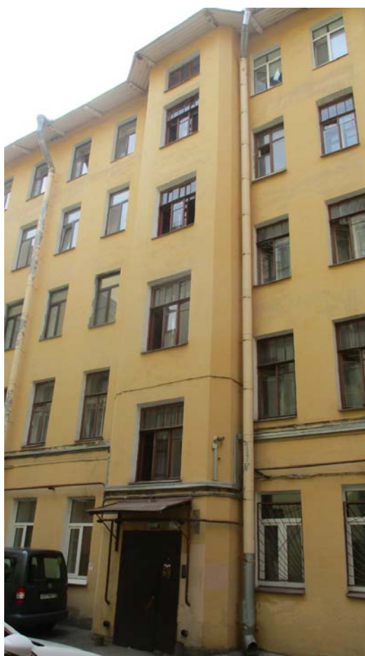
18. Санкт-Петербург. 11 линия, д.48. Фрагмент фасада северного флигеля.
