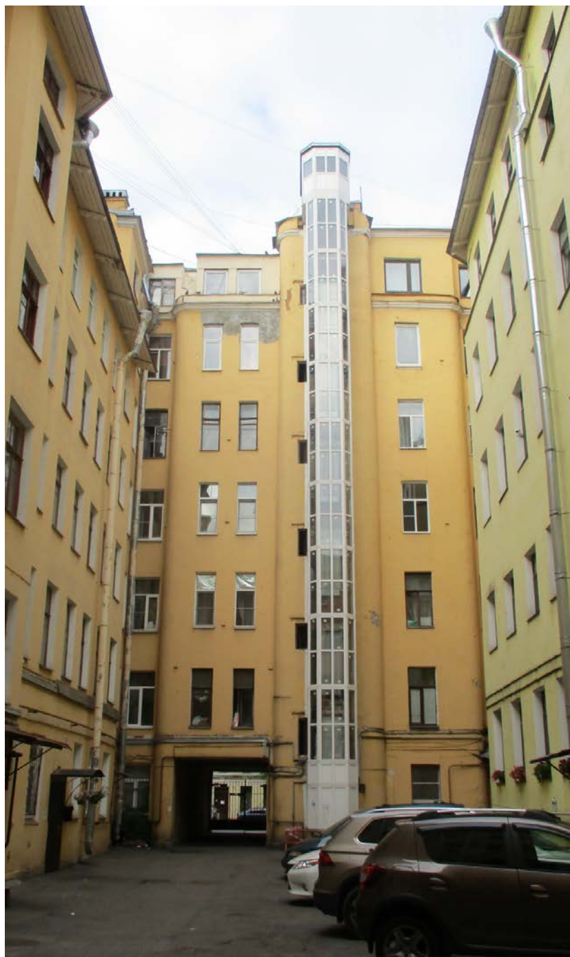
14. Санкт-Петербург. 11 линия, д.48. Вид лицевого корпуса со стороны двора.
