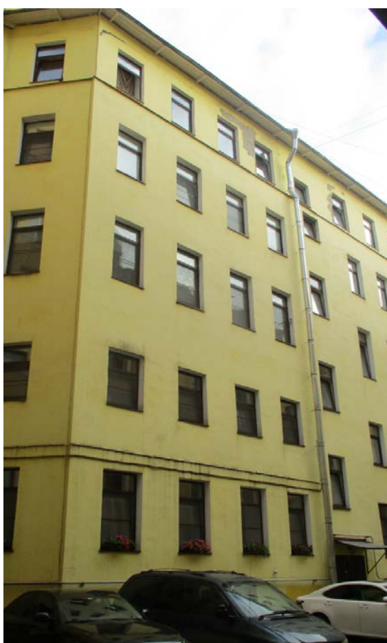
16. Санкт-Петербург. 11 линия, д.48. Фрагмент фасада южного флигеля.
