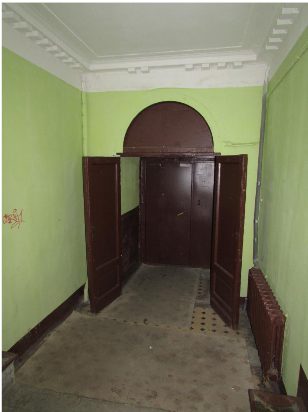
2. г. Санкт-Петербург, 11-я линия, В.О.д.48. Вестибюль лестницы 1 Лк
