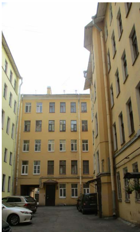
17. Санкт-Петербург. 11 линия, д.48. Вид территории внутреннего двора.
