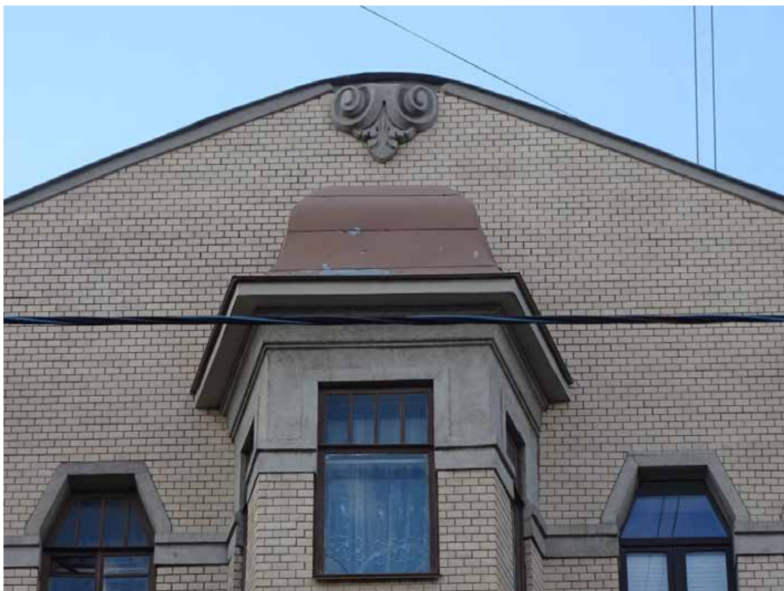
Фото 23. Здание по адресу: г. Санкт-Петербург, 11-я линия В. О., 34/47, литера А. Фрагмент фасада. Вид с Среднего пр. Съемка 19.04.2021 г. Кириков Б. М.
