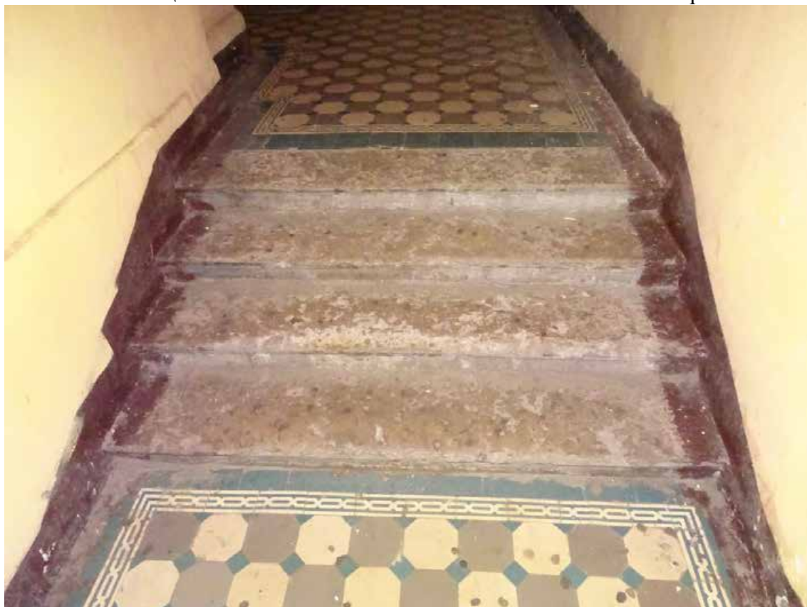
Фото 3. Лестница № 1. 1-й этаж. Вестибюль. Съемка 19.04.2021 г. Кириков Б. М.
