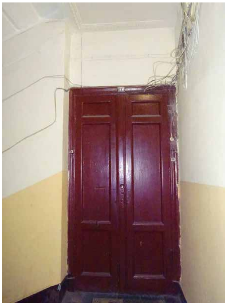
Фото 21. Лестница № 1. 2-й этаж. Съемка 19.04.2021 г. Кириков Б. М.
