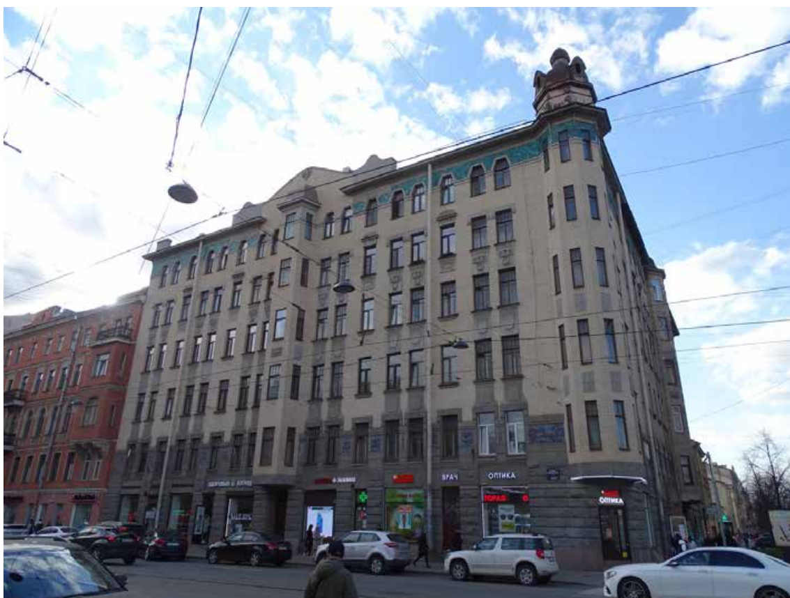
Фото 14. Здание по адресу: г. Санкт-Петербург, 11-я линия В. О., 34/47, литера А. Вид на фасад с Среднего пр. Съемка 19.04.2021 г. Кириков Б. М.
