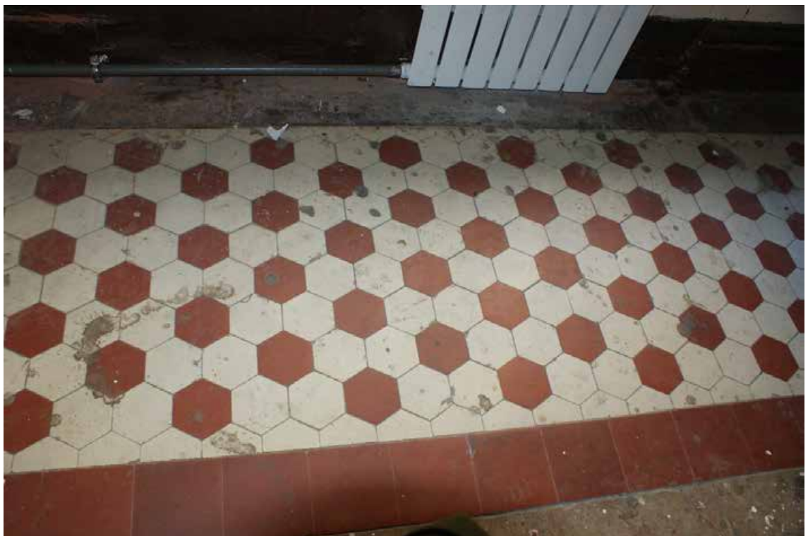
Фото 53. Лестница № 2. Площадка м/у 2-м и 3-м этажом. Покрытие пола. Съемка 19.04.2021 г. Кириков Б. М.
