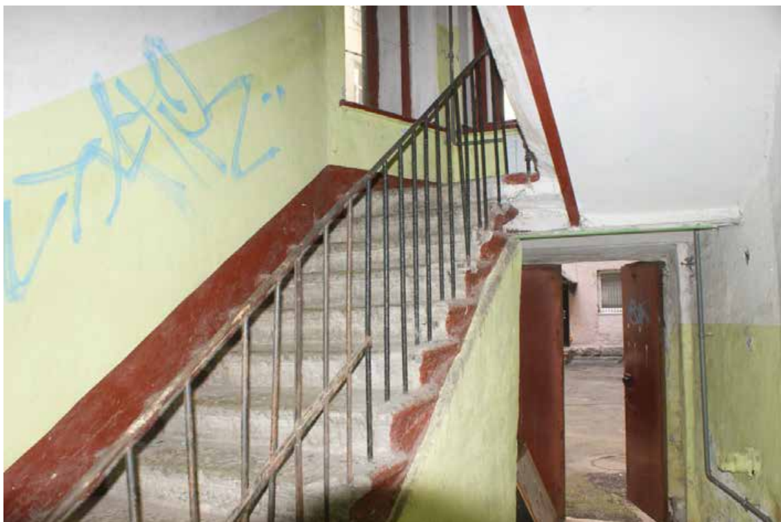
Фото 123. Лестница № 4. Лестничный марш на 2-й этаж. Съемка 19.04.2021 г. Кириков Б. М.
