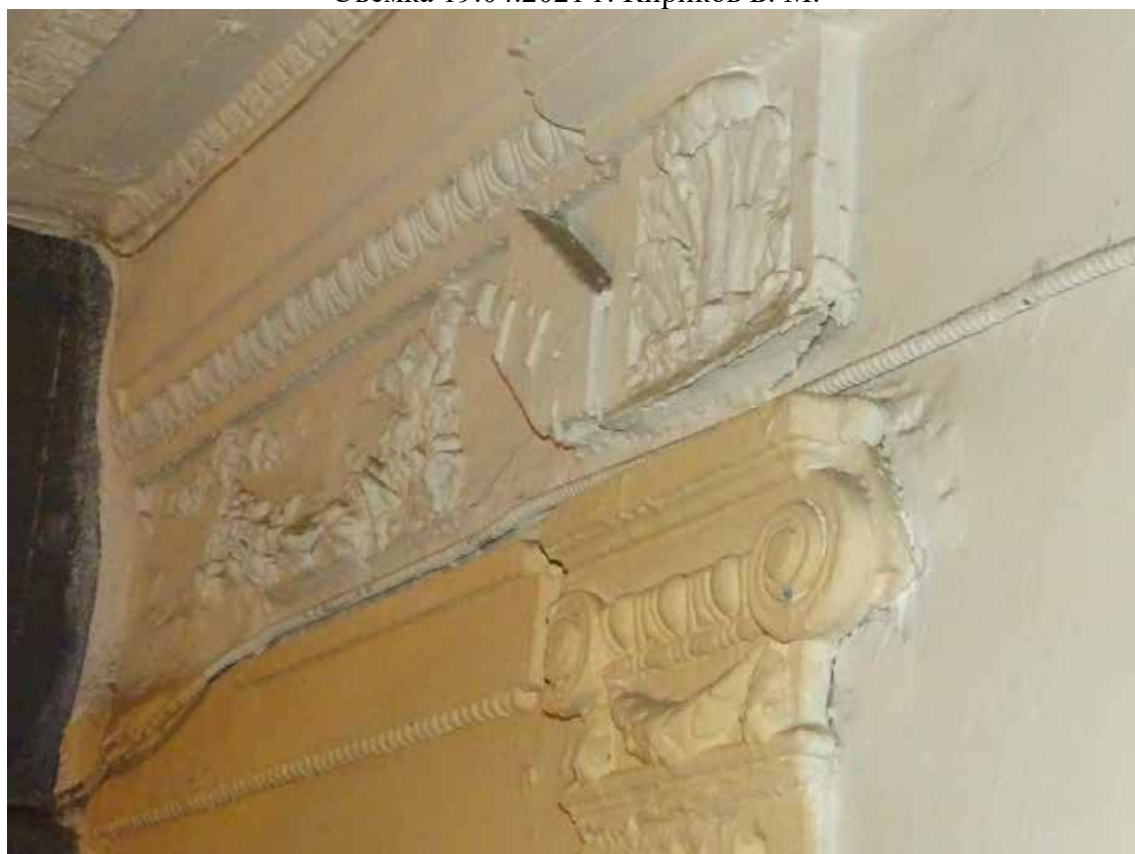
Фото 13. Лестница № 1. 1-й этаж. Оформление стен. Съемка 19.04.2021 г. Кириков Б. М.
