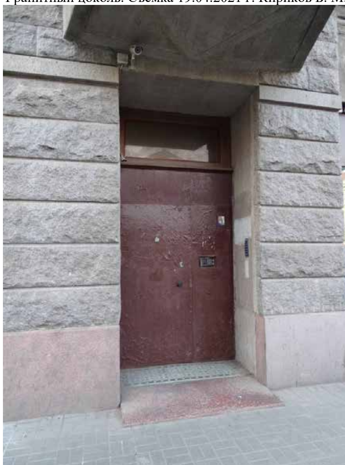
Фото 46. Здание по адресу: г. Санкт-Петербург, 11-я линия В. О., 34/47, литера А. Дверной проем. Фрагмент фасада по 11-й линии. Съемка 19.04.2021 г. Кириков Б. М.
