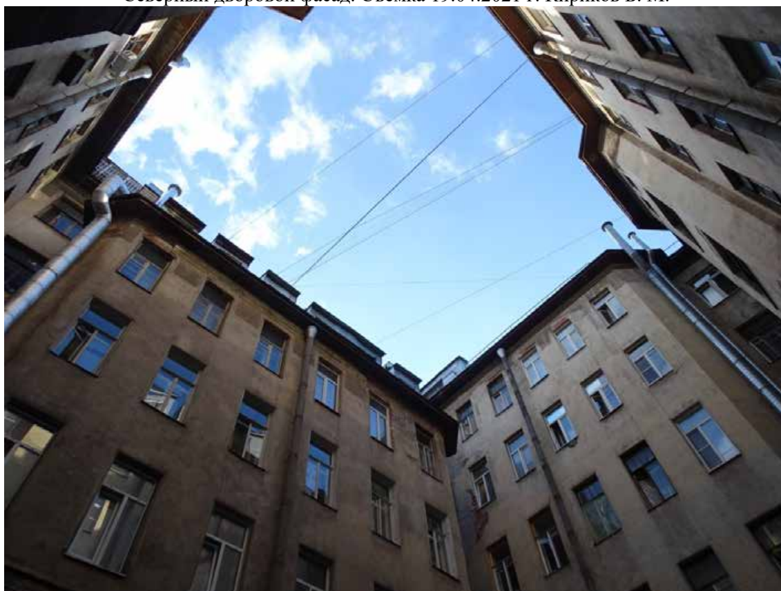
Фото 34. Здание по адресу: г. Санкт-Петербург, 11-я линия В. О., 34/47, литера А. Фрагмент дворового фасада. Съемка 19.04.2021 г. Кириков Б. М.
