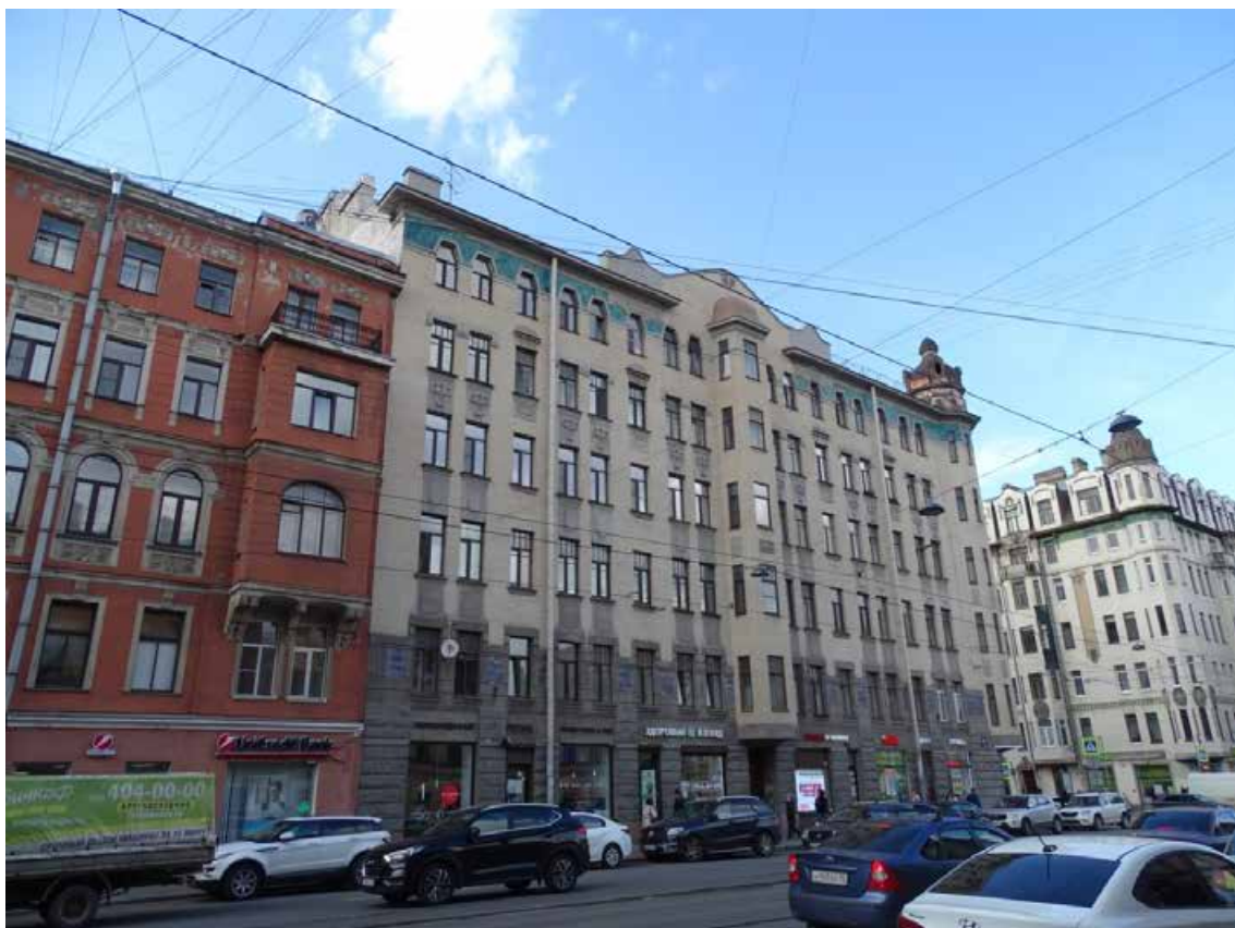
Фото 25. Здание по адресу: г. Санкт-Петербург, 11-я линия В. О., 34/47, литера А. Вид на фасад с Среднего пр. Съемка 19.04.2021 г. Кириков Б. М.
