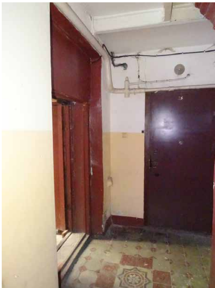
Фото 71. Лестница № 3. 1-й этаж. Съемка 19.04.2021 г. Кириков Б. М.
