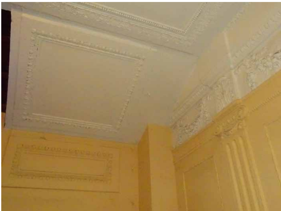
Фото 8. Лестница № 1. 1-й этаж. Вестибюль. Оформление стен и потолка. Съемка 19.04.2021 г. Кириков Б. М.
