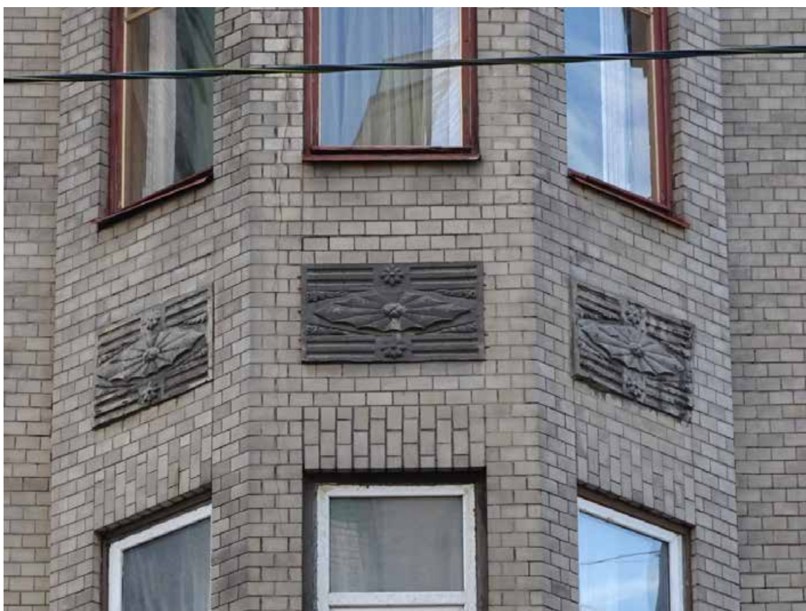
Фото 8. Здание по адресу: г. Санкт-Петербург, 11-я линия В. О., 34/47, литера А. Фрагмент фасада по 11-й линии. Эркер. Съемка 19.04.2021 г. Кириков Б. М.
