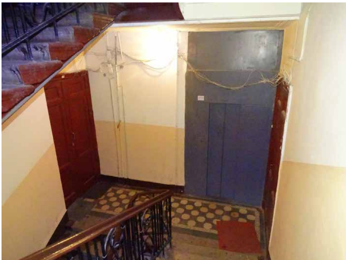
Фото 29. Лестница № 1. 5-й этаж. Съемка 19.04.2021 г. Кириков Б. М.
