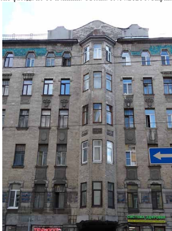
Фото 6. Здание по адресу: г. Санкт-Петербург, 11-я линия В. О., 34/47, литера А. Фрагмент фасада по 11-й линии. Эркер на высоту 2-го 6-го этажей. Съемка 19.04.2021 г. Кириков Б. М.
