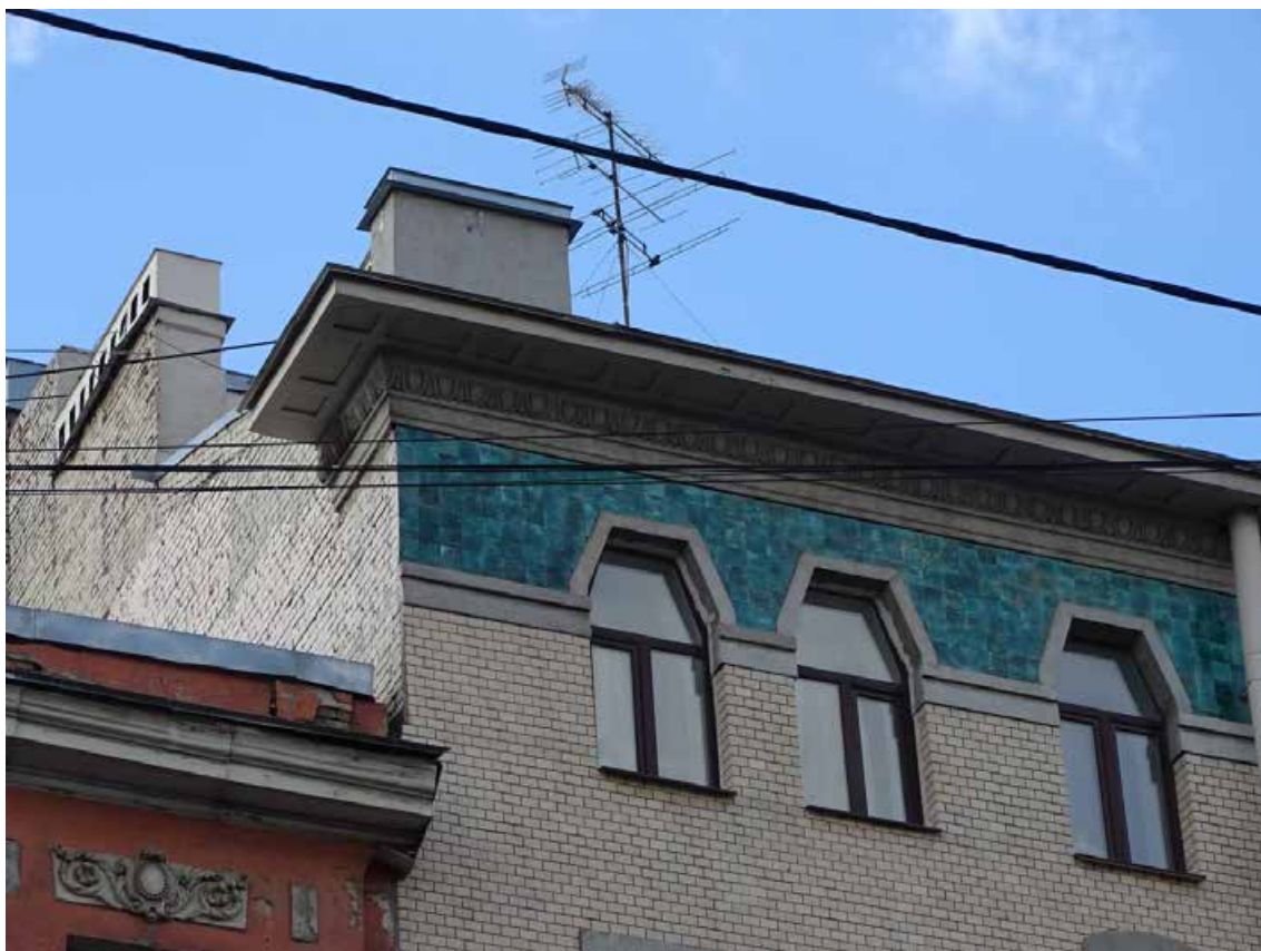
Фото 27. Здание по адресу: г. Санкт-Петербург, 11-я линия В. О., 34/47, литера А. Фрагмент фасада. Вид с Среднего пр. Съемка 19.04.2021 г. Кириков Б. М.
