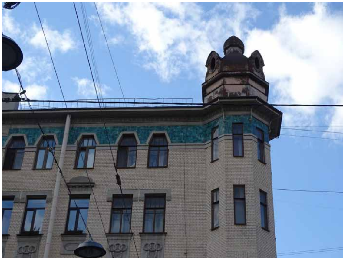
Фото 17. Здание по адресу: г. Санкт-Петербург, 11-я линия В. О., 34/47, литера А. Фрагмент фасада. Вид с Среднего пр. Съемка 19.04.2021 г. Кириков Б. М.
