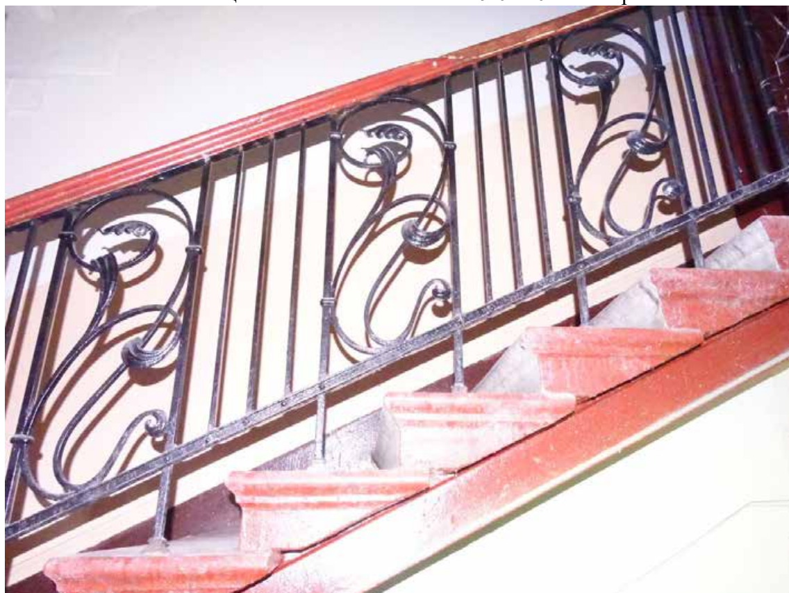
Фото 22. Лестница № 1. Фрагмент лестничного ограждения. Съемка 19.04.2021 г. Кириков Б. М.
