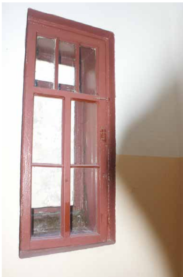
Фото 107. Лестница № 3. 5-й этаж. Съемка 19.04.2021 г. Кириков Б. М.
