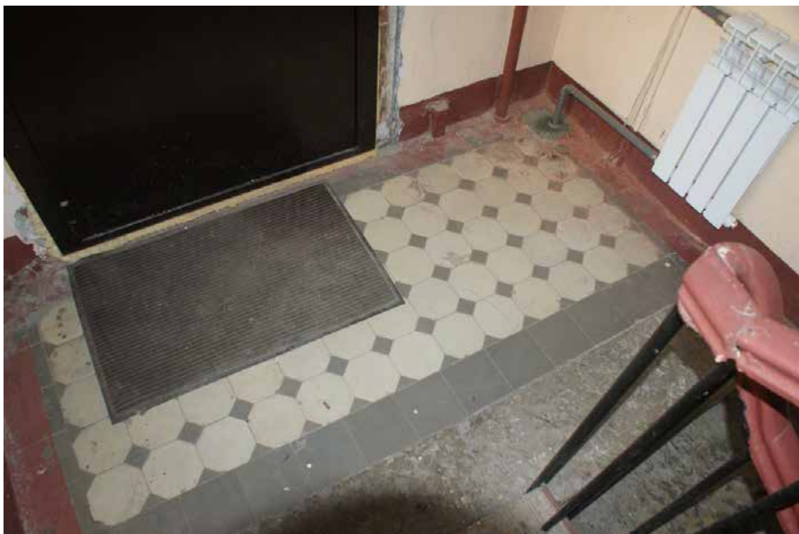
Фото 103. Лестница № 3. 5-й этаж. Покрытие пола. Съёмка 19.04.2021 г. Кириков Б. М.
