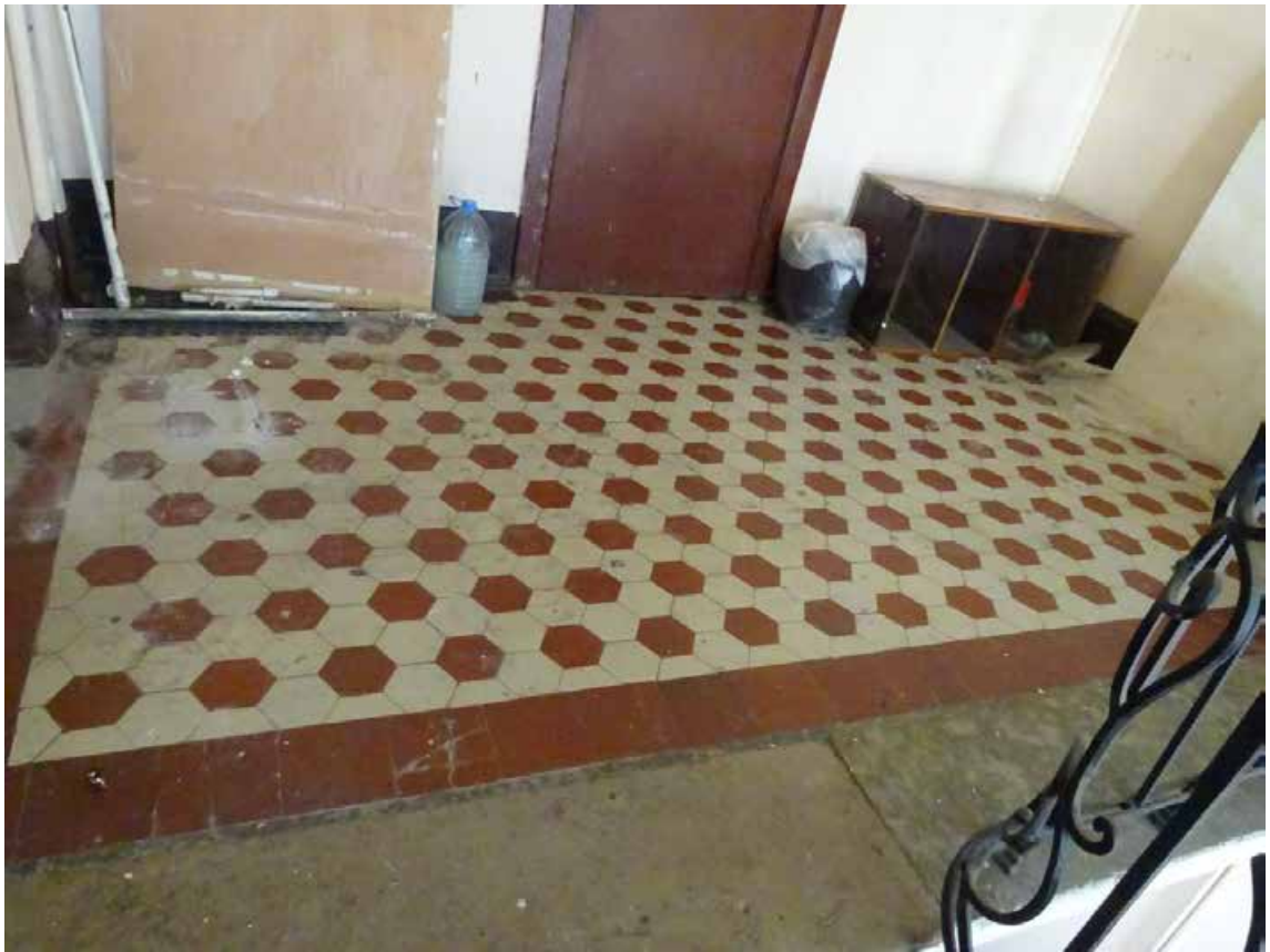
Фото 66. Лестница № 2. 6-й этаж. Покрытие пола. Съёмка 19.04.2021 г. Кириков Б. М.
