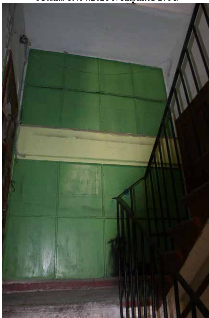
Фото 134. Лестница № 4. 3-й этаж. Съемка 19.04.2021 г. Кириков Б. М.
