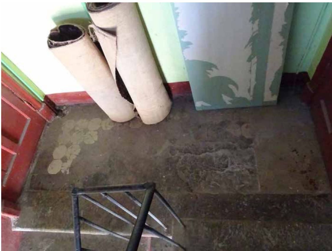
Фото 144. Лестница № 4. 6-й этаж. Покрытие пола. Съемка 19.04.2021 г. Кириков Б. М.
