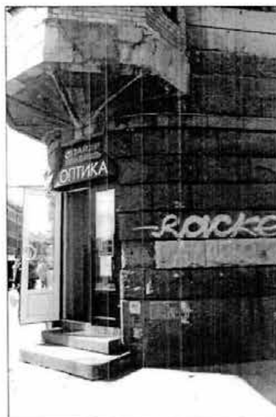
Дверной угловой проем пом 1-Н (1-й этаж). Съемка май 2012 г. М. С. Розанова.
