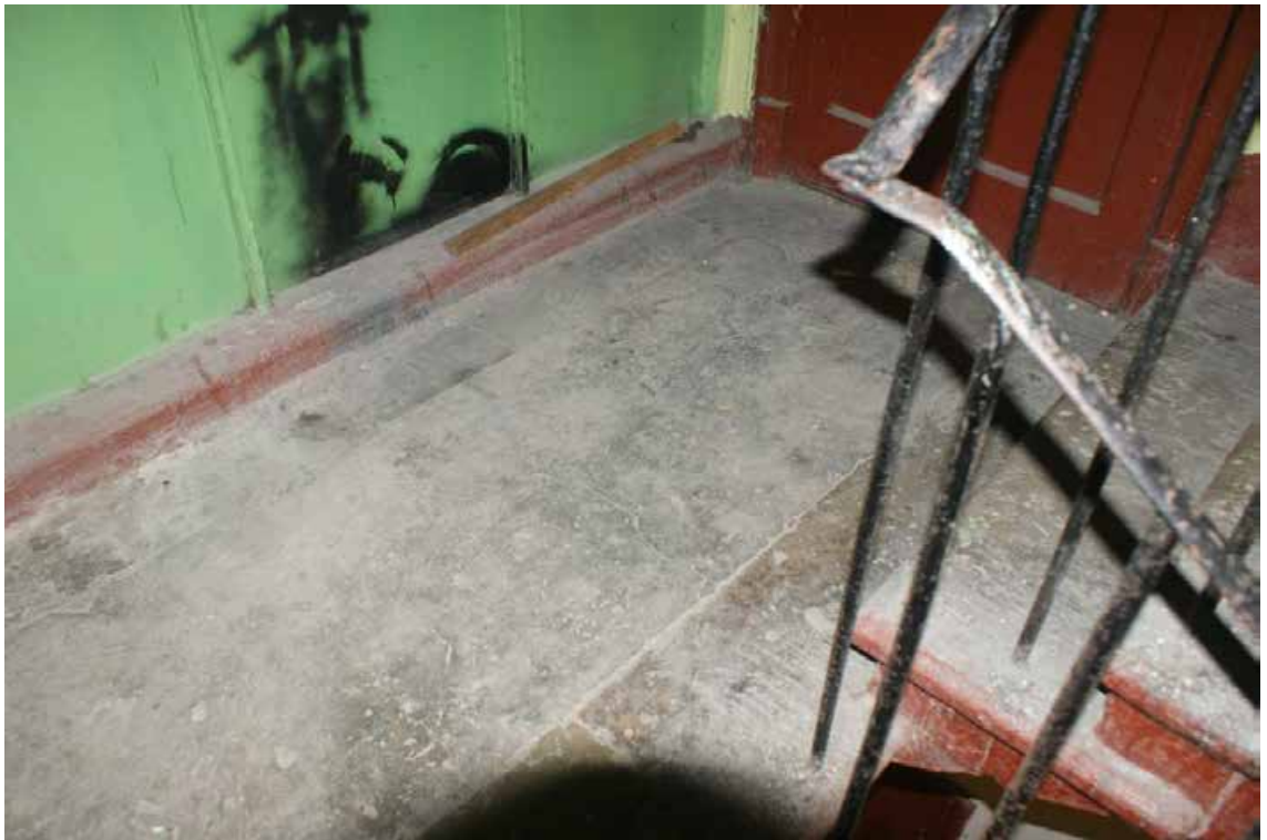
Фото 135. Лестница № 4. 3-й этаж. Съемка 19.04.2021 г. Кириков Б. М.
