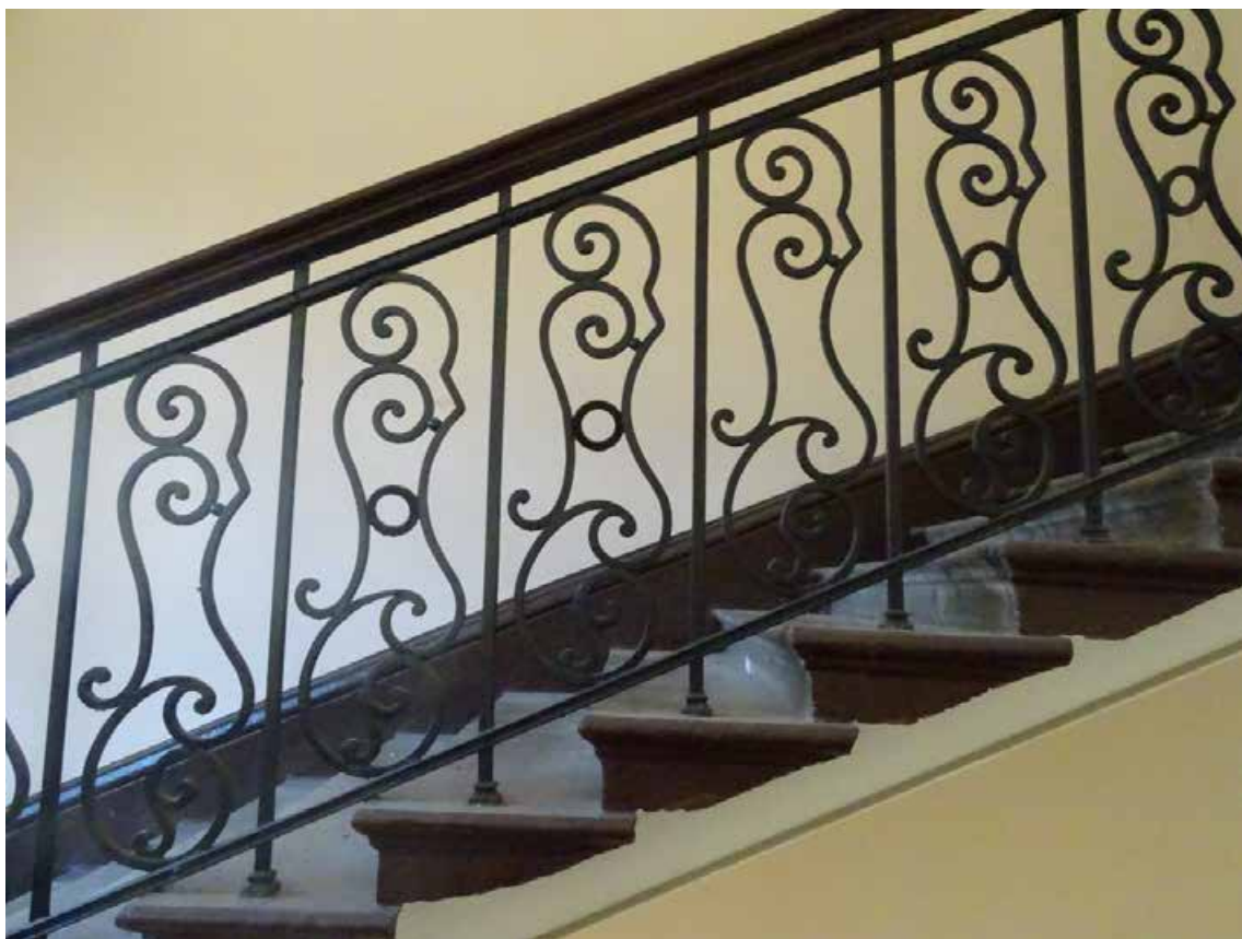
Фото 62. Лестница № 2. Фрагмент ограждения лестницы. Съемка 19.04.2021 г. Кириков Б. М.
