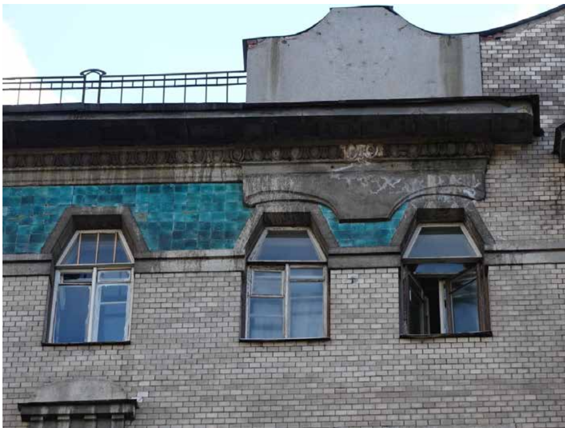
Фото 12. Здание по адресу: г. Санкт-Петербург, 11-я линия В. О., 34/47, литера А. Фрагмент фасада по 11-й линии. Съемка 19.04.2021 г. Кириков Б. М.
