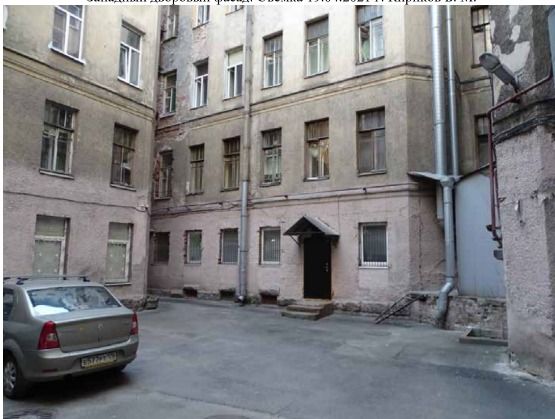
Фото 32. Здание по адресу: г. Санкт-Петербург, 11-я линия В. О., 34/47, литера А. Северо-западный дворовой фасад. Фрагмент. Съемка 19.04.2021 г. Кириков Б. М.
