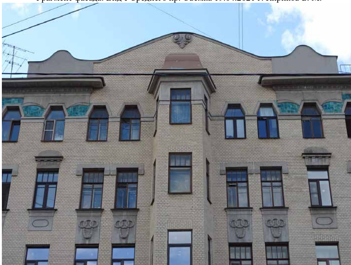
Фото 22. Здание по адресу: г. Санкт-Петербург, 11-я линия В. О., 34/47, литера А. Фрагмент фасада. Вид с Среднего пр. Съемка 19.04.2021 г. Кириков Б. М.
