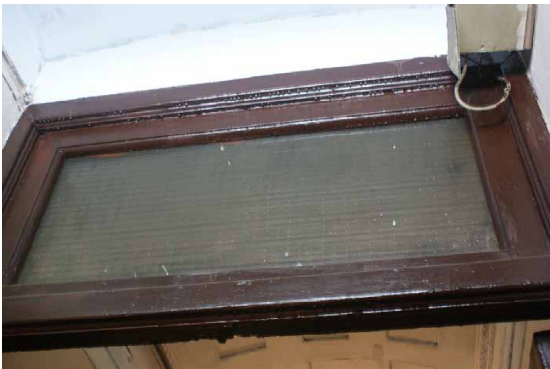
Фото 38. Лестница № 2. 1-й этаж. Вестибюль. Съемка 19.04.2021 г. Кириков Б. М.
