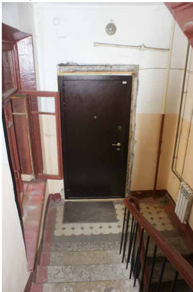
Фото 102. Лестница № 3. 5-й этаж. Съемка 19.04.2021 г. Кириков Б. М.
