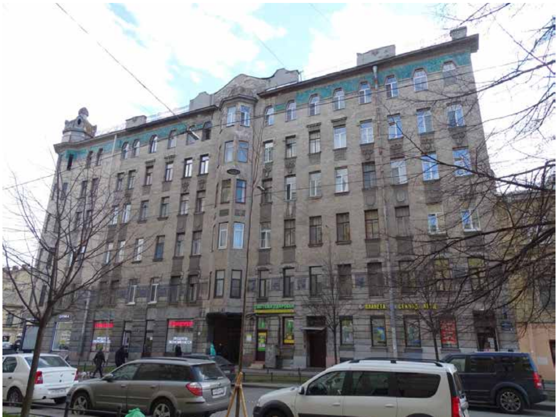
Фото 3. Здание по адресу: г. Санкт-Петербург, 11-я линия В. О., 34/47, литера А. Фасад по 11-й линии. Съемка 19.04.2021 г. Кириков Б. М.
