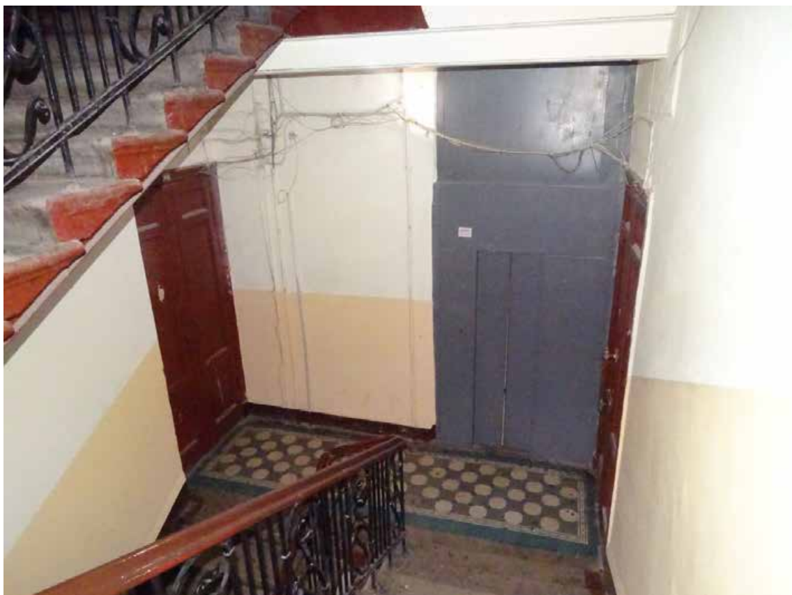
Фото 25. Лестница № 1. 3-й этаж. Съемка 19.04.2021 г. Кириков Б. М.
