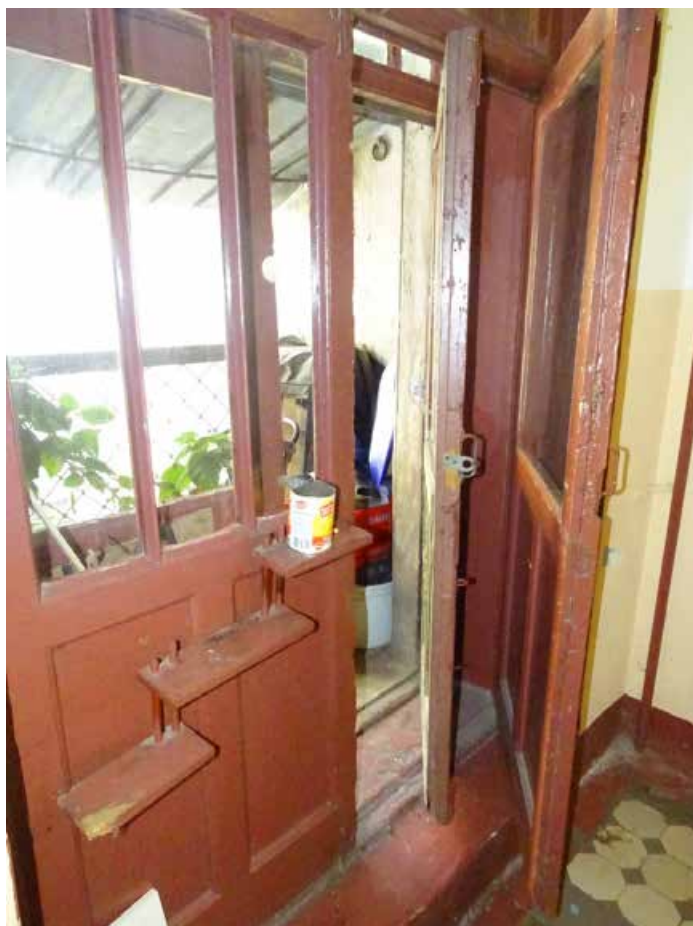
Фото 97. Лестница № 3. 4-й этаж. Съемка 19.04.2021 г. Кириков Б. М.
