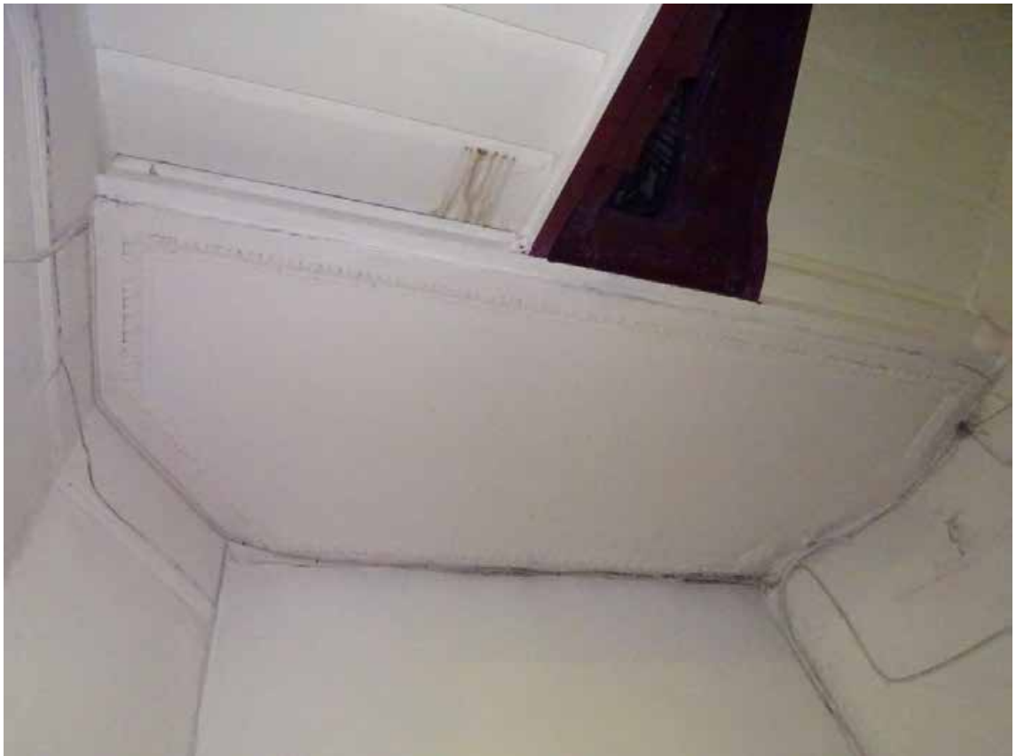
Фото 17. Лестница № 1. Площадка м/у 1-м и 2-м этажом. Оформление потолка. Съемка 19.04.2021 г. Кириков Б. М.
