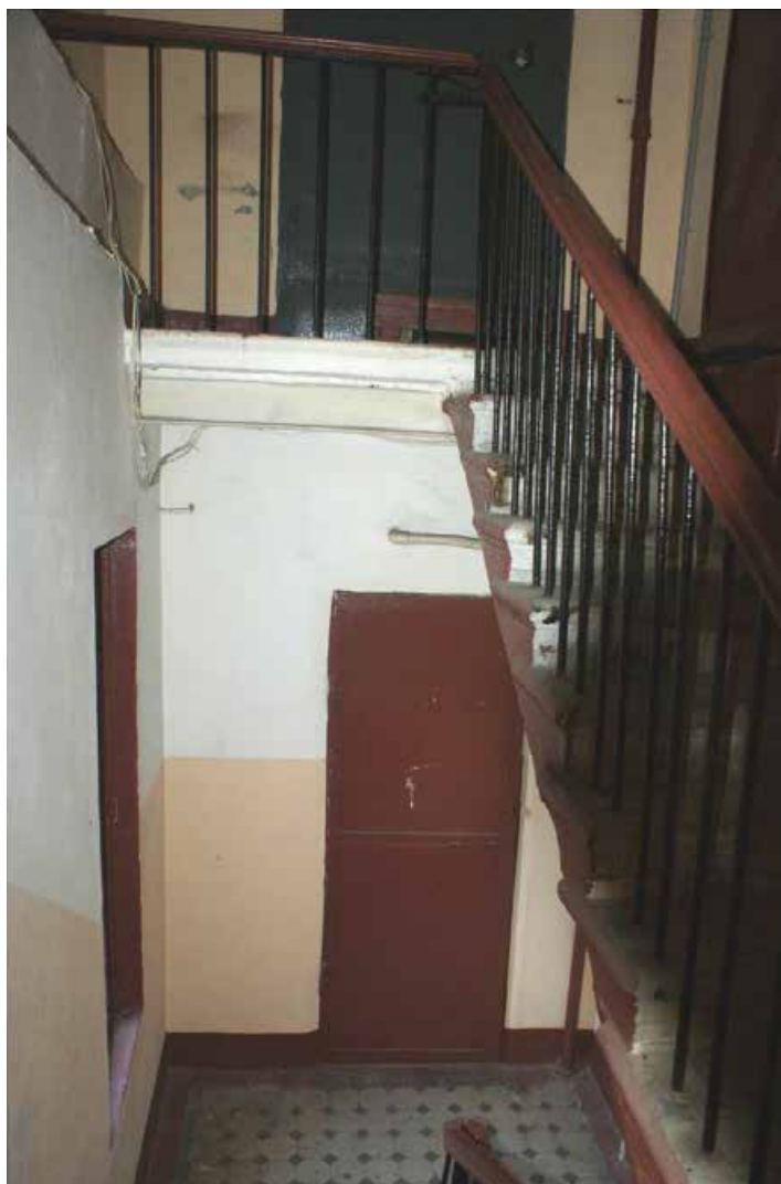
Фото 1 . Лестница № 3. 6-й этаж. Съемка 19.04.2021 г. Кириков Б. М.
