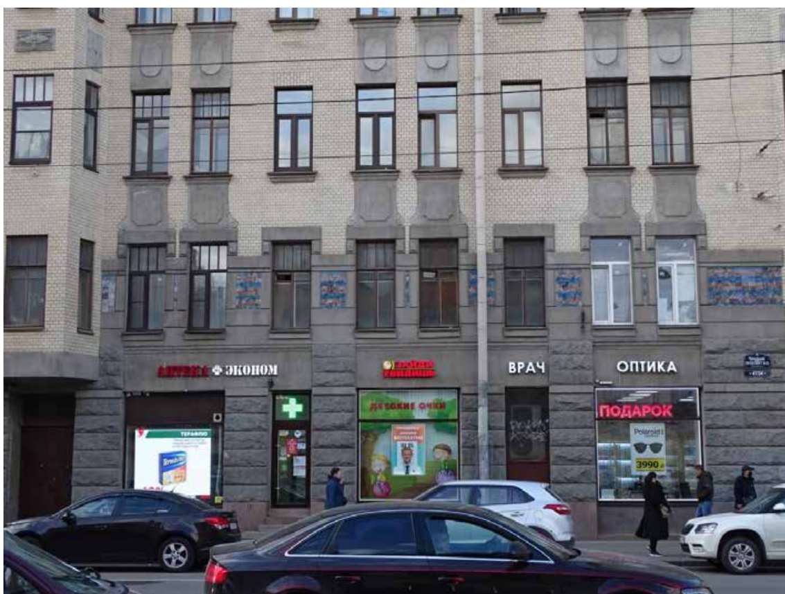
Фото 20. Здание по адресу: г. Санкт-Петербург, 11-я линия В. О., 34/47, литера А. Фрагмент фасада. Вид с Среднего пр. Съемка 19.04.2021 г. Кириков Б. М.
