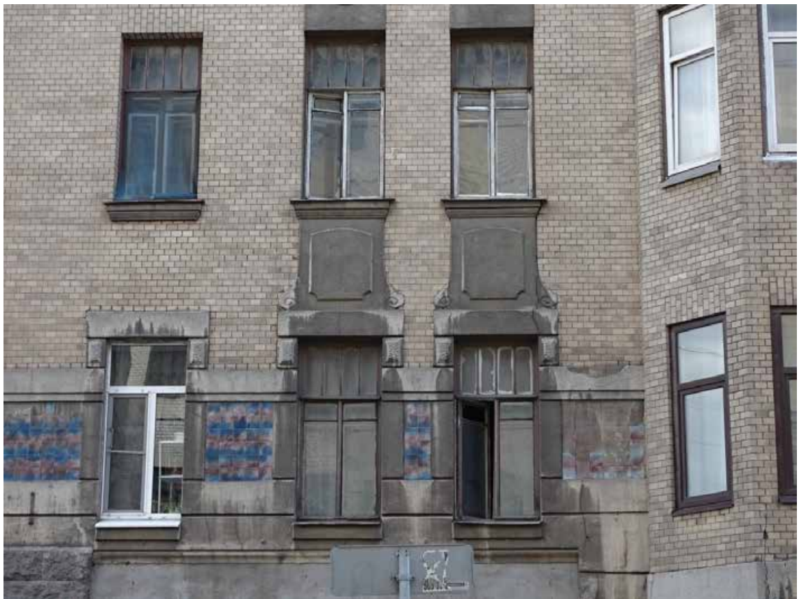
Фото 10. Здание по адресу: г. Санкт-Петербург, 11-я линия В. О., 34/47, литера А. Фрагмент фасада по 11-й линии. Съемка 19.04.2021 г. Кириков Б. М.
