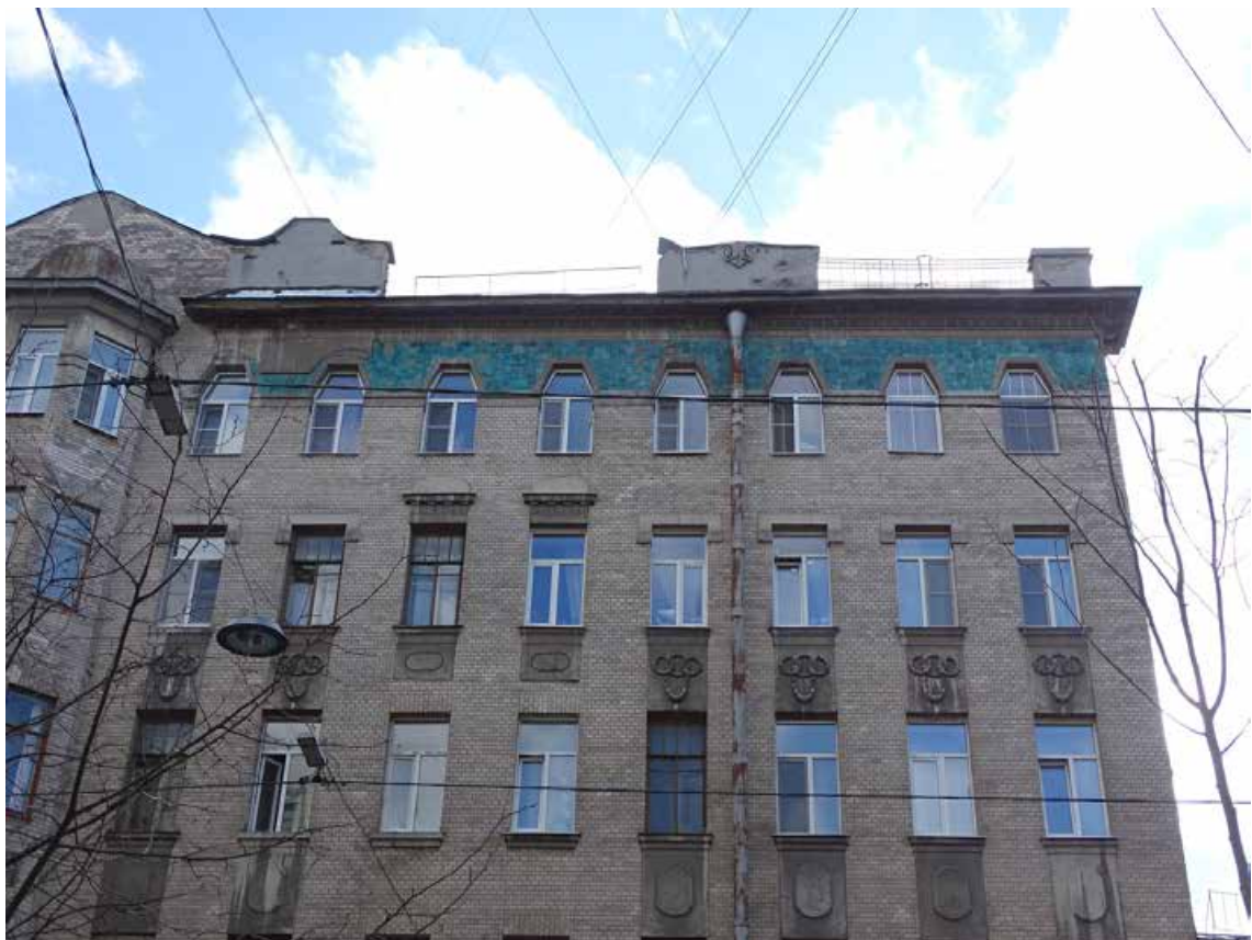
Фото 4. Здание по адресу: г. Санкт-Петербург, 11-я линия В. О., 34/47, литера А. Фрагмент фасада по 11-й линии. Съемка 19.04.2021 г. Кириков Б. М.
