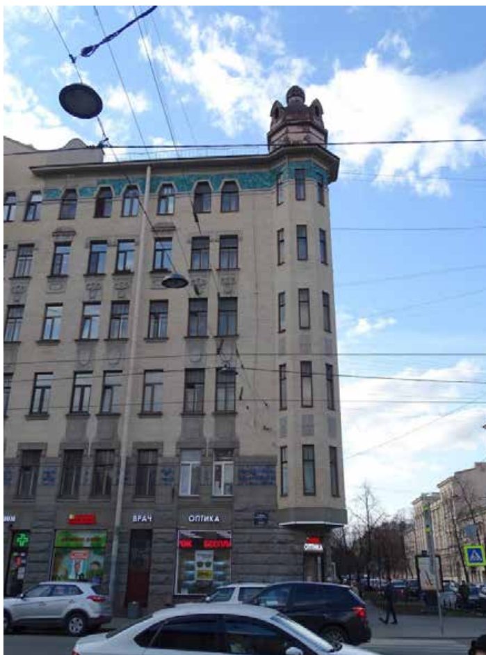
Фото 15. Здание по адресу: г. Санкт-Петербург, 11-я линия В. О., 34/47, литера А. Фрагмент фасада. Вид с Среднего пр. Съемка 19.04.2021 г. Кириков Б. М.
