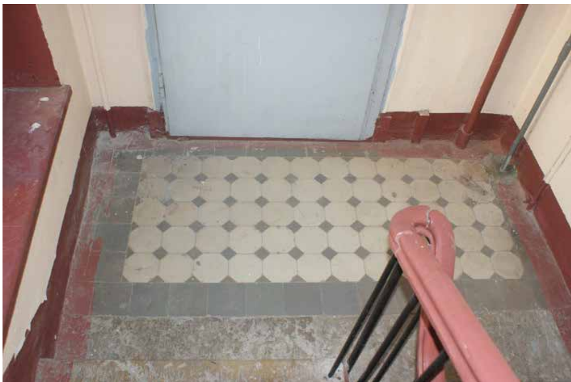
Фото 9 . Лестница № 3. 6-й этаж. Покрытие пола. Съёмка 19.04.2021 г. Кириков Б. М.
