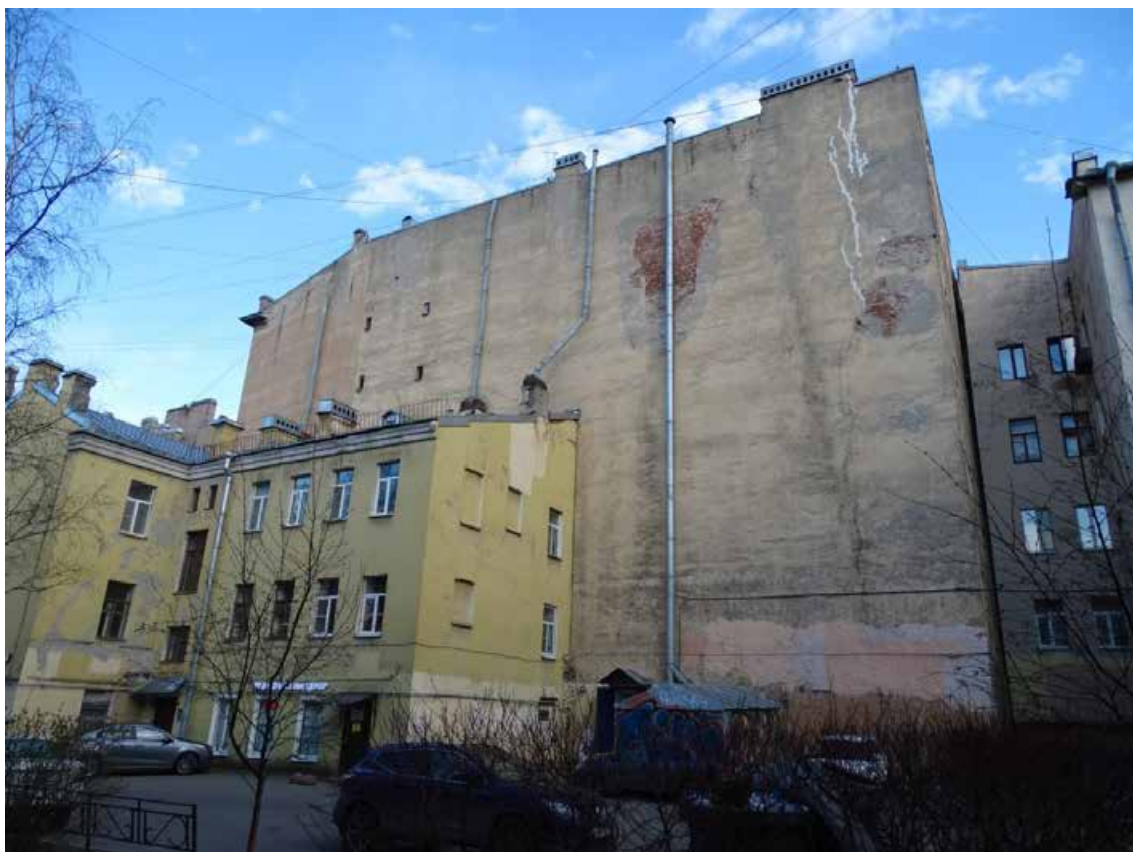
Фото 29. Здание по адресу: г. Санкт-Петербург, 11-я линия В. О., 34/47, литера А. Дворовые фасады. Съемка 19.04.2021 г. Кириков Б. М.
