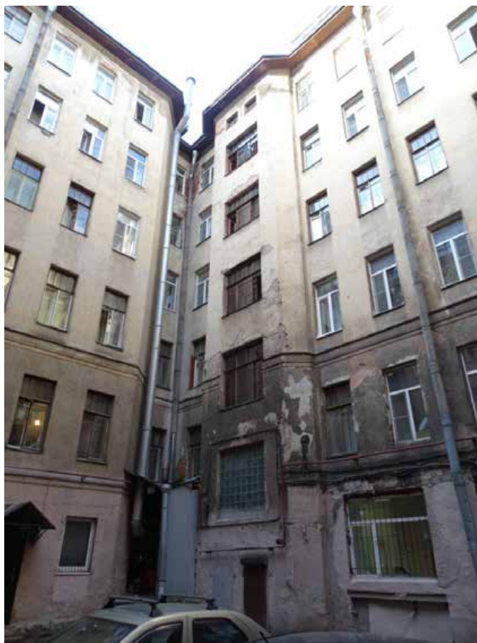
Фото 35. Здание по адресу: г. Санкт-Петербург, 11-я линия В. О., 34/47, литера А. Северо-восточный дворовой фасад. Съемка 19.04.2021 г. Кириков Б. М.
