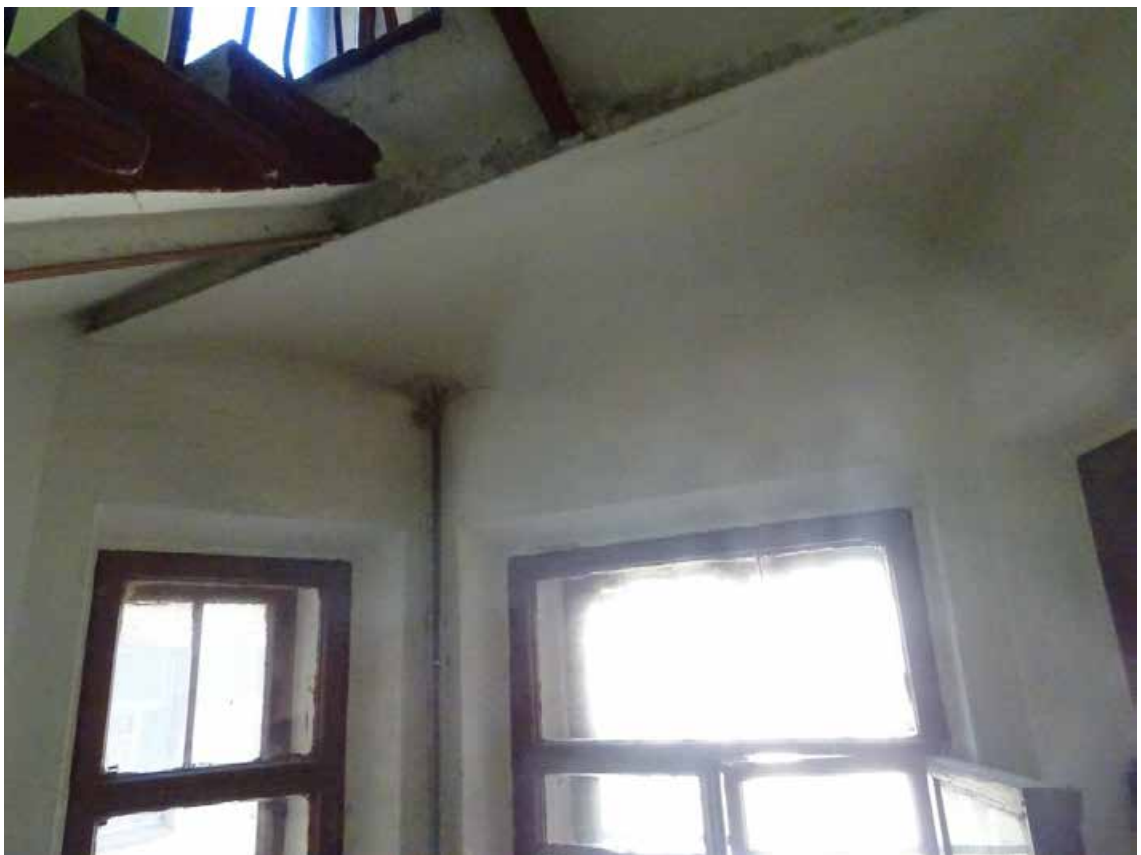
Фото 140. Лестница № 4. Площадка м/у 4-м и 5-м этажом. Свод. Съемка 19.04.2021 г. Кириков Б. М.
