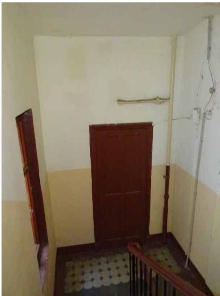
Фото 99. Лестница № 3. 4-й этаж. Съемка 19.04.2021 г. Кириков Б. М.
