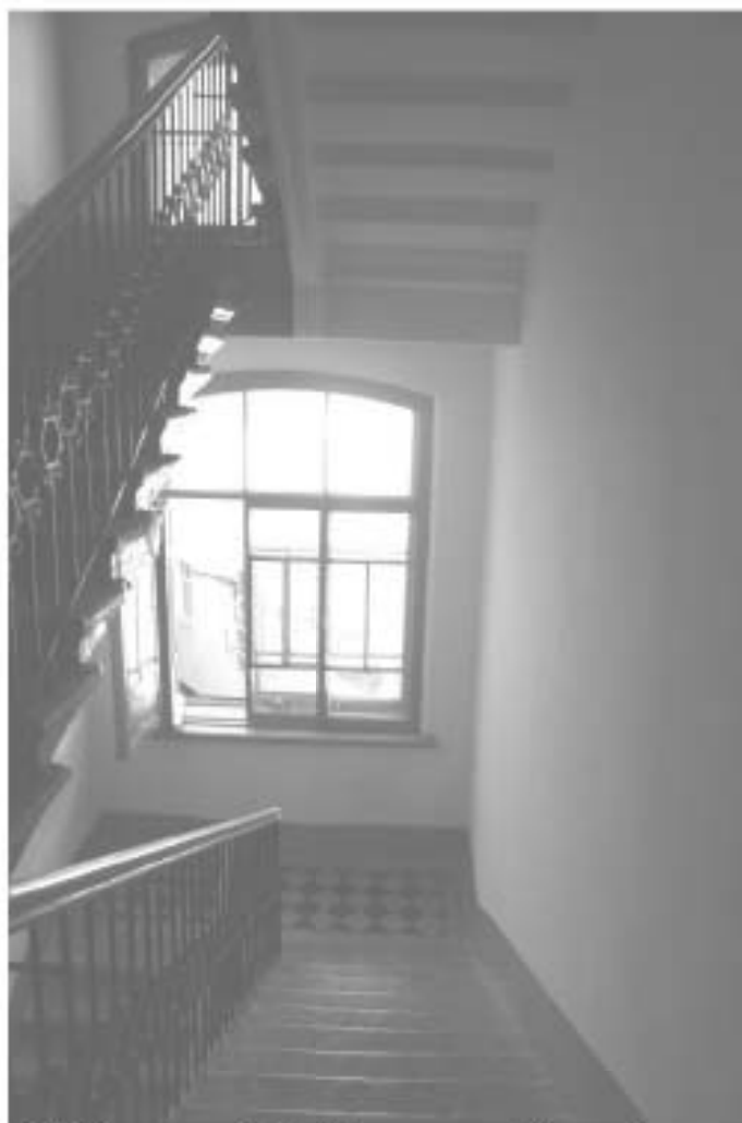
Фото 77. Лестница № 4. Площадка м/у 3-м и 4-м этажом. Съемка 19.04.2021 г. Трушковский В.Э.
