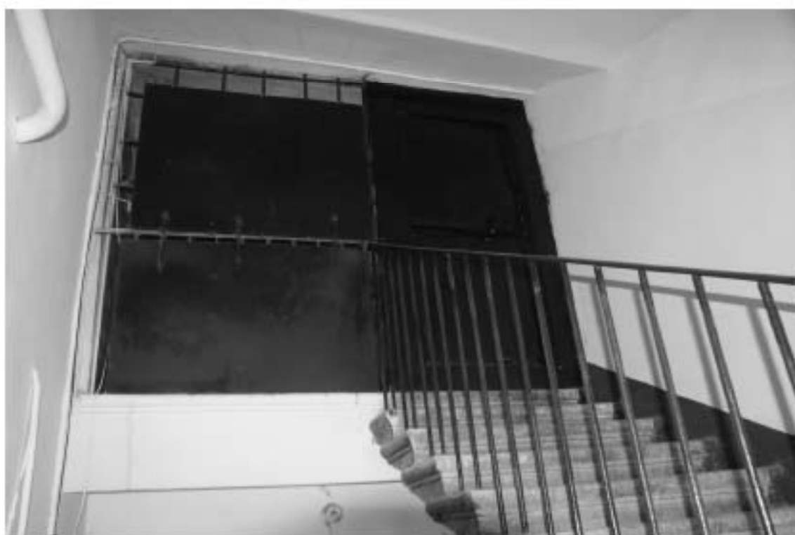
Фото 120. Лестница № 6. Площадка 5-го этажа. Чердак. Съемка 19.04.2021 г. Трушковский В.Э.
