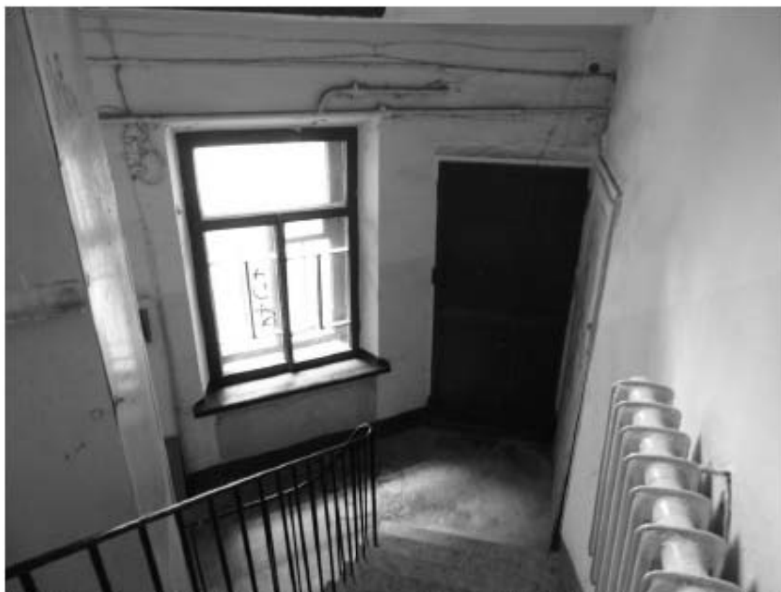
Фото 164. Лестница № 8. Площадка 3-го этажа. Съемка 19.04.2021 г. Трушковский В.Э.
