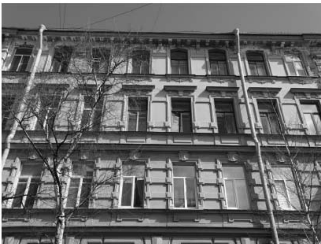
Фото 10. Здание по адресу: г. Санкт-Петербург, Тучков пер., 11/5, литера А. Фрагмент лицевого фасада со стороны Тучкова пер. 3-й, 4-й, 5-й этаж. Съемка 19.04.2021 г. Трушковский В.Э.
