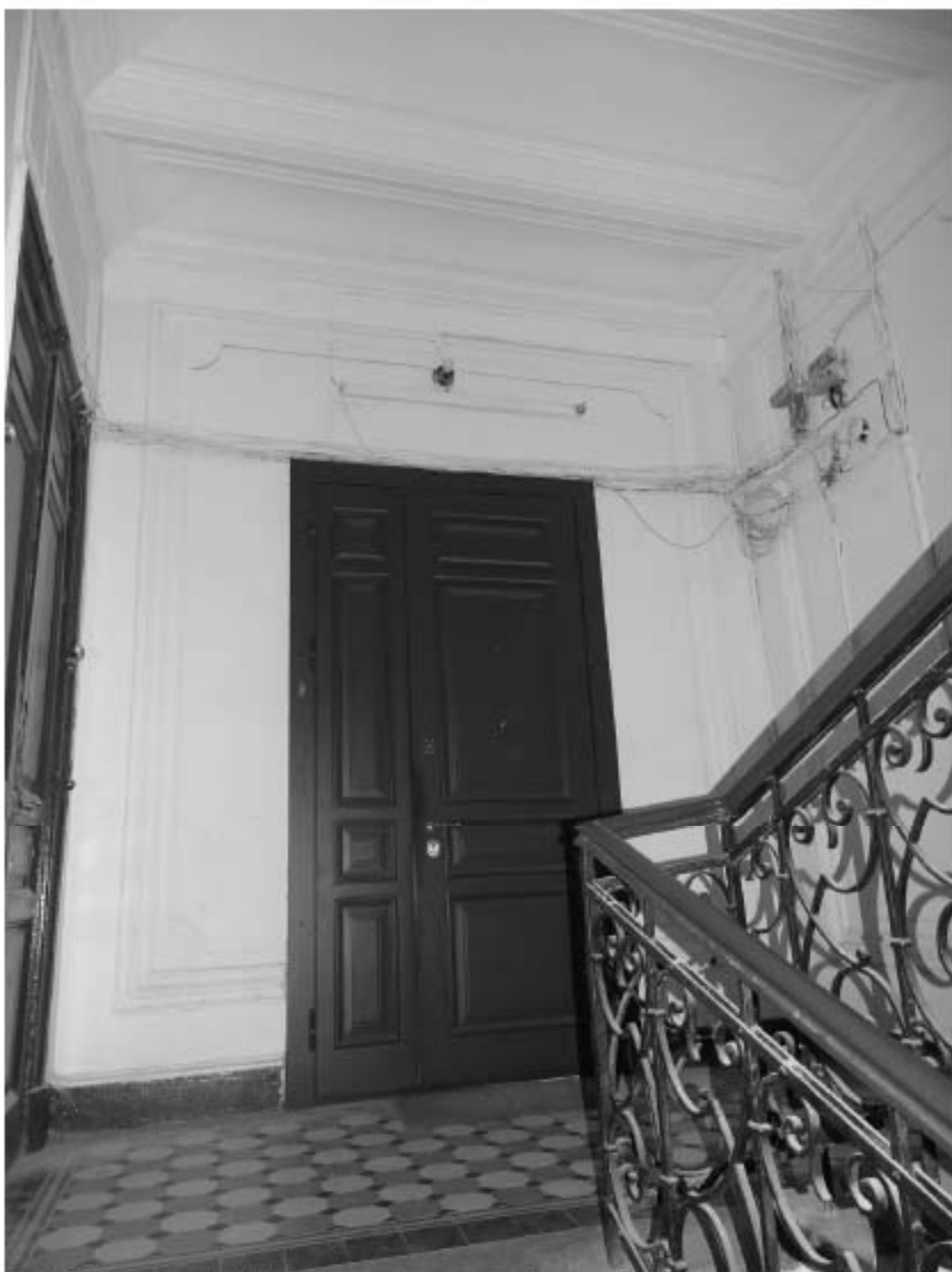
Фото 23. Лестница № 1. Площадка 2-го этажа. Съемка 19.04.2021 г. Трушковский В.Э.
