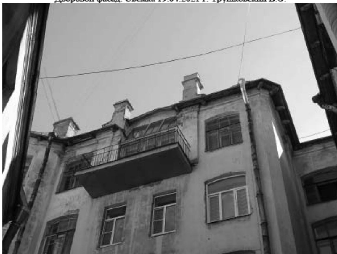
Фото 27. Здание по адресу: г. Санкт-Петербург, Тучков пер., 11/5, литера А. Фрагмент северо-западного дворового фасада. Балкон. Съемка 19.04.2021 г. Трушковский В.Э.
