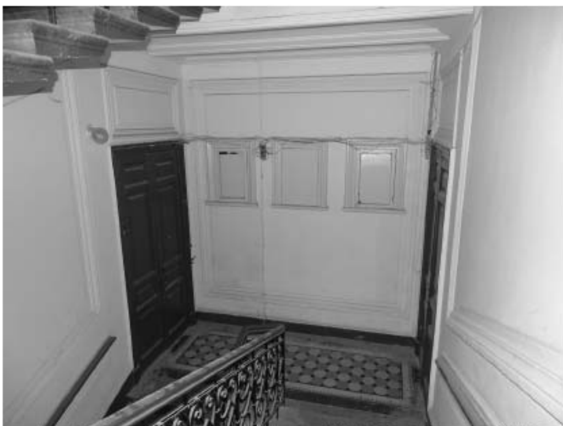
Фото 55. Лестница № 2. 3-й этаж. Съемка 19.04.2021 г. Трушковский В.Э.
