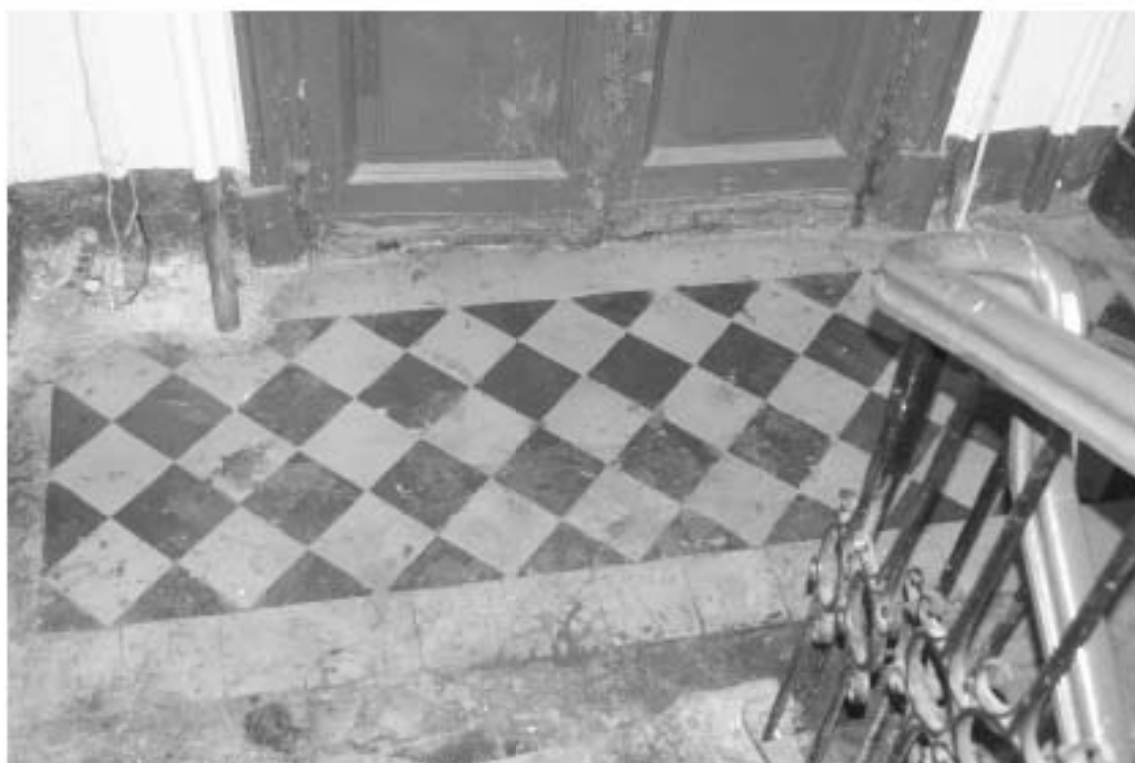
Фото 141. Лестница № 7. Площадка 4-го этажа. Покрытие пола. Съемка 19.04.2021 г. Трушковский В.Э.
