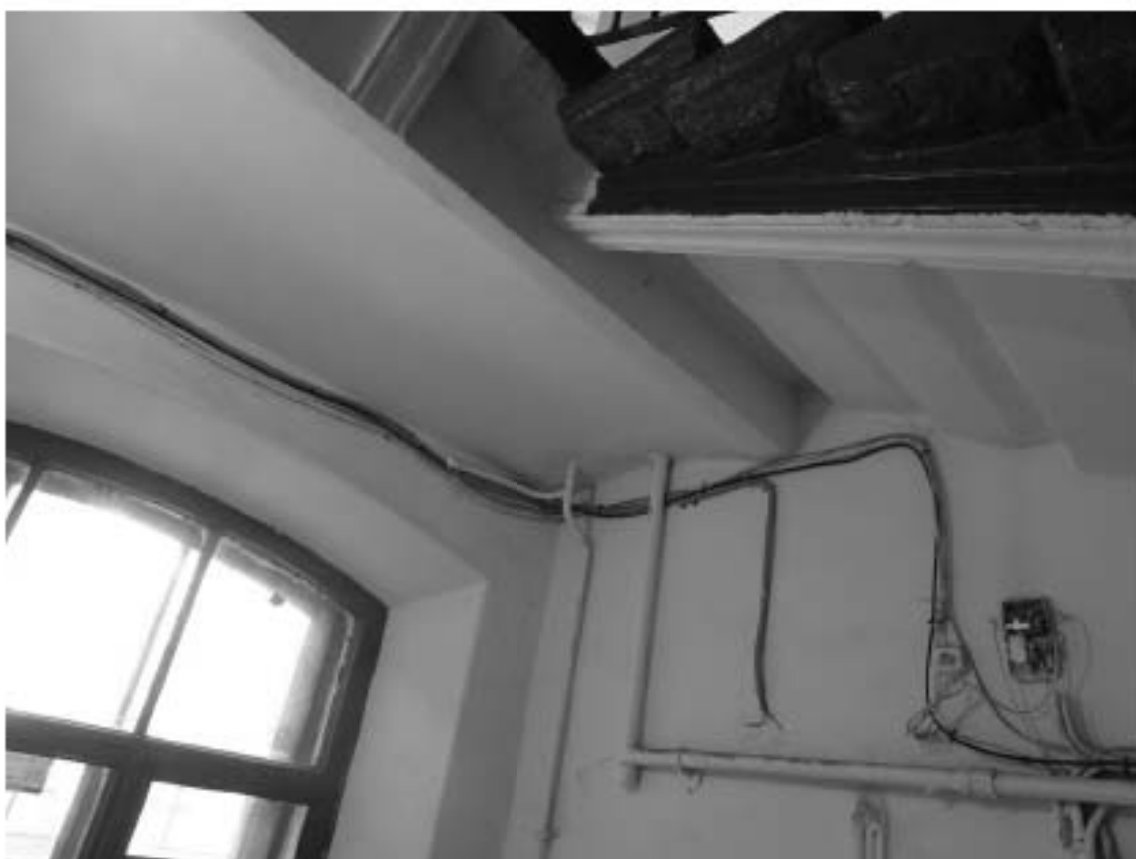
Фото 126. Лестница № 7. Вестибюль 1-й этаж. Съёмка 19.04.2021 г. Трушковский В.Э.
