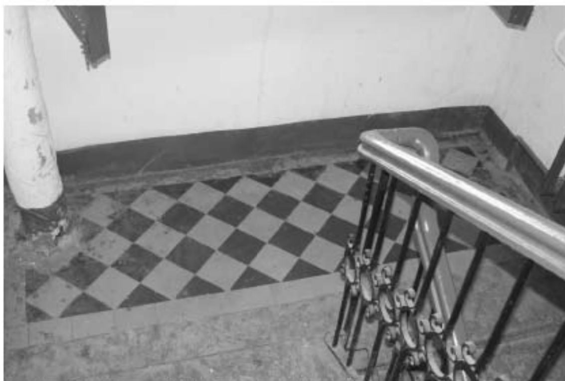
Фото 139. Лестница № 7. Площадка м/у 3-м и 4-м этажом. Покрытие пола. Съемка 19.04.2021 г. Трушковский В.Э.
