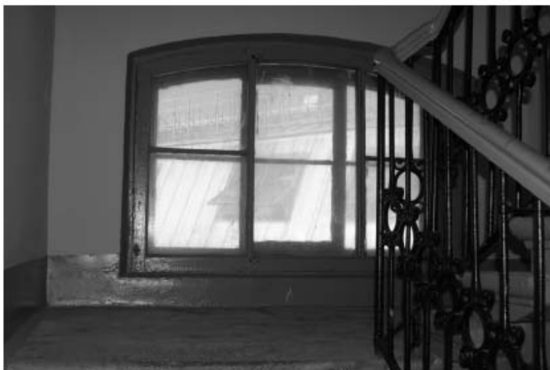
Фото 81. Лестница № 4. Площадка м/у 4-м и 5-м этажом. Съемка 19.04.2021 г. Трушковский В.Э.
