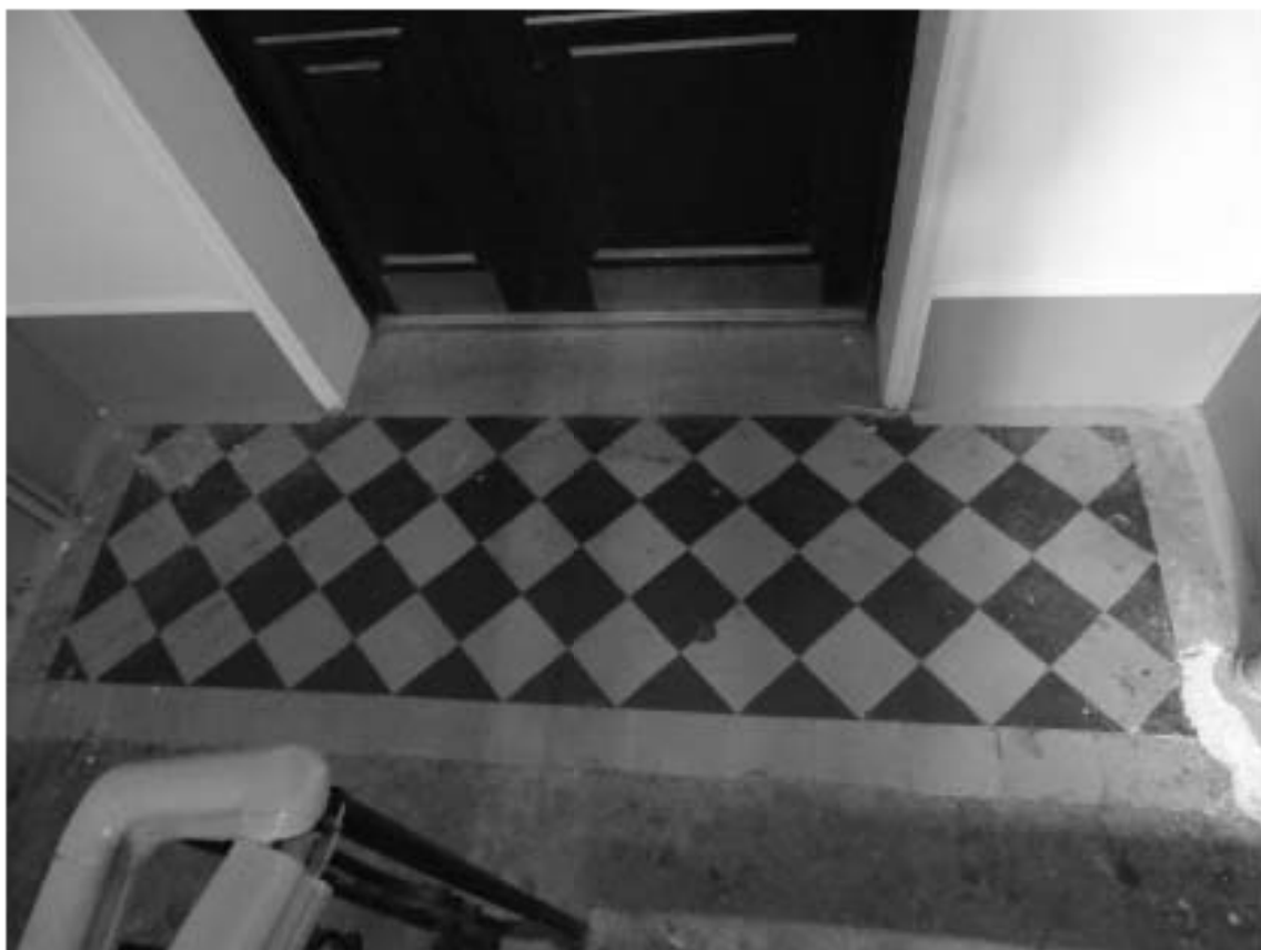
Фото 69. Лестница № 4. Площадка 1-го этажа. Покрытие пола. Съемка 19.04.2021 г. Трушковский В.Э.
