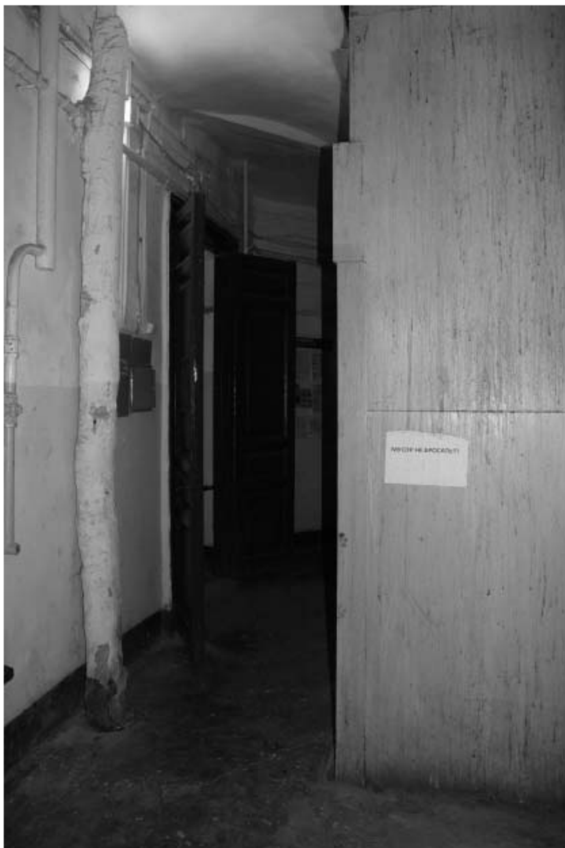
Фото 155. Лестница № 8. Вестибюль 1-го этажа. Съемка 19.04.2021 г. Трушковский В.Э.
