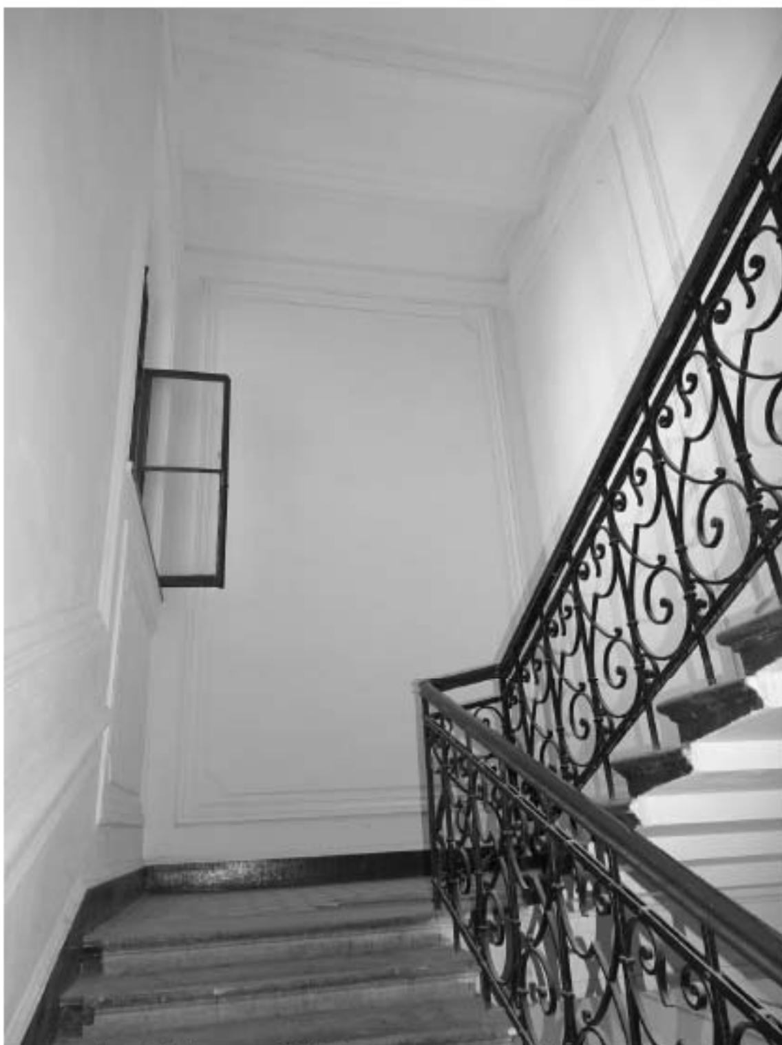
Фото 28. Лестница № 1. Вид на площадку м/у 3-м и 4-м этажом. Съемка 19.04.2021 г. Трушковский В.Э.
