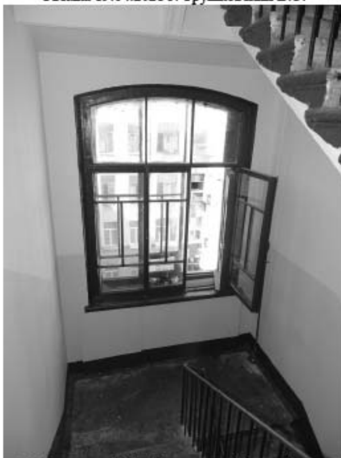
Фото 99. Лестница № 5. Площадка м/у 3-м и 4-м этажом. Съемка 19.04.2021 г. Трушковский В.Э.
