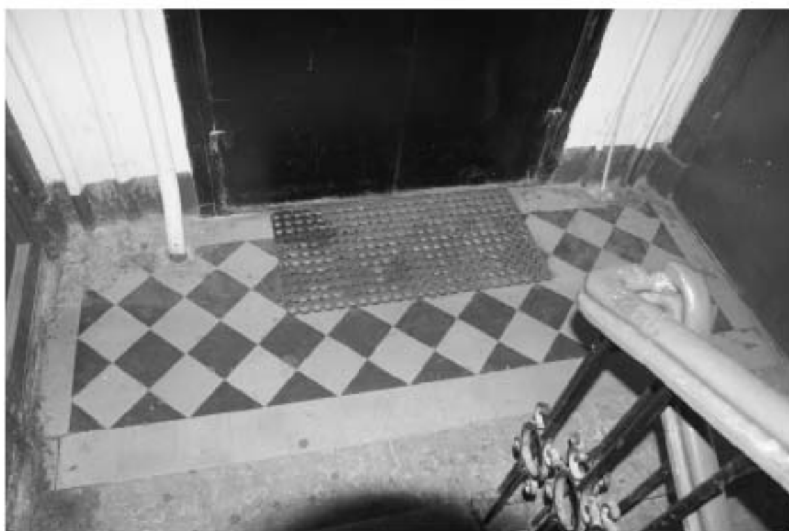
Фото 134. Лестница № 7. Площадка 3-го этажа. Покрытие пола. Съемка 19.04.2021 г. Трушковский В.Э.
