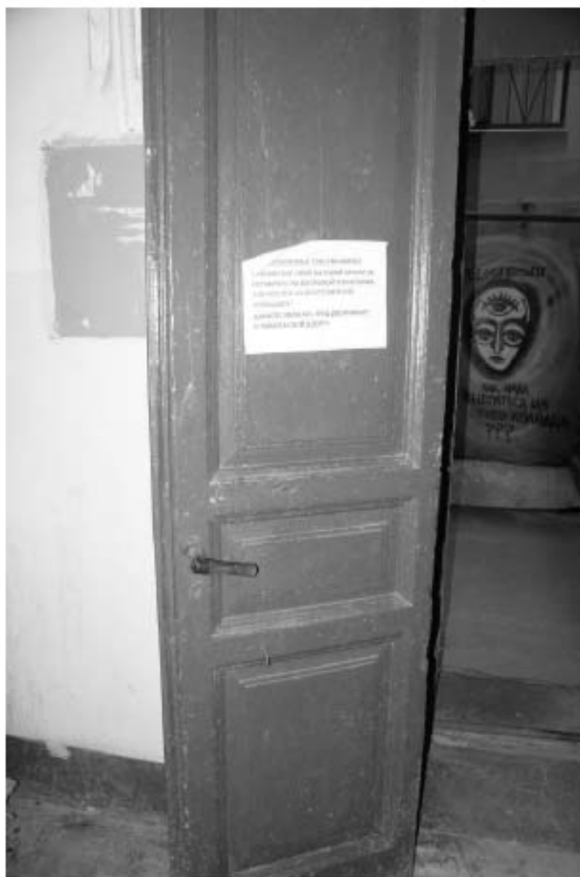
Фото 149. Лестница № 8. Вестибюль 1-го этажа. Входная дверь. Съемка 19.04.2021 г. Трушковский В.Э.
