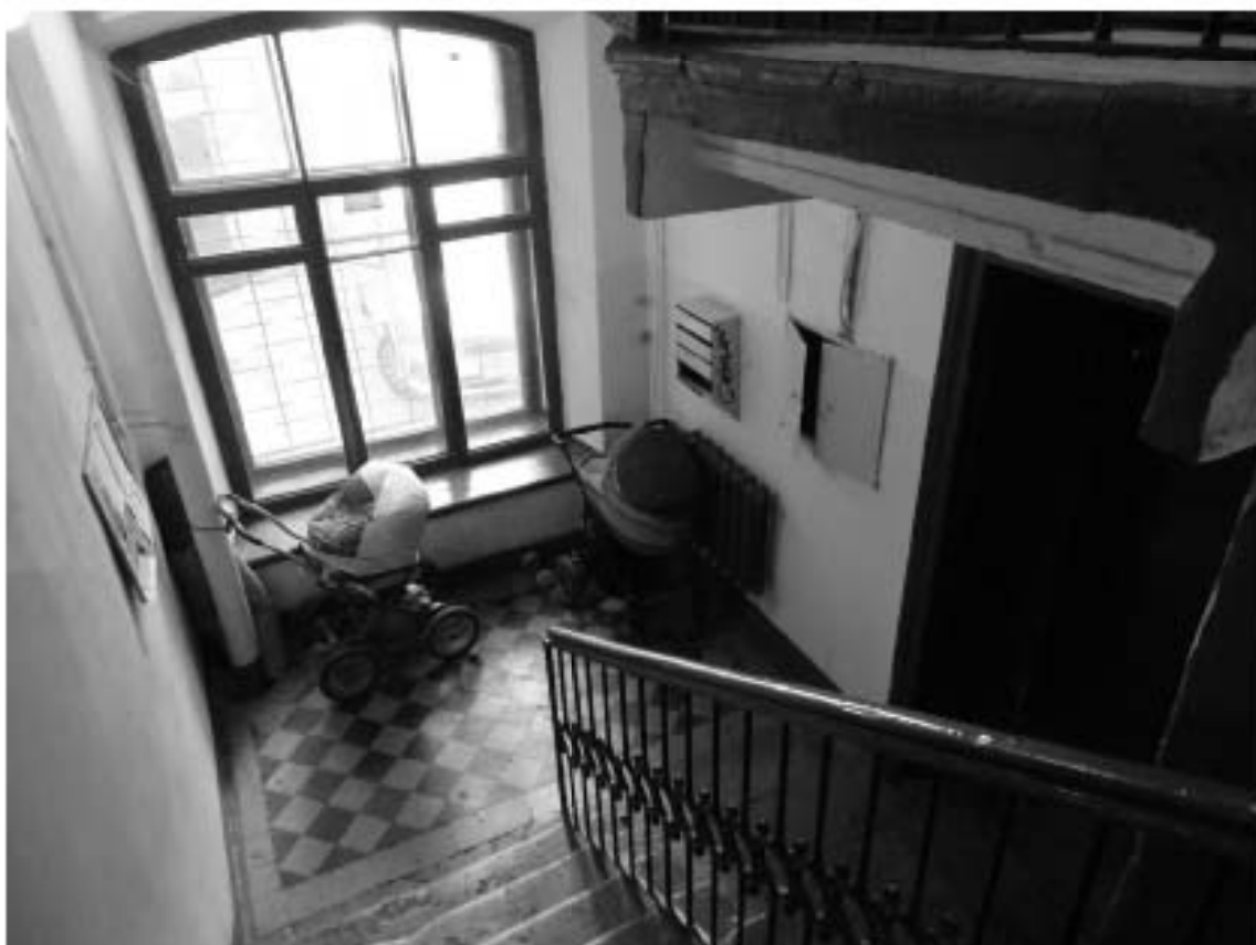
Фото 125. Лестница № 7. Вестибюль. 1-й этаж. Съемка 19.04.2021 г. Трушковский В.Э.
