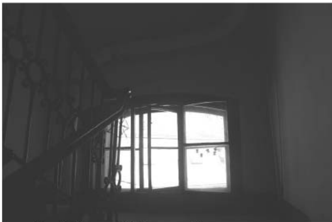
Фото 143. Лестница № 7. Площадка м/у 5-м и чердачным этажом. Съемка 19.04.2021 г. Трушковский В.Э.
