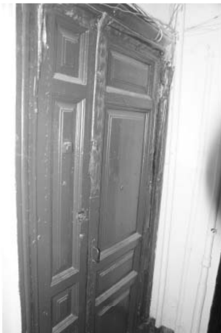
Фото 135. Лестница № 7. Площадка 3-го этажа. Дверное заполнение. Съемка 19.04.2021 г. Трушковский В.Э.
