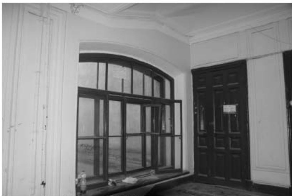
Фото 45. Лестница № 2. Площадка между 1-м и 2-м этажом. Съемка 19.04.2021 г. Трушковский В.Э.
