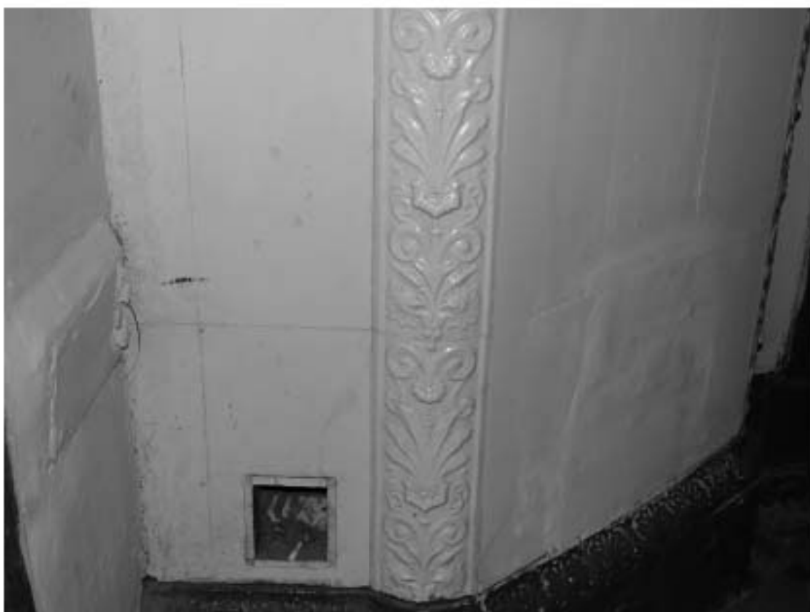
Фото 63. Лестница № 3. 1-й этаж. Рельефные растительные орнаменты на ребрах печи. Съемка 19.04.2021 г. Трушковский В.Э.
