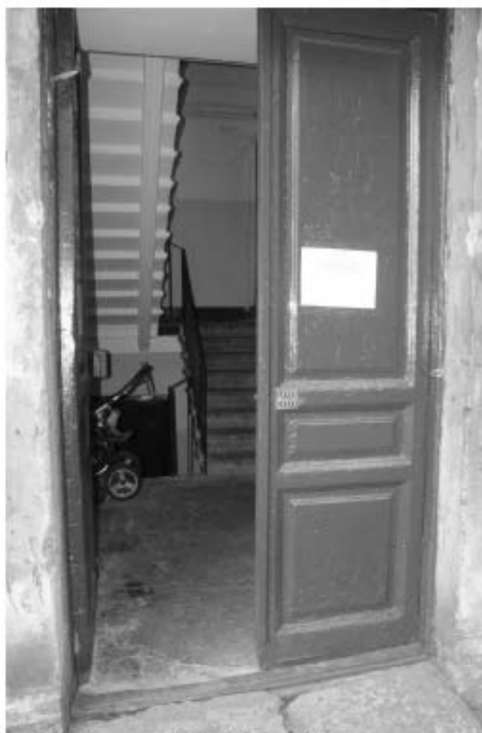
Фото 84. Лестница № 5. 1-й этаж. Дверное заполнение. Съемка 19.04.2021 г. Трушковский В.Э.
