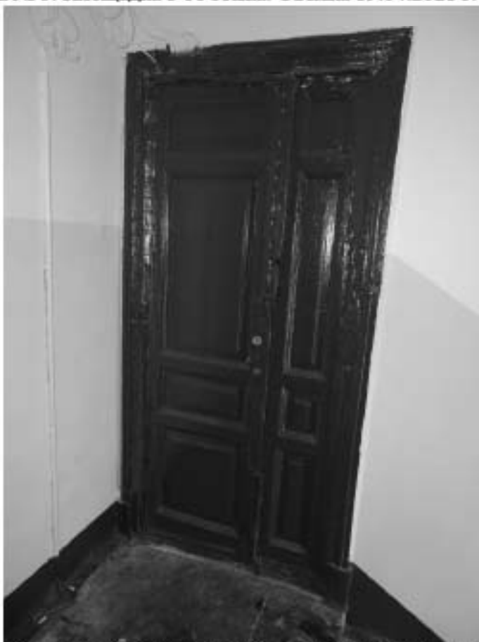
Фото 97. Лестница № 5. Площадка 3-го этажа. Дверное заполнение. Съемка 19.04.2021 г. Трушковский В.Э.
