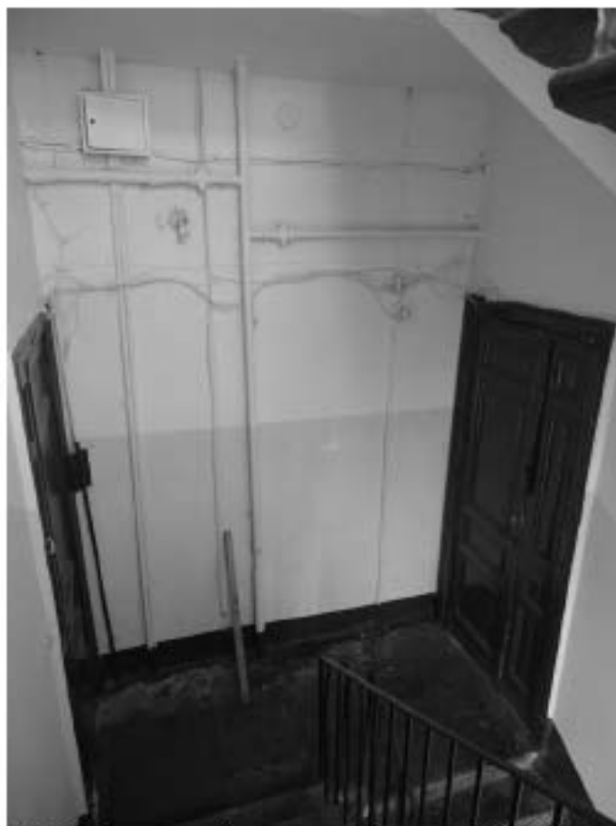
Фото 96. Лестница № 5. Площадка 3-го этажа. Съемка 19.04.2021 г. Трушковский В.Э.
