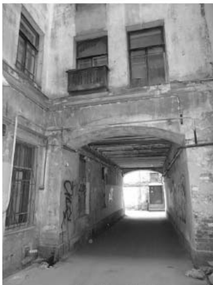
Фото 37. Здание по адресу: г. Санкт-Петербург, Тучков пер., 11/5, литера А. Воротный проезд в северо-западный двор. Съемка 19.04.2021 г. Трушковский В.Э.
