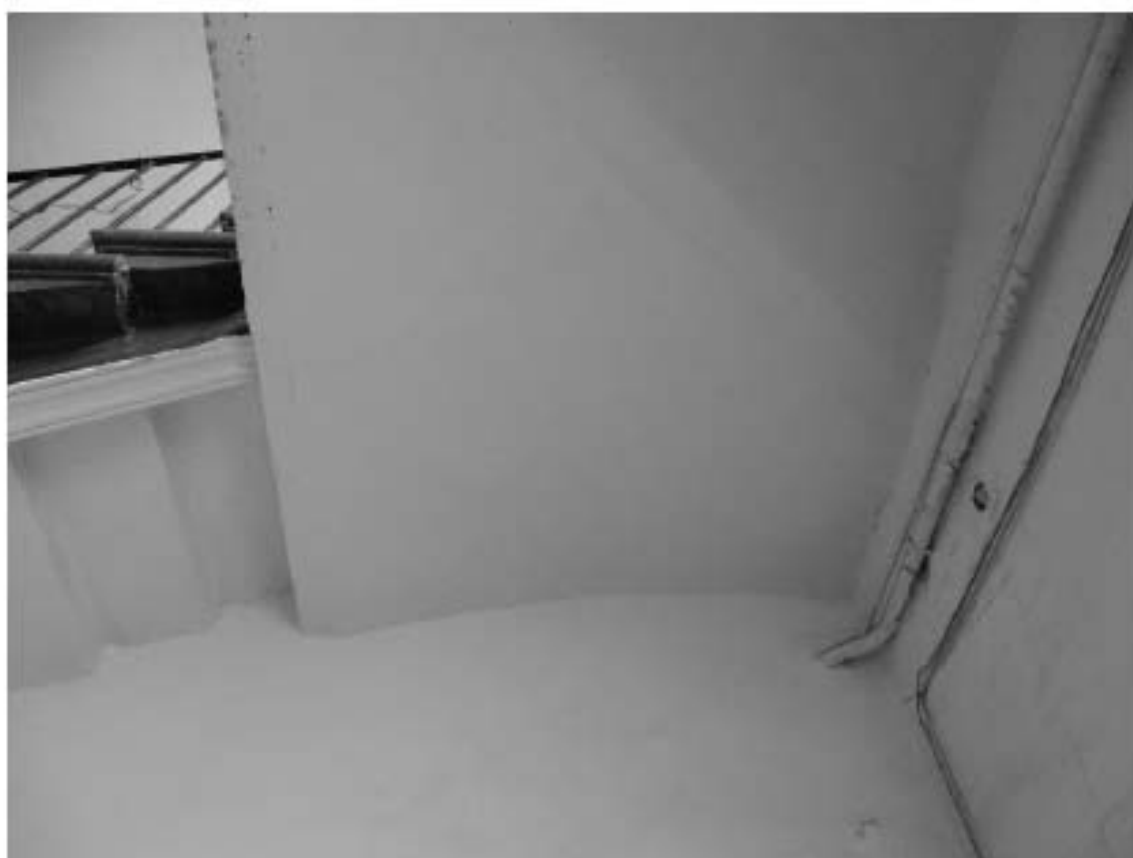
Фото 180. Лестница № 7. Площадка 5-го этажа. Съемка 19.04.2021 г. Трушковский В.Э.
