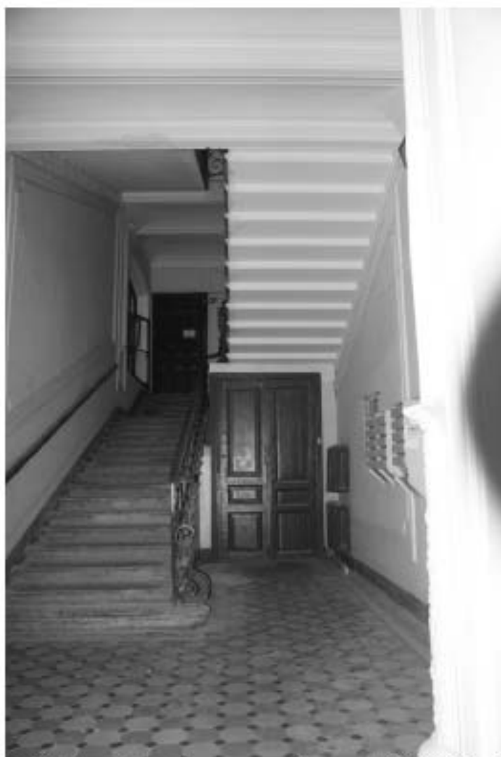
Фото 41. Лестница № 2. Вестибюль 1-го этажа. Съемка 19.04.2021 г. Трушковский В.Э.
