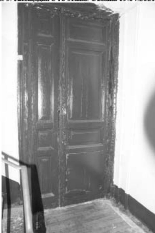
Фото 93. Лестница № 5. Площадка 2-го этажа. Дверное заполнение. Съемка 19.04.2021 г. Трушковский В.Э.
