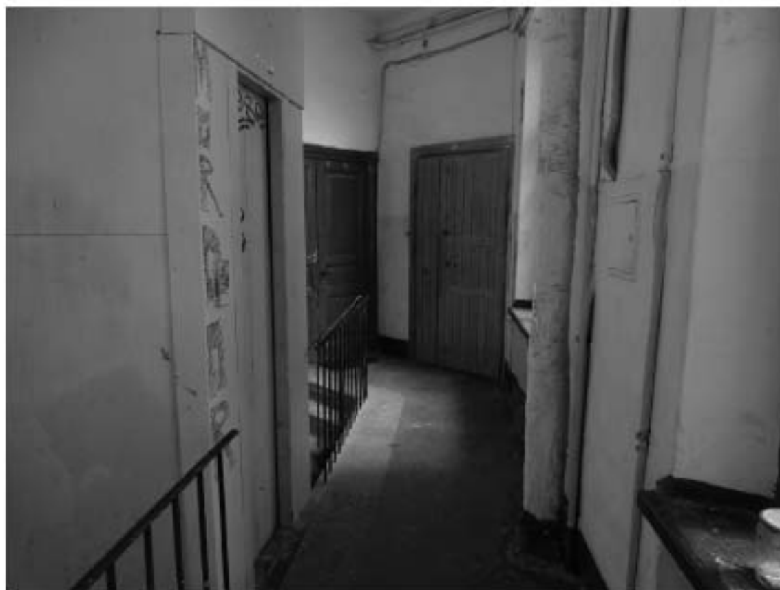
Фото 178. Лестница № 8. Площадка 5-го этажа. Съемка 19.04.2021 г. Трушковский В.Э.
