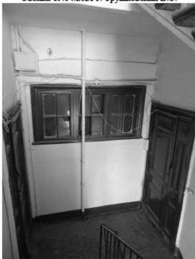
Фото 114. Лестница № 6. Площадка 3-го этажа. Съемка 19.04.2021 г. Трушковский В.Э.
