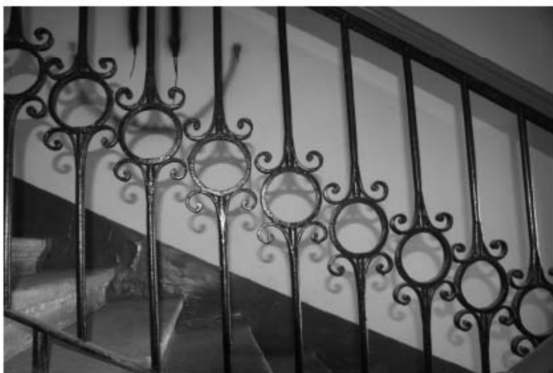
Фото 142. Лестница № 7. Площадка 4-го этажа. Лестничное ограждение. Съемка 19.04.2021 г. Трушковский В.Э.
