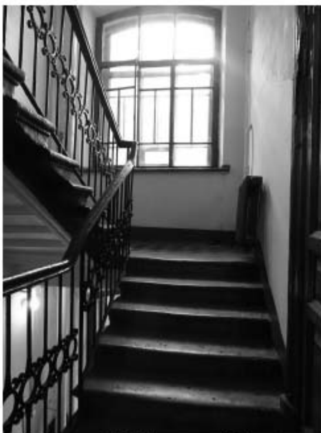
Фото 130. Лестница № 7. Площадка м/у 1-м и 2-м этажом. Съемка 19.04.2021 г. Трушковский В.Э.
