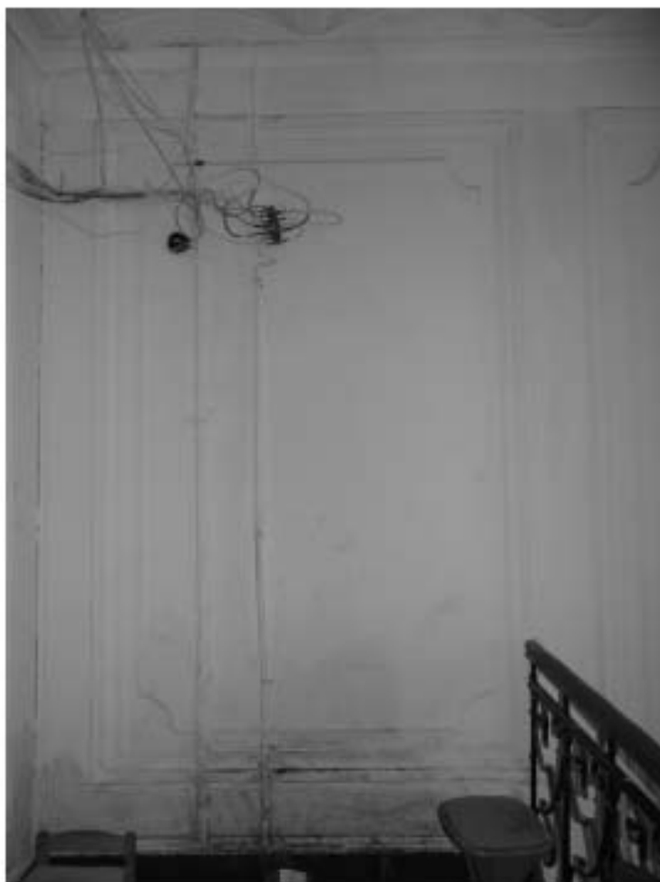
Фото 33. Лестница № 1. Площадка. 4-го этажа. Съемка 19.04.2021 г. Трушковский В.Э.
