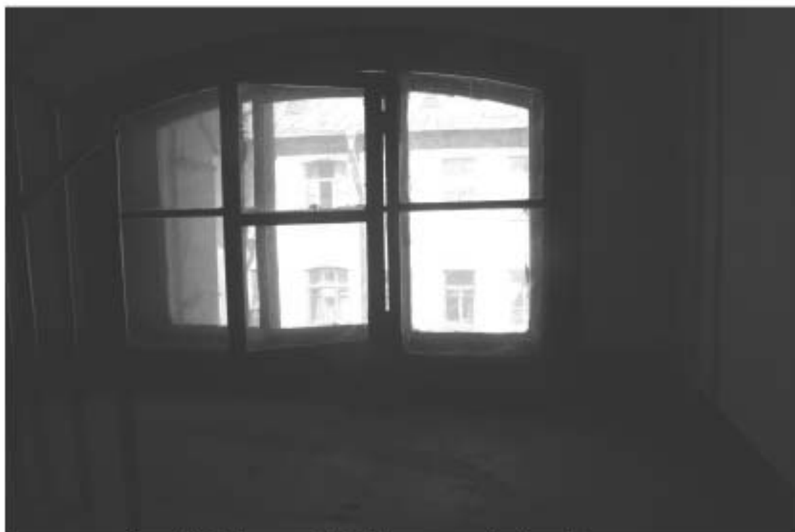
Фото 119. Лестница № 6. Площадка м/у 4-м и 5-м этажом. Съемка 19.04.2021 г. Трушковский В.Э.
