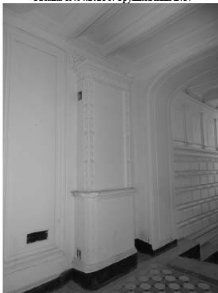
Фото 12. Лестница № 1. Вестибюль 1-го этажа. Оформление стен. Съемка 19.04.2021 г. Трушковский В.Э.
