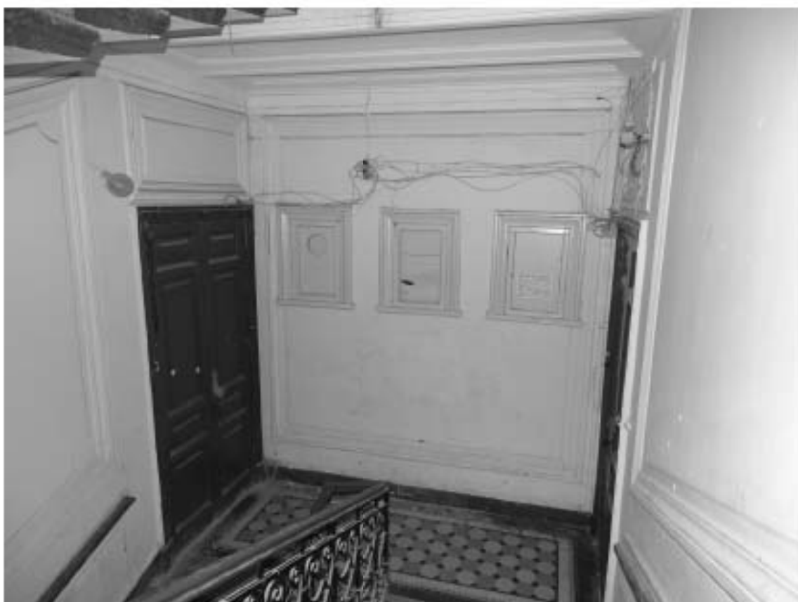
Фото 52. Лестница № 2. 2-й этаж. Съёмка 19.04.2021 г. Трушковский В.Э.
