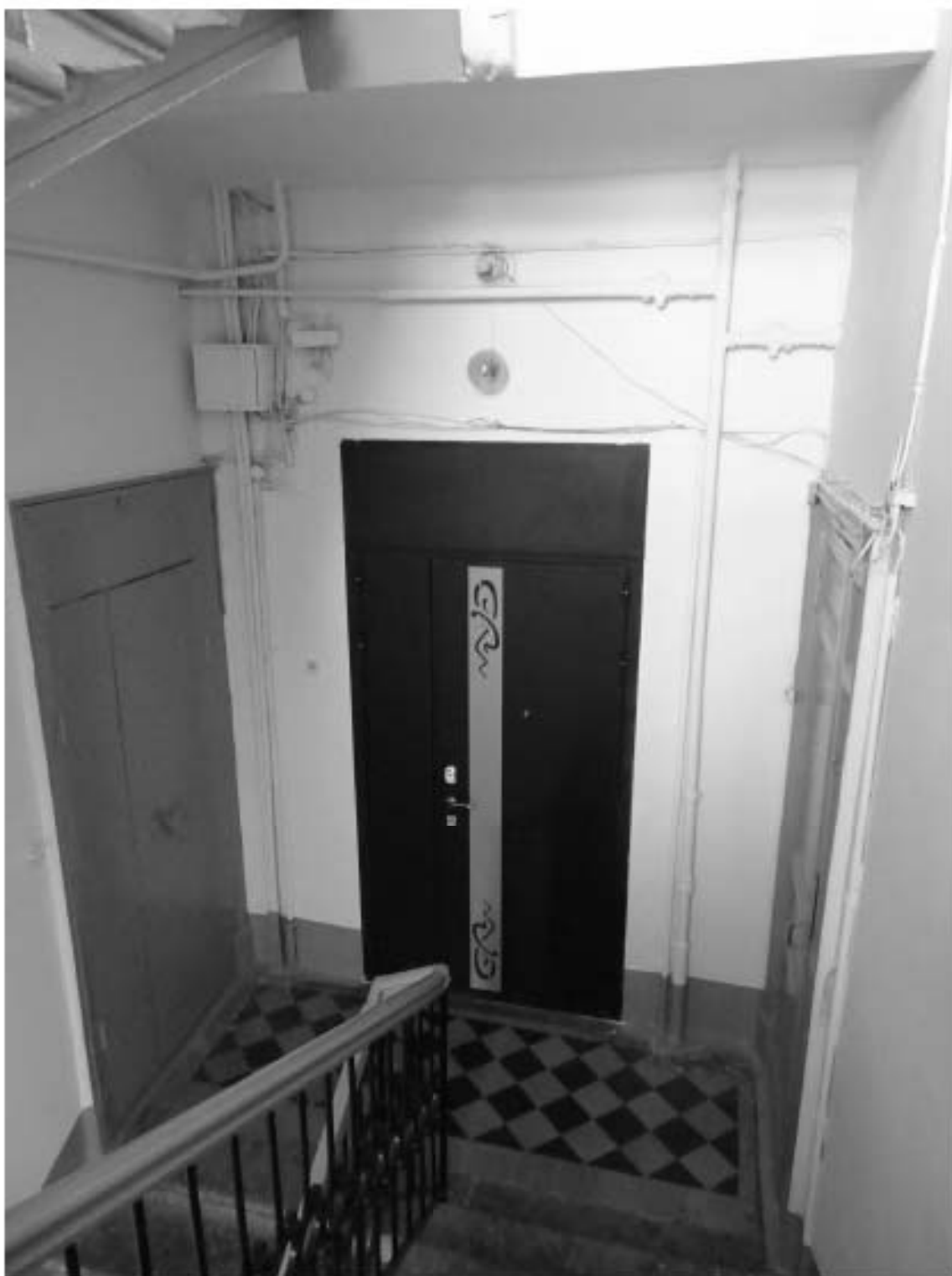
Фото 76. Лестница № 4. Площадка 3-го этажа. Съемка 19.04.2021 г. Трушковский В.Э.
