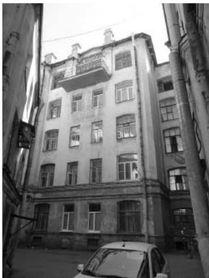
Фото 26. Здание по адресу: г. Санкт-Петербург, Тучков пер., 11/5, литера А. Дворовой фасад. Съемка 19.04.2021 г. Трушковский В.Э.
