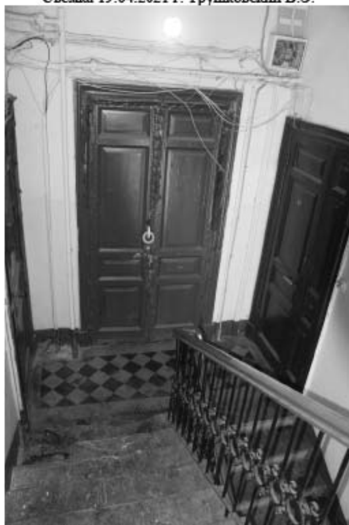
Фото 140. Лестница № 7. Площадка 4-го этажа. Съемка 19.04.2021 г. Трушковский В.Э.
