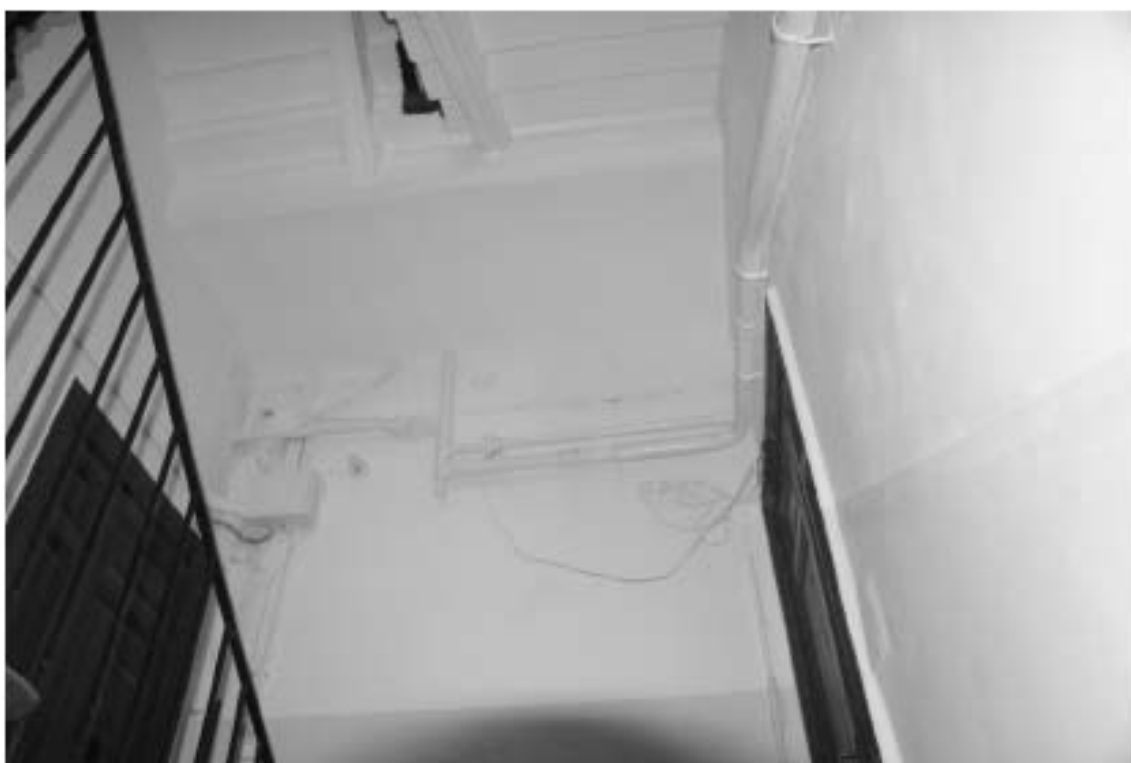
Фото 89. Лестница № 5. Площадка 1-го этажа. Оформление потолка. Съемка 19.04.2021 г. Трушковский В.Э.
