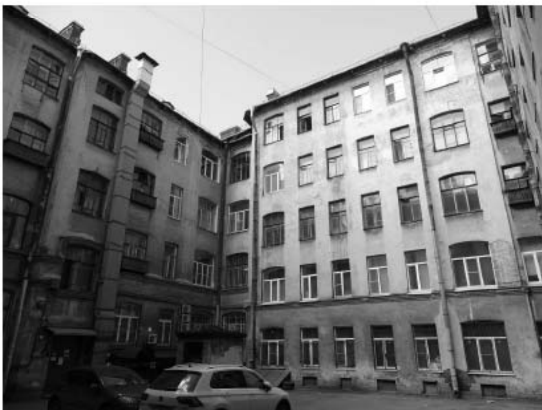
Фото 54. Здание по адресу: г. Санкт-Петербург, Тучков пер., 11/5, литера А. Дворовой фасад лицевого корпуса. Съемка 19.04.2021 г. Трушковский В.Э.
