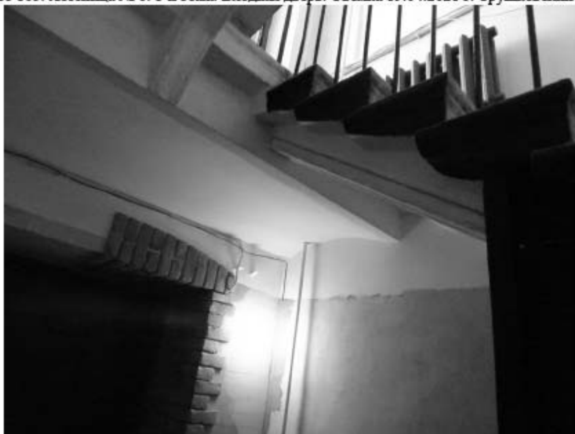
Фото 106. Лестница № 6. 1-й этаж. Съемка 19.04.2021 г. Трушковский В.Э.
