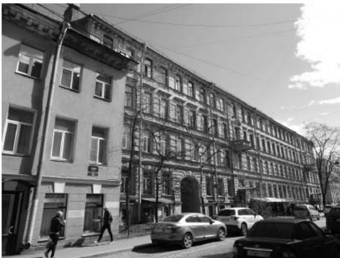
Фото 9. Здание по адресу: г. Санкт-Петербург, Тучков пер., 11/5, литера А. Вид на лицевой фасад со стороны Тучкова пер. Съемка 19.04.2021 г. Трушковский В.Э.
