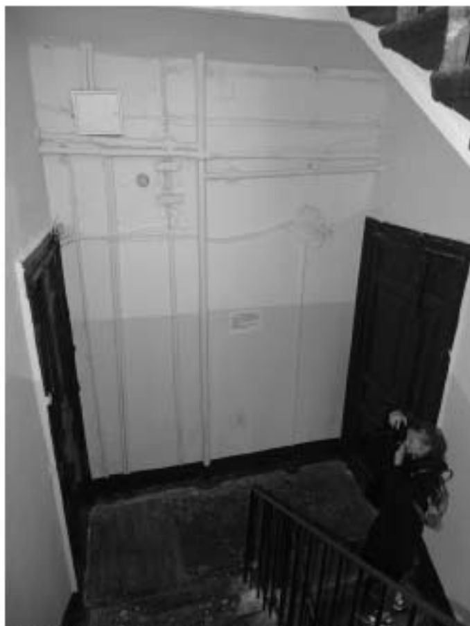
Фото 94. Лестница № 5. Площадка 2-го этажа. Съемка 19.04.2021 г. Трушковский В.Э.
