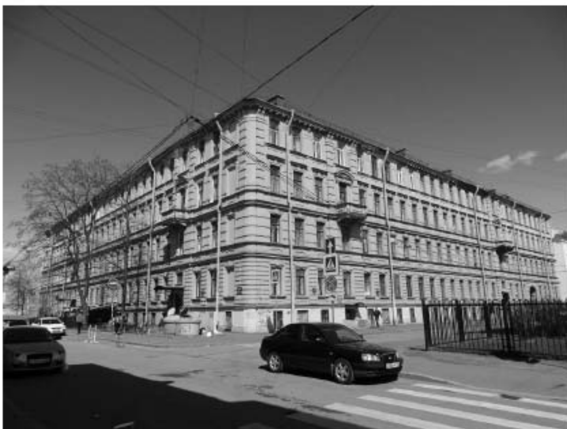
Фото 1. Здание по адресу: г. Санкт-Петербург, Тучков пер., 11/5, литера А. Вид с пересечения Тучкова и Волховского пер. Съемка 19.04.2021 г. Трушковский В.Э.
