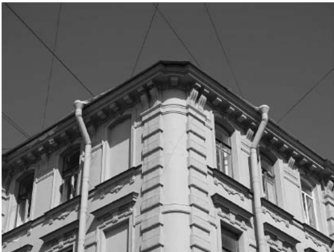
Фото 3. Здание по адресу: г. Санкт-Петербург, Тучков пер., 11/5, литера А. Вид с пересечения Тучкова и Волховского пер. Декорированный карниз. Съемка 19.04.2021 г. Трушковский В.Э.
