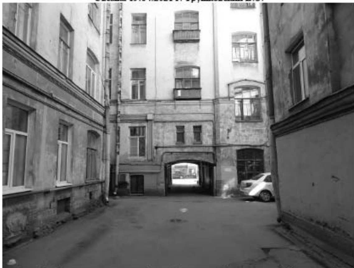
Фото 31. Здание по адресу: г. Санкт-Петербург, Тучков пер., 11/5, литера А. Фрагмент северо-западного дворового фасада. Съемка 19.04.2021 г. Трушковский В.Э.
