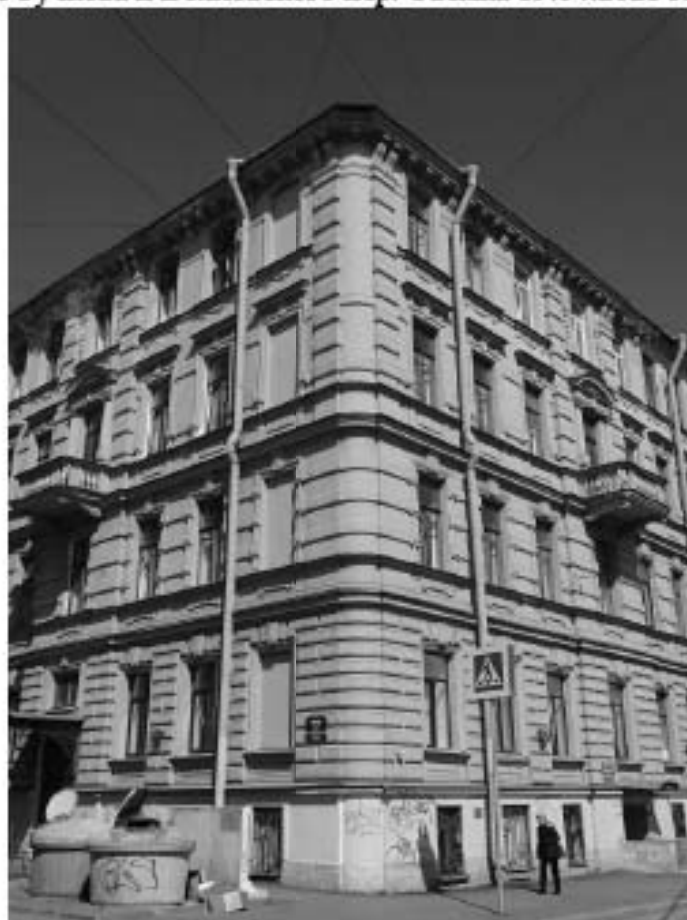
Фото 2. Здание по адресу: г. Санкт-Петербург, Тучков пер., 11/5, литера А. Вид с пересечения Тучкова и Волховского пер. Съемка 19.04.2021 г. Трушковский В.Э.
