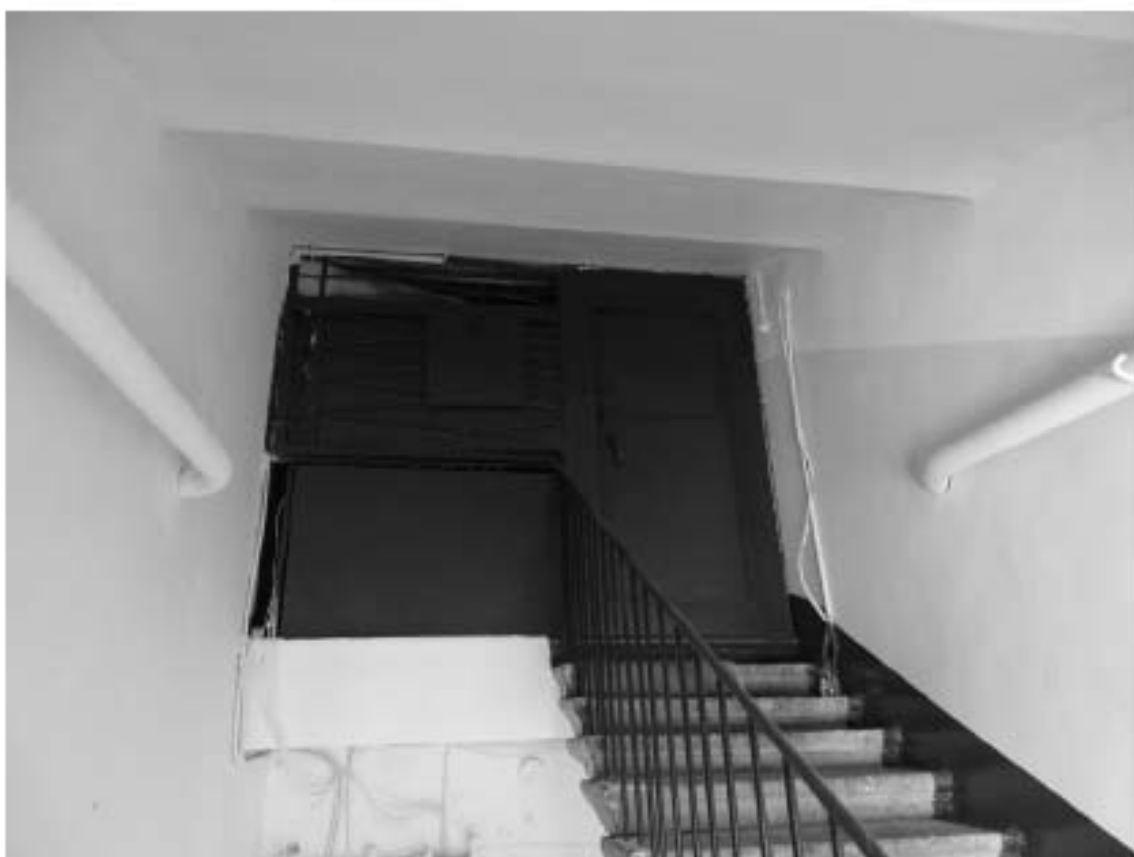
Фото 104. Лестница № 5. 6 этаж. Съёмка 19.04.2021 г. Трушковский В.Э.
