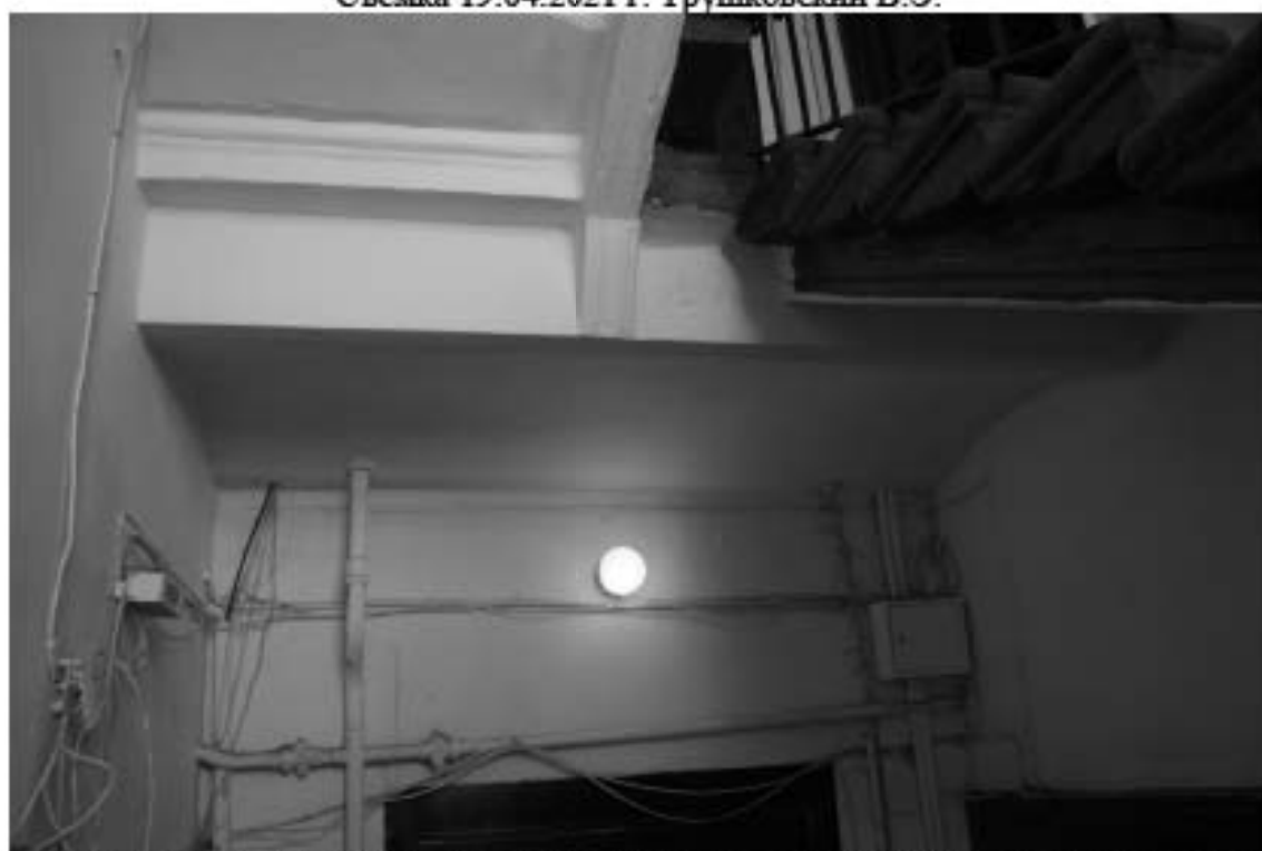
Фото 136. Лестница № 7. Площадка 3-го этажа. Съемка 19.04.2021 г. Трушковский В.Э.
