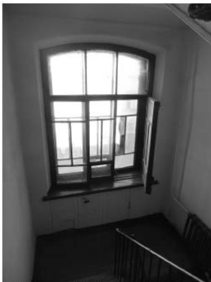
Фото 113. Лестница № 6. Площадка м/у 2-м и 3-м этажом. Съемка 19.04.2021 г. Трушковский В.Э.
