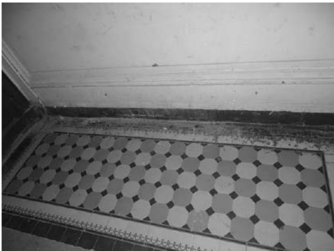
Фото 50. Лестница № 2. 2-й этаж. Покрытие пола. Съёмка 19.04.2021 г. Трушковский В.Э.
