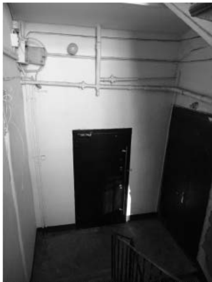
Фото 109. Лестница № 6. Площадка 1-го этажа. Съемка 19.04.2021 г. Трушковский В.Э.
