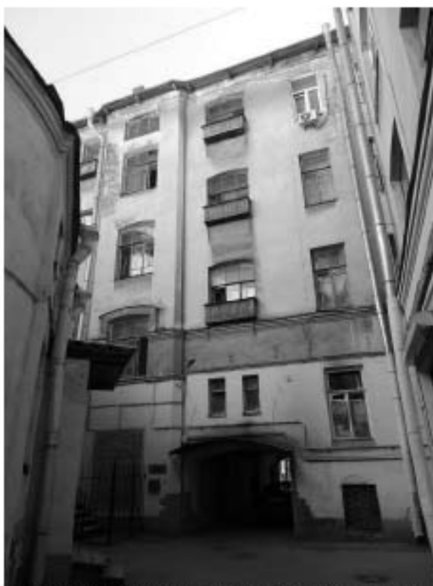
Фото 41. Здание по адресу: г. Санкт-Петербург, Тучков пер., 11/5, литера А. Северо-восточный дворовой фасад. Воротный проезд. Съемка 19.04.2021 г. Трушковский В.Э.
