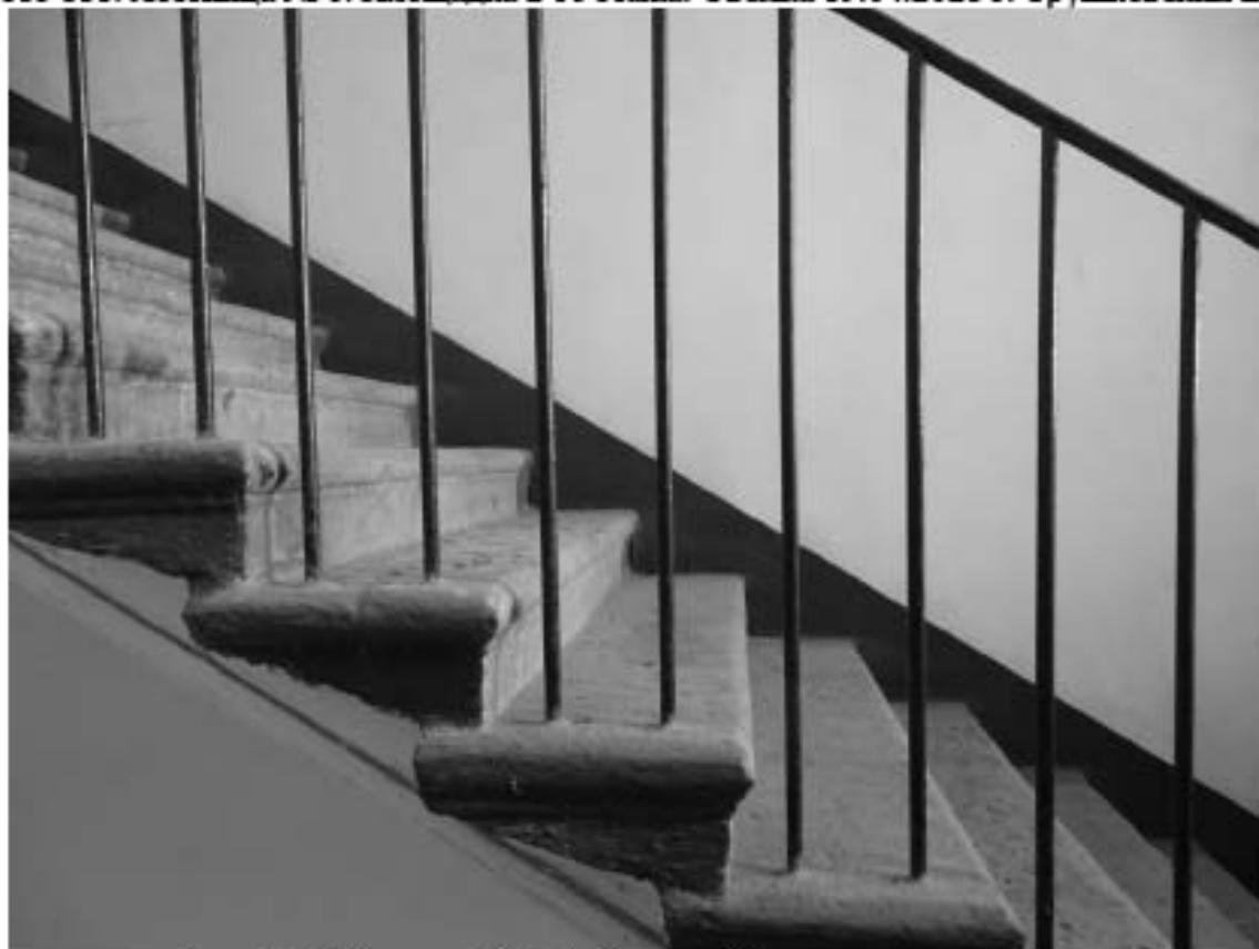
Фото 112. Лестница № 6. 2-й этажа. Лестничное ограждение. Съёмка 19.04.2021 г. Трушковский В.Э.
