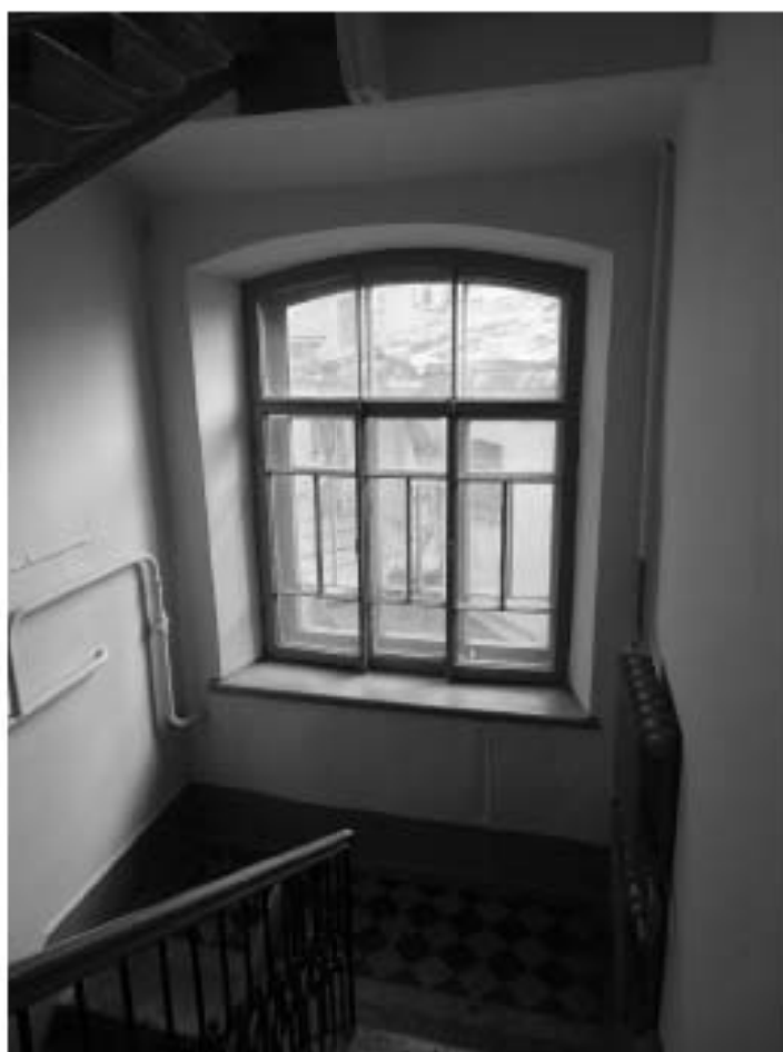
Фото 72. Лестница № 4. Площадка м/у 1-м и 2-м этажом. Съемка 19.04.2021 г. Трушковский В.Э.
