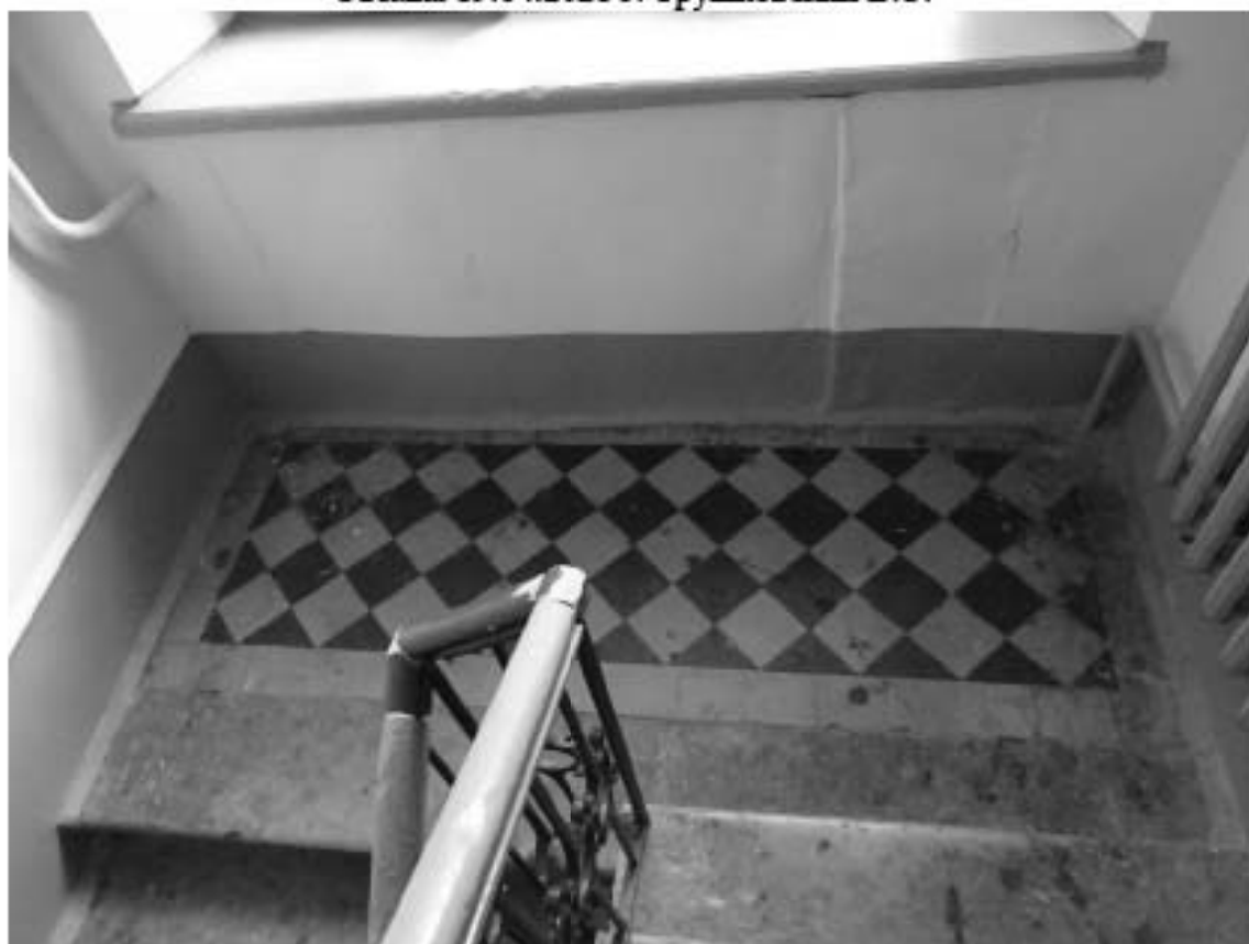
Фото 73. Лестница № 4. Площадка м/у 1-м и 2-м этажом. Покрытие пола. Съемка 19.04.2021 г. Трушковский В.Э.
