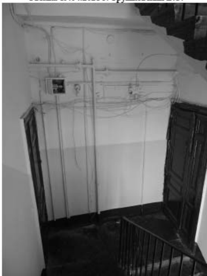
Фото 101. Лестница № 5. Площадка 4-го этажа. Съемка 19.04.2021 г. Трушковский В.Э.
