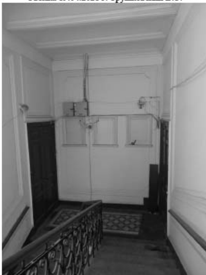
Фото 59. Лестница № 2. 4-й этажом. Съемка 19.04.2021 г. Трушковский В.Э.
