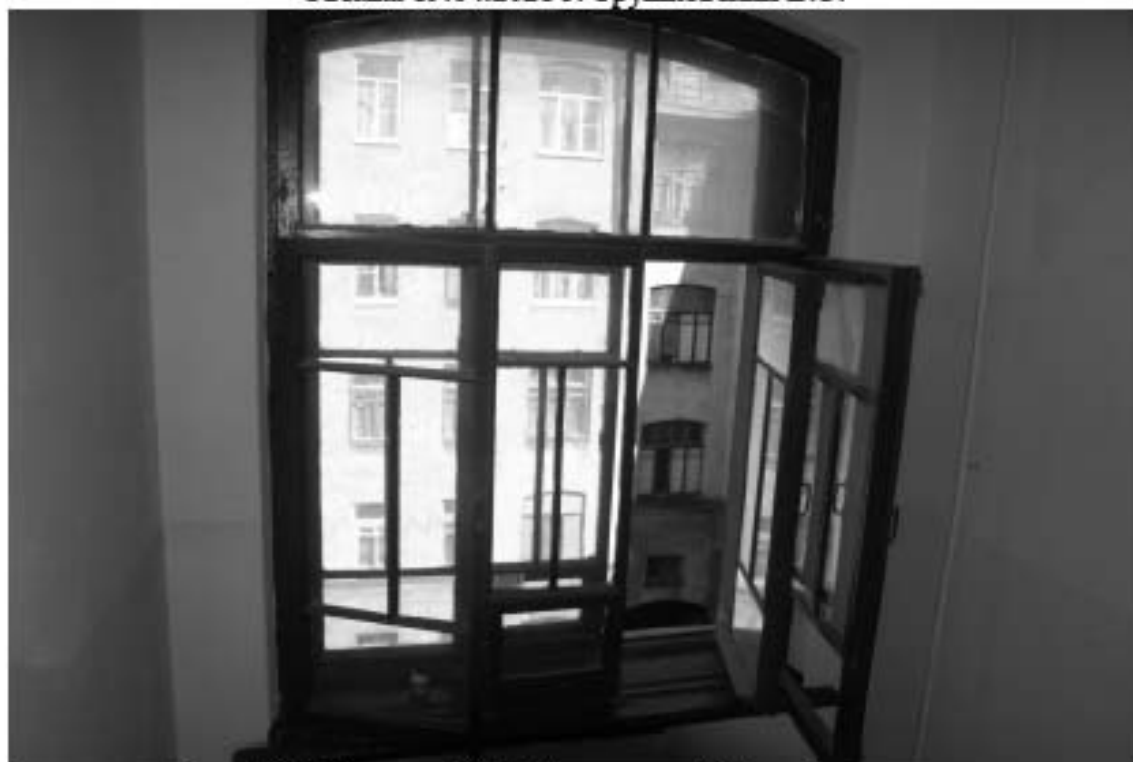
Фото 116. Лестница № 6. Площадка м/у 3-м и 4-м этажом. Съемка 19.04.2021 г. Трушковский В.Э.
