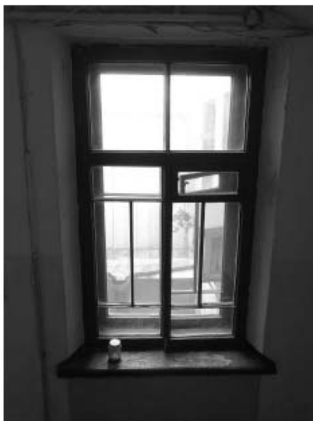
Фото 177. Лестница № 8. Площадка 5-го этажа. Оформление окна. Съемка 19.04.2021 г. Трушковский В.Э.
