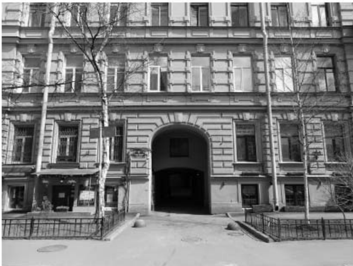
Фото 13. Здание по адресу: г. Санкт-Петербург, Тучков пер., 11/5, литера А. Фрагмент лицевого фасада со стороны Тучкова пер. Воротный проезд. Съемка 19.04.2021 г. Трушковский В.Э.
