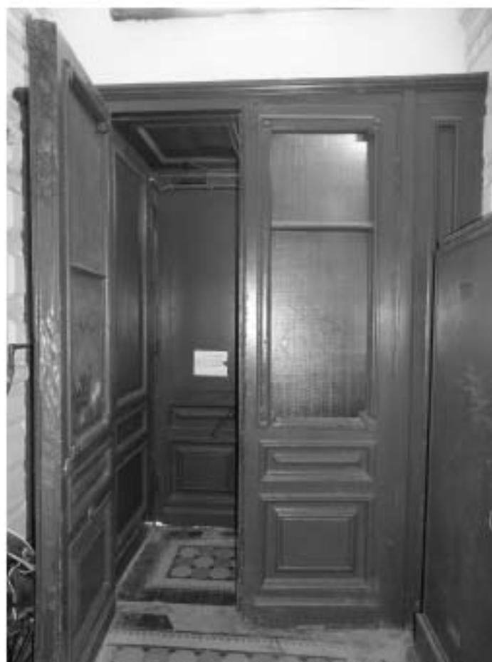
Фото 63. Лестница № 3. 1-й этаж. Вестибюль. Дверное заполнение. Съемка 19.04.2021 г. Трушковский В.Э.
