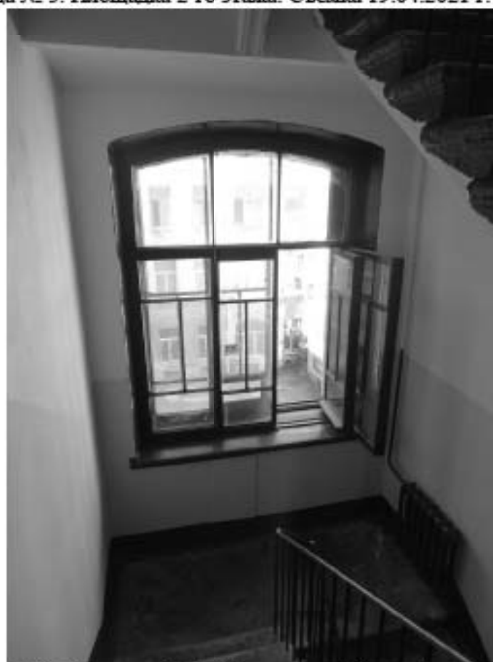
Фото 95. Лестница № 5. Площадка м/у 2-м и 3-м этажом. Съемка 19.04.2021 г. Трушковский В.Э.
