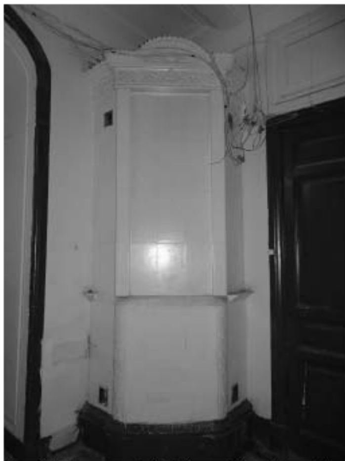
Фото 63. Лестница № 3. 1-й этаж. Вестибюль. Печь. Съемка 19.04.2021 г. Трушковский В.Э.
