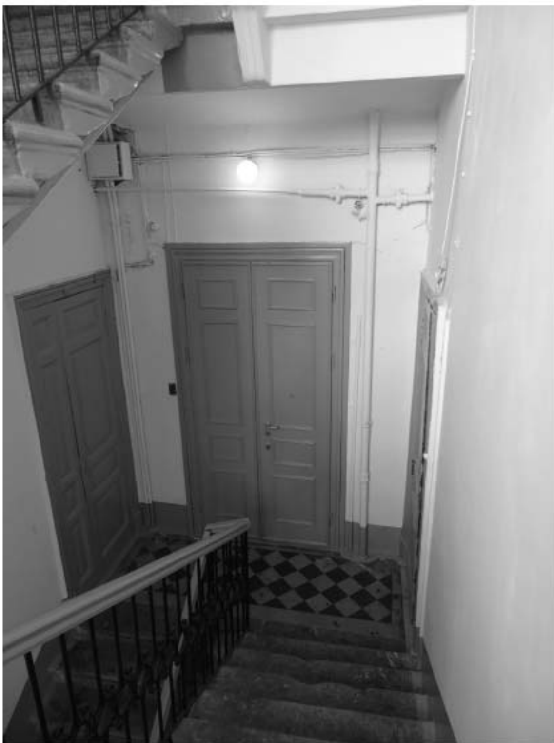
Фото 74. Лестница № 4. Площадка 2-го этажа. Съемка 19.04.2021 г. Трушковский В.Э.
