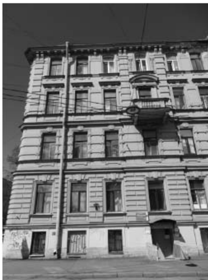
Фото 5. Здание по адресу: г. Санкт-Петербург, Тучков пер., 11/5, литера А. Фрагмент лицевого фасада с Волховского пер. Съемка 19.04.2021 г. Трушковский В.Э.
