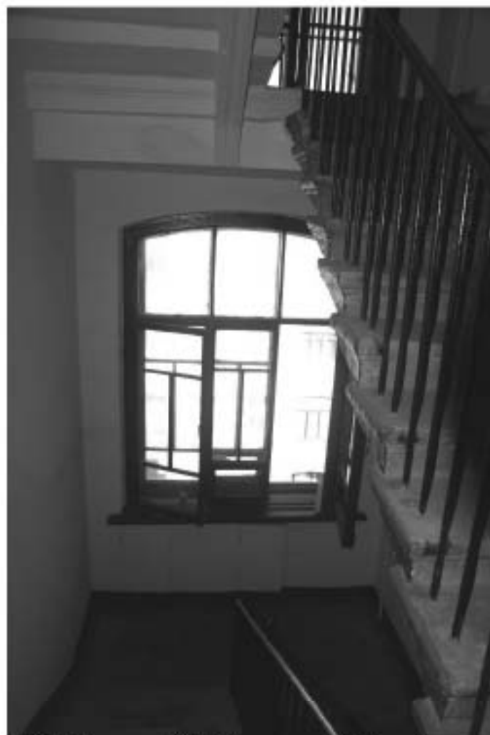
Фото 115. Лестница № 6. Площадка м/у 3-м и 4-м этажом. Съемка 19.04.2021 г. Трушковский В.Э.
