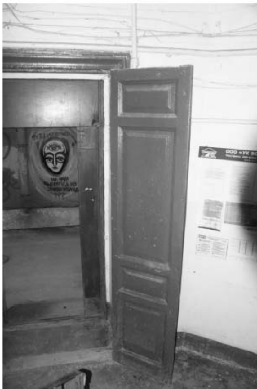
Фото 148. Лестница № 8. Вестибюль 1-го этажа. Входная дверь. Съемка 19.04.2021 г. Трушковский В.Э.
