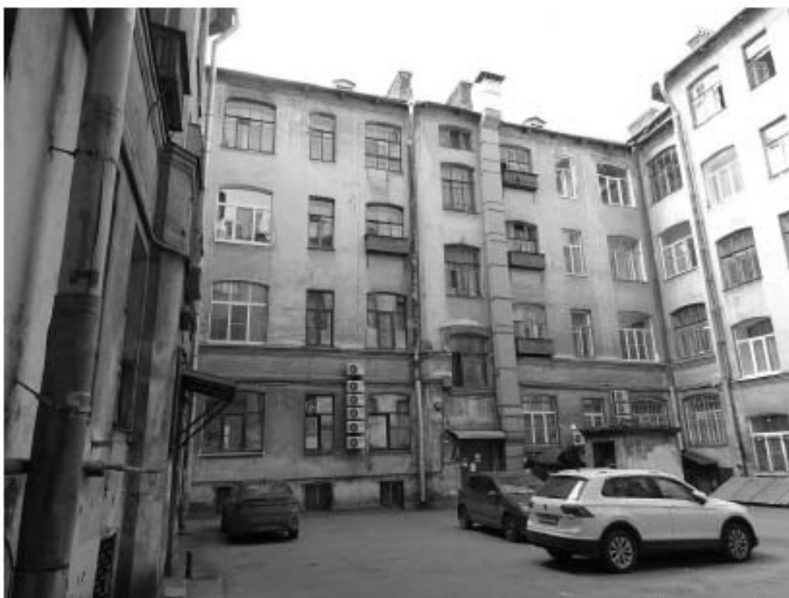
Фото 53. Здание по адресу: г. Санкт-Петербург, Тучков пер., 11/5, литера А. Дворовой фасад лицевого корпуса. Съемка 19.04.2021 г. Трушковский В.Э.
