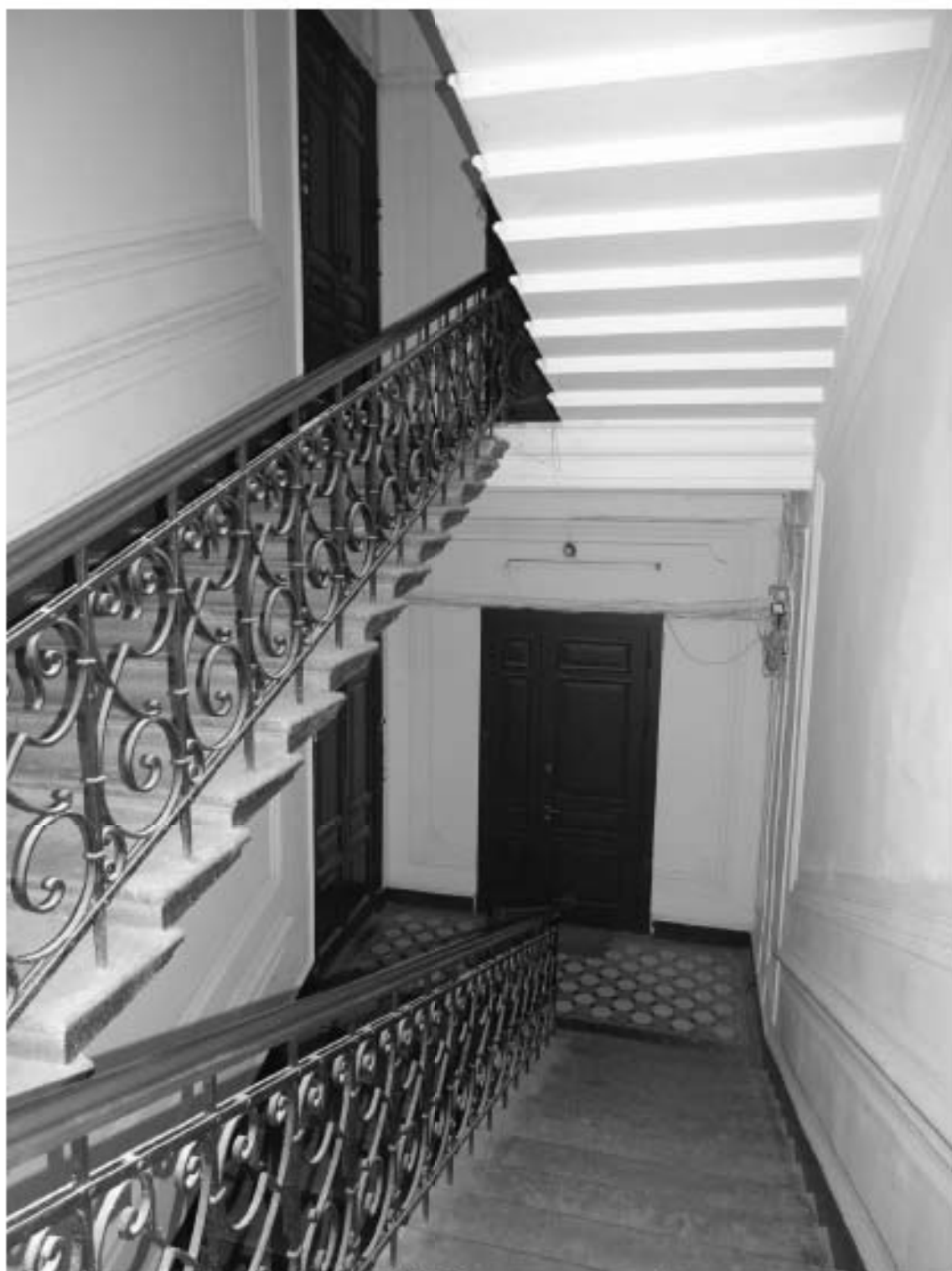
Фото 24. Лестница № 1. Вид на площадку 2-го этажа. Съемка 19.04.2021 г. Трушковский В.Э.
