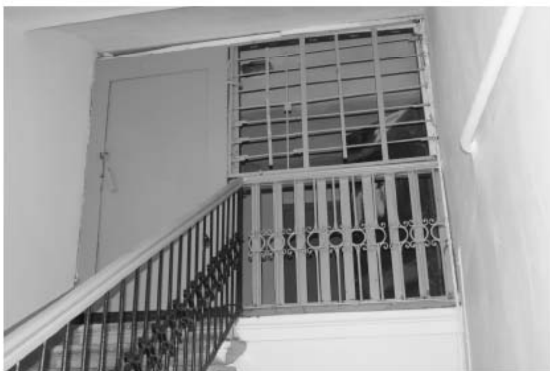
Фото 82. Лестница № 4. 5-й этаж. Съемка 19.04.2021 г. Трушковский В.Э.
