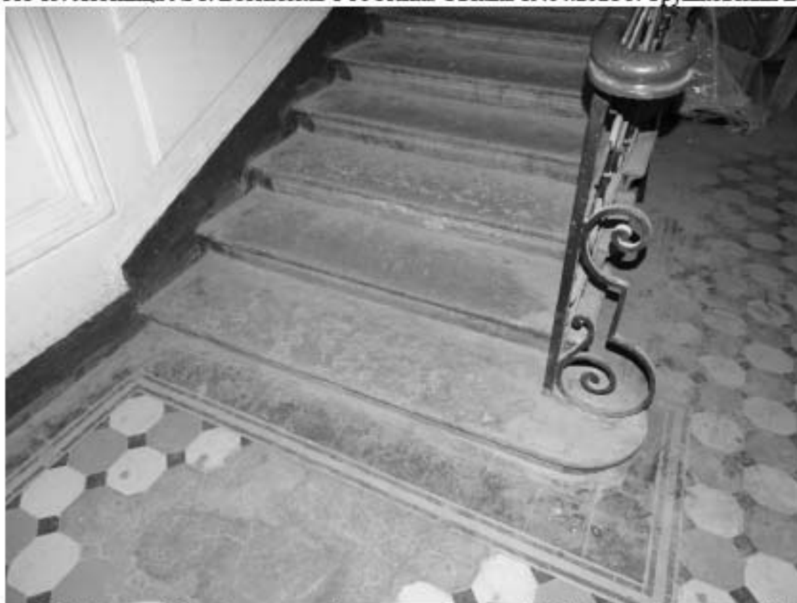
Фото 16. Лестница № 1. Вестибюль 1-го этажа. Съемка 19.04.2021 г. Трушковский В.Э.
