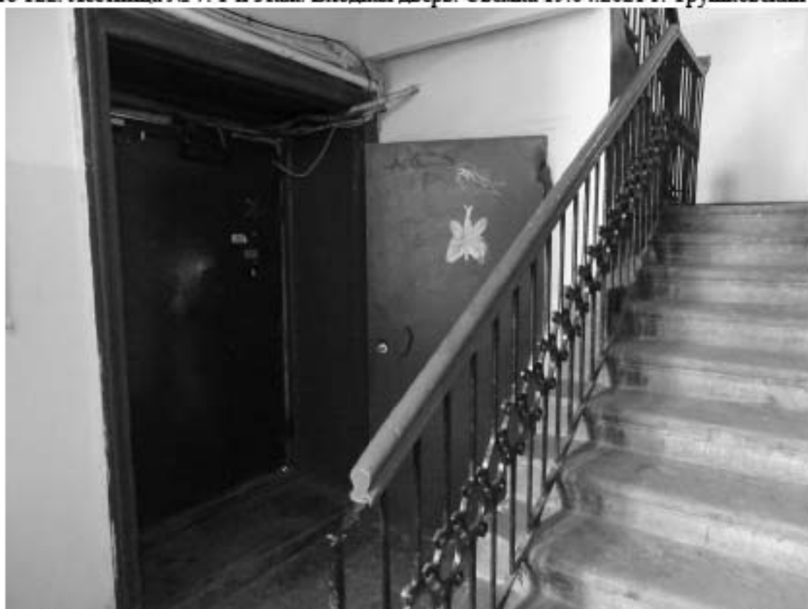
Фото 123. Лестница № 7. 1-й этаж. Съемка 19.04.2021 г. Трушковский В.Э.
