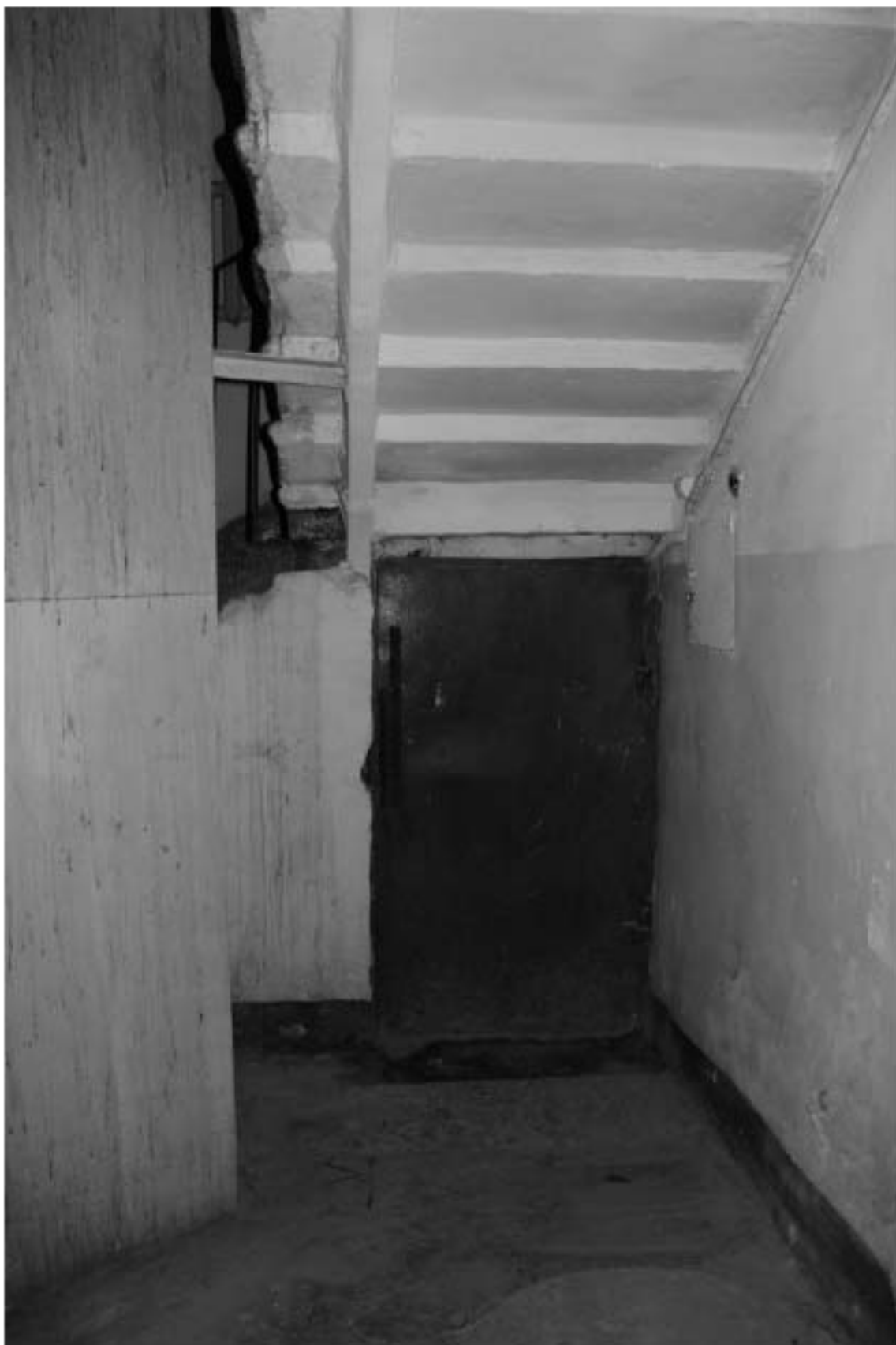
Фото 153. Лестница № 8. Вестибюль 1-го этажа. Пространство под лестницей. Съемка 19.04.2021 г. Трушковский В.Э.
