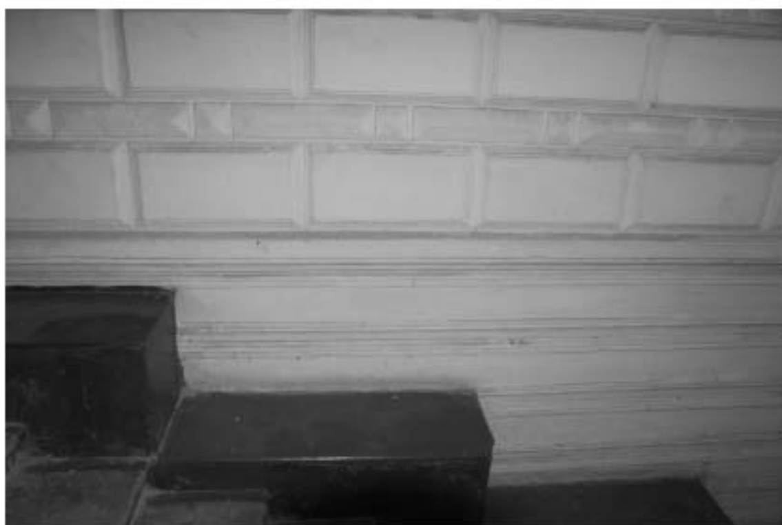
Фото 40. Лестница № 2. Вестибюль 1-го этажа. Оформление стен. Съемка 19.04.2021 г. Трушковский В.Э.
