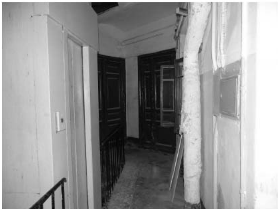
Фото 160. Лестница № 8. Площадка 2-го этажа. Съемка 19.04.2021 г. Трушковский В.Э.
