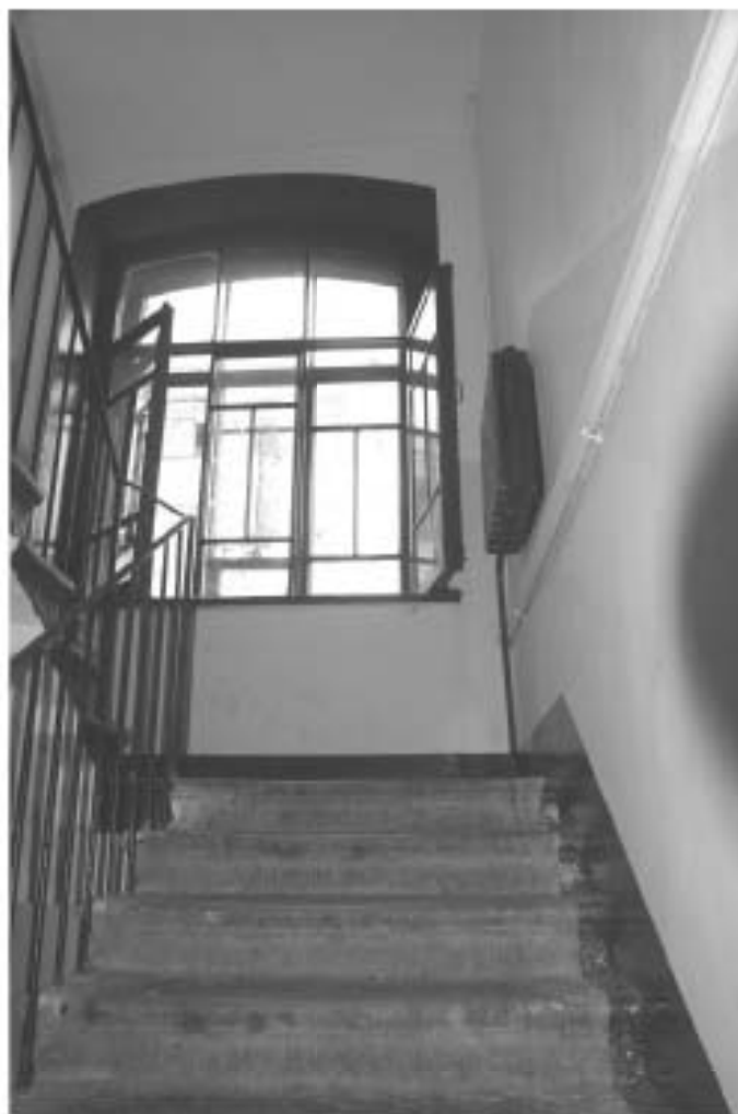
Фото 90. Лестница № 5. Площадка м/у 1-м и 2-м этажом. Съемка 19.04.2021 г. Трушковский В.Э.
