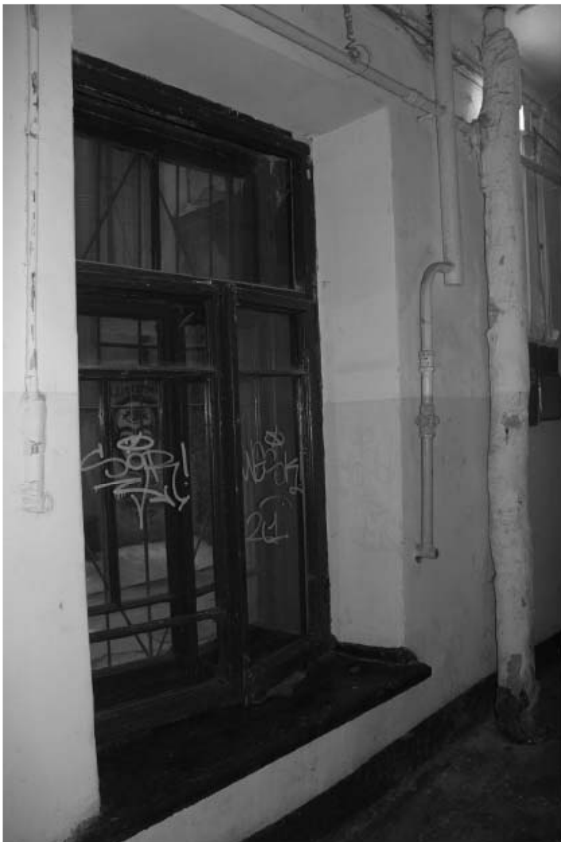
Фото 157. Лестница № 8. Вестибюль 1-го этажа. Оформление окна. Съемка 19.04.2021 г. Трушковский В.Э.
