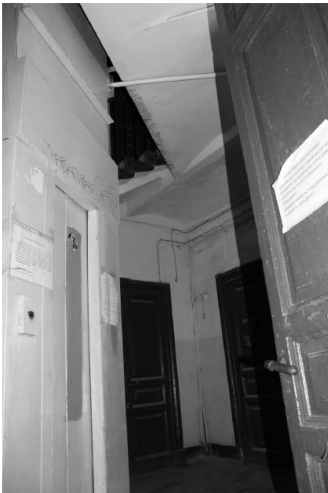
Фото 150. Лестница № 8. Вестибюль 1-го этажа. Съемка 19.04.2021 г. Трушковский В.Э.
