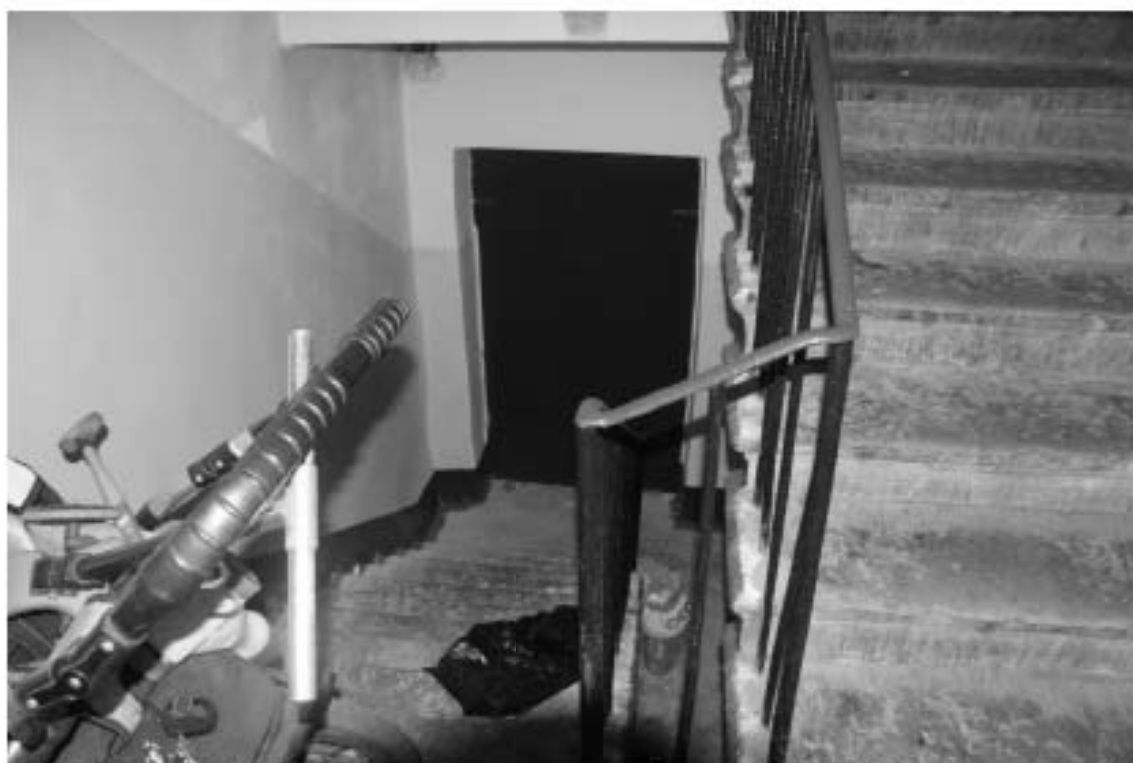
Фото 86. Лестница № 5. 1-й этаж. Спуск в подвал. Съемка 19.04.2021 г. Трушковский В.Э.
