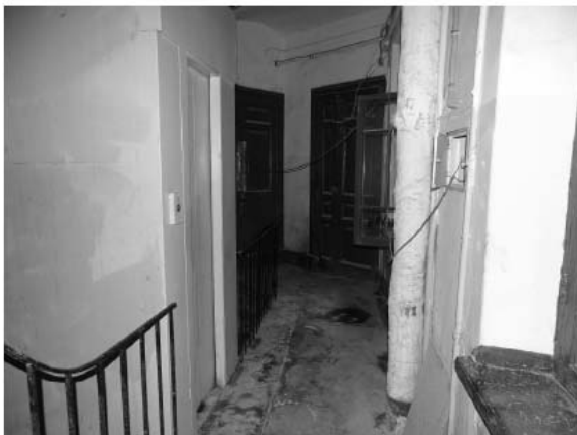
Фото 165. Лестница № 8. Площадка 3-го этажа. Съемка 19.04.2021 г. Трушковский В.Э.
