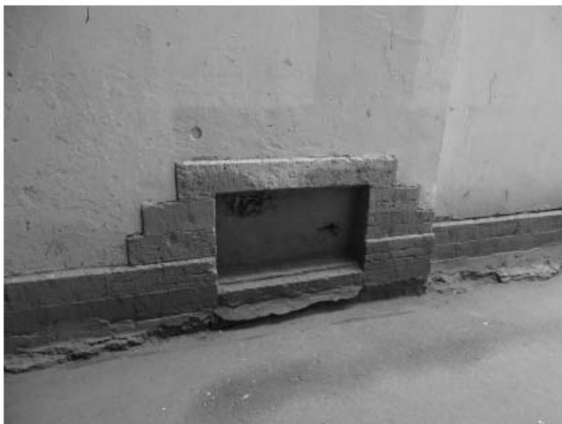
Фото 51. Здание по адресу: г. Санкт-Петербург, Тучков пер., 11/5, литера А. Воротный проезд. Цоколь. Съемка 19.04.2021 г. Трушковский В.Э.
