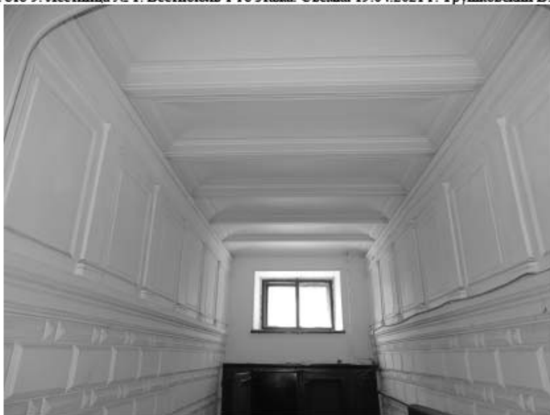
Фото 10. Лестница № 1. Вестибюль 1-го этажа. Оформление потолка. Съемка 19.04.2021 г. Трушковский В.Э.
