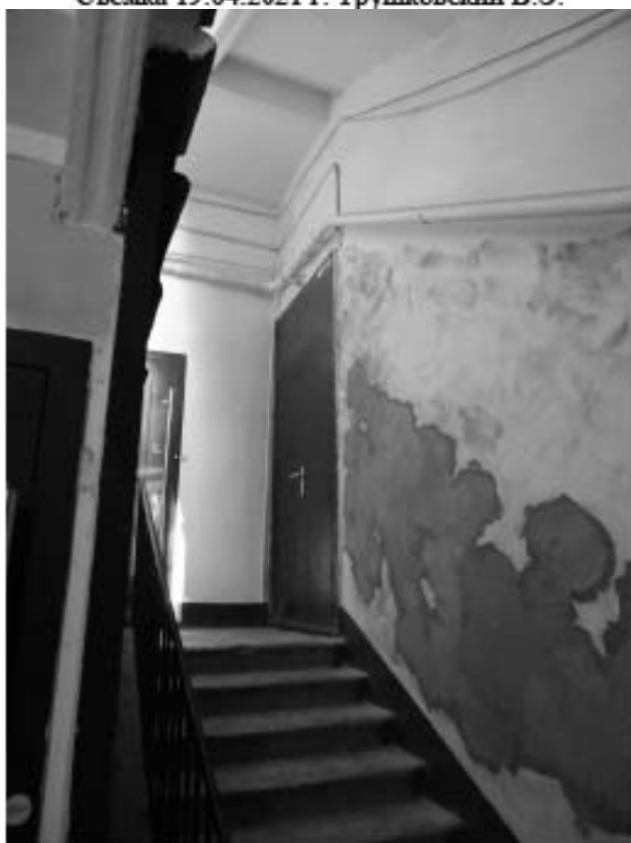
Фото 108. Лестница № 6. 1-й этаж. Съемка 19.04.2021 г. Трушковский В.Э.
