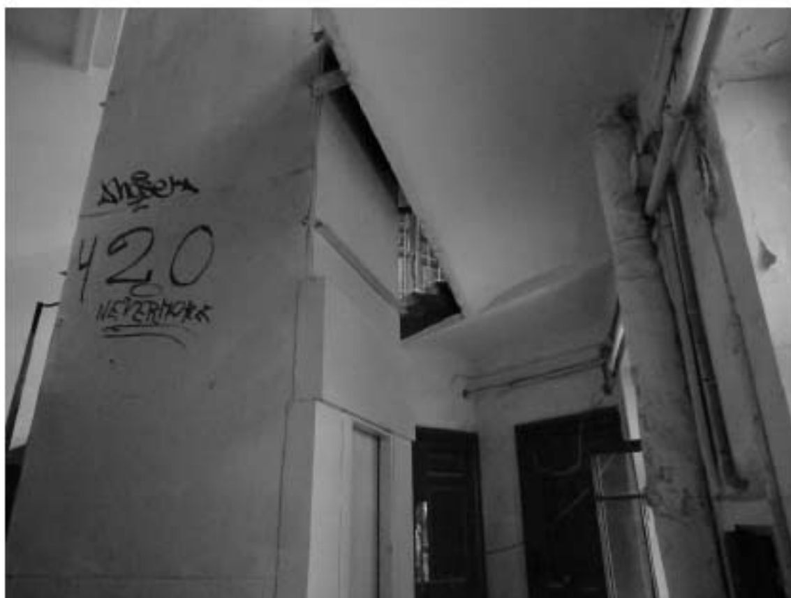
Фото 167. Лестница № 8. Площадка 3-го этажа. Съемка 19.04.2021 г. Трушковский В.Э.
