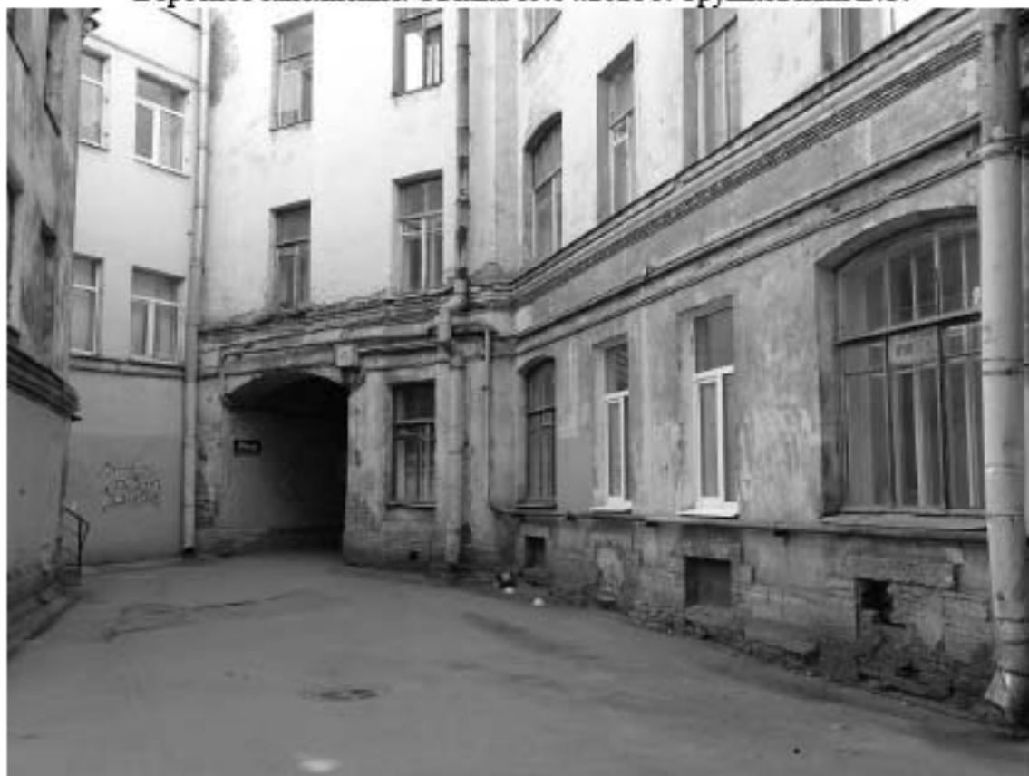
Фото 23. Здание по адресу: г. Санкт-Петербург, Тучков пер., 11/5, литера А. Фрагмент северо-западного дворового фасада. Съемка 19.04.2021 г. Трушковский В.Э.
