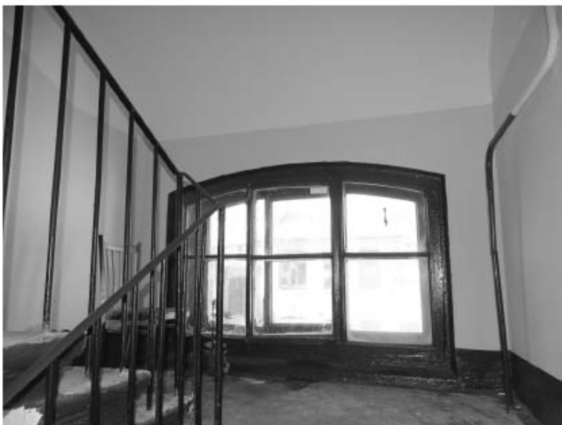
Фото 102. Лестница № 5. Площадка м/у 4-м и 5-м этажом. Съемка 19.04.2021 г. Трушковский В.Э.
