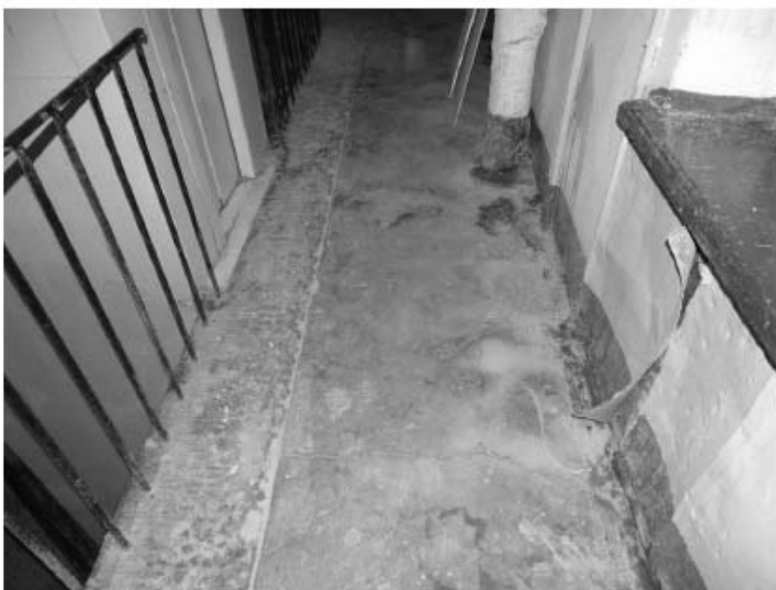
Фото 162. Лестница № 8. Площадка 2-го этажа. Покрытие пола. Съемка 19.04.2021 г. Трушковский В.Э.
