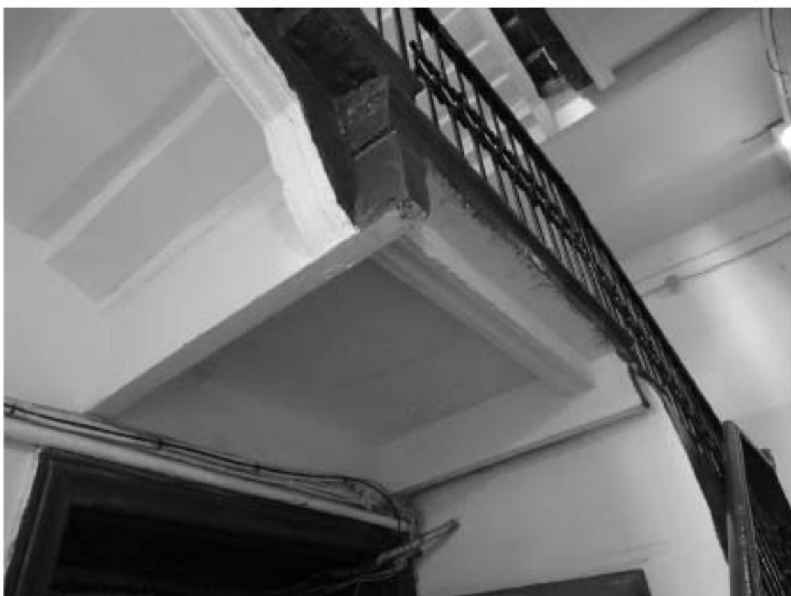
Фото 124. Лестница № 7. 1-й этаж. Съемка 19.04.2021 г. Трушковский В.Э.
