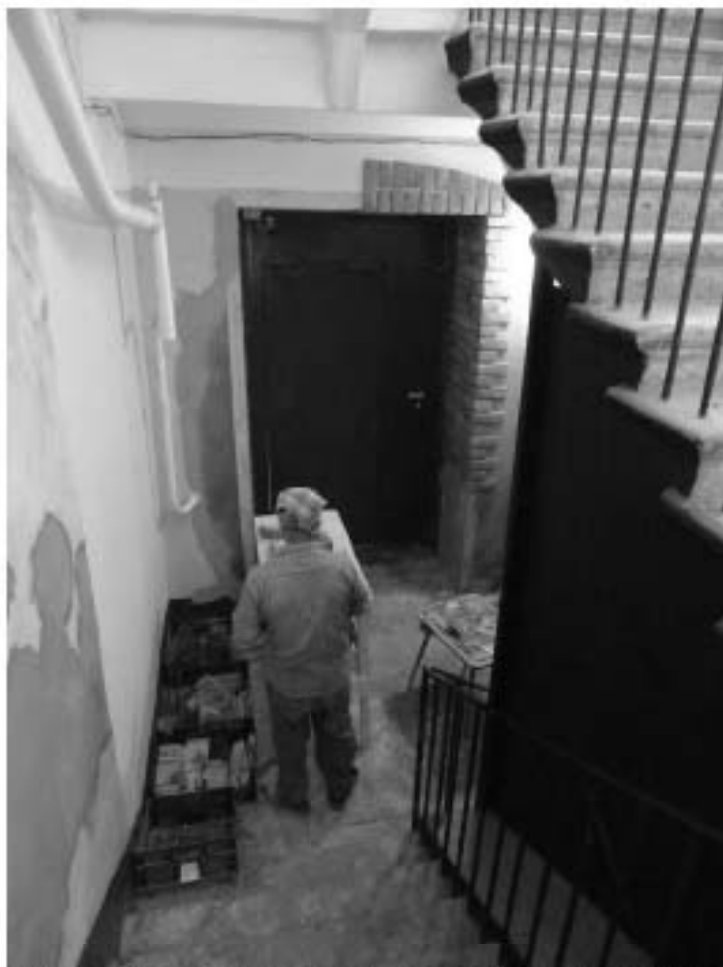
Фото 105. Лестница № 6. 1-й этаж. Входная дверь. Съемка 19.04.2021 г. Трушковский В.Э.
