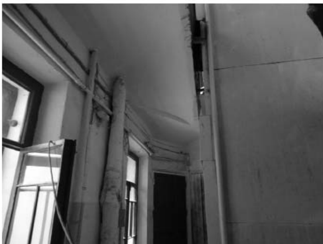
Фото 168. Лестница № 8. Площадка 3-го этажа. Съемка 19.04.2021 г. Трушковский В.Э.
