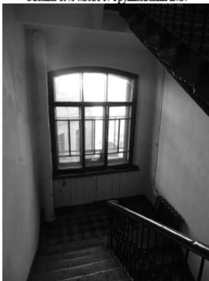
Фото 132. Лестница № 7. Площадка м/у 2-м и 3-м этажом. Съемка 19.04.2021 г. Трушковский В.Э.
