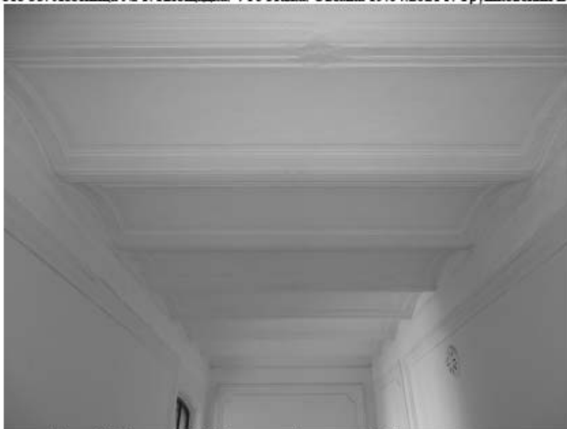
Фото 34. Лестница № 1. Площадка. 4-го этажа. Оформление потолка. Съемка 19.04.2021 г. Трушковский В.Э.
