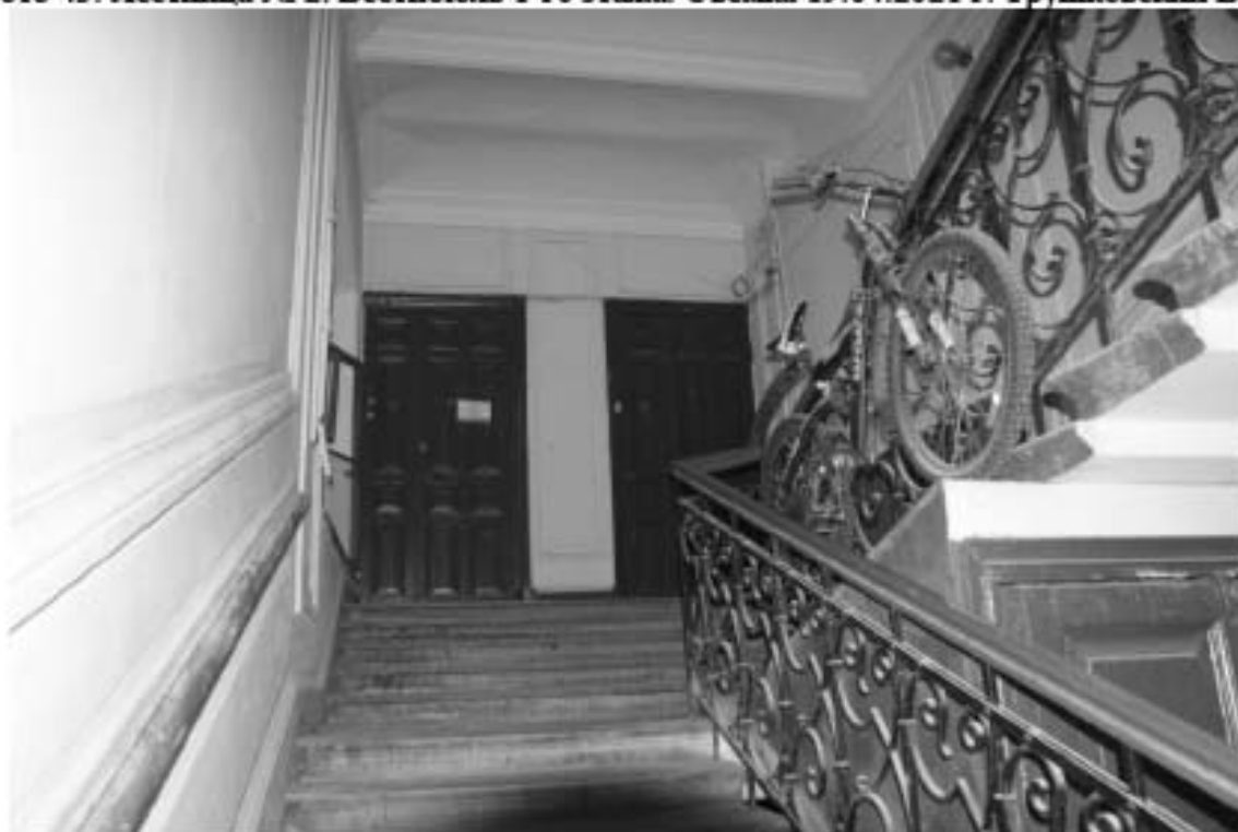
Фото 44. Лестница № 2. Площадка между 1-м и 2-м этажом. Съёмка 19.04.2021 г. Трушковский В.Э.
