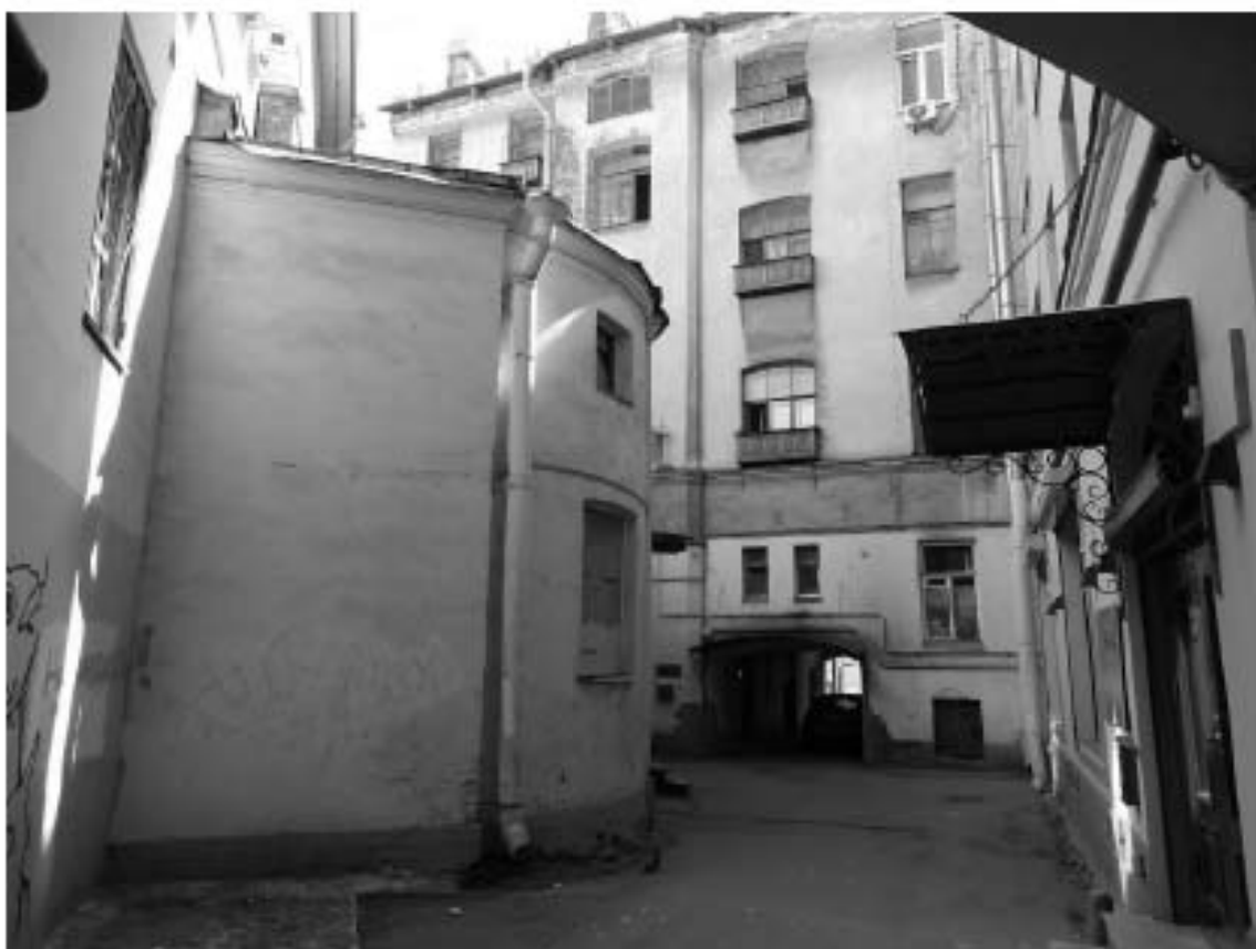
Фото 39. Здание по адресу: г. Санкт-Петербург, Тучков пер., 11/5, литера А. Северо-восточный дворовой фасад. Съемка 19.04.2021 г. Трушковский В.Э.
