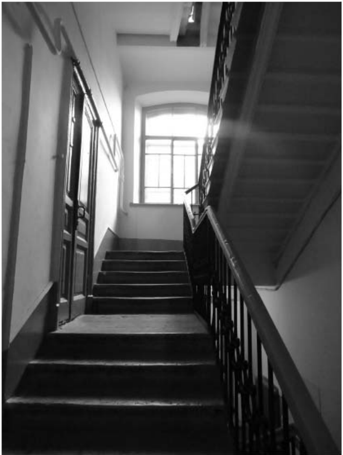
Фото 71. Лестница № 4. Промежуточная площадка м/у 1-м и 2-м этажом. Съемка 19.04.2021 г. Трушковский В.Э.
