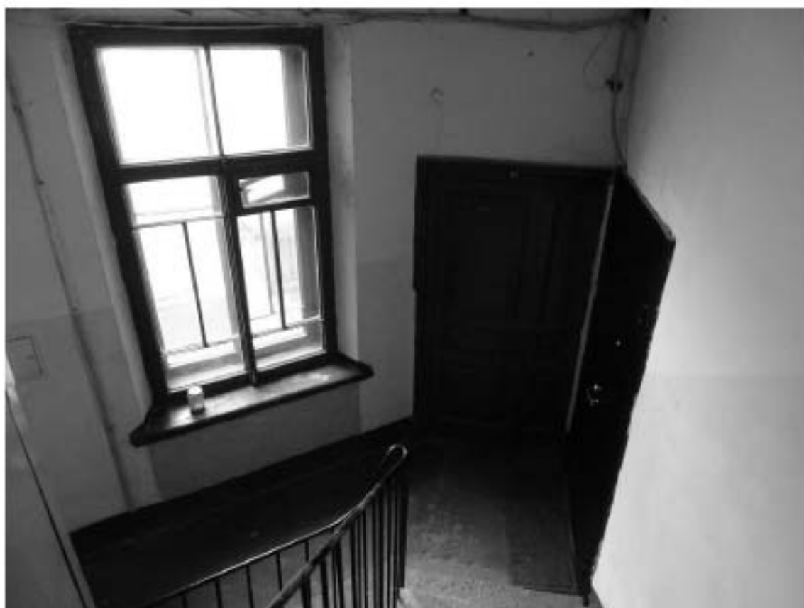
Фото 175. Лестница № 8. Площадка 5-го этажа. Съёмка 19.04.2021 г. Трушковский В.Э.
