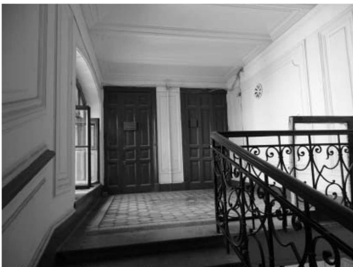
Фото 61. Лестница № 2. Площадка 5-го этажа. Съемка 19.04.2021 г. Трушковский В.Э.
