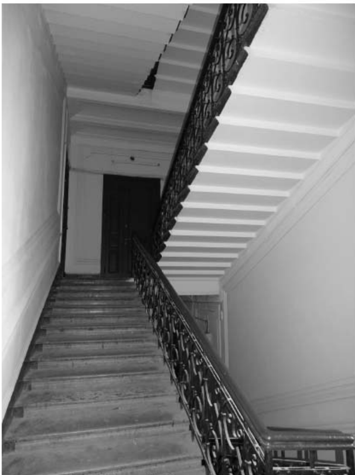
Фото 22. Лестница № 1. Вид на площадку 2-го этажа. Съемка 19.04.2021 г. Трушковский В.Э.
