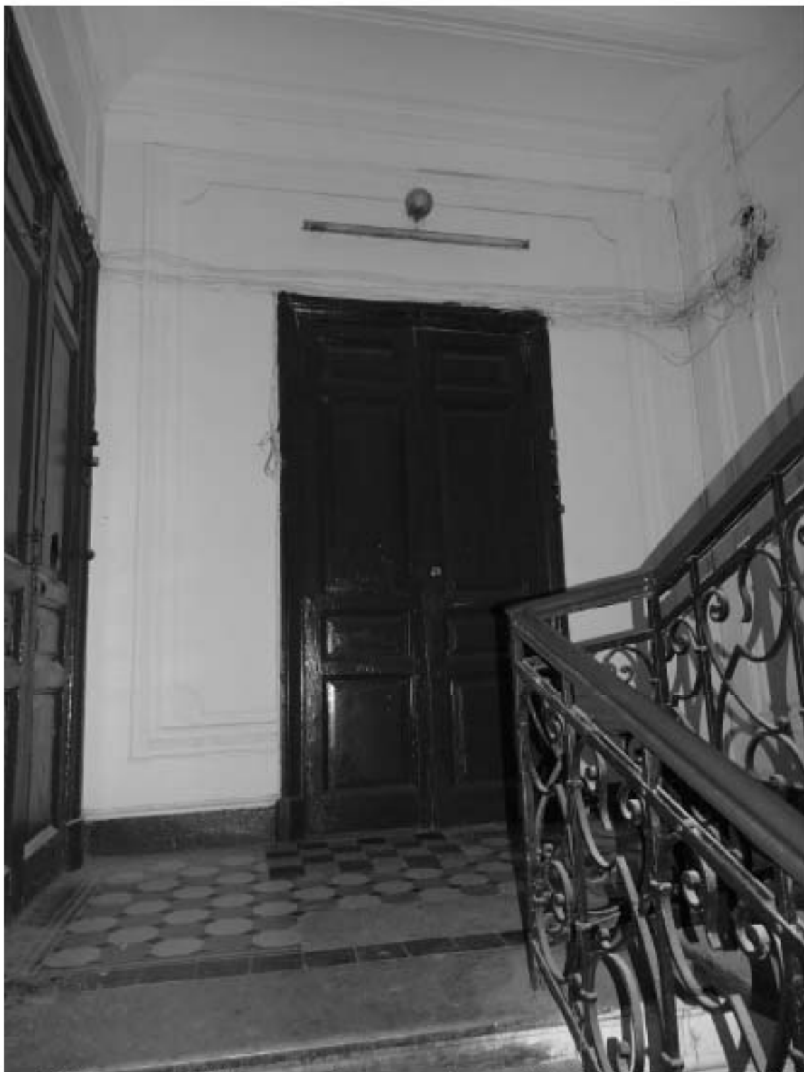
Фото 27. Лестница № 1. Площадка 3-го этажа. Съемка 19.04.2021 г. Трушковский В.Э.
