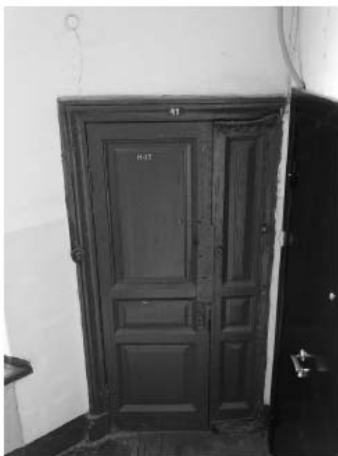
Фото 176. Лестница № 8. Площадка 5-го этажа. Оформление двери. Съёмка 19.04.2021 г. Трушковский В.Э.
