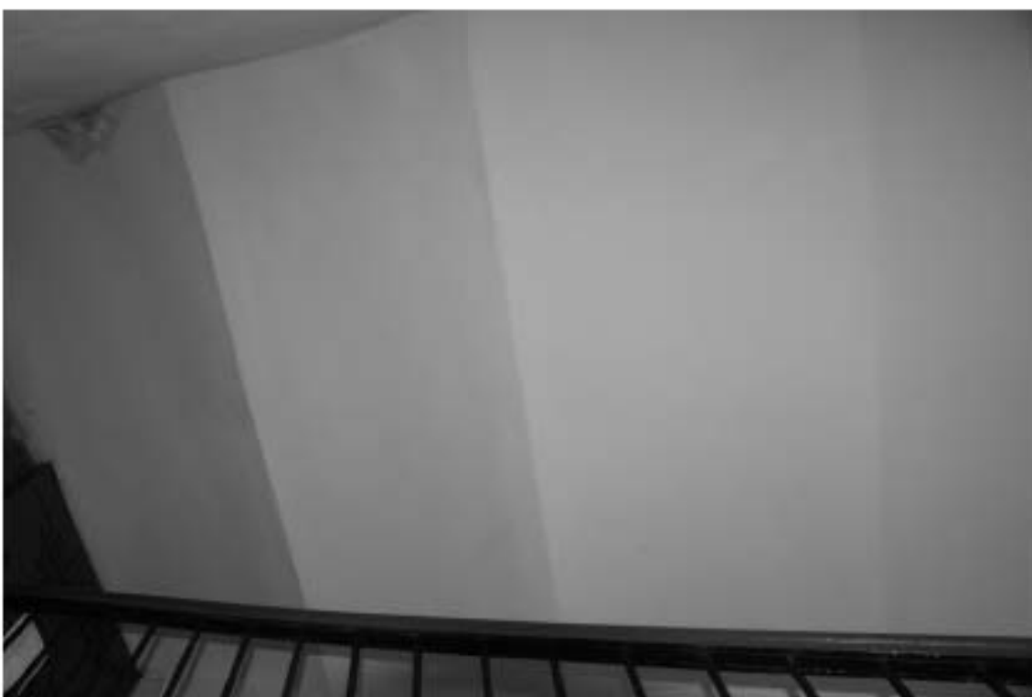
Фото 146. Лестница № 7. Оформление потолка. Съемка 19.04.2021 г. Трушковский В.Э.
