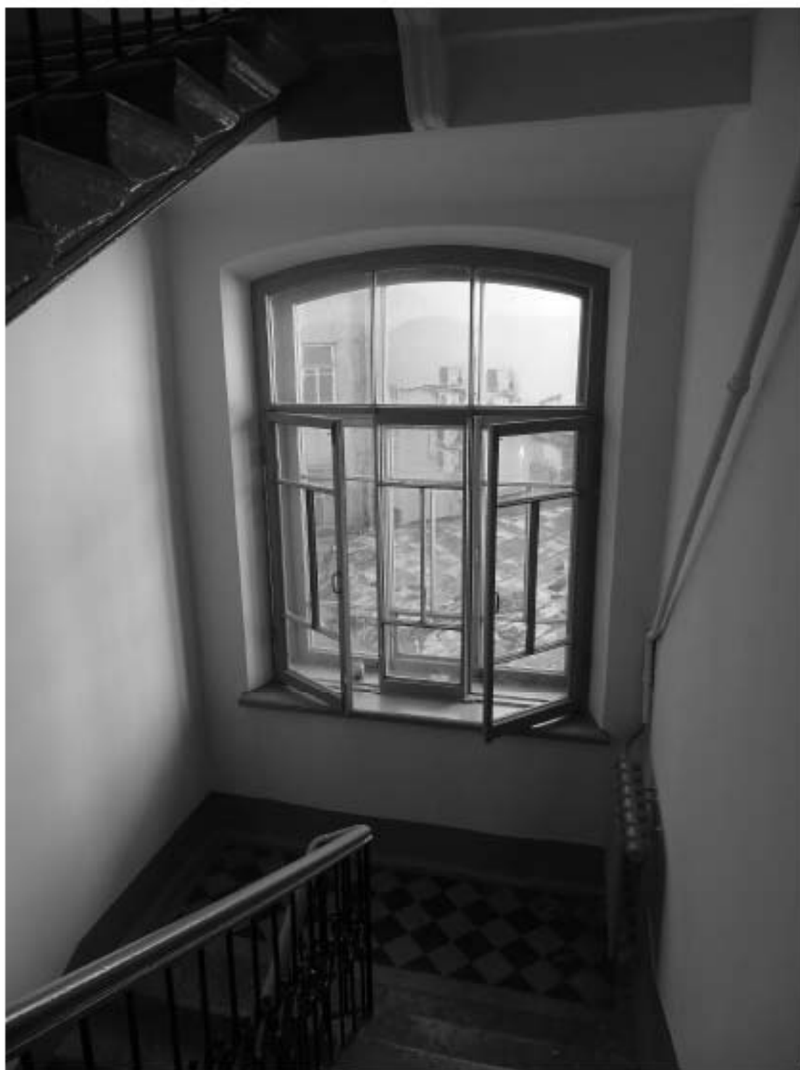
Фото 75. Лестница № 4. Площадка м/у 2-м и 3-м этажом. Съемка 19.04.2021 г. Трушковский В.Э.
