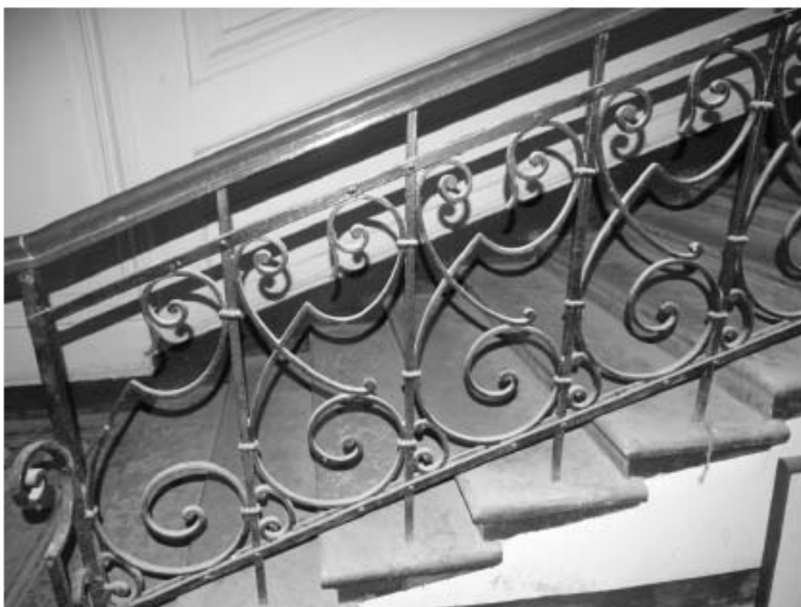
Фото 17. Лестница № 1. Вестибюль 1-го этажа. Лестничное ограждение. Съемка 19.04.2021 г. Трушковский В.Э.
