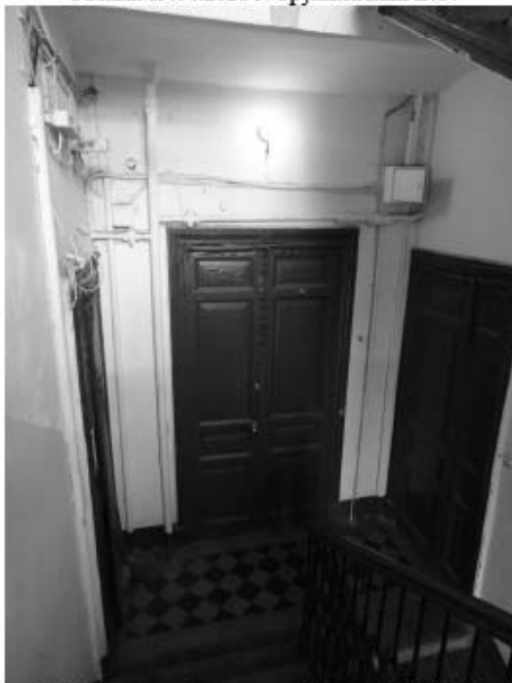
Фото 131. Лестница № 7. Площадка 2-го этажа. Съемка 19.04.2021 г. Трушковский В.Э.
