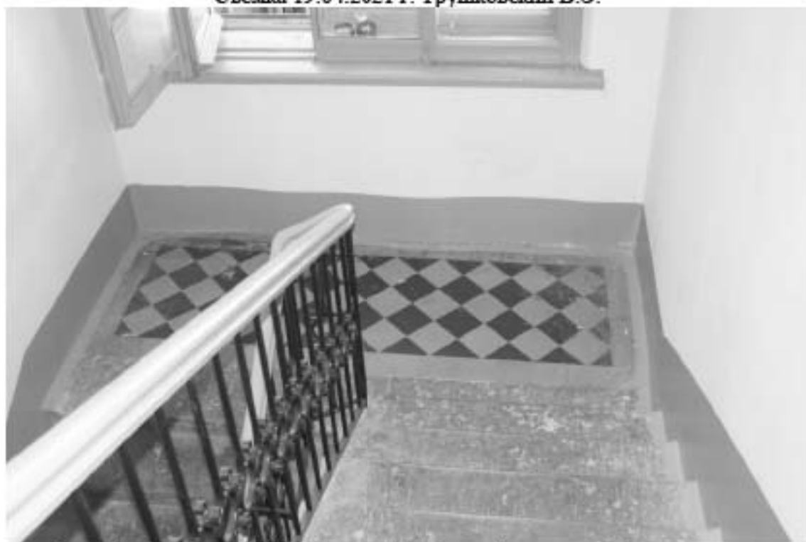
Фото 78. Лестница № 4. Площадка м/у 3-м и 4-м этажом. Покрытие пола. Съемка 19.04.2021 г. Трушковский В.Э.
