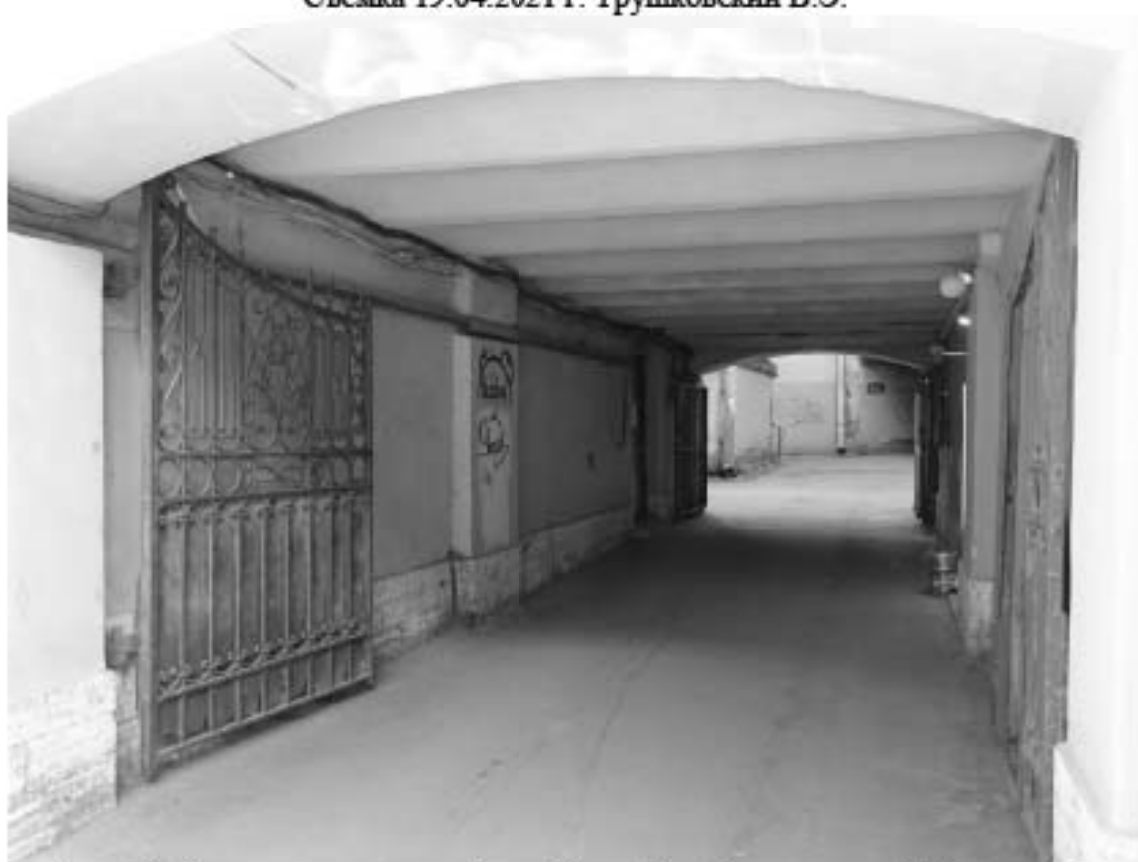
Фото 21. Здание по адресу: г. Санкт-Петербург, Тучков пер., 11/5, литера А. Воротный проезд лицевого фасада со стороны Тучкова пер. Съемка 19.04.2021 г. Трушковский В.Э.
