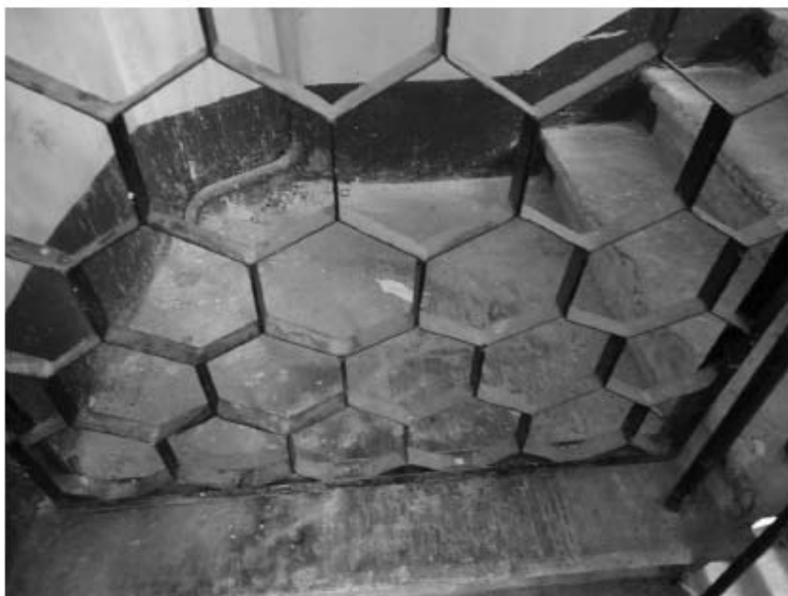
Фото 183. Лестница № 8. Площадка м/у 5-м и 6-м этажом. Съемка 19.04.2021 г. Трушковский В.Э.
