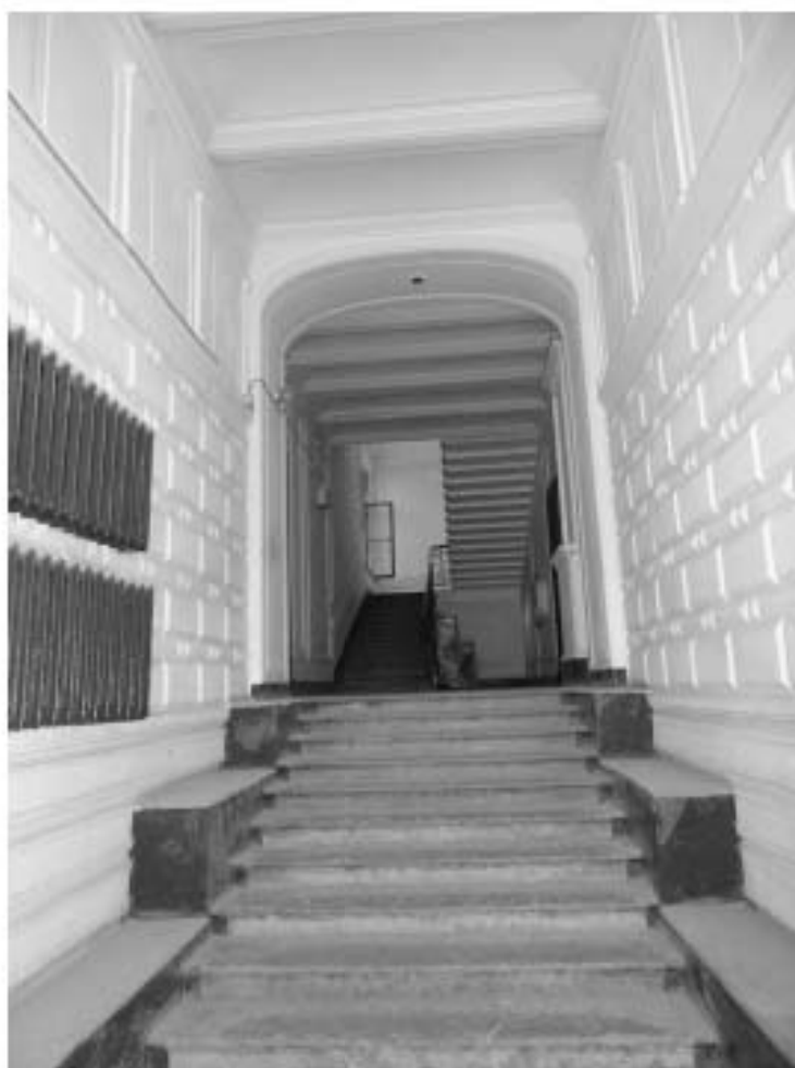
Фото 9. Лестница № 1. Вестибюль 1-го этажа. Съемка 19.04.2021 г. Трушковский В.Э.
