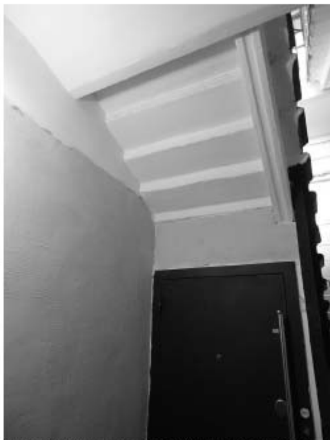
Фото 107. Лестница № 6. 1-й этаж. Дверь в подвал. Съемка 19.04.2021 г. Трушковский В.Э.
