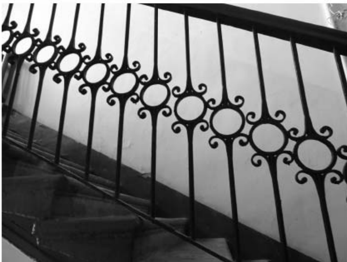
Фото 130. Лестница № 7. Площадка м/у 1-м и 2-м этажом. Лестничное ограждение. Съемка 19.04.2021 г. Трушковский В.Э.
