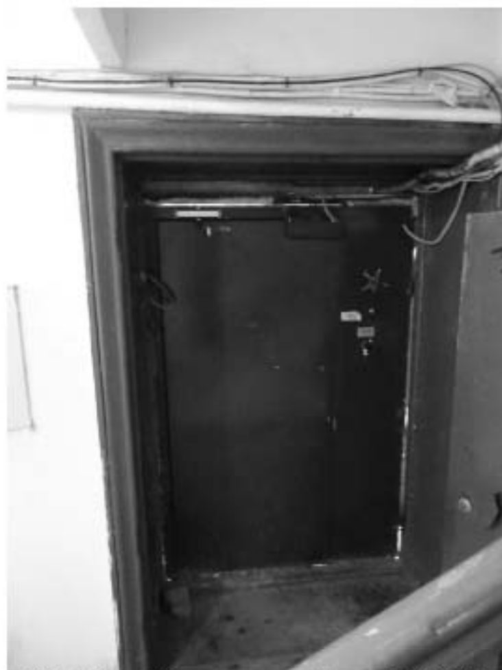
Фото 122. Лестница № 7. 1-й этаж. Входная дверь. Съемка 19.04.2021 г. Трушковский В.Э.
