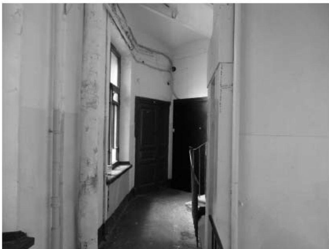
Фото 179. Лестница № 7. Площадка 5-го этажа. Съемка 19.04.2021 г. Трушковский В.Э.
