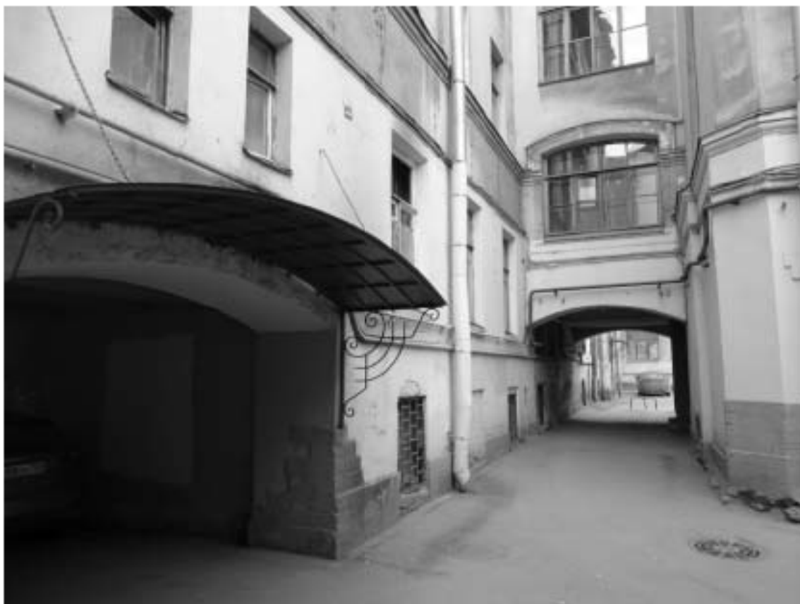
Фото 47. Здание по адресу: г. Санкт-Петербург, Тучков пер., 11/5, литера А. Фрагмент северо-восточного дворового фасада. Съемка 19.04.2021 г. Трушковский В.Э.
