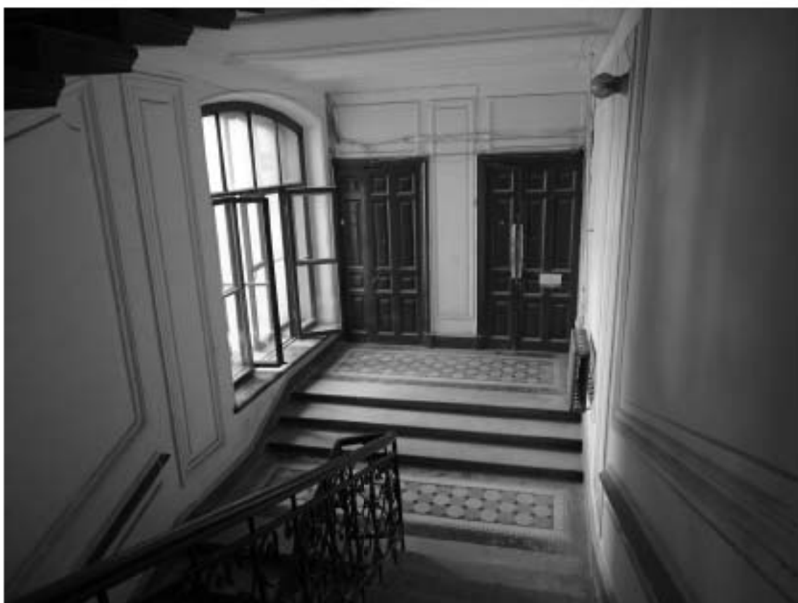
Фото 54. Лестница № 2. Площадка между 2-м и 3-м этажом. Съемка 19.04.2021 г. Трушковский В.Э.
