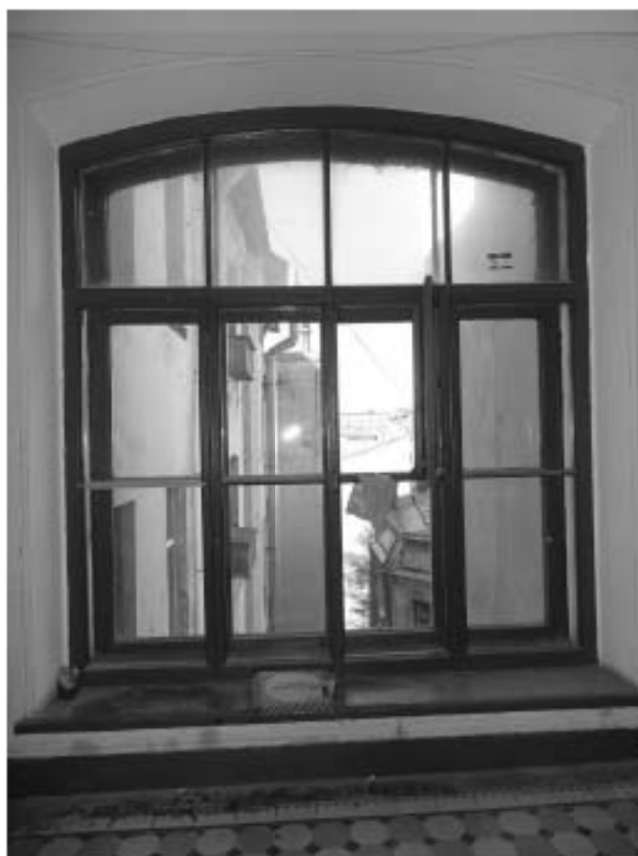
Фото 56. Лестница № 2. Площадка между 3-м и 4-м этажом. Оконное заполнение. Съемка 19.04.2021 г. Трушковский В.Э.
