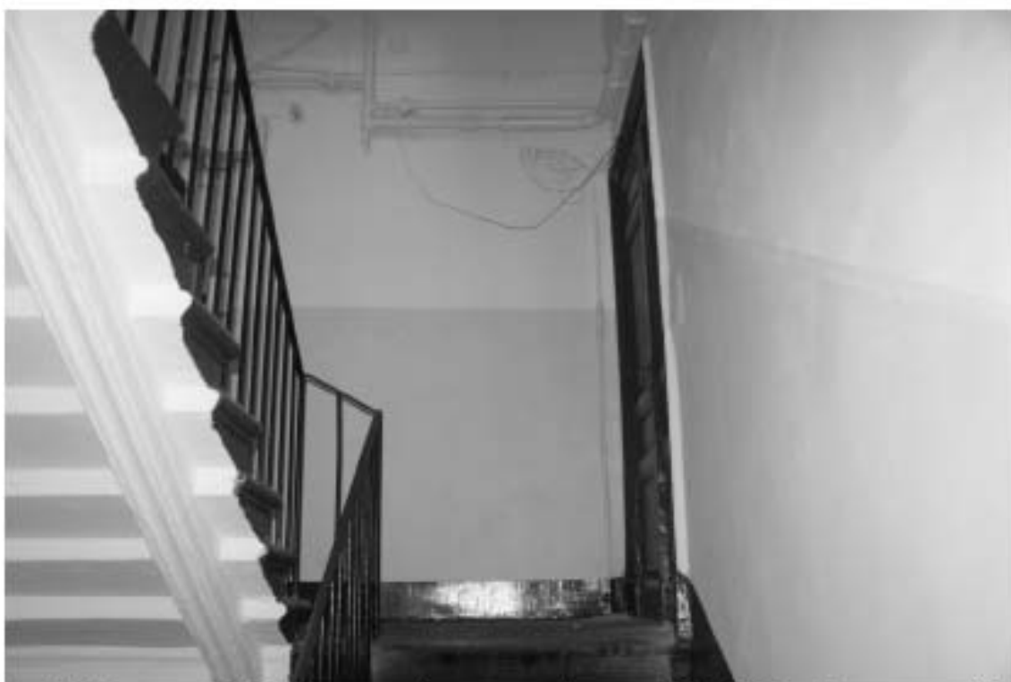
Фото 88. Лестница № 5. Площадка 1-го этажа. Съемка 19.04.2021 г. Трушковский В.Э.
