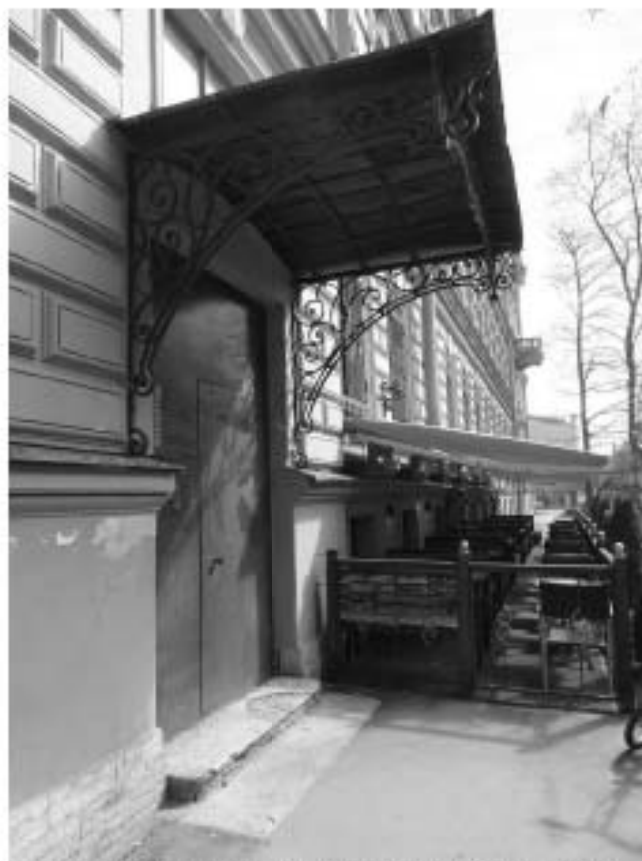
Фото 17. Здание по адресу: г. Санкт-Петербург, Тучков пер., 11/5, литера А. Фрагмент лицевого фасада со стороны Тучкова пер. Вход в парадную. Оформление навеса. Съемка 19.04.2021 г. Трушковский В.Э.
