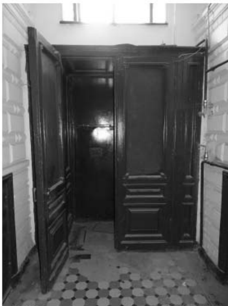
Фото 5. Лестница № 1. Вестибюль 1-го этажа. Съемка 19.04.2021 г. Трушковский В.Э.
