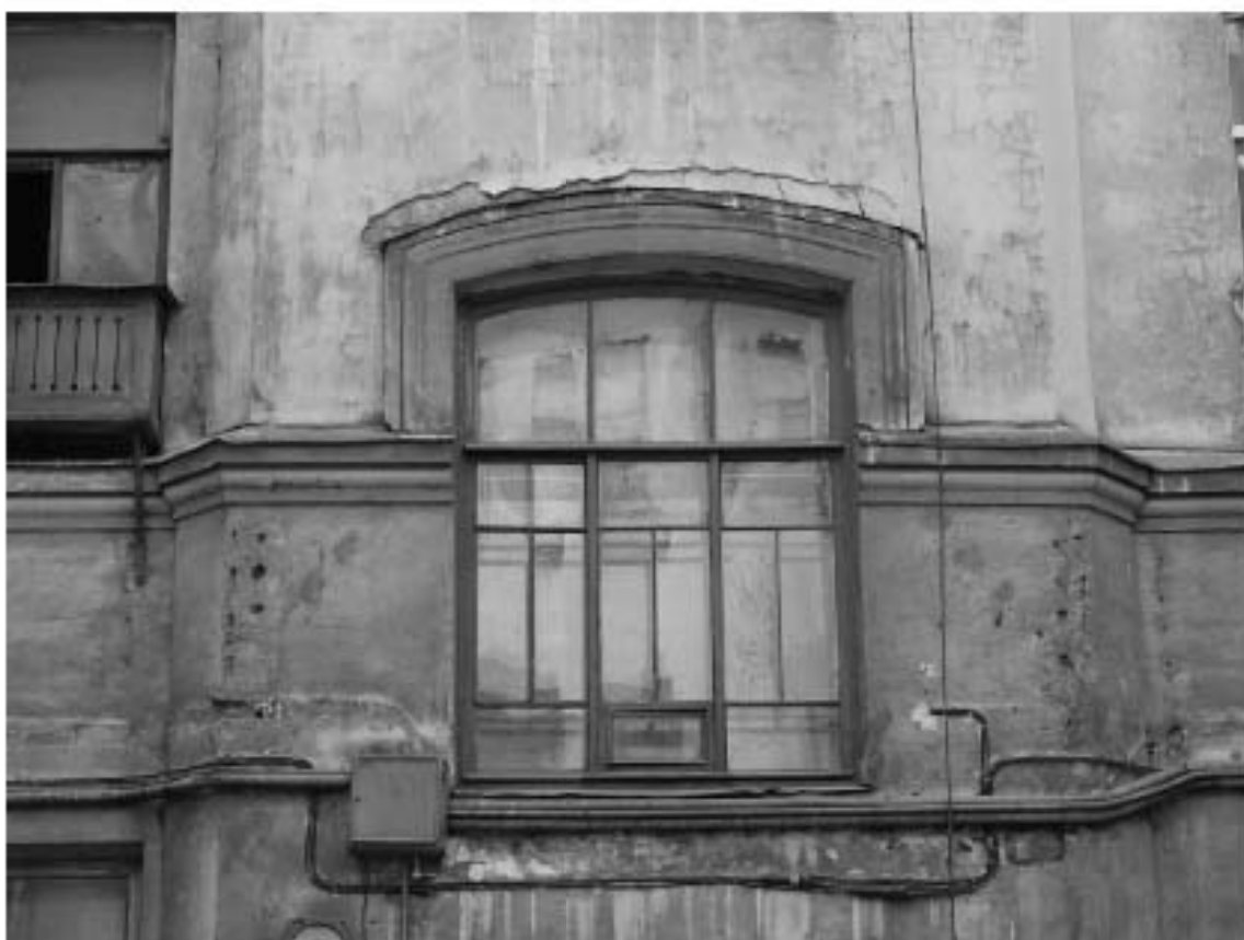
Фото 60. Здание по адресу: г. Санкт-Петербург, Тучков пер., 11/5, литера А. Фрагмент дворового фасада. Лицевой корпус. Съемка 19.04.2021 г. Трушковский В.Э.
