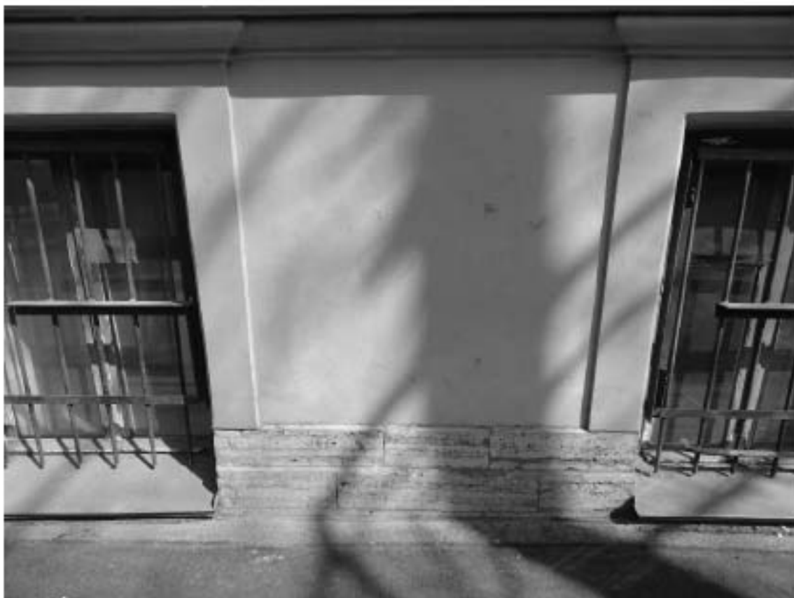
Фото 15. Здание по адресу: г. Санкт-Петербург, Тучков пер., 11/5, литера А. Фрагмент лицевого фасада со стороны Тучкова пер. Цоколь из известняка. Съемка 19.04.2021 г. Трушковский В.Э.
