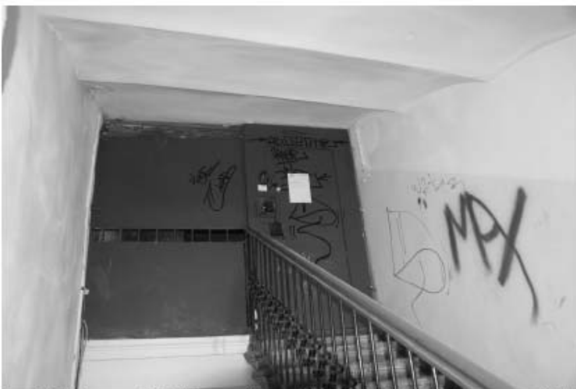
Фото 145. Лестница № 7. Чердачный этаж. Съемка 19.04.2021 г. Трушковский В.Э.
