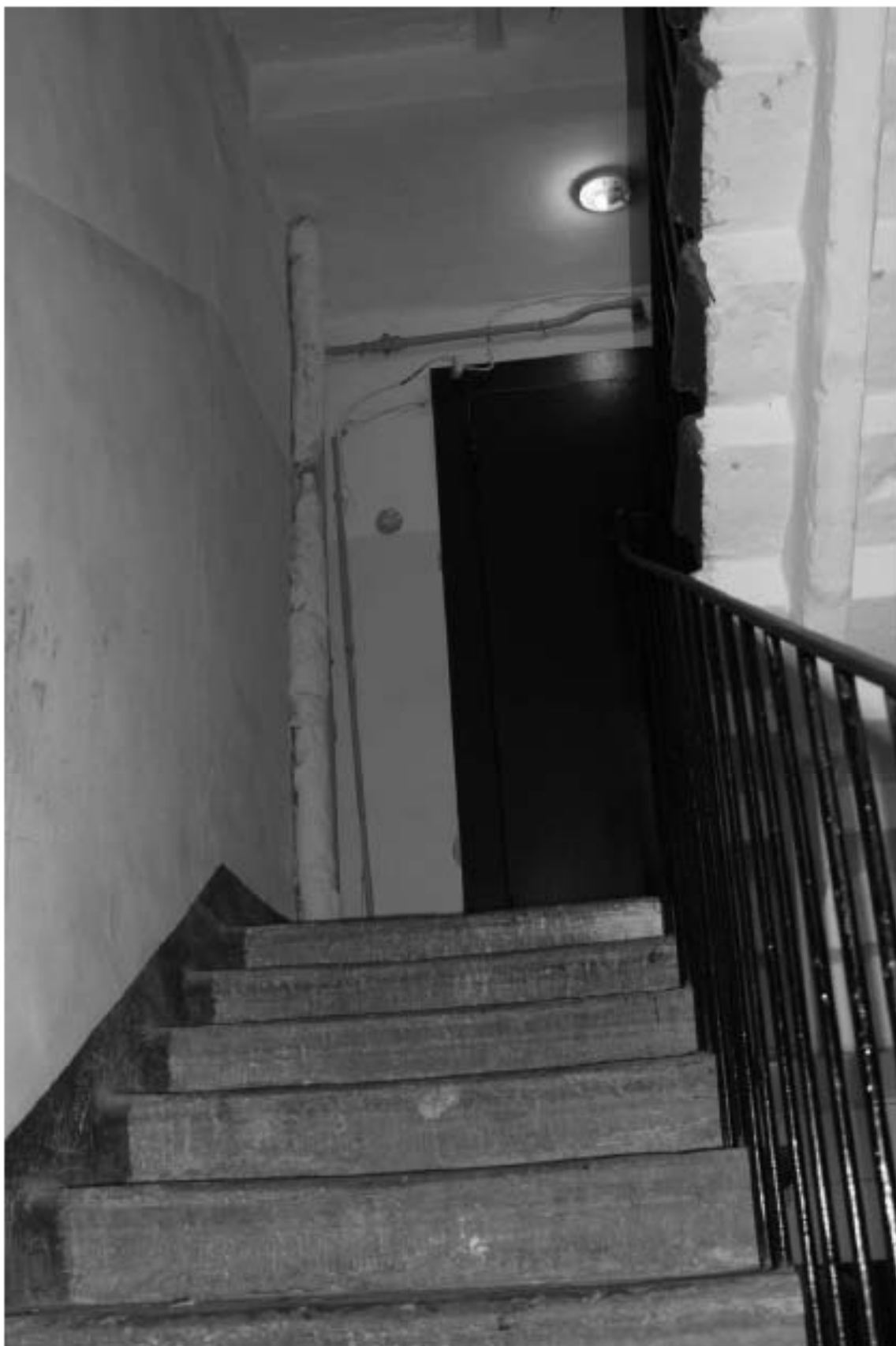
Фото 191. Лестница службы: Площадка 2-го этажа. Съемка 19.04.2021 г. Трушковский В.Э.
