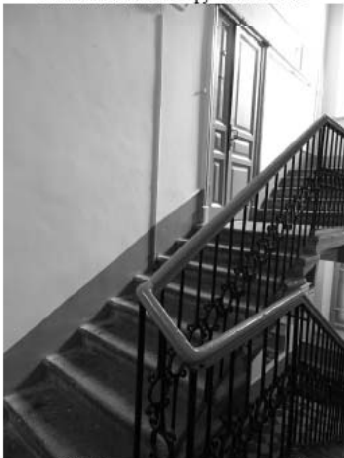
Фото 70. Лестница № 4. Промежуточная площадка м/у 1-м и 2-м этажом. Съемка 19.04.2021 г. Трушковский В.Э.
