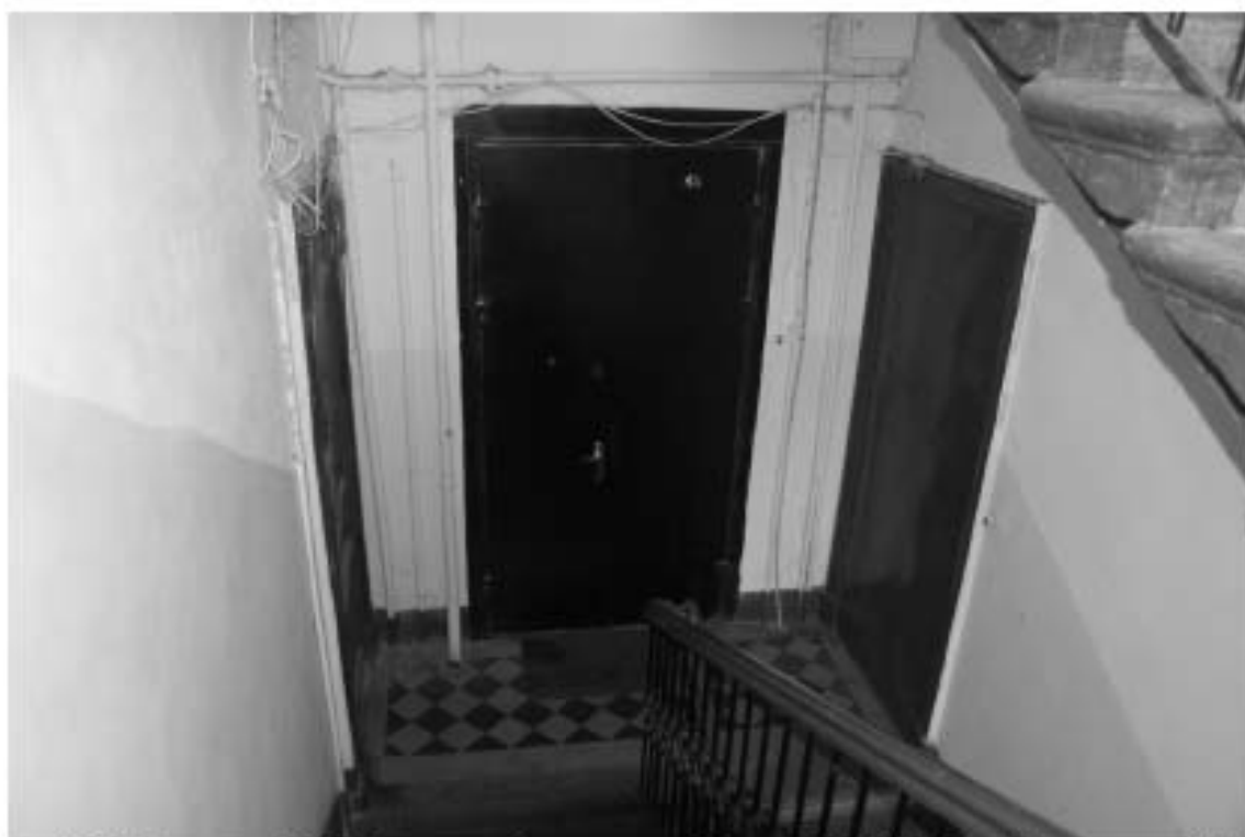
Фото 133. Лестница № 7. Площадка 3-го этажа. Съемка 19.04.2021 г. Трушковский В.Э.
