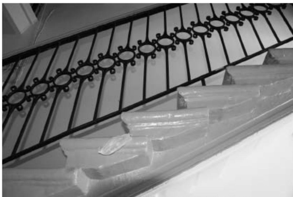
Фото 76. Лестница № 4. 3-й этаж. Лестничное ограждение. Съемка 19.04.2021 г. Трушковский В.Э.
