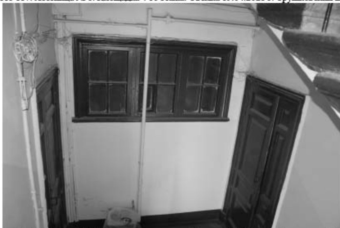
Фото 118. Лестница № 6. Площадка 4-го этажа. Съемка 19.04.2021 г. Трушковский В.Э.
