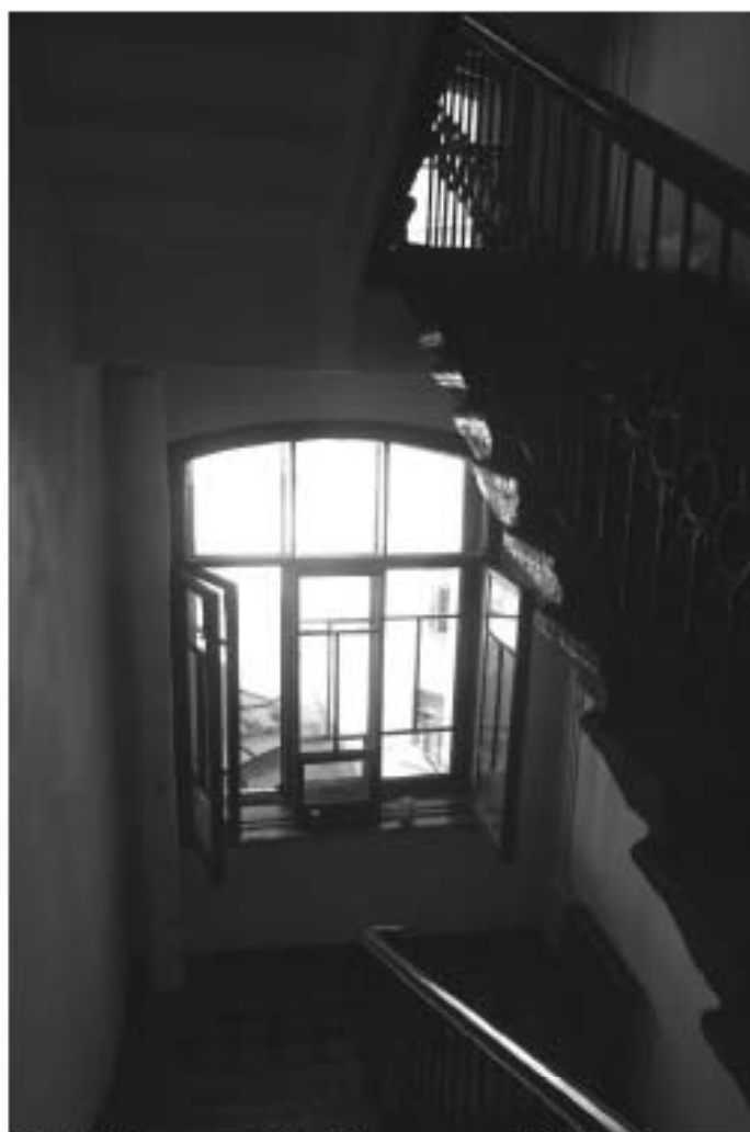
Фото 137. Лестница № 7. Площадка м/у 3-м и 4-м этажом. Съемка 19.04.2021 г. Трушковский В.Э.
