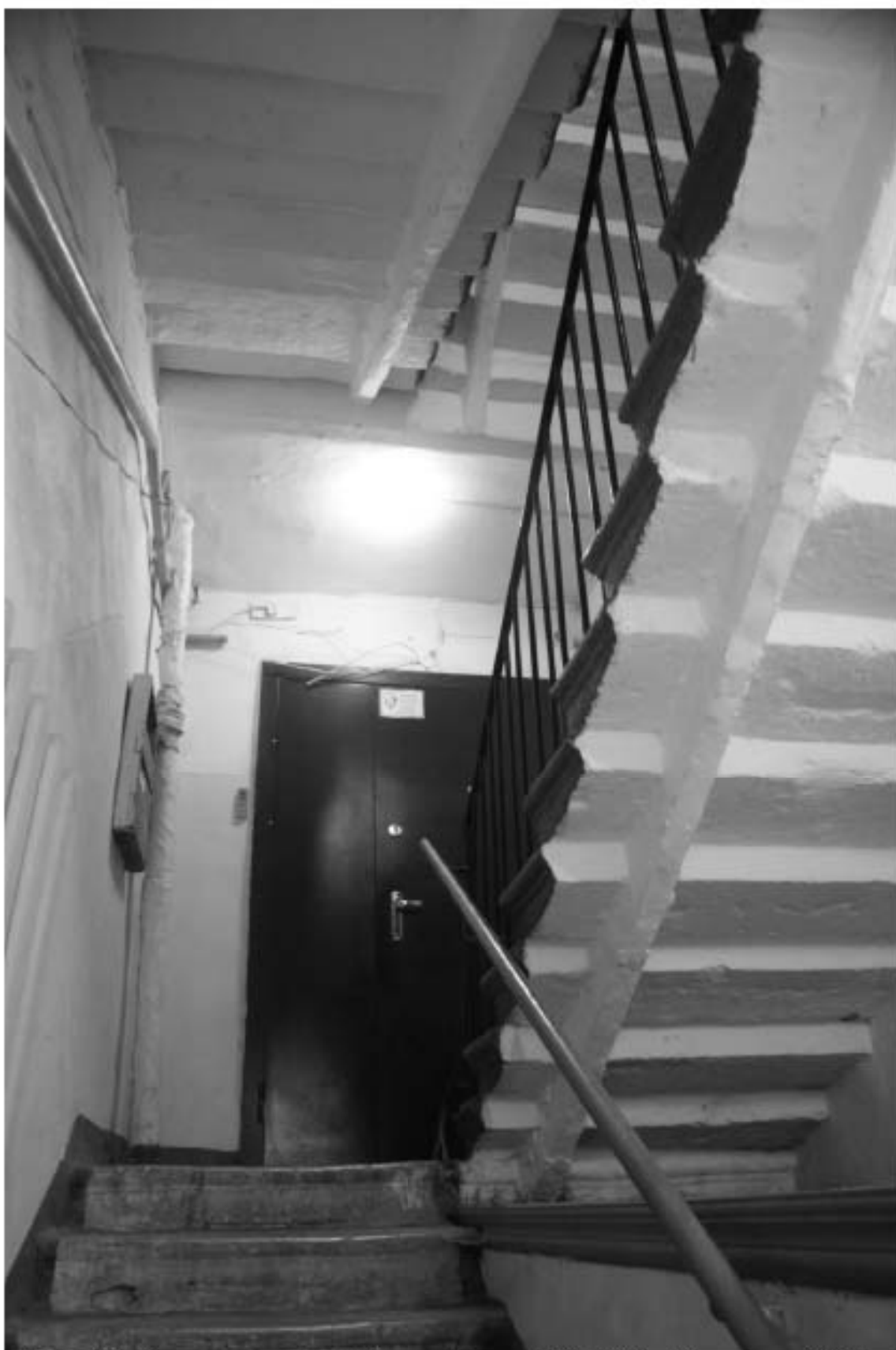
Фото 188. Лестница службы: 1-й этаж. Съемка 19.04.2021 г. Трушковский В.Э.
