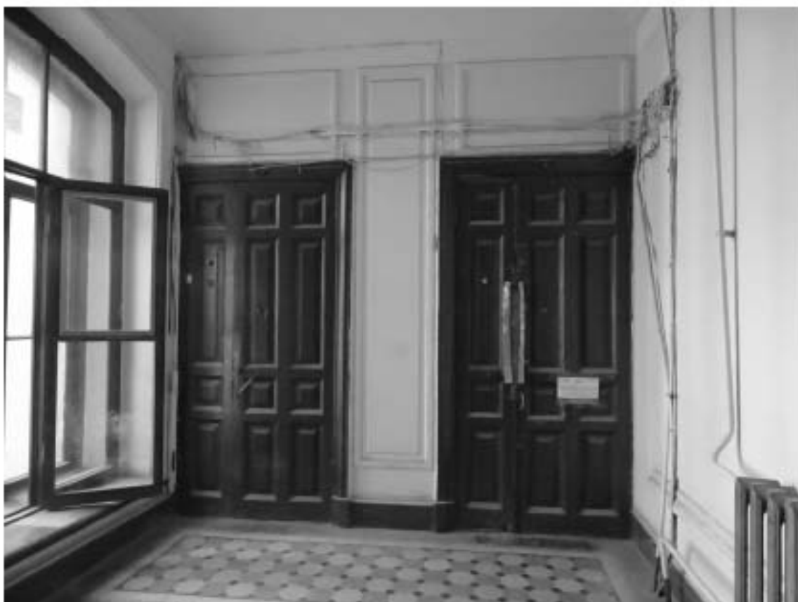
Фото 53. Лестница № 2. Площадка между 2-м и 3-м этажом. Съёмка 19.04.2021 г. Трушковский В.Э.
