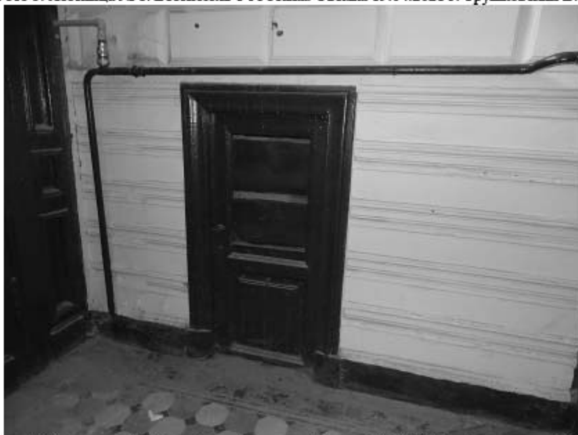
Фото 6. Лестница № 1. Вестибюль 1-го этажа. Съемка 19.04.2021 г. Трушковский В.Э.
