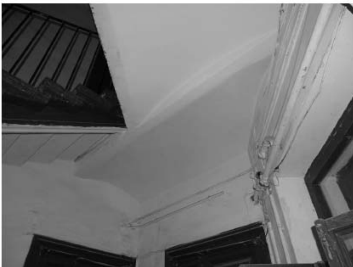
Фото 161. Лестница № 8. Площадка 2-го этажа. Съемка 19.04.2021 г. Трушковский В.Э.
