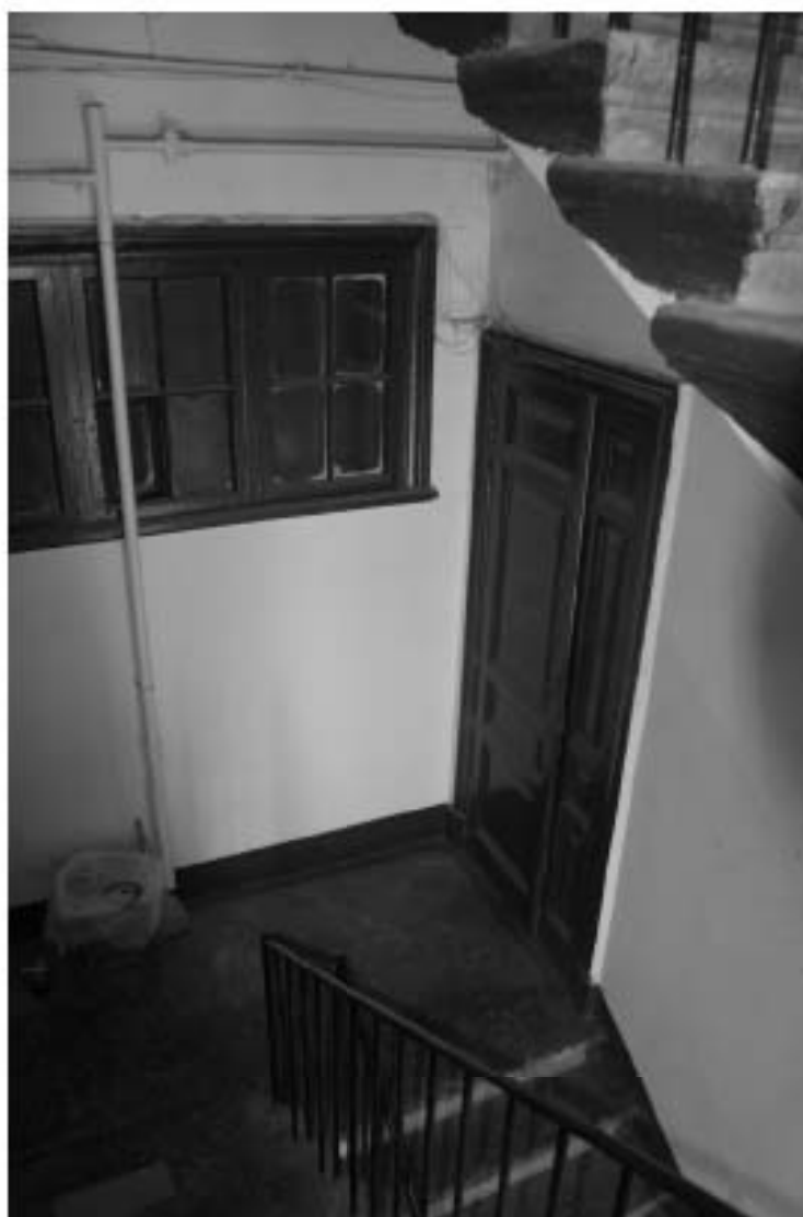
Фото 117. Лестница № 6. Площадка 4-го этажа. Съемка 19.04.2021 г. Трушковский В.Э.
