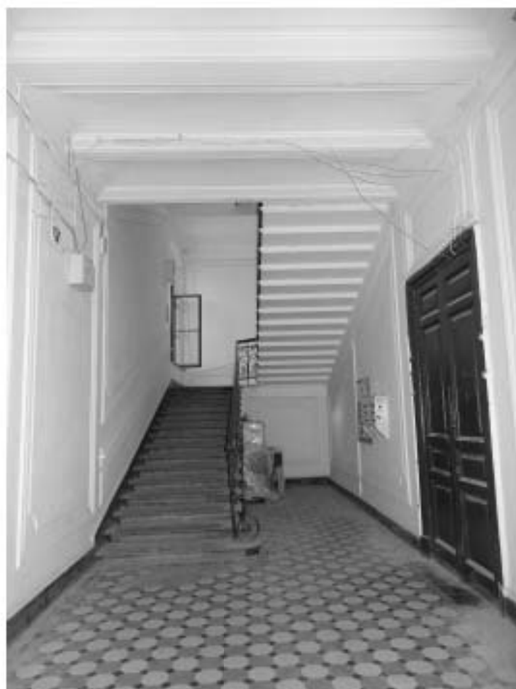
Фото 13. Лестница № 1. Вестибюль 1-го этажа. Съемка 19.04.2021 г. Трушковский В.Э.
