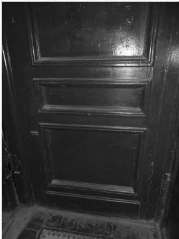
Фото 8. Лестница № 1. Вестибюль 1-го этажа. Входная дверь. Съёмка 19.04.2021 г. Трушковский В.Э.
