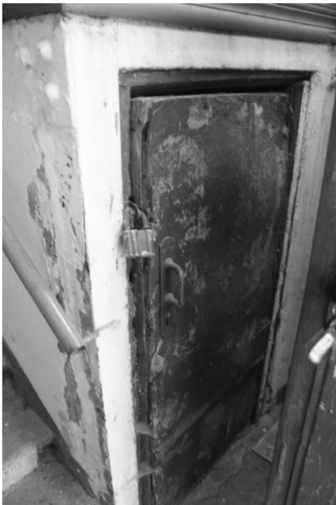
Фото 187. Лестница службы: 1-й этаж. Дверь в подвал. Съемка 19.04.2021 г. Трушковский В.Э.
