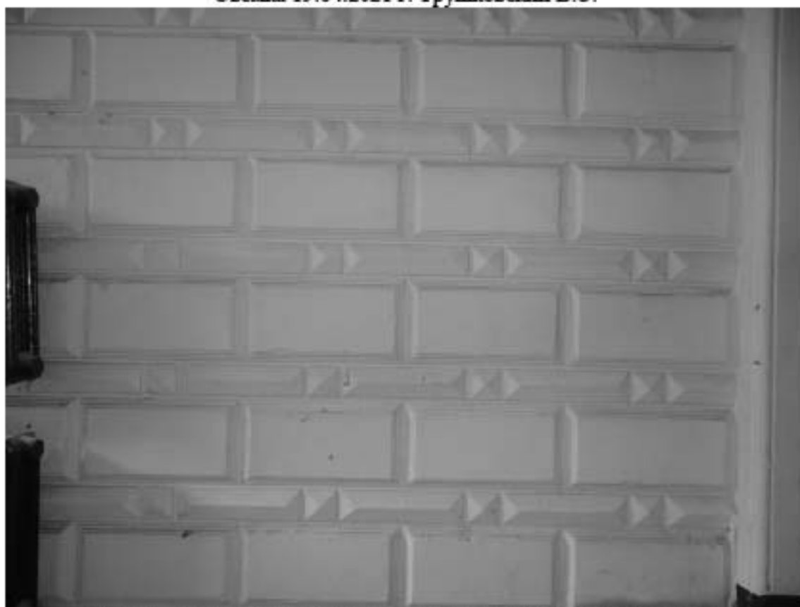
Фото 4. Лестница № 1. Вестибюль 1-го этажа. Оформление стен. Съемка 19.04.2021 г. Трушковский В.Э.
