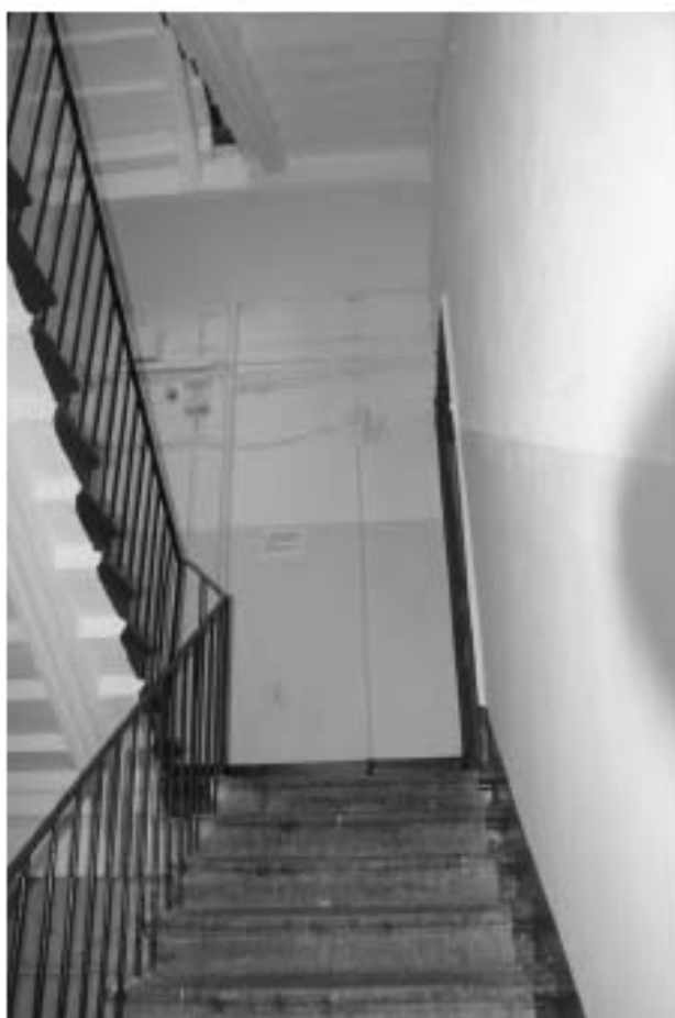
Фото 92. Лестница № 5. Площадка 2-го этажа. Съемка 19.04.2021 г. Трушковский В.Э.
