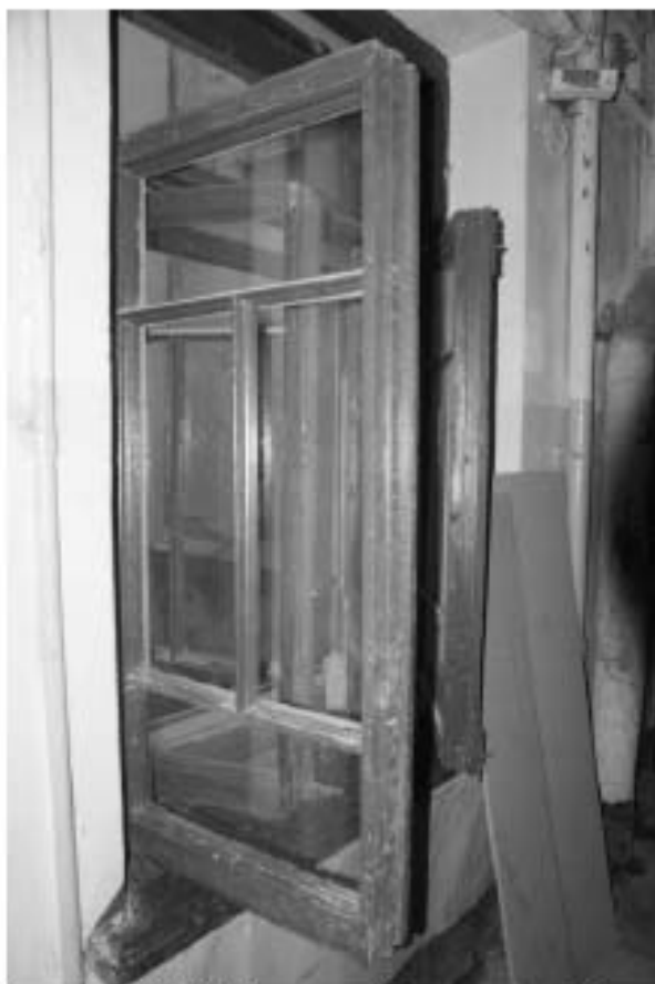
Фото 159. Лестница № 8. Площадка 2-го этажа. Оформление окна. Съемка 19.04.2021 г. Трушковский В.Э.
