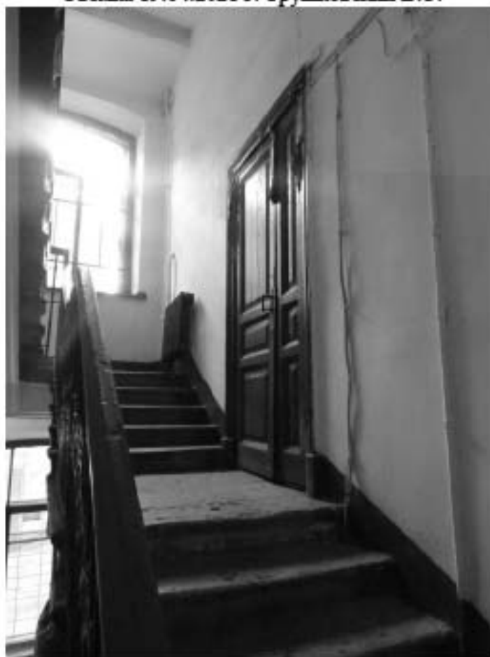
Фото 129. Лестница № 7. Промежуточная площадка м/у 1-м и 2-м этажом. Съемка 19.04.2021 г. Трушковский В.Э.
