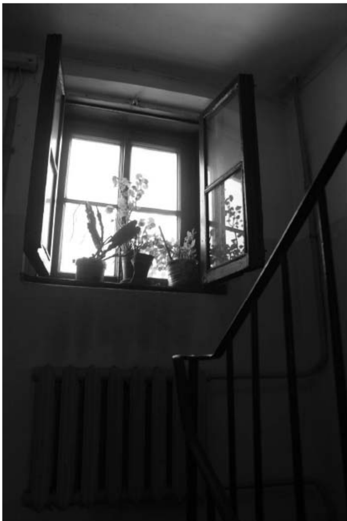
Фото 190. Лестница службы: Площадка м/у 1-м и 2-м этажом. Оформление окна. Съемка 19.04.2021 г. Трушковский В.Э.
