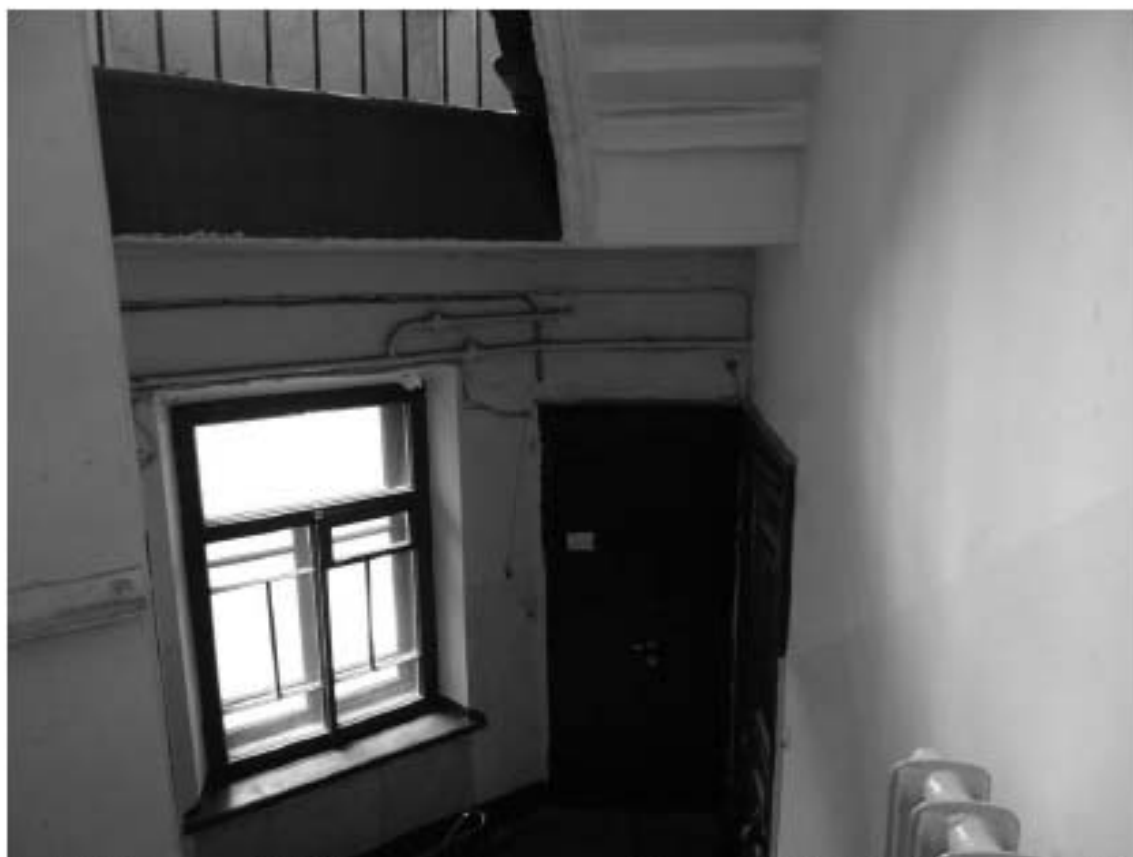
Фото 170. Лестница № 8. Площадка 4-го этажа. Съемка 19.04.2021 г. Трушковский В.Э.
