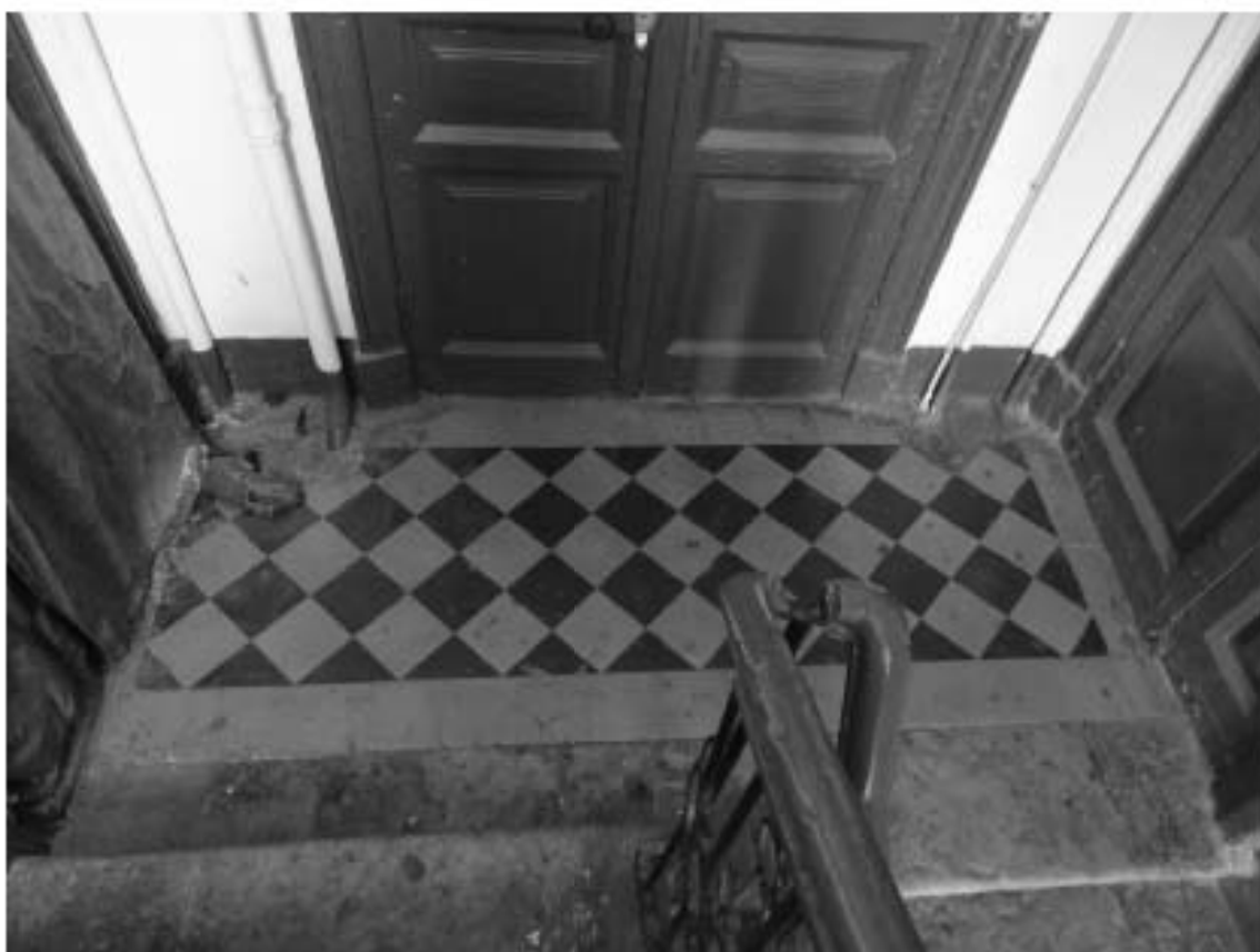
Фото 131. Лестница № 7. Площадка 2-го этажа. Покрытие пола. Съемка 19.04.2021 г. Трушковский В.Э.
