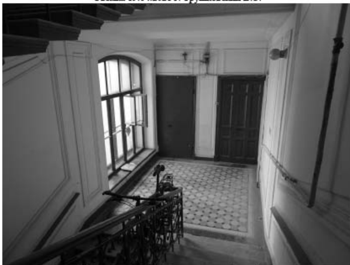
Фото 57. Лестница № 2. Площадка между 3-м и 4-м этажом. Съемка 19.04.2021 г. Трушковский В.Э.
