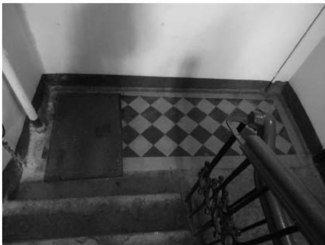
Фото 128. Лестница № 7. Площадка 1-го этажа. Покрытие пола. Съемка 19.04.2021 г. Трушковский В.Э.
