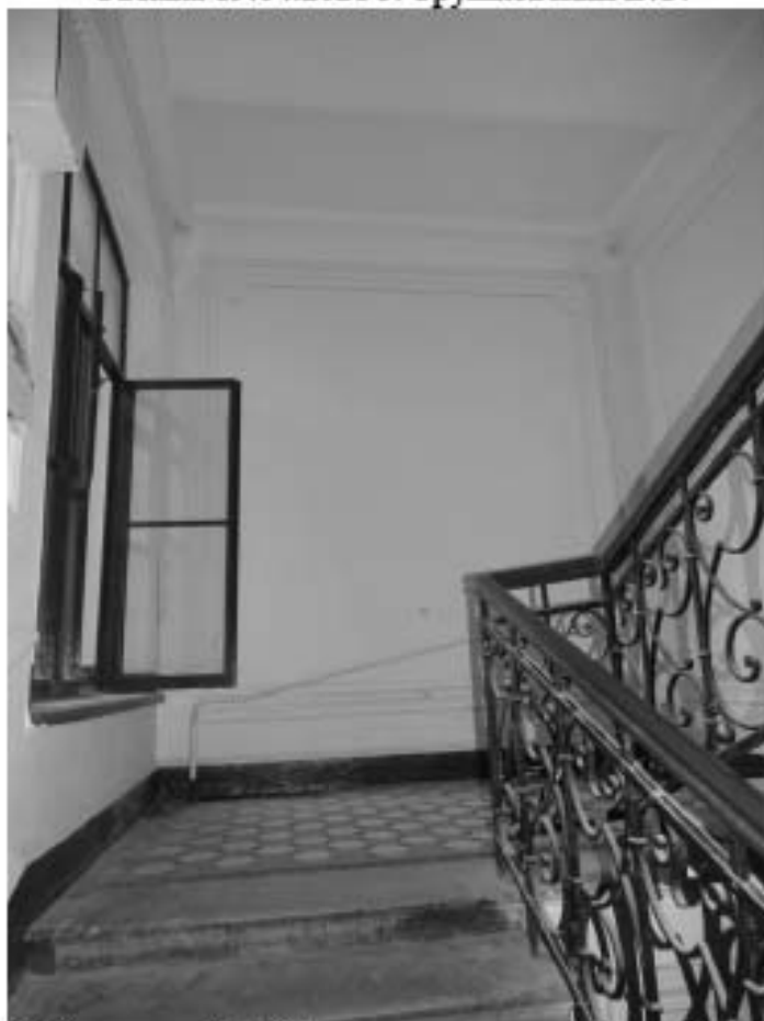
Фото 18. Лестница № 1. Вид на площадку м/у 1-м и 2-м этажом. Съемка 19.04.2021 г. Трушковский В.Э.
