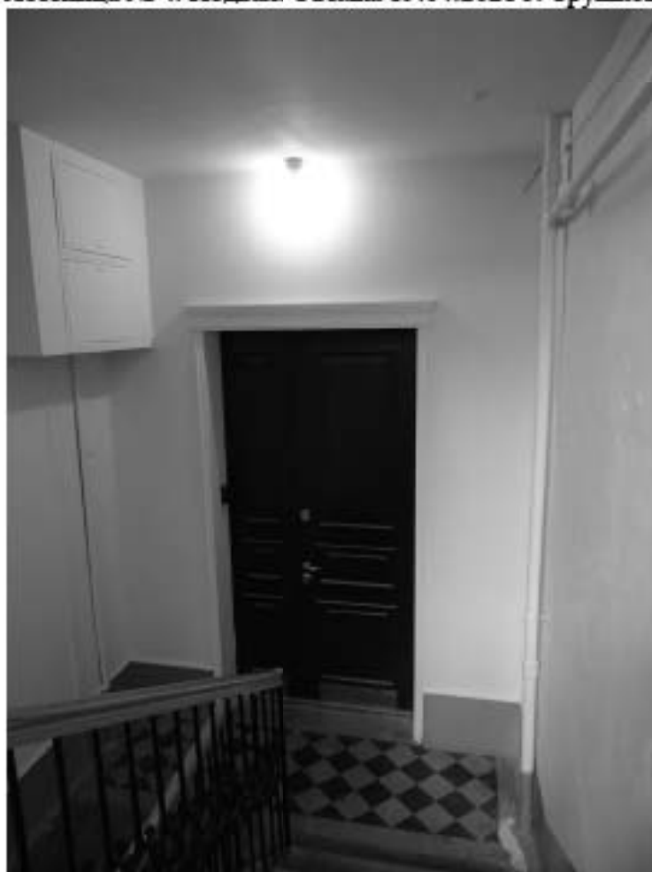
Фото 68. Лестница № 4. Площадка 1-го этажа. Съемка 19.04.2021 г. Трушковский В.Э.
