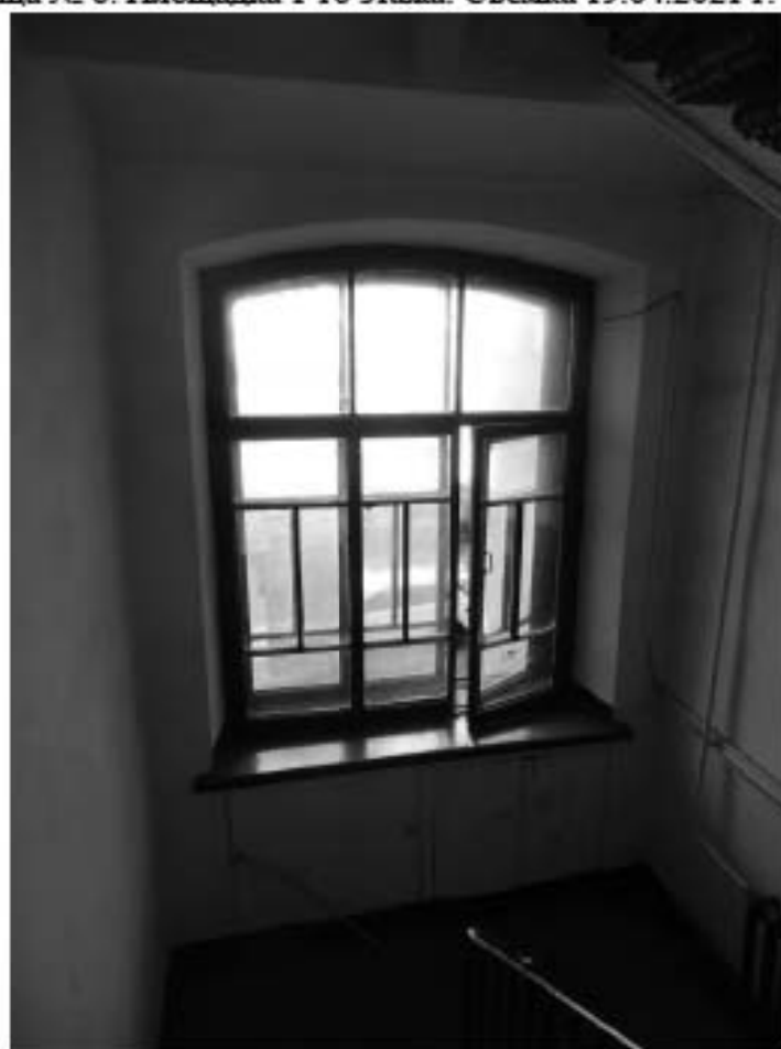
Фото 110. Площадка м/у 1-м и 2-м этажом. Съемка 19.04.2021 г. Трушковский В.Э.
