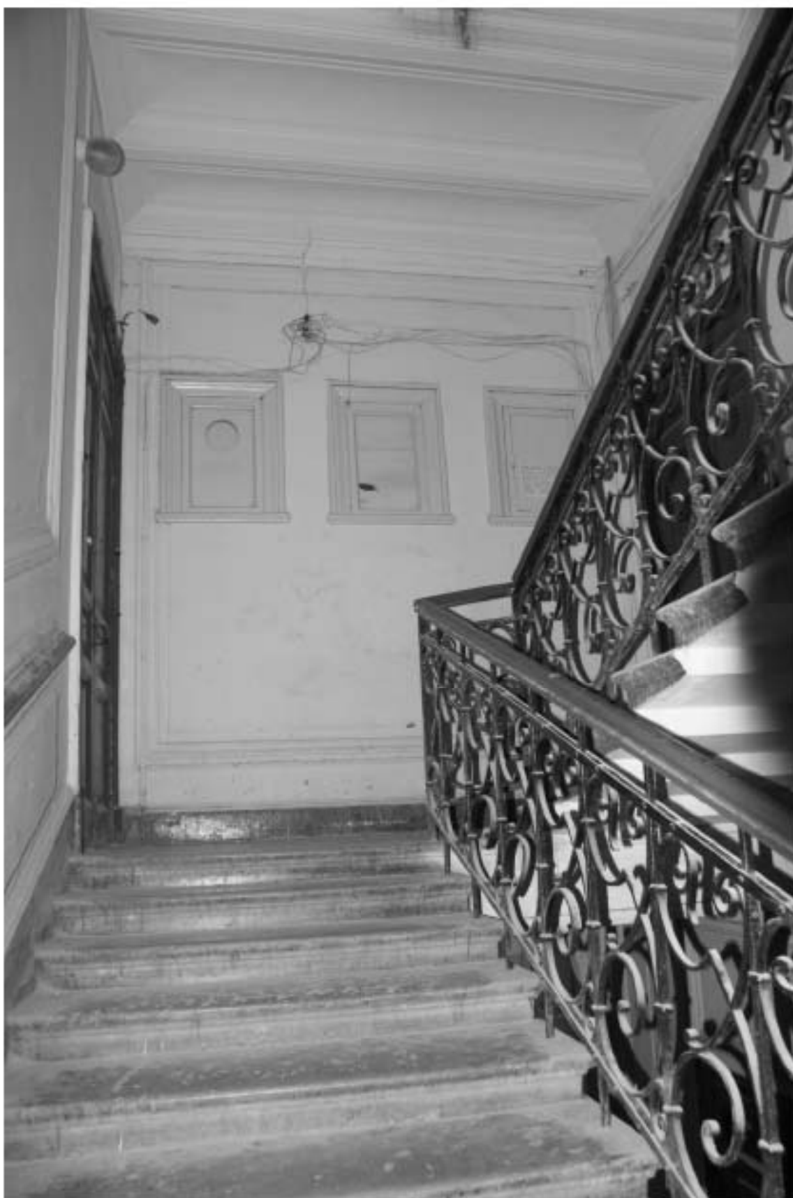
Фото 49. Лестница № 2. 2-й этаж. Съемка 19.04.2021 г. Трушковский В.Э.
