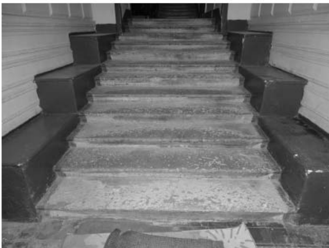
Фото 63. Лестница № 3. 1-й этаж. Вестибюль. Одномаршевая лестница. Съемка 19.04.2021 г. Трушковский В.Э.
