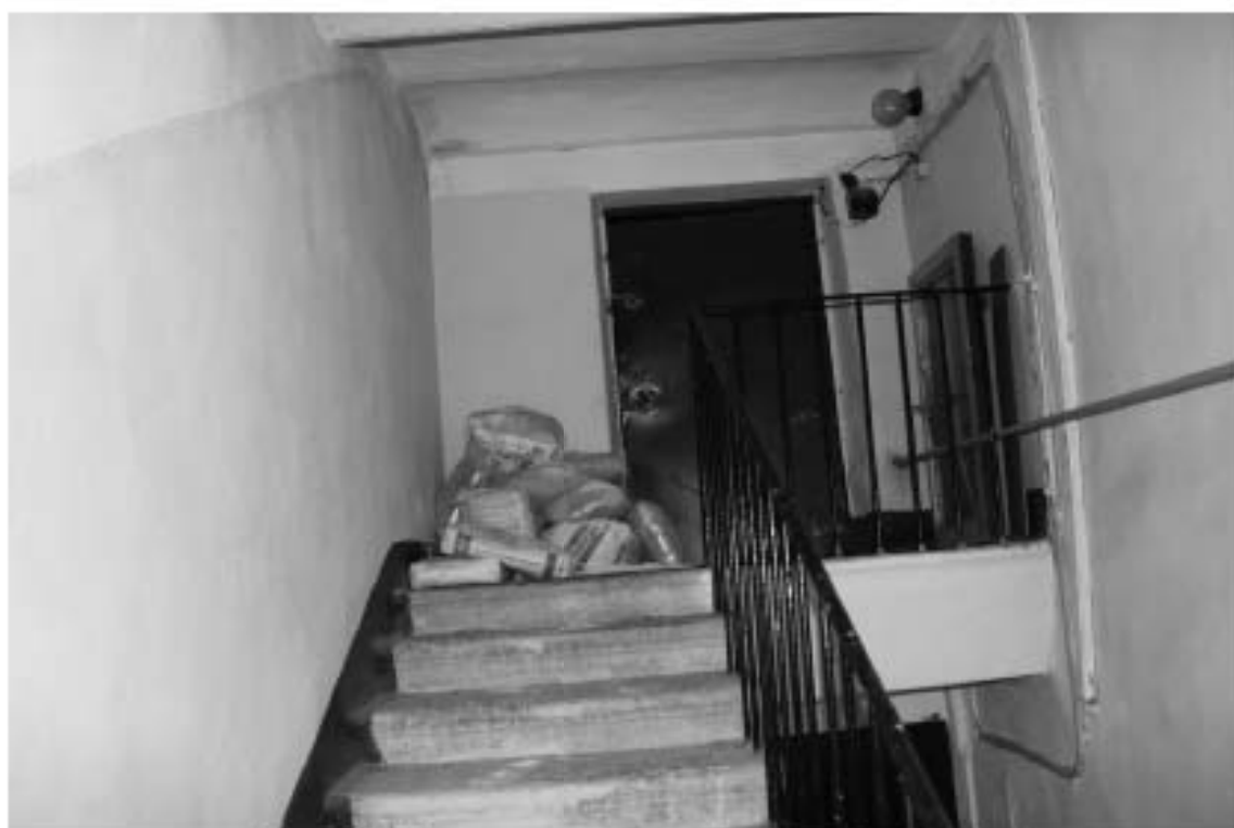
Фото 193. Лестница службы: Площадка 3-го этажа. Съемка 19.04.2021 г. Трушковский В.Э.
