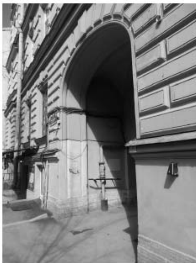
Фото 20. Здание по адресу: г. Санкт-Петербург, Тучков пер., 11/5, литера А. Фрагмент лицевого фасада со стороны Тучкова пер. Оформление воротного проезда. Съемка 19.04.2021 г. Трушковский В.Э.
