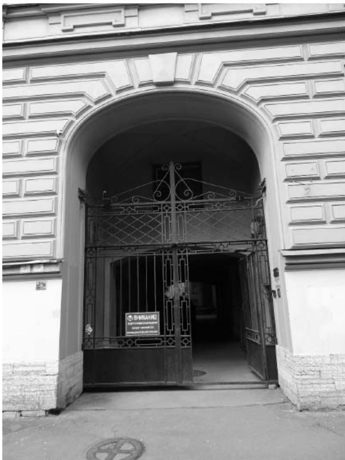
Фото 65. Здание по адресу: г. Санкт-Петербург, Тучков пер., 11/5, литера А. Оформление воротного проезда лицевого фасада со стороны Волховского пер. Съемка 19.04.2021 г. Трушковский В.Э.
