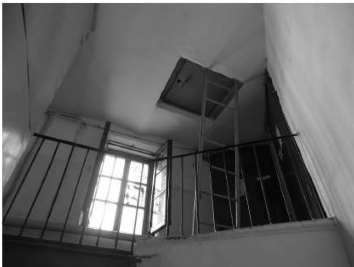
Фото 184. Лестница № 8. Площадка 6-го этажа. Съемка 19.04.2021 г. Трушковский В.Э.
