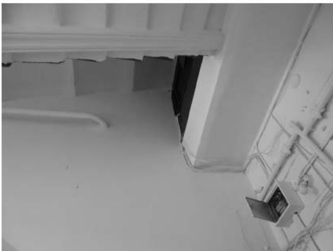
Фото 100. Лестница № 5. Площадка 4-го этажа. Оформление потолка. Съемка 19.04.2021 г. Трушковский В.Э.
