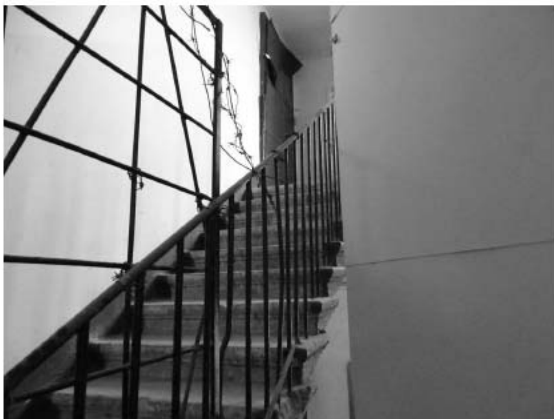
Фото 185. Лестница № 8. Вид на площадку 6-го этажа. Съемка 19.04.2021 г. Трушковский В.Э.
