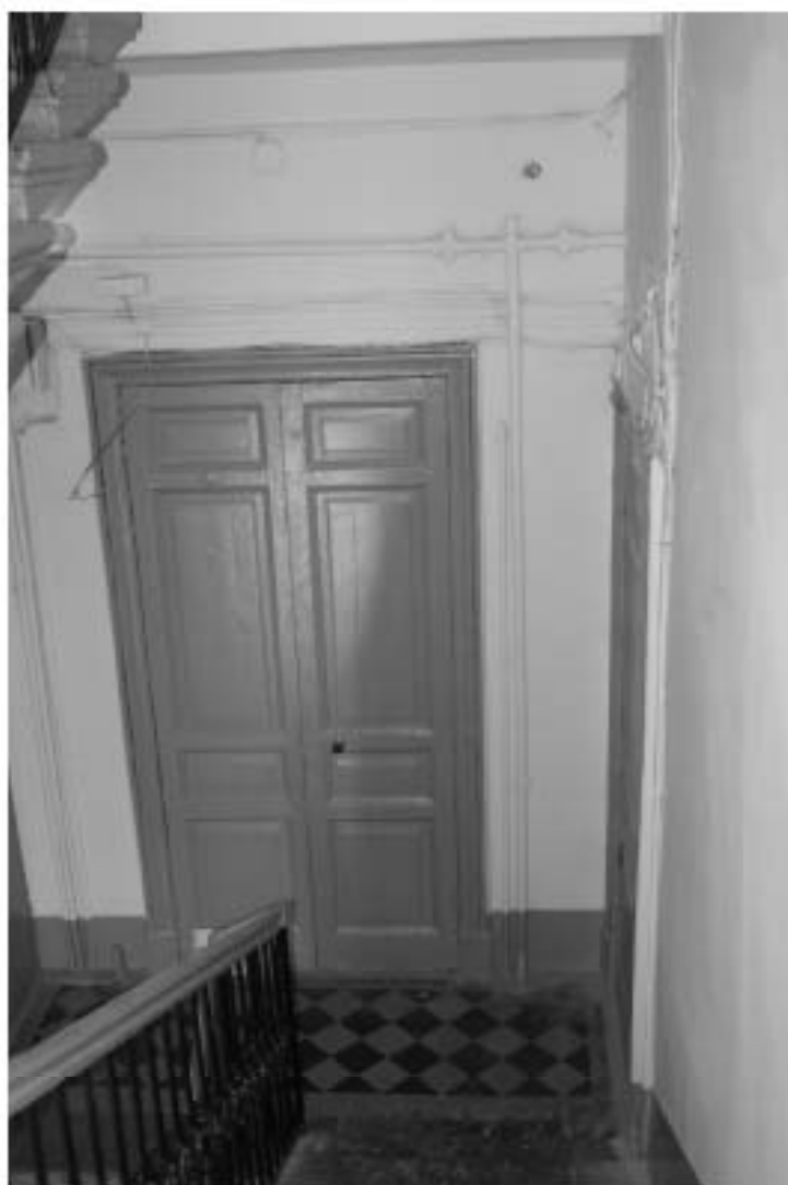
Фото 79. Лестница № 4. 4-й этаж. Съемка 19.04.2021 г. Трушковский В.Э.
