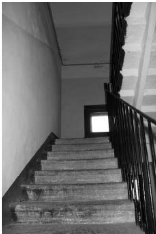
Фото 192. Лестница службы: Площадка м/у 2-м и 3-м этажом. Съемка 19.04.2021 г. Трушковский В.Э.
