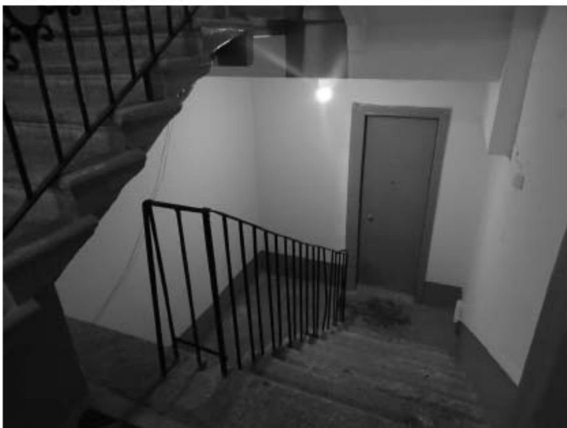
Фото 67. Лестница № 4. Подвал. Съемка 19.04.2021 г. Трушковский В.Э.
