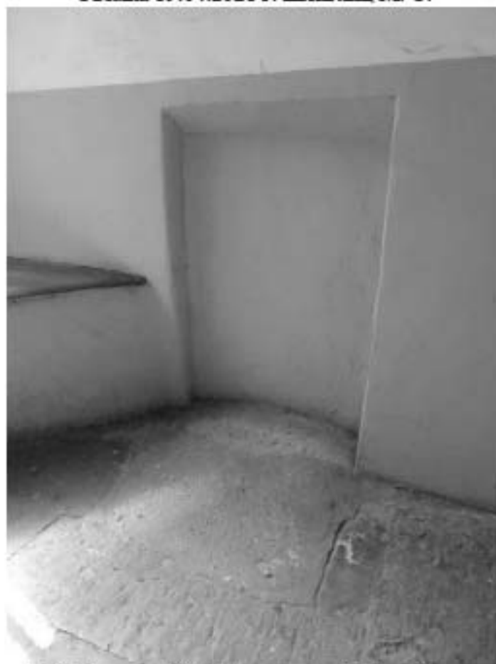
Фото 112. Лестница № 4. Площадка м/у 1-м и 2-м этажом. Съемка 19.04.2021 г. Штиглиц М. С.
