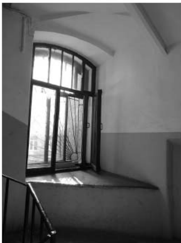
Фото 113. Лестница № 4. Площадка м/у 1-м и 2-м этажом. Оконный проем. Съемка 19.04.2021 г. Штиглиц М. С.
