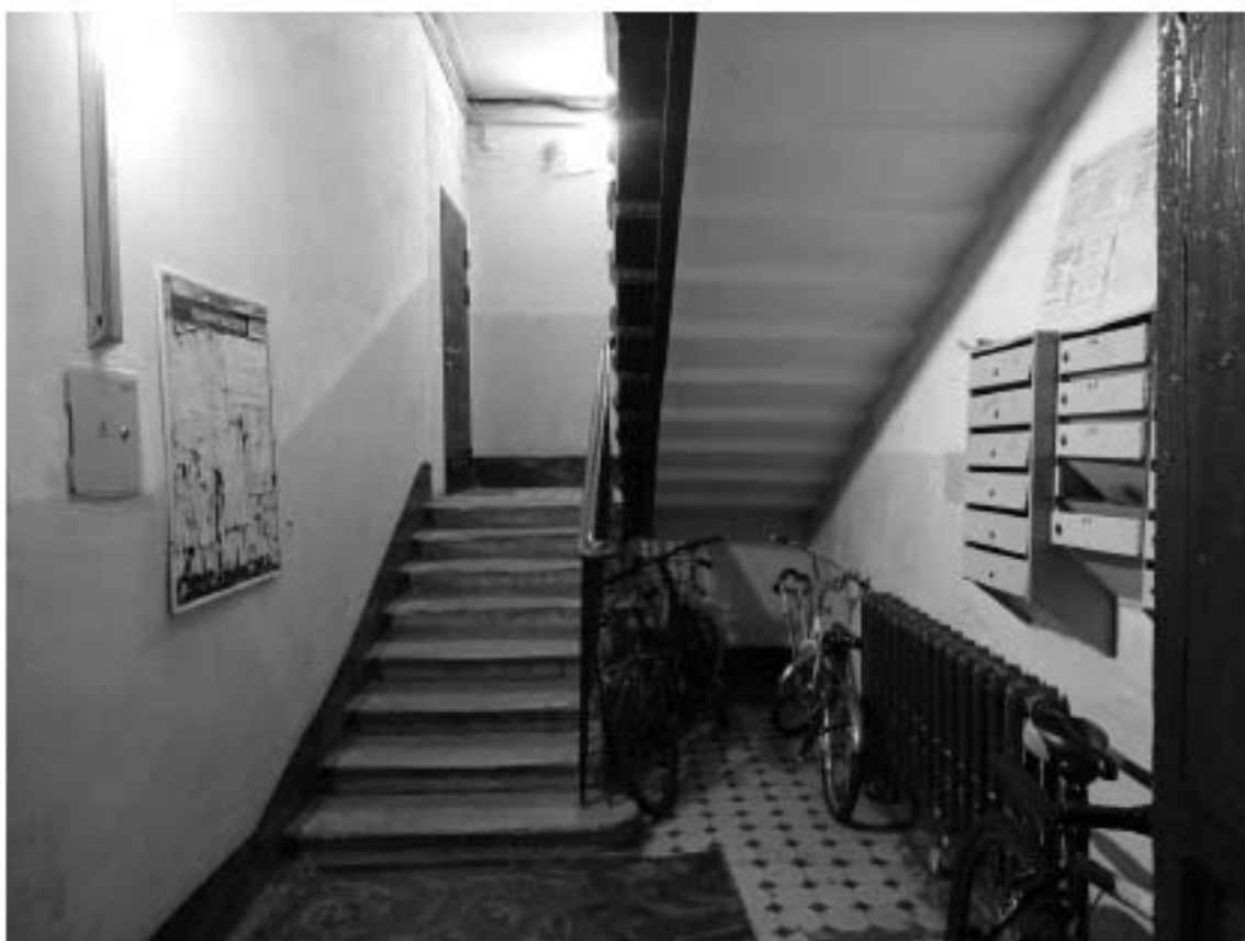
Фото 51. Лестница № 2. Вид на площадку 1-го этажа. Съемка 19.04.2021 г. Штиглиц М. С.
