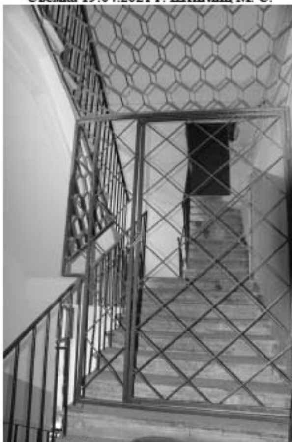
Фото 134. Лестница № 4. Закрытая металлическая решетка на 6-й этаж. Съемка 19.04.2021 г. Штиглиц М. С.
