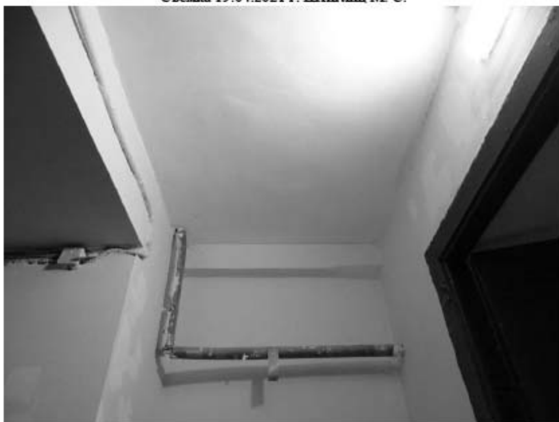
Фото 4. Лестница № 1. 1-й этаж. Тамбур. Съемка 19.04.2021 г. Штиглиц М. С.
