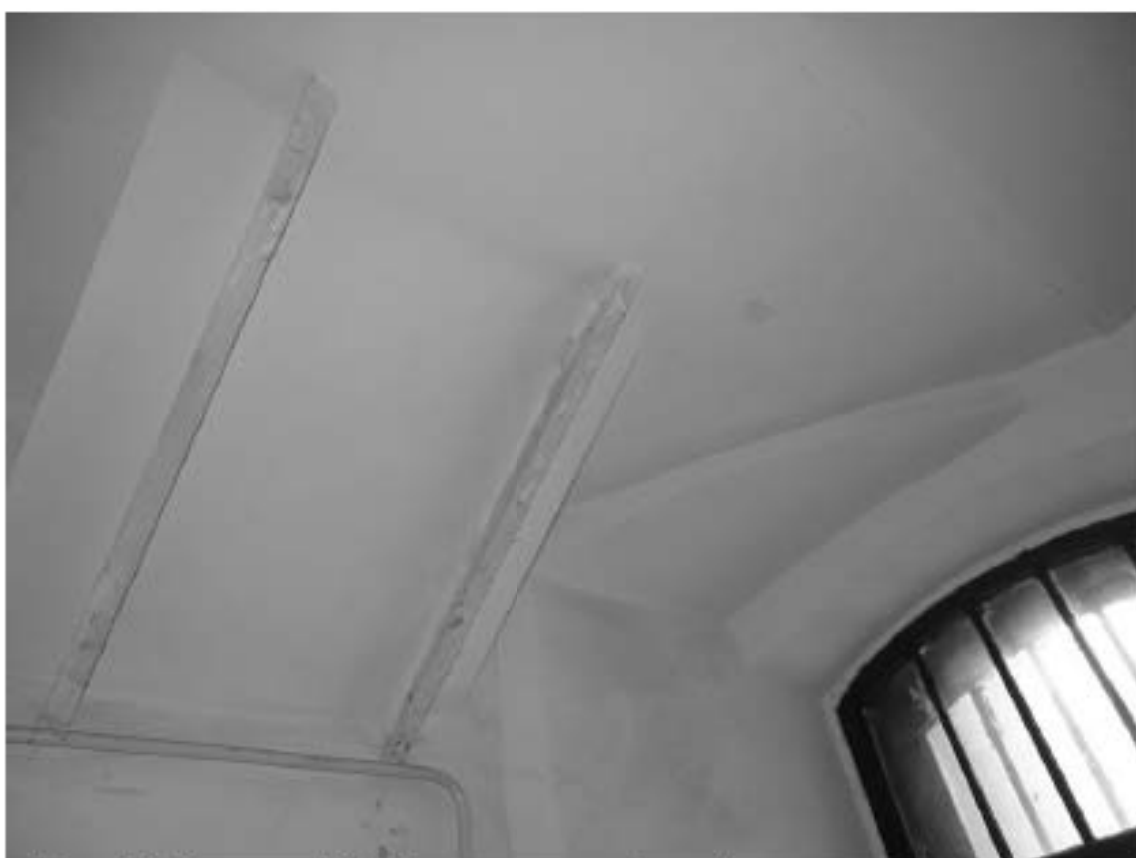
Фото 162. Лестница № 5. Площадка между 3-м и 4-м этажом. Оконный проем. Съемка 19.04.2021 г. Штиглиц М. С.
