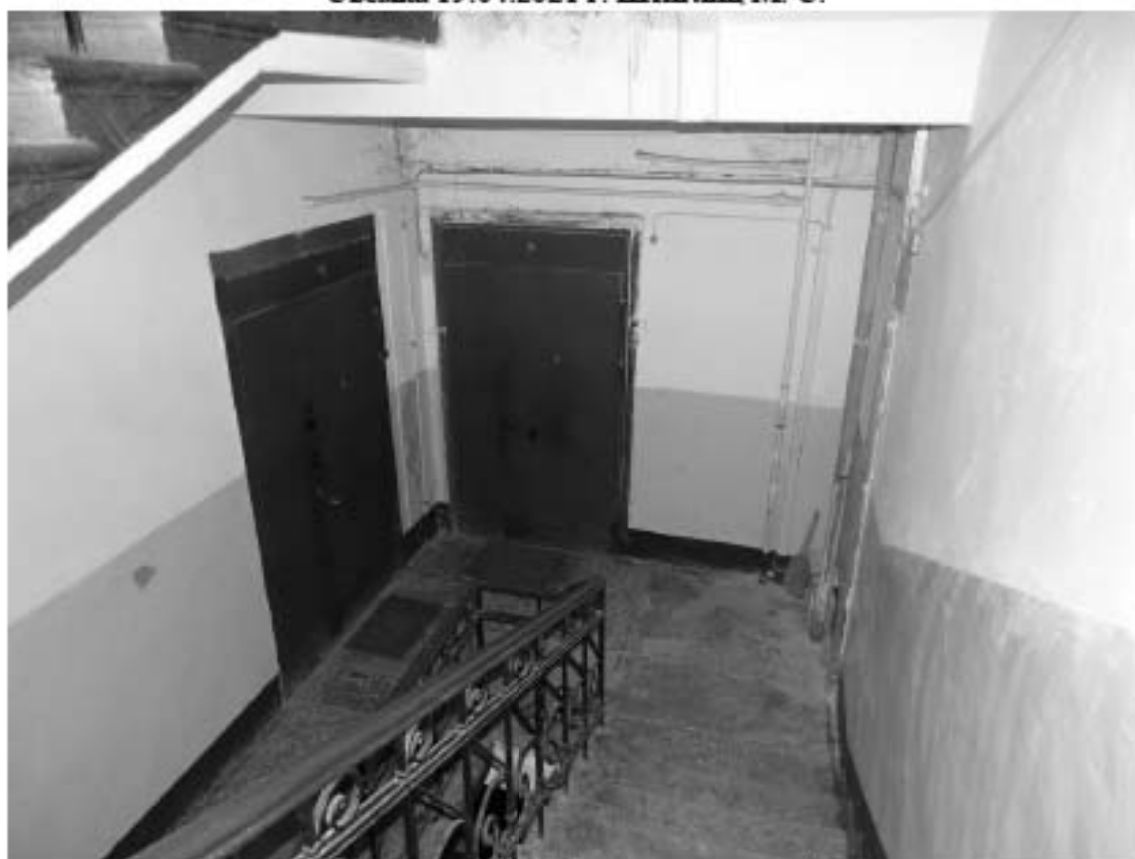
Фото 164. Лестница № 5. Вид на площадку 4-го этажа. Съемка 19.04.2021 г. Штиглиц М. С.
