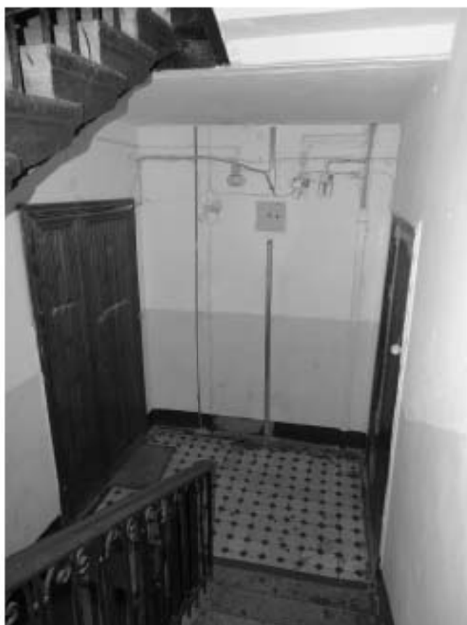
Фото 61. Лестница № 2. Вид на площадку 3-го этажа. Съемка 19.04.2021 г. Штиглиц М. С.
