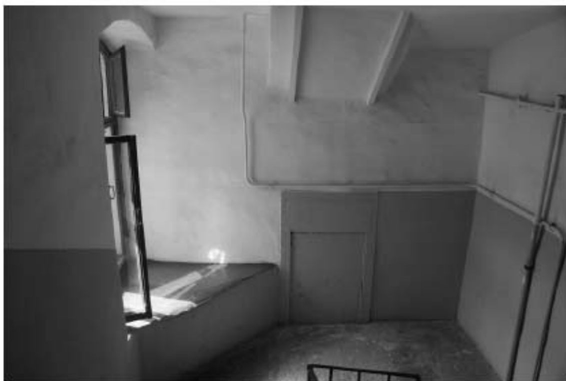
Фото 128. Лестница № 4. Вид на площадку м/у 4-м и 5-м этажом. Съемка 19.04.2021 г. Штиглиц М. С.
