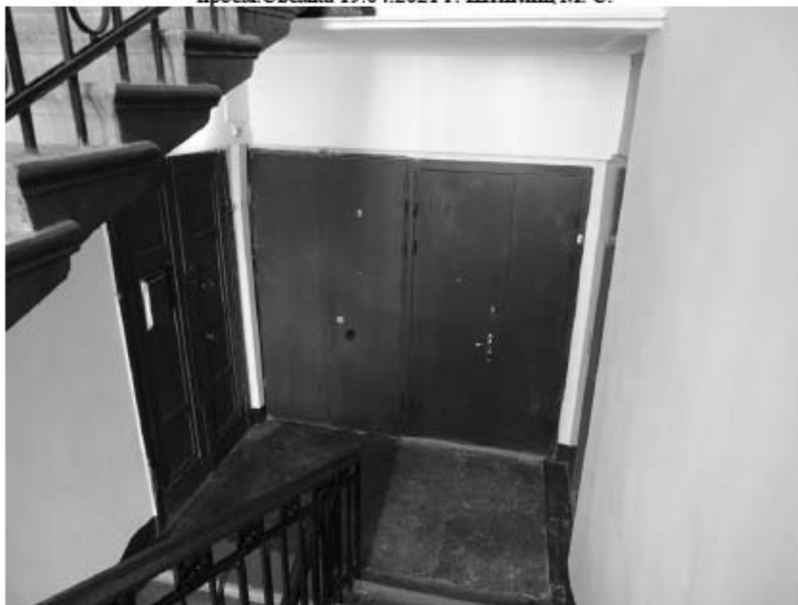
Фото 30. Лестница № 1. Вид на площадку 4-го этажа. Съемка 19.04.2021 г. Штиглиц М. С.
