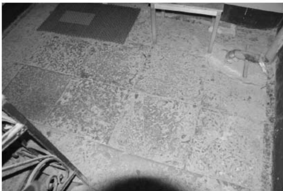
Фото 142. Лестница № 5. Площадка 1-го этажа. Покрытие пола. Съемка 19.04.2021 г. Штиглиц М. С.
