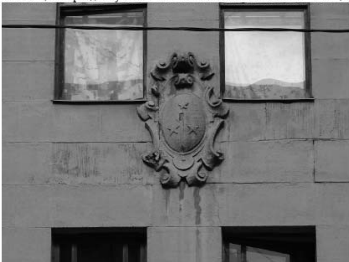
Фото 1611. Здание по адресу: г. Санкт-Петербург, Большая Зеленина ул., дом 29, литера А. Фрагмент лицевого фасада по ул. Большая Зеленина. Овальный лепной картуш. Съемка 19.04.2021 г. Штиглиц М. С.
