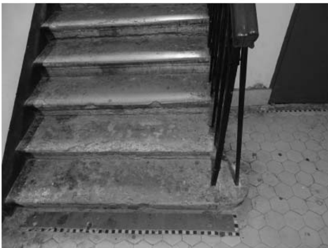
Фото 11. Лестница № 1. Вестибюль. 1-й этаж. Покрытие пола. Съемка 19.04.2021 г. Штиглиц М. С.
