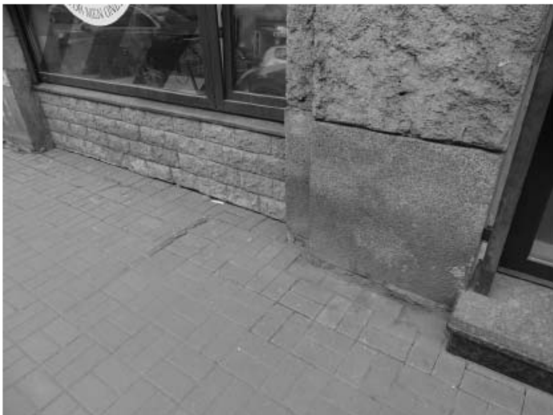
Фото 23. Здание по адресу: г. Санкт-Петербург, Большая Зеленина ул., дом 29, литера А. Фрагмент лицевого фасада по ул. Большая Зеленина. Гранитный цоколь. Съемка 19.04.2021 г. Штиглиц М. С.
