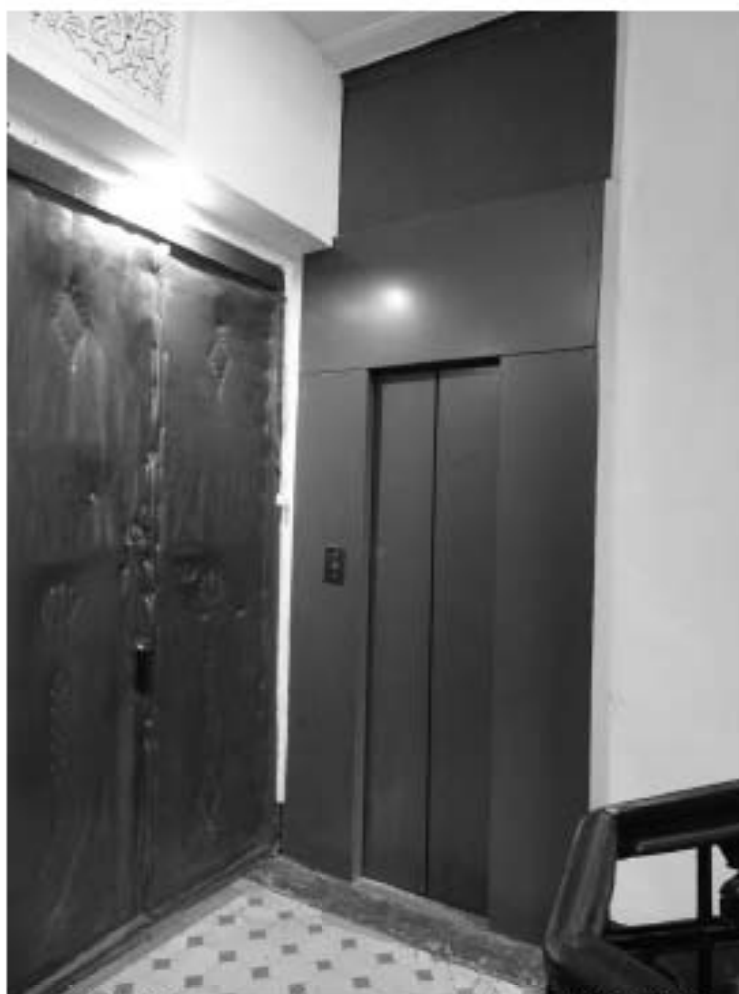
Фото 19. Лестница № 1. Площадка 2-го этажа. Съемка 19.04.2021 г. Штиглиц М. С.
