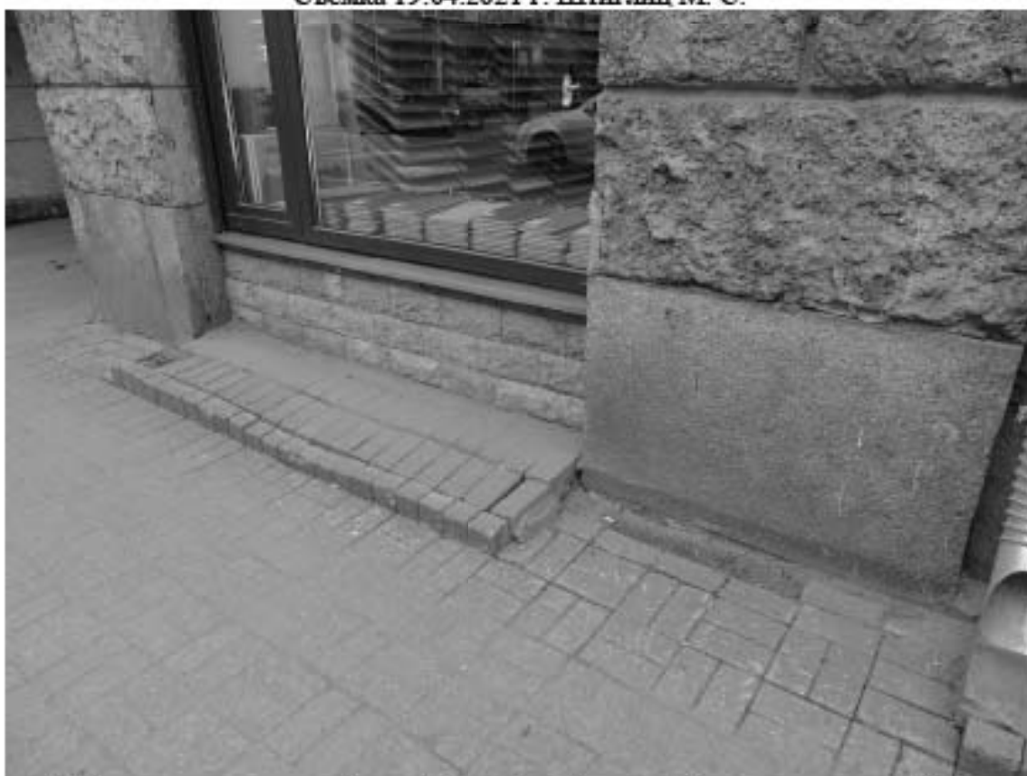
Фото 24. Здание по адресу: г. Санкт-Петербург, Большая Зеленина ул., дом 29, литера А. Фрагмент лицевого фасада по ул. Большая Зеленина. Гранитный цоколь. Съемка 19.04.2021 г. Штиглиц М. С.
