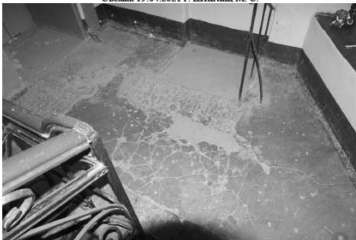
Фото 156. Лестница № 5. Площадка между 2-м и 3-м этажом. Покрытие пола. Съемка 19.04.2021 г. Штиглиц М. С.
