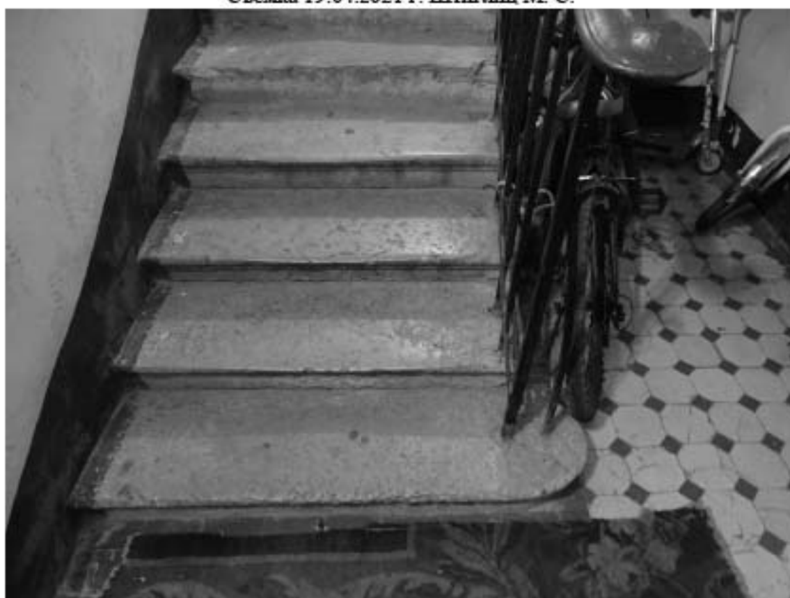
Фото 50. Лестница № 2. Вестибюль. 1-й этаж. Съемка 19.04.2021 г. Штиглиц М. С.
