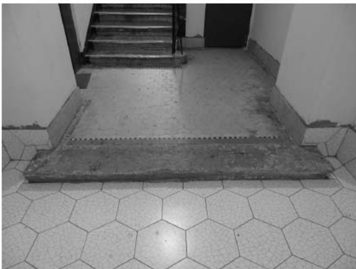
Фото 9. Лестница № 1. Вестибюль. 1-й этаж. Покрытие пола. Съемка 19.04.2021 г. Штиглиц М. С.
