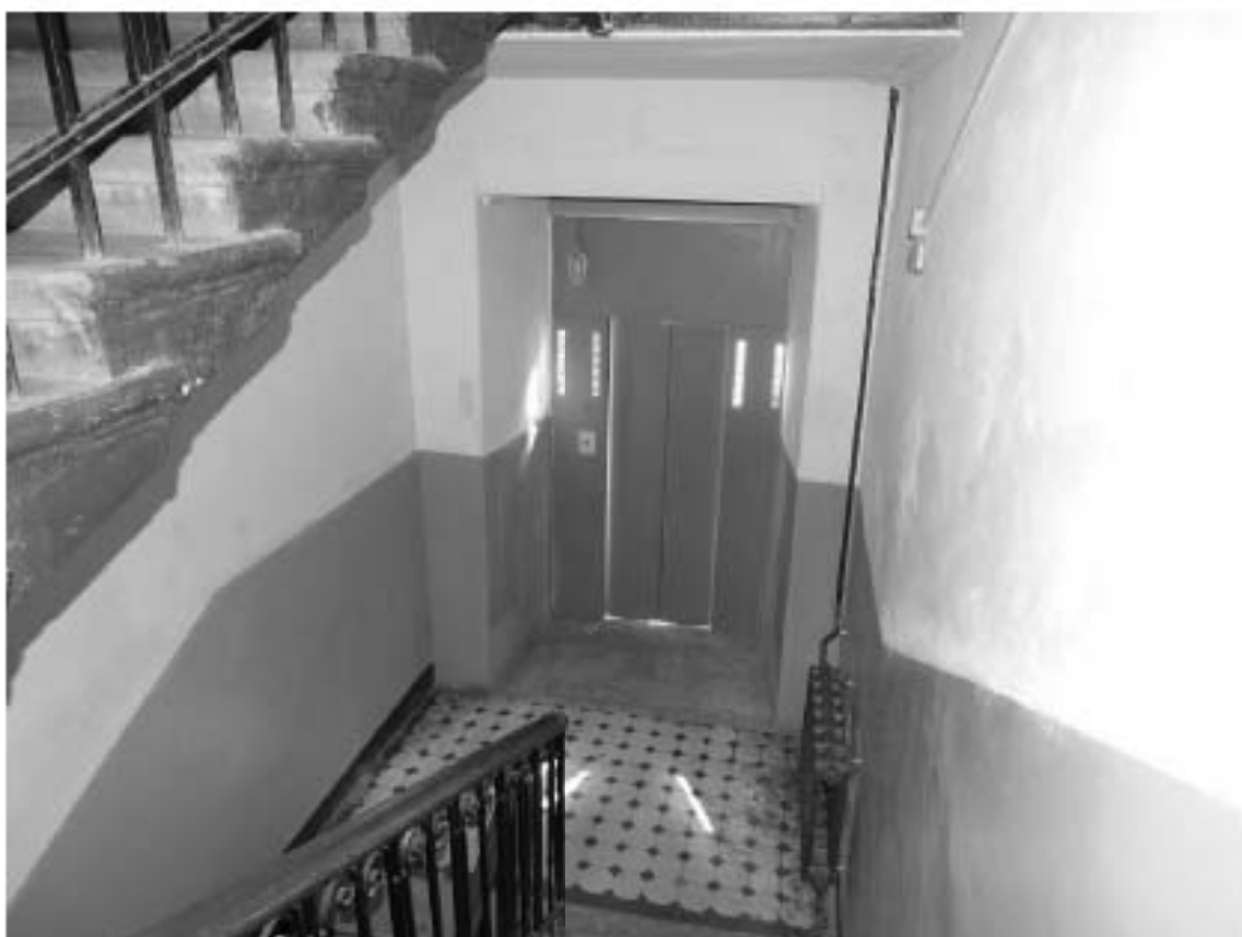
Фото 90. Лестница № 3. Вид на площадку м/у 3-м и 4-м этажом. Съемка 19.04.2021 г. Штиглиц М. С.
