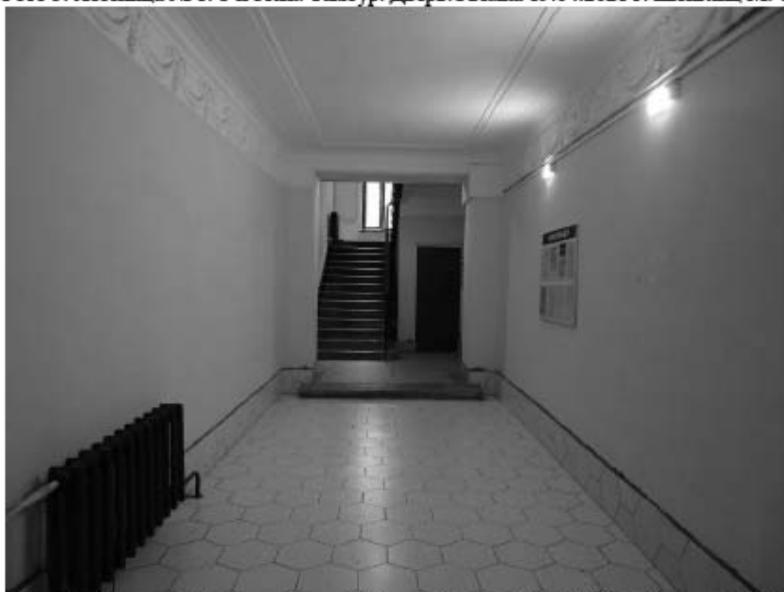
Фото 6. Лестница № 1. Вестибюль. 1-й этаж. Съёмка 19.04.2021 г. Штиглиц М. С.
