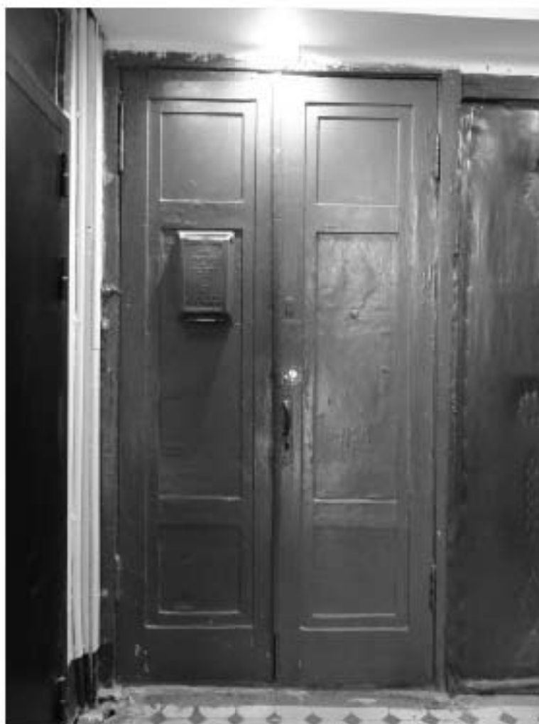
Фото 21. Лестница № 1. Площадка 2-го этажа. Съемка 19.04.2021 г. Штиглиц М. С.
