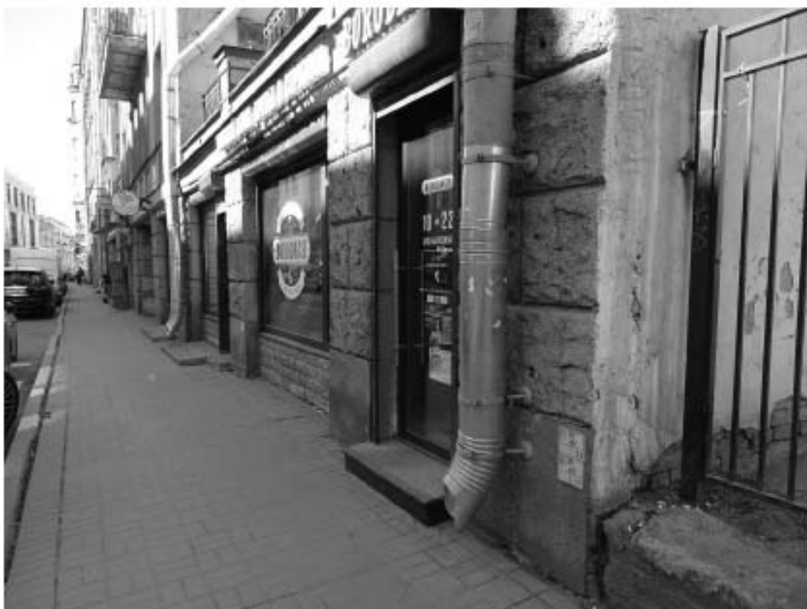
Фото 21. Здание по адресу: г. Санкт-Петербург, Большая Зеленина ул., дом 29, литера А. Фрагмент лицевого фасада по ул. Большая Зеленина. Проем парадного входа. Съемка 19.04.2021 г. Штиглиц М. С.
