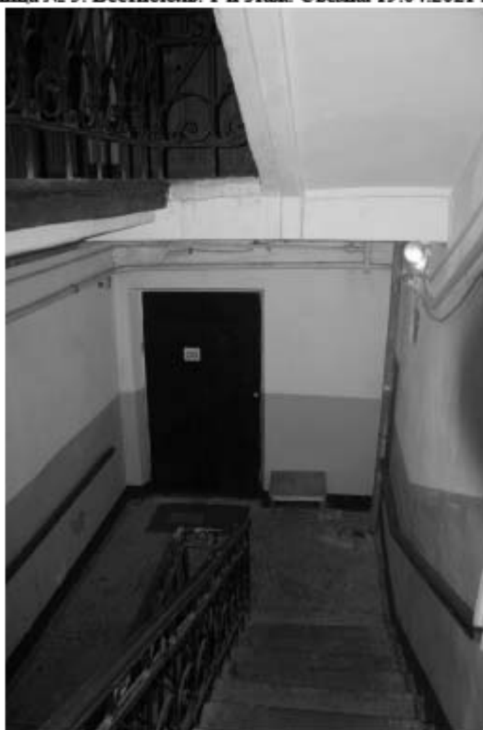
Фото 140. Лестница № 5. Вид на площадку 1-го этажа. Съёмка 19.04.2021 г. Штиглиц М. С.
