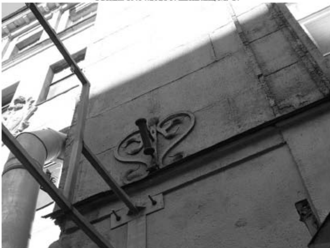
Фото 22. Здание по адресу: г. Санкт-Петербург, Большая Зеленина ул., дом 29, литера А. Фрагмент лицевого фасада по ул. Большая Зеленина. Флагодержатель. Съемка 19.04.2021 г. Штиглиц М. С.
