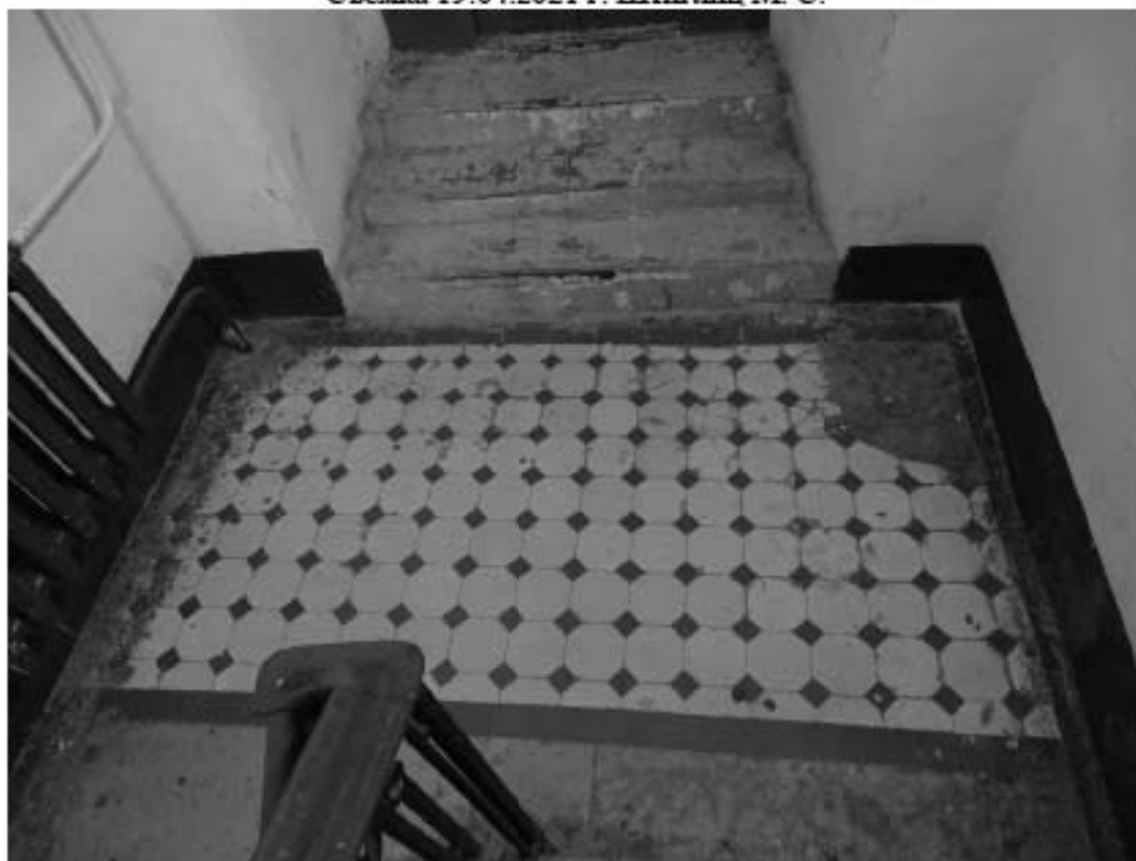
Фото 56. Лестница № 2. Площадка м/у 1-м и 2-м этажом. Покрытие пола. Съемка 19.04.2021 г. Штиглиц М. С.
