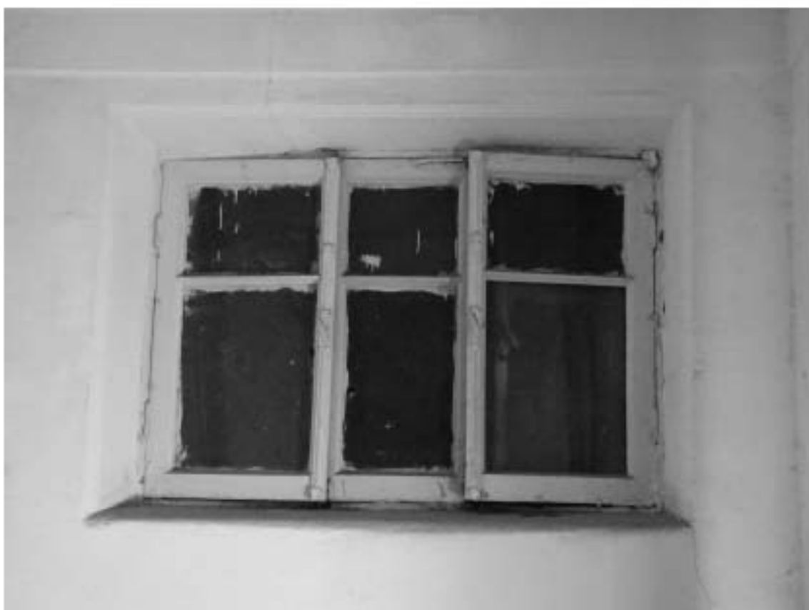
Фото 98. Лестница № 3. Площадка м/у 5-м и 6-м этажом. Оконные проем. Съемка 19.04.2021 г. Штиглиц М. С.
