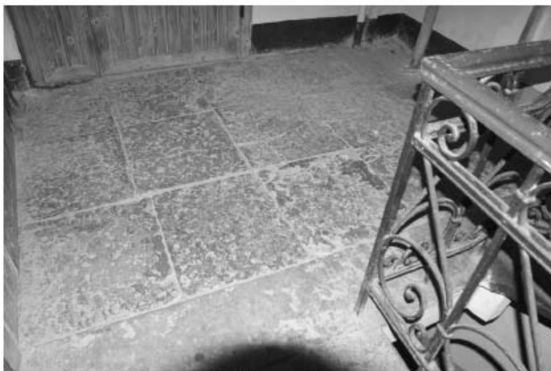
Фото 149. Лестница № 5. Площадка 2-го этажа. Покрытие пола. Съемка 19.04.2021 г. Штиглиц М. С.
