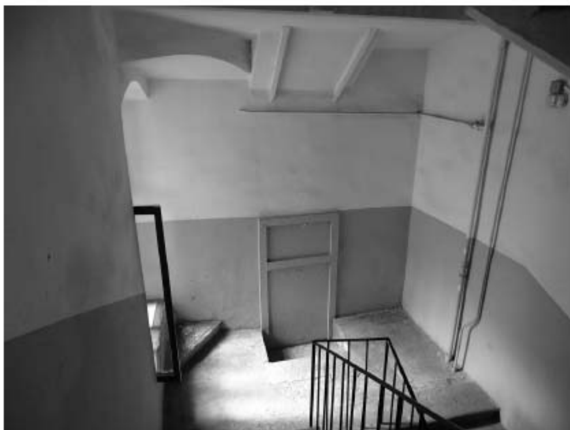
Фото 121. Лестница № 4. Вид на площадку м/у 3-м и 4-м этажом. Съемка 19.04.2021 г. Штиглиц М. С.
