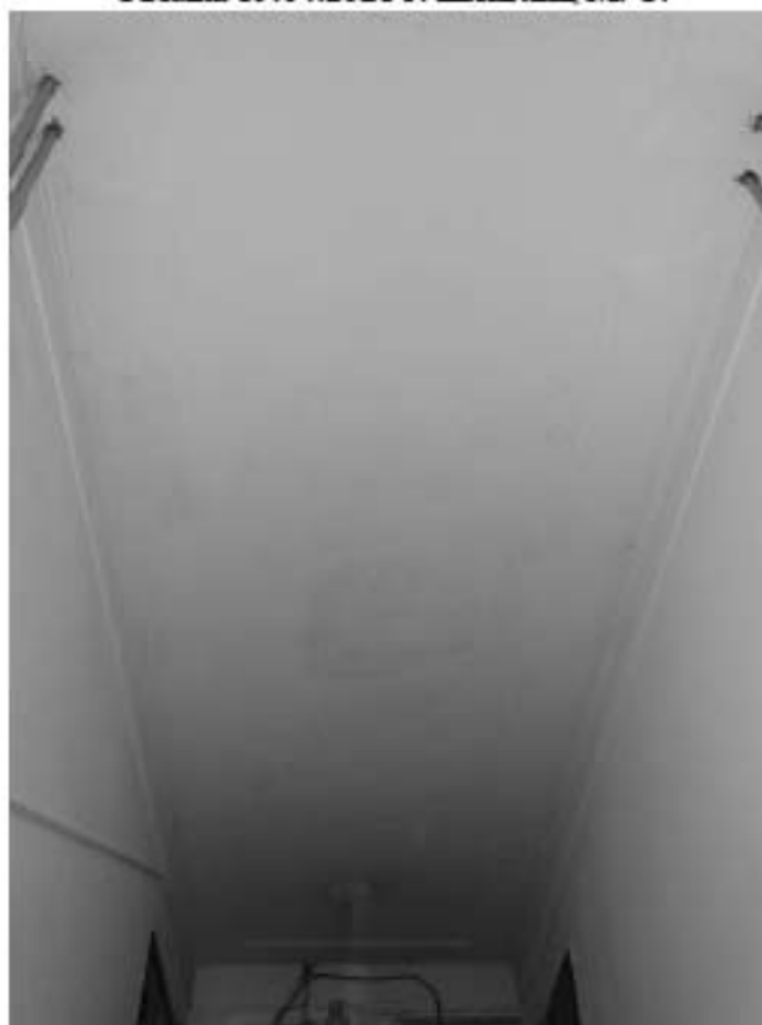
Фото 101. Лестница № 3. Площадка 6-го этажа. Оформление потолка. Съемка 19.04.2021 г. Штиглиц М. С.
