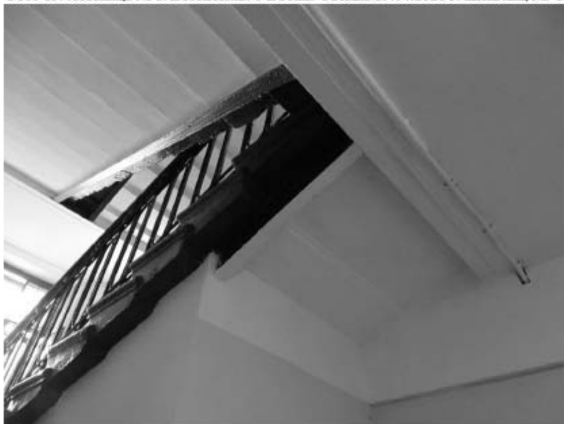
Фото 14. Лестница № 1. Вестибюль. 1-й этаж. Съемка 19.04.2021 г. Штиглиц М. С.
