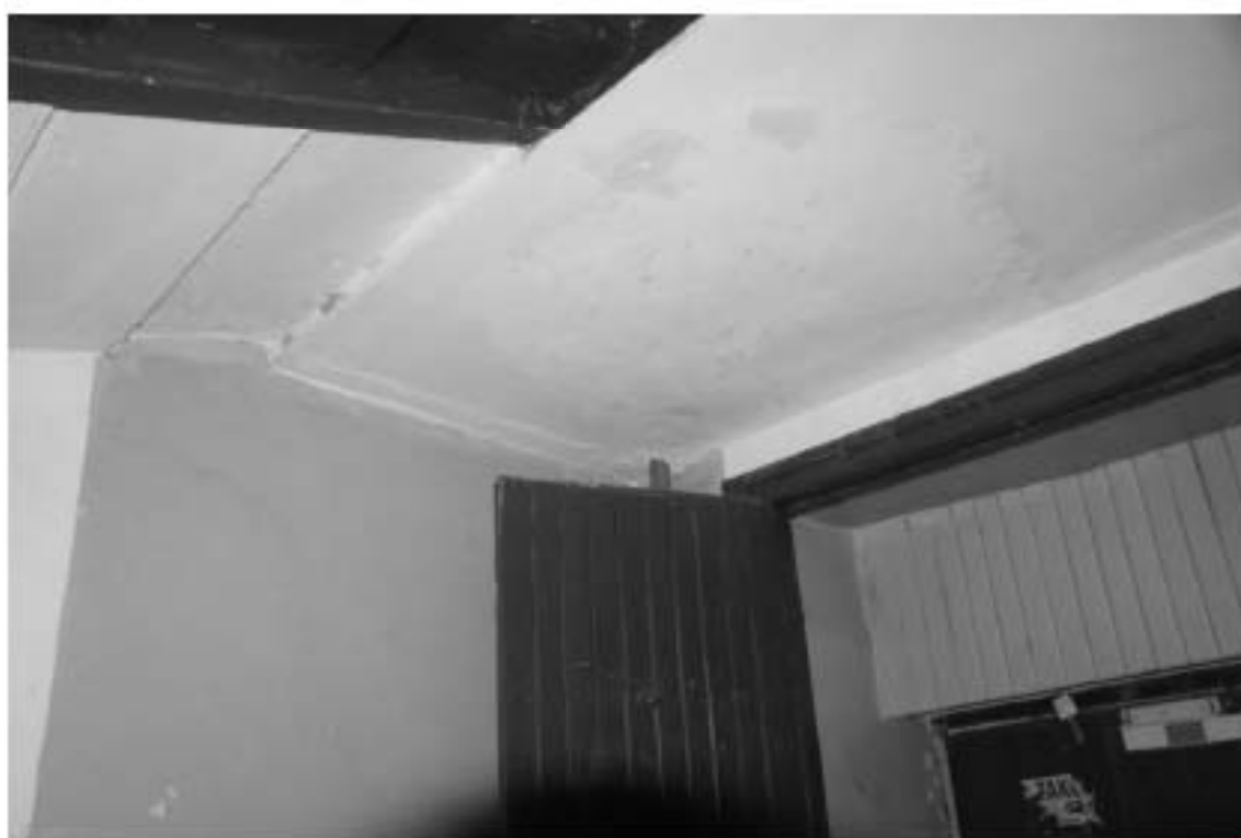
Фото 79. Лестница № 3. Вестибюль. 1-й этаж. Оформление потолка. Съемка 19.04.2021 г. Штиглиц М. С.
