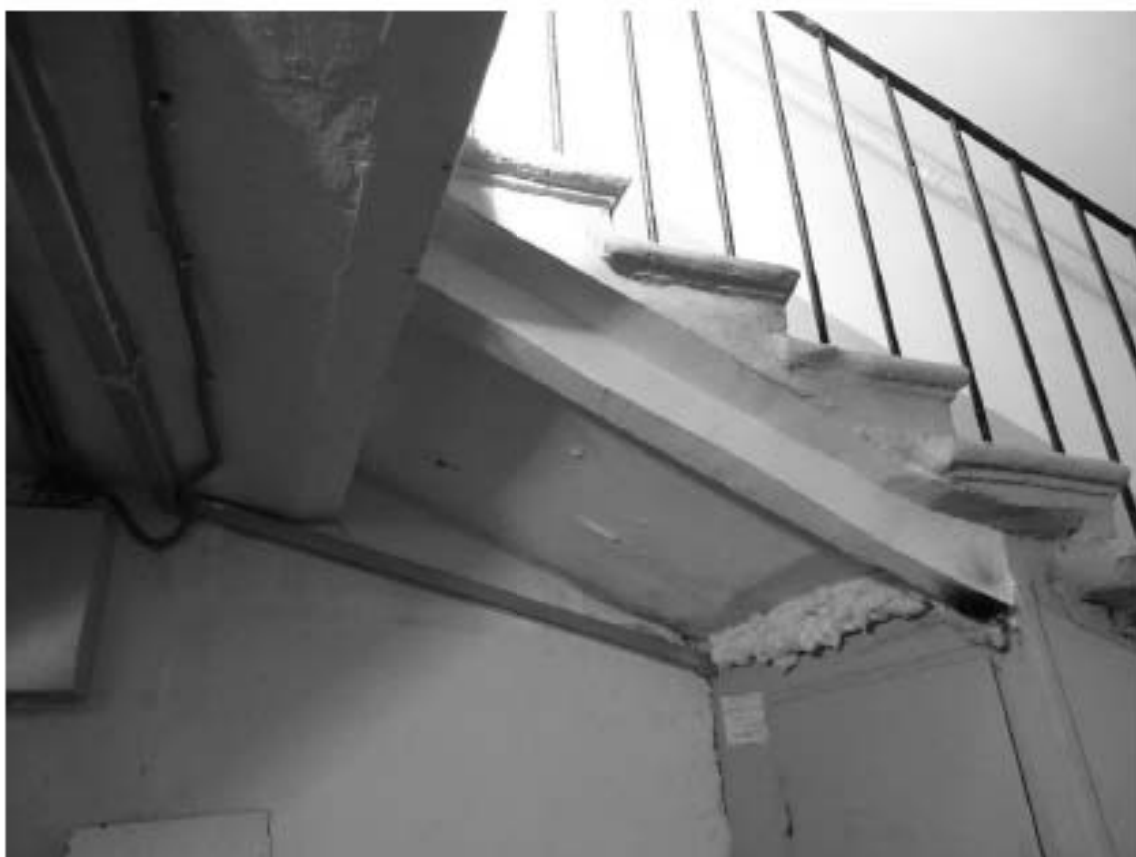
Фото 107. Лестница № 4. Вестибюль. 1-й этаж. Пространство под лестницей. Съемка 19.04.2021 г. Штиглиц М. С.
