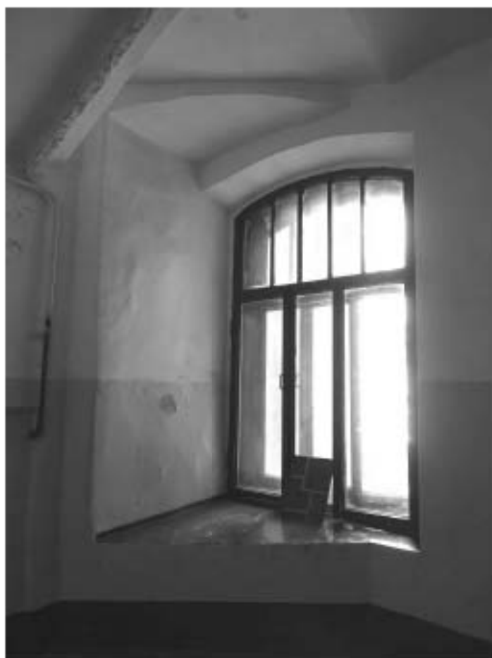
Фото 163. Лестница № 5. Площадка между 3-м и 4-м этажом. Оконный проем. Съемка 19.04.2021 г. Штиглиц М. С.
