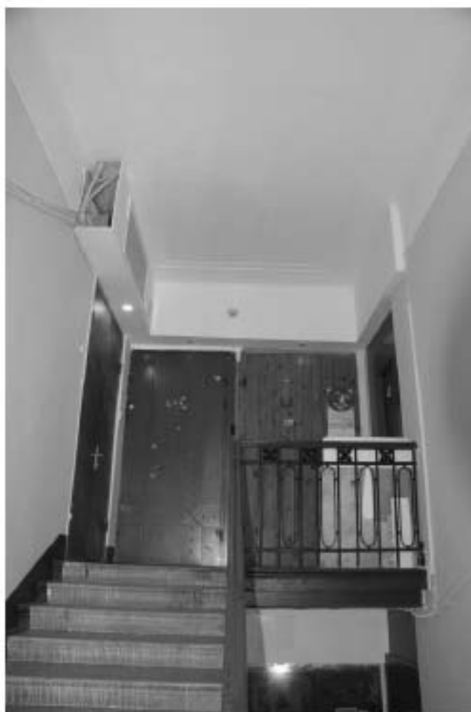
Фото 43. Лестница № 1. Вид на площадку 6-го этажа. Съёмка 19.04.2021 г. Штиглиц М. С.
