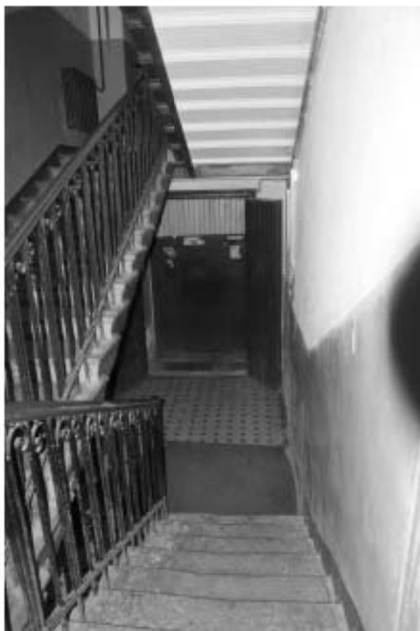
Фото 82. Лестница № 3. Вид на вестибюль. 1-й этаж. Съемка 19.04.2021 г. Штиглиц М. С.
