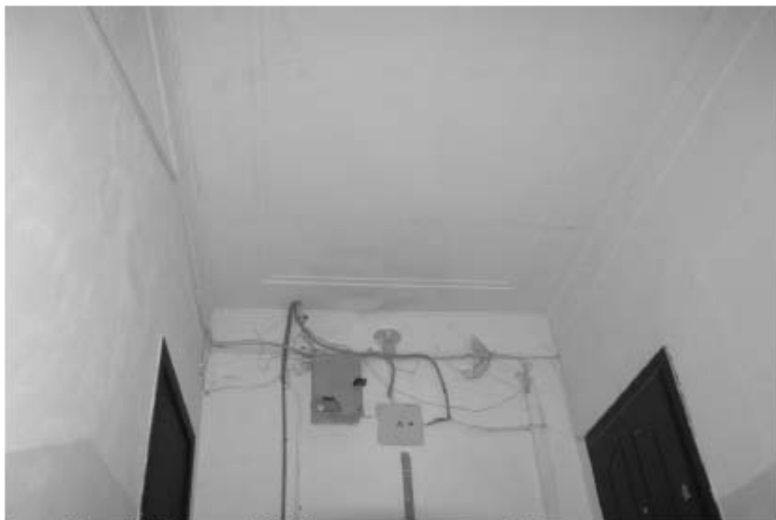
Фото 75. Лестница № 2. Площадка 6-го этажа. Оформление потолка. Съемка 19.04.2021 г. Штиглиц М. С.
