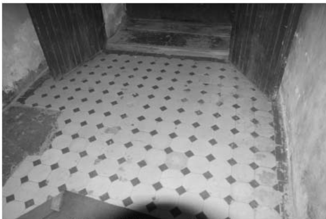
Фото 78. Лестница № 3. Вестибюль. 1-й этаж. Покрытие пола. Съемка 19.04.2021 г. Штиглиц М. С.
