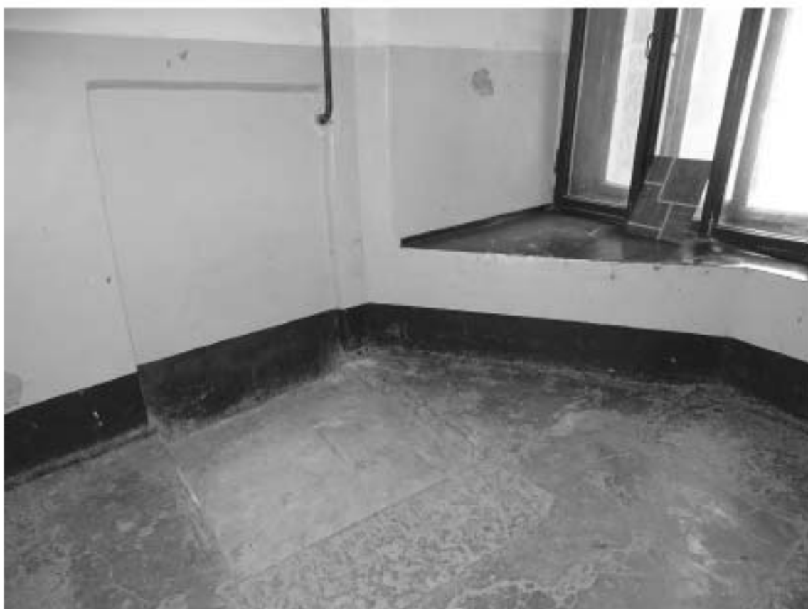
Фото 161. Лестница № 5. Площадка м/у 3-м и 4-м этажом. Съемка 19.04.2021 г. Штиглиц М. С.
