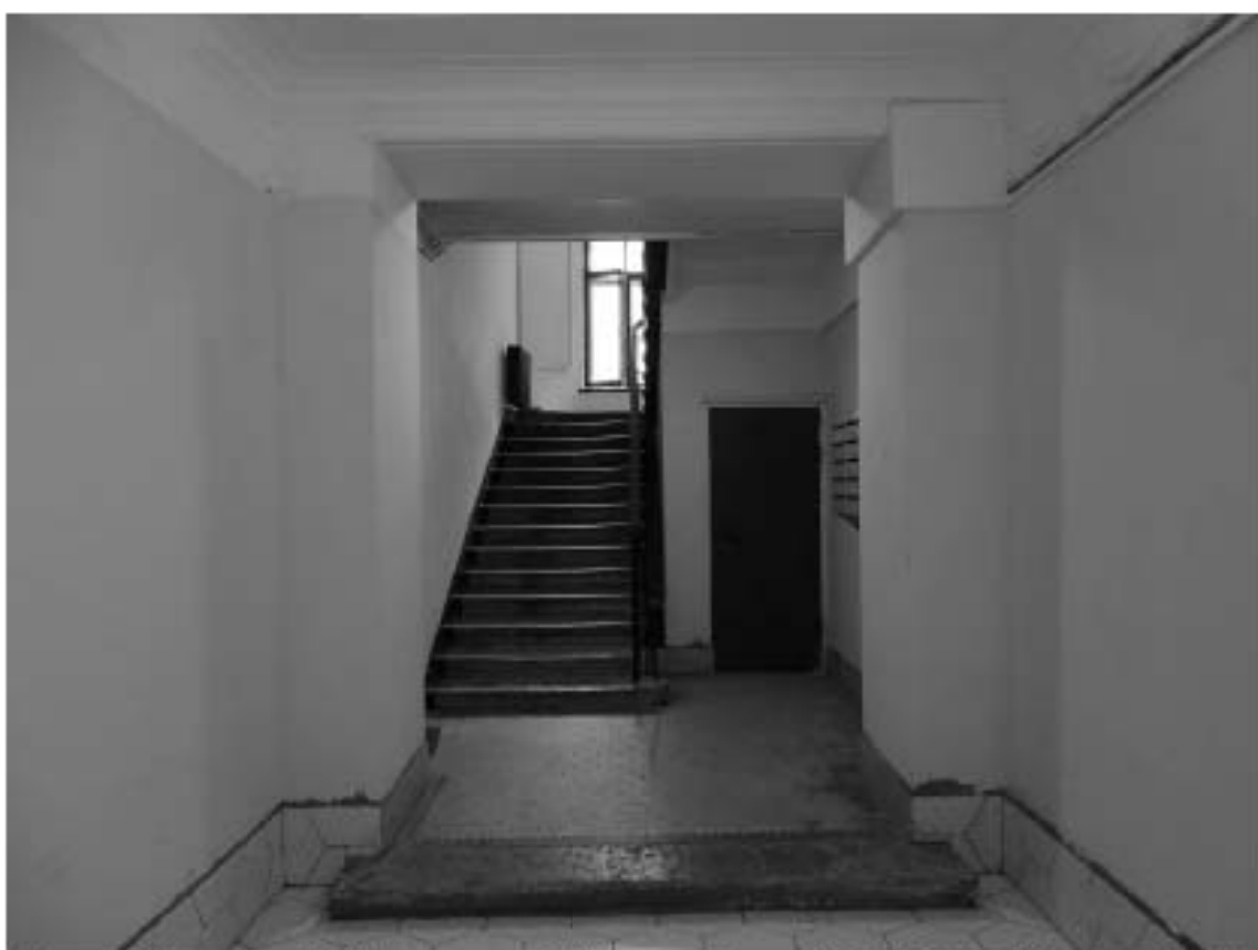
Фото 8. Лестница № 1. Вестибюль.1-й этаж. Съемка 19.04.2021 г. Штиглиц М. С.
