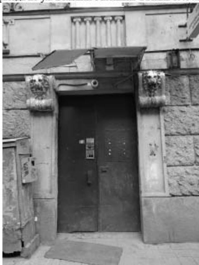
Фото 18. Здание по адресу: г. Санкт-Петербург, Большая Зеленина ул., дом 29, литера А. Фрагмент лицевого фасада по ул. Большая Зеленина. Проем парадного входа. Съемка 19.04.2021 г. Штиглиц М. С.
