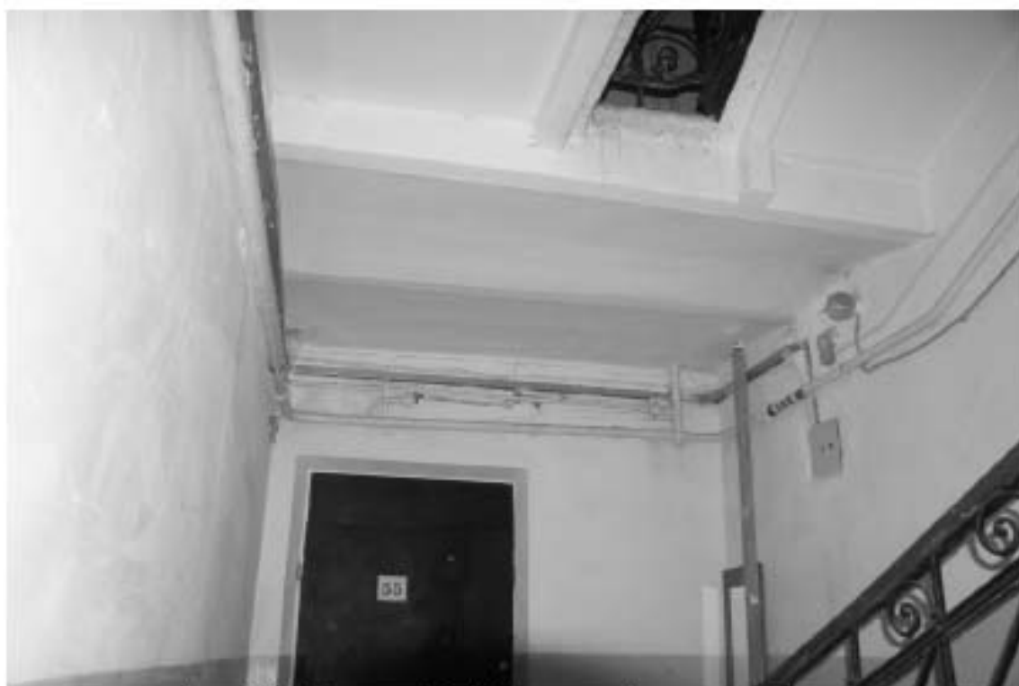
Фото 141. Лестница № 5. Площадка 1-го этажа. Своды. Съемка 19.04.2021 г. Штиглиц М. С.
