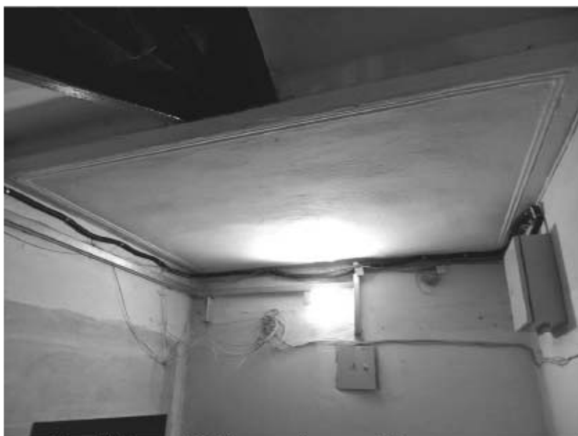
Фото 54. Лестница № 2. Площадка 1-го этажа. Оформление потолка. Съемка 19.04.2021 г. Штиглиц М. С.
