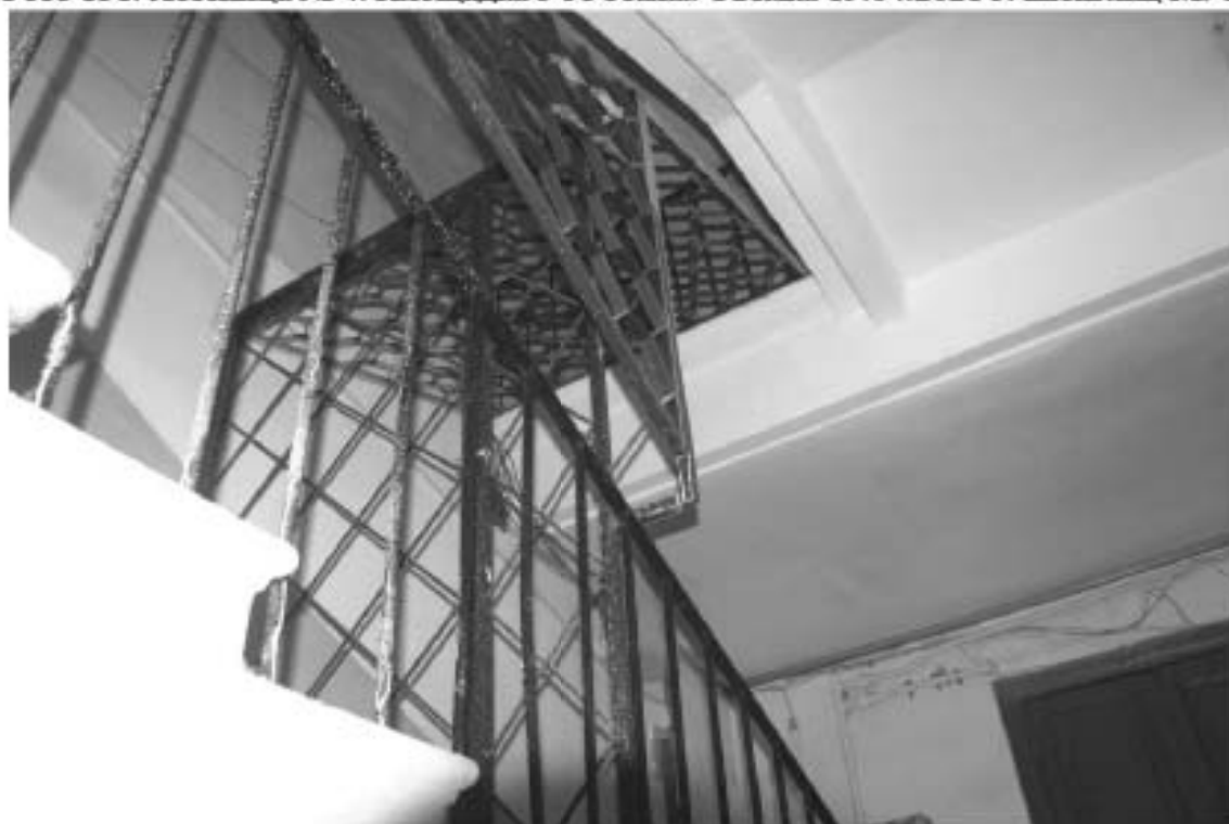
Фото 132. Лестница № 4. Площадка 5-го этажа. Своды. Съемка 19.04.2021 г. Штиглиц М. С.
