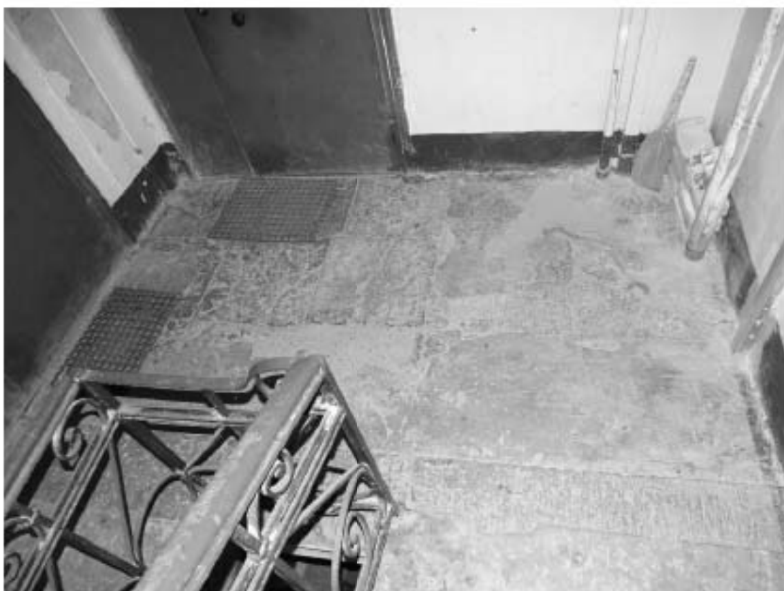
Фото 165. Лестница № 5. Площадка 4-го этажа. Покрытие пола. Съемка 19.04.2021 г. Штиглиц М. С.
