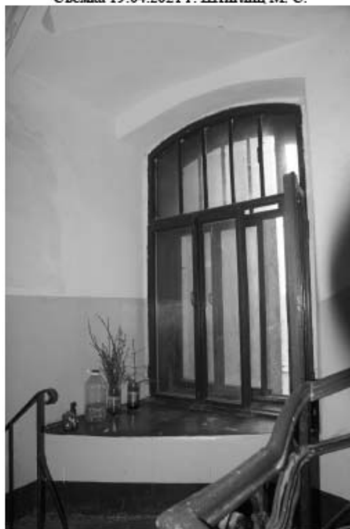
Фото 154. Лестница № 5. Площадка между 2-м и 3-м этажом. Оконный проем. Съемка 19.04.2021 г. Штиглиц М. С.
