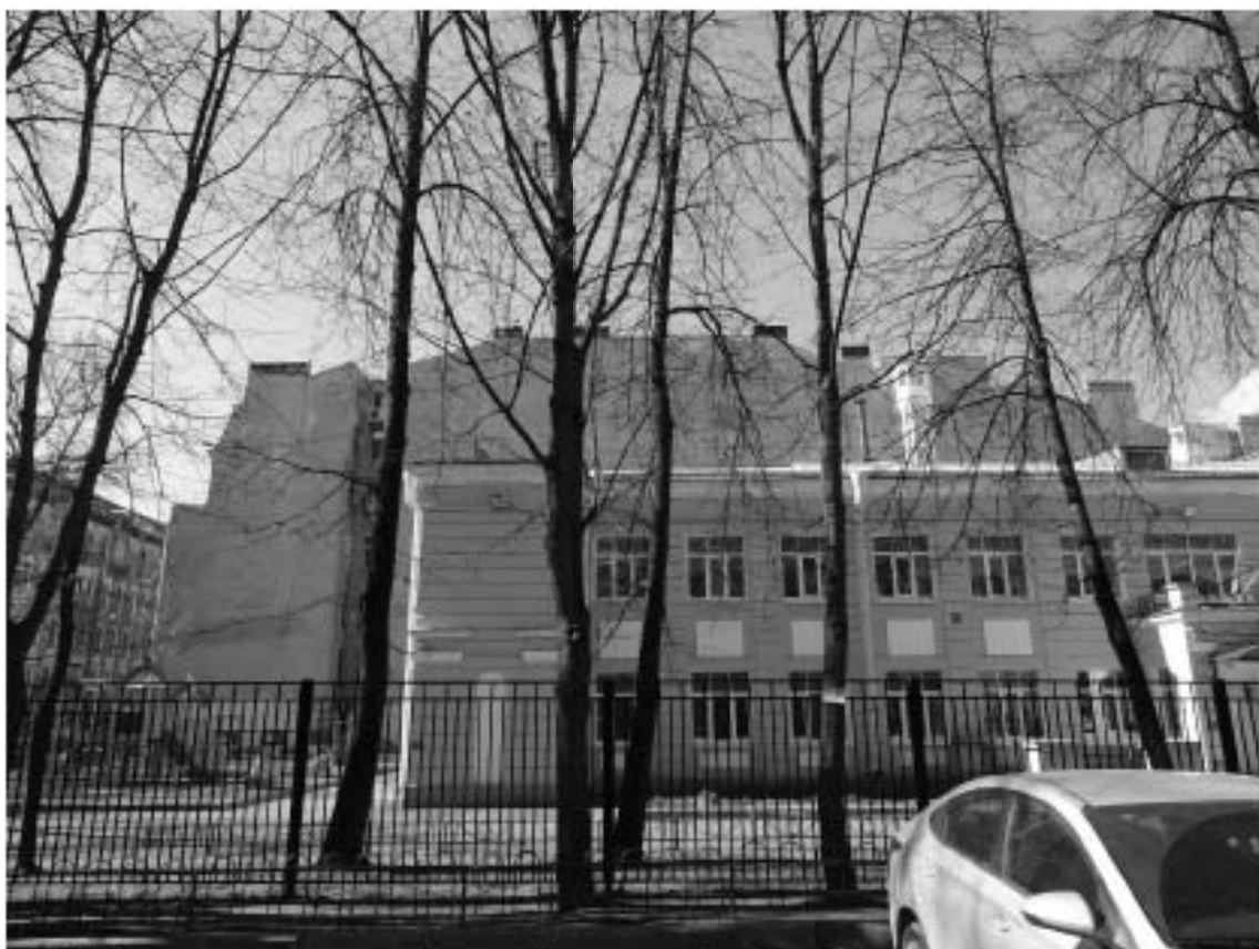
Фото 10. Здание по адресу: г. Санкт-Петербург, Большая Зеленина ул., дом 29, литера А. Брандмауэр. Съемка 19.04.2021 г. Штиглиц М. С.
