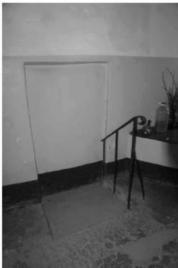
Фото 155. Лестница № 5. Площадка между 2-м и 3-м этажом. Съемка 19.04.2021 г. Штиглиц М. С.
