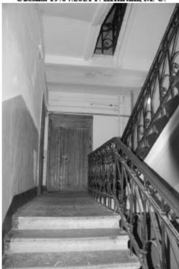
Фото 148. Лестница № 5. Вид на площадку 2-го этажа. Съемка 19.04.2021 г. Штиглиц М. С.
