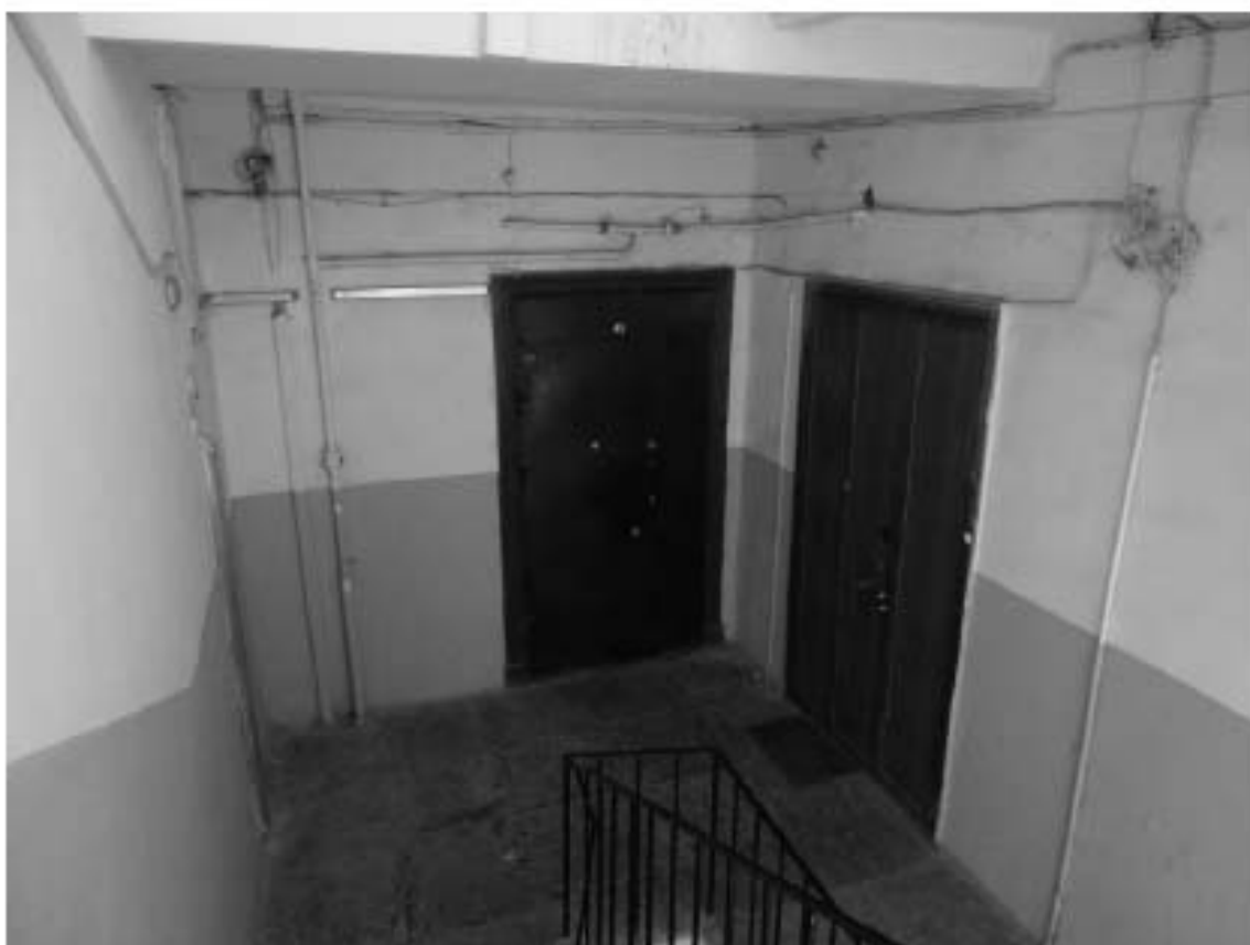
Фото 115. Лестница № 4. Вид на площадку 2-го этажа. Съемка 19.04.2021 г. Штиглиц М. С.
