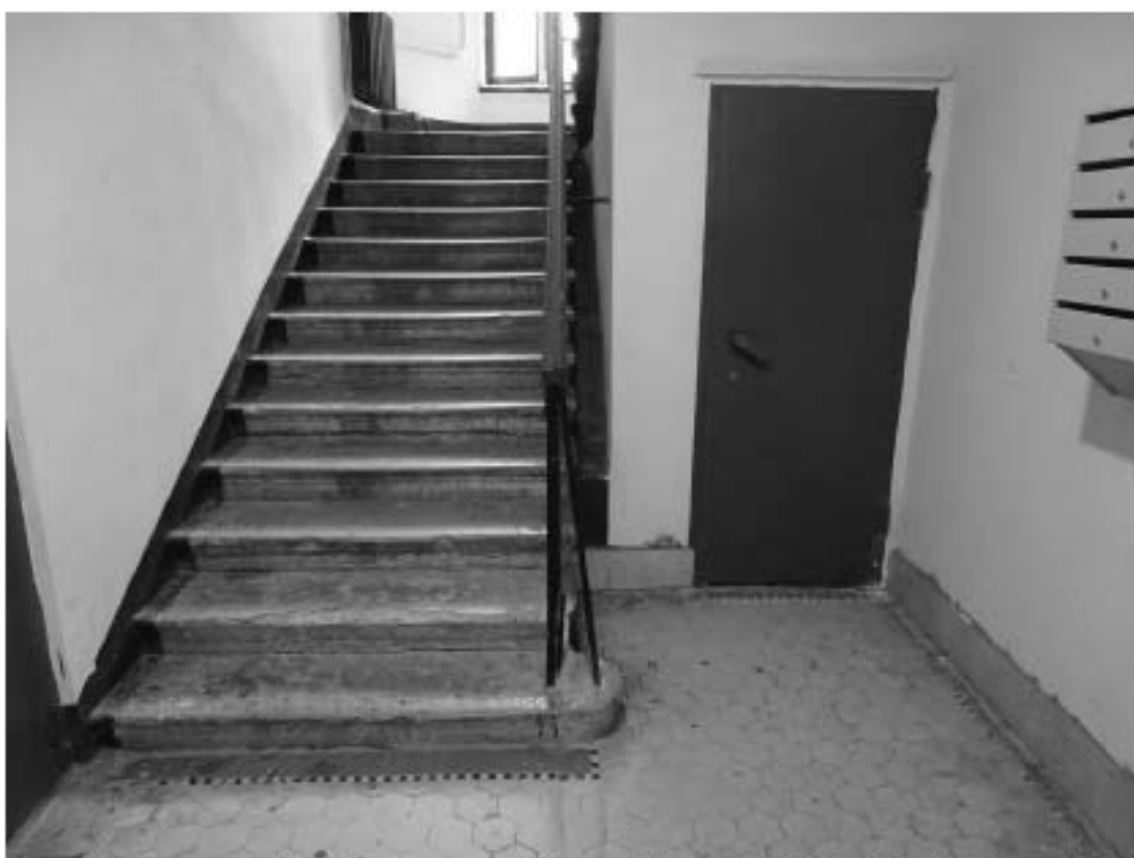
Фото 10. Лестница № 1. Вестибюль. 1-й этаж. Съемка 19.04.2021 г. Штиглиц М. С.
