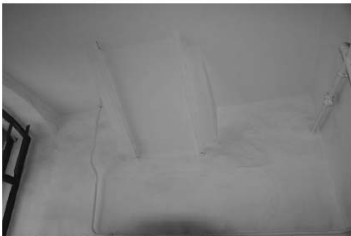
Фото 129. Лестница № 4. Площадка м/у 4-м и 5-м этажом. Своды. Съемка 19.04.2021 г. Штиглиц М. С.
