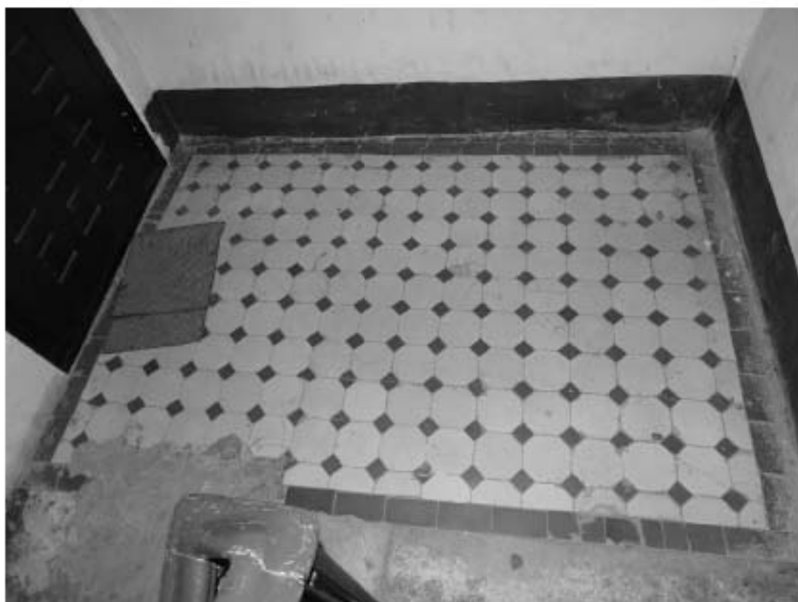
Фото 53. Лестница № 2. Площадка 1-го этажа. Покрытие пола. Съемка 19.04.2021 г. Штиглиц М. С.
