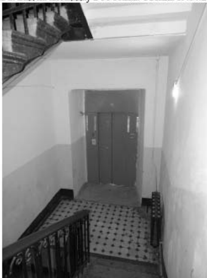
Фото 60. Лестница № 2. Вид на площадку м/у 2-м и 3-м этажом. Съемка 19.04.2021 г. Штиглиц М. С.
