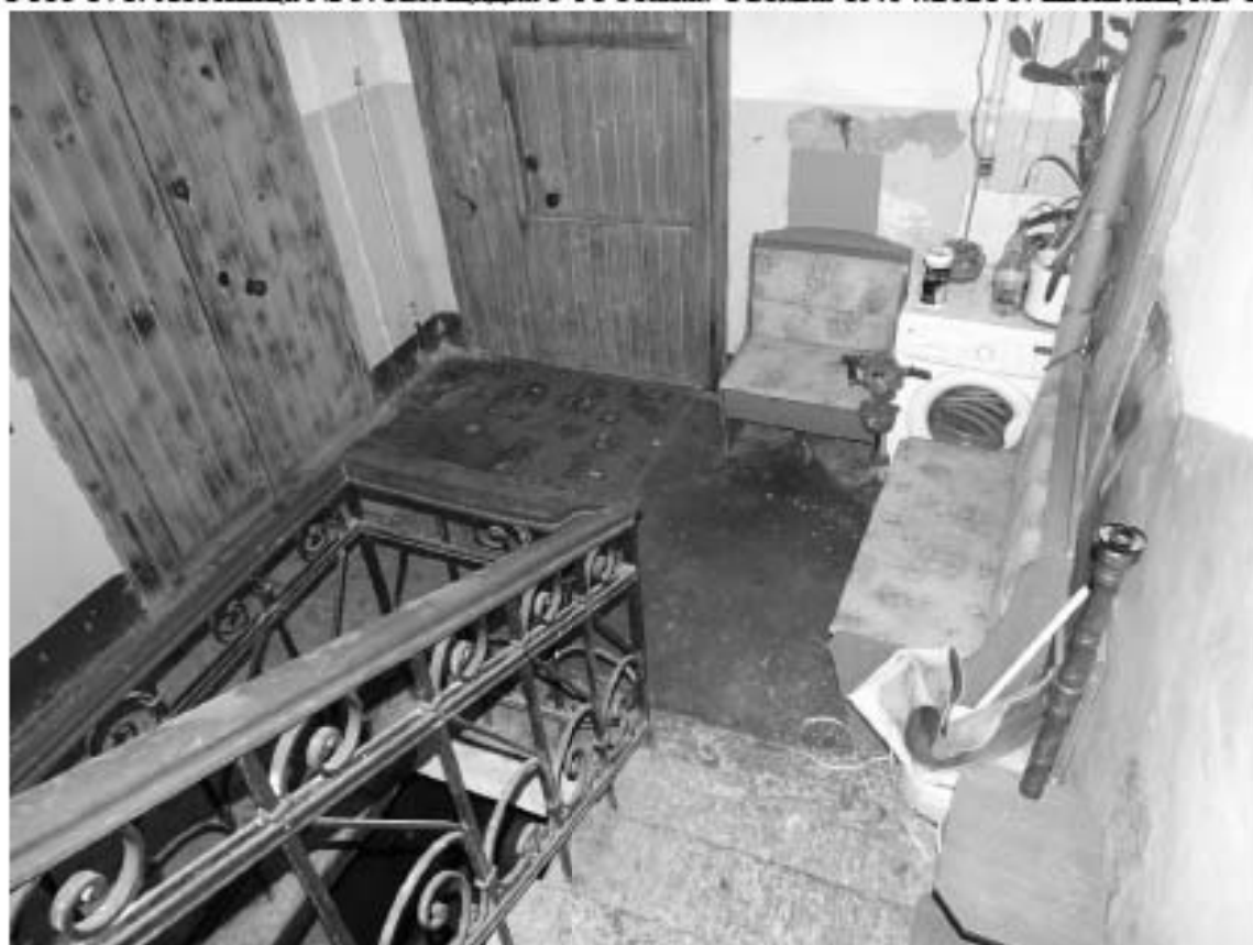
Фото 172. Лестница № 5. Площадка 5-го этажа. Покрyтие пола. Съемка 19.04.2021 г. Штиглиц М. С.
