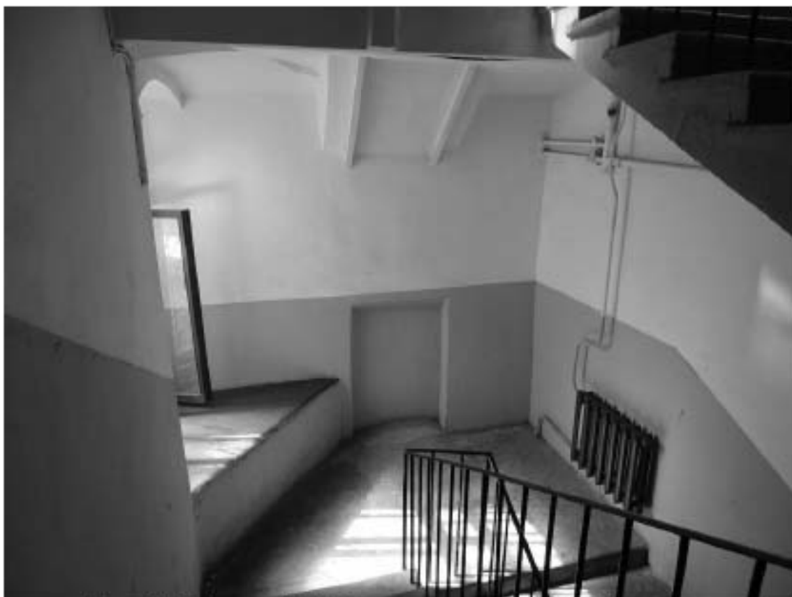
Фото 110. Лестница № 4. Вид на площадку м/у 1-м и 2-м этажом. Съемка 19.04.2021 г. Штиглиц М. С.
