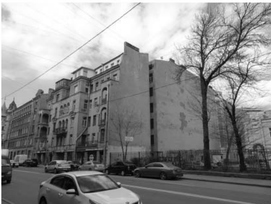
Фото 1. Здание по адресу: г. Санкт-Петербург, Большая Зеленина ул., дом 29, литера А. Лицевой фасад по ул. Большая Зеленина. Съемка 19.04.2021 г. Штиглиц М. С.
