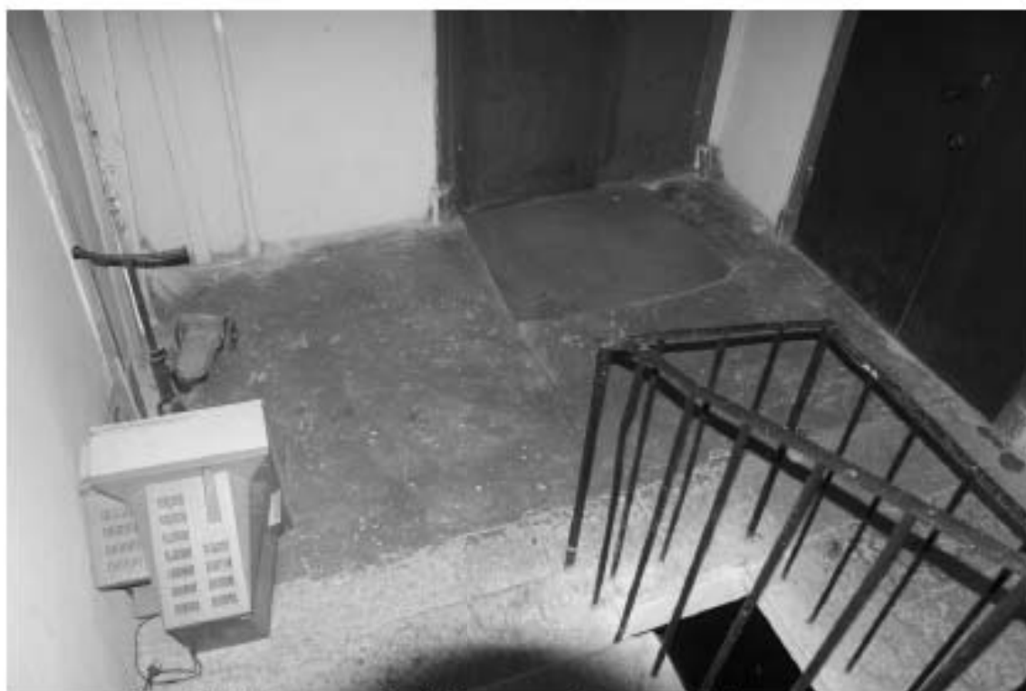
Фото 127. Лестница № 4. Площадка 4-го этажа. Покрытие пола. Съемка 19.04.2021 г. Штиглиц М. С.
