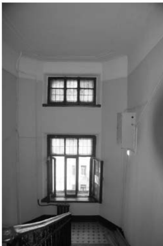
Фото 39. Лестница № 1. Вид на площадку м/у 5-м и 6-м этажом. Съемка 19.04.2021 г. Штиглиц М. С.
