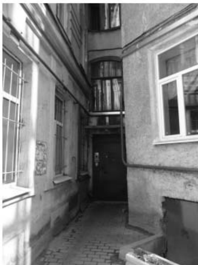
Фото 33. Здание по адресу: г. Санкт-Петербург, Большая Зеленина ул., дом 29, литера А. Фрагмент дворового фасада. Дверной проем лестничной клетки. Съемка 19.04.2021 г. Штиглиц М. С.
