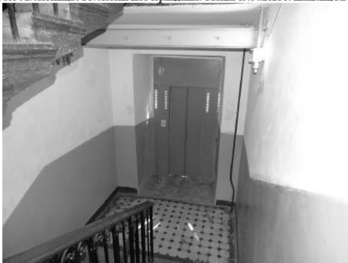
Фото 93. Лестница № 3. Вид на площадку м/у 4-м и 5-м этажом. Съемка 19.04.2021 г. Штиглиц М. С.
