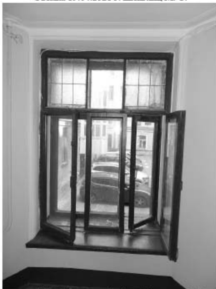
Фото 16. Лестница № 1. Площадка м/у 1-м и 2-м этажом. Оконный проем. Съемка 19.04.2021 г. Штиглиц М. С.
