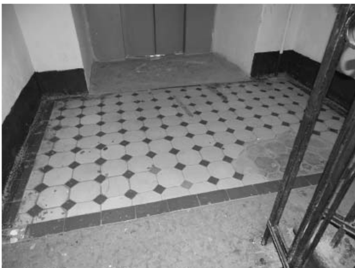
Фото 66. Лестница № 2. Площадка м/у 4-м и 5-м этажом. Покрытие пола. Съемка 19.04.2021 г. Штиглиц М. С.
