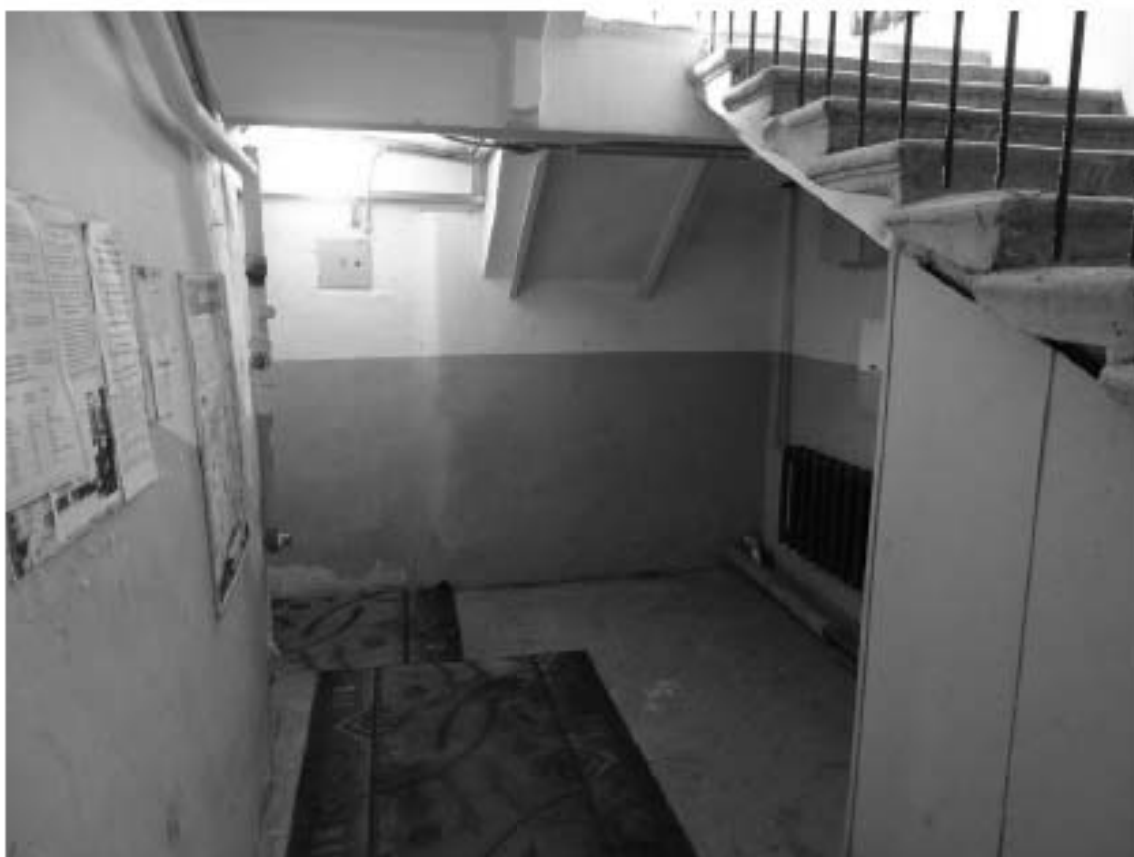
Фото 105. Лестница № 4. Вестибюль. 1-й этаж. Съемка 19.04.2021 г. Штиглиц М. С.
