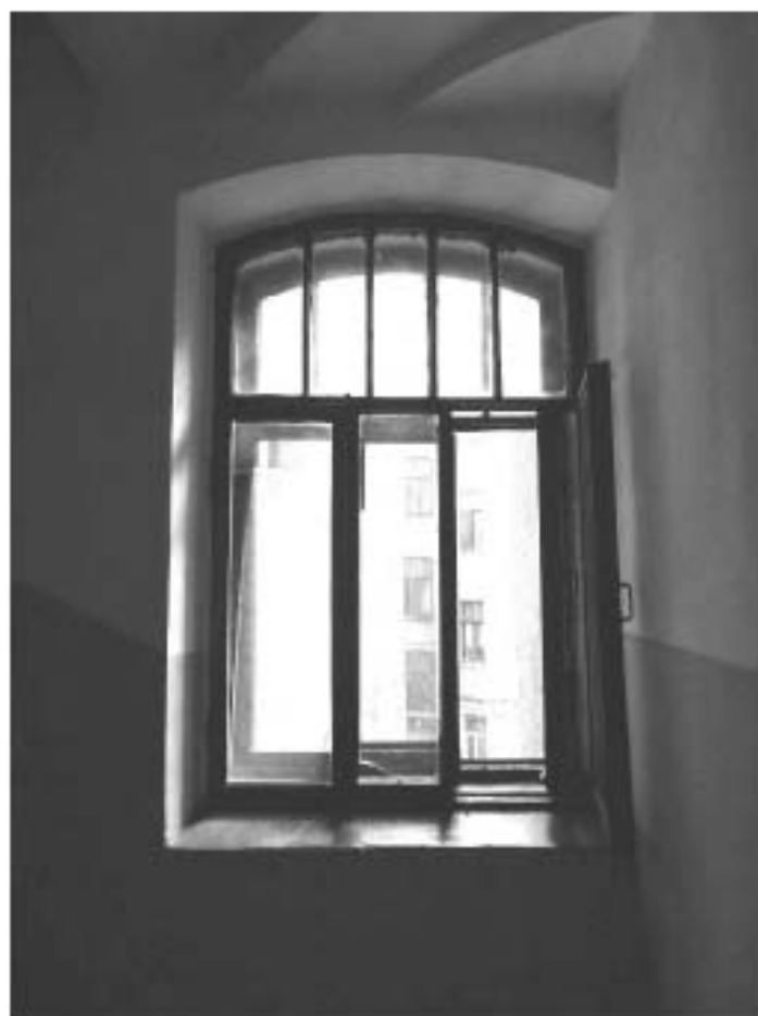
Фото 119. Лестница № 4. Площадка между 2-м и 3-м этажом. Оконный проем. Съемка 19.04.2021 г. Штиглиц М. С.
