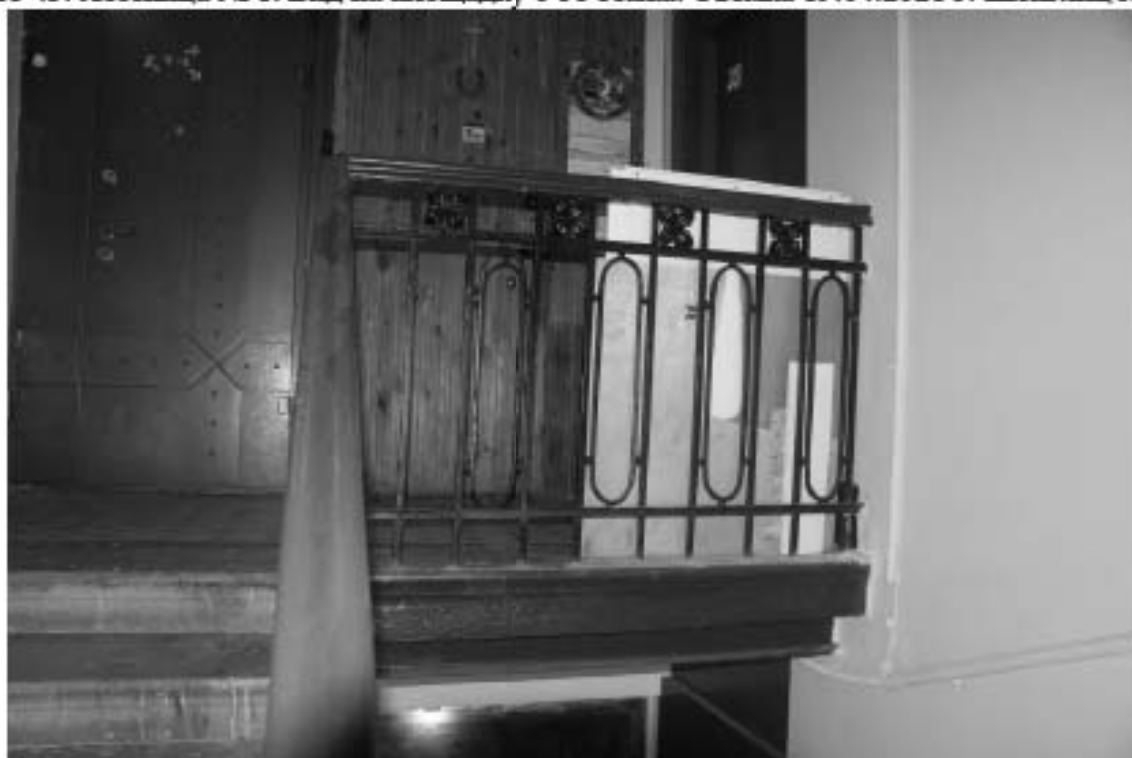
Фото 44. Лестница № 1. Площадка 6-го этажа. Лестничное ограждение. Съёмка 19.04.2021 г. Штиглиц М. С.
