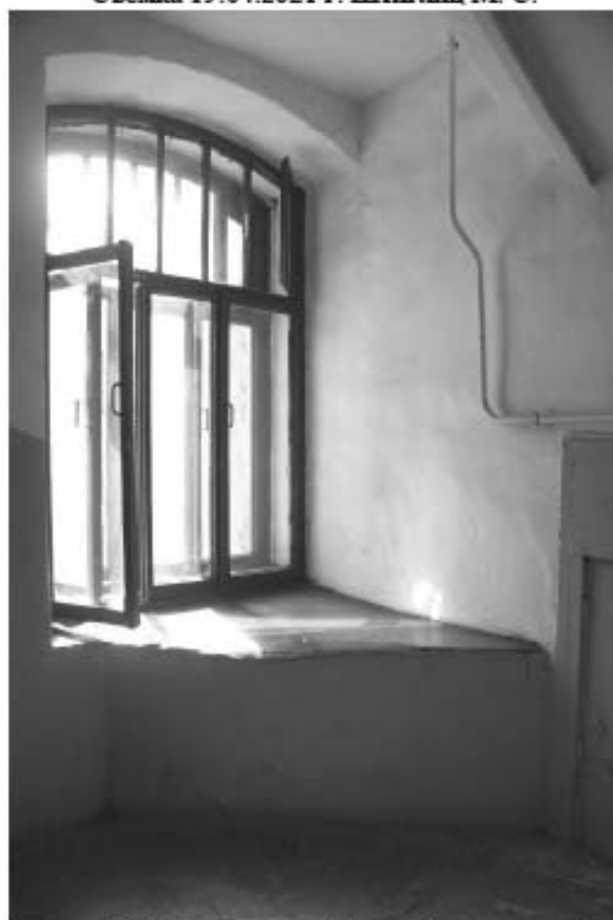
Фото 130. Лестница № 4. Площадка м/у 4-м и 5-м этажом. Оконный проем. Съемка 19.04.2021 г. Штиглиц М. С.
