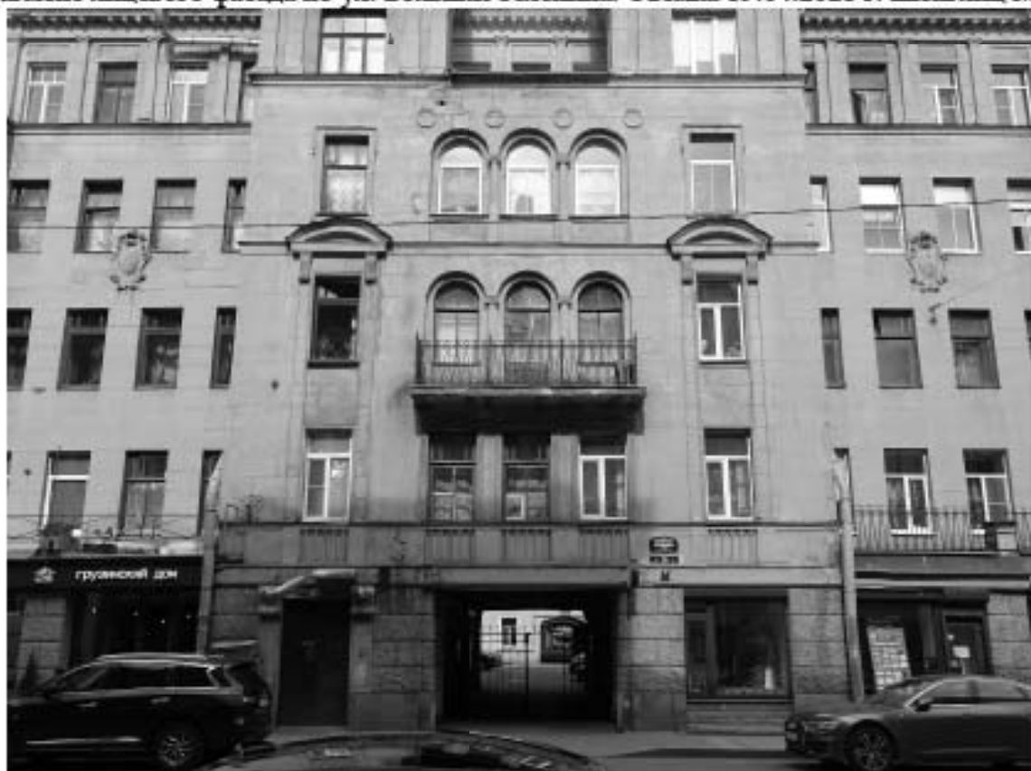
Фото 6. Здание по адресу: г. Санкт-Петербург, Большая Зеленая ул., дом 29, литера А. Фрагмент лицевого фасада по ул. Большая Зеленая. Ризалит с воротным проездом. Съемка 19.04.2021 г. Штиглиц М. С.
