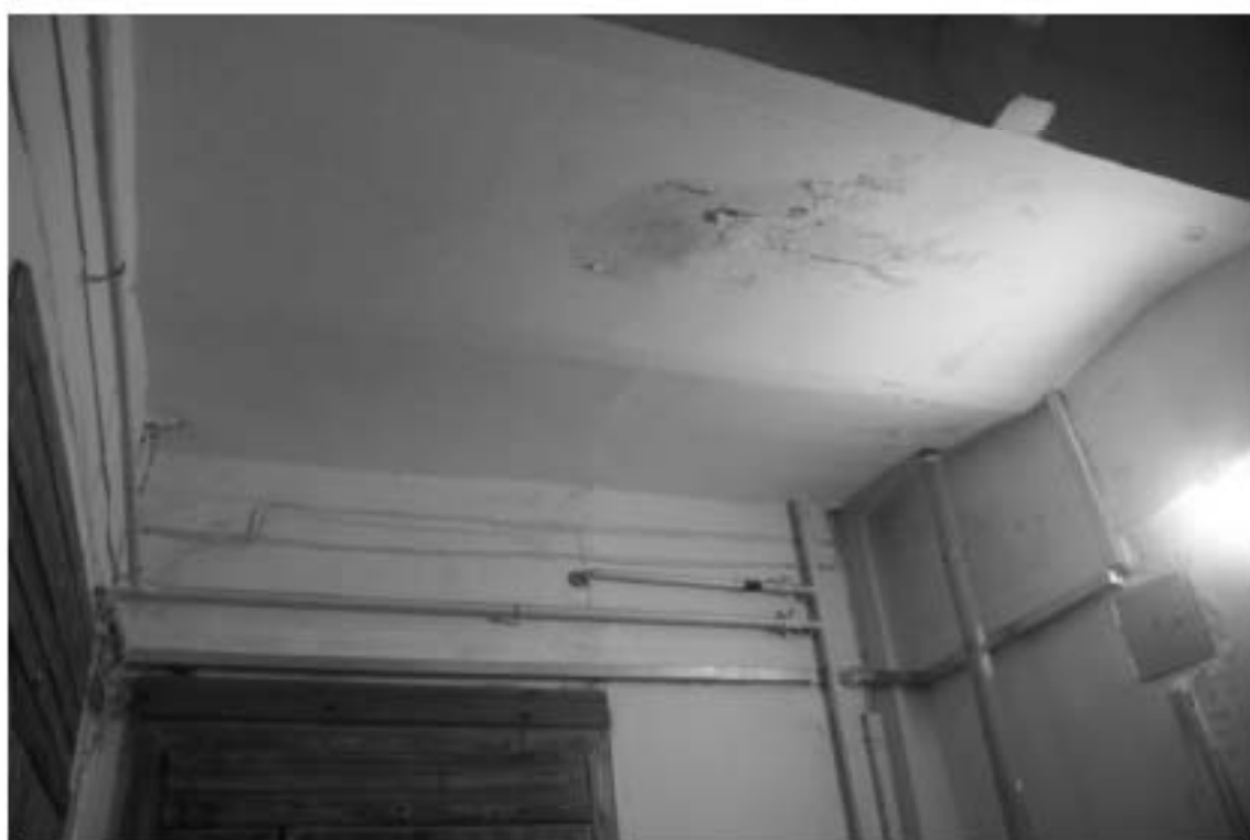
Фото 150. Лестница № 5. Площадка 2-го этажа. Своды. Съемка 19.04.2021 г. Штиглиц М. С.
