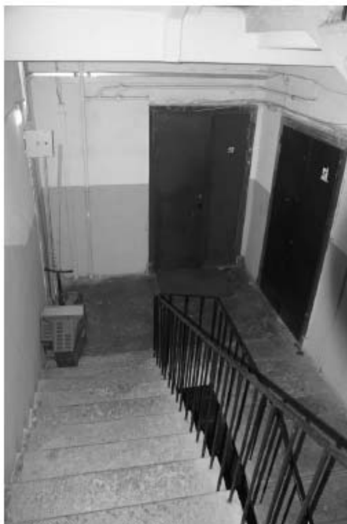
Фото 125. Лестница № 4. Вид на площадку 4-го этажа. Съемка 19.04.2021 г. Штиглиц М. С.
