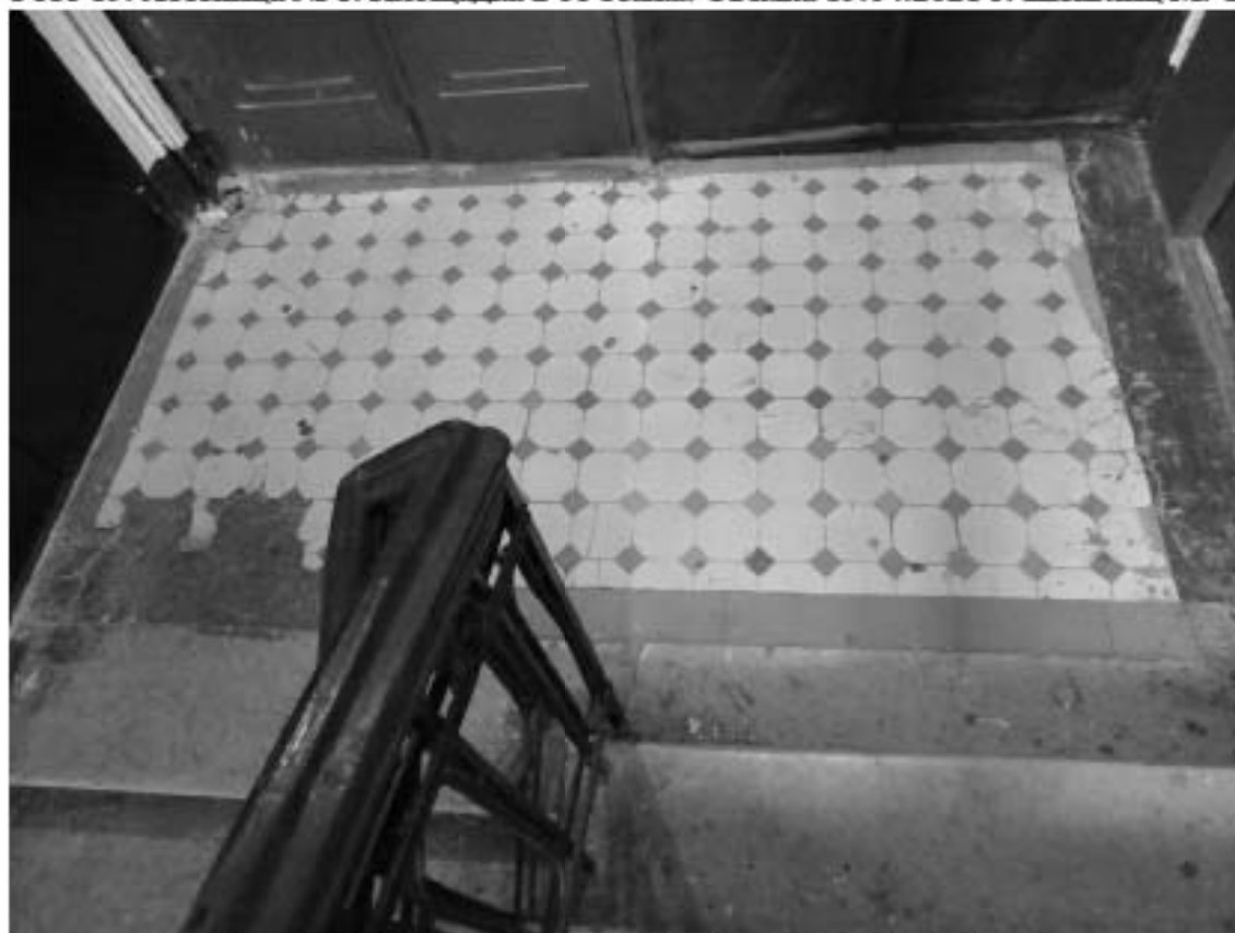
Фото 20. Лестница № 1. Площадка 2-го этажа. Покрѳтне пола. Съемка 19.04.2021 г. Штиглиц М. С.
