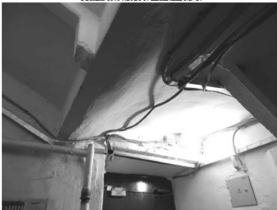
Фото 104. Лестница № 4. Вестибюль. 1-й этаж. Своды. Съемка 19.04.2021 г. Штиглиц М. С.
