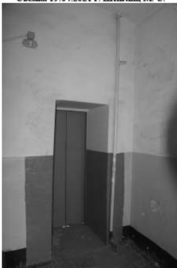
Фото 152. Лестница № 5. Площадка между 2-м и 3-м этажом. Съемка 19.04.2021 г. Штиглиц М. С.
