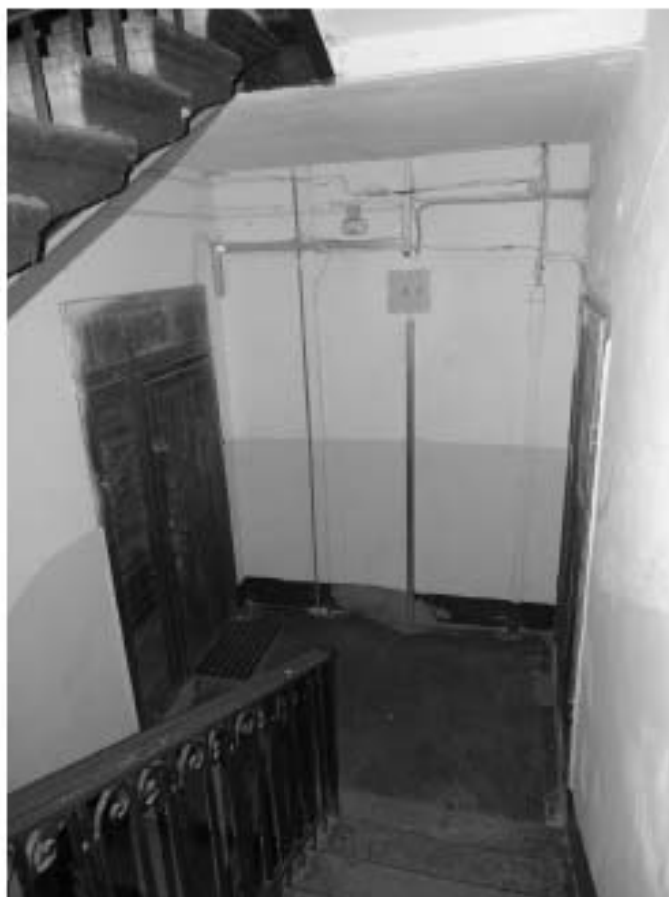
Фото 59. Лестница № 2. Вид на площадку 2-го этажа. Съемка 19.04.2021 г. Штиглиц М. С.
