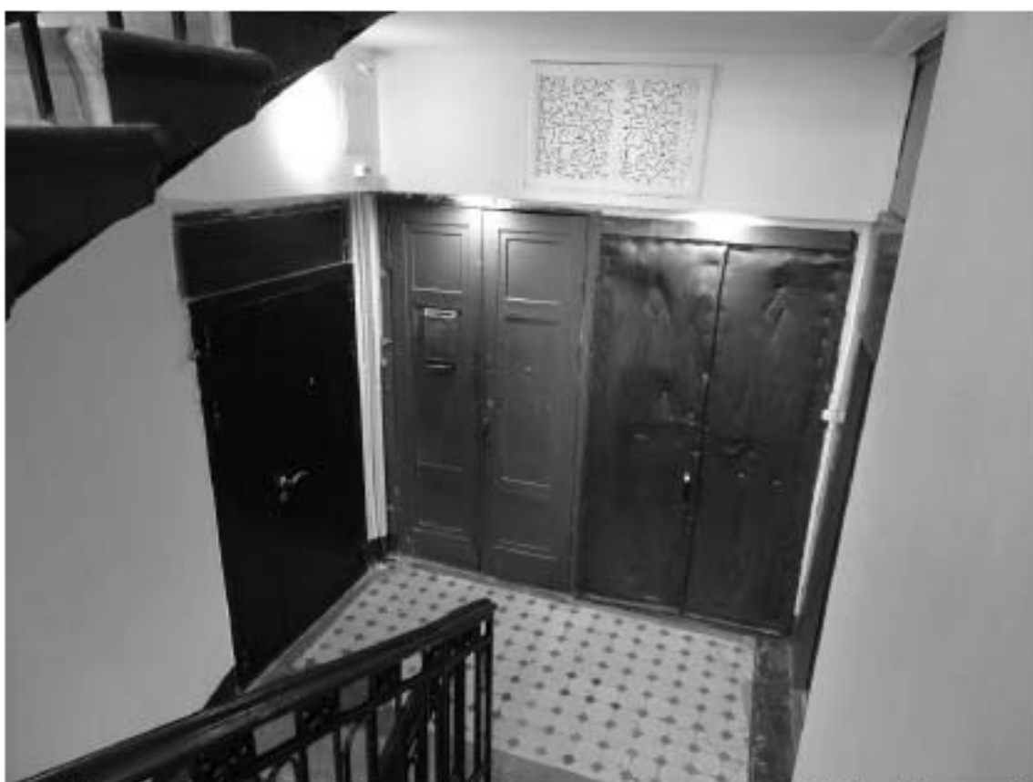
Фото 18. Лестница № 1. Вид на площадку 2-го этажа. Съемка 19.04.2021 г. Штиглиц М. С.
