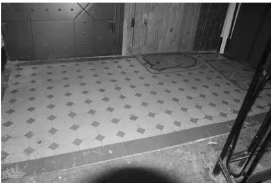
Фото 45. Лестница № 1. Площадка 6-го этажа. Покрѳтне пола. Съемка 19.04.2021 г. Штиглиц М. С.
