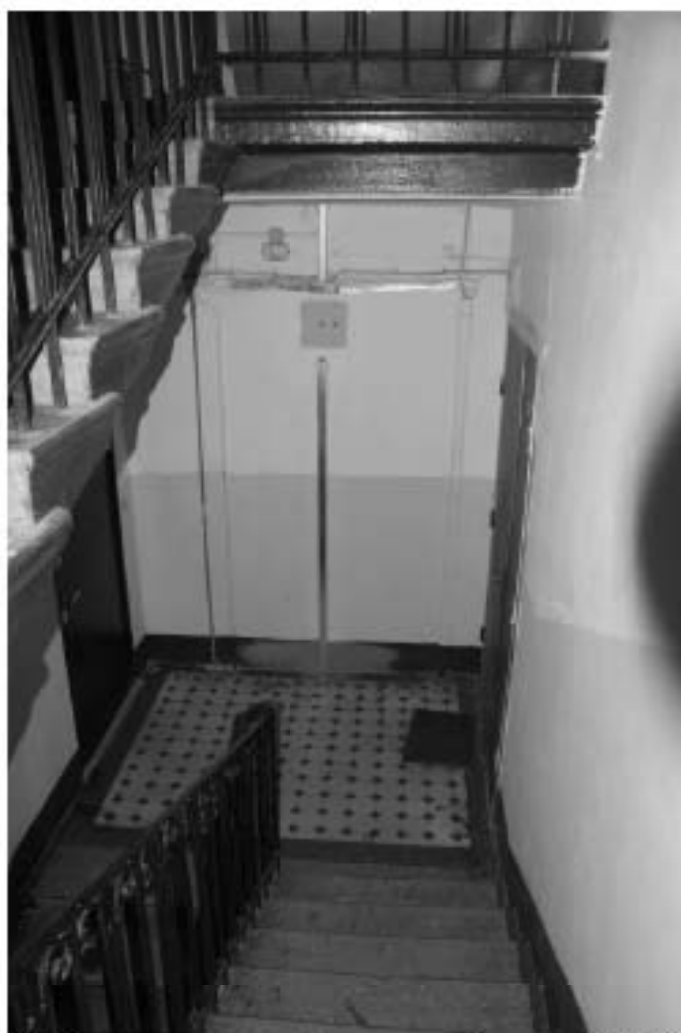
Фото 67. Лестница № 2. Вид на площадку 5-го этажа. Съемка 19.04.2021 г. Штиглиц М. С.
