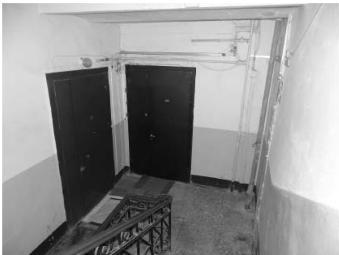
Фото 158. Лестница № 5. Вид на площадку 3-го этажа. Съемка 19.04.2021 г. Штиглиц М. С.
