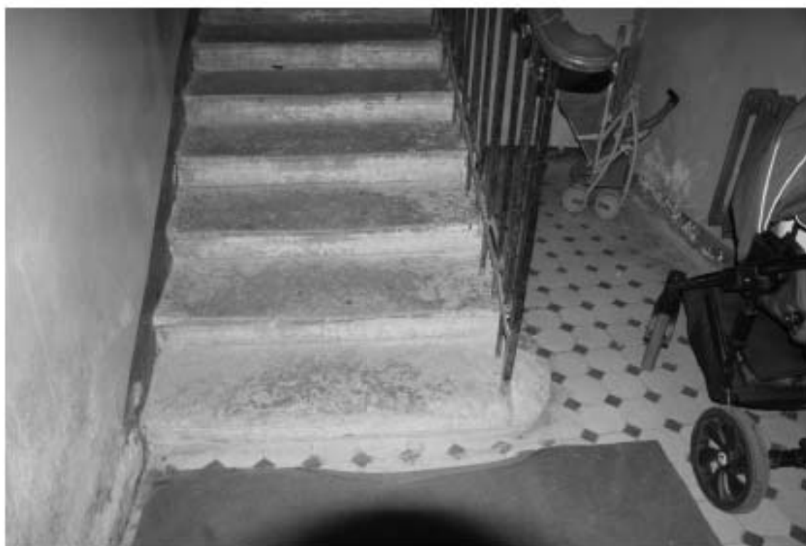
Фото 80. Лестница № 3. Вестибюль. 1-й этаж. Съемка 19.04.2021 г. Штиглиц М. С.
