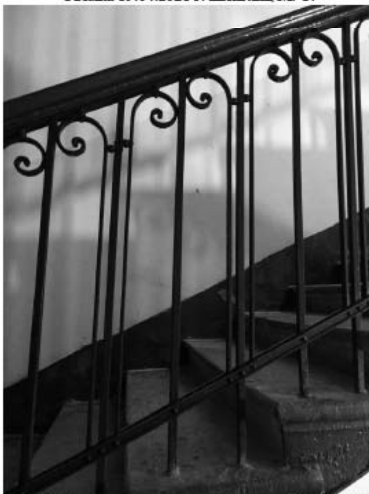
Фото 58. Лестница № 2. Лестничное ограждение. Съемка 19.04.2021 г. Штиглиц М. С.
