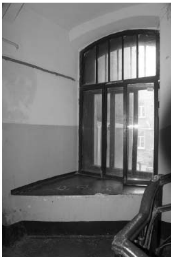
Фото 145. Лестница № 5. Площадка м/у 1-м и 2-м этажом. Оконный проем. Съемка 19.04.2021 г. Штиглиц М. С.
