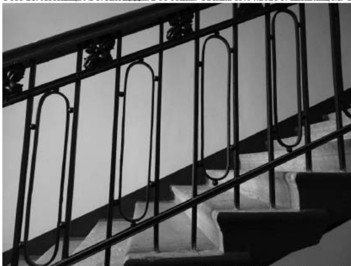
Фото 22. Лестница № 1. Лестничное ограждение. Съемка 19.04.2021 г. Штиглиц М. С.
