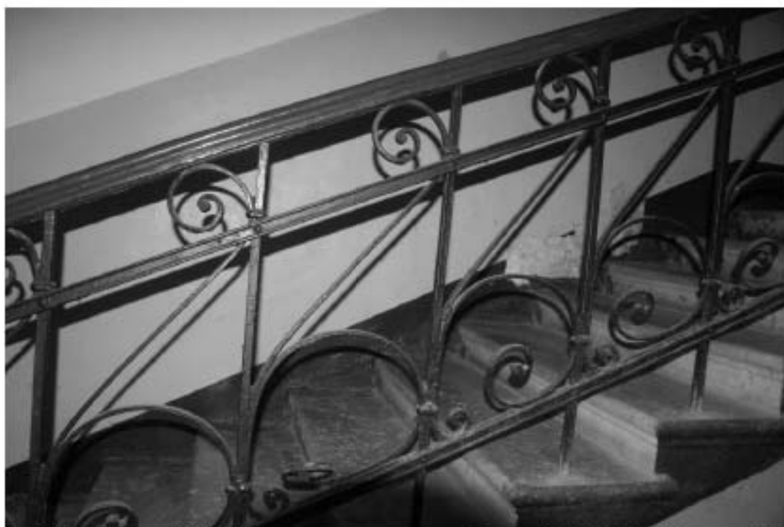
Фото 157. Лестница № 5. Лестничное ограждение. Съемка 19.04.2021 г. Штиглиц М. С.
