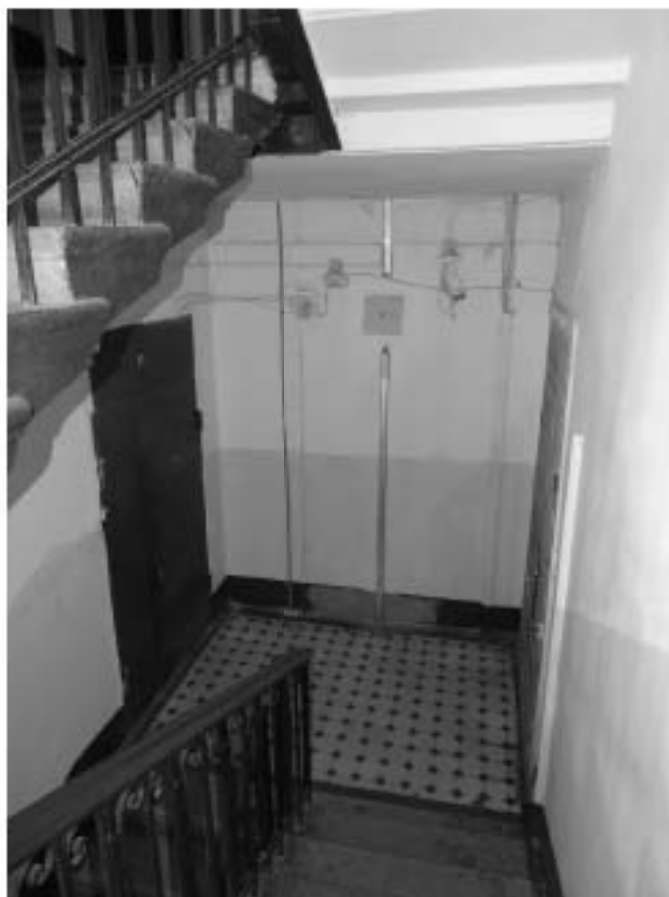
Фото 63. Лестница № 2. Вид на площадку 4-го этажа. Съемка 19.04.2021 г. Штиглиц М. С.
