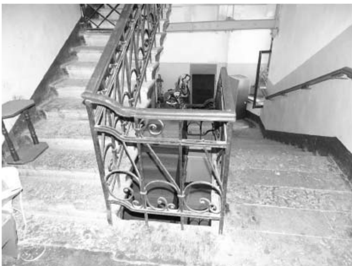
Фото 174. Лестница № 5. Площадка 5-го этажа. Лестничное ограждение. Съемка 19.04.2021 г. Штиглиц М. С.
