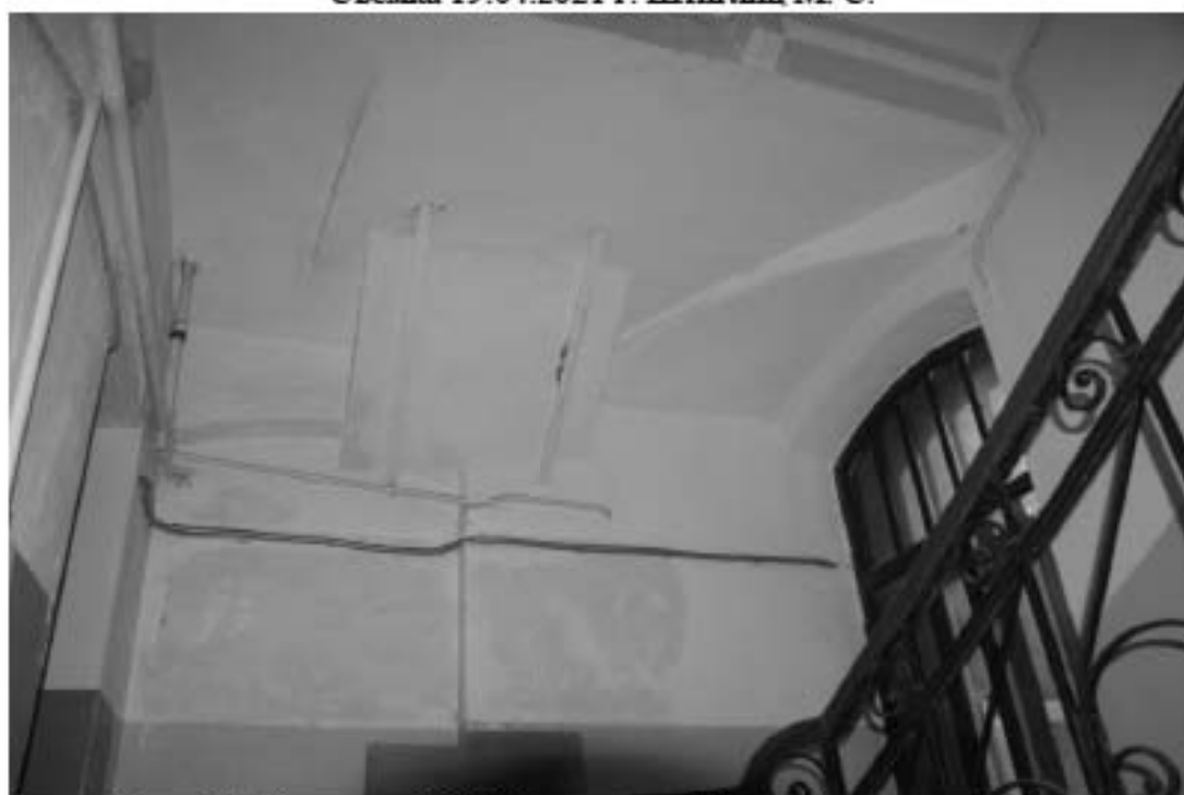
Фото 144. Лестница № 5. Площадка м/у 1-м и 2-м этажом. Своды. Съемка 19.04.2021 г. Штиглиц М. С.
