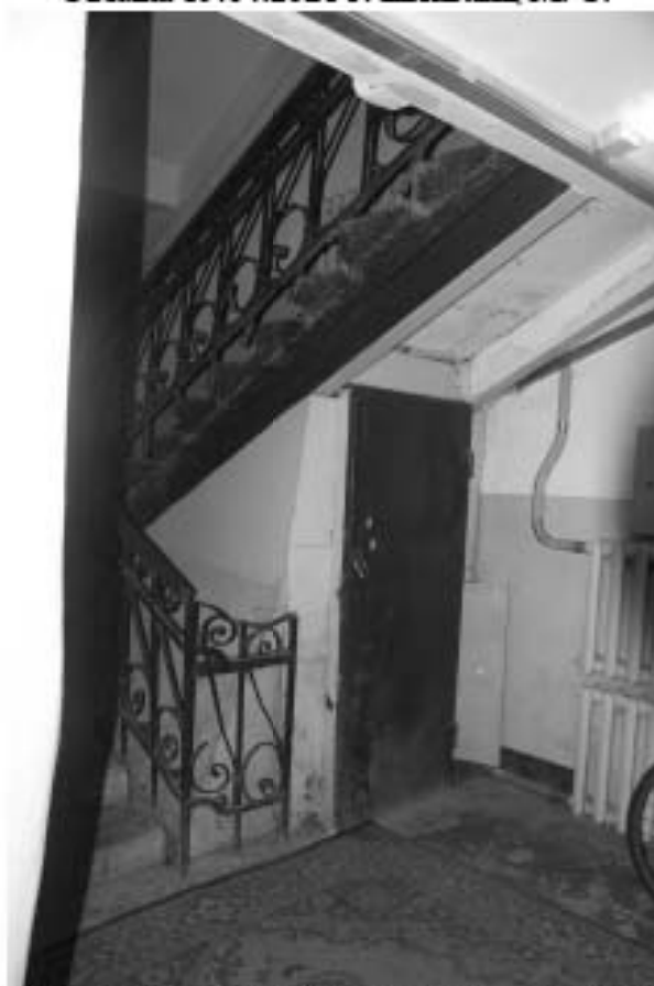
Фото 136. Лестница № 5. Вестибюль.1-й этаж. Съемка 19.04.2021 г. Штиглиц М. С.
