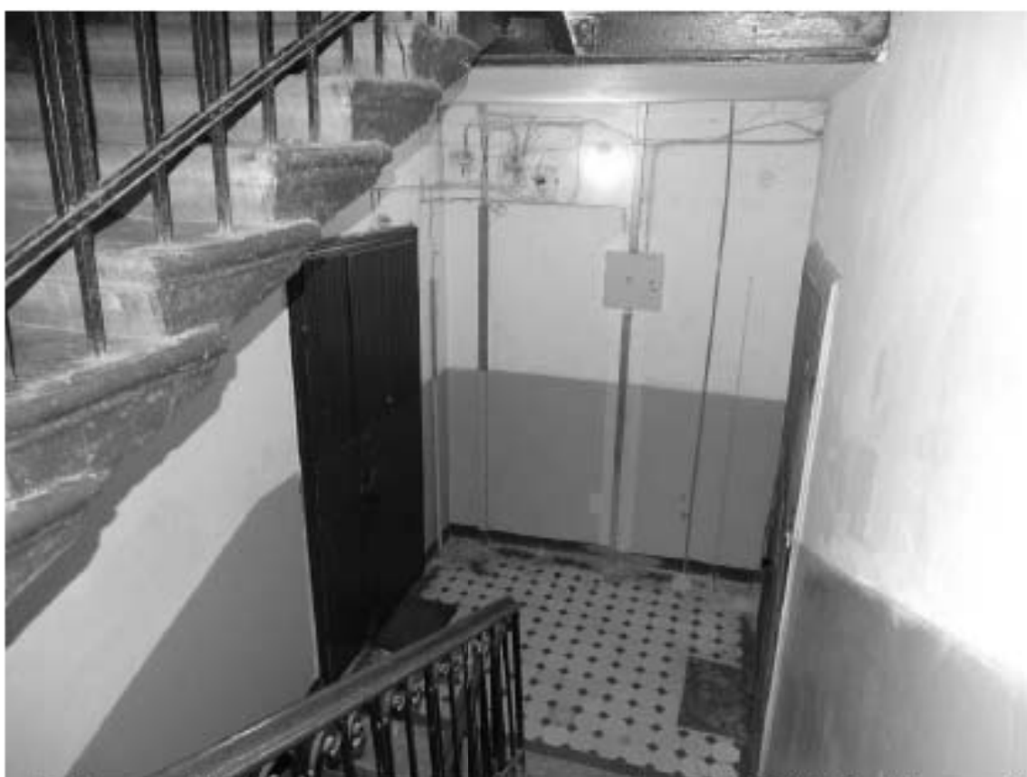
Фото 89. Лестница № 3. Вид на площадку 3-го этажа. Съемка 19.04.2021 г. Штиглиц М. С.
