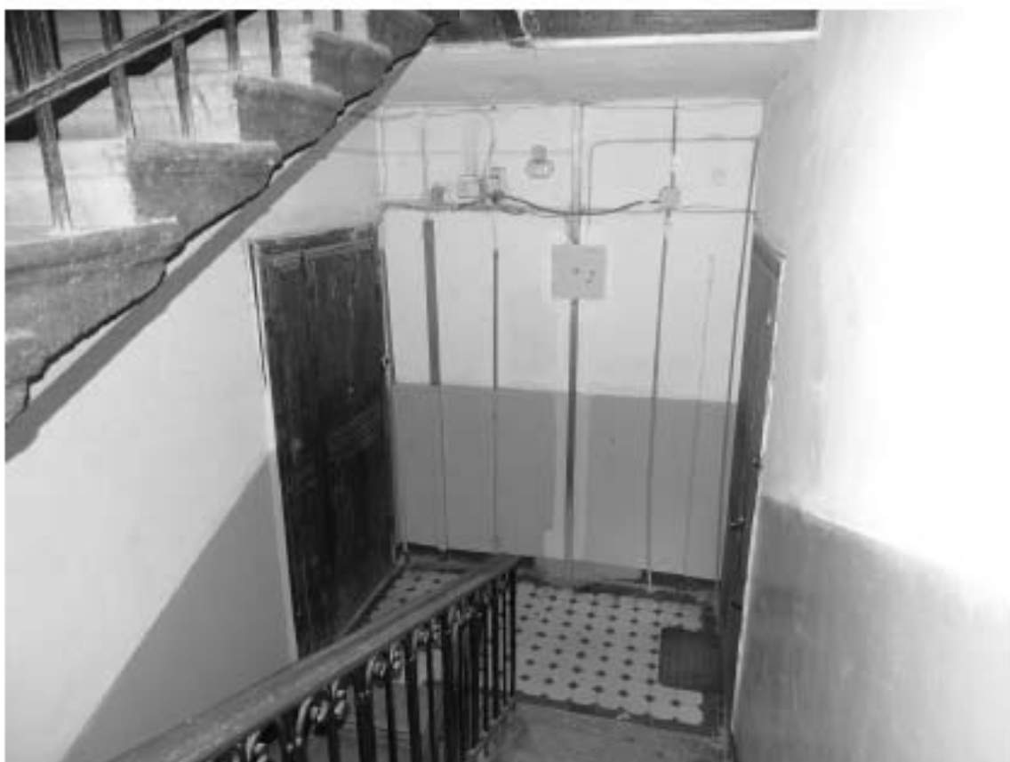
Фото 86. Лестница № 3. Вид на площадку 2-го этажа. Съемка 19.04.2021 г. Штиглиц М. С.
