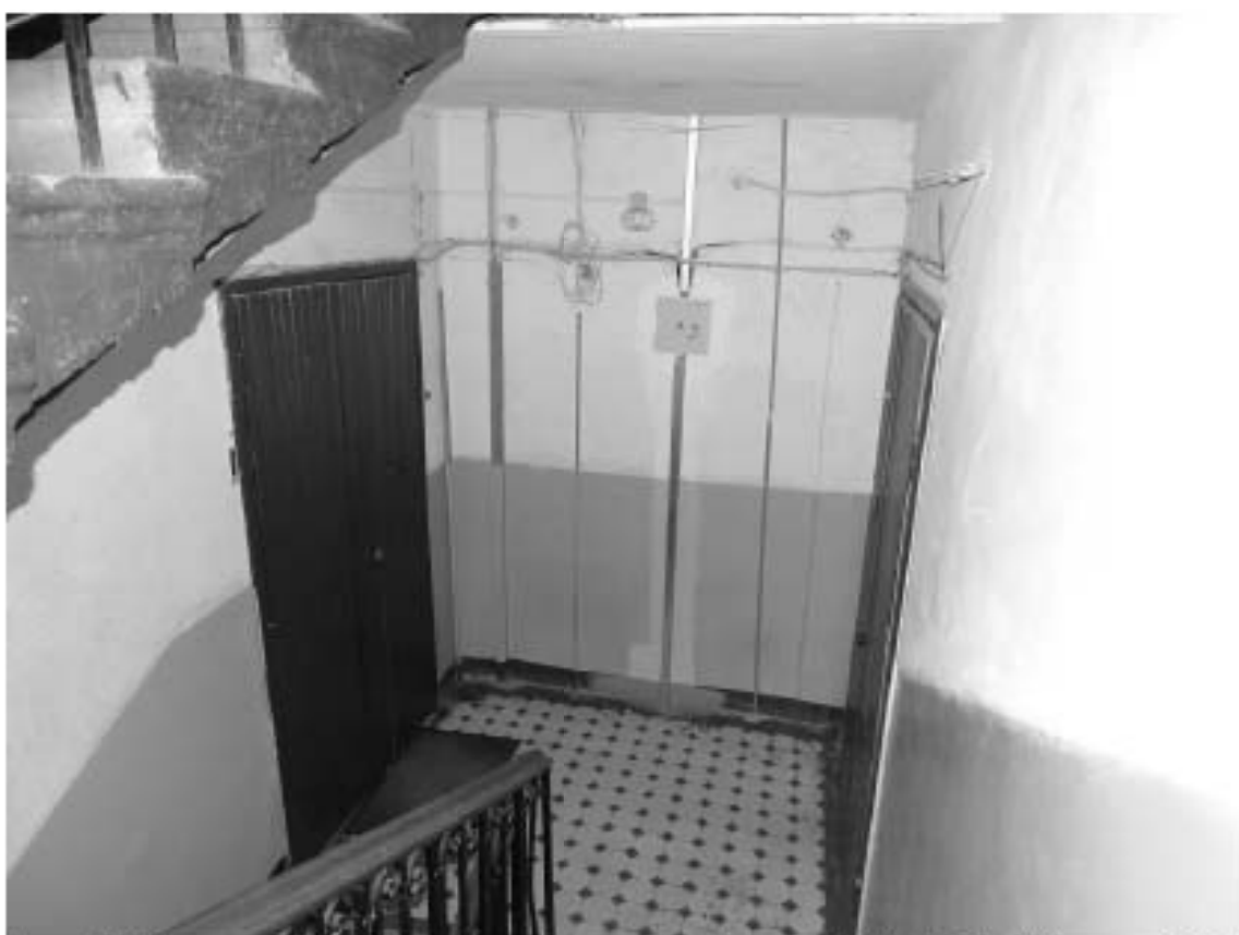
Фото 91. Лестница № 3. Площадка 4-го этажа. Съемка 19.04.2021 г. Штиглиц М. С.
