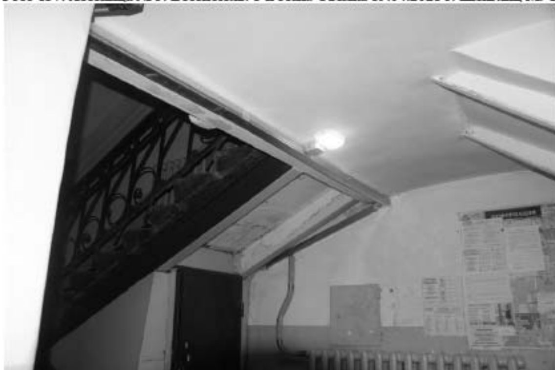
Фото 138. Лестница № 5. Вестибюль. 1-й этаж. Съёмка 19.04.2021 г. Штиглиц М. С.
