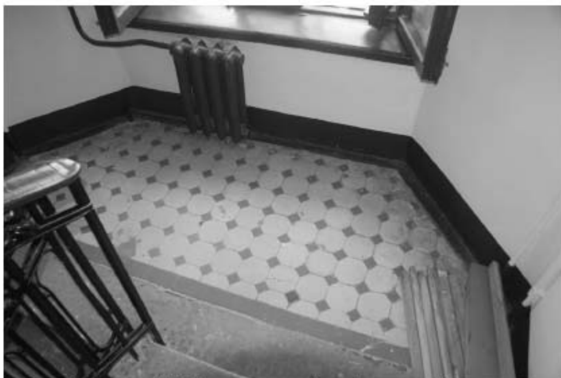
Фото 41. Лестница № 1. Площадка между 5-м и 6-м этажом. Покрытие пола. Съемка 19.04.2021 г. Штиглиц М. С.
