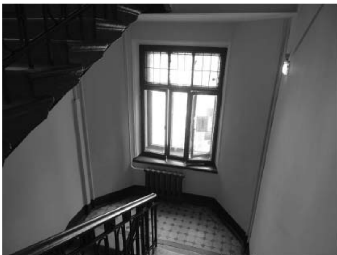
Фото 28. Лестница № 1. Вид на площадку м/у 3-м и 4-м этажом. Съемка 19.04.2021 г. Штиглиц М. С.
