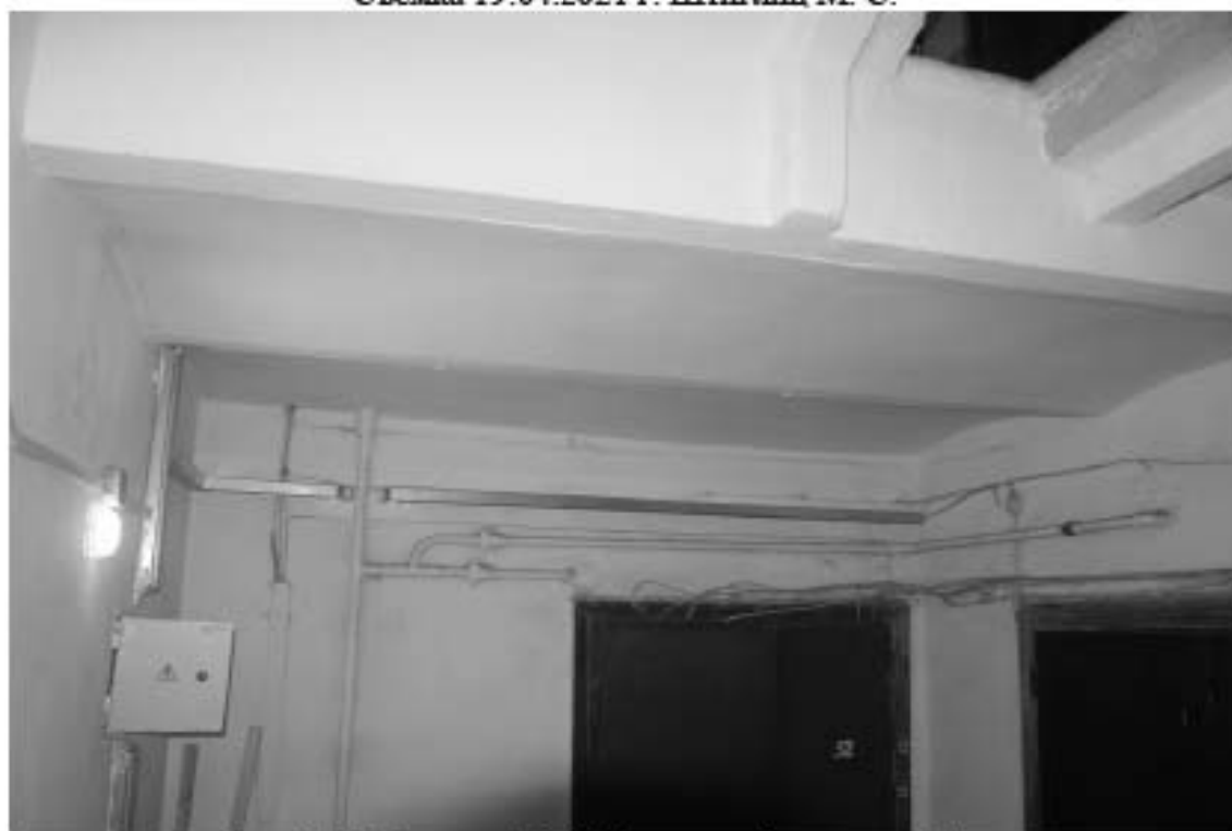
Фото 126. Лестница № 4. Площадка 4-го этажа. Своды. Съемка 19.04.2021 г. Штиглиц М. С.
