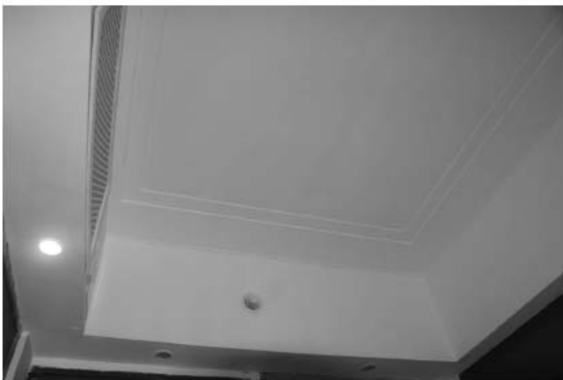
Фото 46. Лестница № 1. 6 этаж. Оформление потолка. Съемка 19.04.2021 г. Штиглиц М. С.
