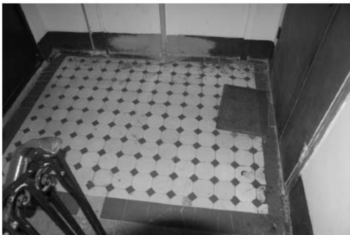
Фото 69. Лестница № 2. Площадка 5-го этажа. Покрытие пола. Съемка 19.04.2021 г. Штиглиц М. С.
