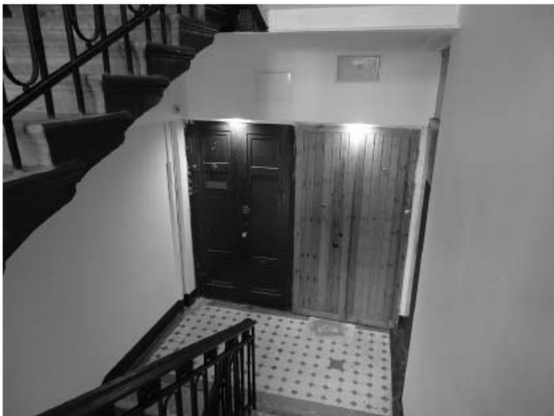
Фото 25. Лестница № 1. Вид на площадку 3-го этажа. Съемка 19.04.2021 г. Штиглиц М. С.
