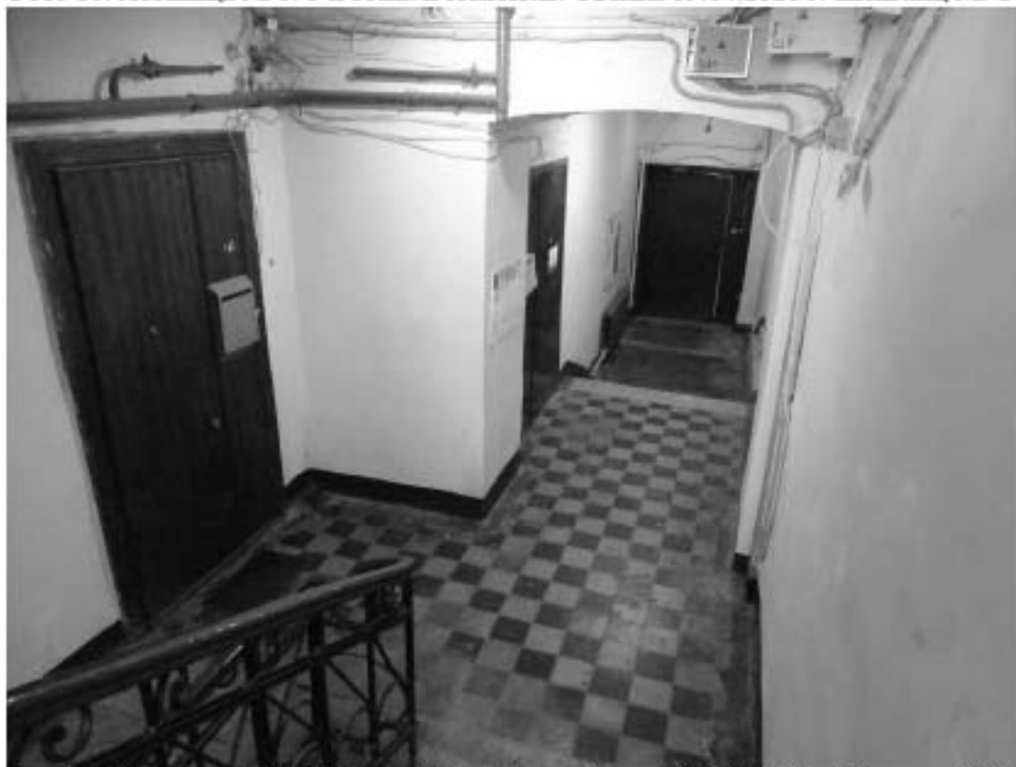
Фото 87. Лестница № 8. 1-й этаж. Вестибюль. Съёмка 19.04.2021 г. Штиглиц М. С.
