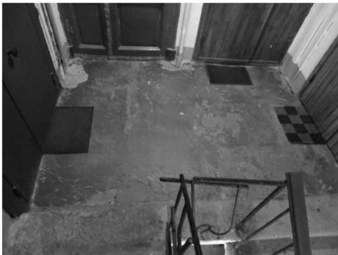
Фото 28. Лестница № 6. 5-й этаж. Покрытие пола. Съёмка 19.04.2021 г. Штиглиц М. С.
