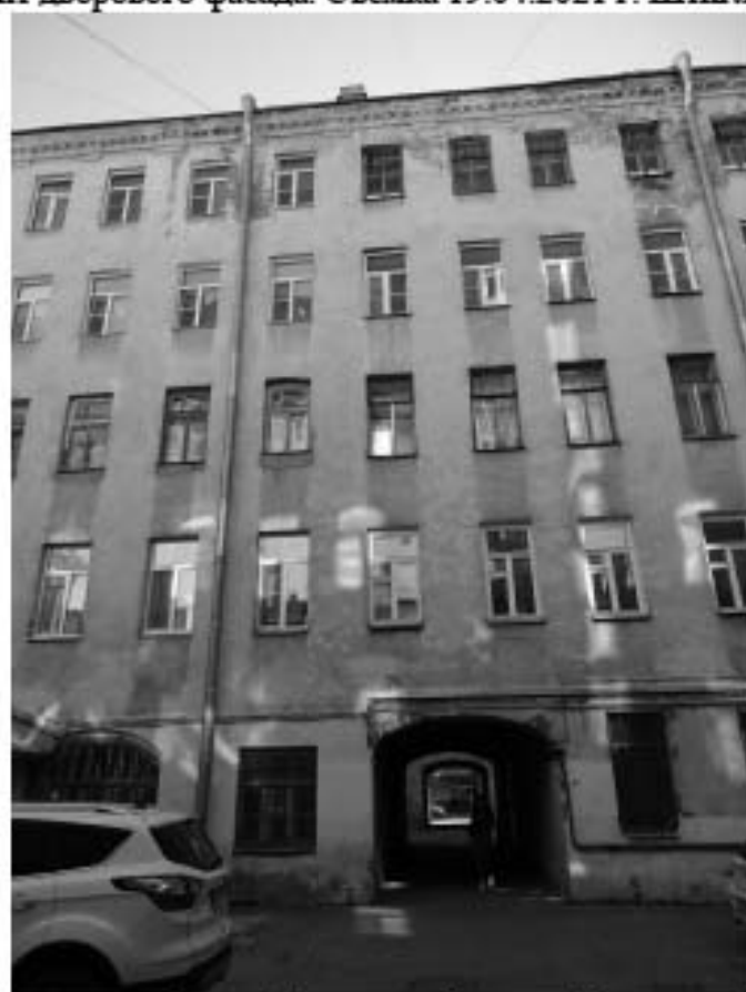
Фото 20. Здание по адресу: г. Санкт-Петербург, Большая Зеленина ул., дом 29, литера Б. Фрагмент дворового фасада. Съемка 19.04.2021 г. Штиглиц М. С.
