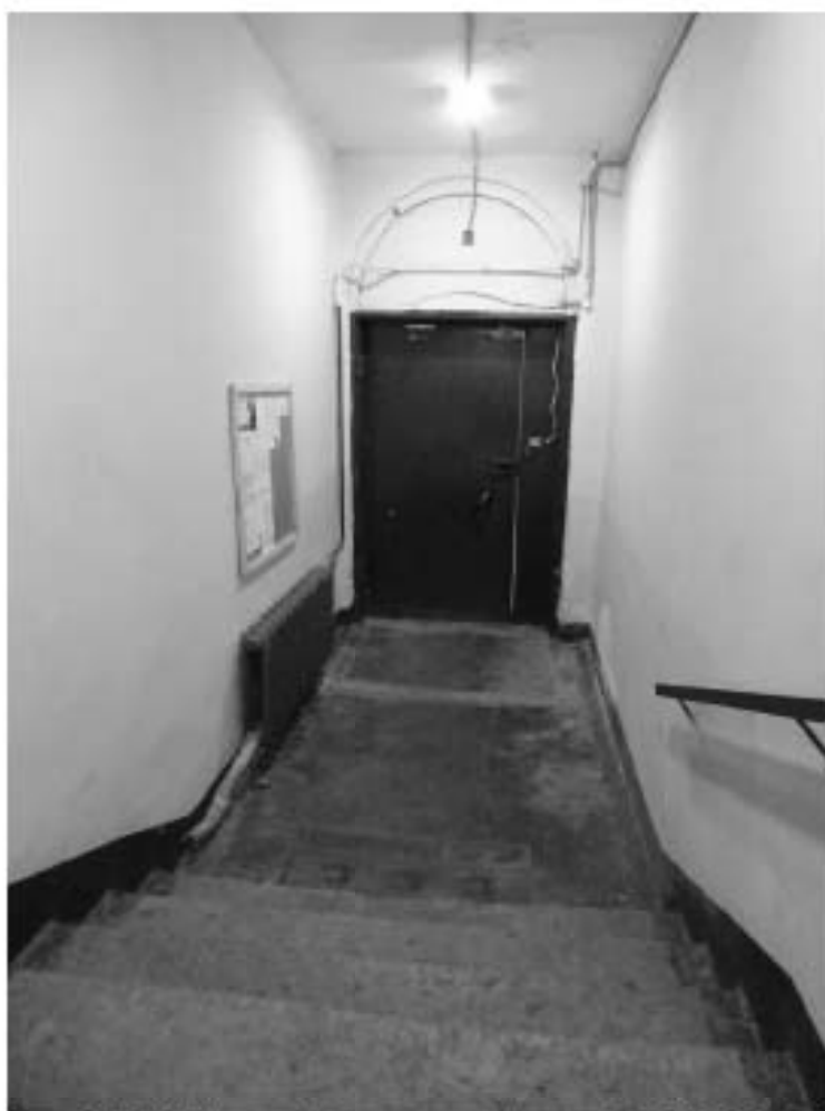
Фото 86. Лестница № 8. 1-й этаж. Вестибюль. Съёмка 19.04.2021 г. Штиглиц М. С.
