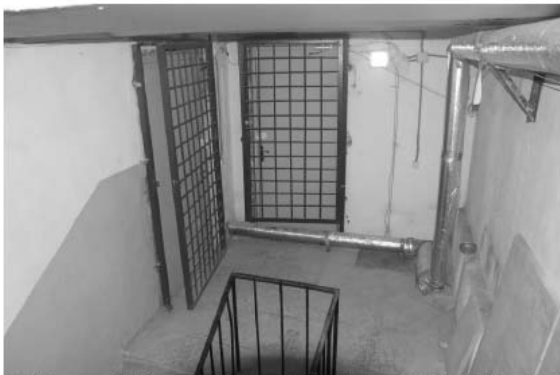
Фото 74. Лестница № 7. Выход на технический этаж. Съемка 19.04.2021 г. Штиглиц М. С.
