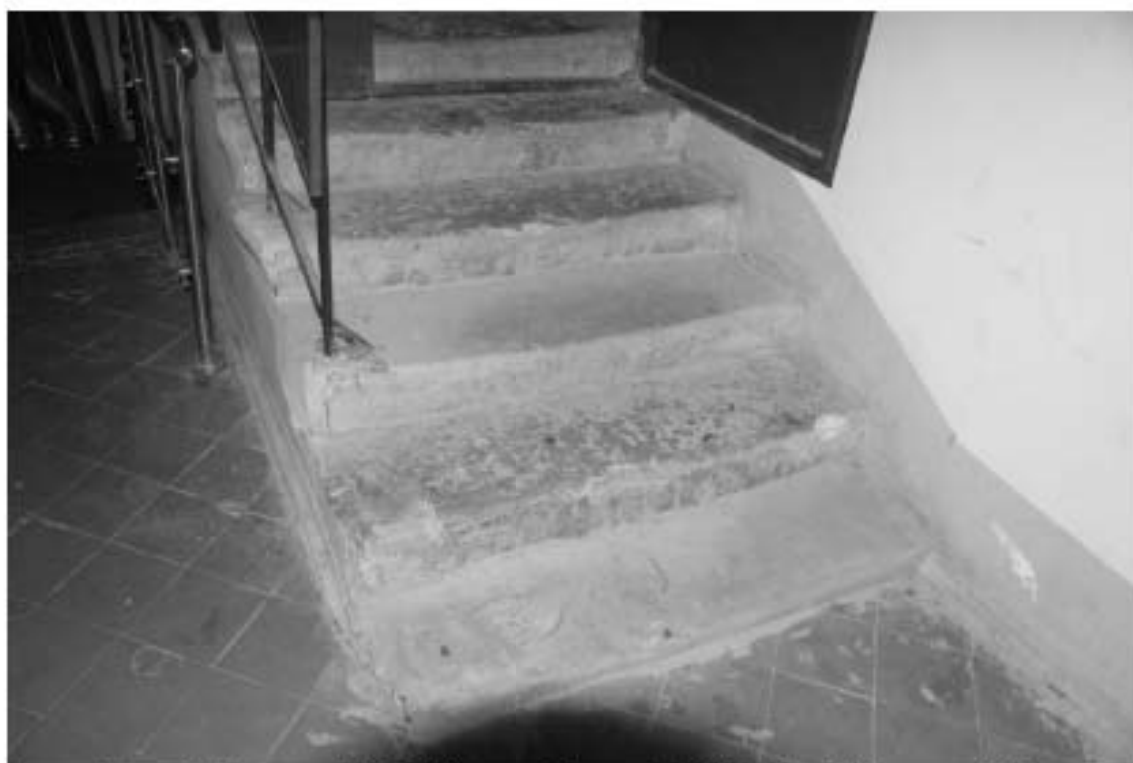
Фото 9. Лестница № 6. 1-й этаж. Съемка 19.04.2021 г. Штиглиц М. С.
