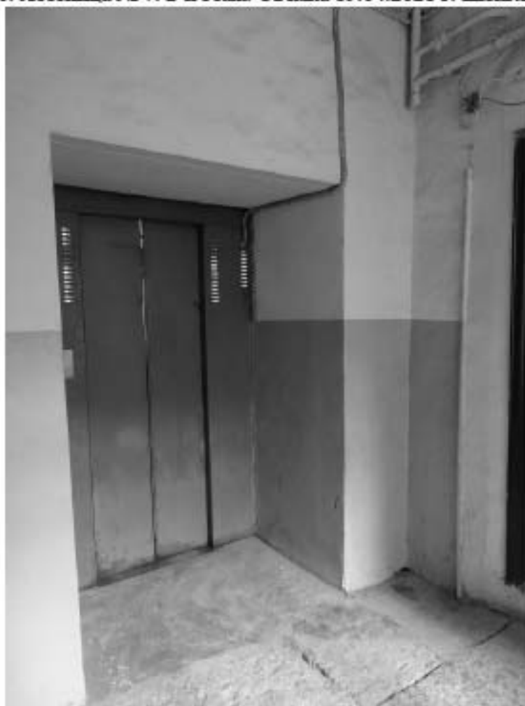
Фото 51. Лестница № 7. 2-й этаж. Съемка 19.04.2021 г. Штиглиц М. С.
