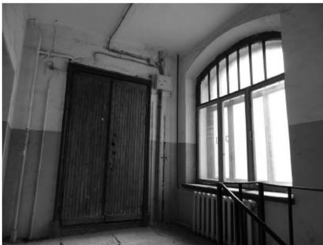
Фото 58. Лестница № 7. 3-й этаж. Съемка 19.04.2021 г. Штиглиц М. С.
