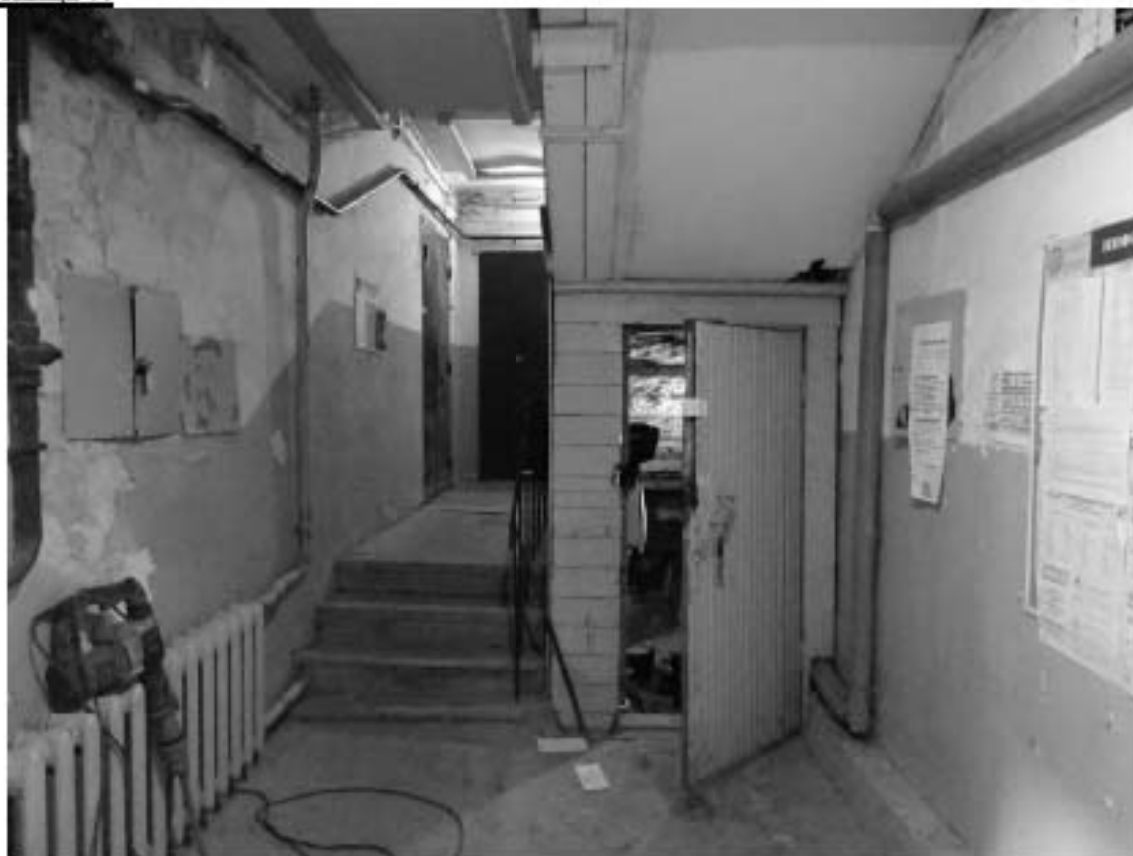
Фото 34. Лестница № 7. 1-й этаж. Съемка 19.04.2021 г. Штиглиц М. С.
