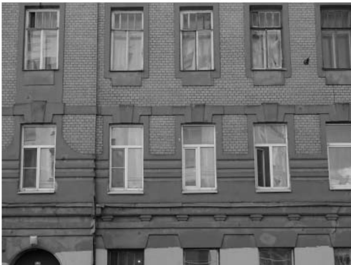
Фото 7. Здание по адресу: г. Санкт-Петербург, Большая Зеленина ул., дом 29, литера Б. Фрагмент лицевого фасада по ул. Петрозаводской. Съемка 19.04.2021 г. Штиглиц М. С.
