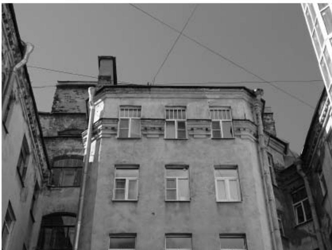
Фото 25. Здание по адресу: г. Санкт-Петербург, Большая Зеленина ул., дом 29, литера Б. Фрагмент дворового фасада. Съемка 19.04.2021 г. Штиглиц М. С.
