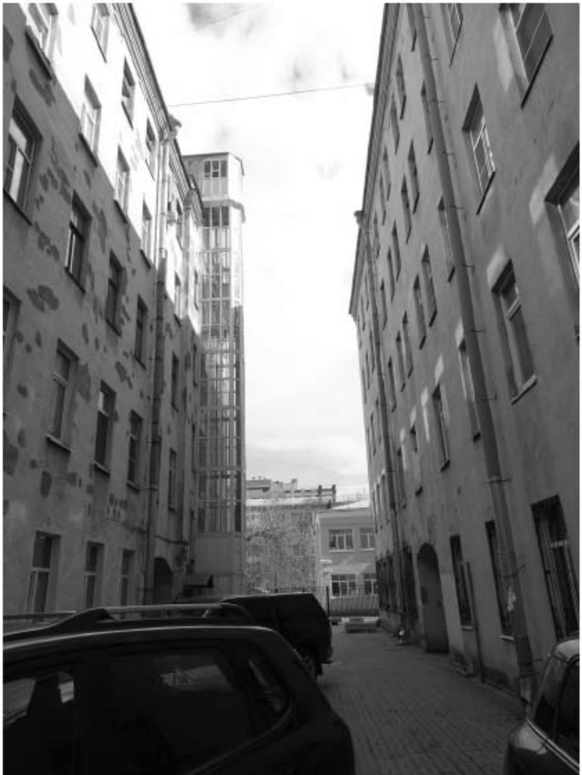
Фото 35 Здание по адресу: г. Санкт-Петербург, Большая Зеленина ул., дом 29, литера Б. Северо-восточный и юго-западный фасад 5-ти этажного корпуса. Съемка 19.04.2021 г. Штиглиц М. С.
