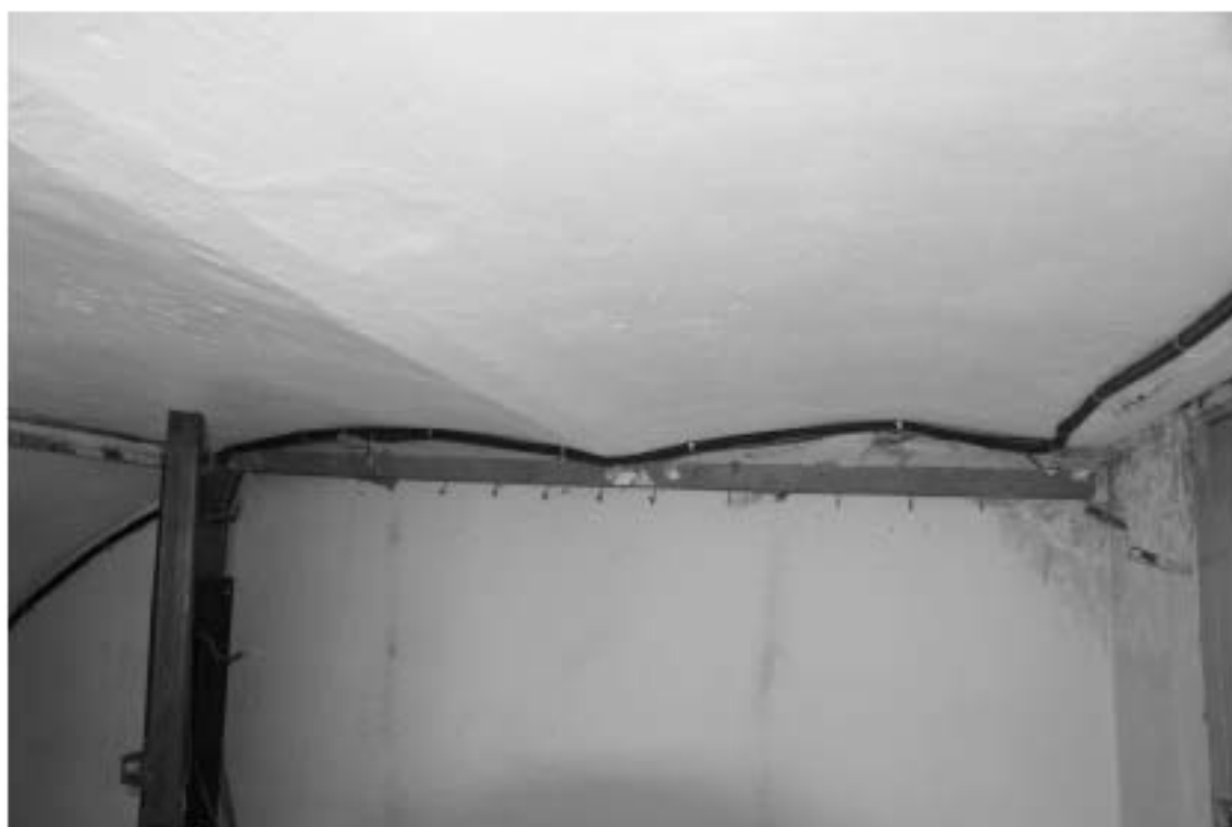
Фото 83. Лестница № 7. Технический этаж. Своды. Съемка 19.04.2021 г. Штиглиц М. С.
