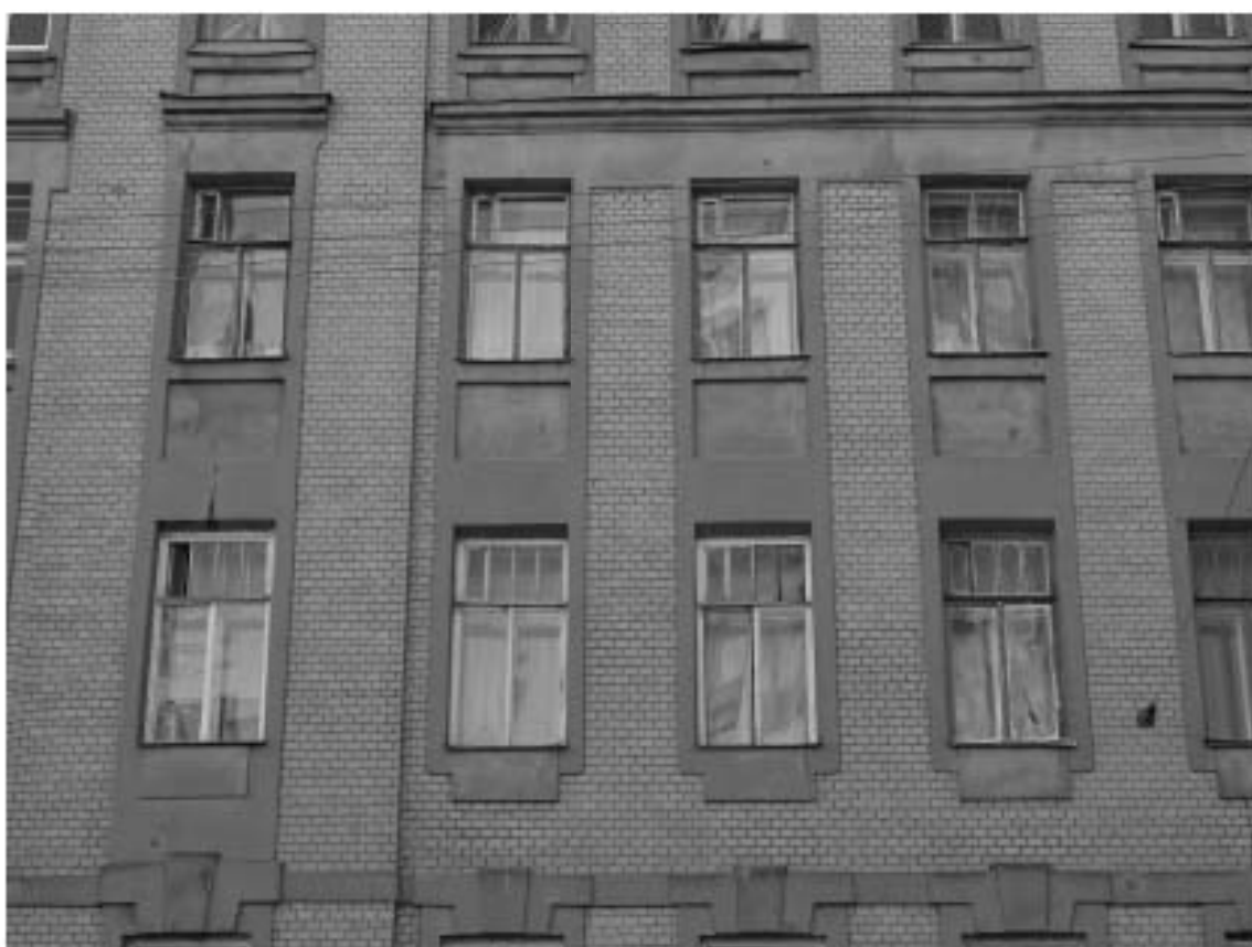
Фото 6. Здание по адресу: г. Санкт-Петербург, Большая Зеленина ул., дом 29, литера Б. Фрагмент лицевого фасада по ул. Петрозаводской. Съемка 19.04.2021 г. Штиглиц М. С.
