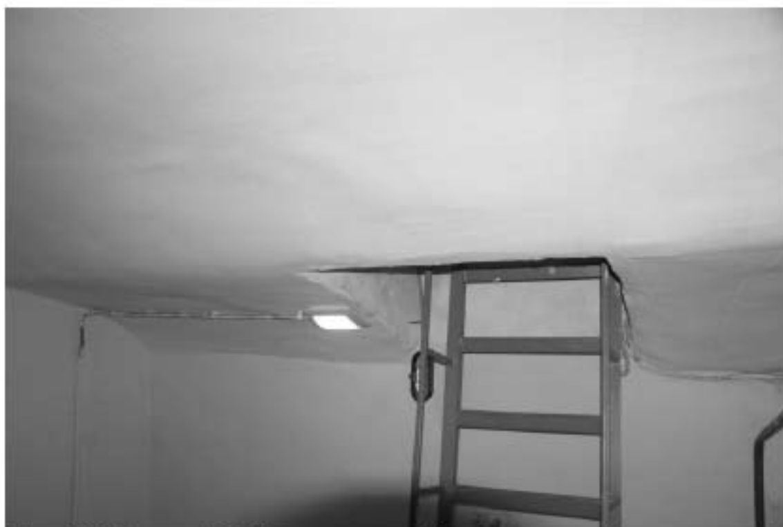
Фото 112. Лестница № 8. Площадка между 5-м и 6-м этажом. Выход на кровлю. Съемка 19.04.2021 г. Штиглиц М. С.
