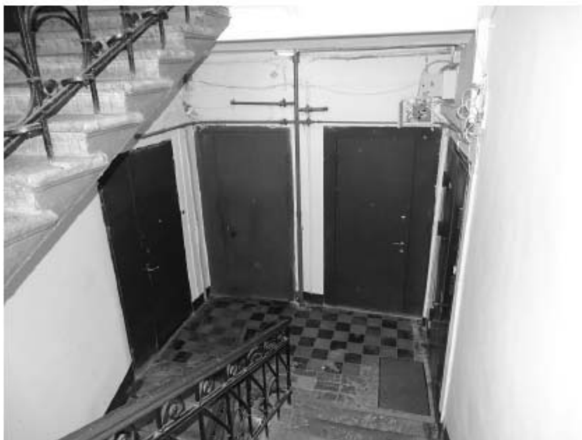
Фото 96. Лестница № 8. 2-й этаж. Съемка 19.04.2021 г. Штиглиц М. С.
