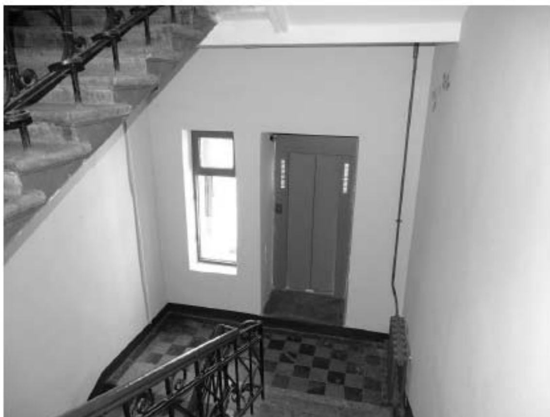
Фото 98. Лестница № 8. Площадка между 2-м и 3-м этажом. Съемка 19.04.2021 г. Штиглиц М. С.
