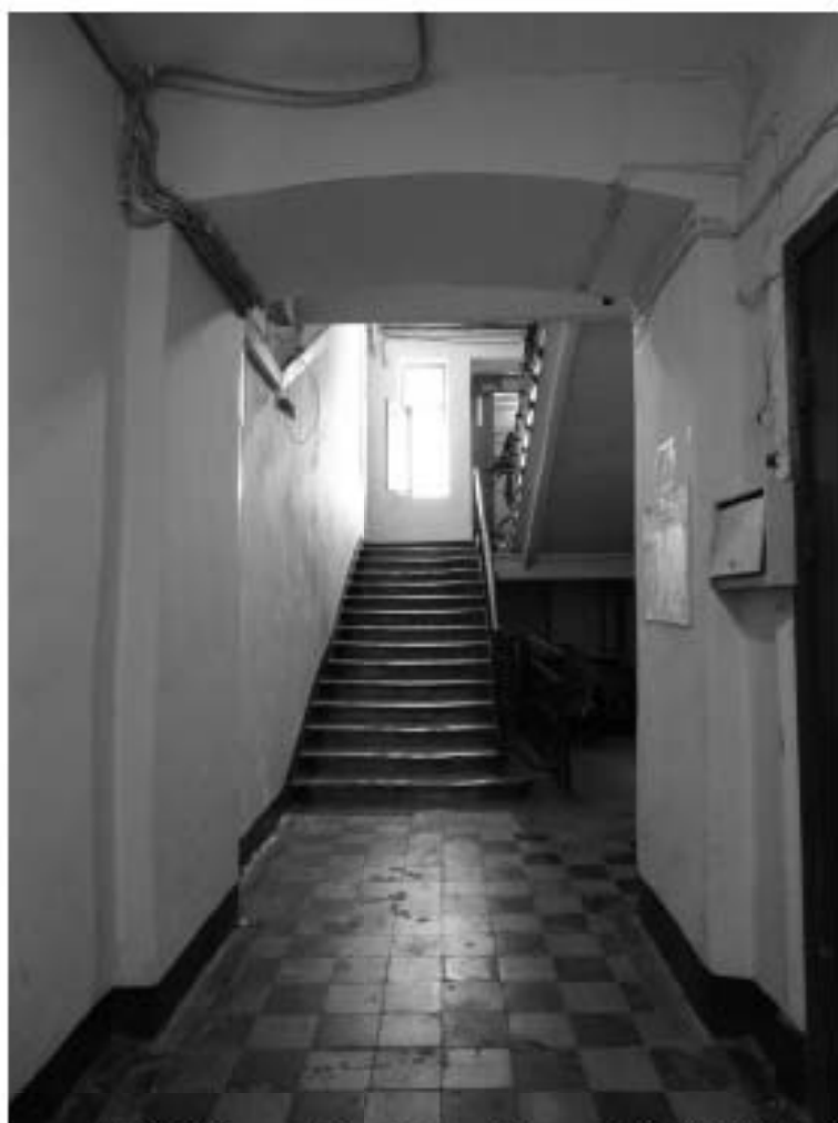
Фото 88. Лестница № 8. 1-й этаж. Вестибюль. Съёмка 19.04.2021 г. Штиглиц М. С.
