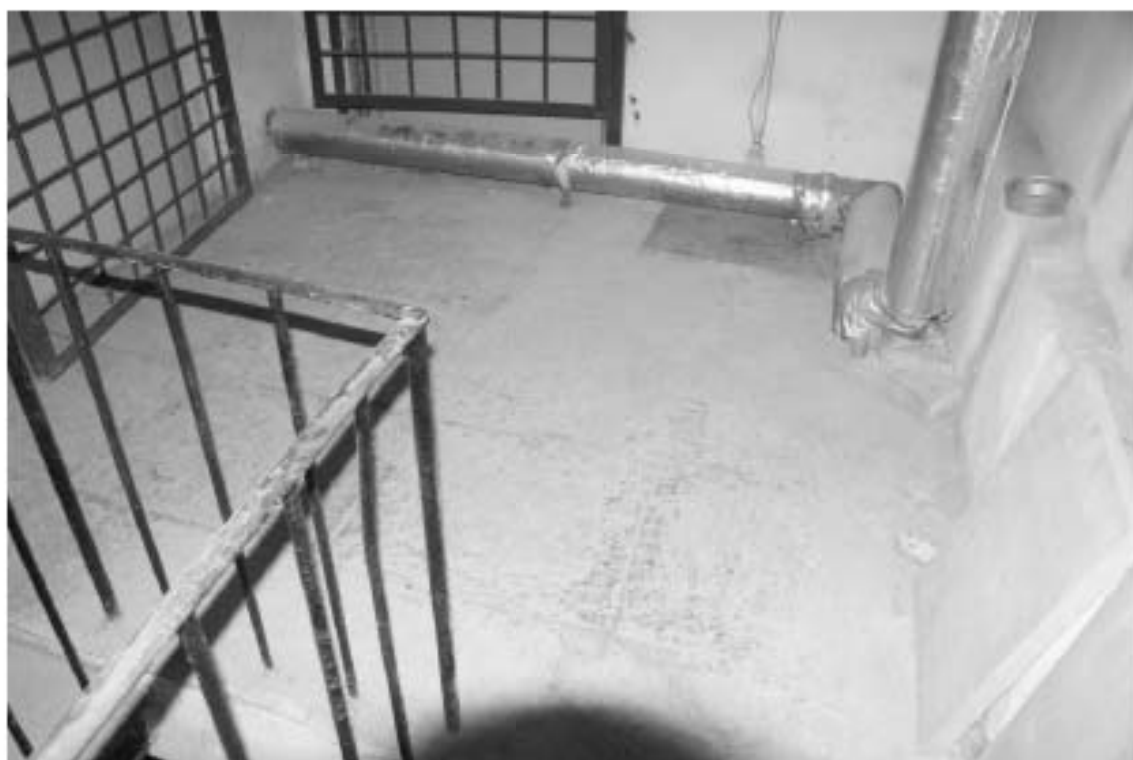
Фото 75. Лестница № 7. Выход на технический этаж. Съемка 19.04.2021 г. Штиглиц М. С.
