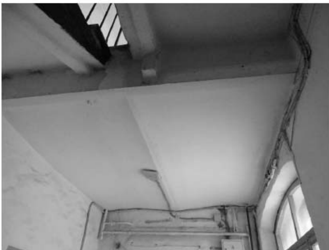
Фото 52. Лестница № 7. 1-й этаж. Своды. Съёмка 19.04.2021 г. Штиглиц М. С.
