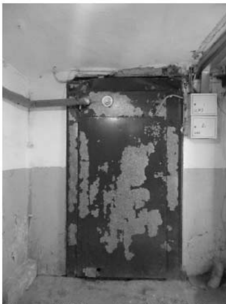
Фото 38. Лестница № 7. 1-й этаж. Съемка 19.04.2021 г. Штиглиц М. С.
