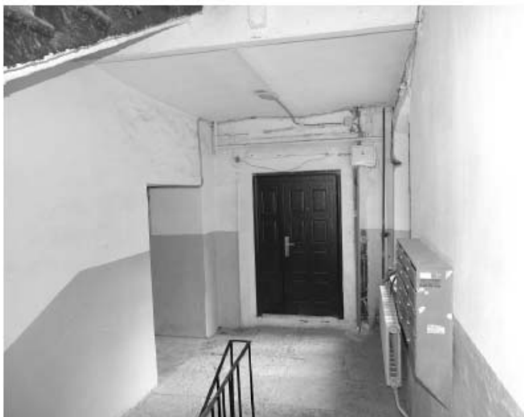
Фото 50. Лестница № 7. 2-й этаж. Съемка 19.04.2021 г. Штиглиц М. С.
