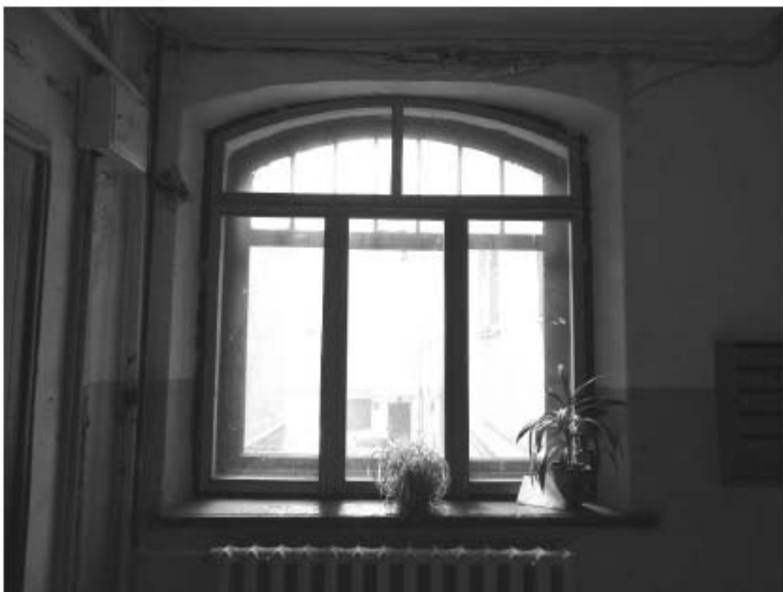
Фото 53. Лестница № 7. 1-й этаж. Съёмка 19.04.2021 г. Штиглиц М. С.
