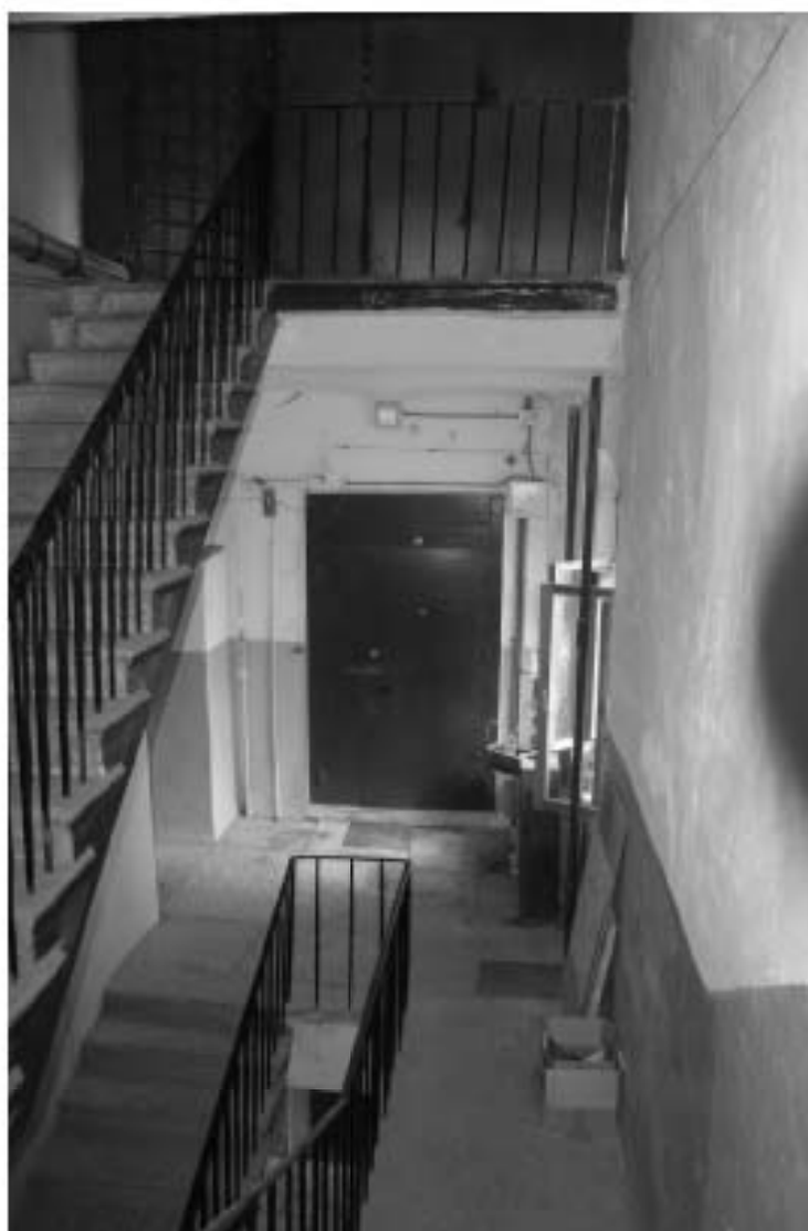
Фото 70. Лестница № 7. 6-й этаж. Съемка 19.04.2021 г. Штиглиц М. С.
