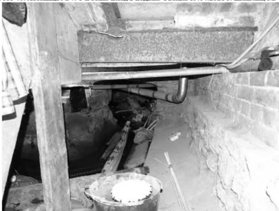
Фото 41. Лестница № 7. Подвал. Съемка 19.04.2021 г. Штиглиц М. С.
