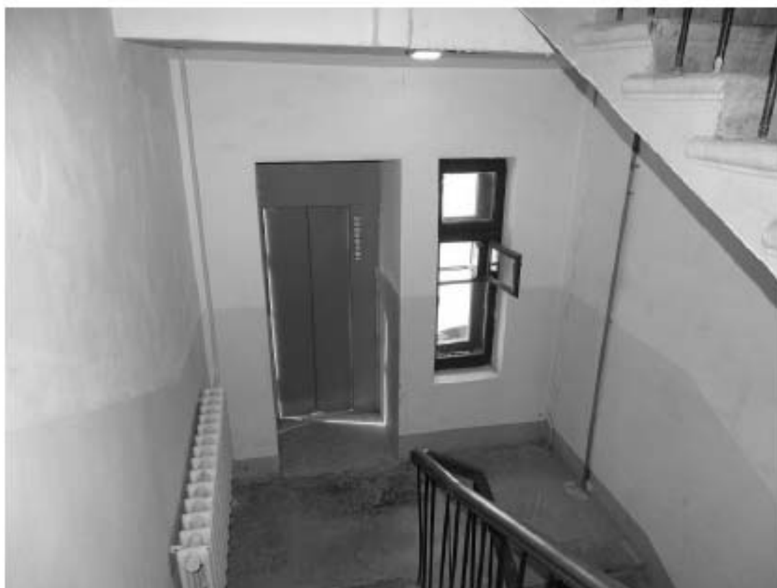
Фото 17. Лестница № 6. Площадка между 2-м и 3-м этажом. Съемка 19.04.2021 г. Штиглиц М. С.
