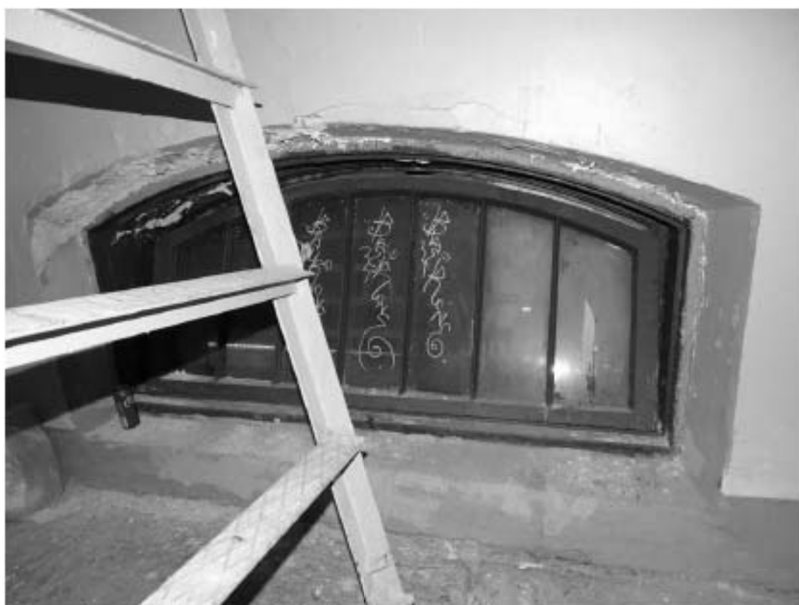
Фото 30. Лестница № 6. Площадка между 5-м и чердачным этажом. Съемка 19.04.2021 г. Штиглиц М. С.
