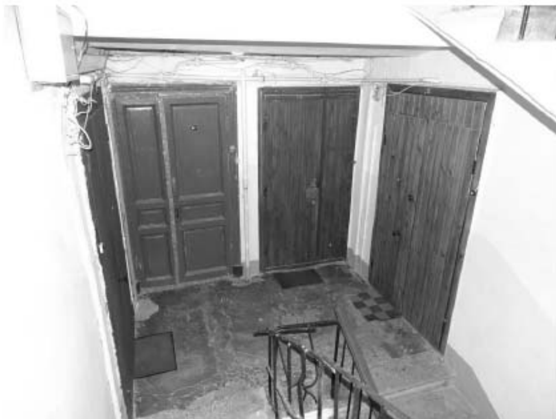
Фото 25. Лестница № 6. 5-й этаж. Съемка 19.04.2021 г. Штиглиц М. С.
