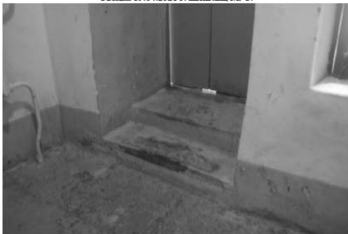
Фото 14. Лестница № 6. Площадка между 1-м и 2-м этажом. Съемка 19.04.2021 г. Штиглиц М. С.
