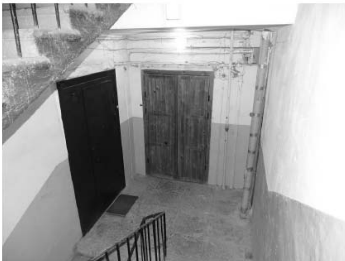
Фото 56. Лестница № 7. 2-й этаж. Съемка 19.04.2021 г. Штиглиц М. С.
