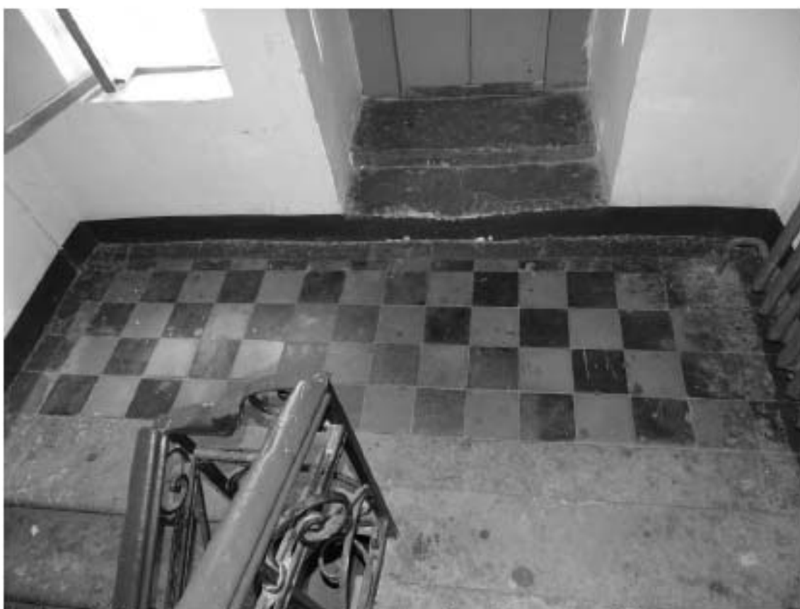
Фото 95. Лестница № 8. Площадка между 1-м и 2-м этажом. Покрытие пола. Съемка 19.04.2021 г. Штиглиц М. С.
