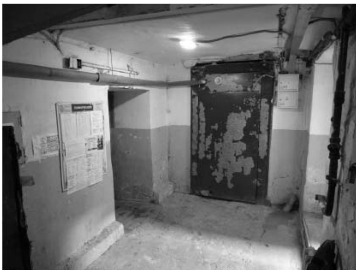
Фото 35. Лестница № 7. 1-й этаж. Съемка 19.04.2021 г. Штиглиц М. С.
