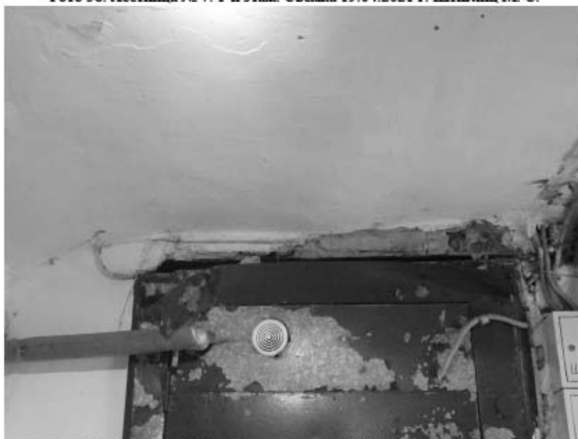
Фото 39. Лестница № 7. 1-й этаж. Съемка 19.04.2021 г. Штиглиц М. С.
