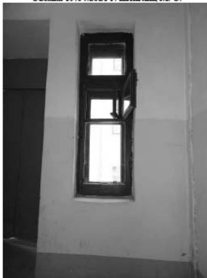
Фото 18. Лестница № 6. Площадка между 2-м и 3-м этажом. Съемка 19.04.2021 г. Штиглиц М. С.
