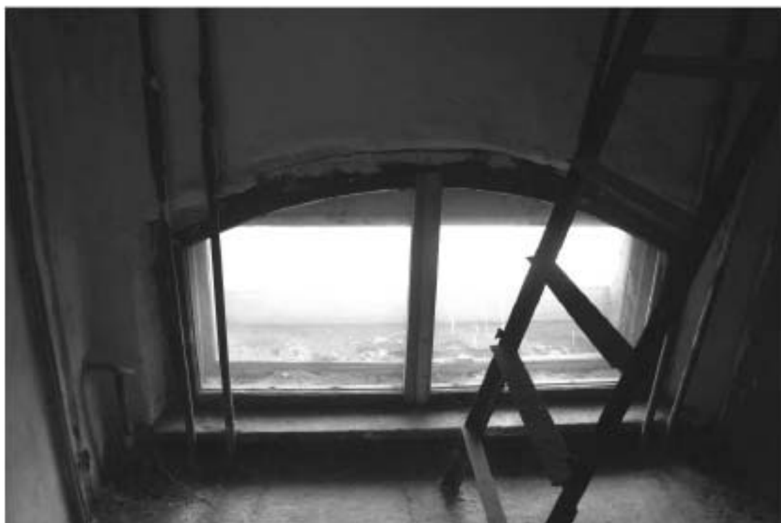
Фото 79. Лестница № 7. Технический этаж. Съемка 19.04.2021 г. Штиглиц М. С.
