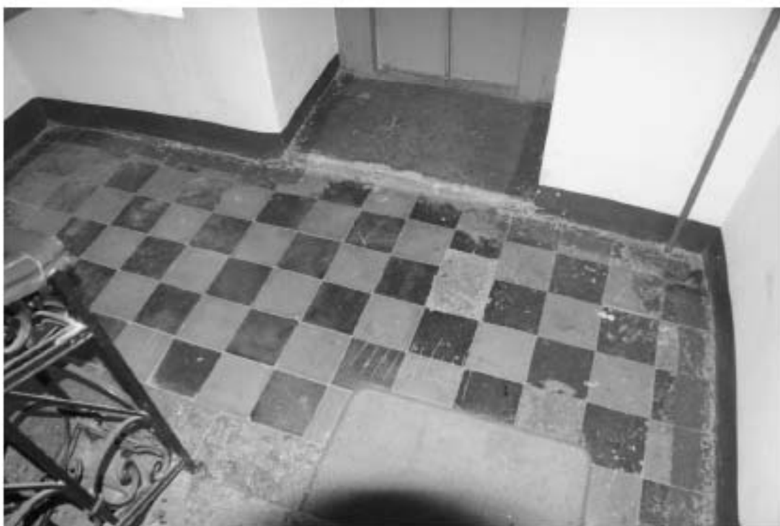
Фото 107. Лестница № 8. Площадка между 4-м и 5-м этажом. Покрытие пола. Съемка 19.04.2021 г. Штиглиц М. С.
