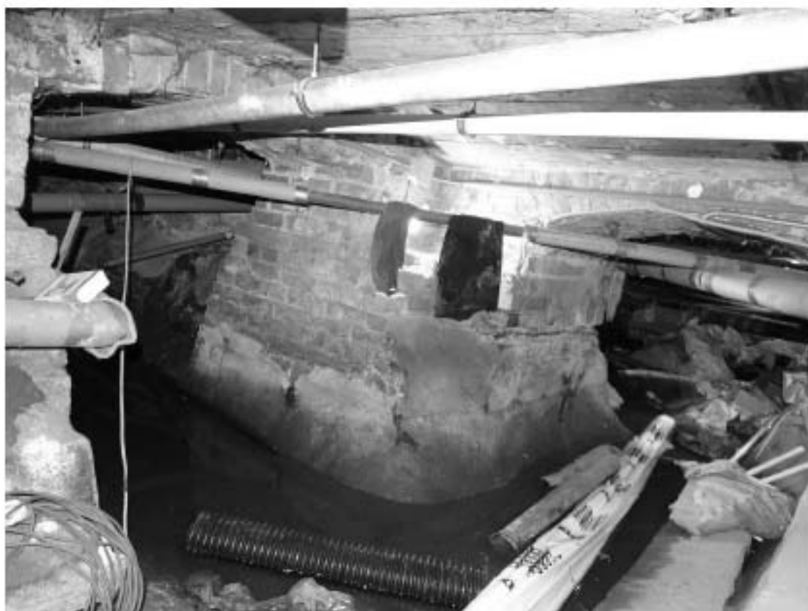
Фото 42. Лестница № 7. Подвал. Съемка 19.04.2021 г. Штиглиц М. С.
