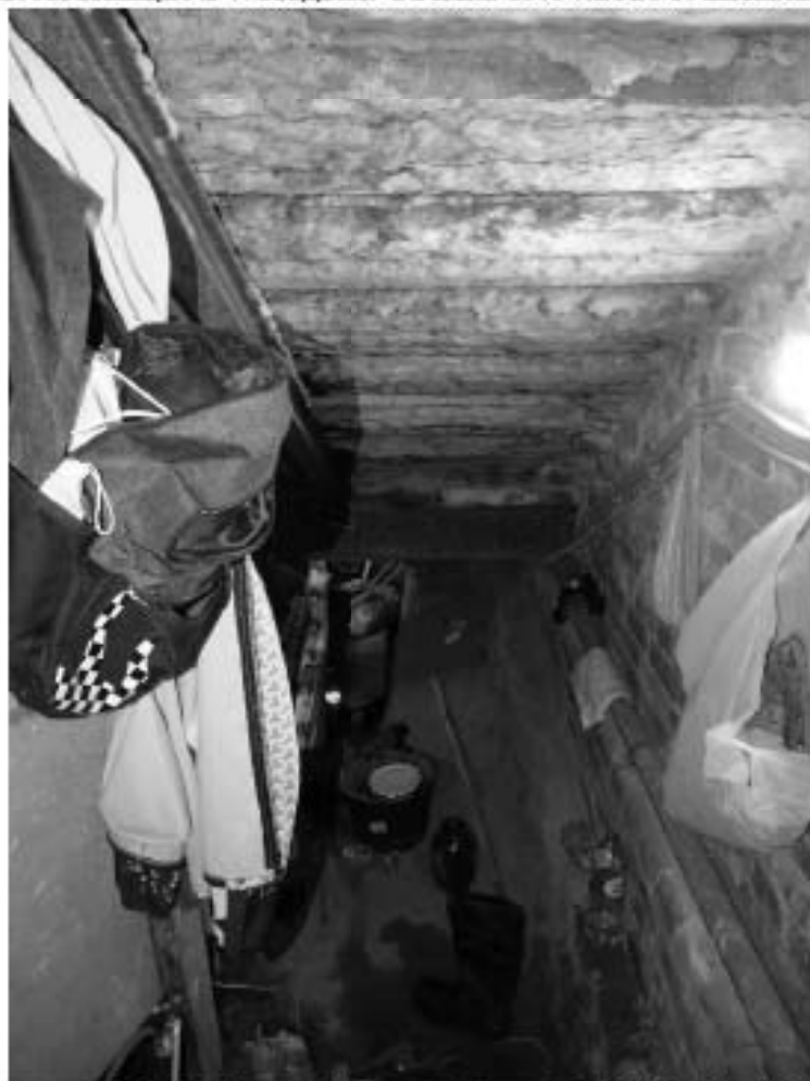
Фото 43. Лестница № 7. 1-й этаж. Подвал. Съемка 19.04.2021 г. Штиглиц М. С.
