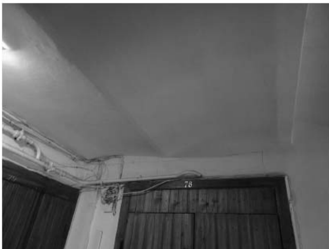
Фото 27. Лестница № 6. 5-й этаж. Своды. Съёмка 19.04.2021 г. Штиглиц М. С.
