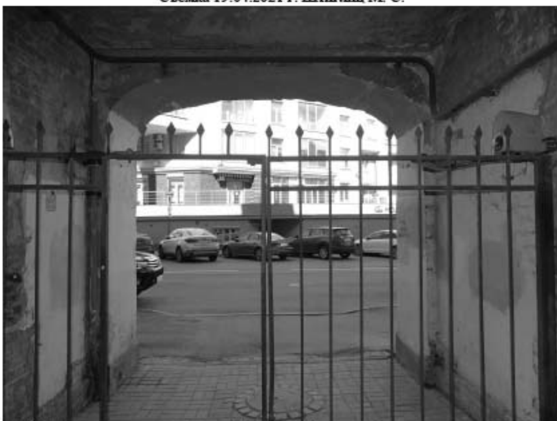
Фото 16. Здание по адресу: г. Санкт-Петербург, Большая Зеленина ул., дом 29, литера Б. Воротный проезд по фасаду ул. Петрозаводской. Съемка 19.04.2021 г. Штиглиц М. С.
