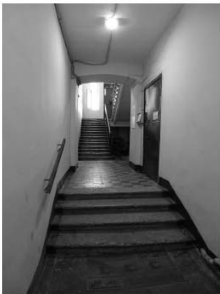
Фото 84. Лестница № 8. 1-й этаж. Вестибюль. Съёмка 19.04.2021 г. Штиглиц М. С.
