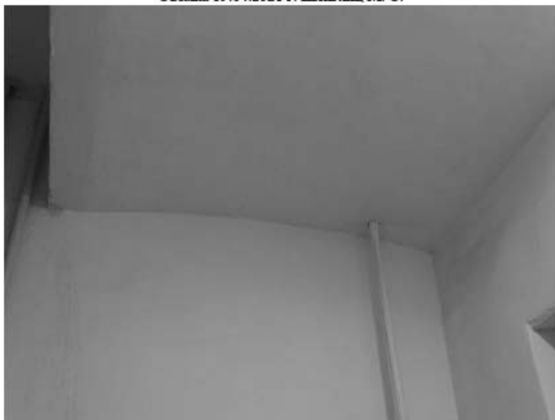
Фото 24. Лестница № 6. Площадка между 4-м и 5-м этажом. Съемка 19.04.2021 г. Штиглиц М. С.
