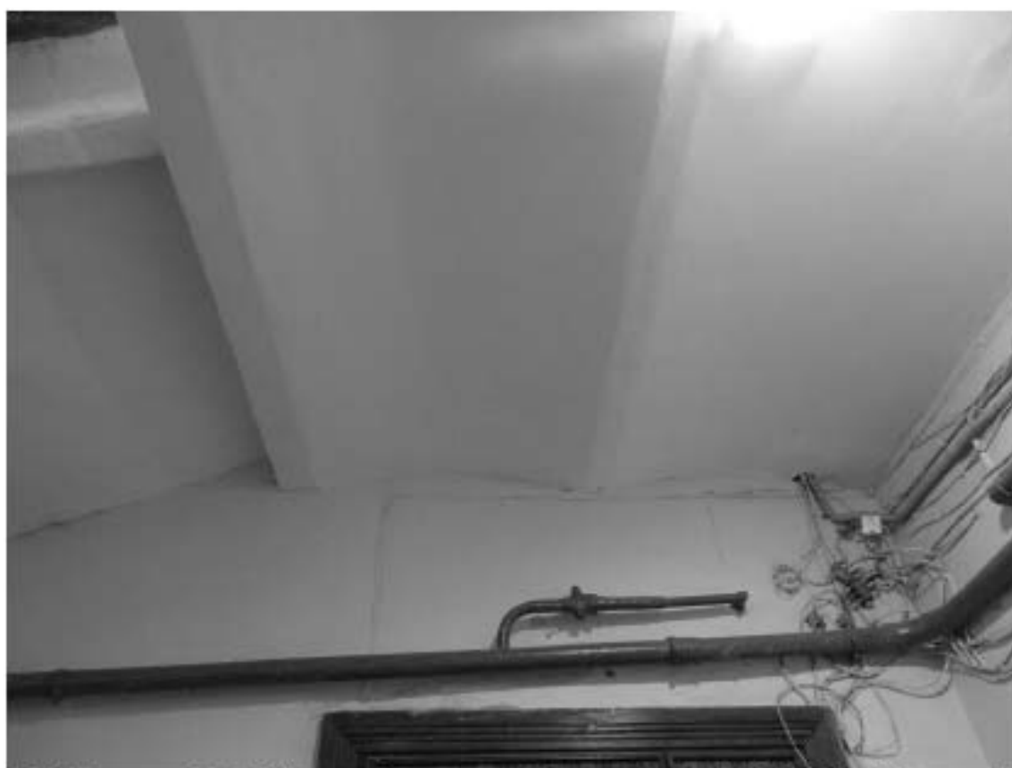
Фото 91. Лестница № 8. 1-й этаж. Вестибюль. Своды. Съемка 19.04.2021 г. Штиглиц М. С.
