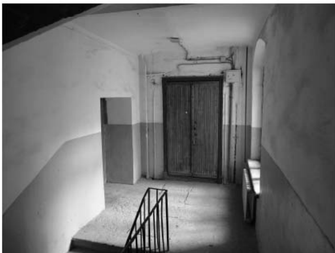
Фото 57. Лестница № 7. 3-й этаж. Съемка 19.04.2021 г. Штиглиц М. С.
