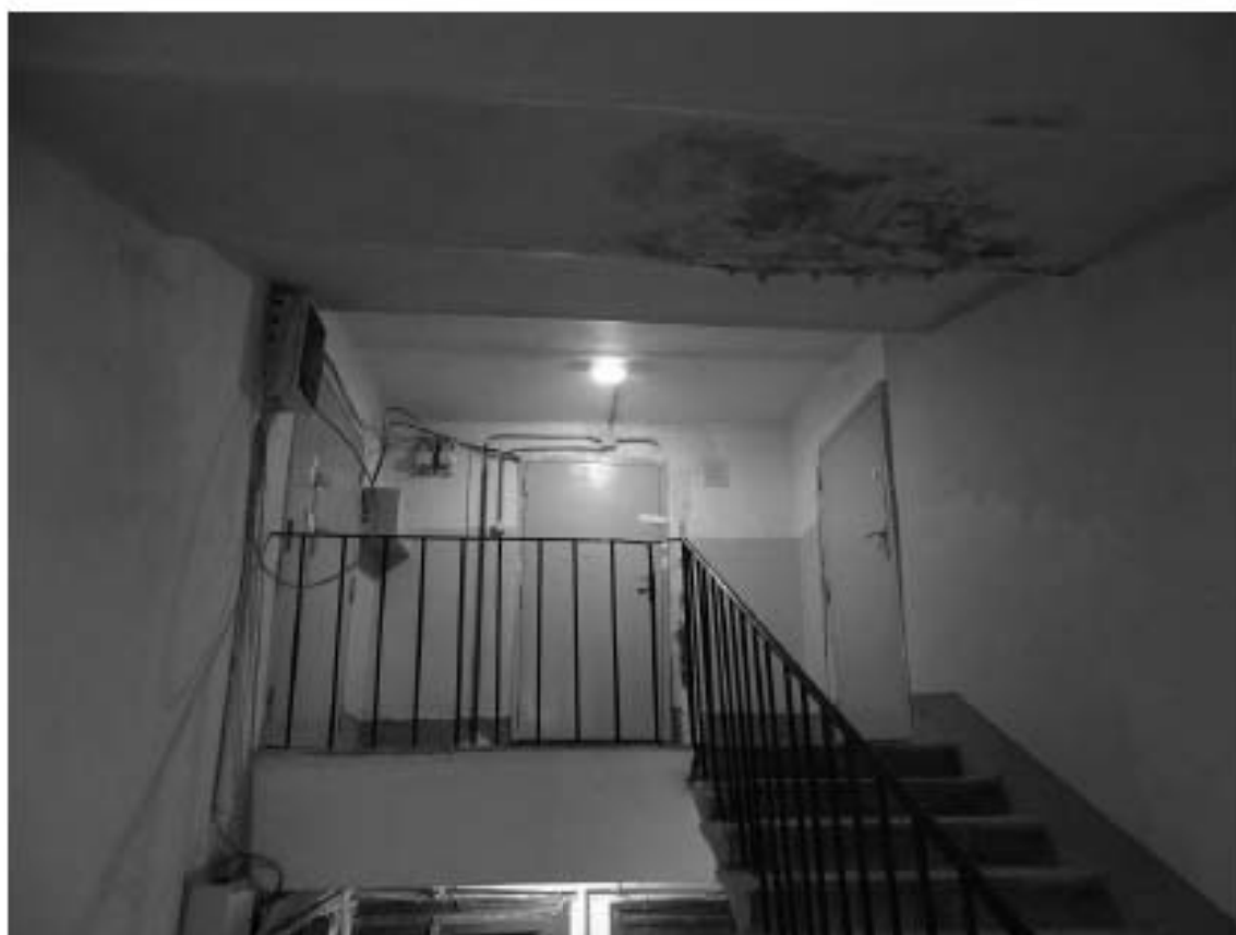
Фото 33. Лестница № 6. Чердачный этаж. Съемка 19.04.2021 г. Штиглиц М. С.
