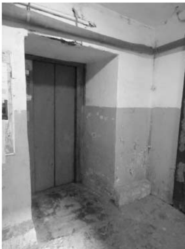
Фото 46. Лестница № 7. 1-й этаж. Съемка 19.04.2021 г. Штиглиц М. С.
