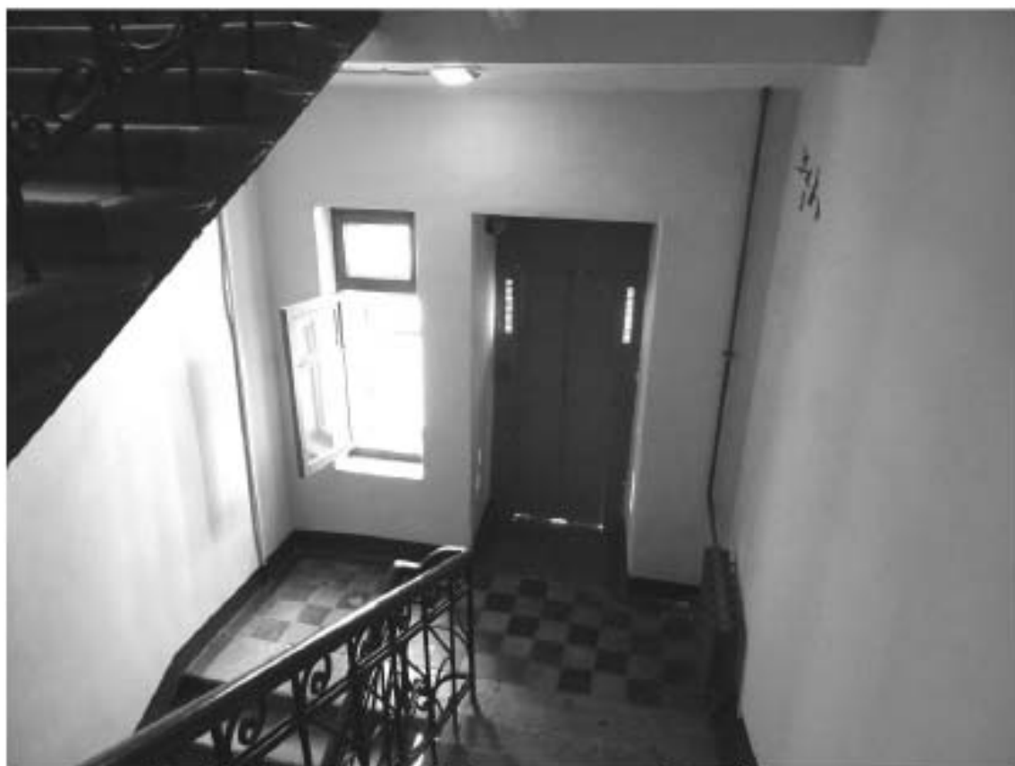
Фото 101. Лестница № 8. Площадка между 3-м и 4-м этажом. Съемка 19.04.2021 г. Штиглиц М. С.
