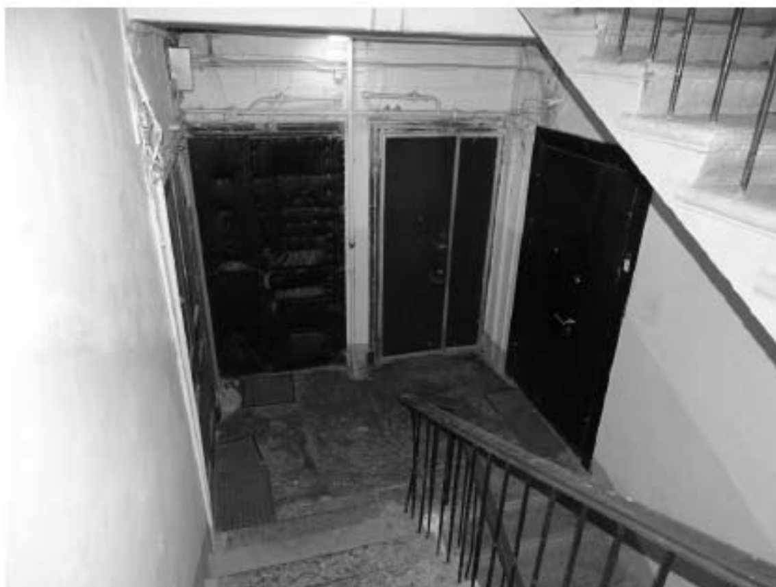
Фото 19. Лестница № 6. 3-й этаж. Съемка 19.04.2021 г. Штиглиц М. С.
