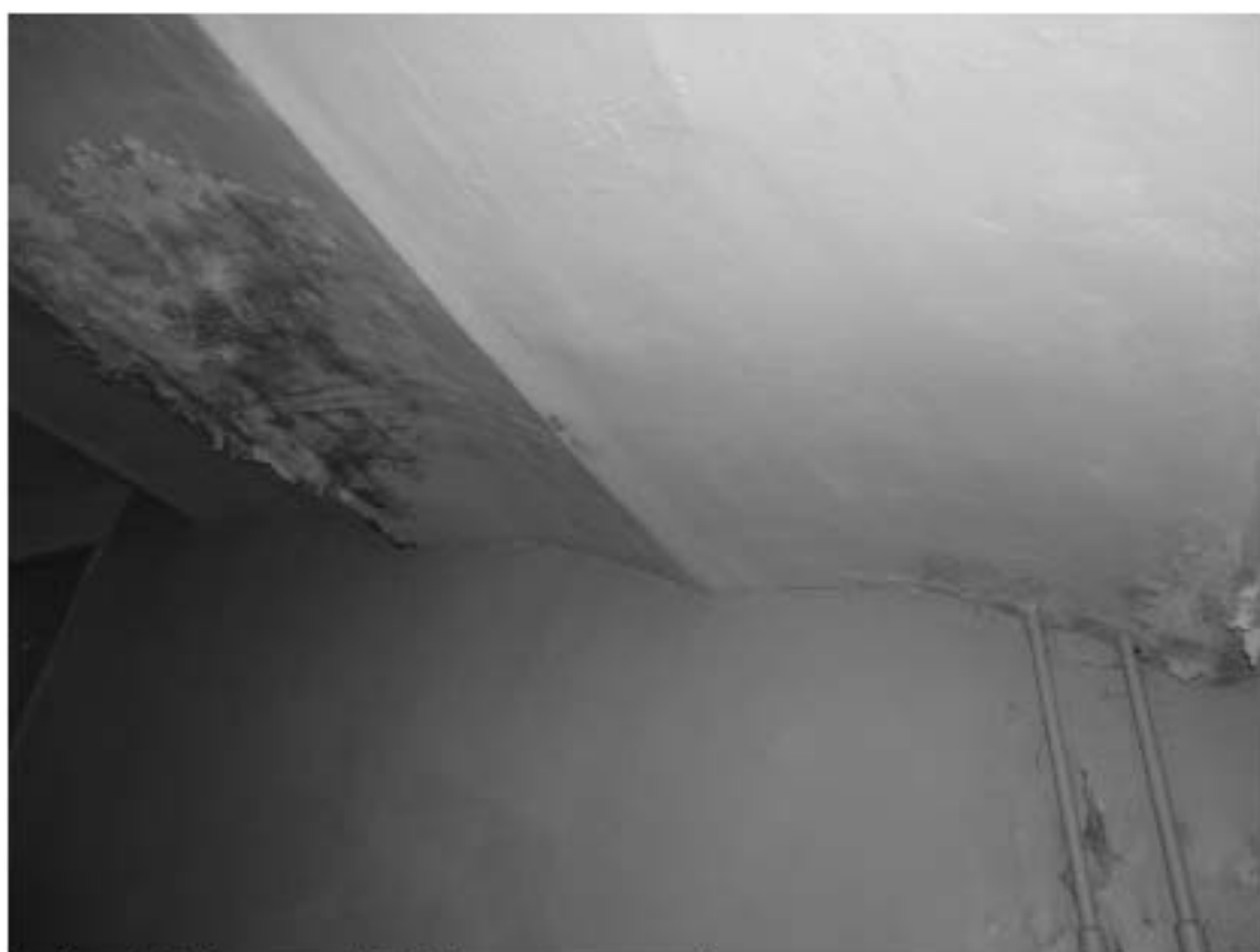
Фото 32. Лестница № 6. Площадка между 5-м и чердачным этажом. Своды. Съемка 19.04.2021 г. Штиглиц М. С.
