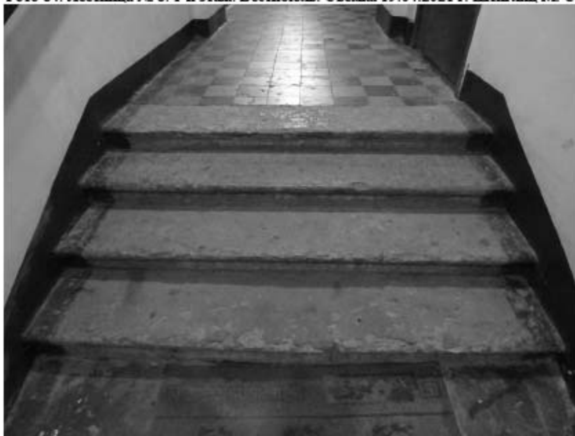
Фото 85. Лестница № 8. 1-й этаж. Вестибюль. Ступени. Съёмка 19.04.2021 г. Штиглиц М. С.
