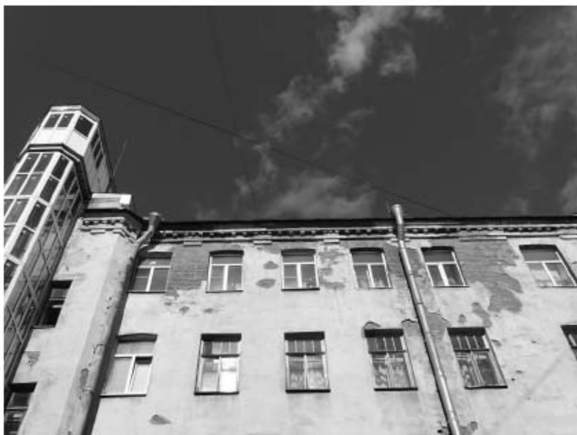
Фото 27. Здание по адресу: г. Санкт-Петербург, Большая Зеленина ул., дом 29, литера Б. Фрагмент дворового фасада. Лицевой корпус. Съемка 19.04.2021 г. Штиглиц М. С.
