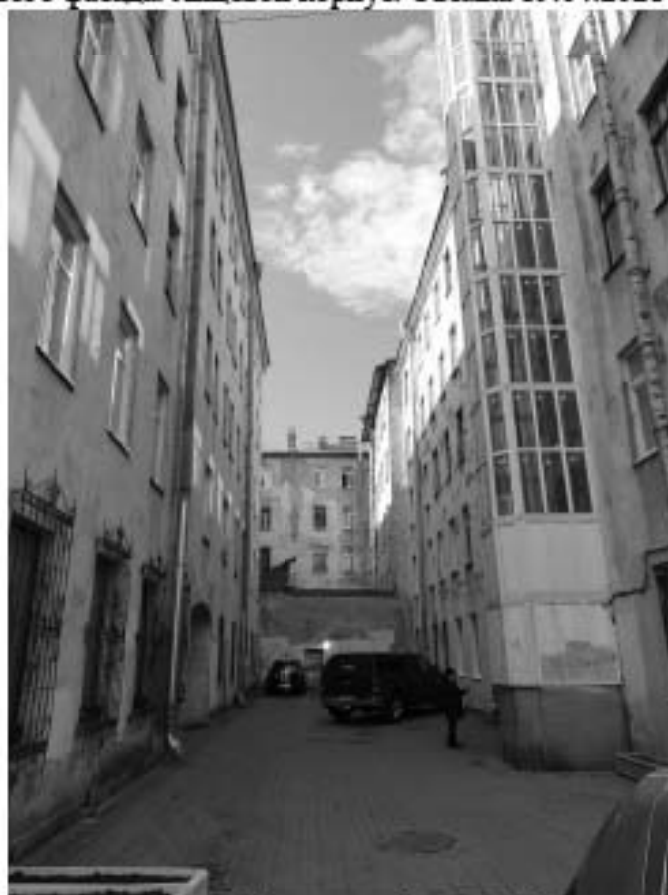
Фото 28. Здание по адресу: г. Санкт-Петербург, Большая Зеленина ул., дом 29, литера Б. Северо-восточный и юго-западный фасад 5-ти этажного корпуса. Съемка 19.04.2021 г. Штиглиц М. С.
