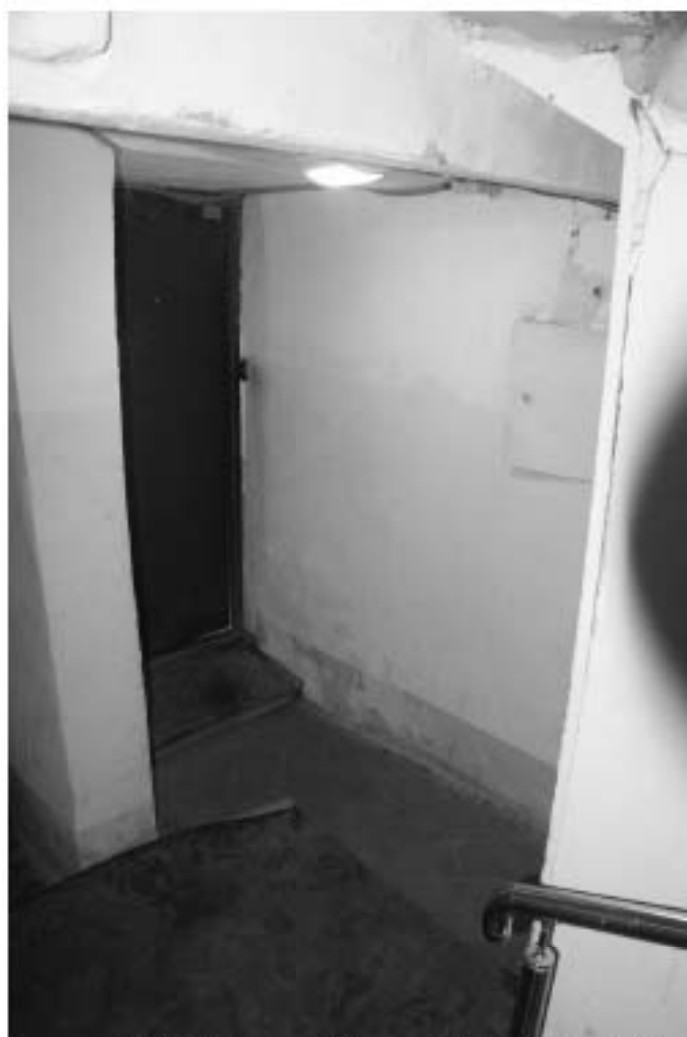
Фото 1. Лестница № 6. 1-й этаж. Съемка 19.04.2021 г. Штиглиц М. С.
