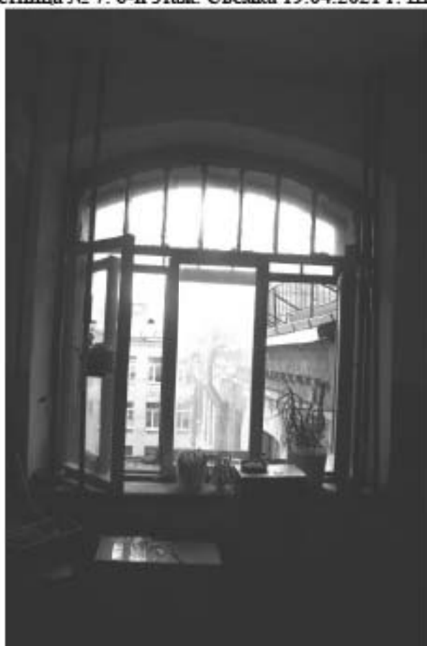
Фото 73. Лестница № 7. 6-й этаж. Съёмка 19.04.2021 г. Штиглиц М. С.
