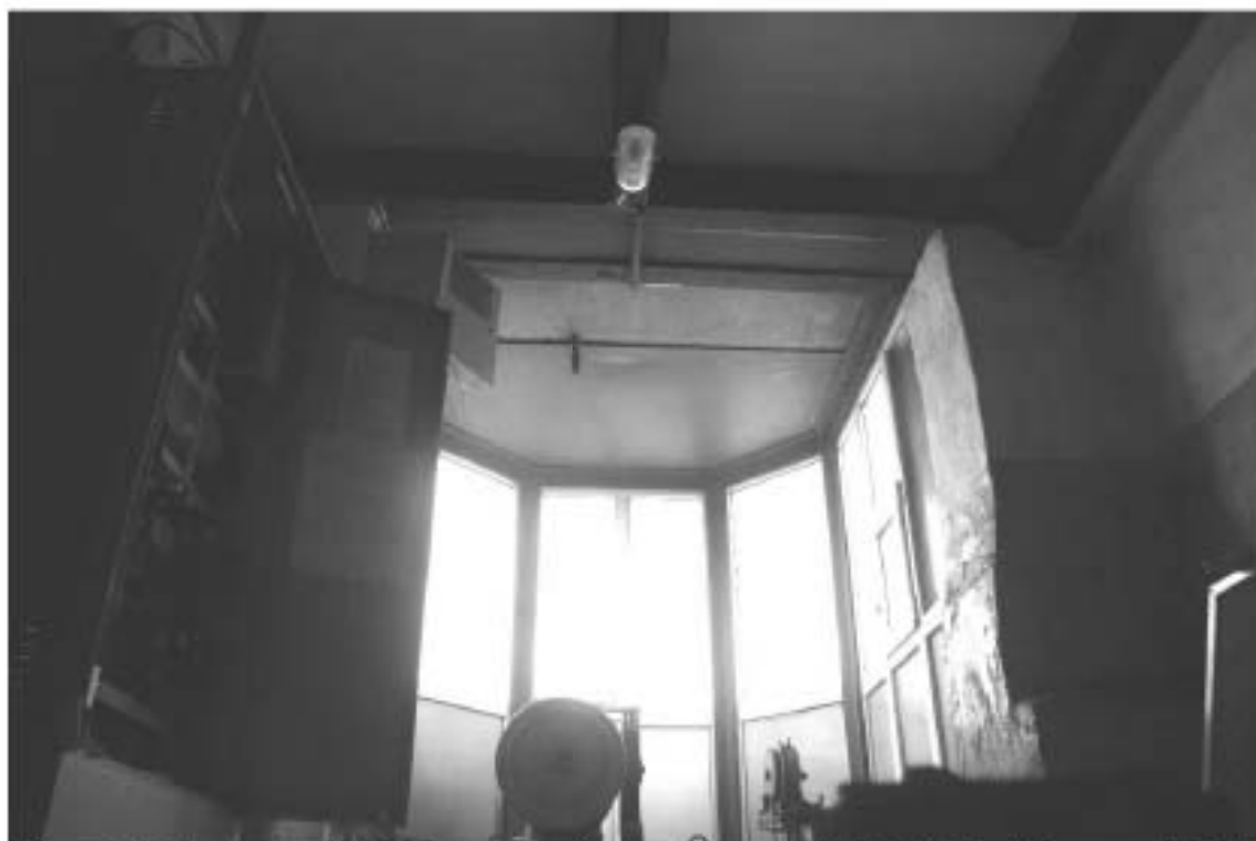
Фото 82. Лестница № 7. Технический этаж. Съемка 19.04.2021 г. Штиглиц М. С.
