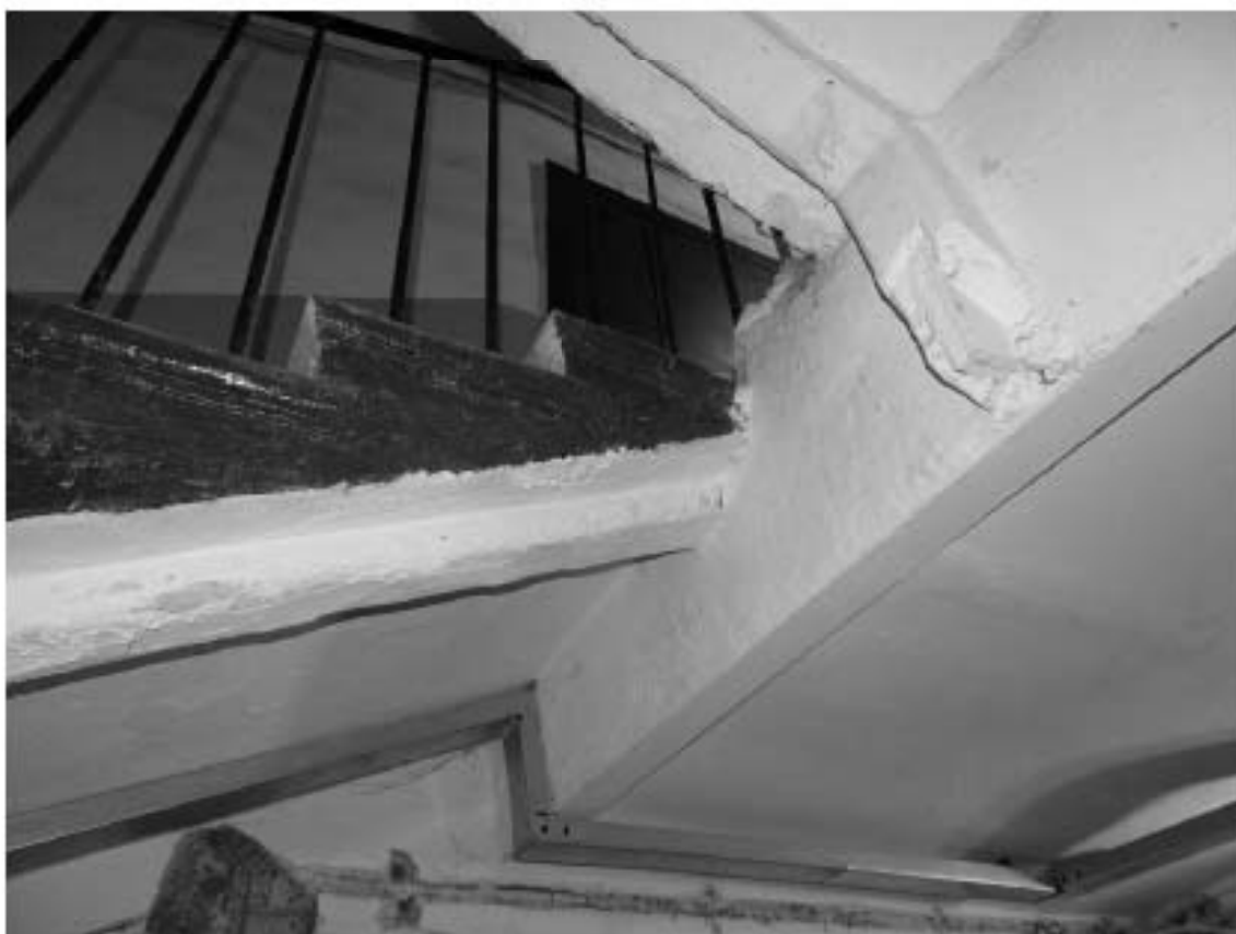
Фото 49. Лестница № 7. 1-й этаж. Съемка 19.04.2021 г. Штиглиц М. С.
