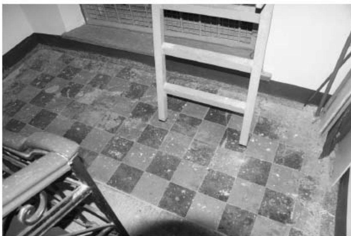
Фото 113. Лестница № 8. Площадка между 5-м и 6-м этажом. Выход на кровлю. Съемка 19.04.2021 г. Штиглиц М. С.
