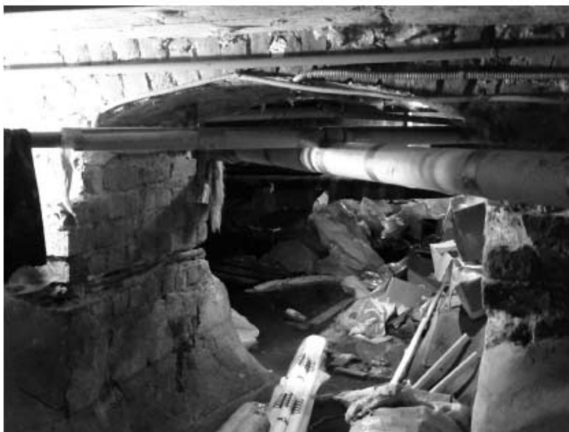
Фото 44. Лестница № 7. Подвал. Съемка 19.04.2021 г. Штиглиц М. С.
