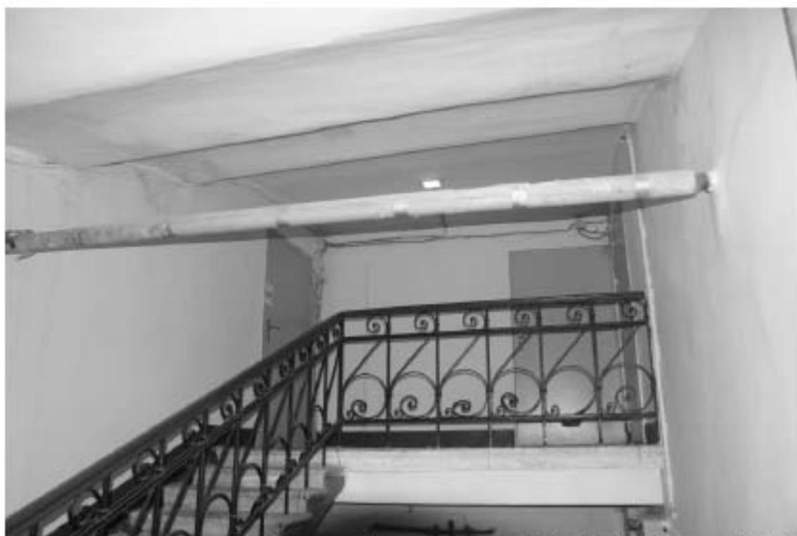
Фото 114. Лестница № 8. Чердачный этаж. Съемка 19.04.2021 г. Штиглиц М. С.
