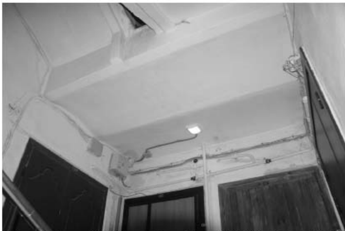
Фото 16. Лестница № 6. 2-й этаж. Своды. Съемка 19.04.2021 г. Штиглиц М. С.
