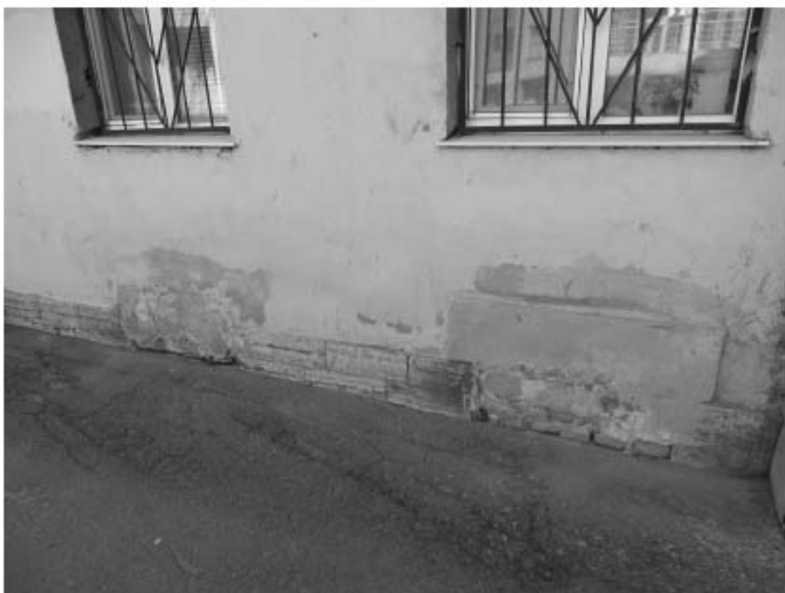
Фото 13 Здание по адресу: г. Санкт-Петербург, Большая Зеленина ул., дом 29, литера Б. Фрагмент лицевого фасада по ул. Петрозаводской. Цоколь. Съемка 19.04.2021 г. Штиглиц М. С.
