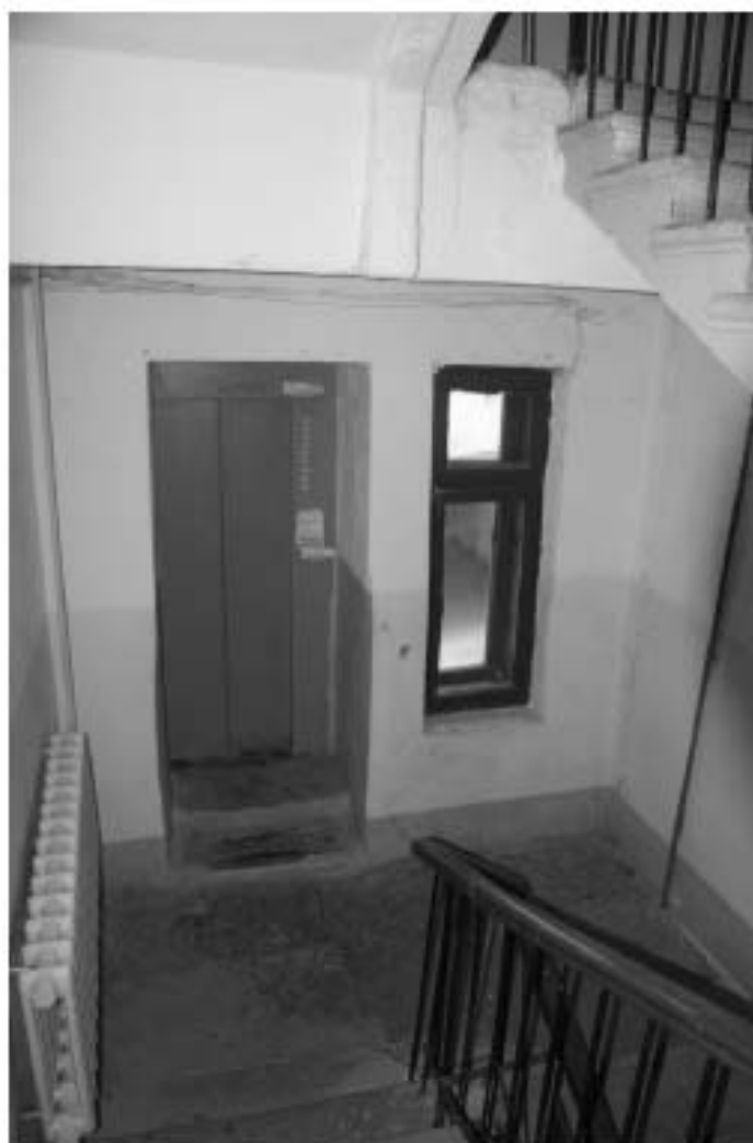
Фото 13. Лестница № 6. Площадка между 1-м и 2-м этажом. Съемка 19.04.2021 г. Штиглиц М. С.
