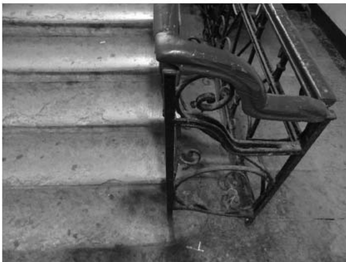
Фото 90. Лестница № 8. 1-й этаж. Вестибюль. Ступени лестничного марша. Съемка 19.04.2021 г. Штиглиц М. С.
