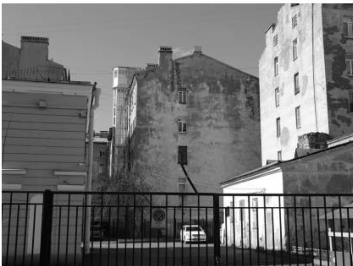
Фото 29. Здание по адресу: г. Санкт-Петербург, Большая Зеленина ул., дом 29, литера Б. Брандмауэр. Съемка 19.04.2021 г. Штиглиц М. С.
