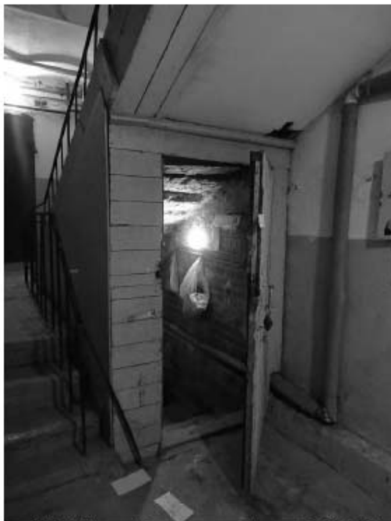
Фото 40. Лестница № 7. 1-й этаж. Вход в подвал. Съемка 19.04.2021 г. Штиглиц М. С.
