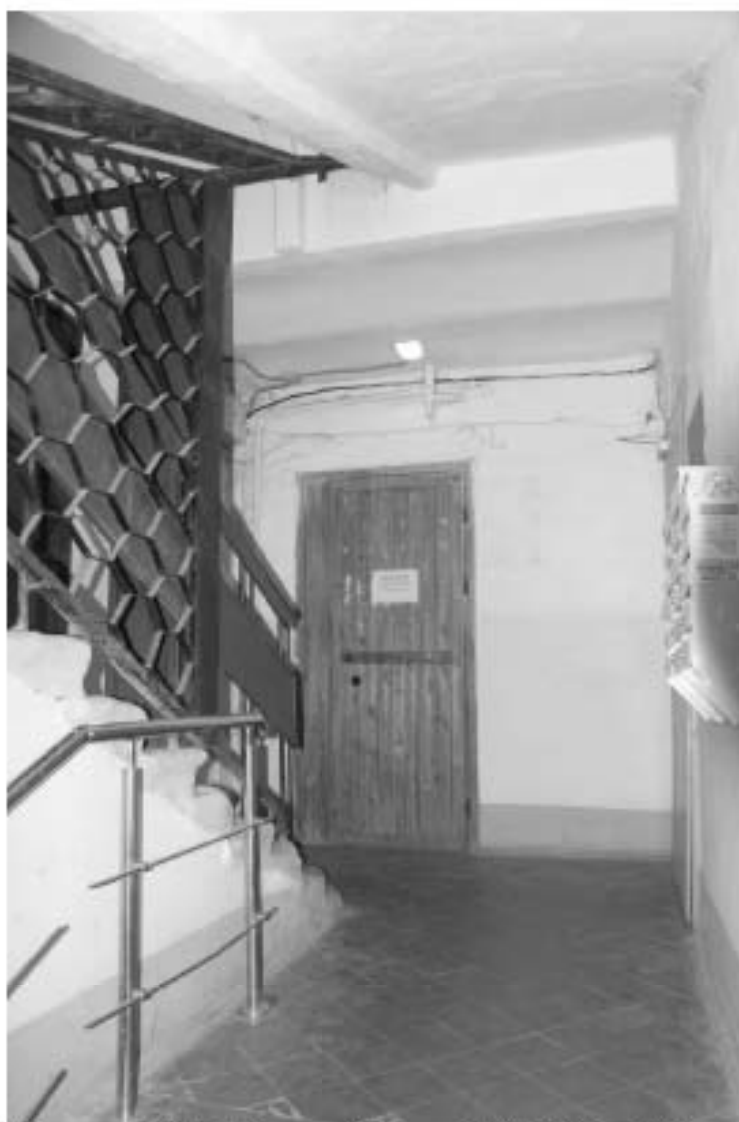
Фото 5. Лестница № 6. 1-й этаж. Съемка 19.04.2021 г. Штиглиц М. С.
