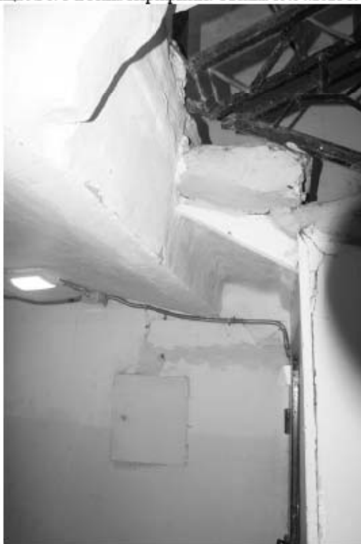
Фото 4. Лестница № 6. 1-й этаж. Перекрытие. Съемка 19.04.2021 г. Штиглиц М. С.
