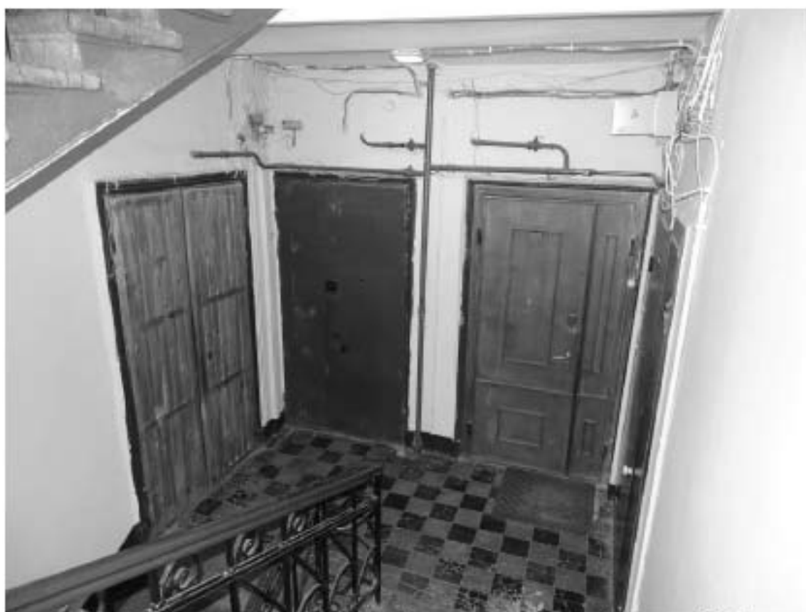
Фото 99. Лестница № 8. 3-й этаж. Съемка 19.04.2021 г. Штиглиц М. С.
