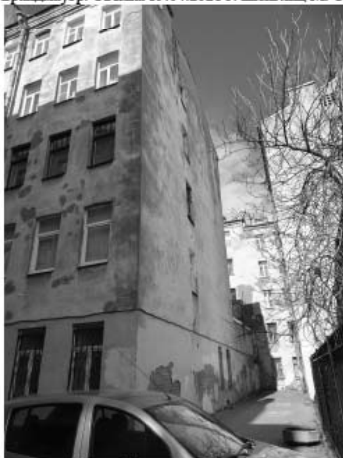
Фото 30. Здание по адресу: г. Санкт-Петербург, Большая Зеленина ул., дом 29, литера Б. Фрагмент северо-восточного фасада 5-ти этажного корпуса. Съемка 19.04.2021 г. Штиглиц М. С.
