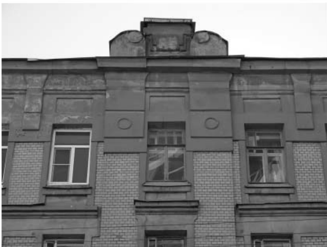
Фото 5. Здание по адресу: г. Санкт-Петербург, Большая Зеленина ул., дом 29, литера Б. Фрагмент лицевого фасада по ул. Петрозаводской. Съемка 19.04.2021 г. Штиглиц М. С.
