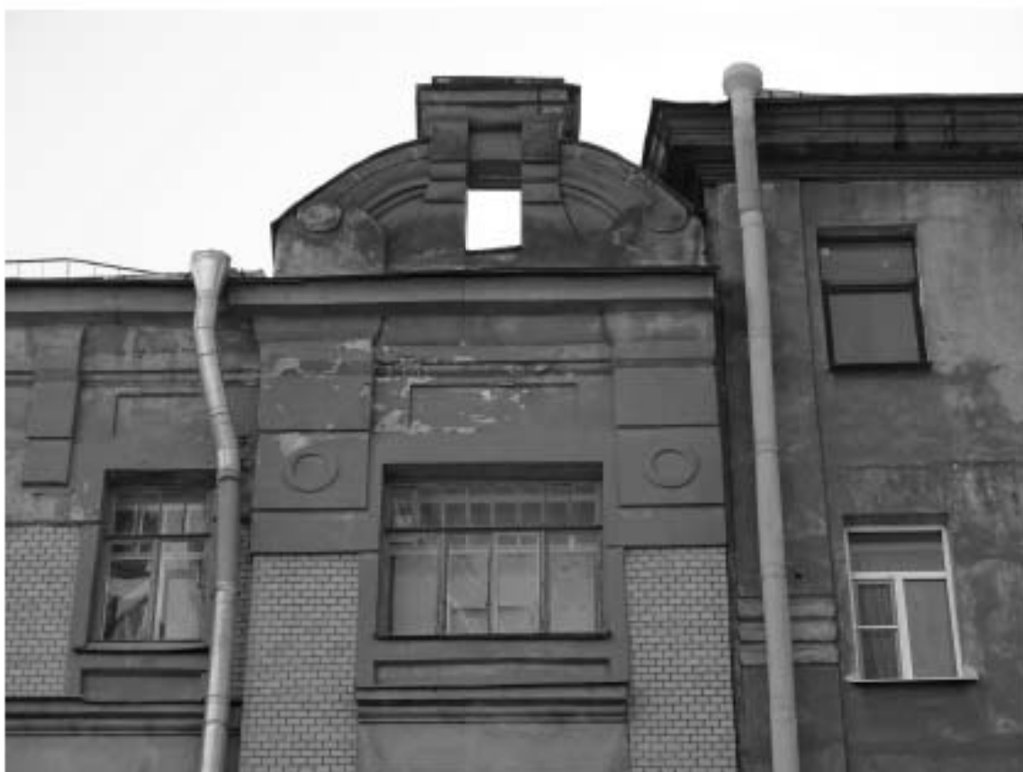
Фото 3. Здание по адресу: г. Санкт-Петербург, Большая Зеленая ул., дом 29, литера Б. Фрагмент лицевого фасада по ул. Петрозаводской. Аттик. Съемка 19.04.2021 г. Штиглиц М. С.
