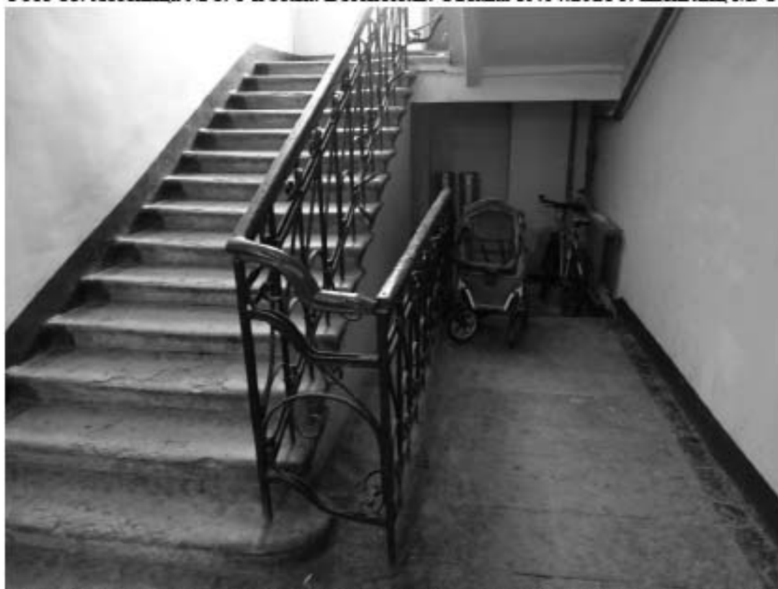
Фото 89. Лестница № 8. 1-й этаж. Вестибюль. Съёмка 19.04.2021 г. Штиглиц М. С.
