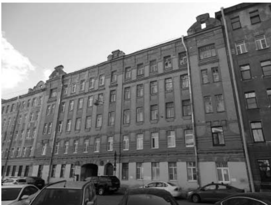
Фото 1. Здание по адресу: г. Санкт-Петербург, Большая Зеленная ул., дом 29, литера Б. Лицевой фасад по ул. Петрозаводской. Съемка 19.04.2021 г. Штиглиц М. С.
