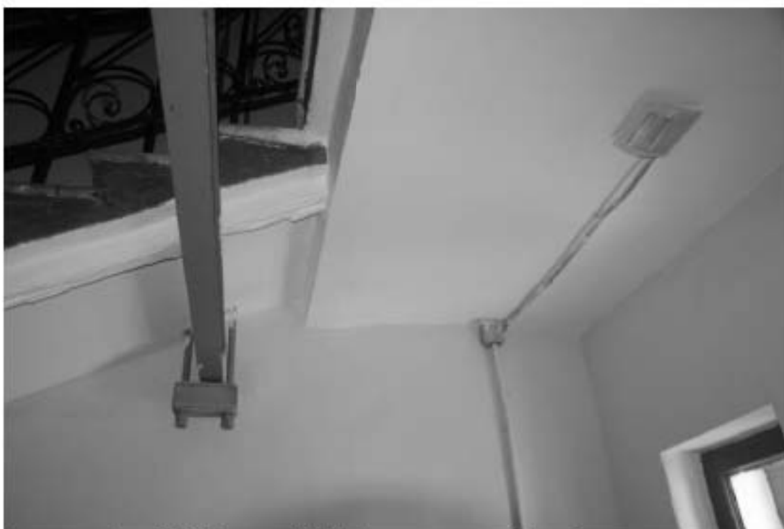
Фото 106. Лестница № 8. Площадка между 4-м и 5-м этажом. Съемка 19.04.2021 г. Штиглиц М. С.
