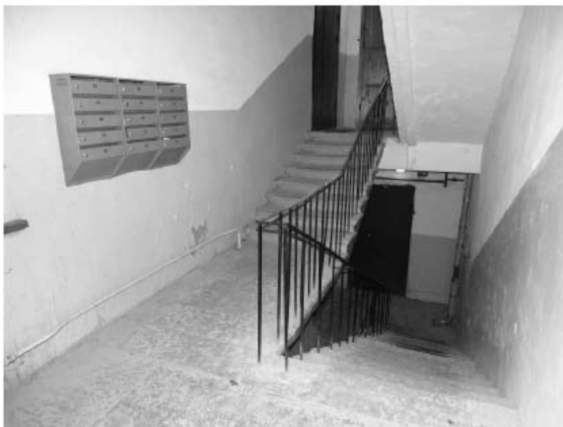
Фото 54. Лестница № 7. 2-й этаж. Съемка 19.04.2021 г. Штиглиц М. С.
